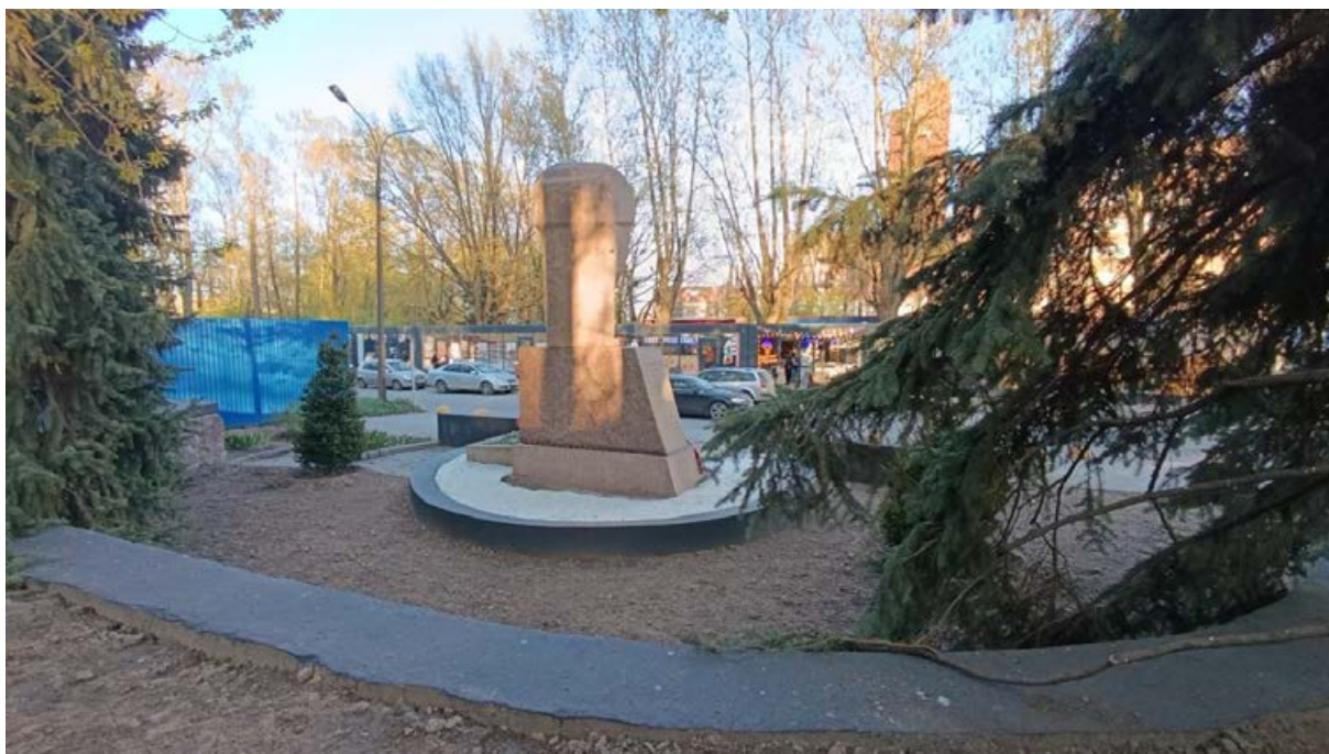
Фото 3. Вид объекта с запада, с насыпи.
