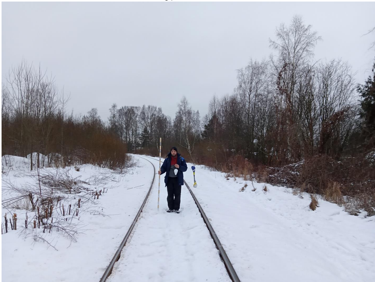
Рис. 22. ЖД Левашово-Сертолово-2021. Точка фотофиксации 3, вид на юг.
