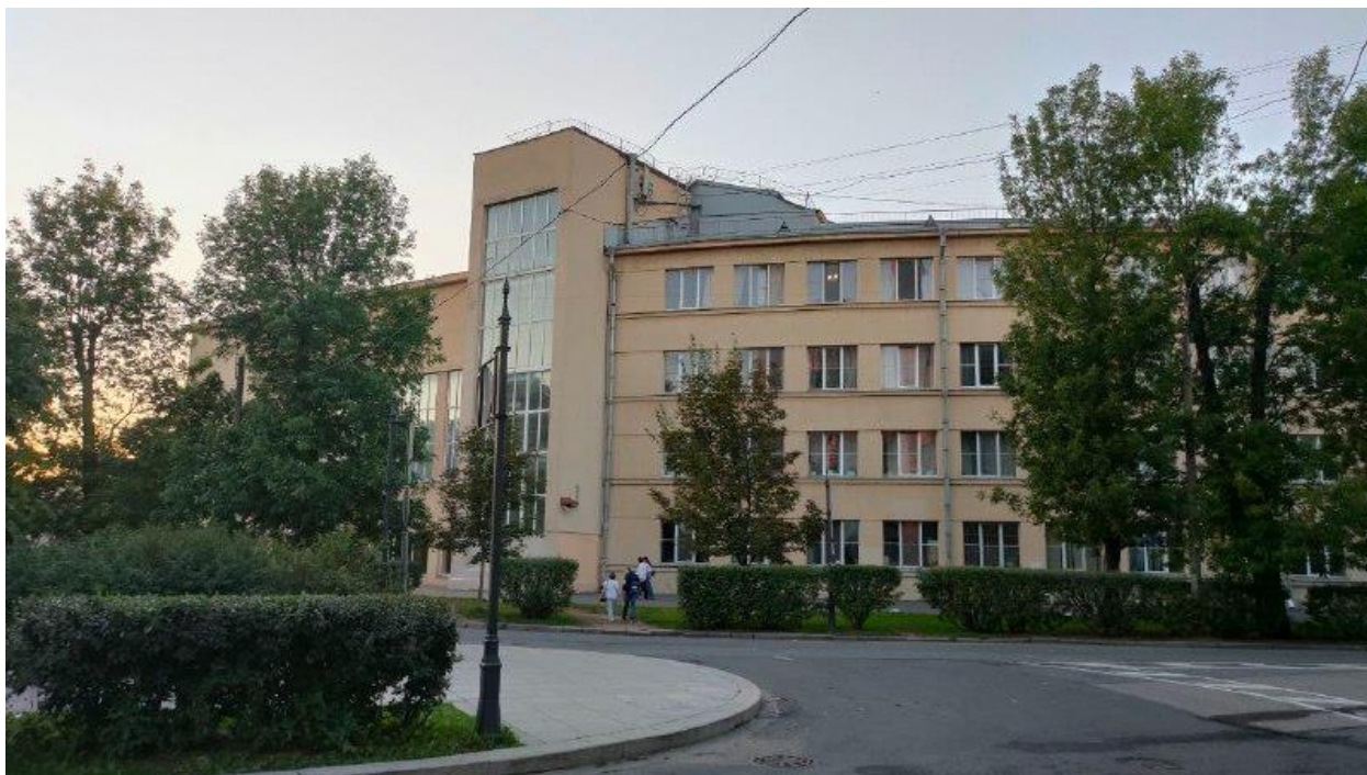
Фото 1. Вид на фасад со стороны Конного переулка выявленного объекта культурного наследия «Здание Академии сигнализации и связи» по адресу: Санкт-Петербург, Кронверкский пр., д. 9, лит. А
