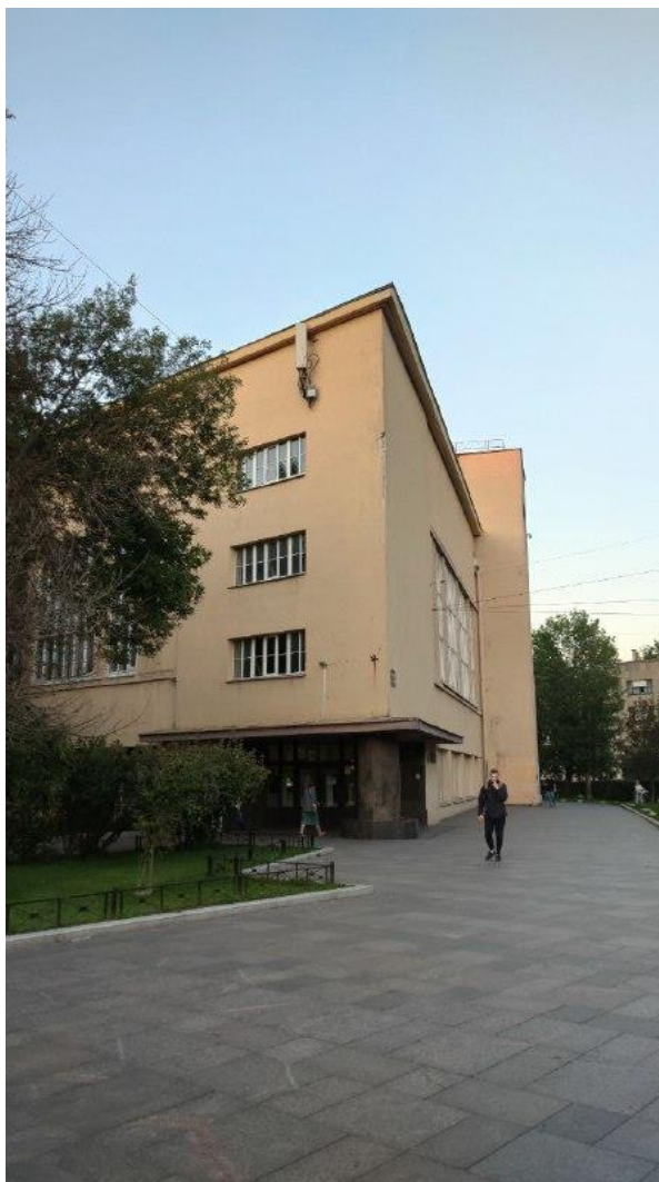
Фото 7. Вид на входную зону на углу Кронверкского проспекта и Конного переулка выявленного объекта культурного наследия «Здание Академии сигнализации и связи» по адресу: Санкт-Петербург, Кронверкский пр., д. 9, лит. А
