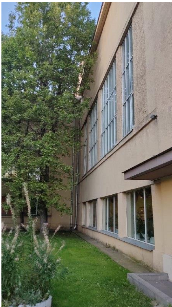
Фото 9. Вид на фрагмент фасада со стороны Каменноостровского проспекта выявленного объекта культурного наследия «Здание Академии сигнализации и связи» по адресу: Санкт-Петербург, Кронверкский пр., д. 9, лит. А
