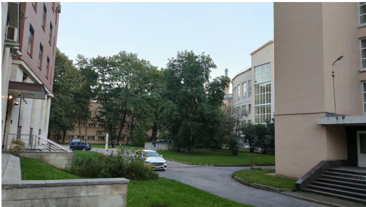
Фото 15. Вид на фасад со стороны Конного переулка выявленного объекта культурного наследия «Здание Академии сигнализации и связи» по адресу: Санкт-Петербург, Кронверкский пр., д. 9, лит. А
