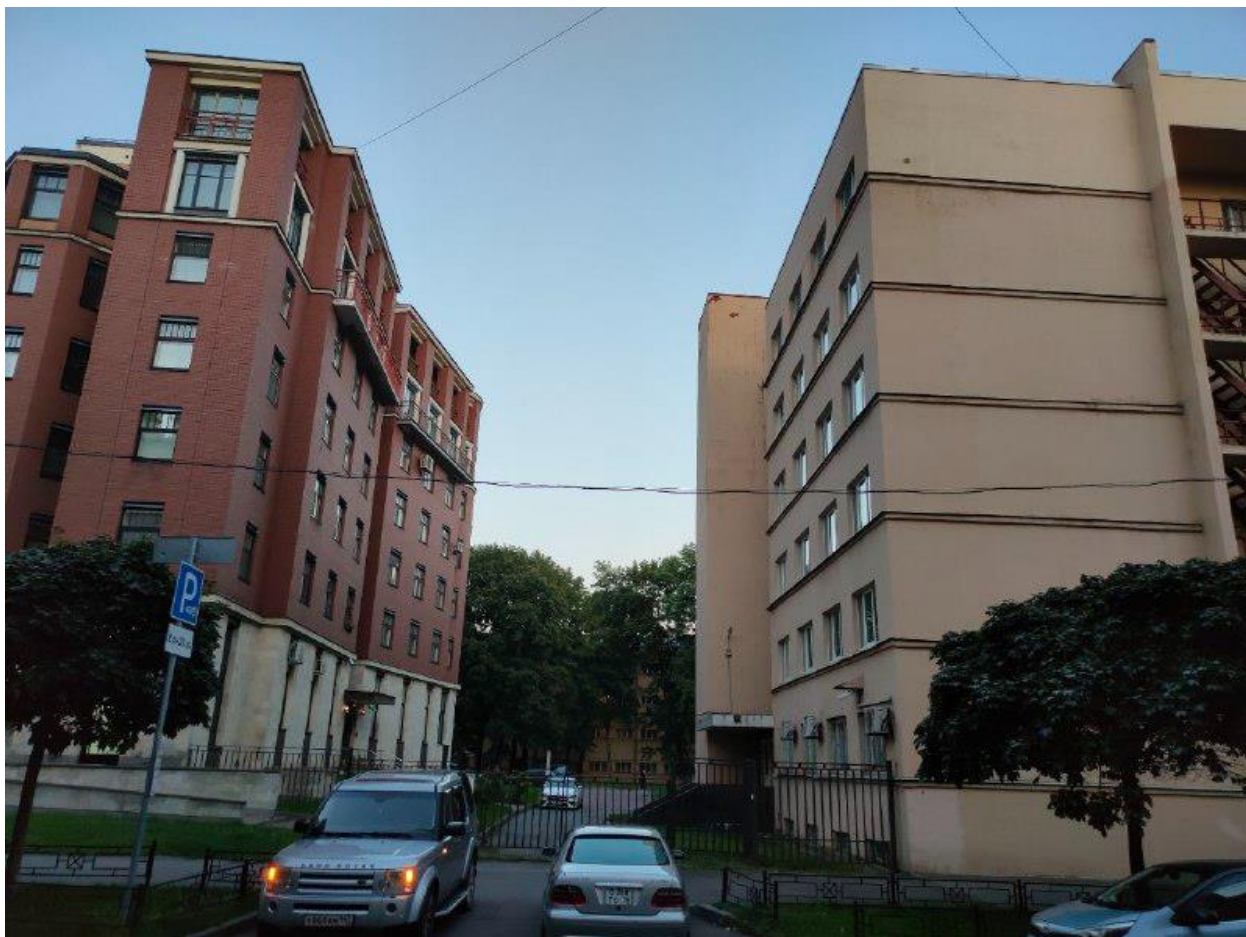
Фото 13. Вид на фрагмент фасада со стороны Крестыанского переулкa выявленного объекта культурного наследия «Здание Академии сигнализации и связи» по адресу: Санкт-Петербург, Кронверкский пр., д. 9, лит. А
