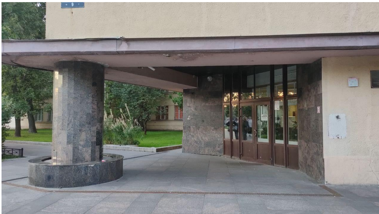
Фото 8. Вид на входную зону на углу Кронверкского проспекта и Конного переулка выявленного объекта культурного наследия «Здание Академии сигнализации и связи» по адресу: Санкт-Петербург, Кронверкский пр., д. 9, лит. А
