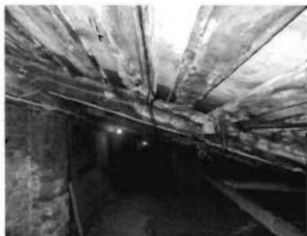
13. Фрагмент стропильной системы.
