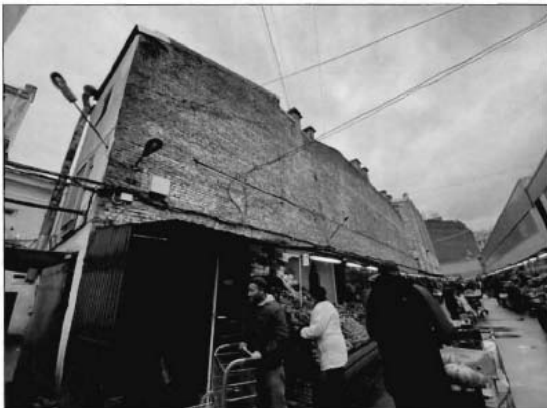
15. Северо-восточный фасад части объекта культурного наследия.
