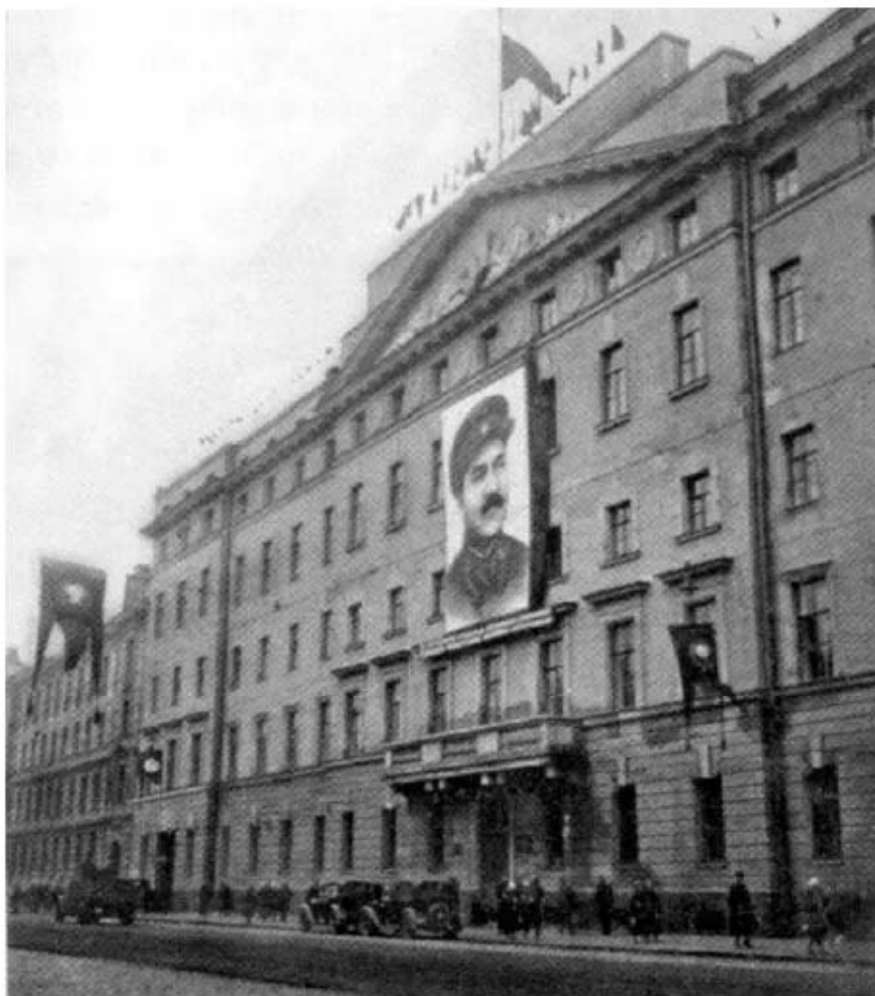
Илл. 9. Здание ЛИИЖТа после перестройки главного корпуса, фото 1930-х гг. (источник: https://www.citywalls.ru/photo650778.html )
