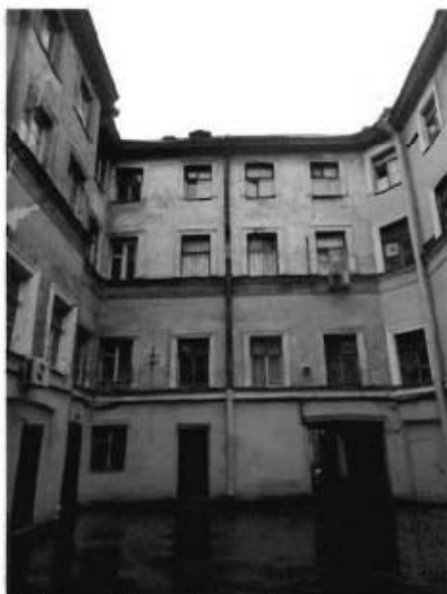
6. Восточный фасад. Западный двор.
