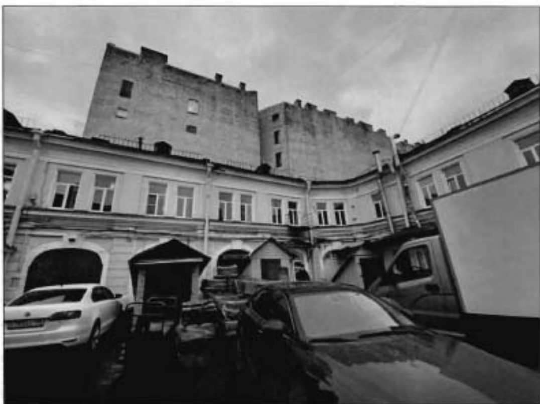
9. Фрагмент юго-восточного фасада части объекта культурного наследия.
