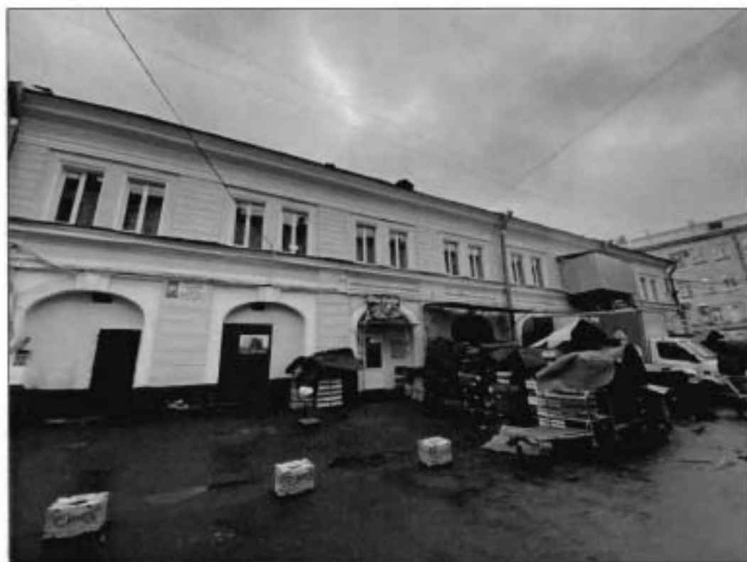
11. Фрагмент восточного фасада части объекта культурного наследия.
