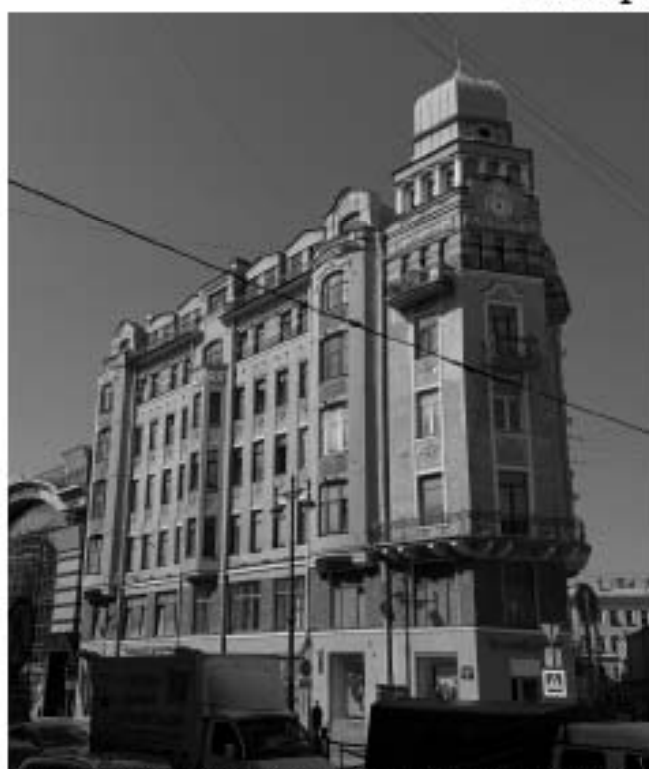
Фот. 1. Вид на выявленный объект культурного наследия «Дом Я.И. Перет» (Московский пр., 1, пер. Бринько, 2), фасад на Московский пр.
