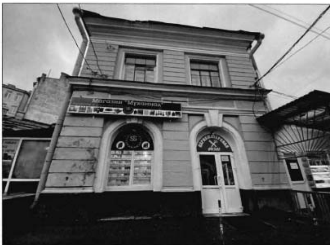
12. Северный фасад части объекта культурного наследия.
