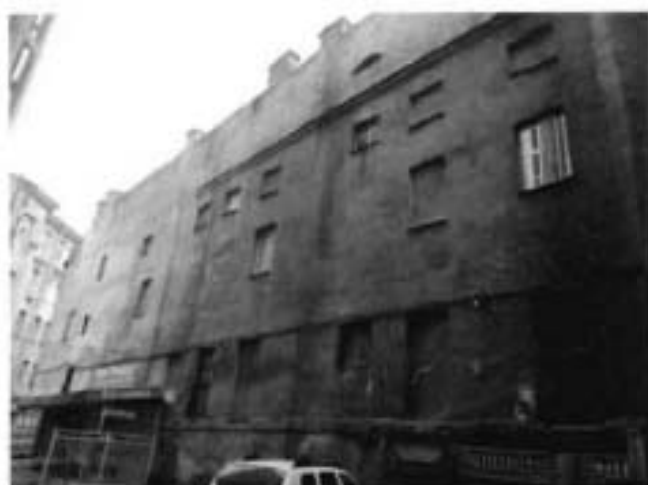
7. Северный фасад здания.
