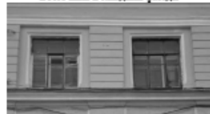
Северный и южный фасады
