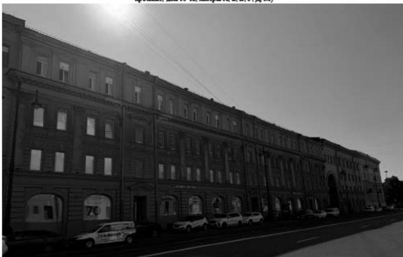
Фот. 11. Вид на объект культурного наследия регионального значения «Здание Общества торговцев рыбного рынка» (Московский проспект, дом 10-12, литеры А, Б, В, Г, Д, М)
