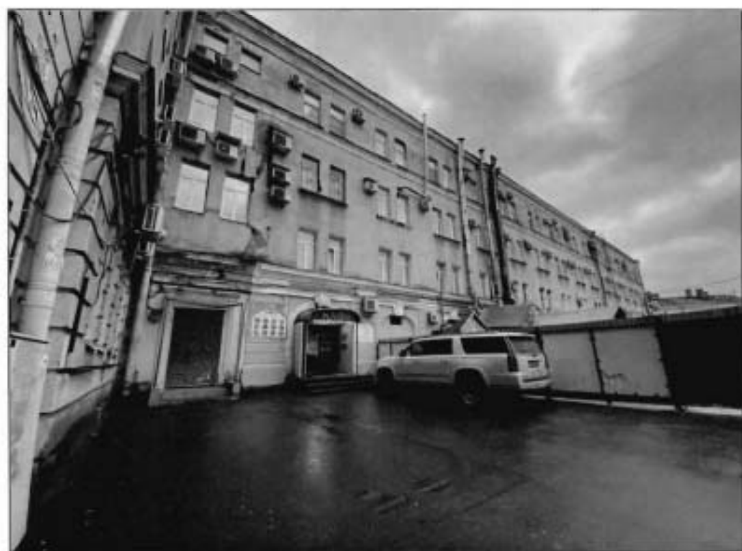
3. Южный дворовой фасад части объекта культурного наследия.
