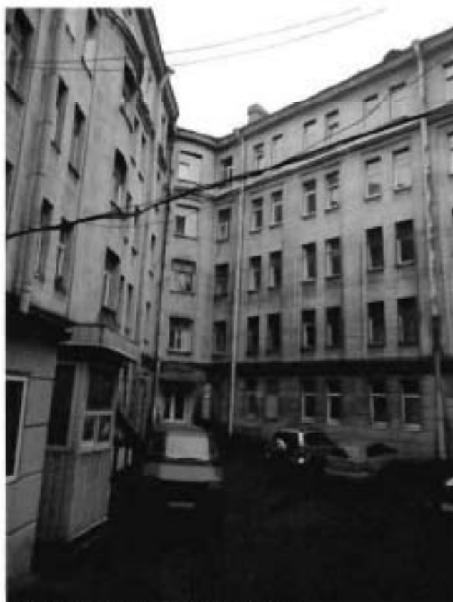
9. Общий вид восточного двора.
