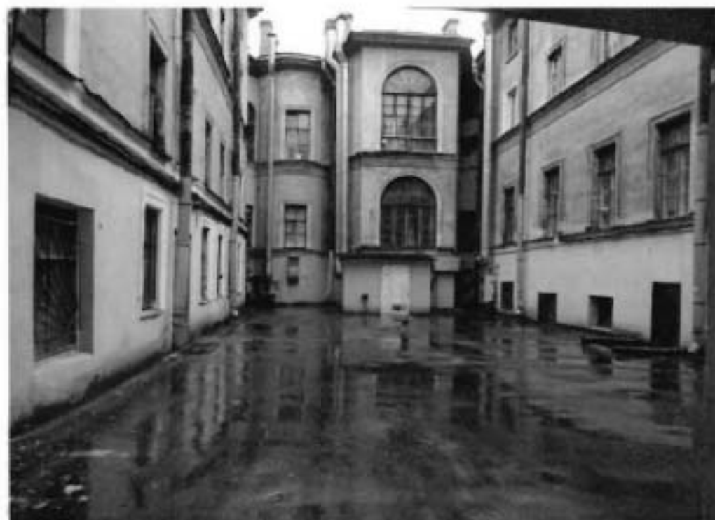
2. Западный фасад здания. Западный двор.
