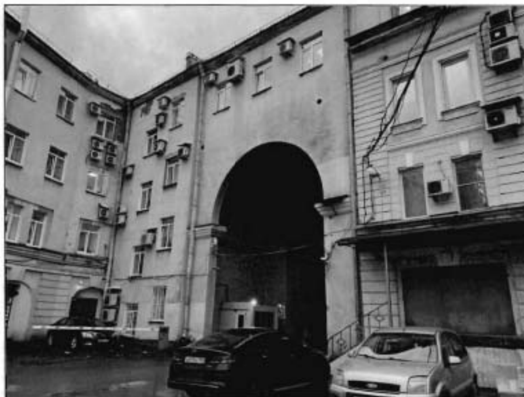
7. Восточный дворовой фасад части объекта культурного наследия.
