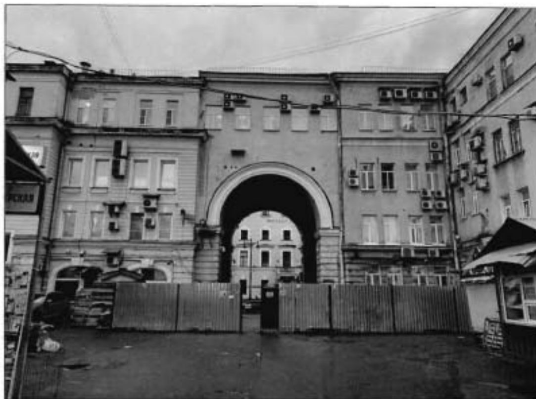
2. Восточный дворовой фасад части объекта культурного наследия.
