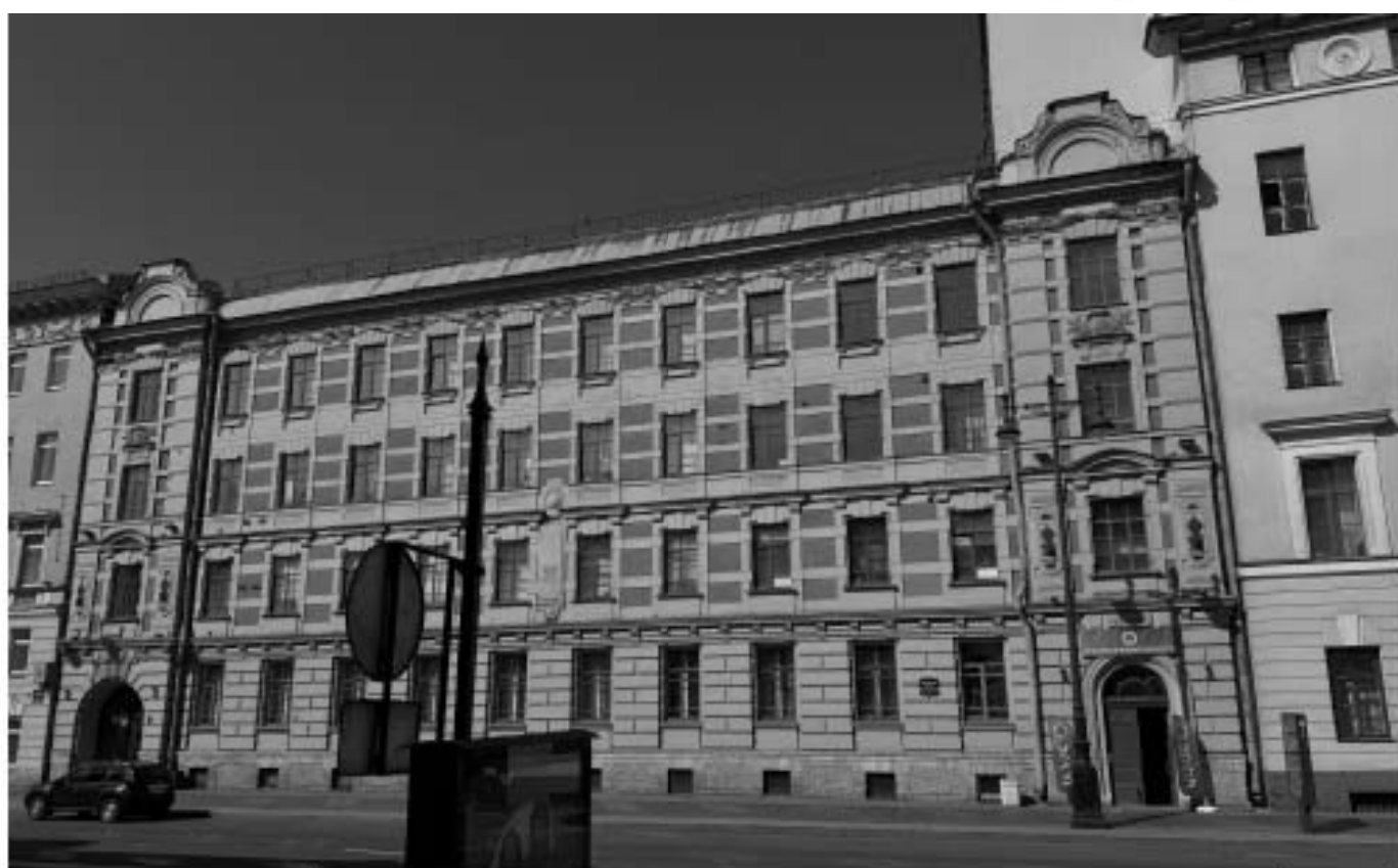
Фот. 9. Вид на выявленный объект культурного наследия «Здание Николаевского общества студентов» (Московский проспект, 11, лит. А1, А2), лицевой фасад
