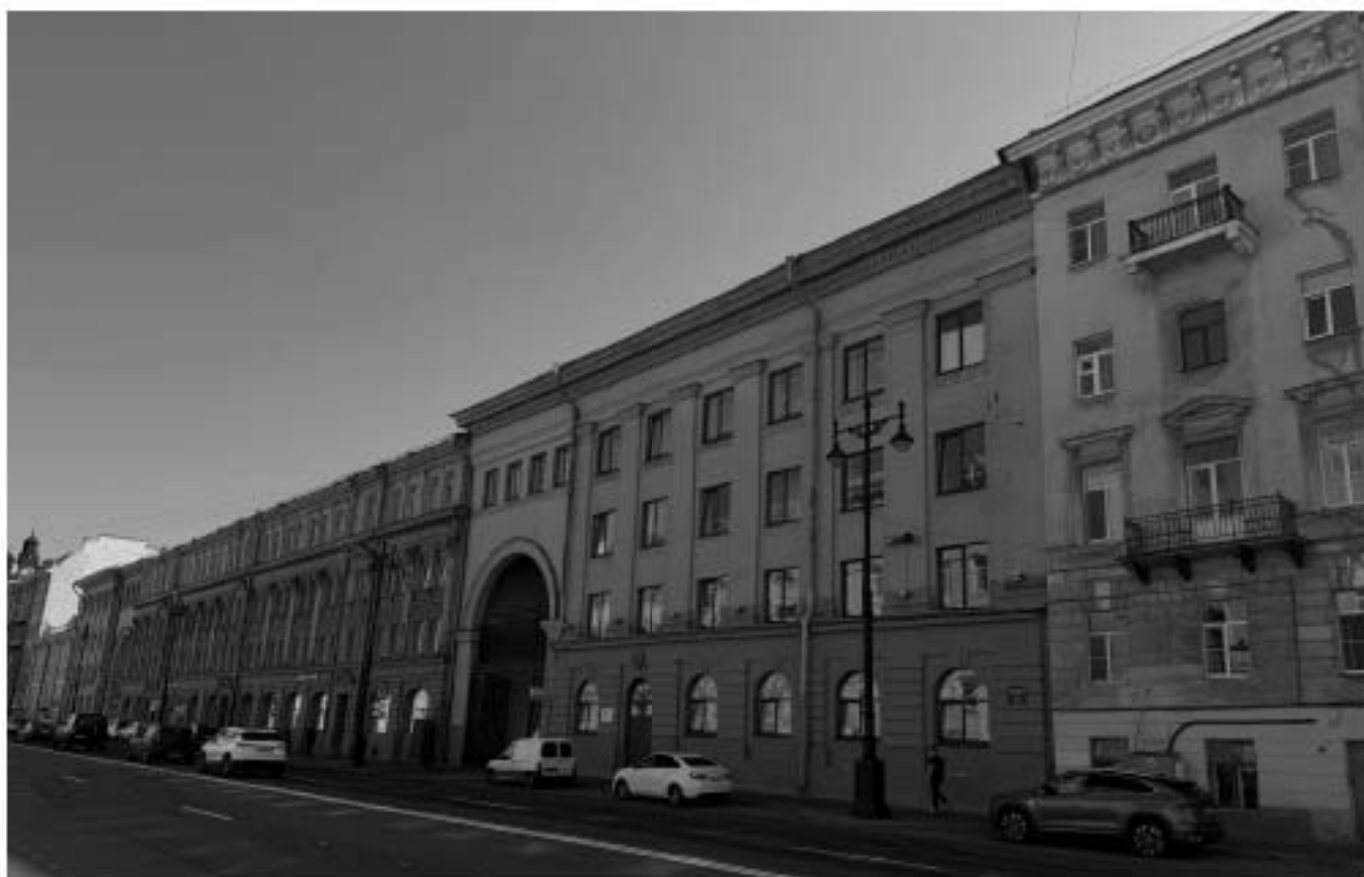
Фот. 10. Вид на объект культурного наследия регионального значения «Здание Общества торговцев рыбного рынка» (Московский проспект, дом 10-12, литеры А, Б, В, Г, Д, М)
