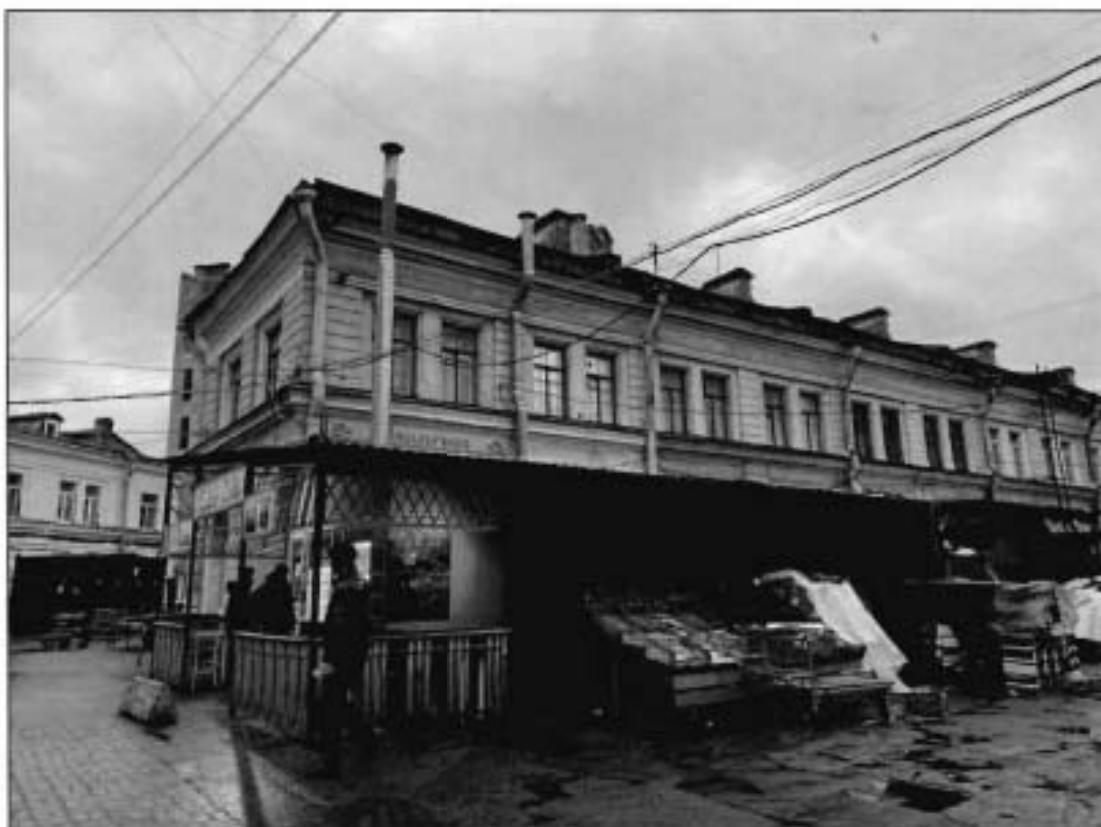
13. Фрагмент западного фасада части объекта культурного наследия.
