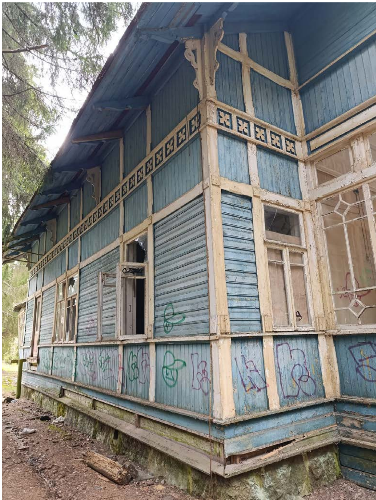
Фото 14. Вид вдоль восточного фасада.
