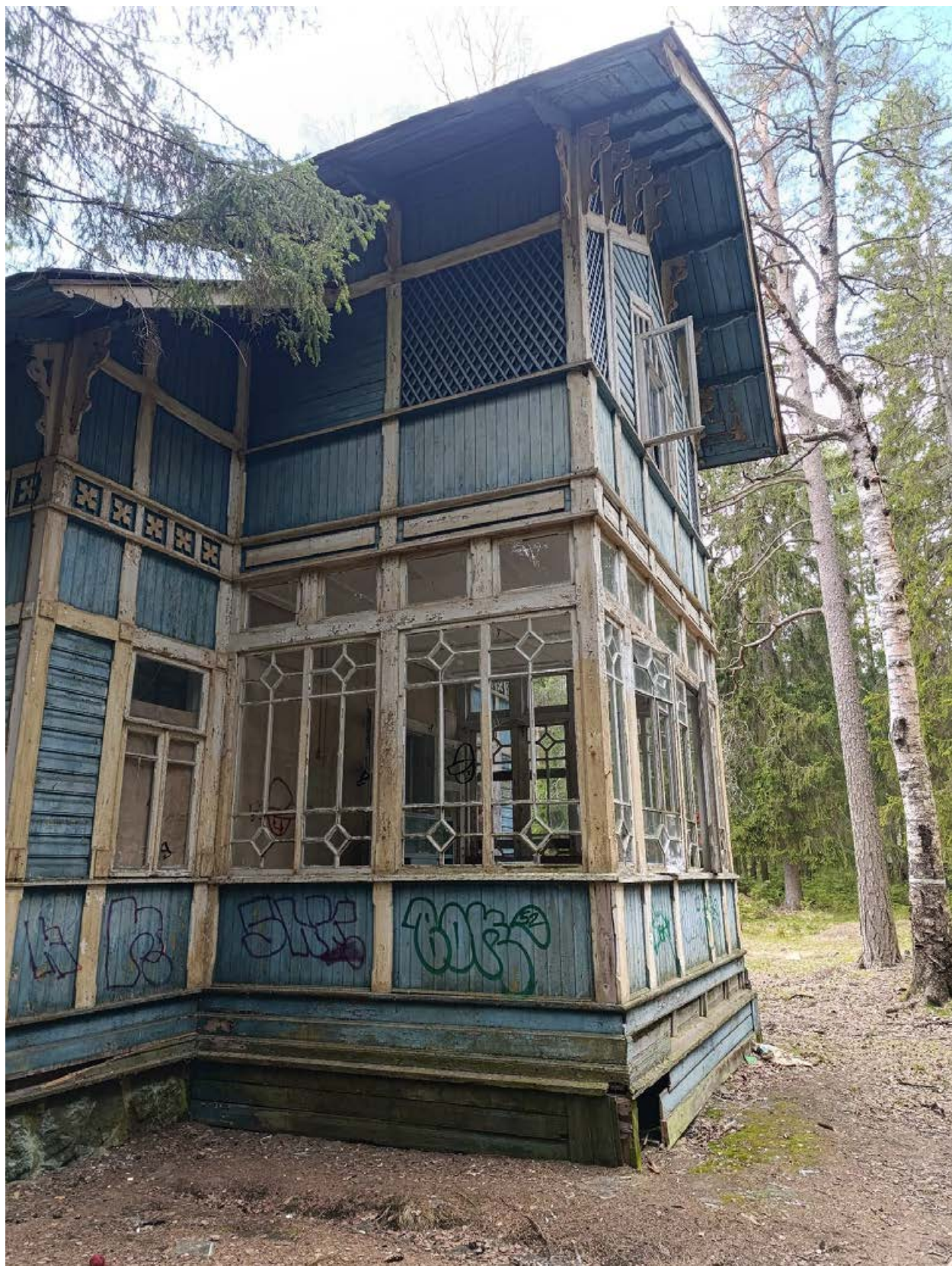
Фото 15. Северный ризалит, вид с востока.
