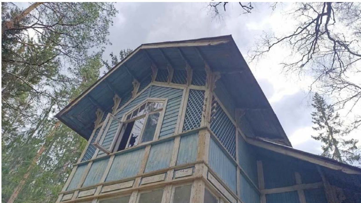
Фото 4. Фрагмент северного фасада, карниз.
