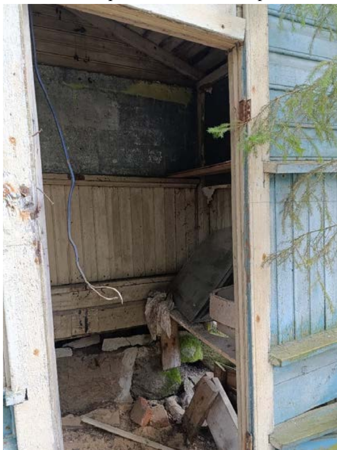
Фото 6. Пристройка к северному фасаду.
