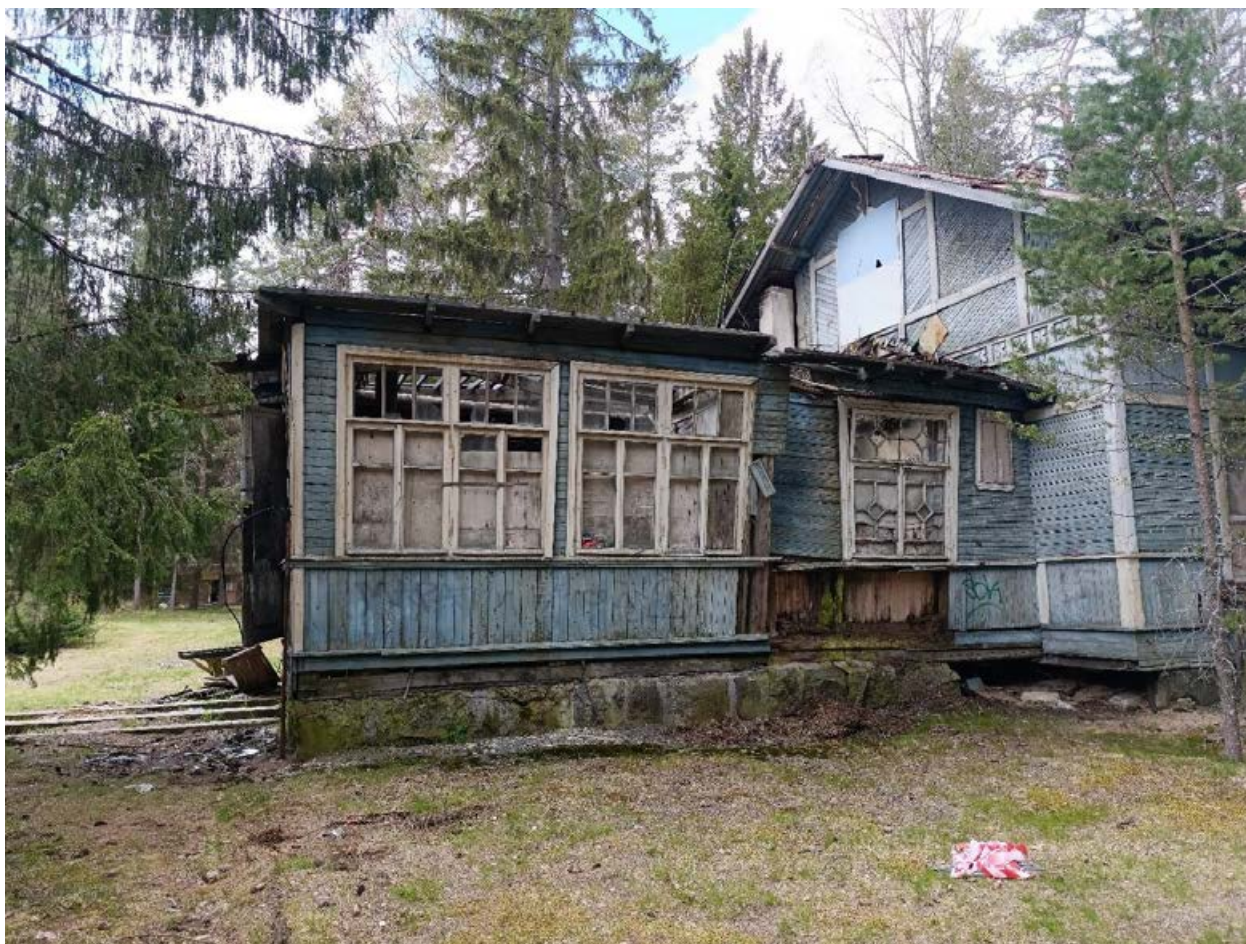
Фото 11. Восточный фасад южной веранды.
