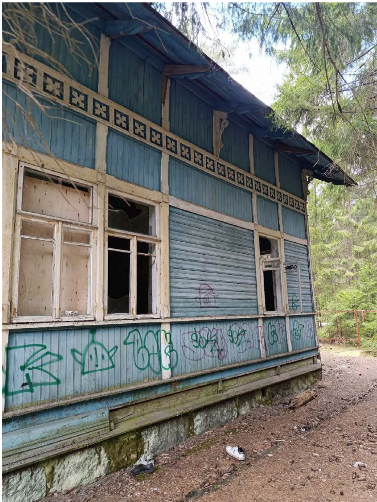
Фото 13. Фрагмент восточного фасада.
