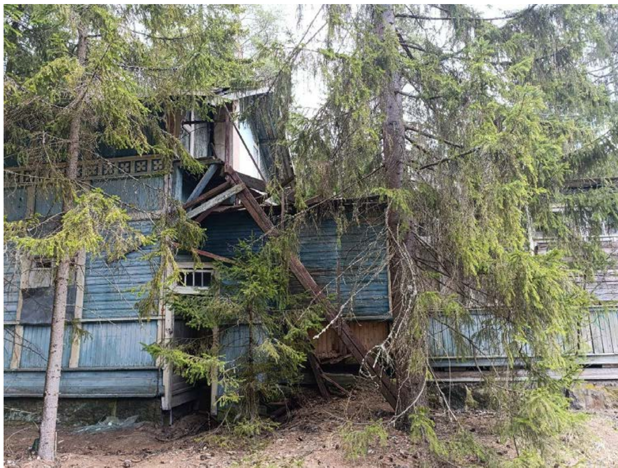
Фото 7. Западный фасад южной веранды.
