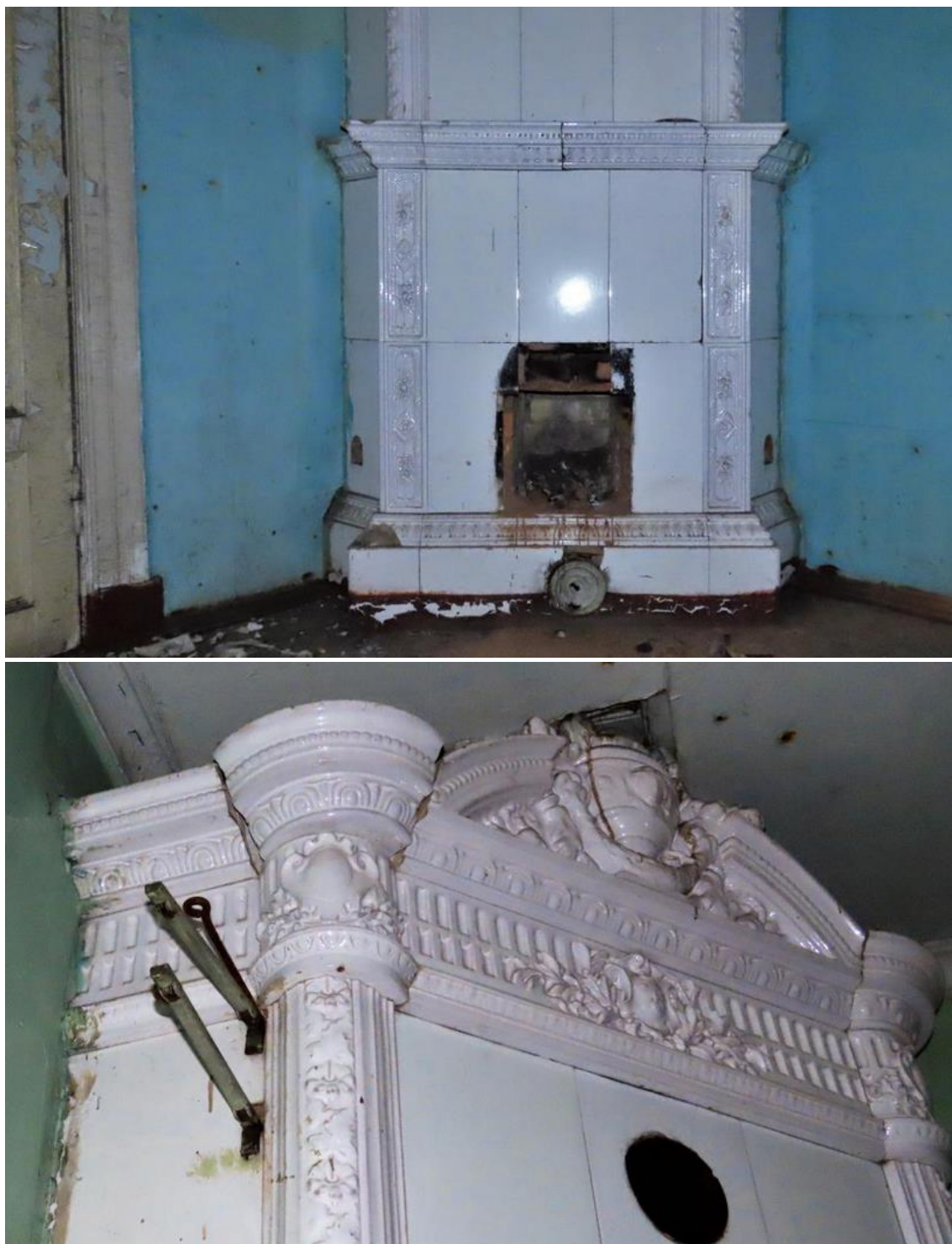
55. Печь в даче Н. Н. Слободзинского. Фото начало 2020. [Электронный портал] URL: https://www.citywalls.ru/house24934.html .
