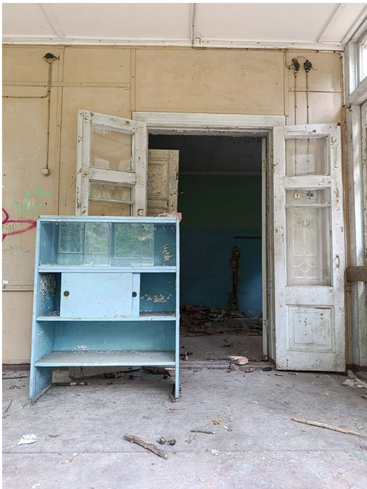
Фото 21. Северный ризалит, помещение 1.
