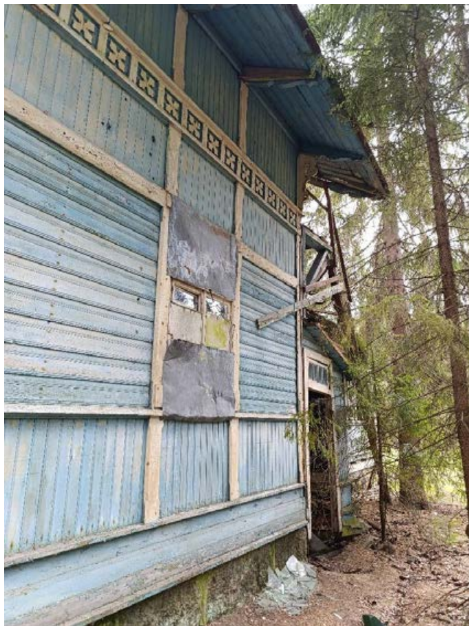
Фото 5. Фрагмент западного фасада.
