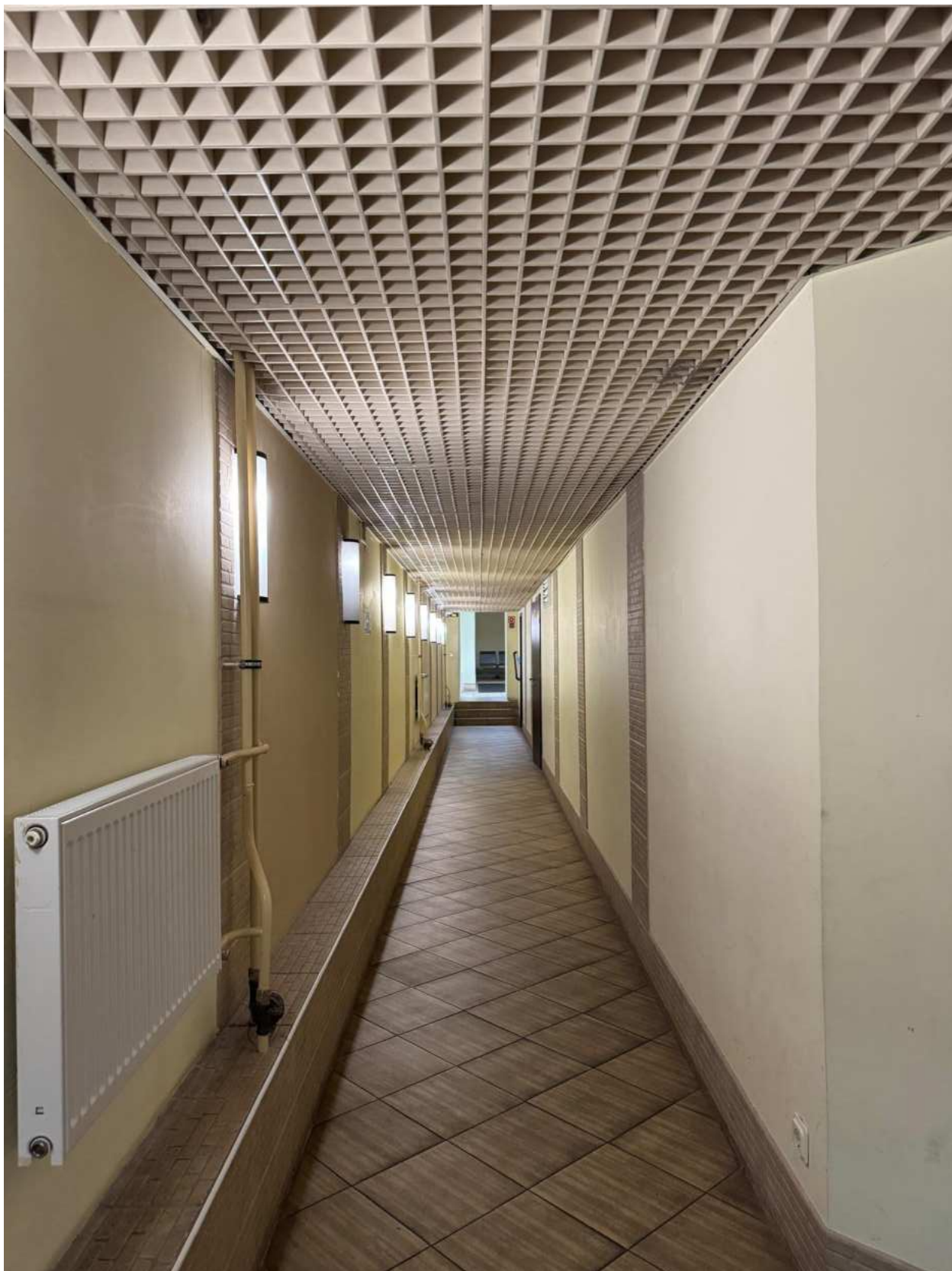
Фото 38. Вид на интерьер подвальных помещений объекта культурного наследия.
