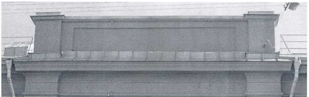
Западный лицевой фасад. Фрагмент. Аттики. Съёмка 21.03.2012, В.А. Матвеева.
