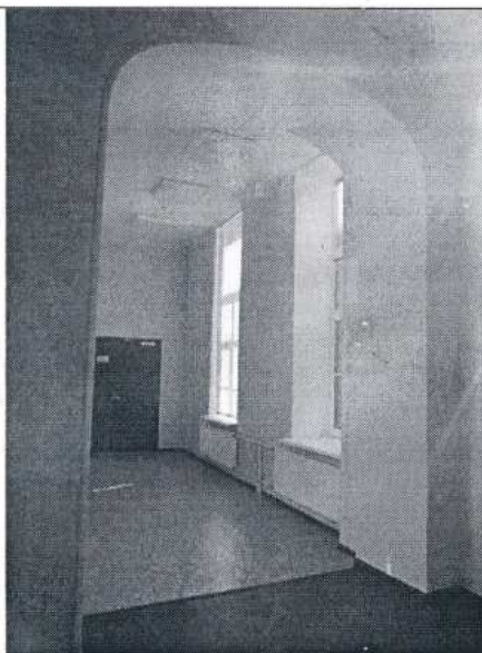
Конструктивный элемент здания – подпружная арка. Съёмка 21.03.2012, В.А. Матвеева.
