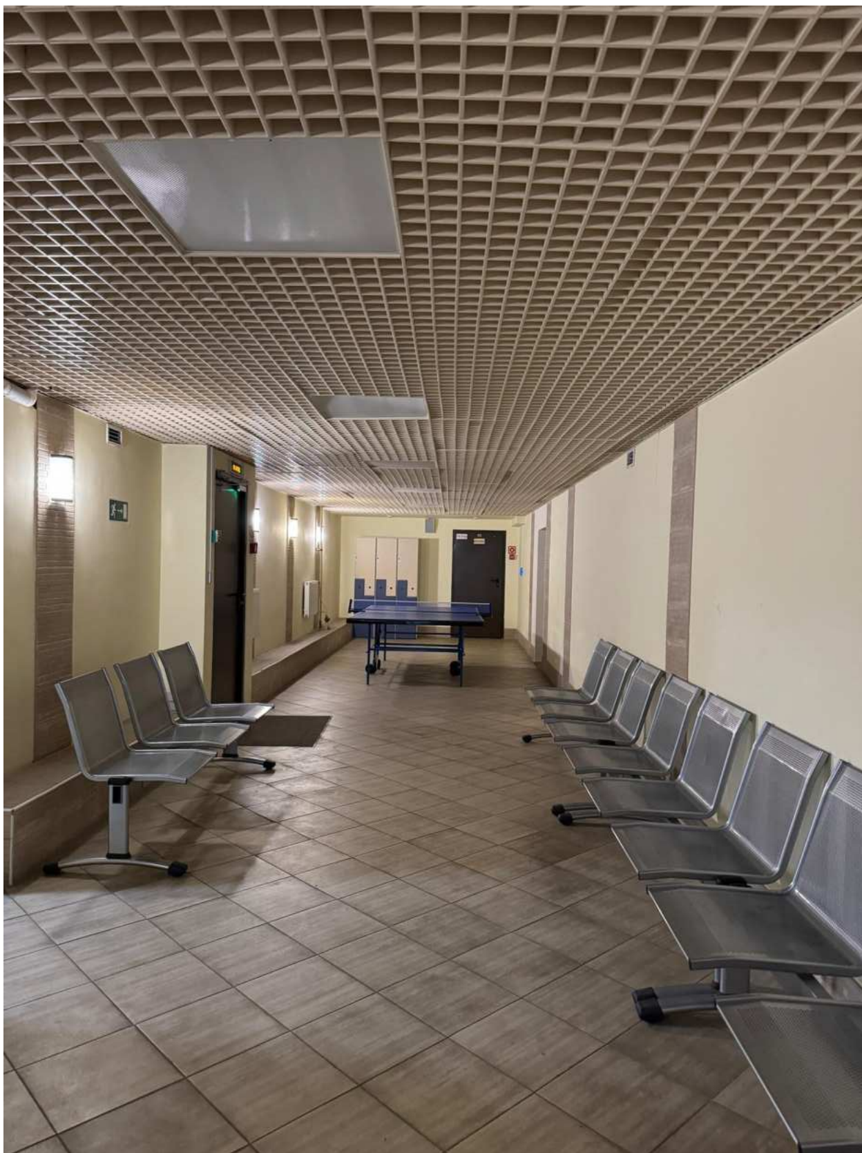
Фото 42. Вид на интерьер подвальных помещений объекта культурного наследия.
