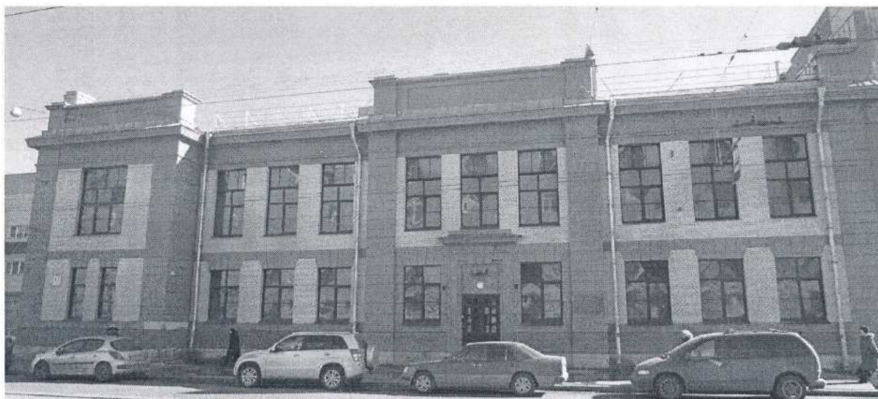
Западный лицевой фасад. Общий вид. Съёмка 21.03.2012, В.А. Матвеева.
