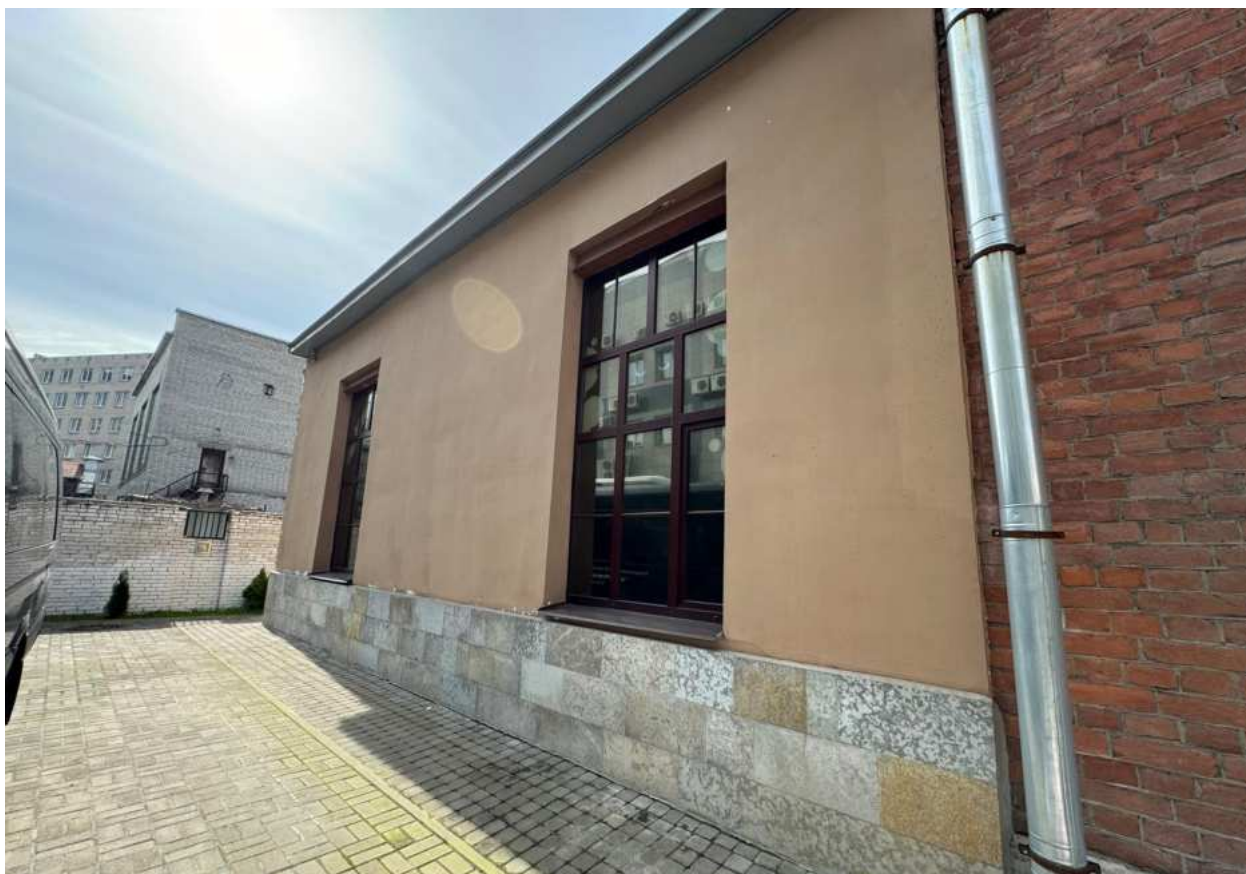
Фото 13. Общий вид пристройки к объекту культурного наследия.
