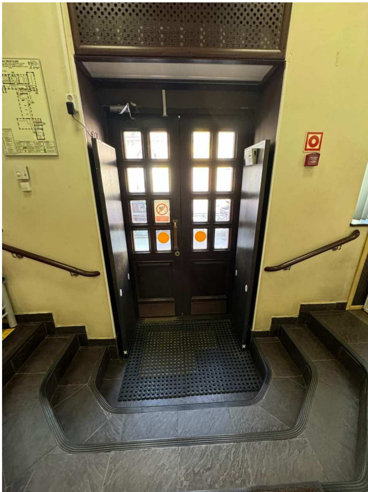
Фото 81. Вид на интерьер помещения 1-го этажа объекта культурного наследия.
