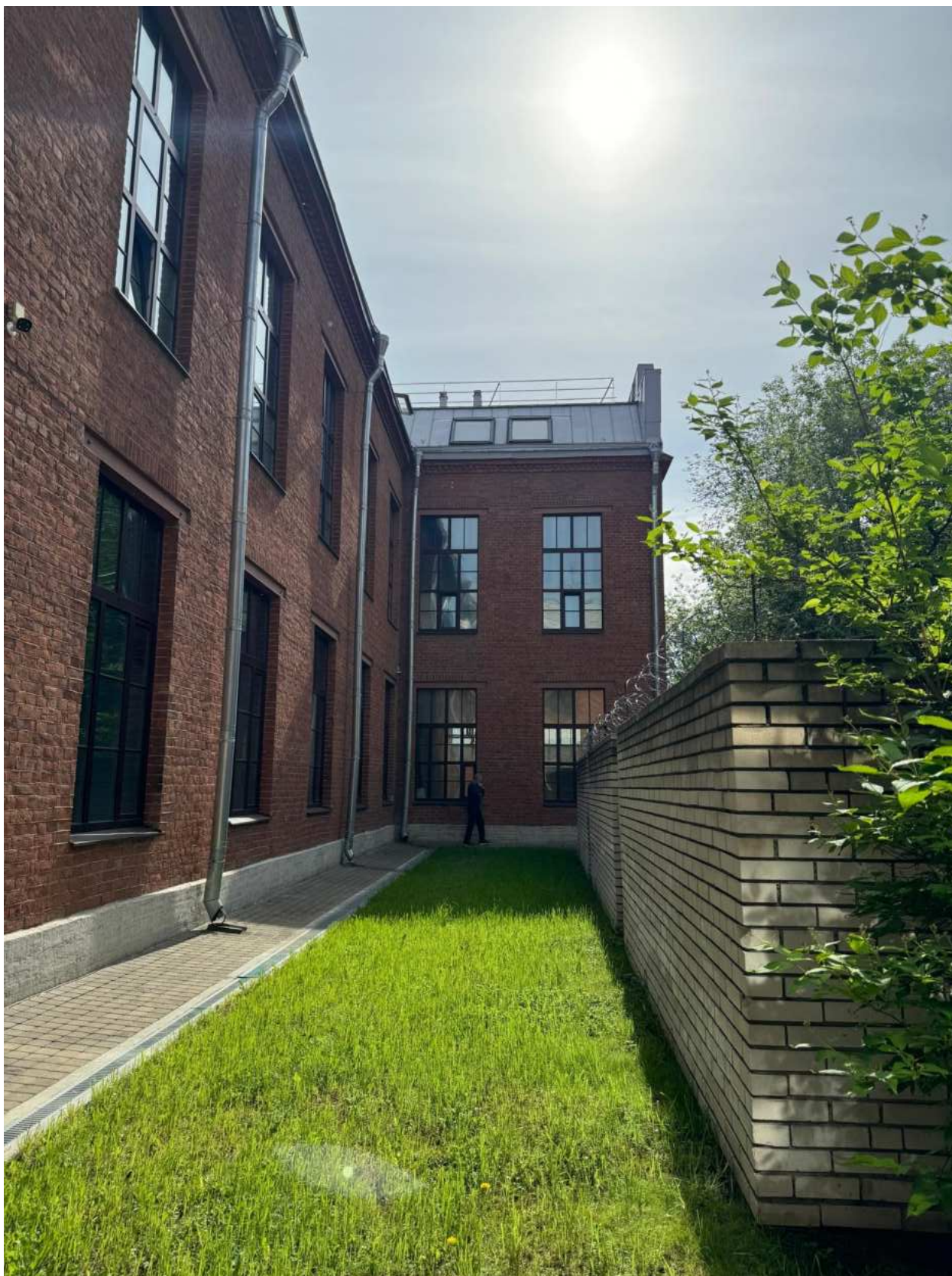
Фото 22. Общий вид дворовых фасадов объекта культурного наследия.
