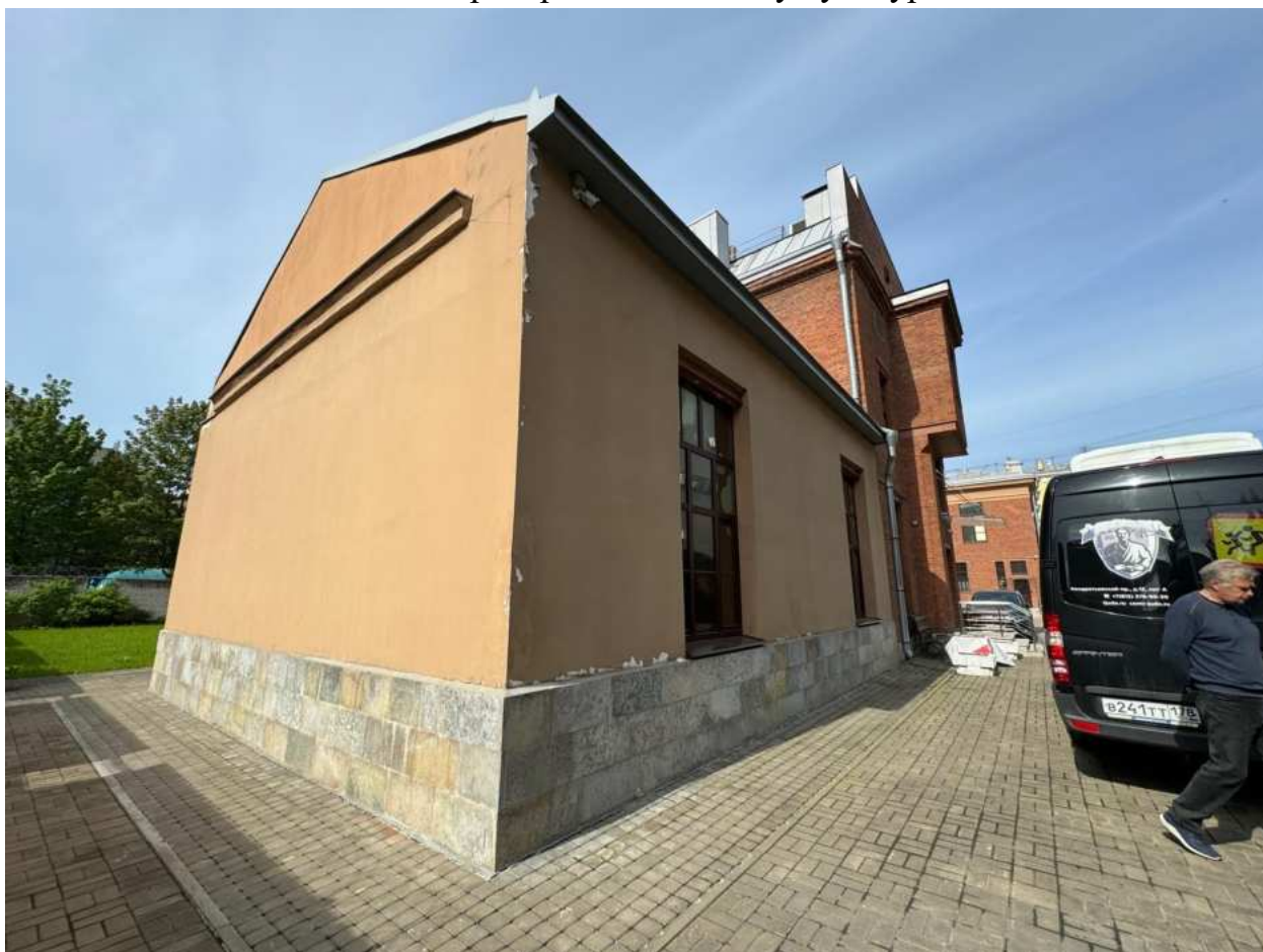
Фото 14. Общий вид пристройки к объекту культурного наследия.
