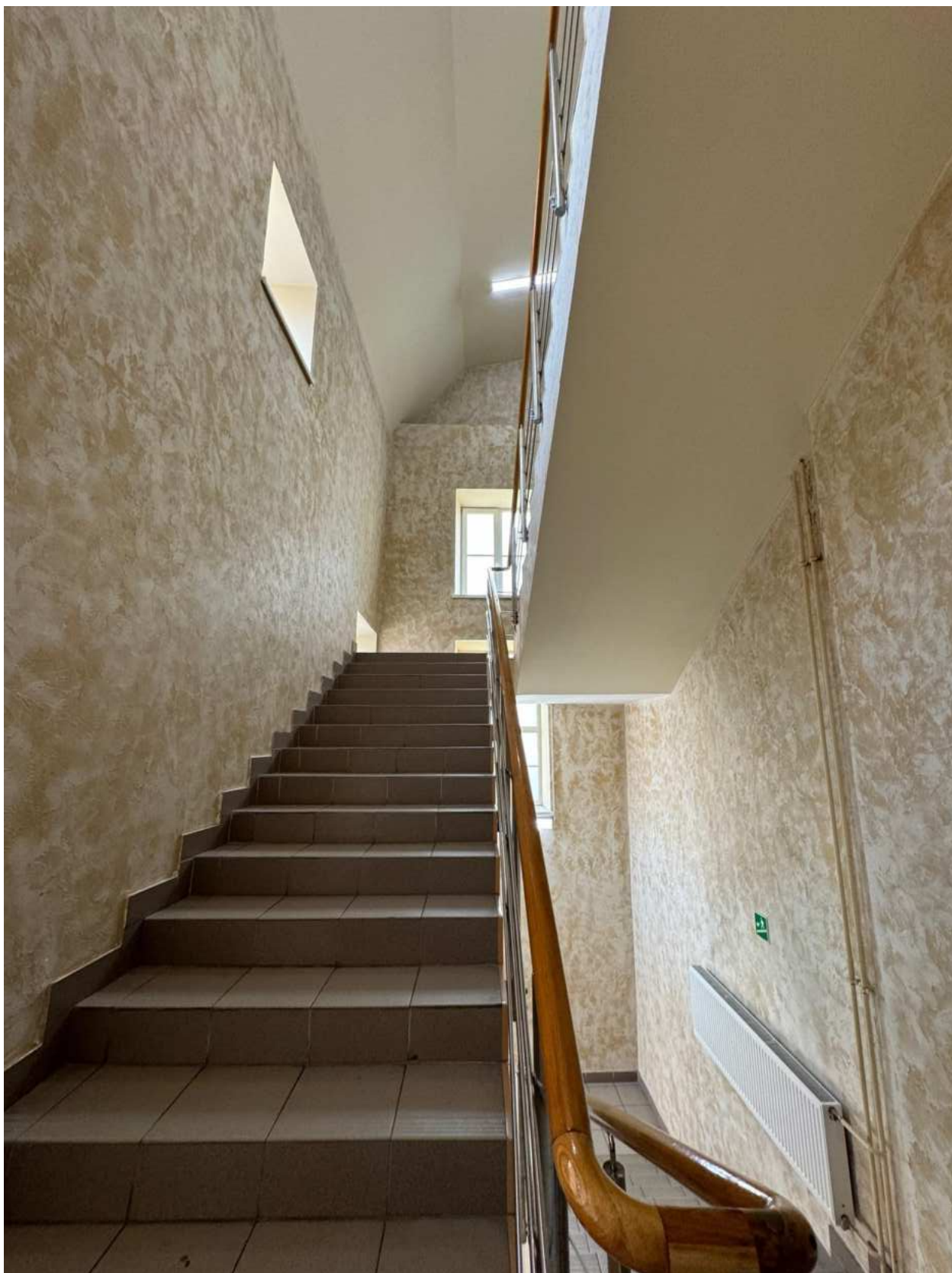
Фото 30. Вид на интерьер северо- восточной лестницы объекта культурного наследия.
