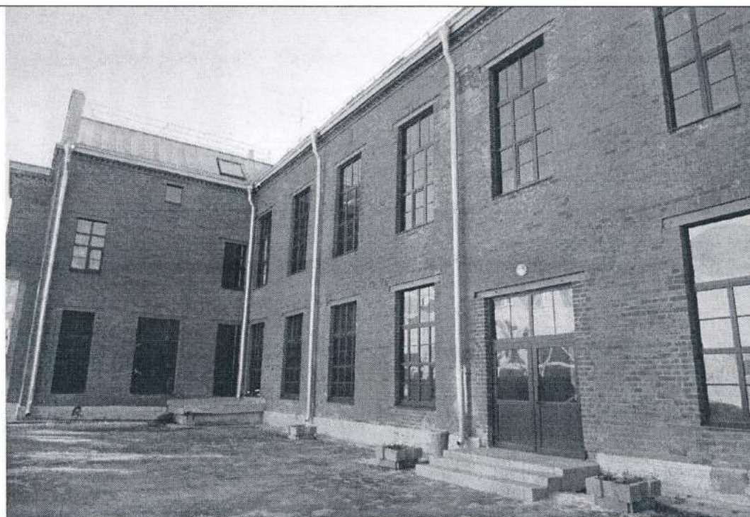
Северный фасад и южный фасад дворовых корпусов. Съёмка 21.03.2012, В.А. Матвеева.
