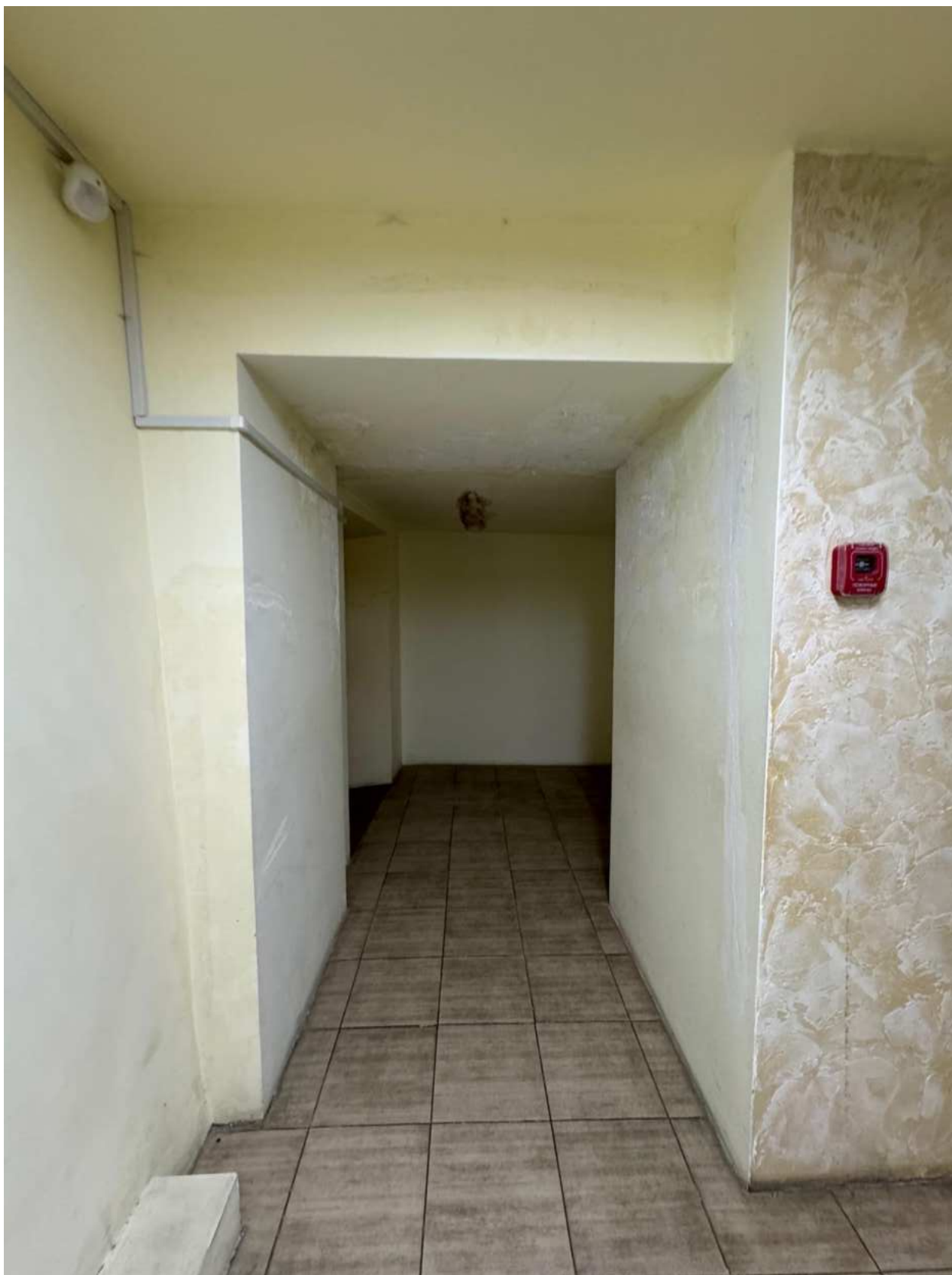
Фото 36. Вид на интерьер подвальных помещений объекта культурного наследия.
