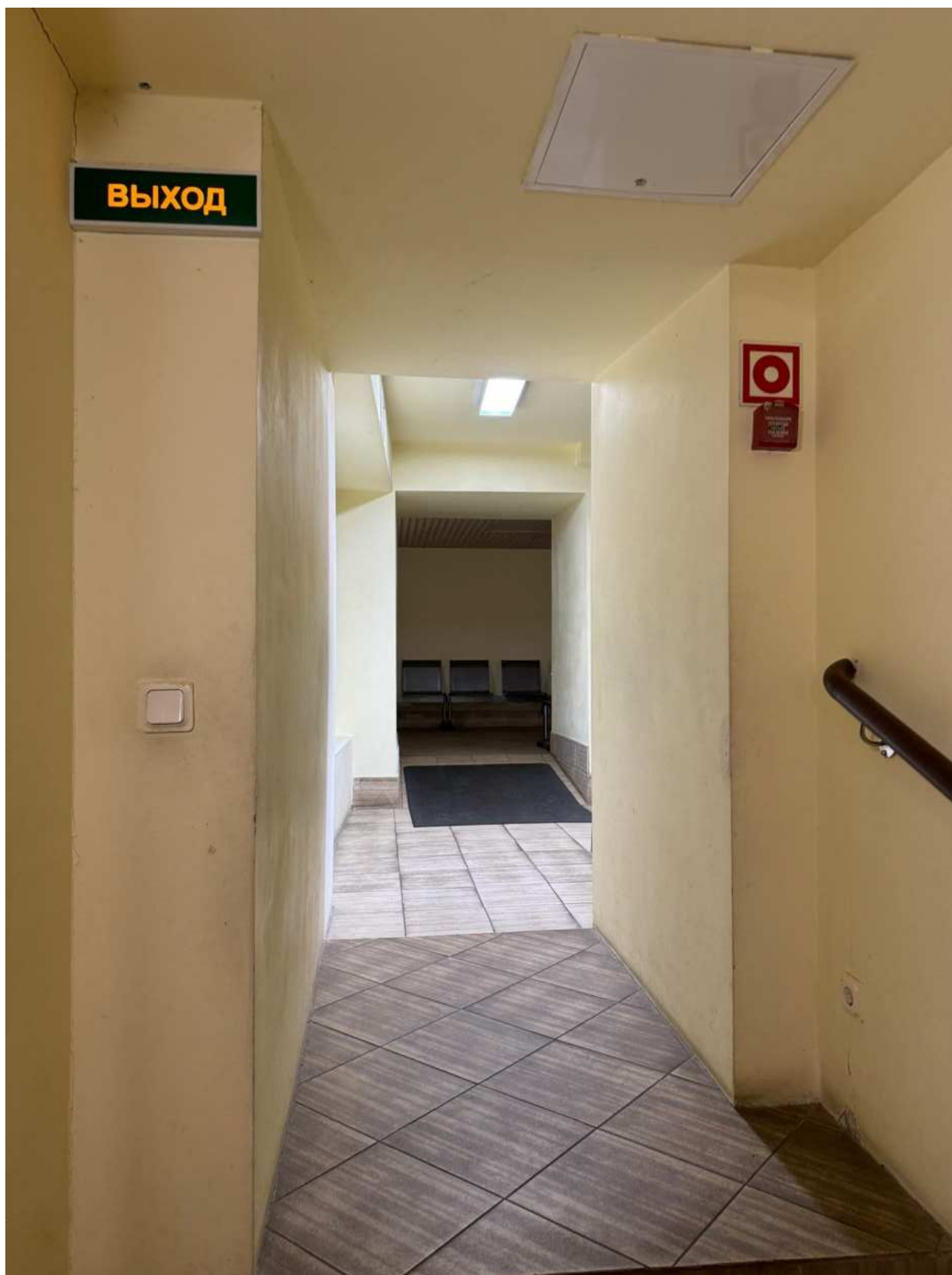
Фото 39. Вид на интерьер подвальных помещений объекта культурного наследия.
