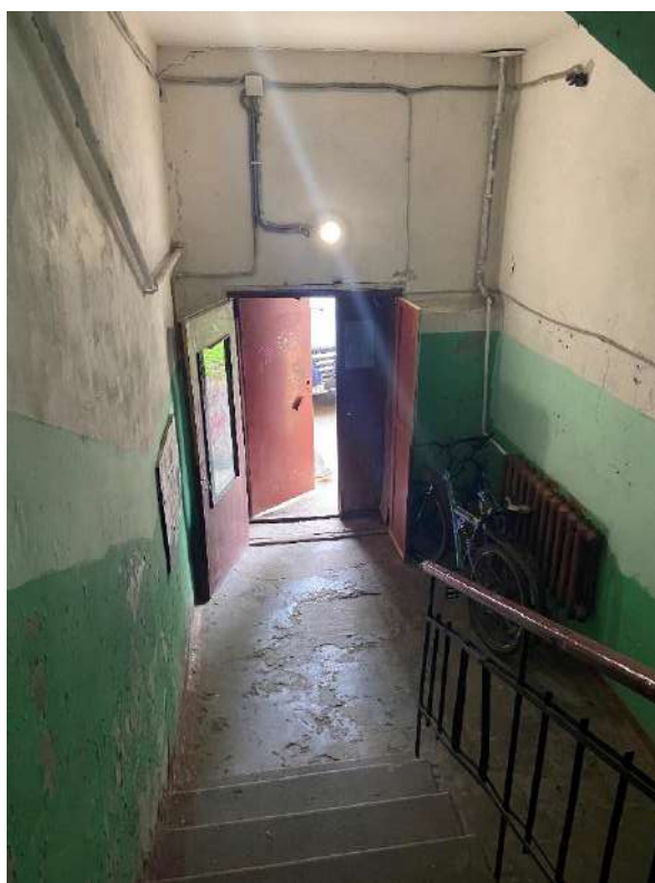
Фото 18. Вид на лестницу 2.
