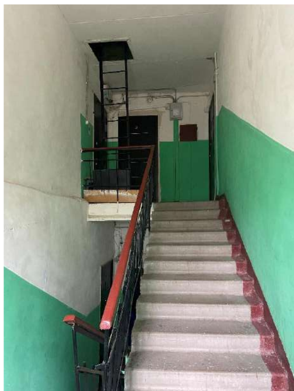
Фото 17. Вид на лестницу 2.
