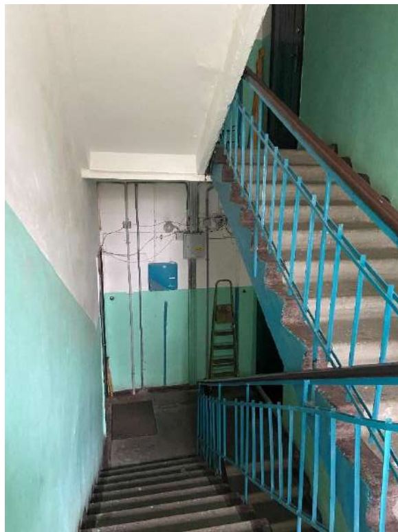
Фото 10. Вид на лестницу 1.
