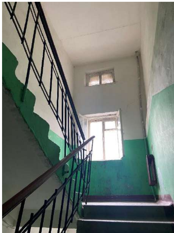
Фото 16. Вид на лестницу 2.
