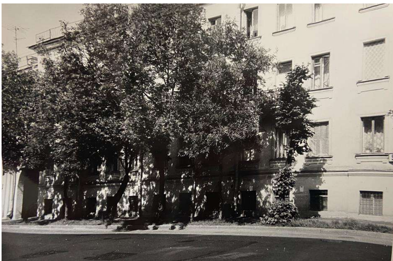
Илл. 12. Вид на дом № 9 по Гражданской ул. Дата: 1990 г. Источник: архив КГИОП.
