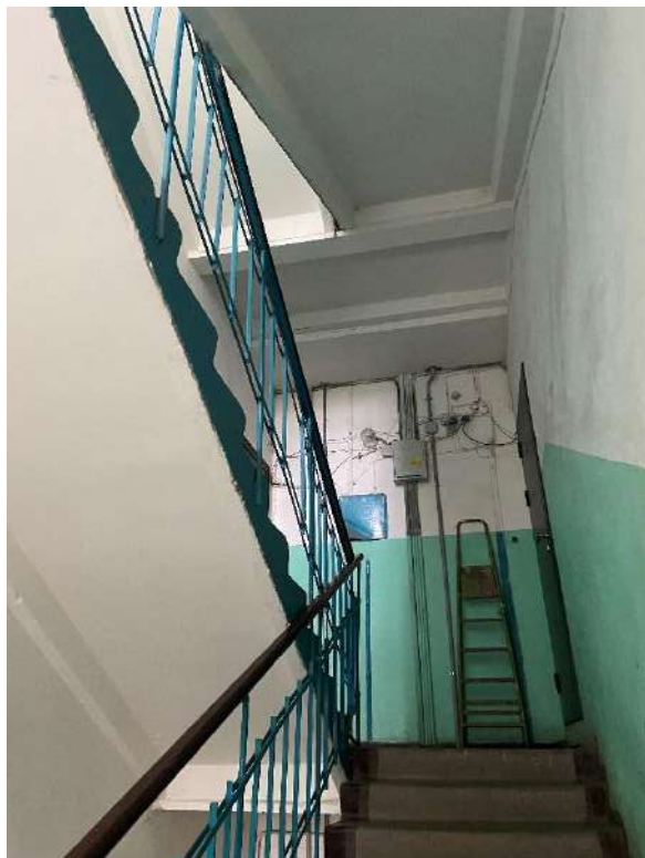
Фото 9. Вид на лестницу 1.
