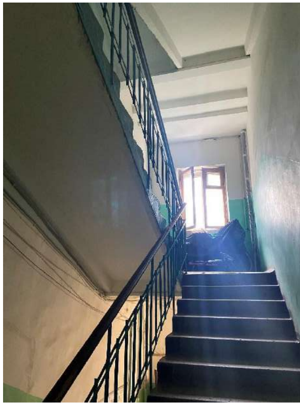
Фото 8. Вид на лестницу 1.
