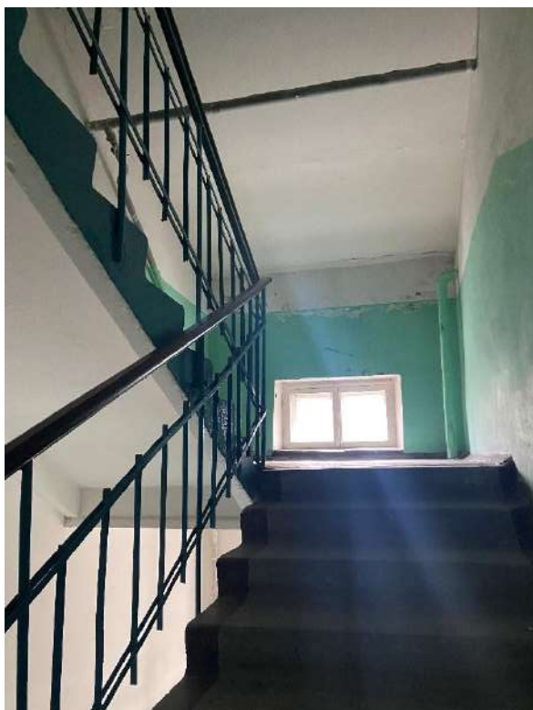
Фото 11. Вид на лестницу 1.
