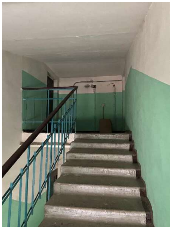
Фото 12. Вид на лестницу 1.
