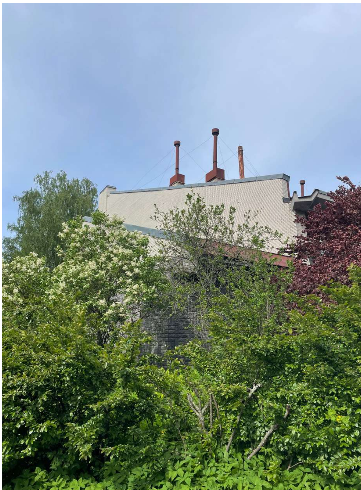
9. Юго-западный угол здания
