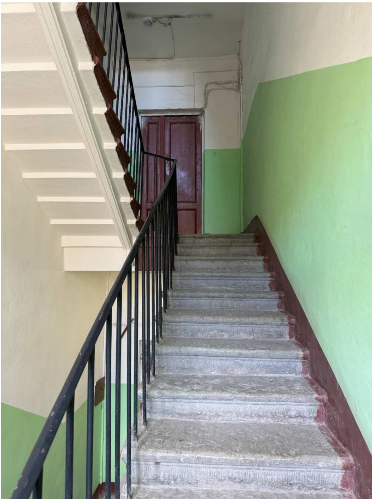
Фото 16. Помещение лестницы 3-ЛК объекта культурного наследия.
