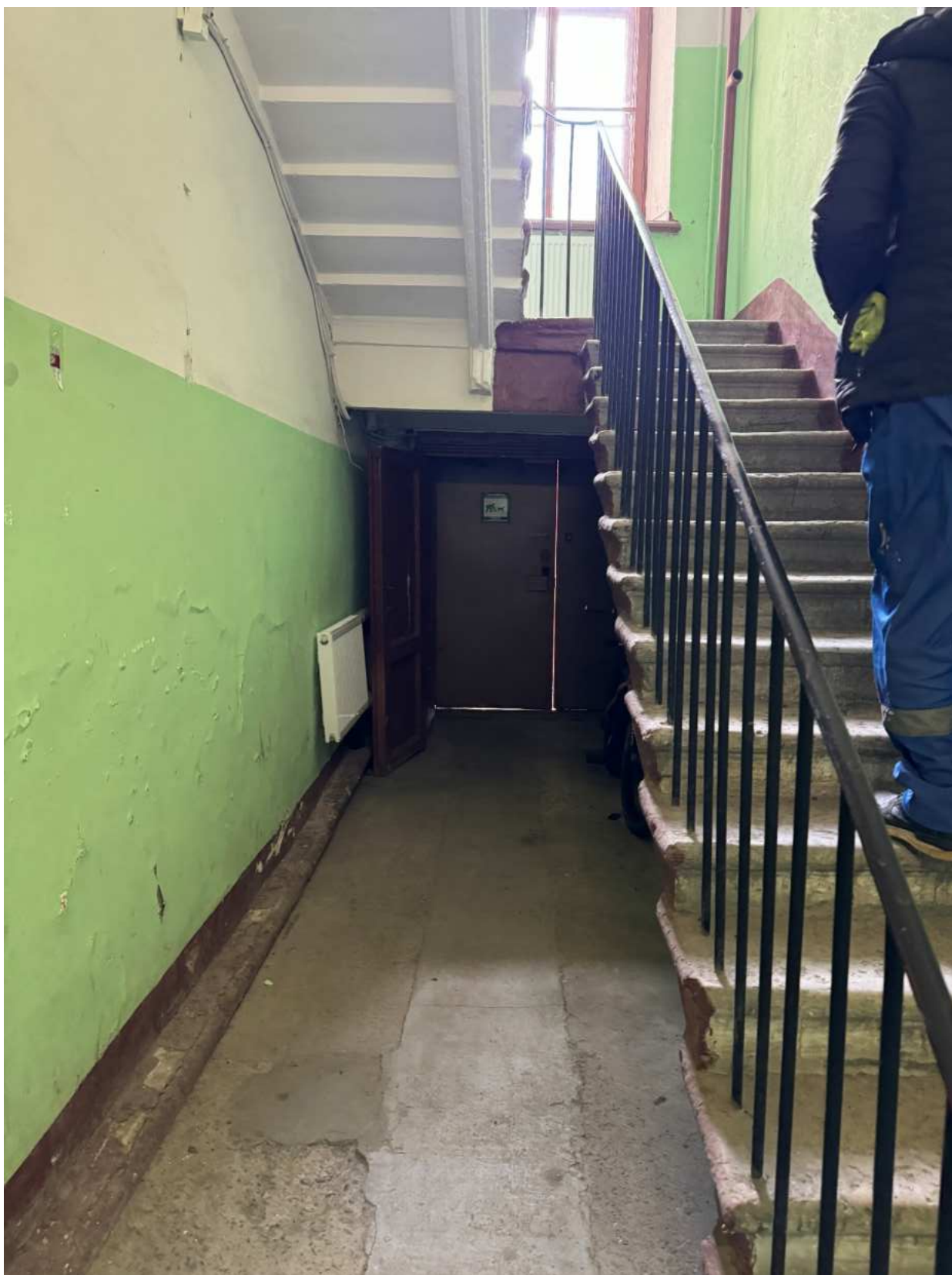
Фото 10. Помещение лестницы 3-ЛК объекта культурного наследия.
