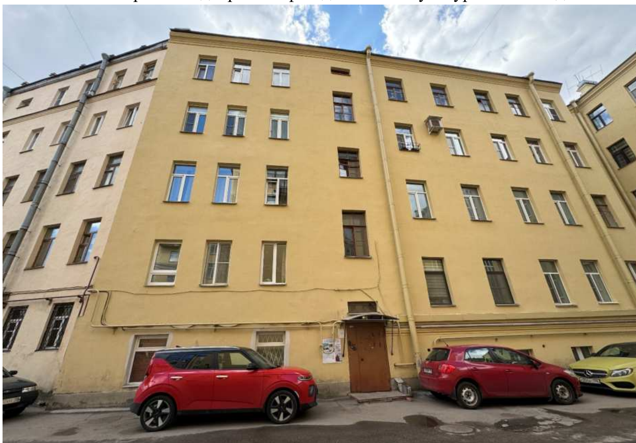
Фото 6. Фрагмент дворового фасада объекта культурного наследия.
