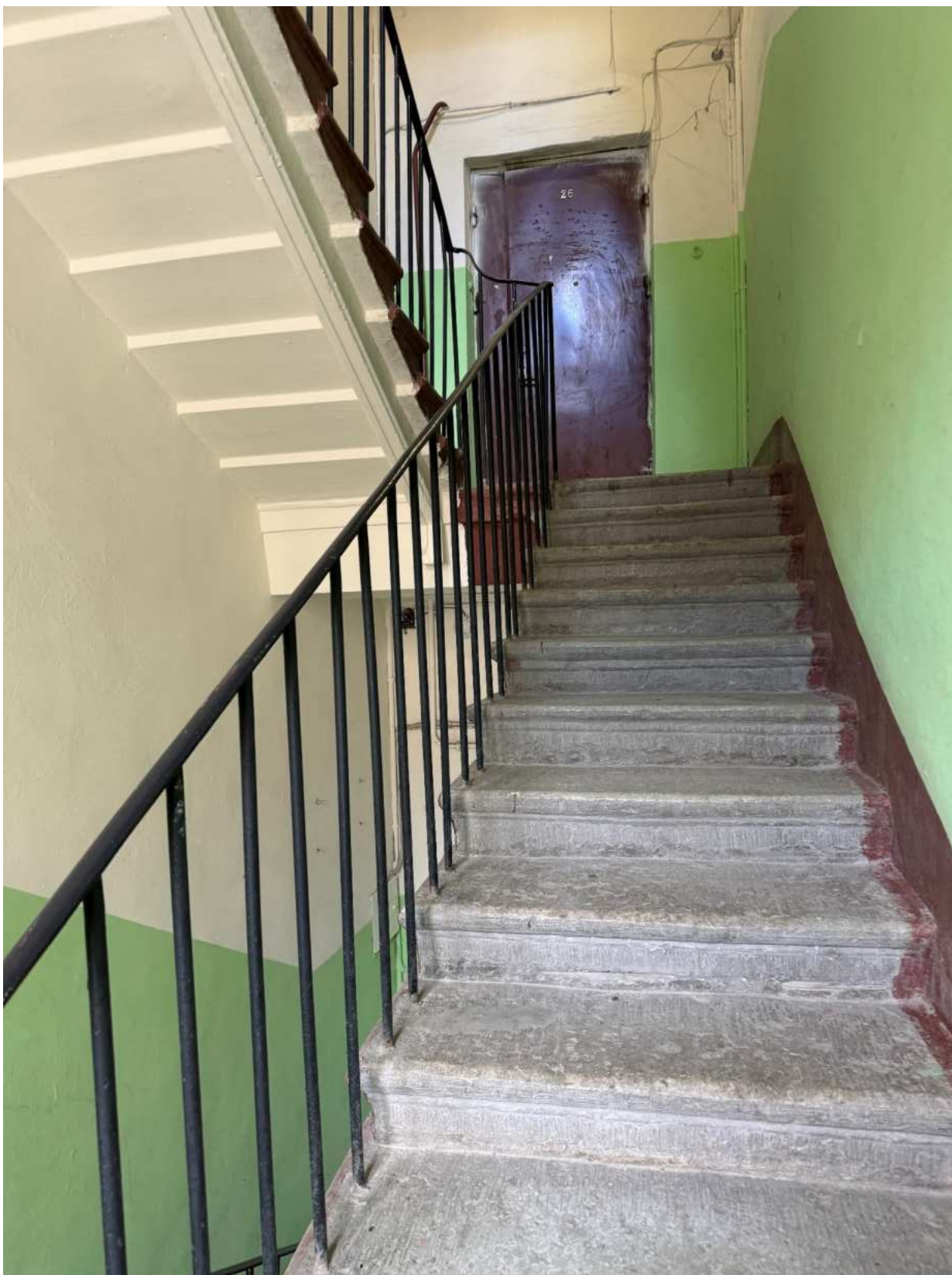
Фото 14. Помещение лестницы 3-ЛК объекта культурного наследия.
