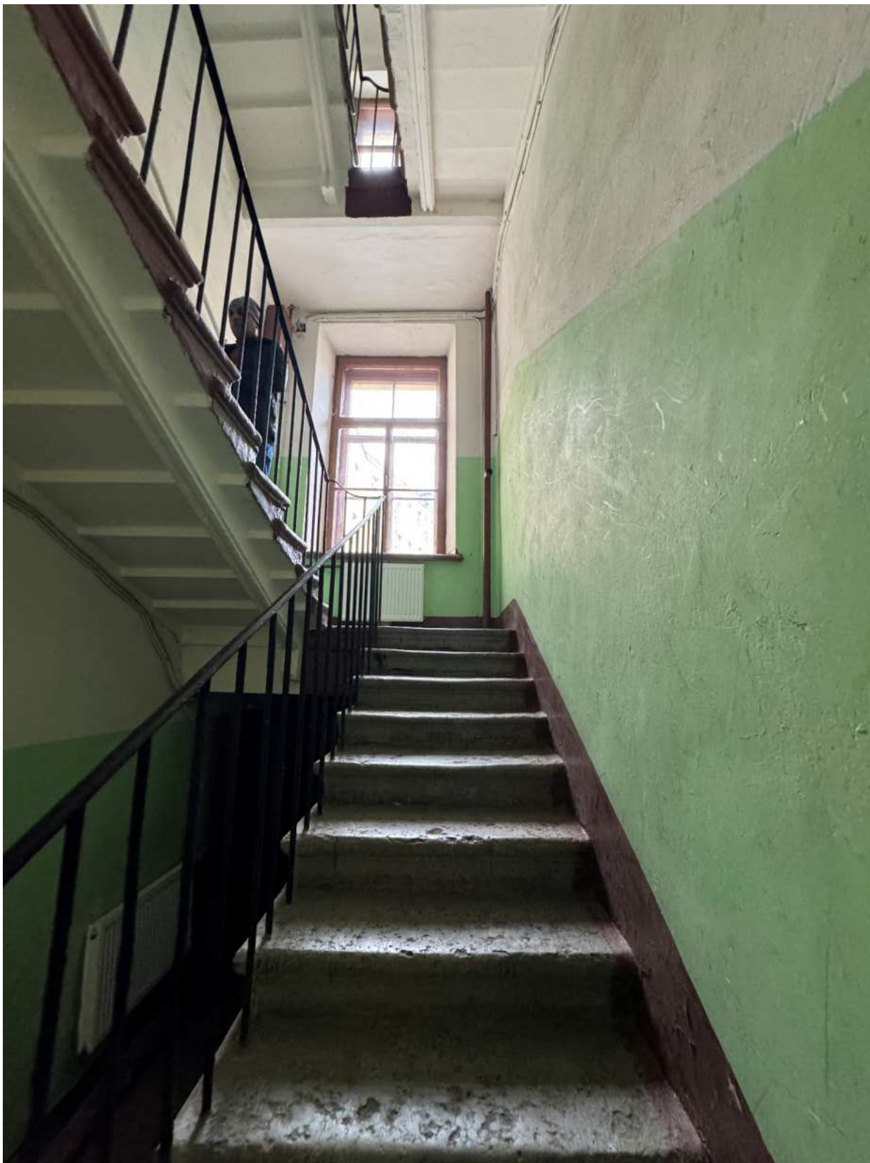
Фото 11. Помещение лестницы 3-ЛК объекта культурного наследия.
