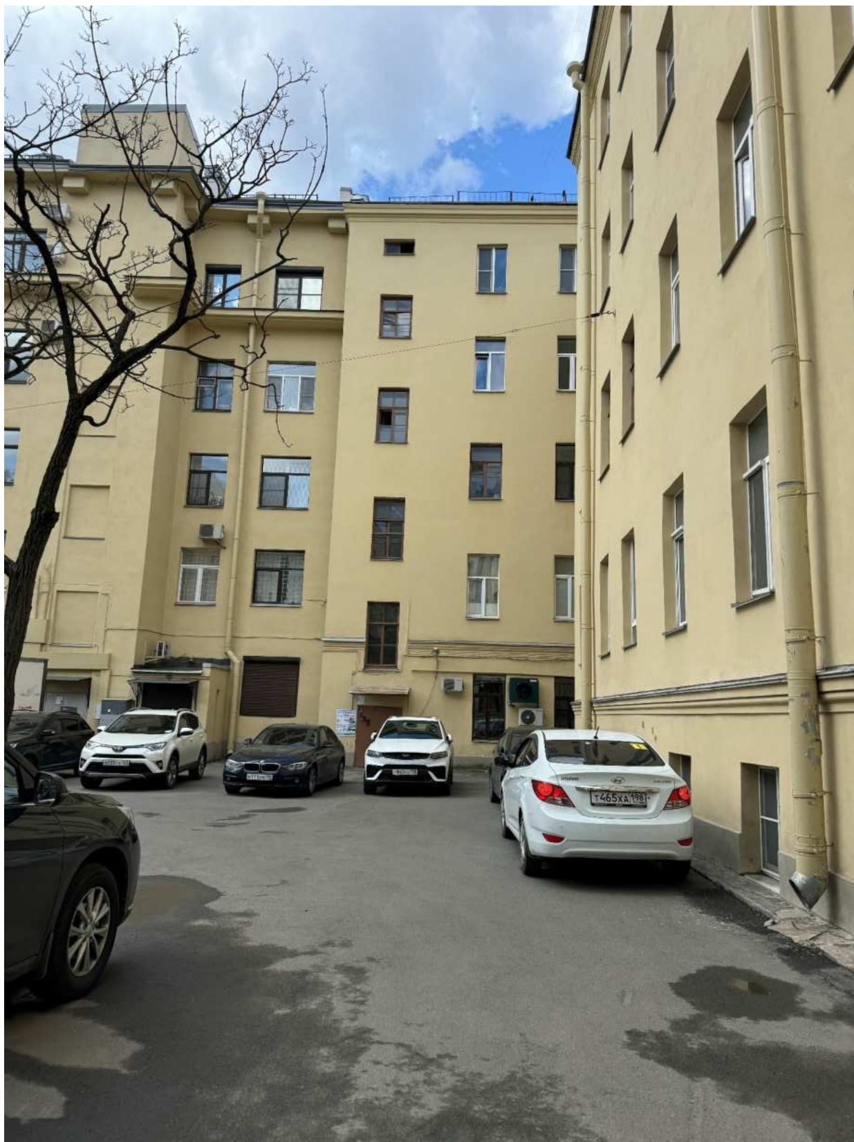
Фото 8. Фрагмент дворовых фасадов объекта культурного наследия.
