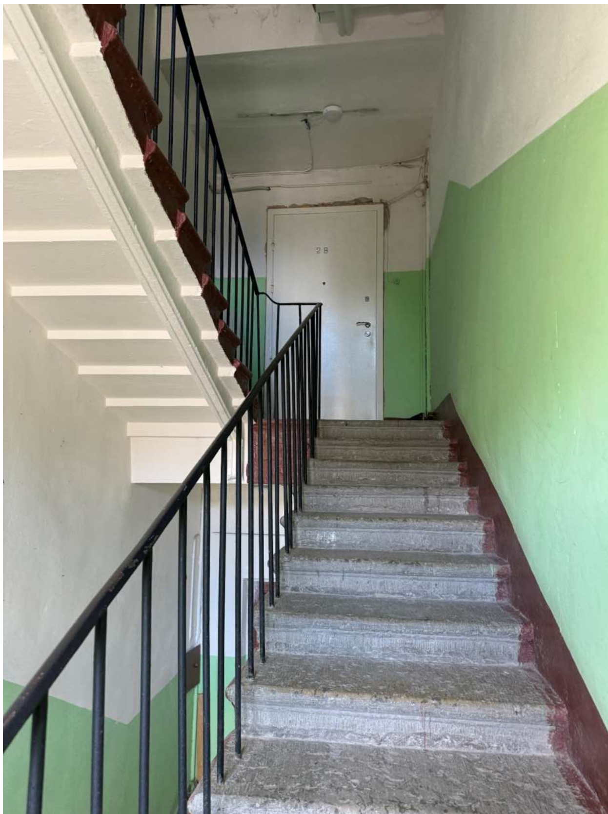
Фото 18. Помещение лестницы 3-ЛК объекта культурного наследия.
