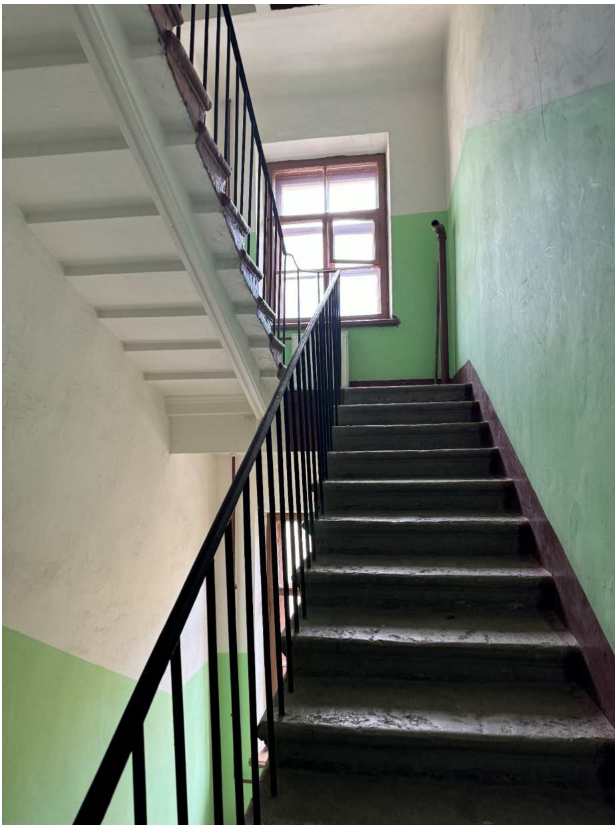
Фото 17. Помещение лестницы 3-ЛК объекта культурного наследия.
