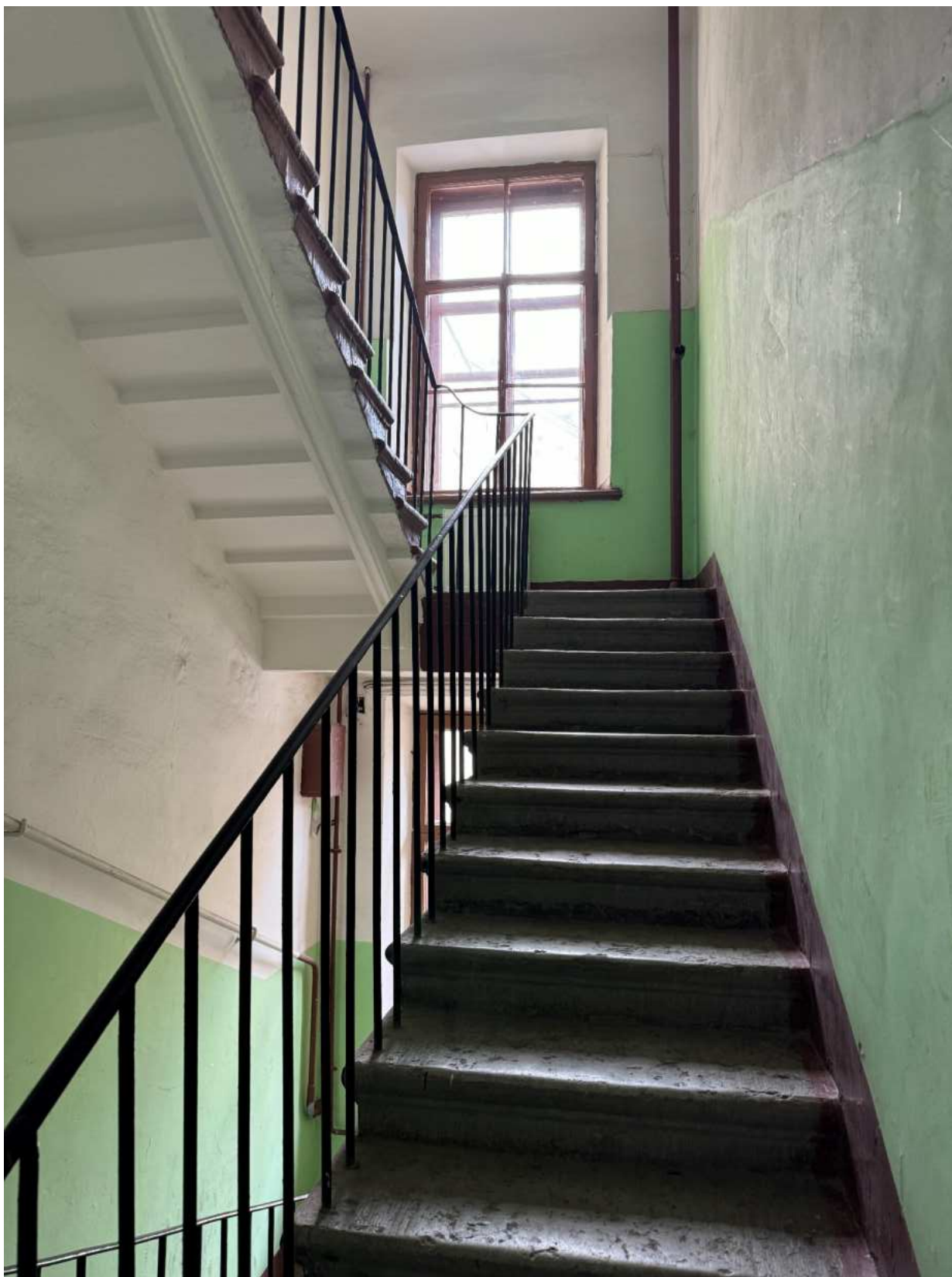
Фото 13. Помещение лестницы 3-ЛК объекта культурного наследия.
