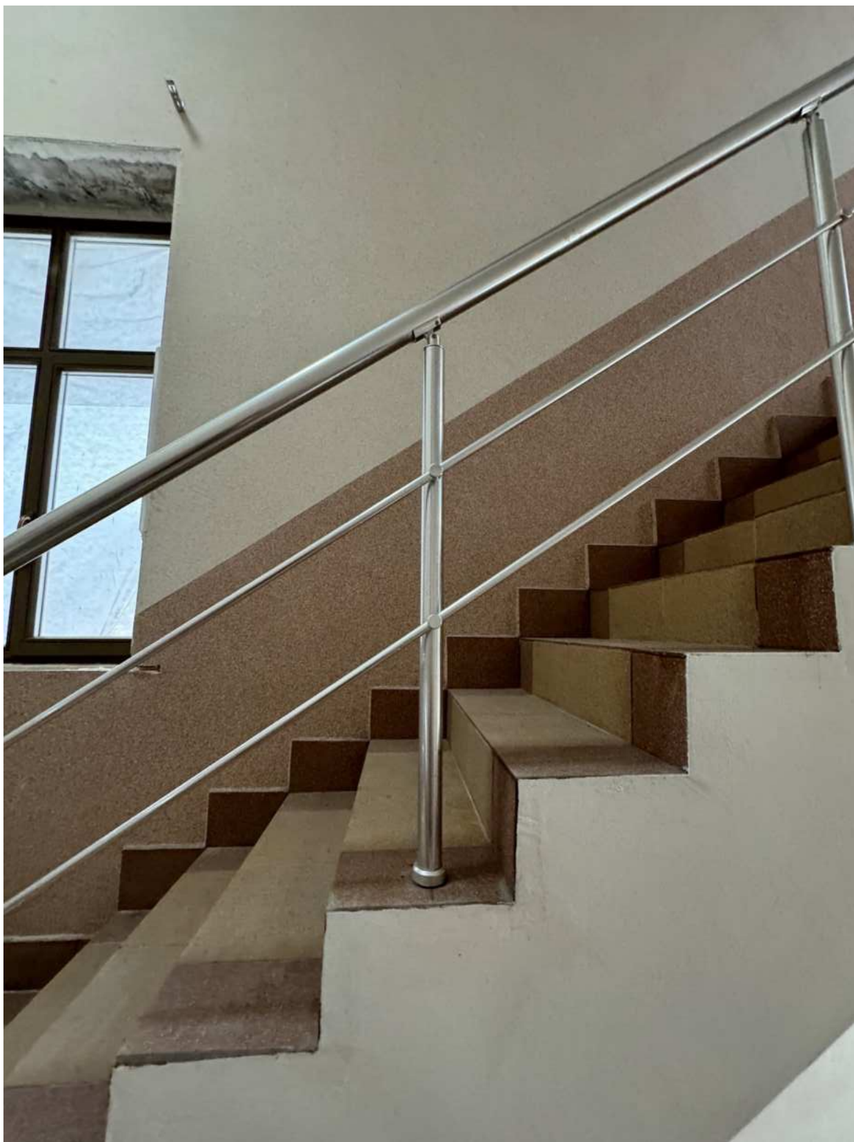
Фото 30. Вид на ограждение лестницы 1-ЛК.
