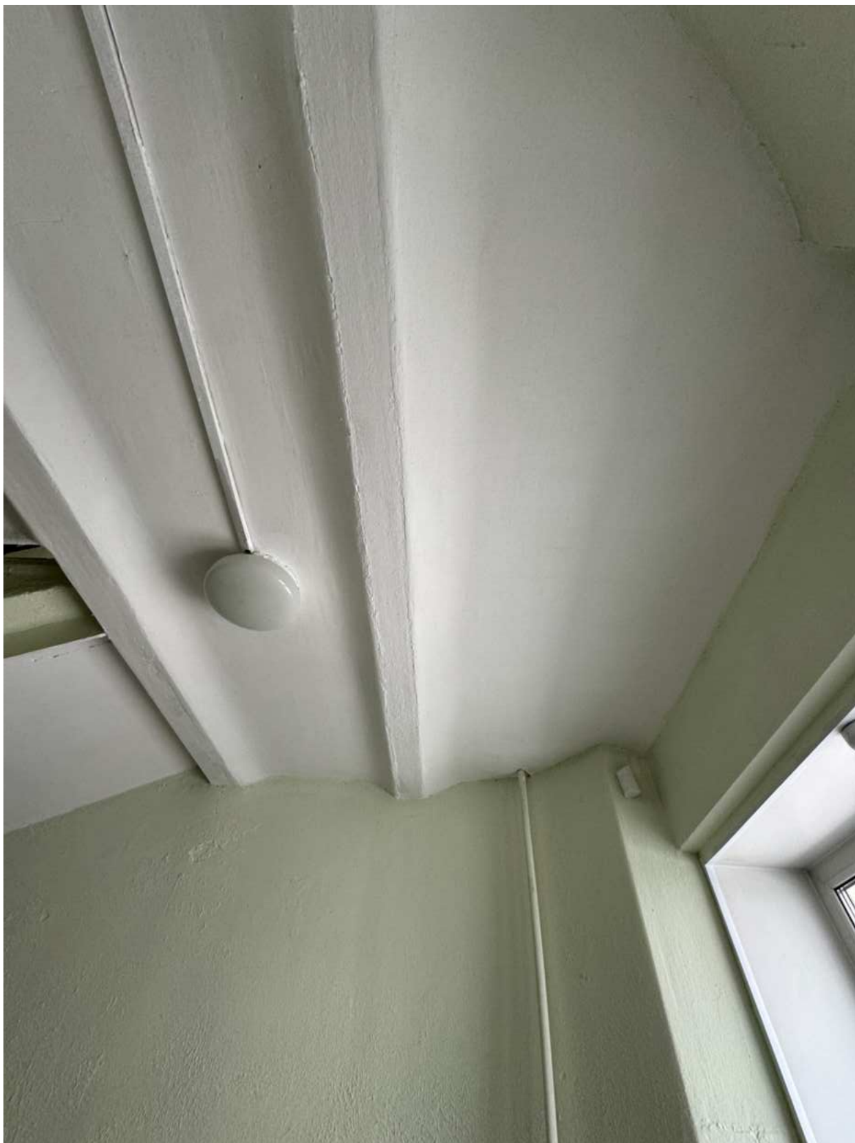
Фото 42. Вид на своды площадок лестницы 2-ЛК.
