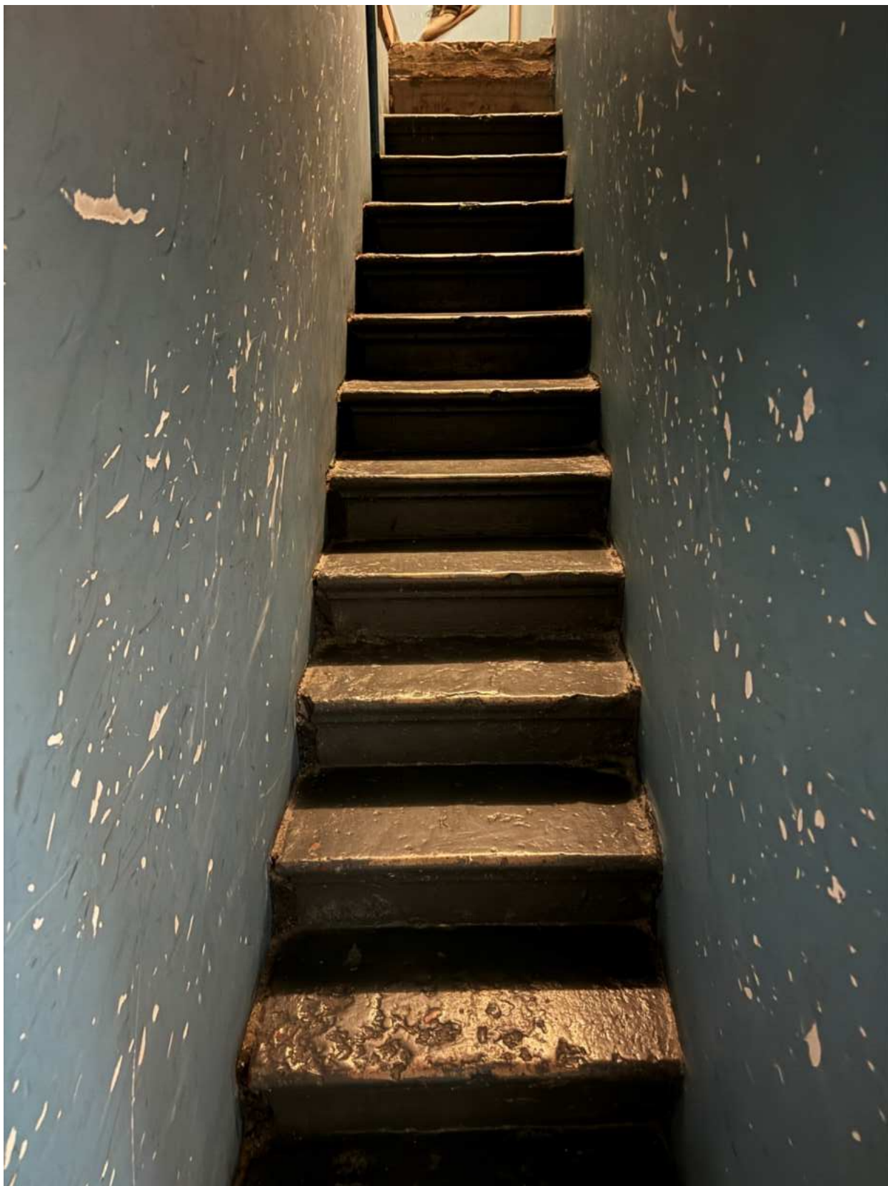
Фото 34. Вид на лестницу, ведущую на чердак.
