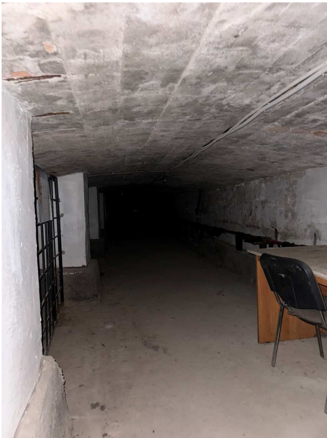
Фото 56. Вид на подвальные помещения.
