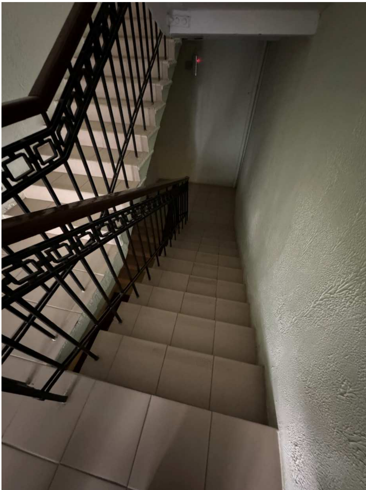
Фото 45. Вид на интерьер лестницы 2-ЛК.
