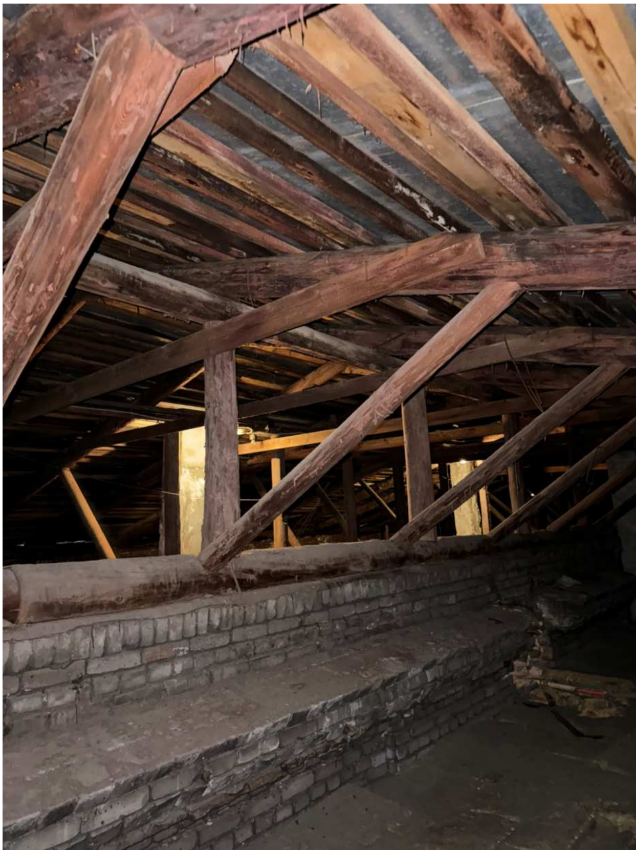
Фото 38. Вид на чердачные помещения.
