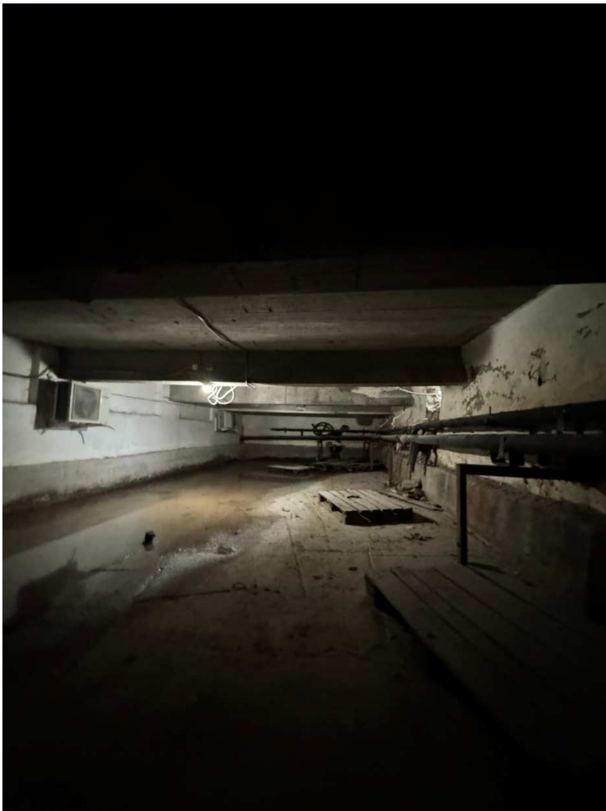
Фото 52. Вид на подвальные помещения.
