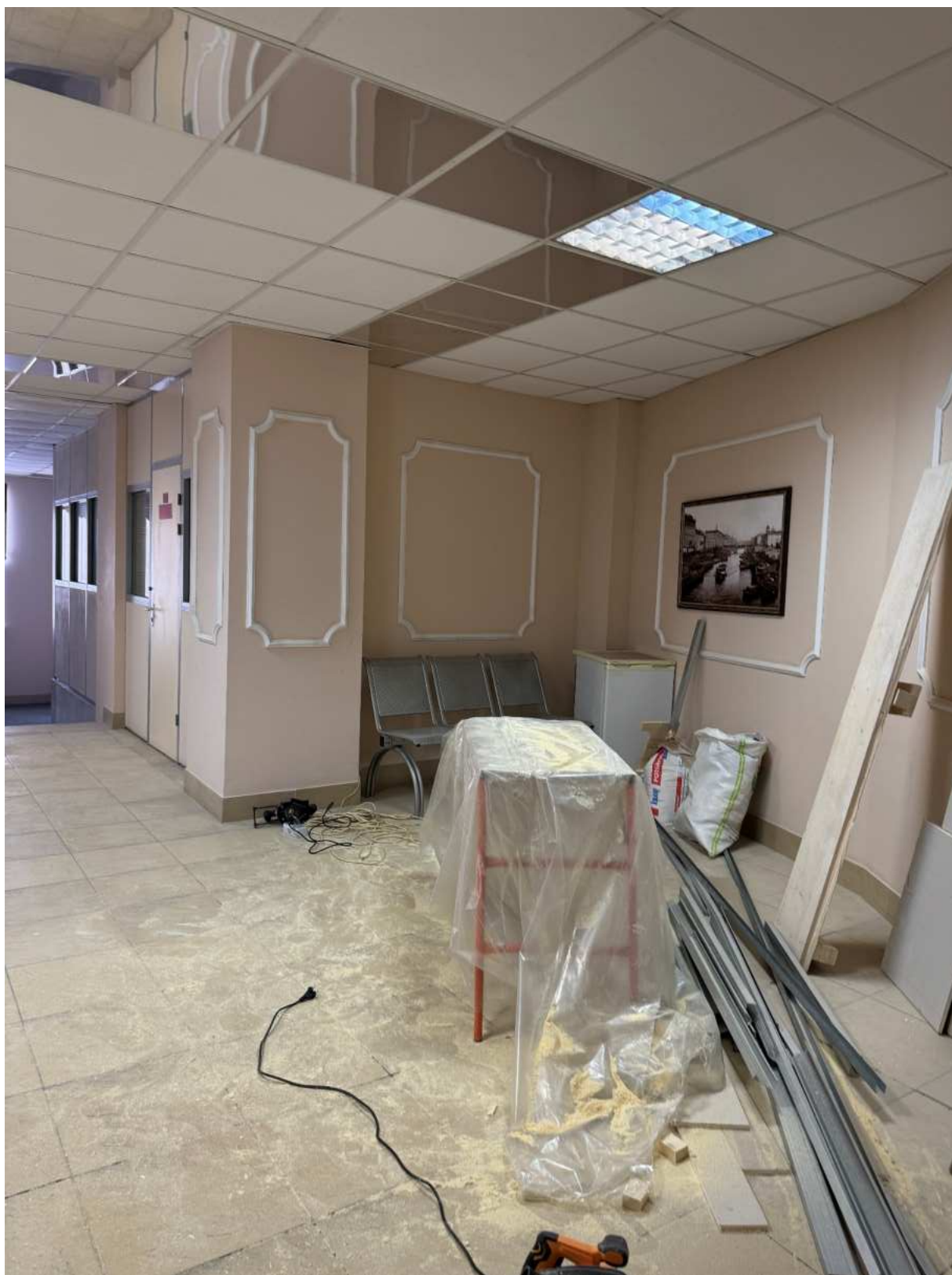
Фото 100. Вид на интерьер холла лестницы 3-ЛК.
