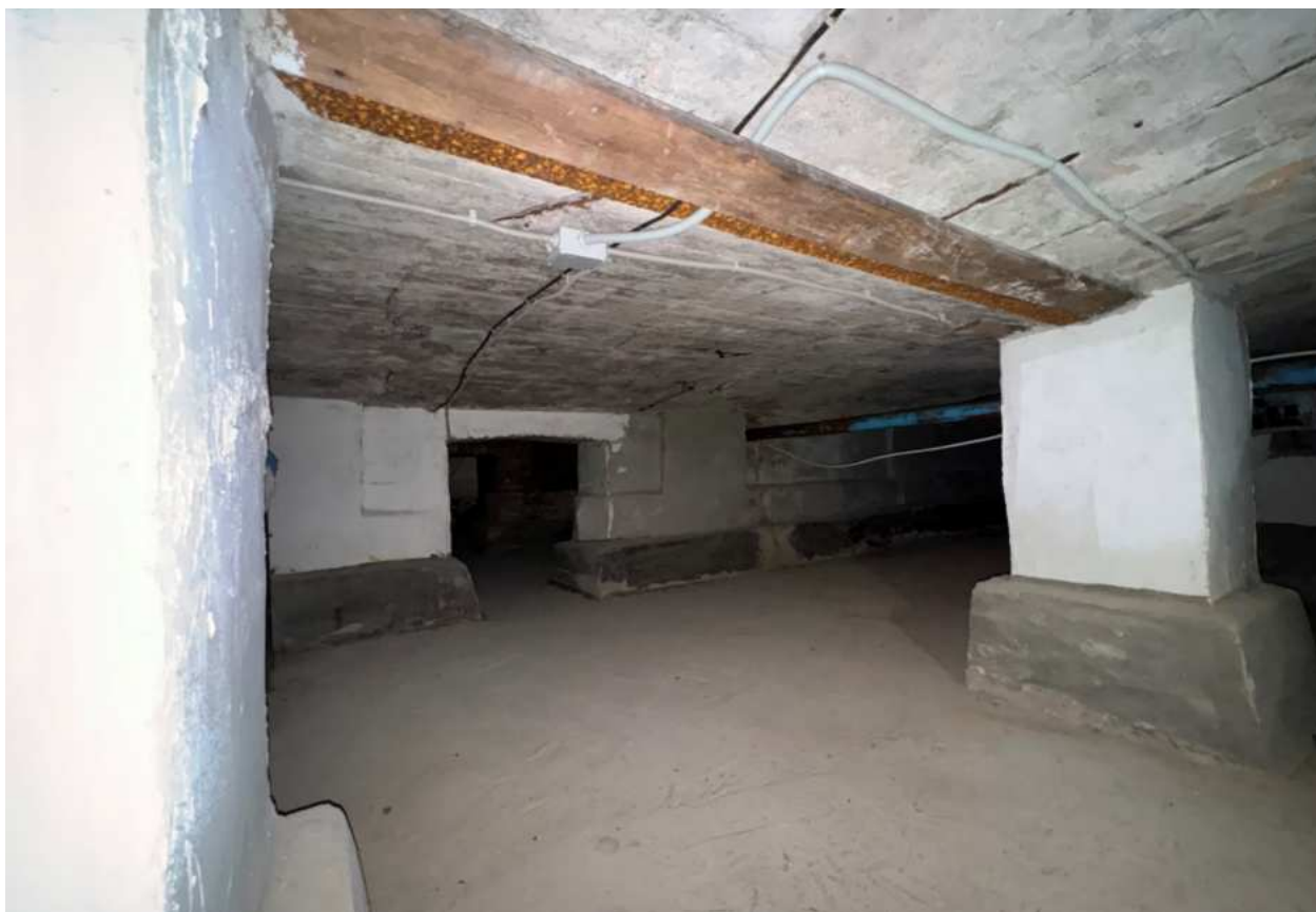
Фото 59. Вид на подвальные помещения.
