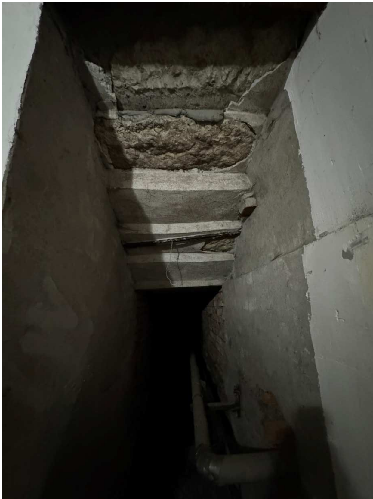
Фото 49. Вид на конструкцию лестницы, ведущей в подвал.
