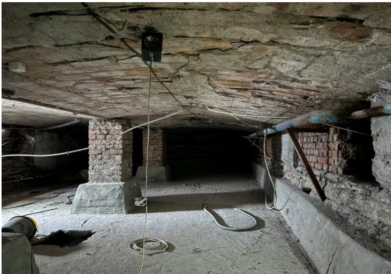
Фото 62. Вид на подвальные помещения.
