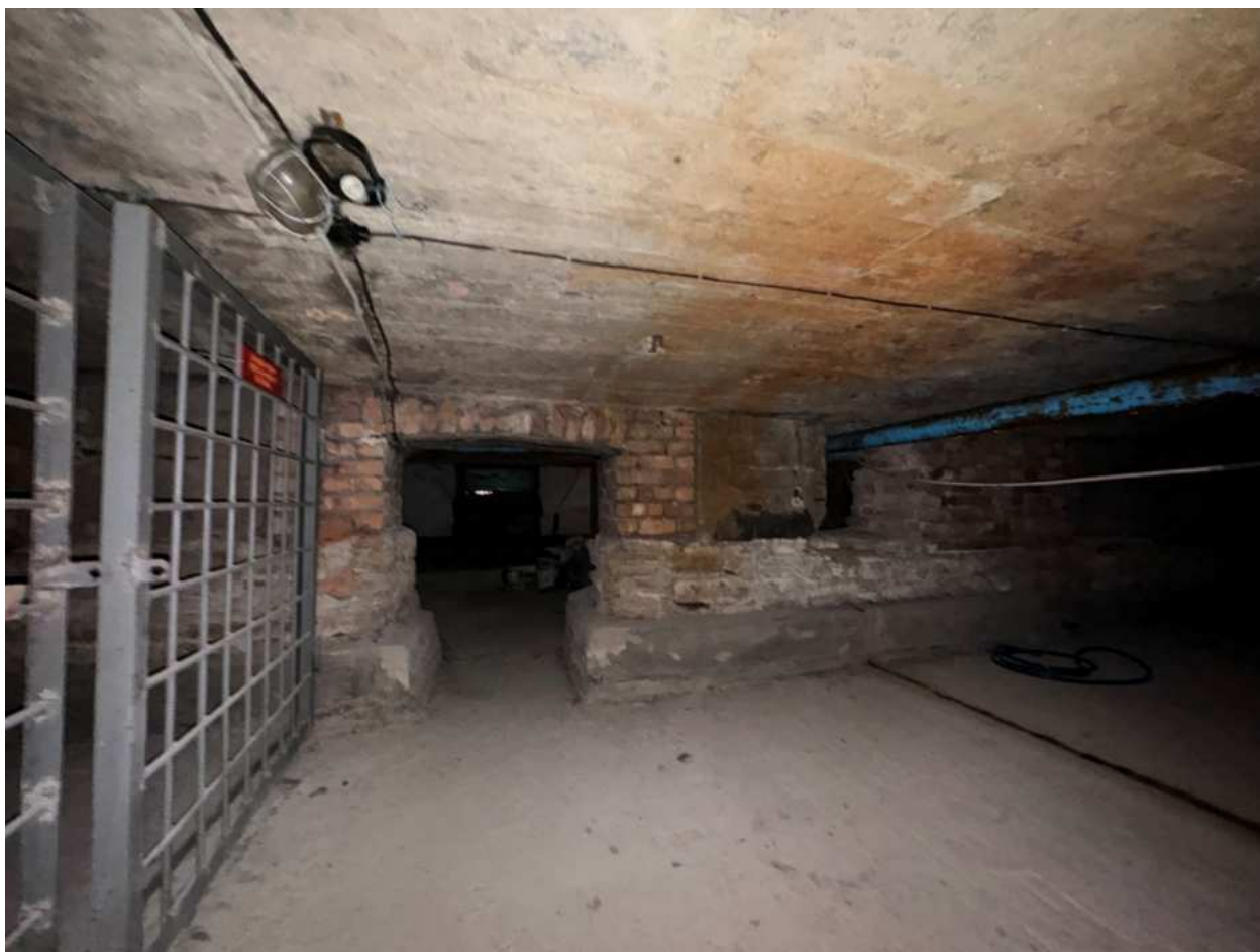
Фото 60. Вид на подвальные помещения.
