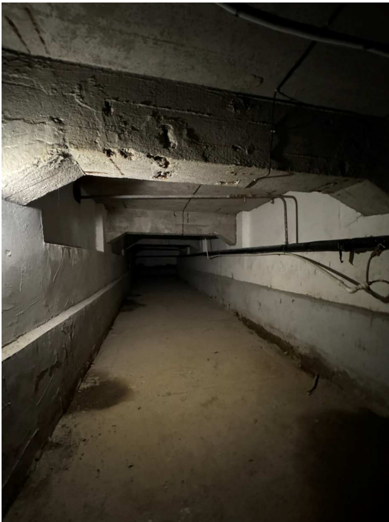
Фото 51. Вид на подвальные помещения.
