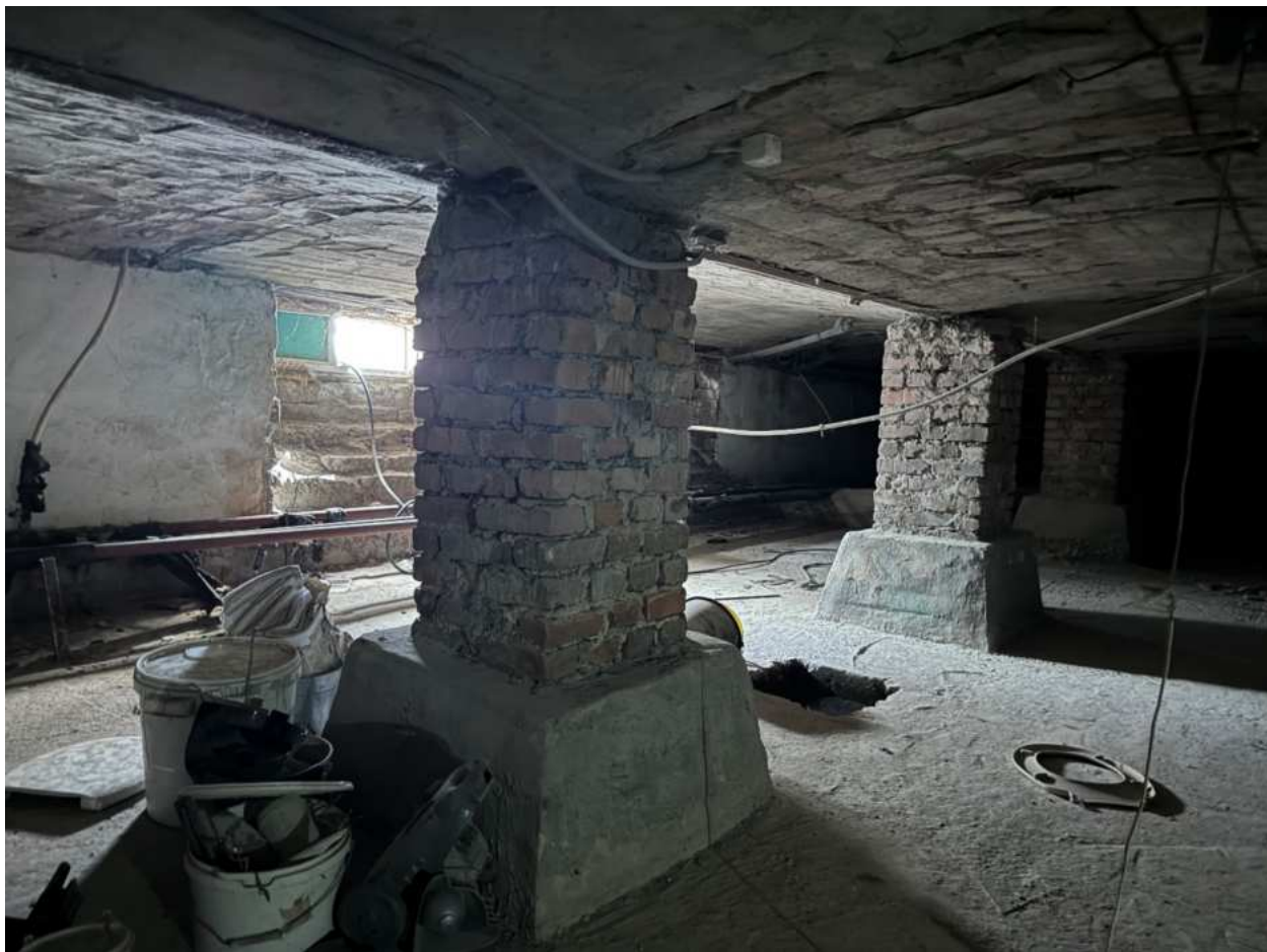
Фото 61. Вид на подвальные помещения.
