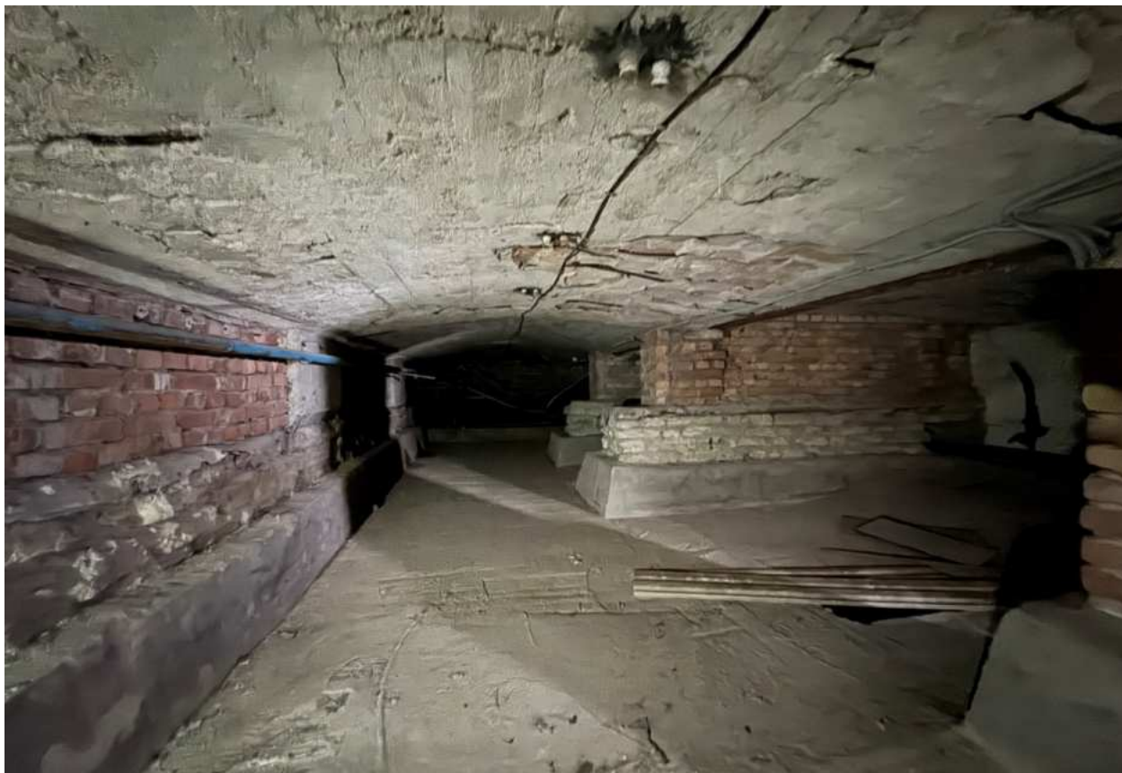
Фото 63. Вид на подвальные помещения.
