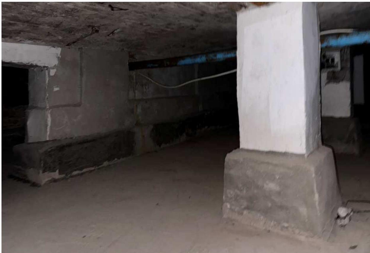
Фото 57. Вид на подвальные помещения.
