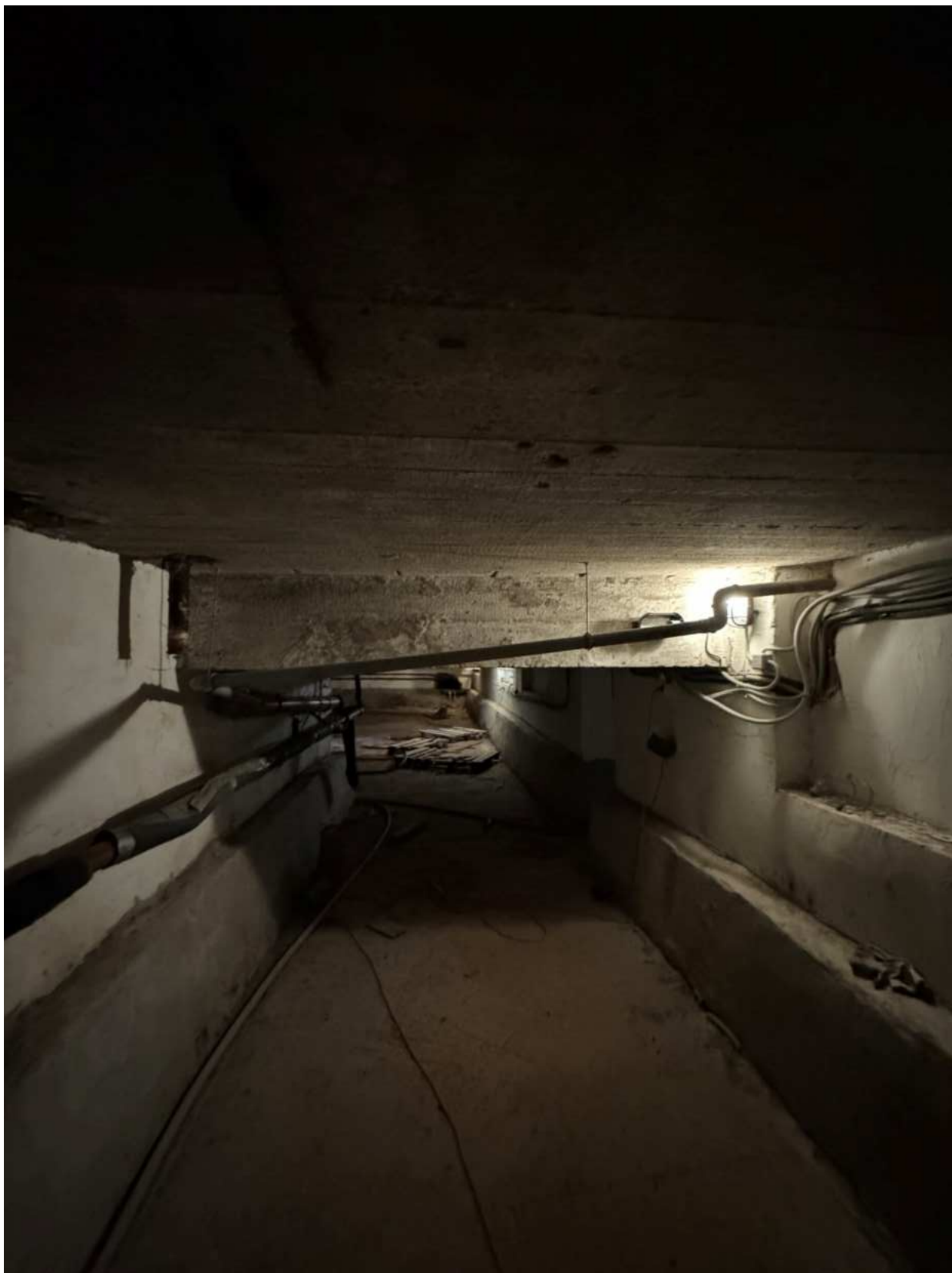
Фото 50. Вид на подвальные помещения.
