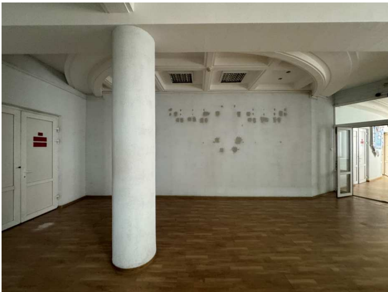
Фото 107. Вид на интерьер холла лестницы 3-ЛК.
