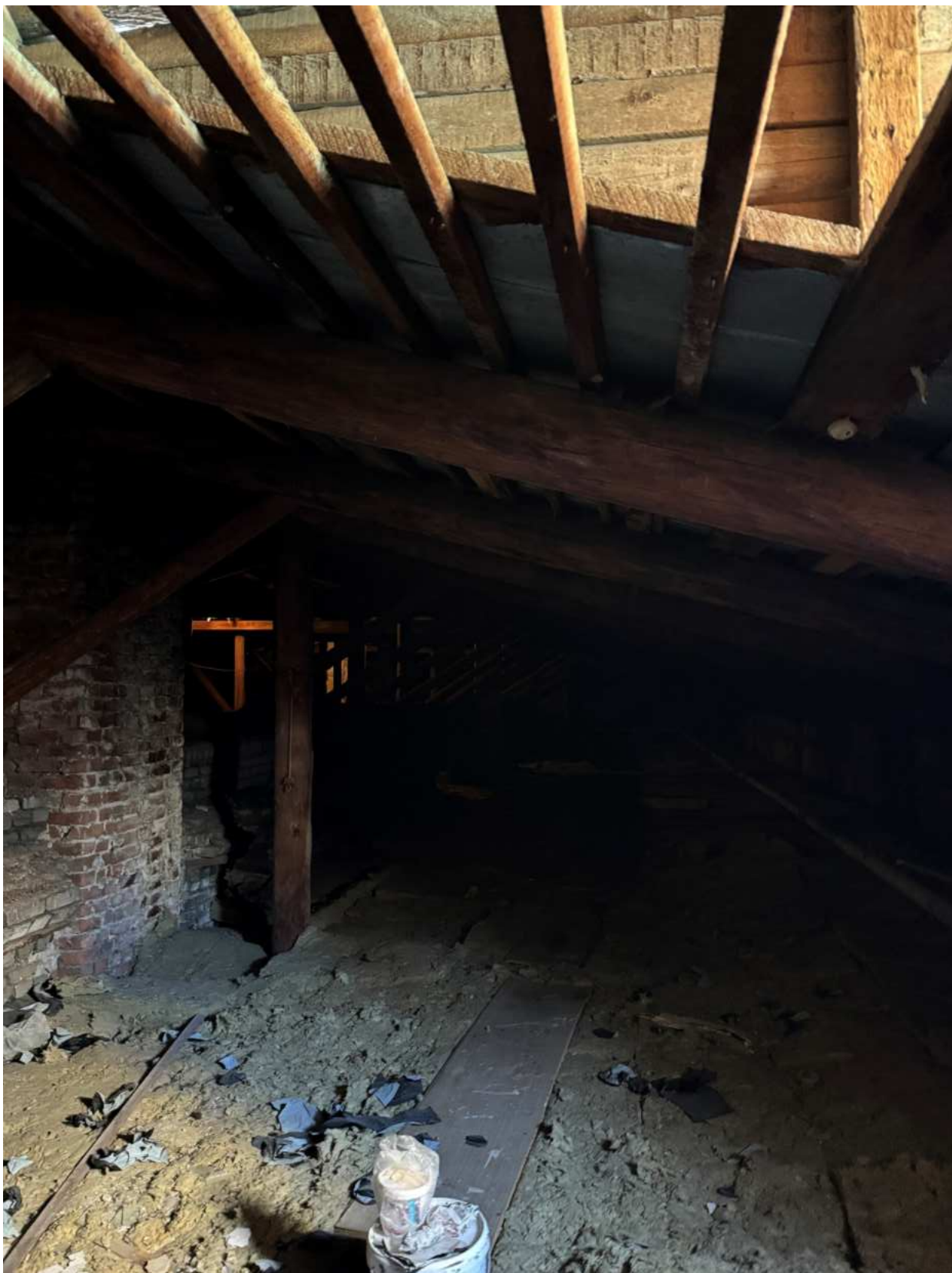
Фото 35. Вид на чердачные помещения.
