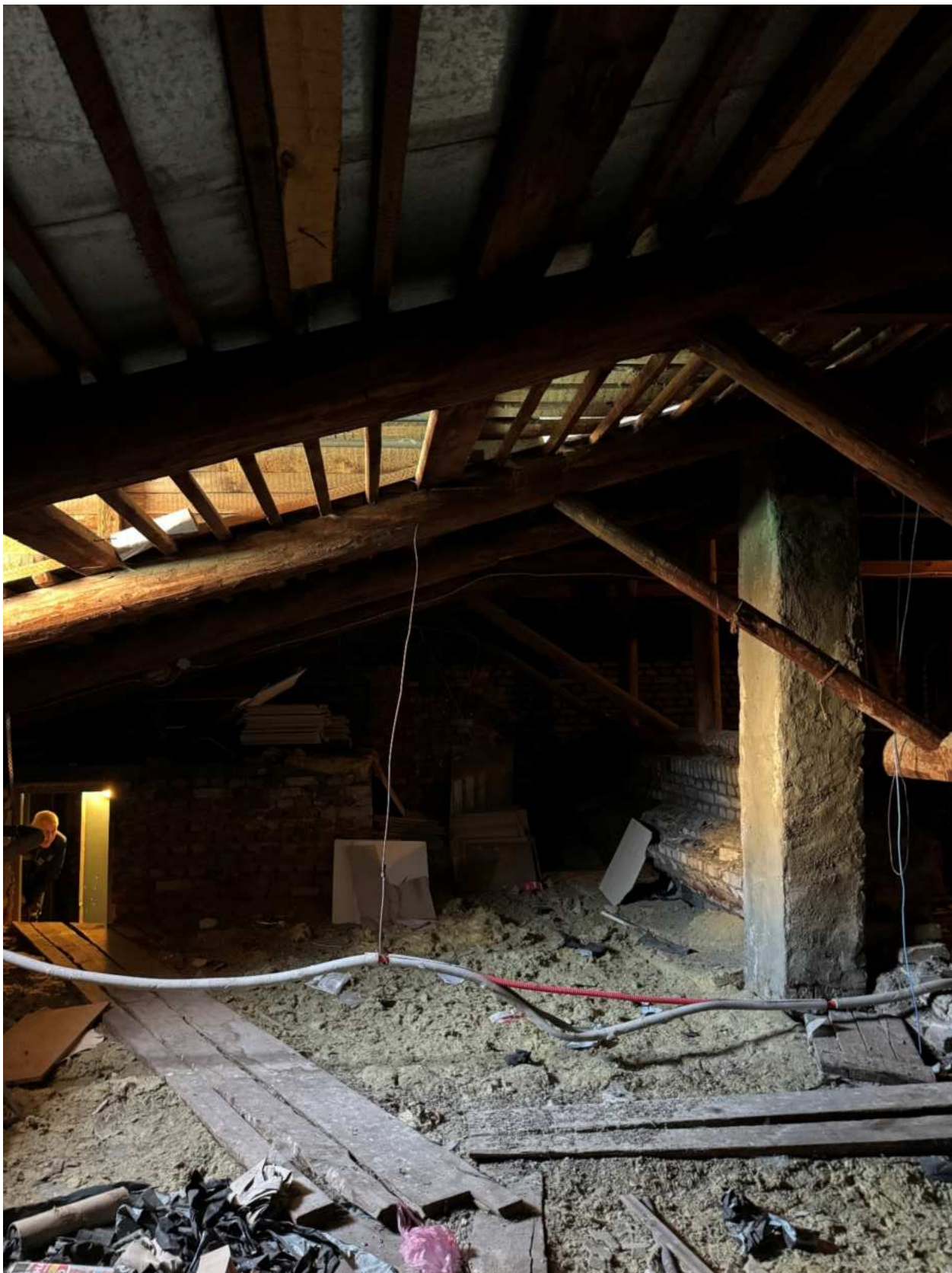
Фото 37. Вид на чердачные помещения.
