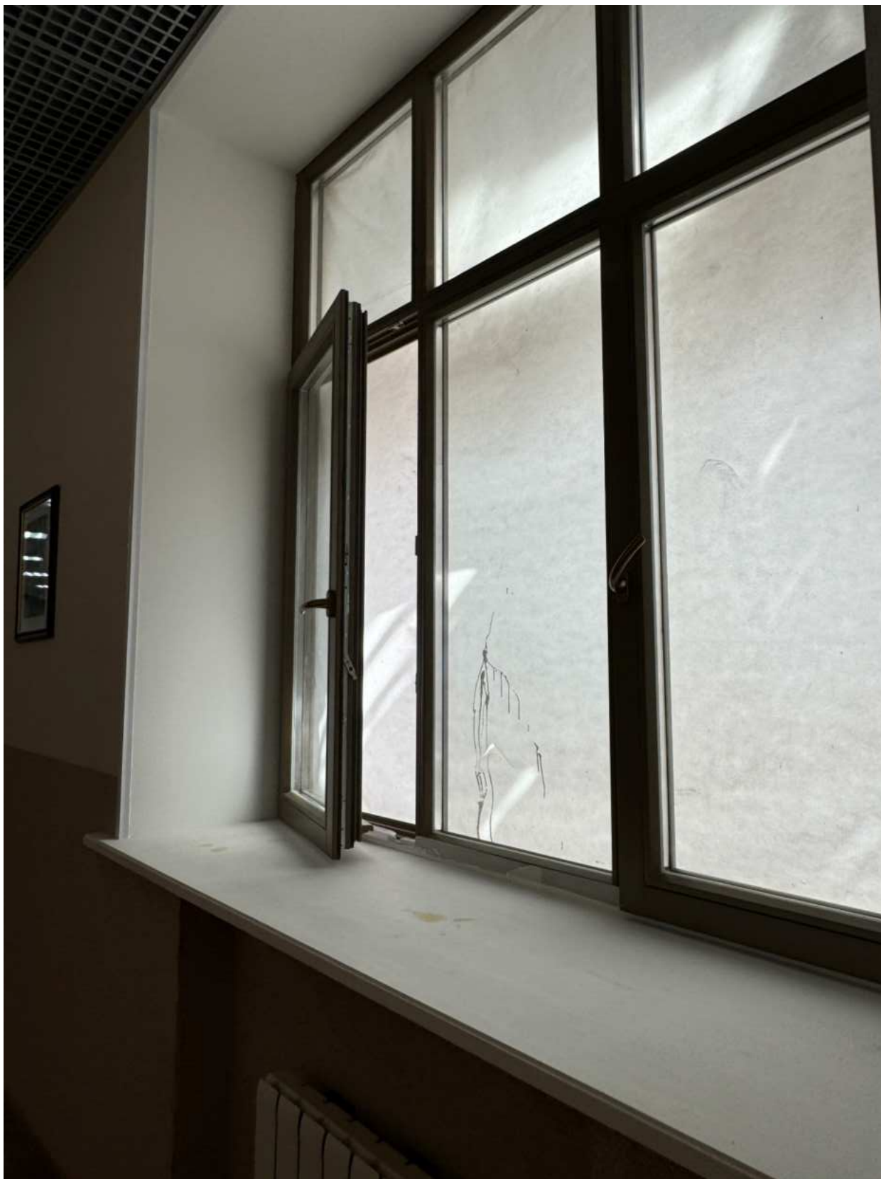
Фото 14. Вид на оконное заполнение.
