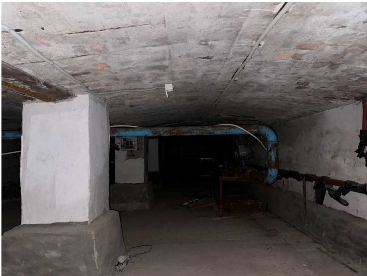
Фото 58. Вид на подвальные помещения.
