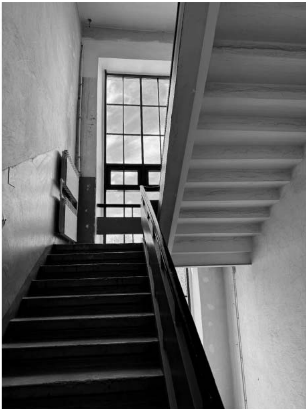
Фото 36. Вид на интерьер лестницы 3-ЛК объекта культурного наследия.
