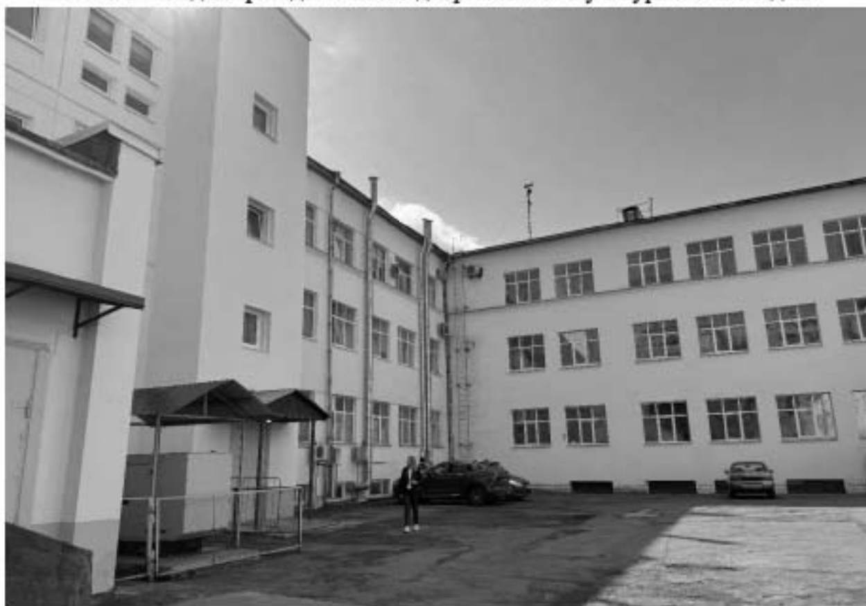
Фото 22. Вид на фасады южного двора объекта культурного наследия.
