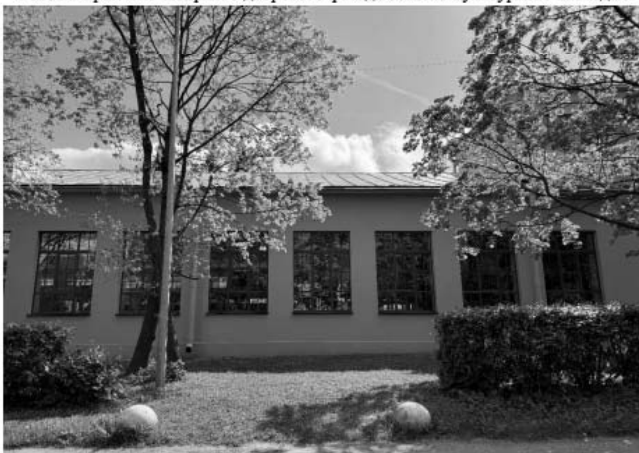
Фото 10. Фрагмент северного дворового фасада объекта культурного наследия.
