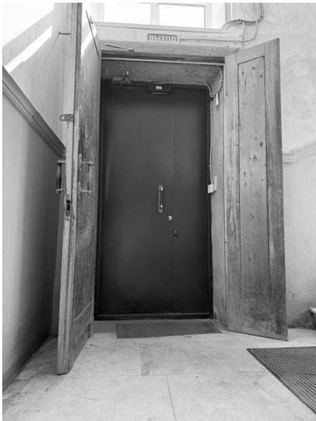
Фото 72. Вид на дверное заполнение в части лестницы 2-ЛК объекта культурного наследия.
