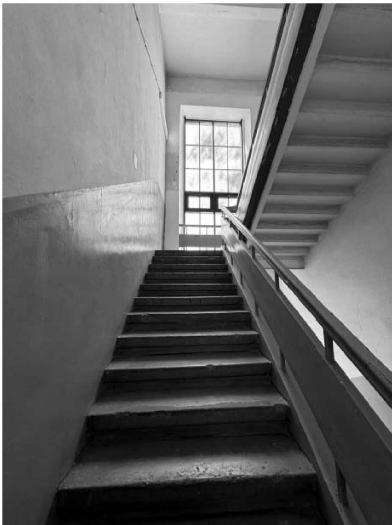
Фото 89. Вид на интерьер лестницы 1-ЛК объекта культурного наследия.
