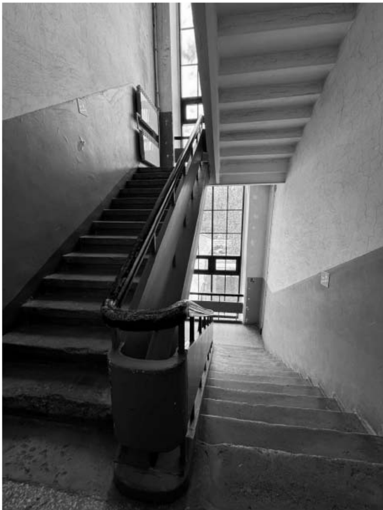
Фото 37. Вид на интерьер лестницы 3-ЛК объекта культурного наследия.
