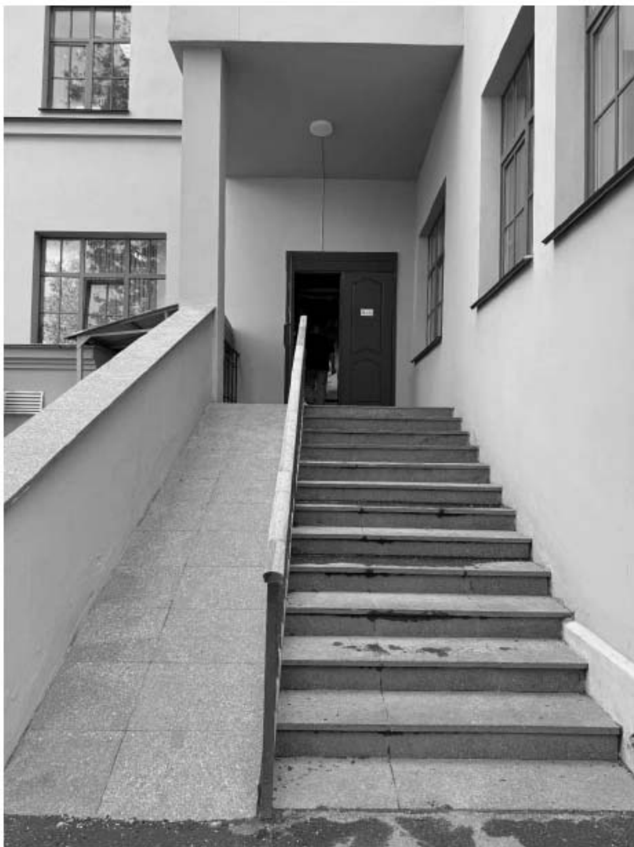
Фото 7. Фрагмент северного дворового фасада объекта культурного наследия.
