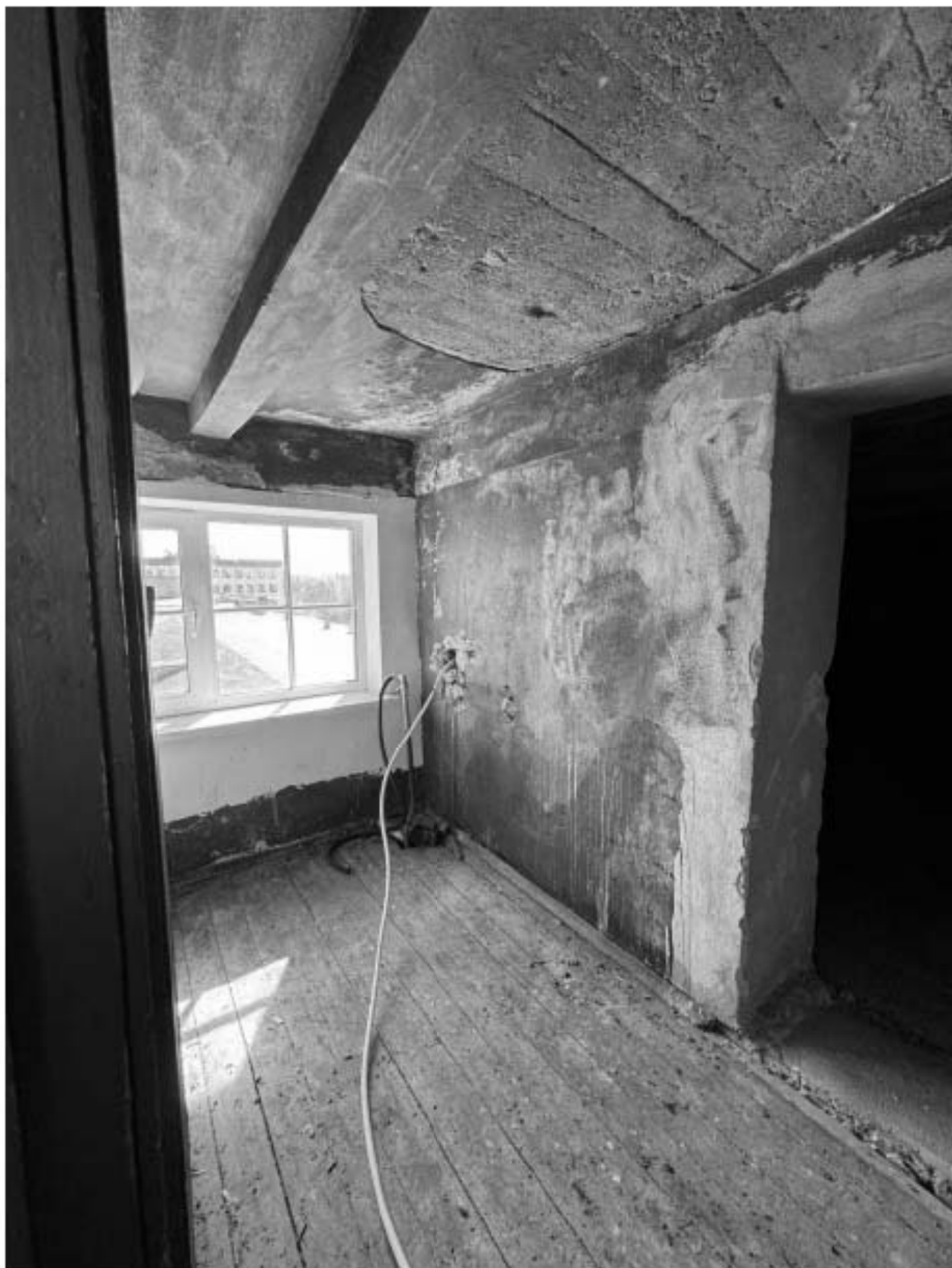
Фото 113. Вид на интерьер помещения объекта культурного наследия.
