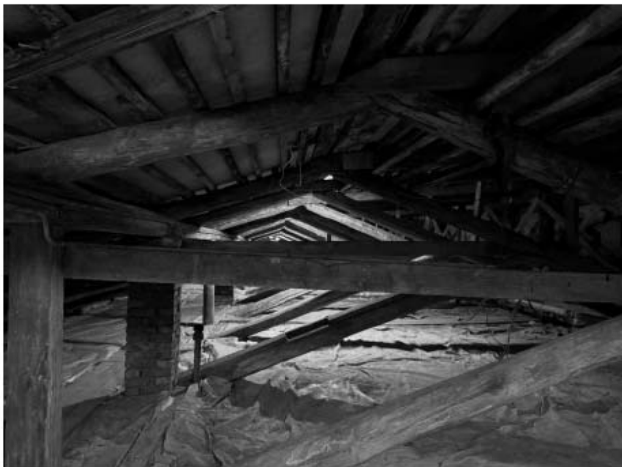
Фото 99. Вид на чердачное помещение объекта культурного наследия.
