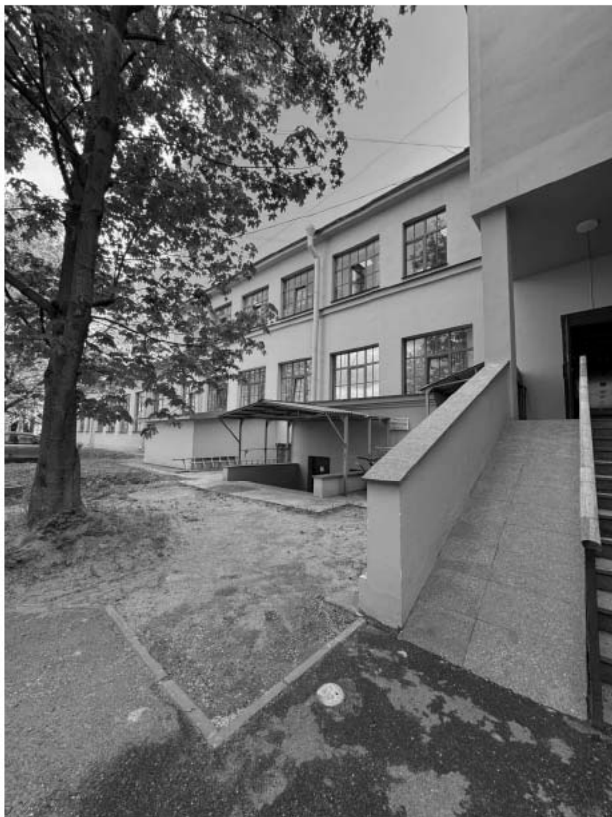
Фото 8. Фрагмент северного дворового фасада объекта культурного наследия.
