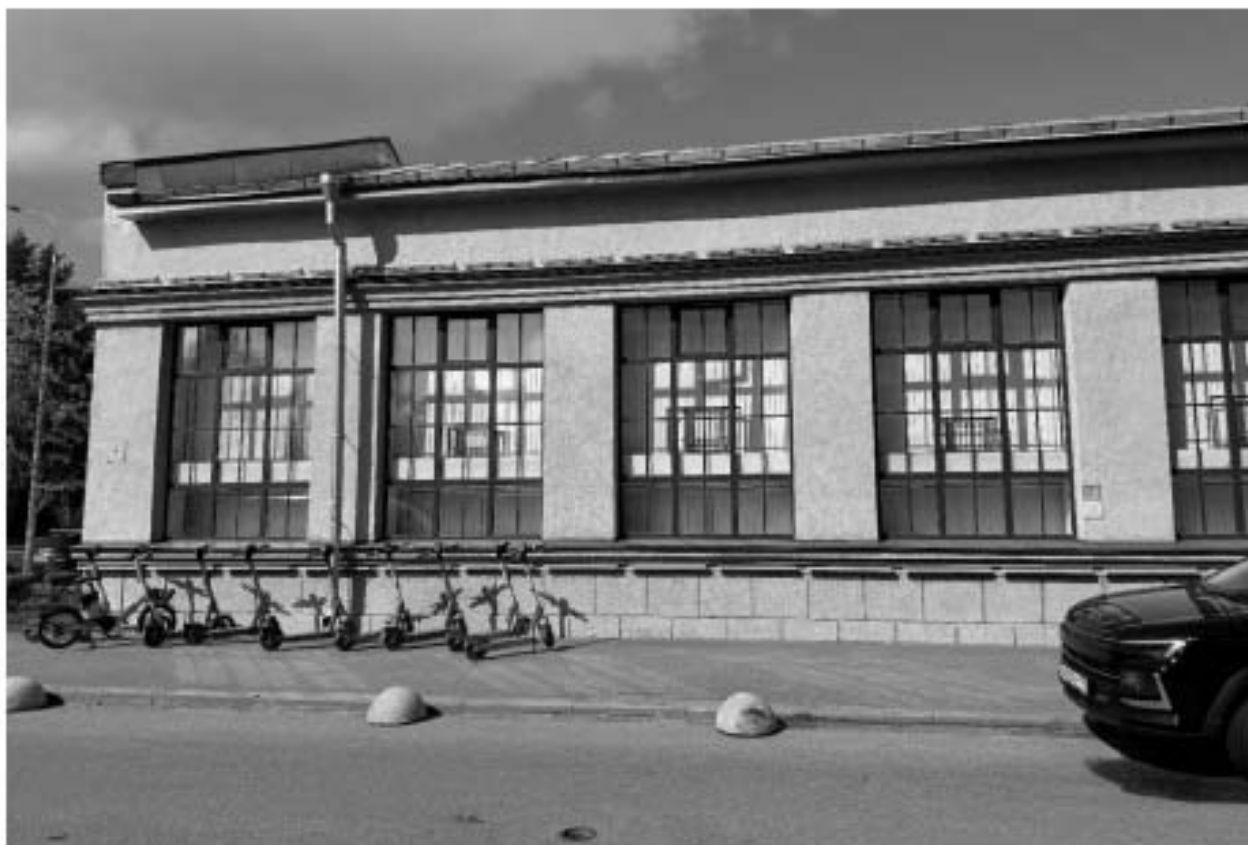
Фото 25. Вид на фрагмент южного лицевого фасада объекта культурного наследия.
