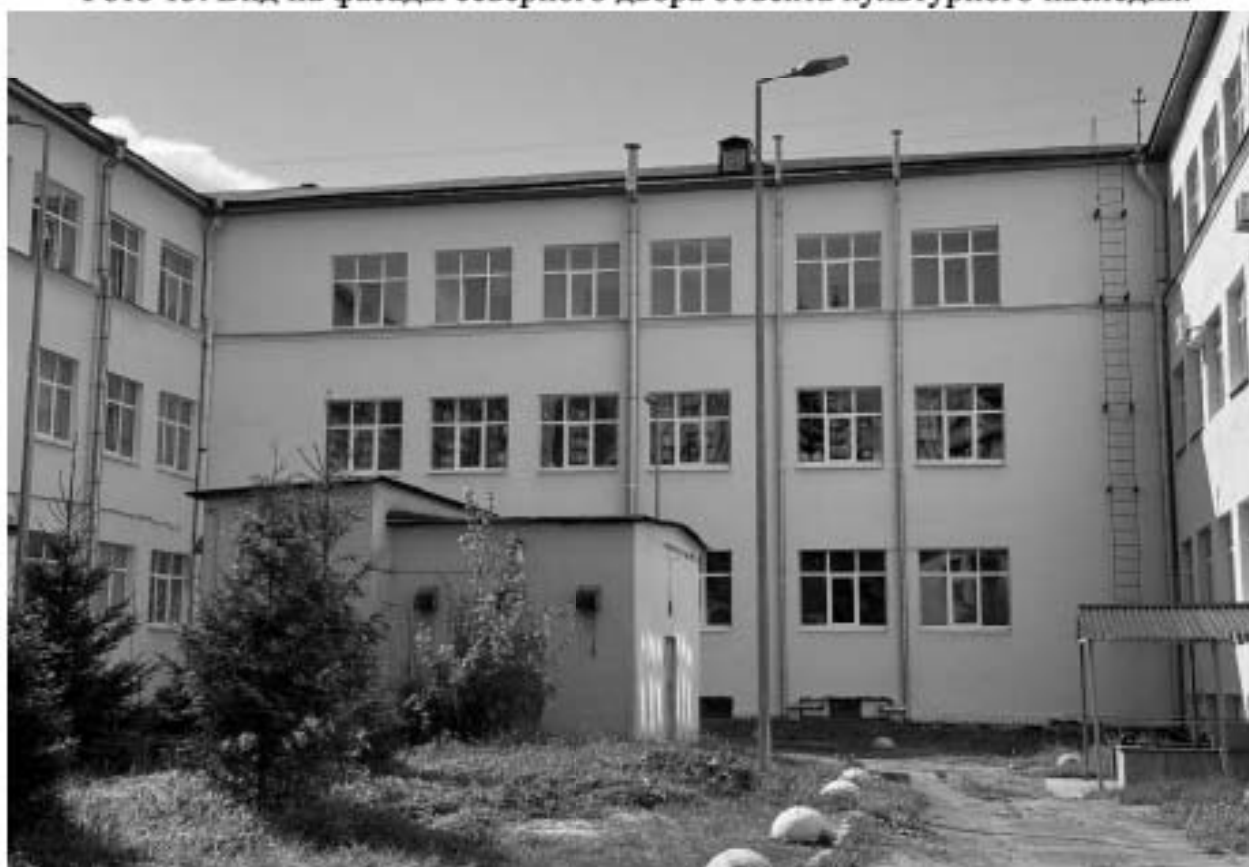
Фото 14. Вид на фасады северного двора объекта культурного наследия.
