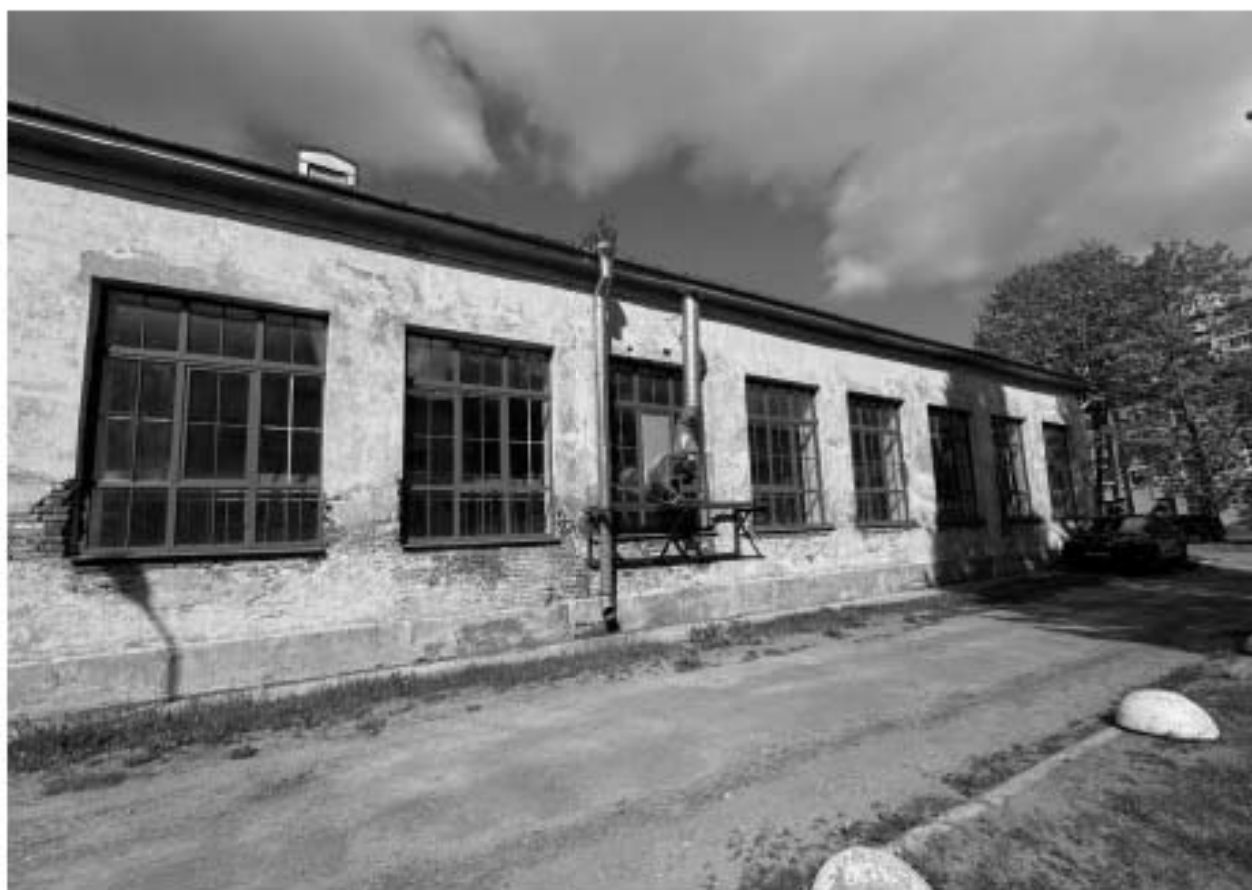
Фото 15. Вид на фасады северного двора объекта культурного наследия.
