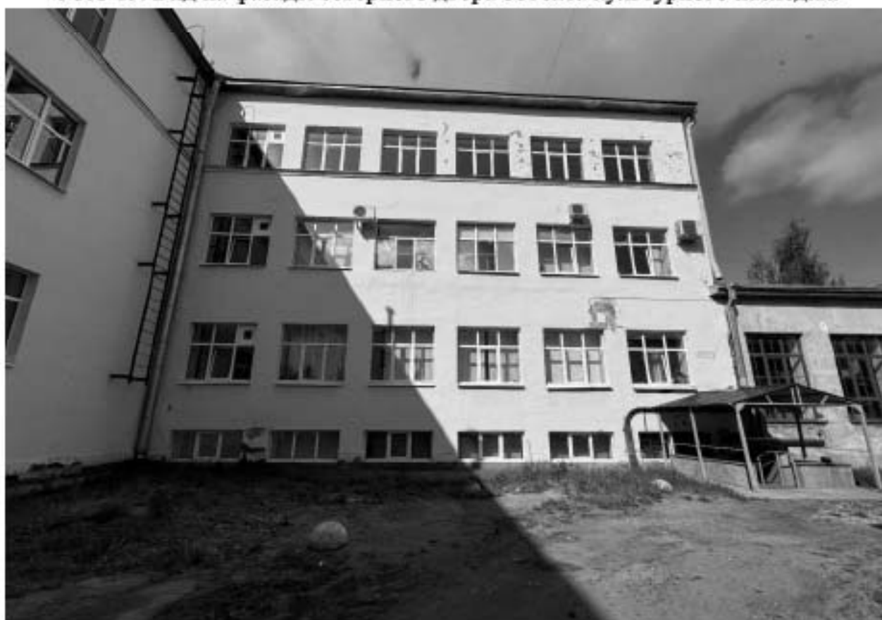
Фото 16. Вид на фасады северного двора объекта культурного наследия.
