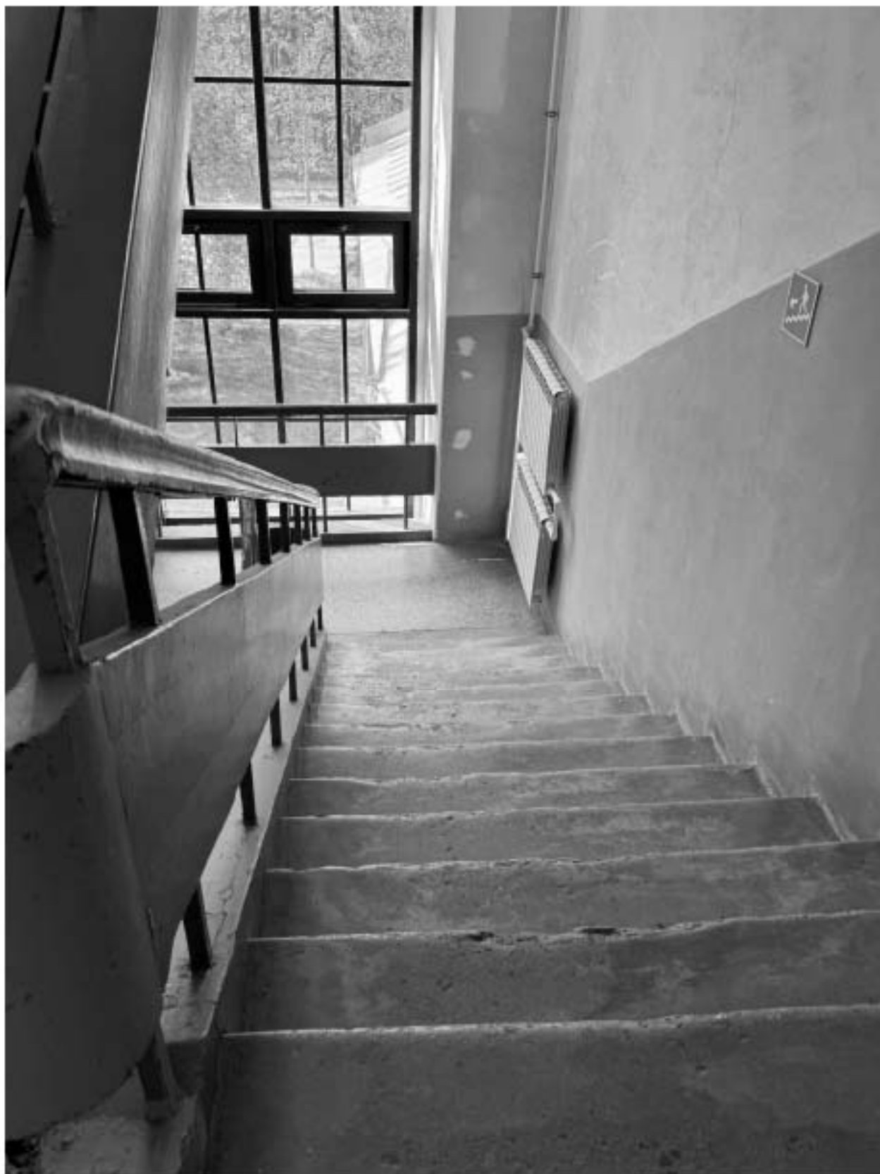
Фото 88. Вид на интерьер лестницы 1-ЛК объекта культурного наследия.
