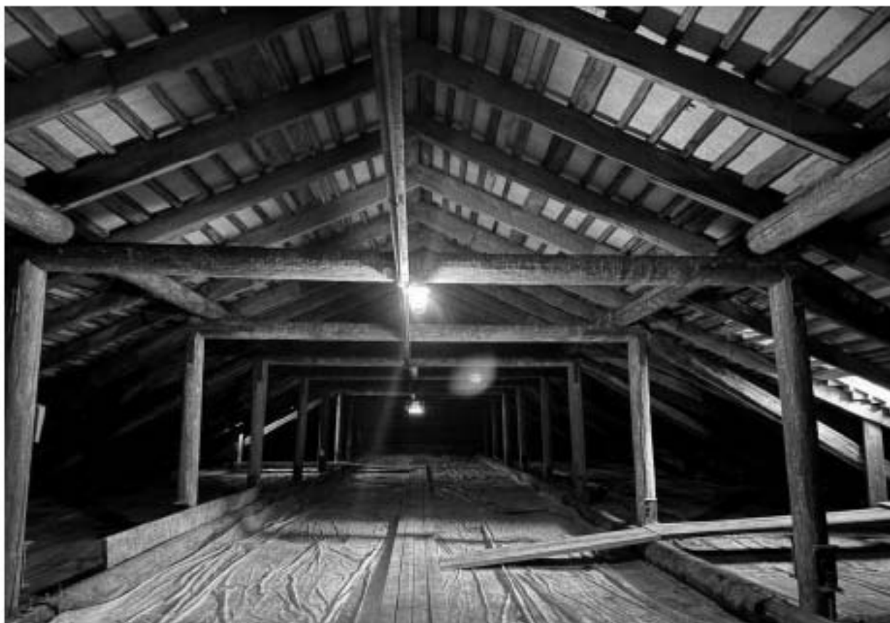
Фото 103. Вид на чердачное помещение объекта культурного наследия.
