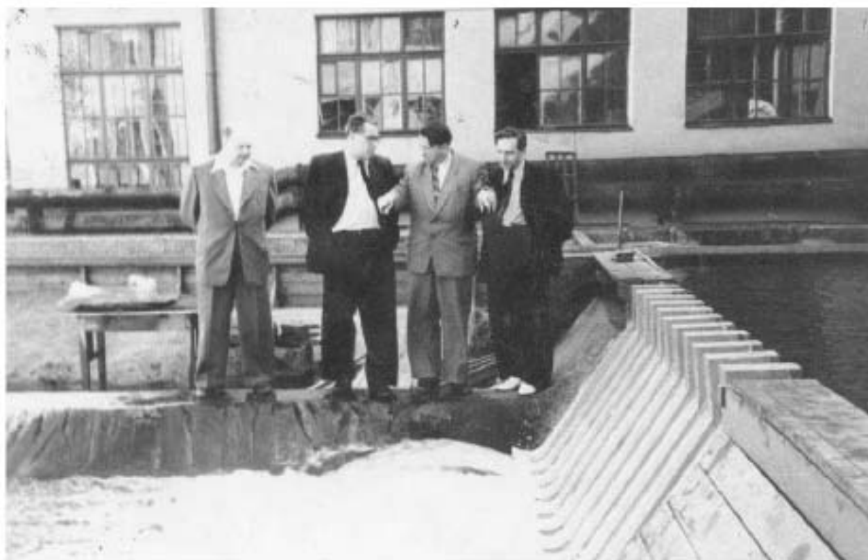
45. Проверка работы Братской ГЭС по модели. Фото 1954 гг. По материалам музея ОАО ВНИИГ им. Б.Е. Веденеева.
