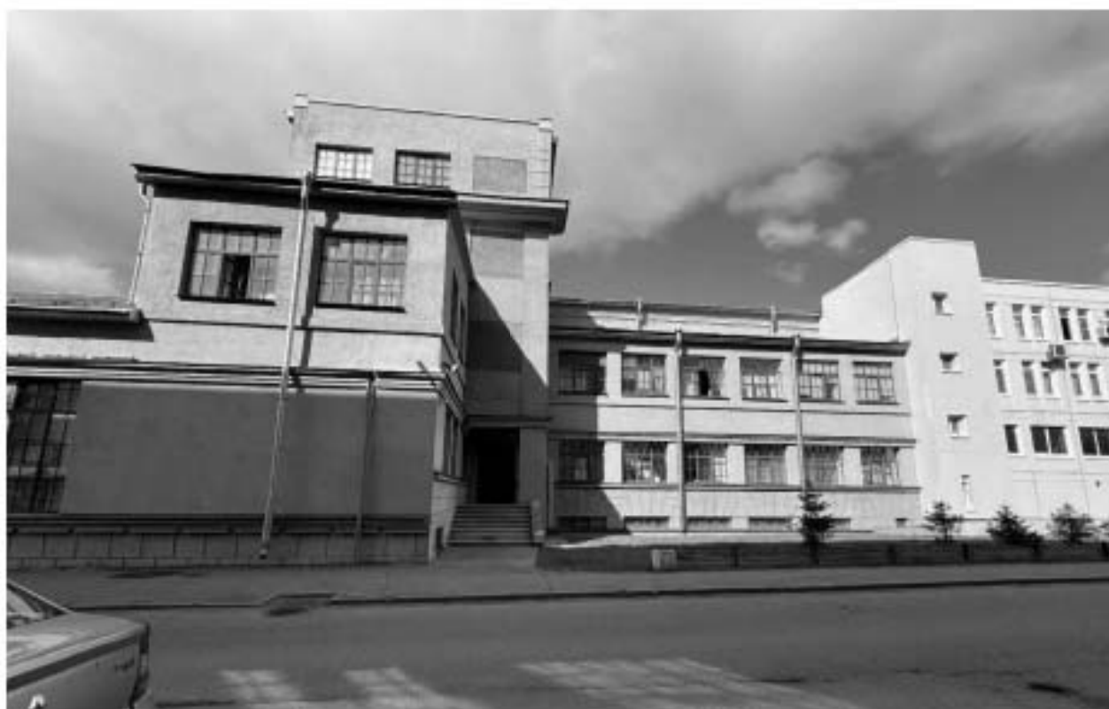
Фото 27. Вид на фрагмент южного лицевого фасада объекта культурного наследия
