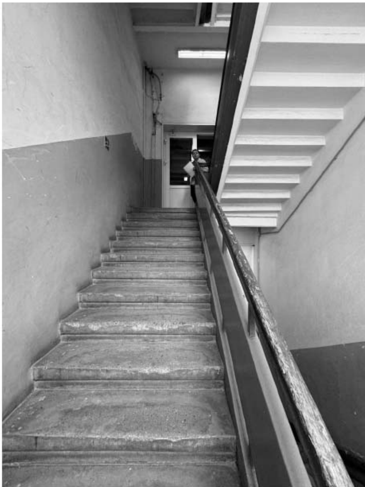
Фото 98. Вид на интерьер лестницы 1-ЛК объекта культурного наследия.
