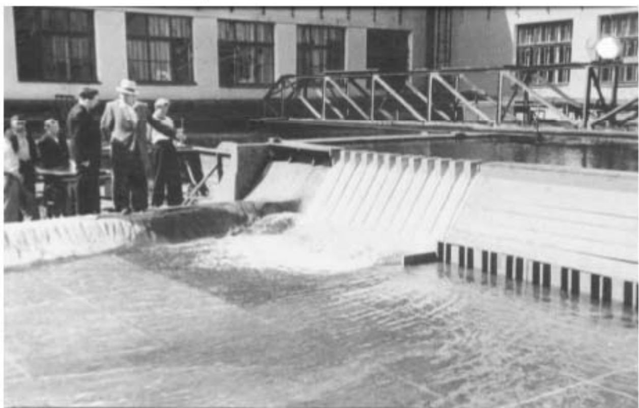
59. Проверка работы Братской ГЭС по модели. Фото 1960-х гг. По материалам музея ОАО ВНИИГ им. Б.Е. Веденеева
