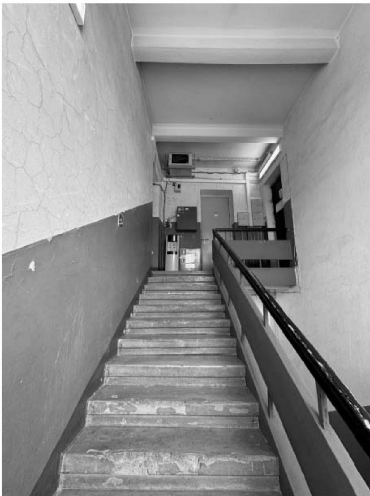
Фото 39. Вид на интерьер лестницы 3-ЛК объекта культурного наследия.
