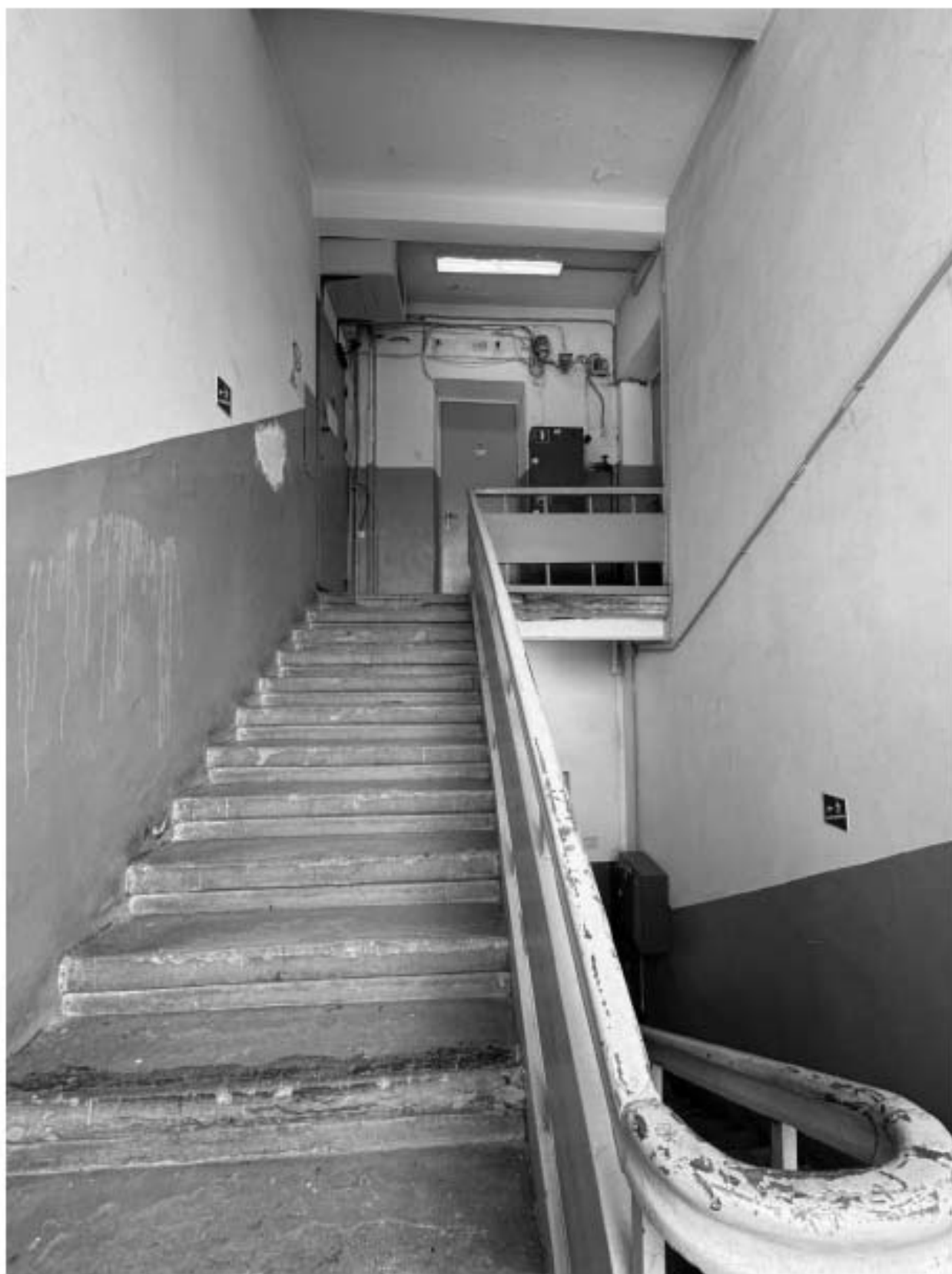
Фото 90. Вид на интерьер лестницы 1-ЛК объекта культурного наследия.
