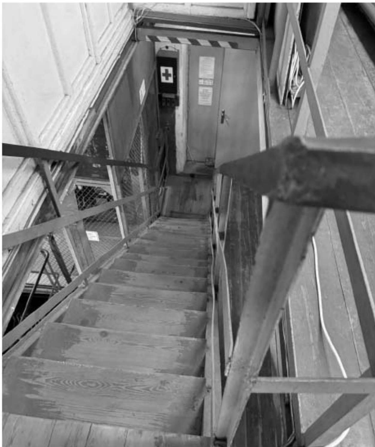
Фото 111. Вид на лестницу помещения объекта культурного наследия.
