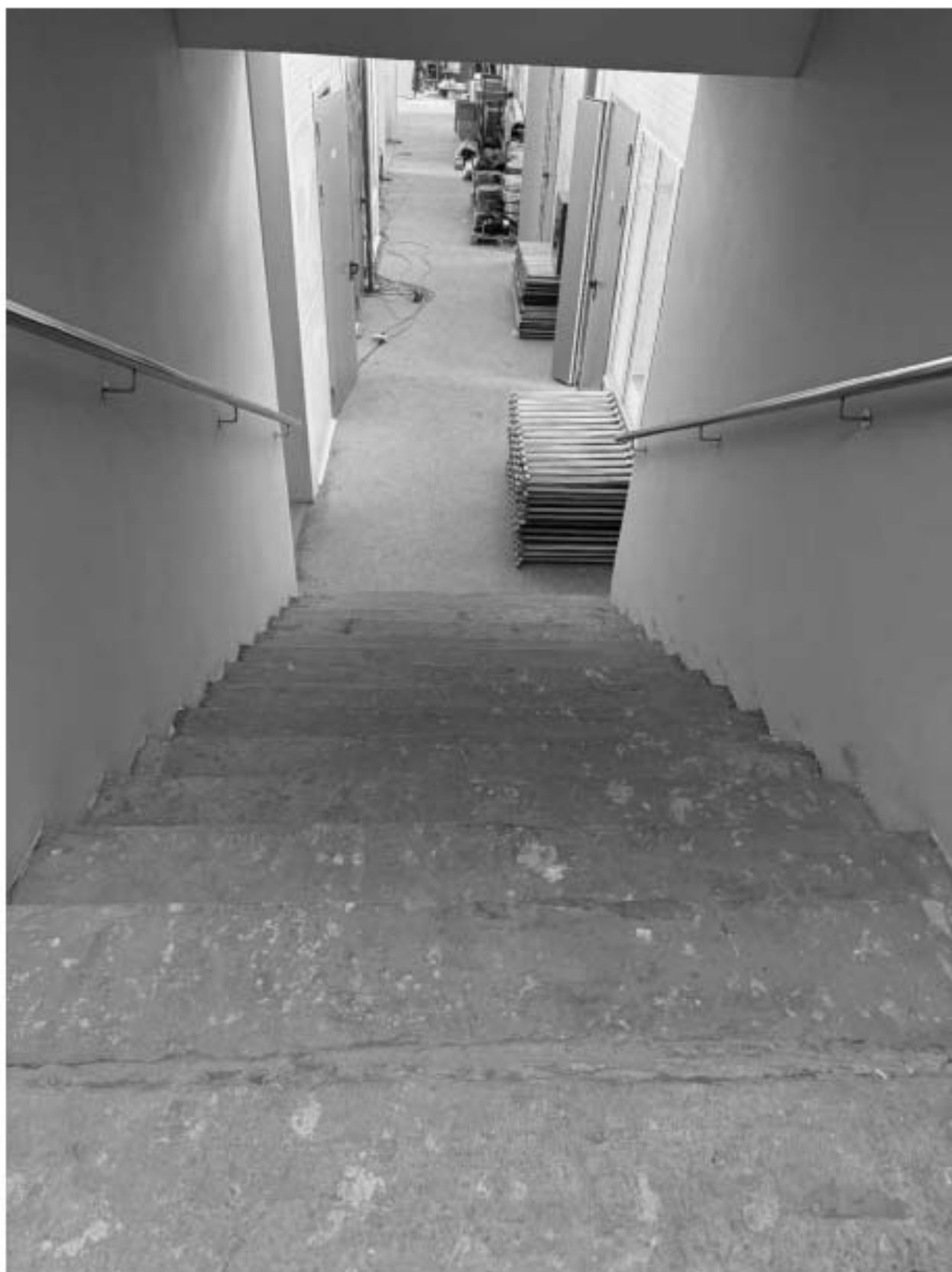
Фото 67. Вид на лестницу объекта культурного наследия.
