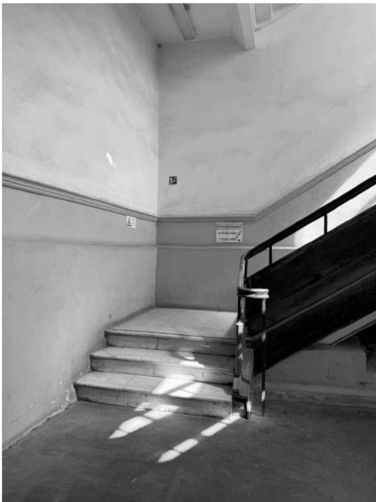
Фото 71. Вид на интерьер лестницы 2-ЛК объекта культурного наследия.
