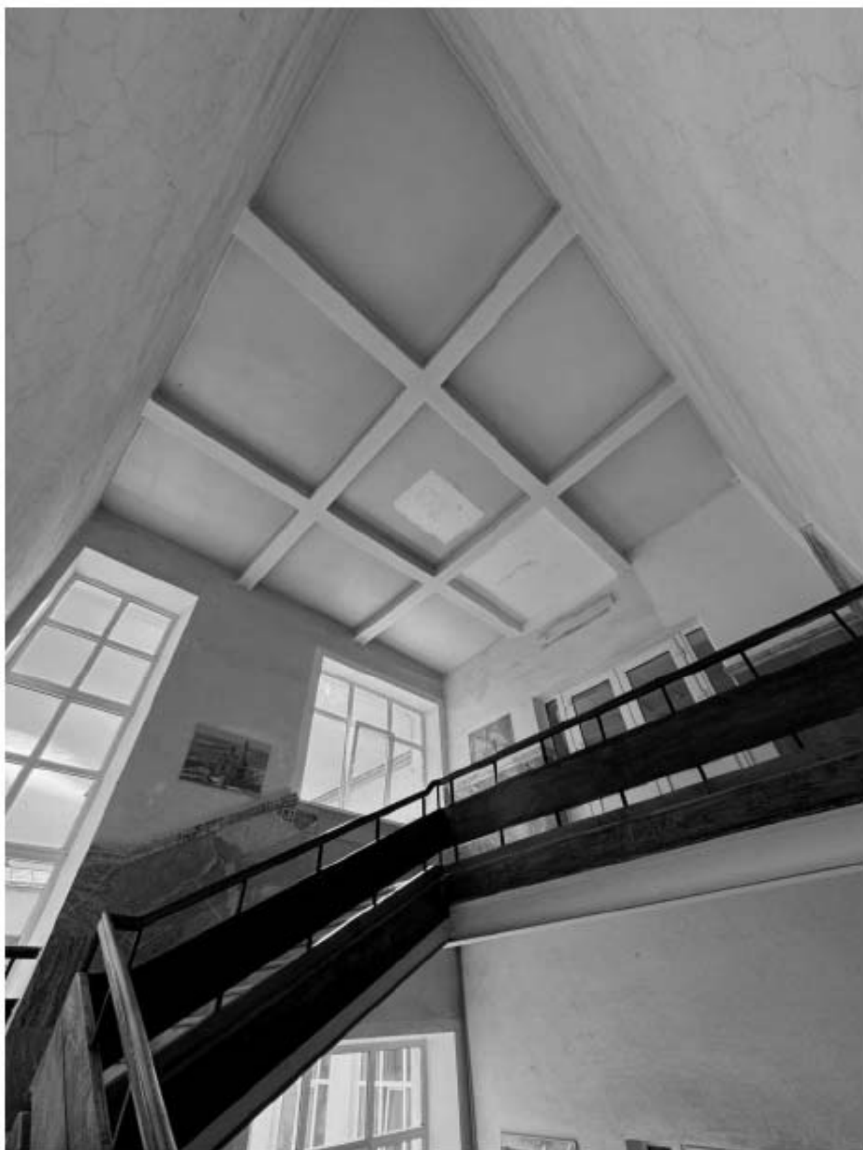
Фото 74. Вид на интерьер лестницы 2-ЛК объекта культурного наследия.
