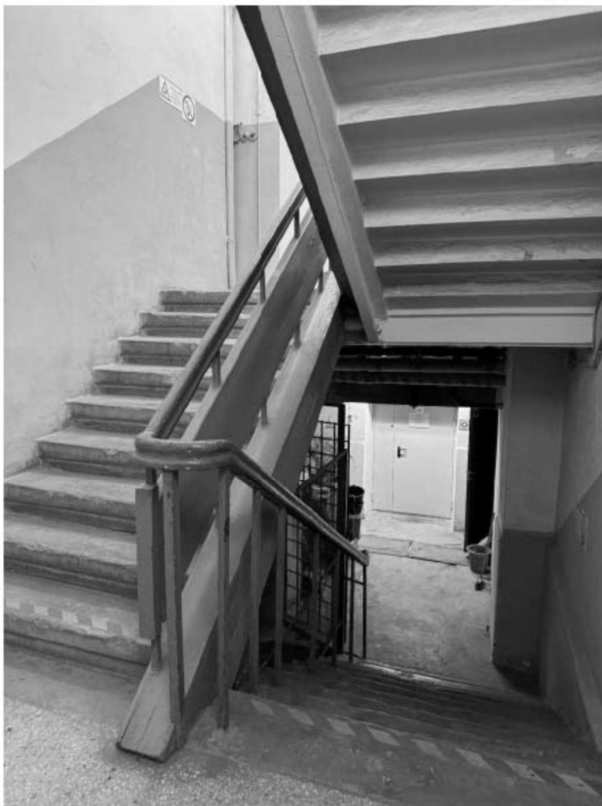
Фото 96. Вид на интерьер лестницы 1-ЛК объекта культурного наследия.
