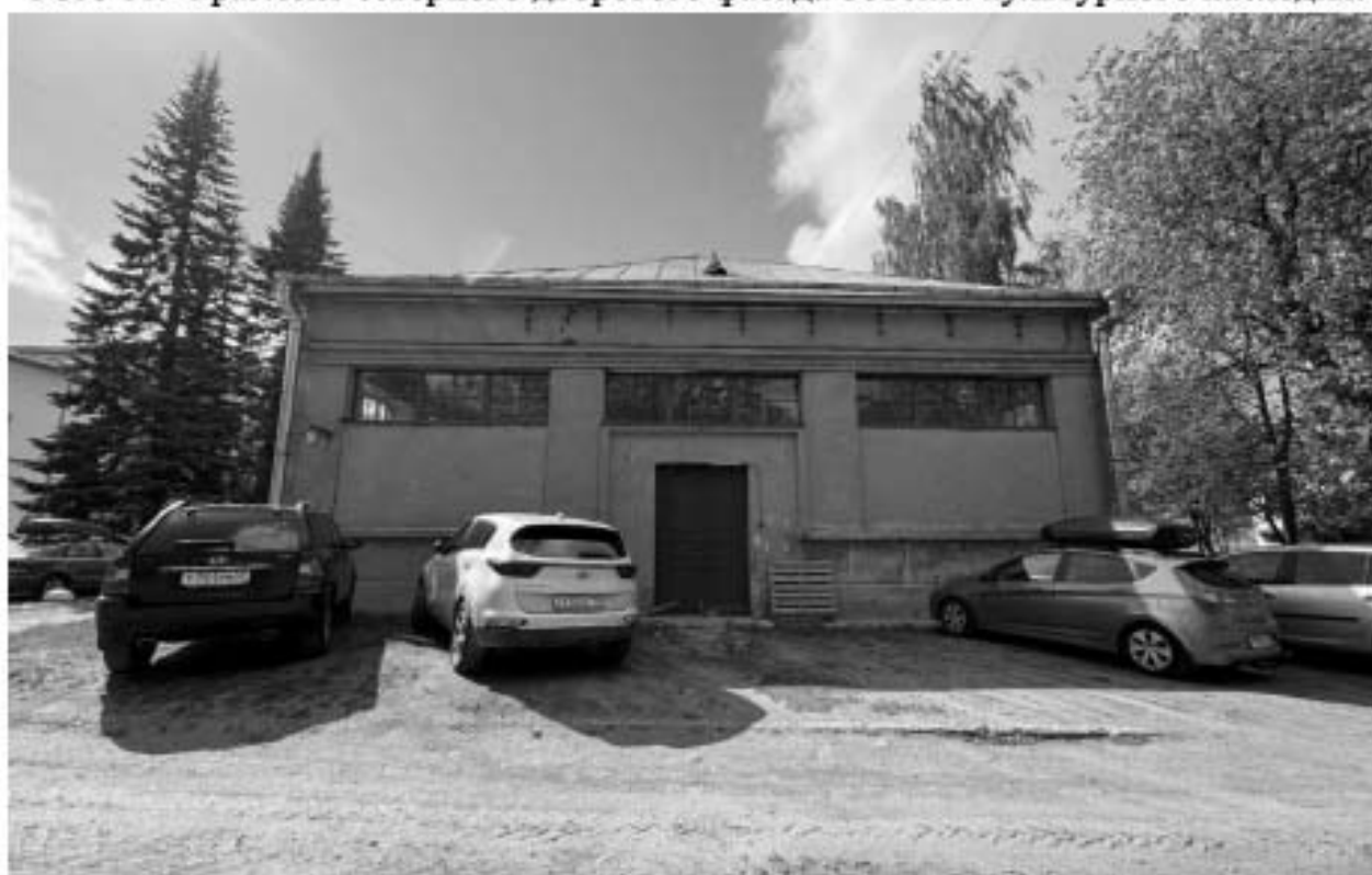
Фото 12. Фрагмент северного дворового фасада объекта культурного наследия.
