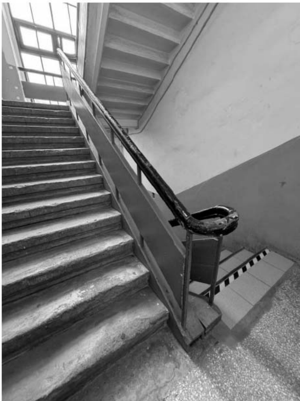
Фото 42. Вид на интерьер лестницы 3-ЛК объекта культурного наследия.
