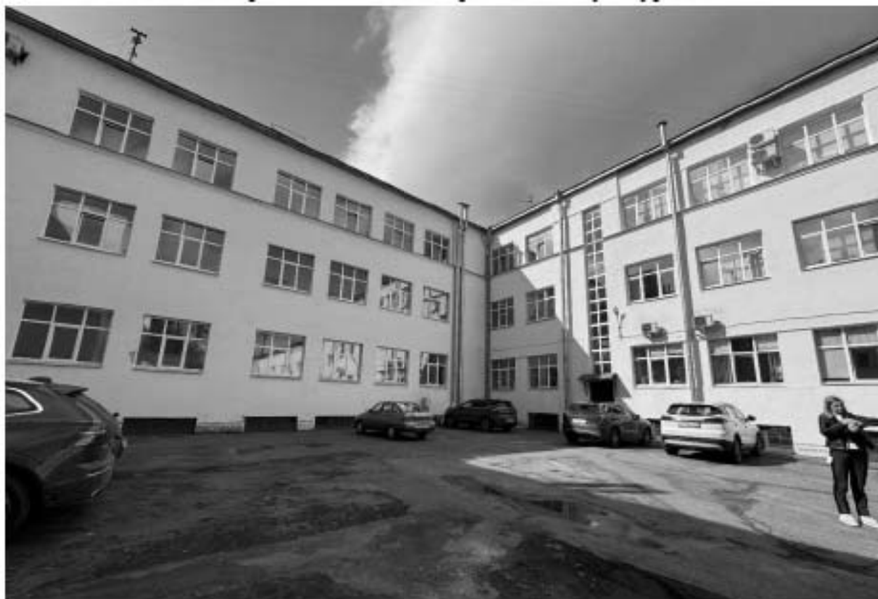
Фото 20. Вид на фасады южного двора объекта культурного наследия.
