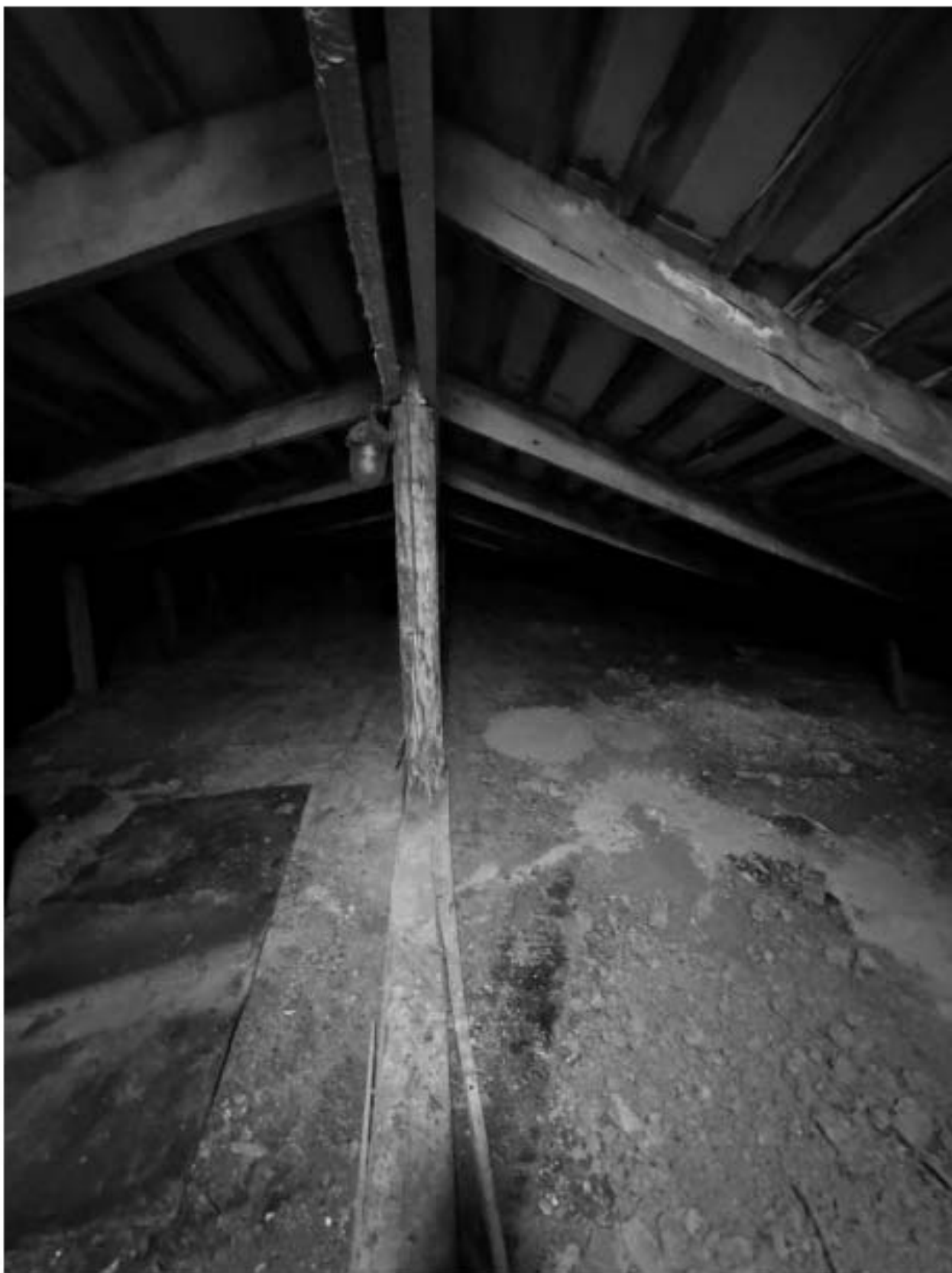
Фото 121. Вид на чердачное помещение объекта культурного наследия.
