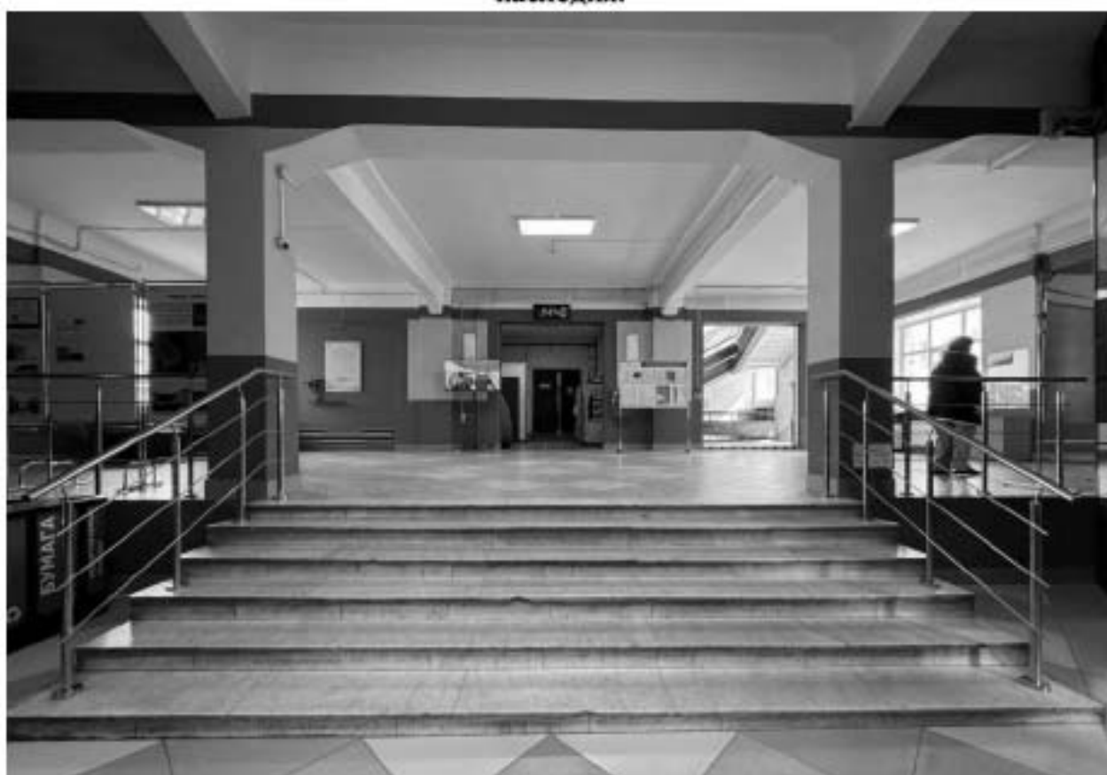
Фото 65. Вид на интерьер помещения главного вестибюля объекта культурного наследия.
