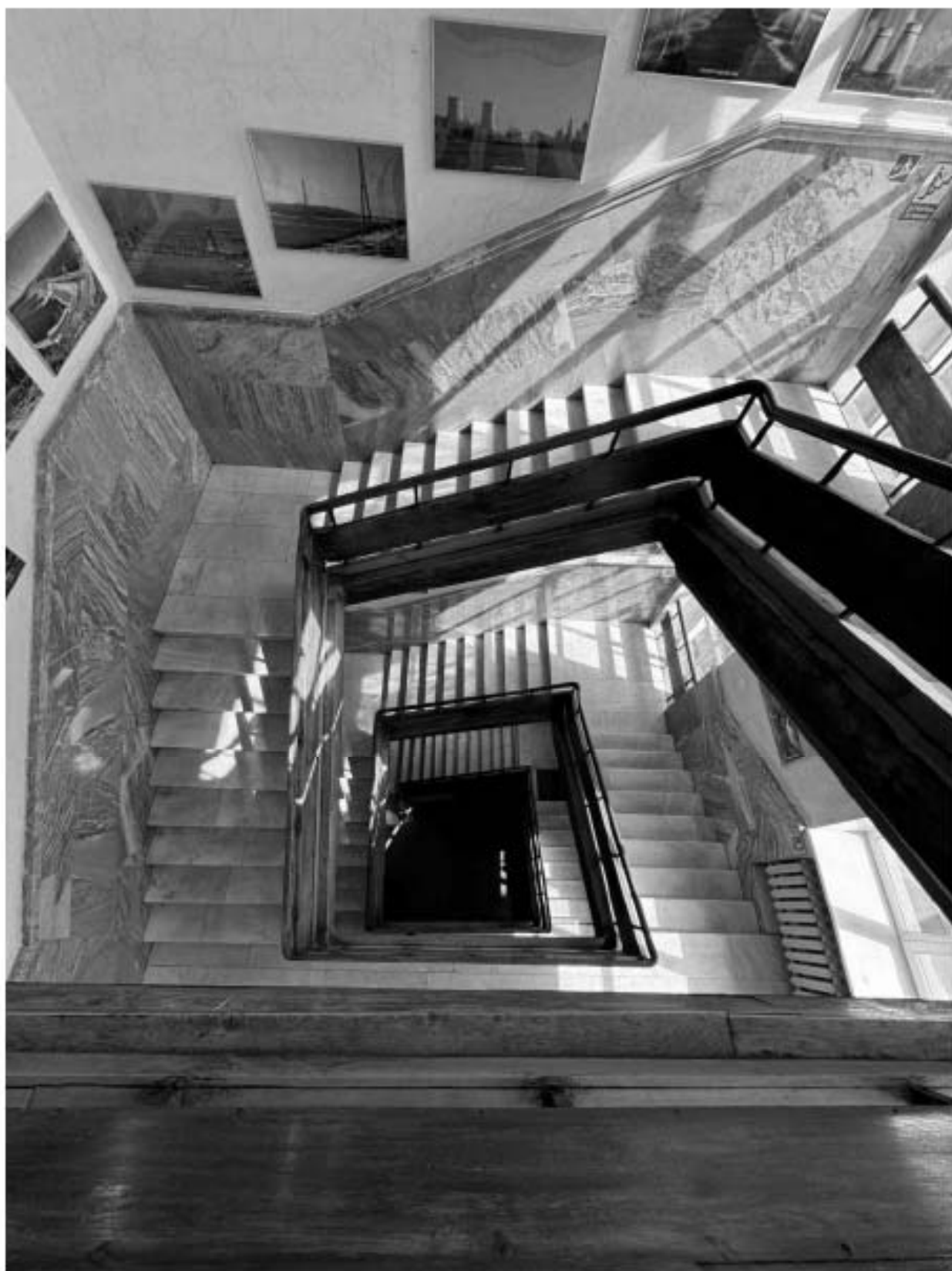
Фото 76. Вид на интерьер лестницы 2-ЛК объекта культурного наследия.
