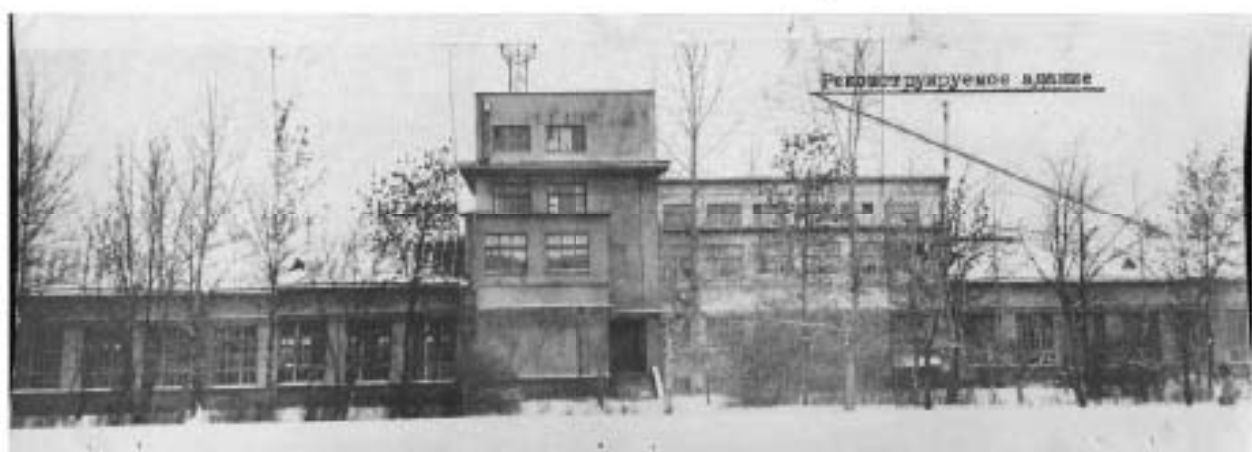
50. Вид лабораторного корпуса. Фото 1957 г. По материалам музея ОАО ВНИИГ им. Б.Е. Веденеева
