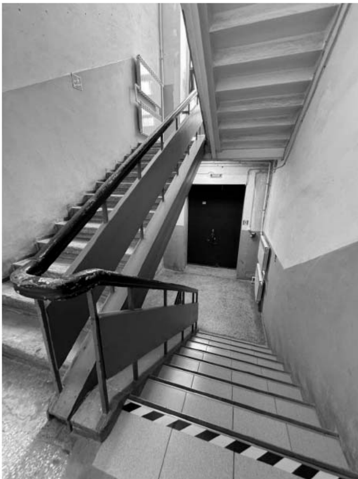
Фото 43. Вид на интерьер лестницы 3-ЛК объекта культурного наследия.
