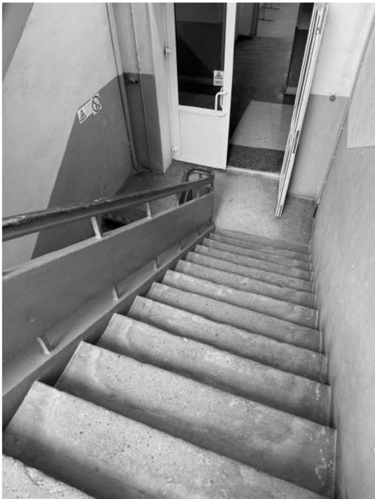
Фото 93. Вид на интерьер лестницы 1-ЛК объекта культурного наследия.
