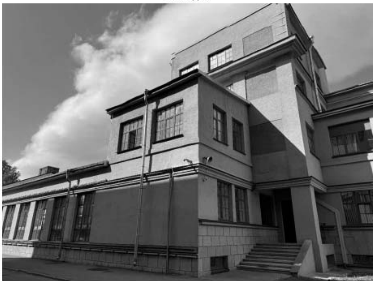
Фото 28. Вид на фрагмент южного лицевого фасада объекта культурного наследия.
