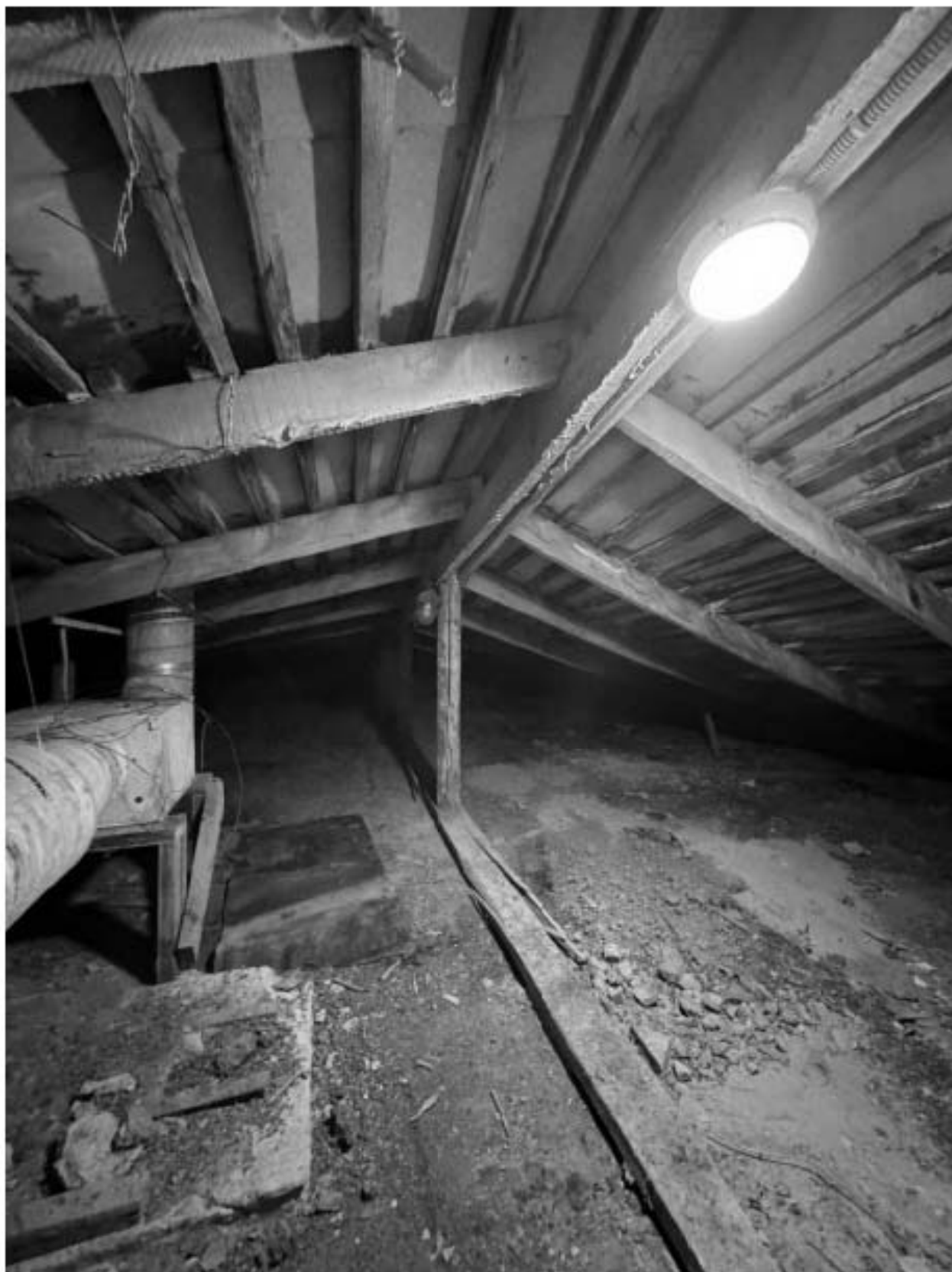
Фото 119. Вид на чердачное помещение объекта культурного наследия.
