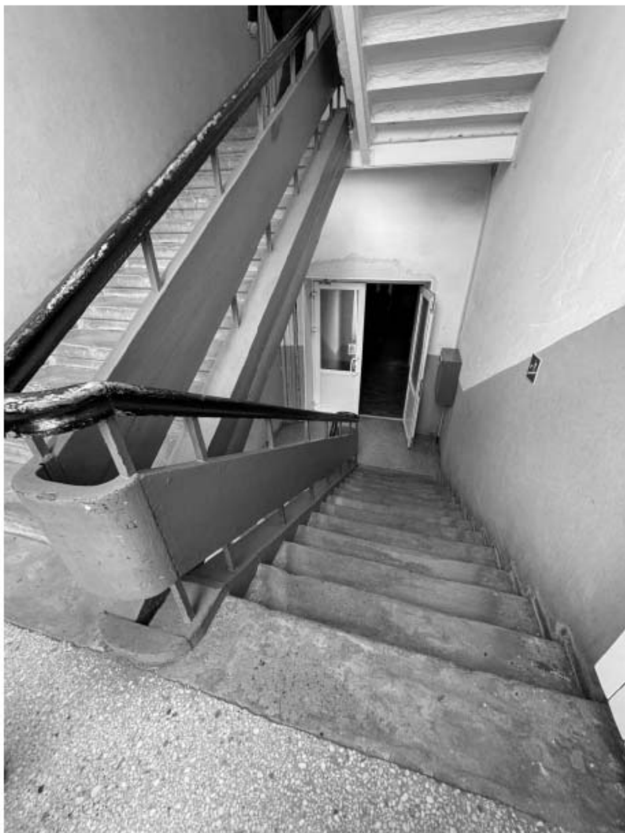
Фото 40. Вид на интерьер лестницы 3-ЛК объекта культурного наследия.
