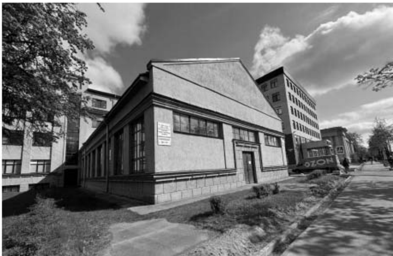
Фото 23. Вид на фрагмент лицевого фасада по Гжатской улице объекта культурного наследия.
