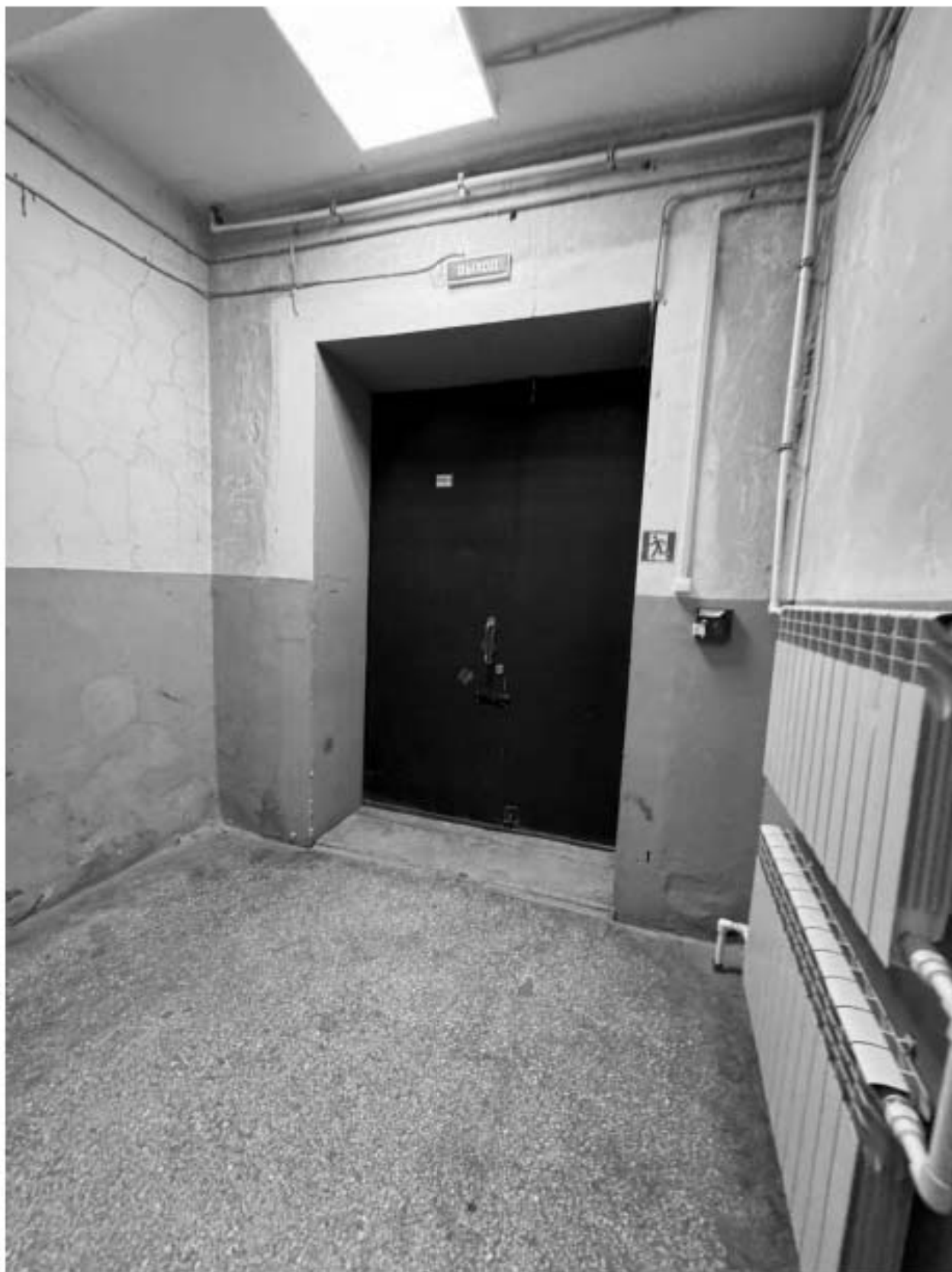
Фото 44. Вид на интерьер лестницы 3-ЛК объекта культурного наследия.
