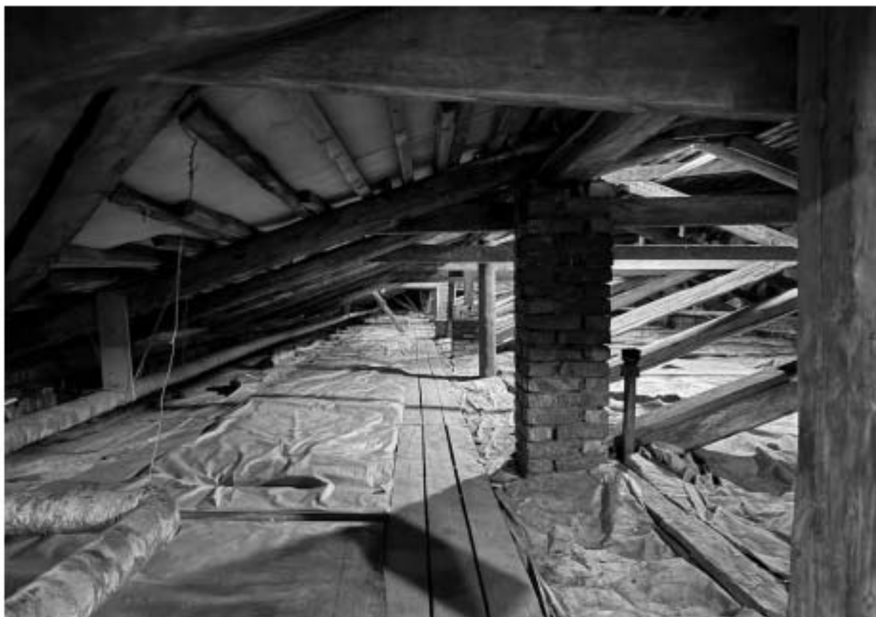
Фото 101. Вид на чердачное помещение объекта культурного наследия.
