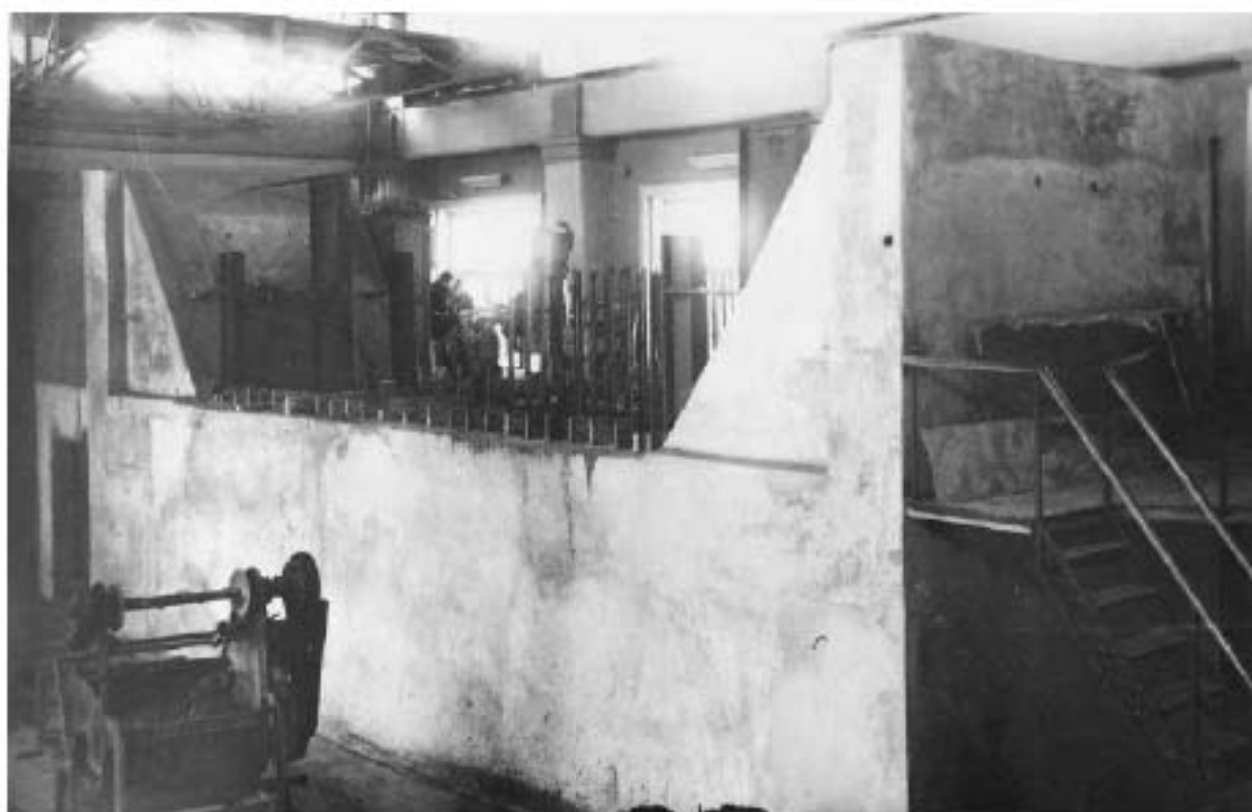
44. Стенд для испытания моделей плотин. 1950-е гг. По материалам музея ОАО ВНИИГ им. Б.Е. Веденеева
