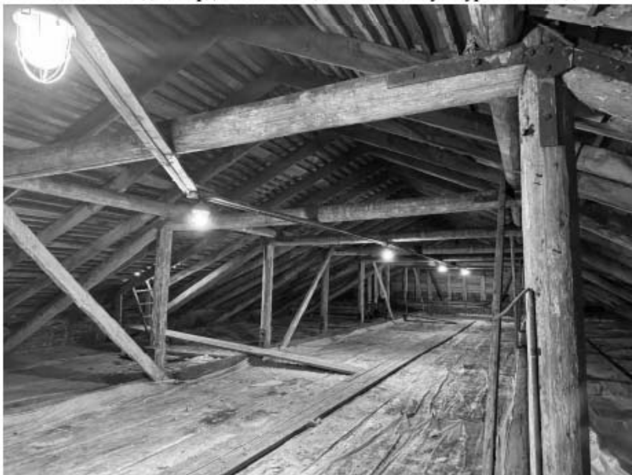
Фото 102. Вид на чердачное помещение объекта культурного наследия.
