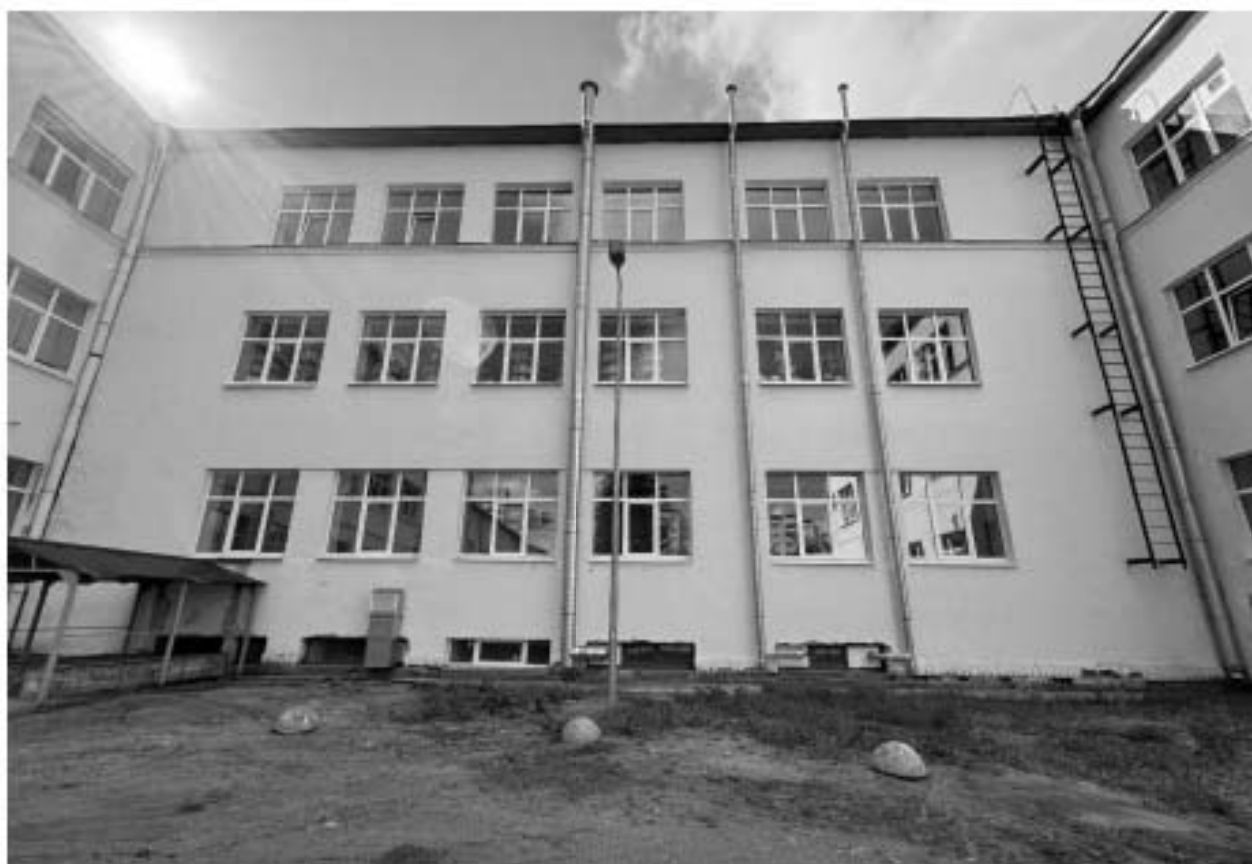
Фото 17. Вид на фасады северного двора объекта культурного наследия.
