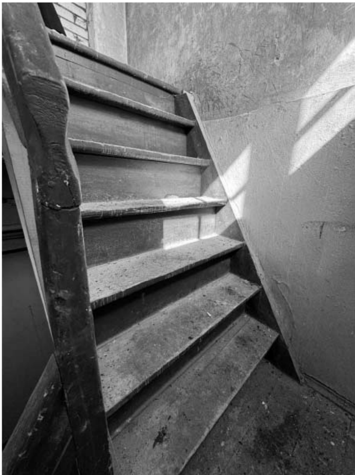
Фото 112. Вид на лестницу в части чердака объекта культурного наследия.
