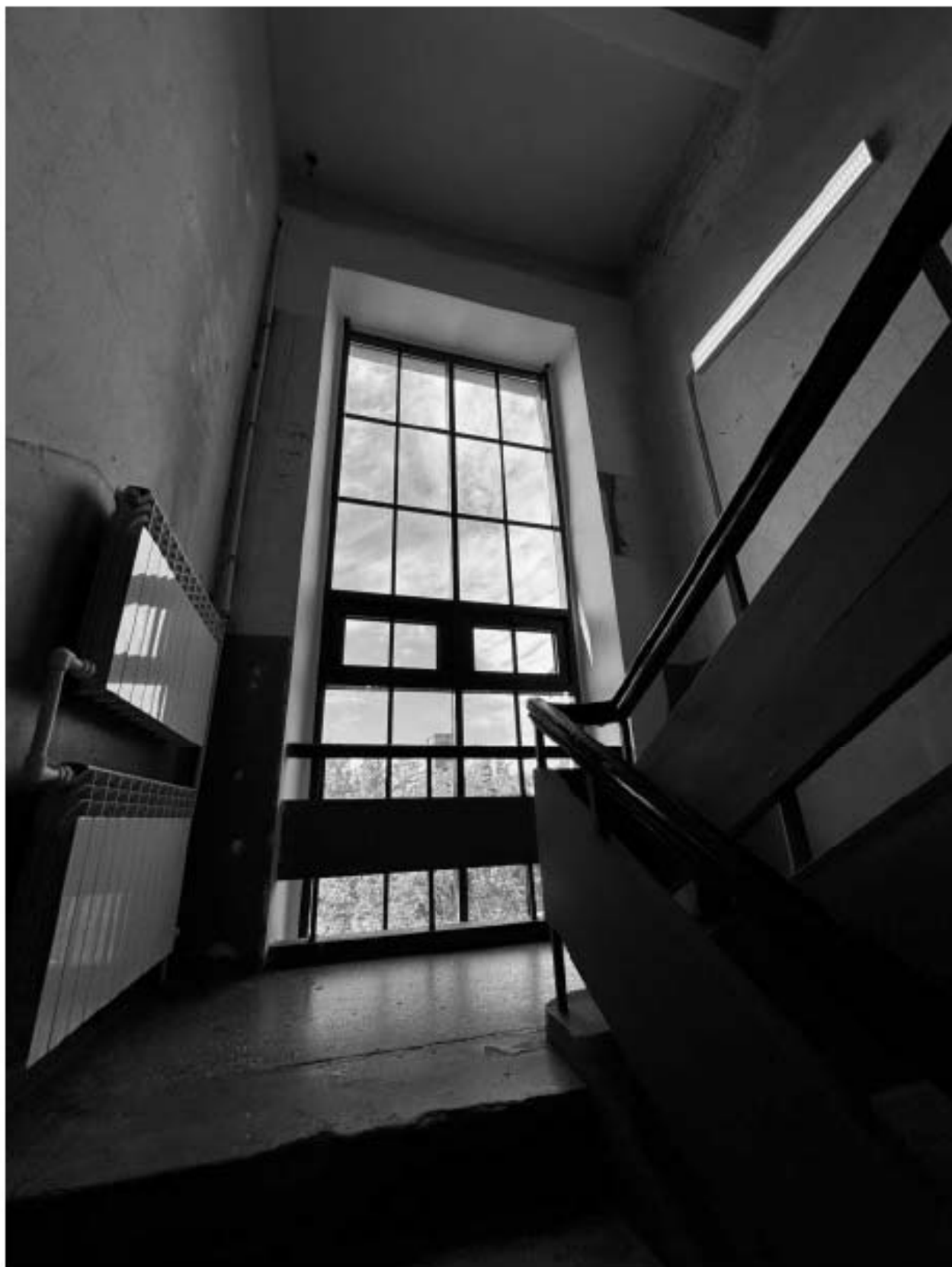
Фото 38. Вид на интерьер лестницы 3-ЛК объекта культурного наследия.
