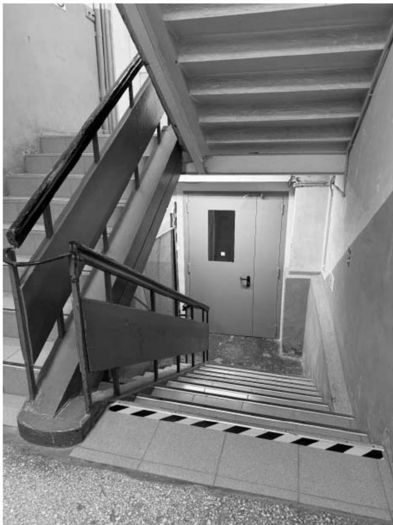
Фото 45. Вид на интерьер лестницы 3-ЛК объекта культурного наследия.
