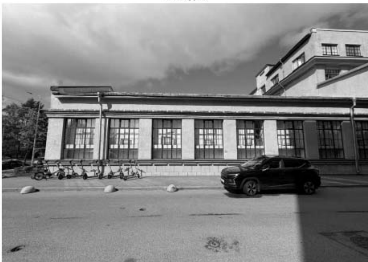
Фото 26. Вид на фрагмент южного лицевого фасада объекта культурного наследия.
