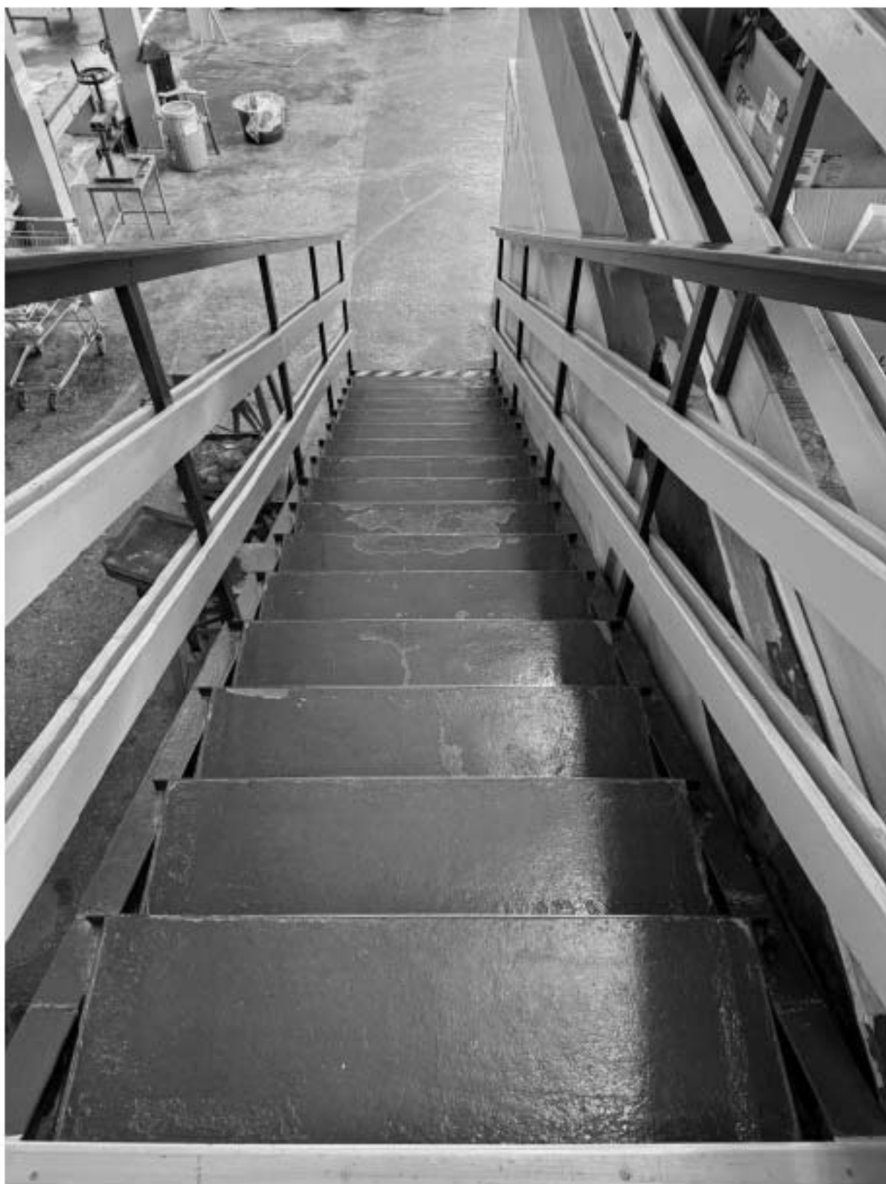
Фото 47. Вид на лестницу объекта культурного наследия.
