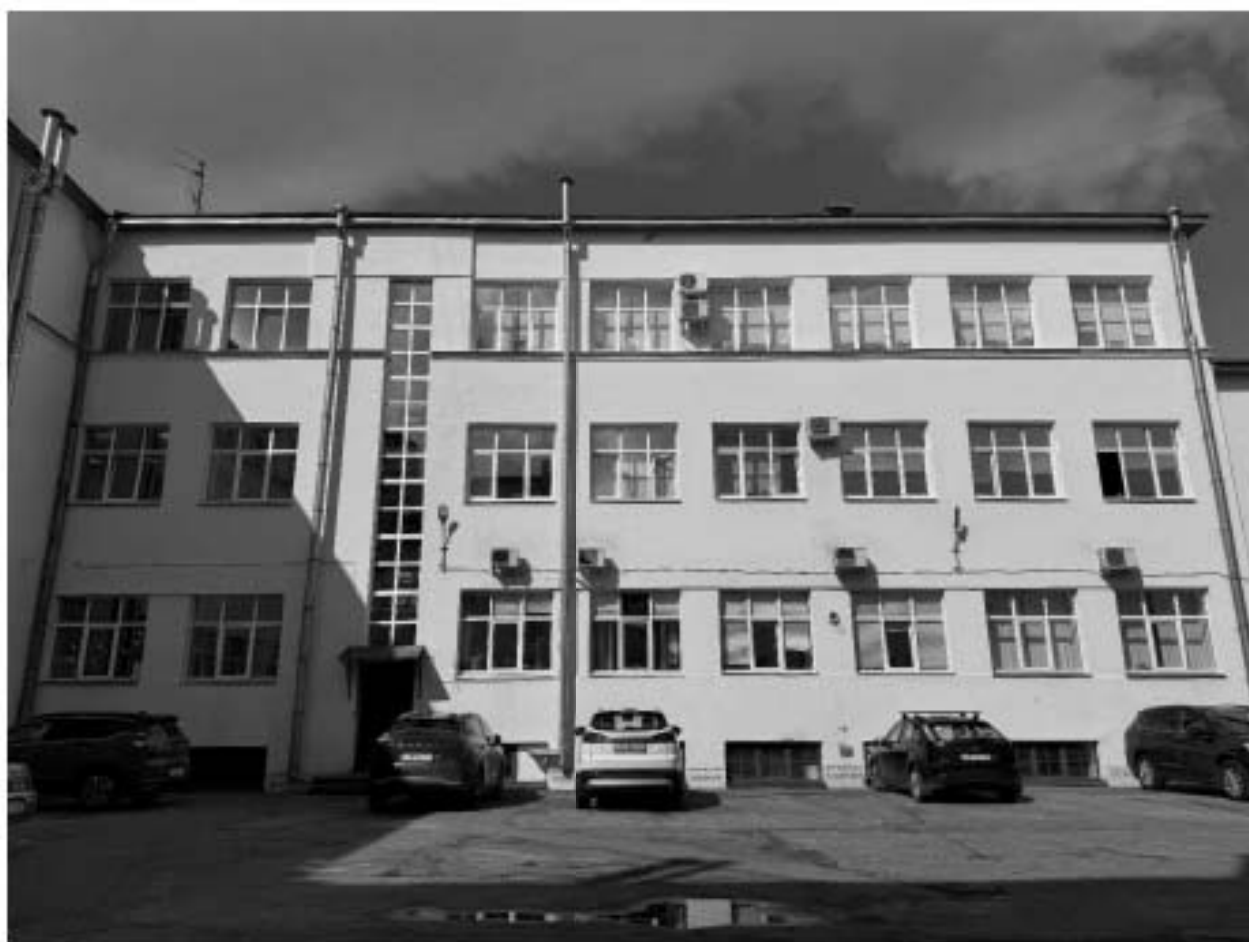
Фото 21. Вид на фасады южного двора объекта культурного наследия.
