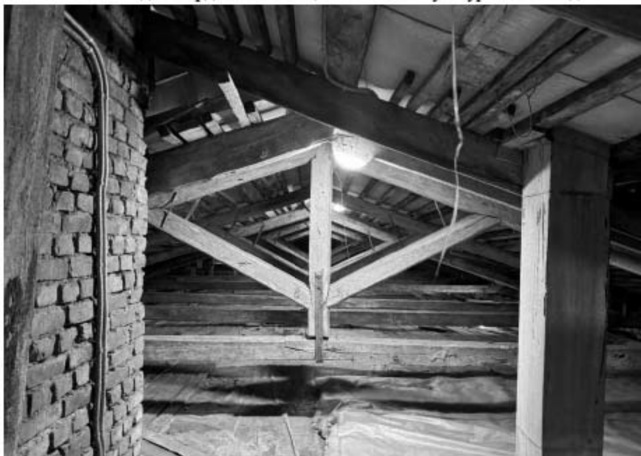
Фото 100. Вид на чердачное помещение объекта культурного наследия.
