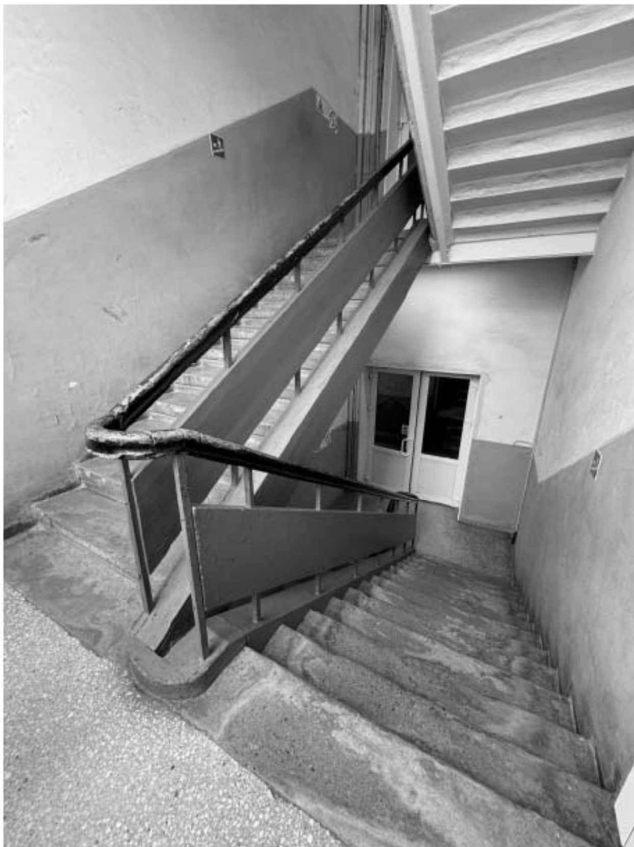
Фото 41. Вид на интерьер лестницы 3-ЛК объекта культурного наследия.
