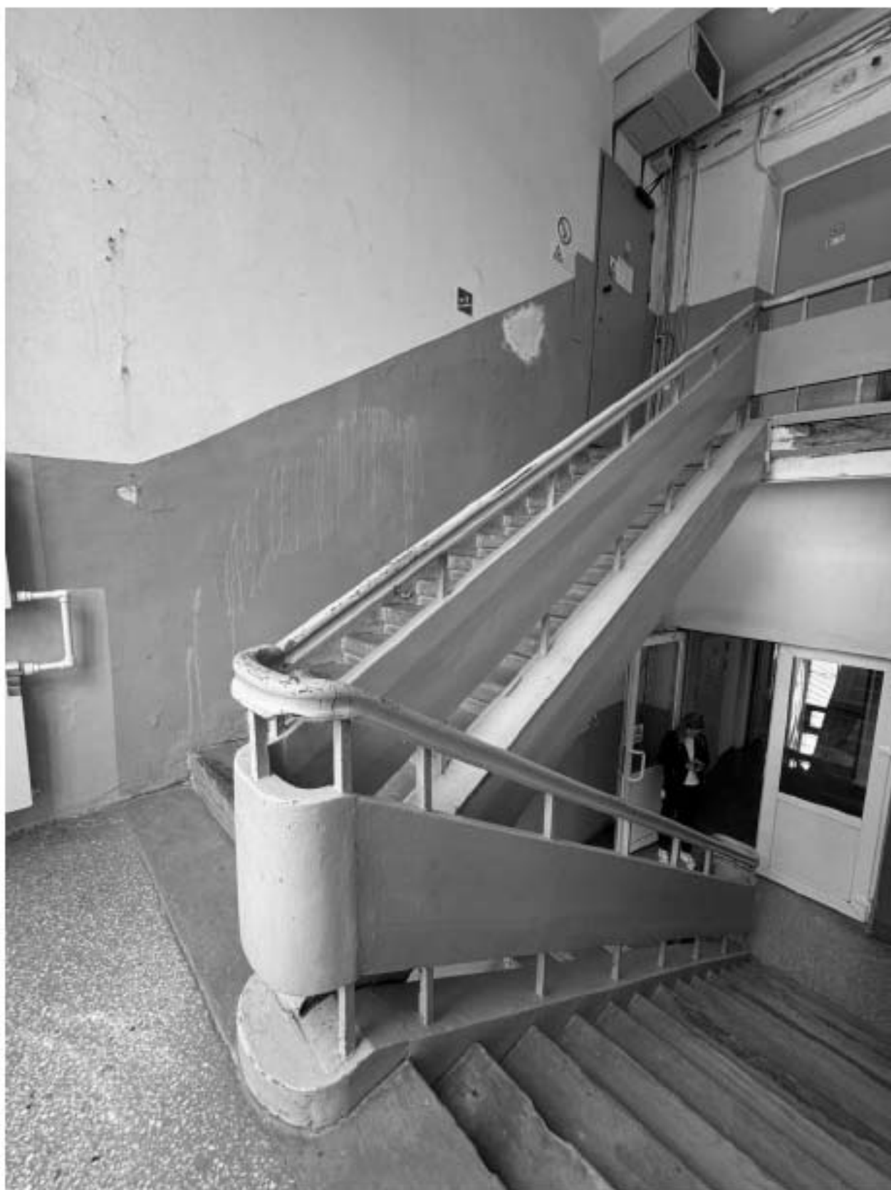
Фото 91. Вид на интерьер лестницы 1-ЛК объекта культурного наследия.
