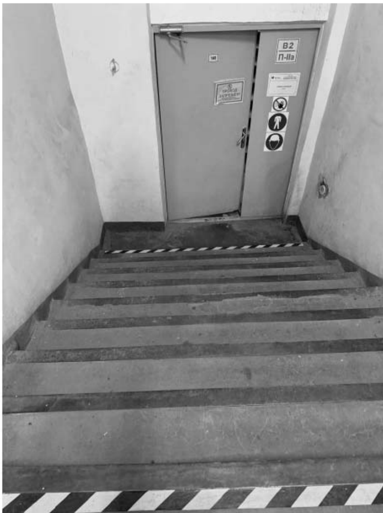
Фото 105. Вид на лестницу помещения объекта культурного наследия.
