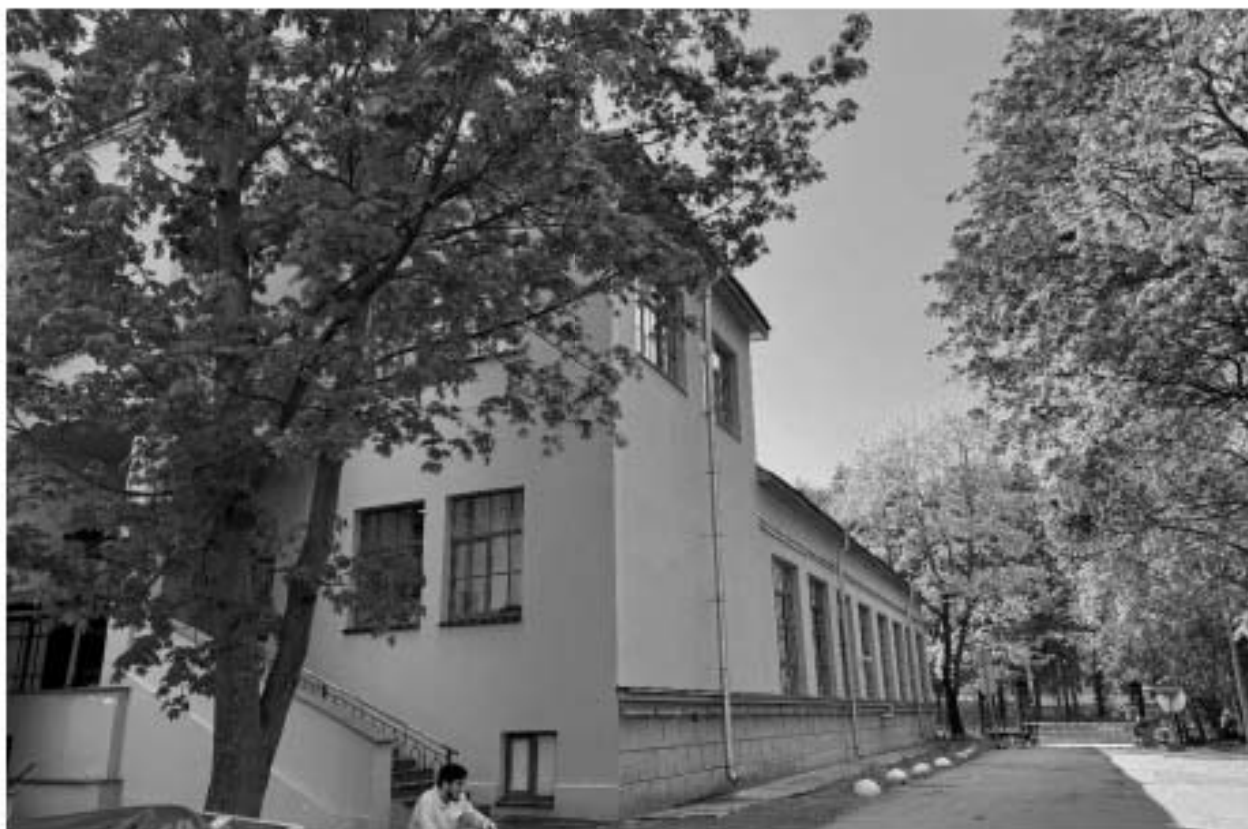
Фото 9. Фрагмент северного дворового фасада объекта культурного наследия.
