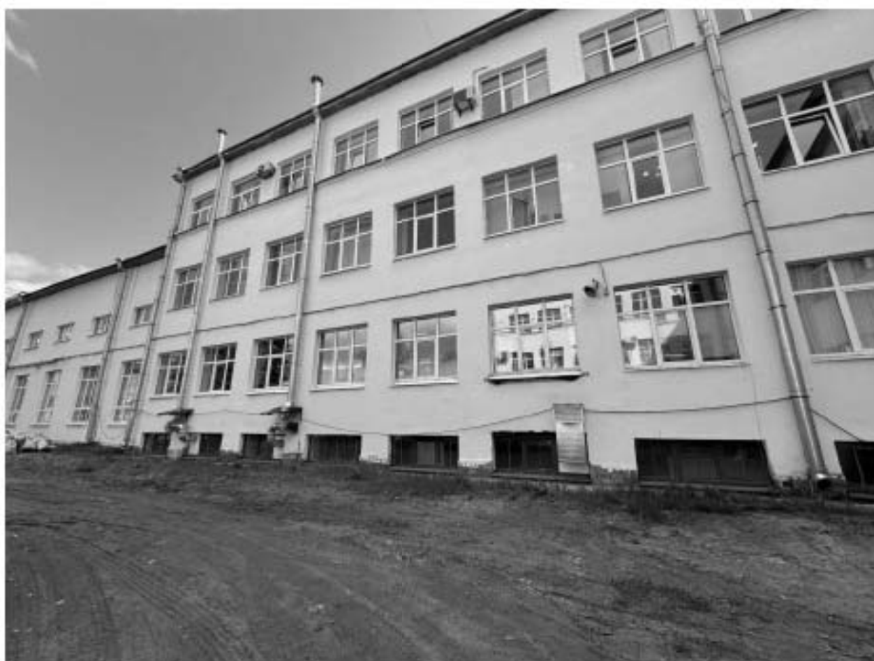
Фото 18. Вид на фасады северного двора объекта культурного наследия.
