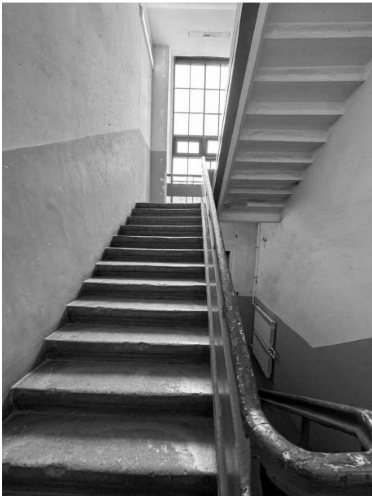
Фото 97. Вид на интерьер лестницы 1-ЛК объекта культурного наследия.
