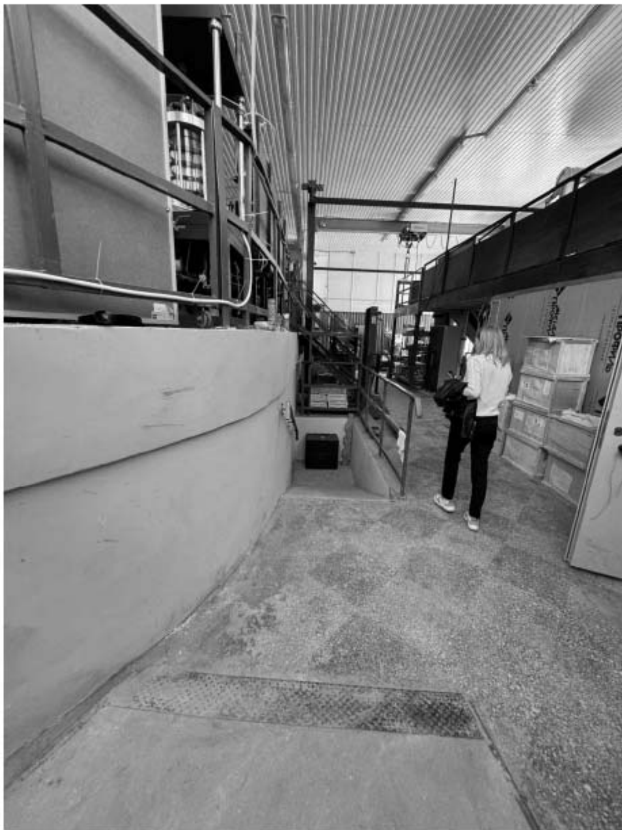
Фото 128. Вид на интерьер помещения объекта культурного наследия.
