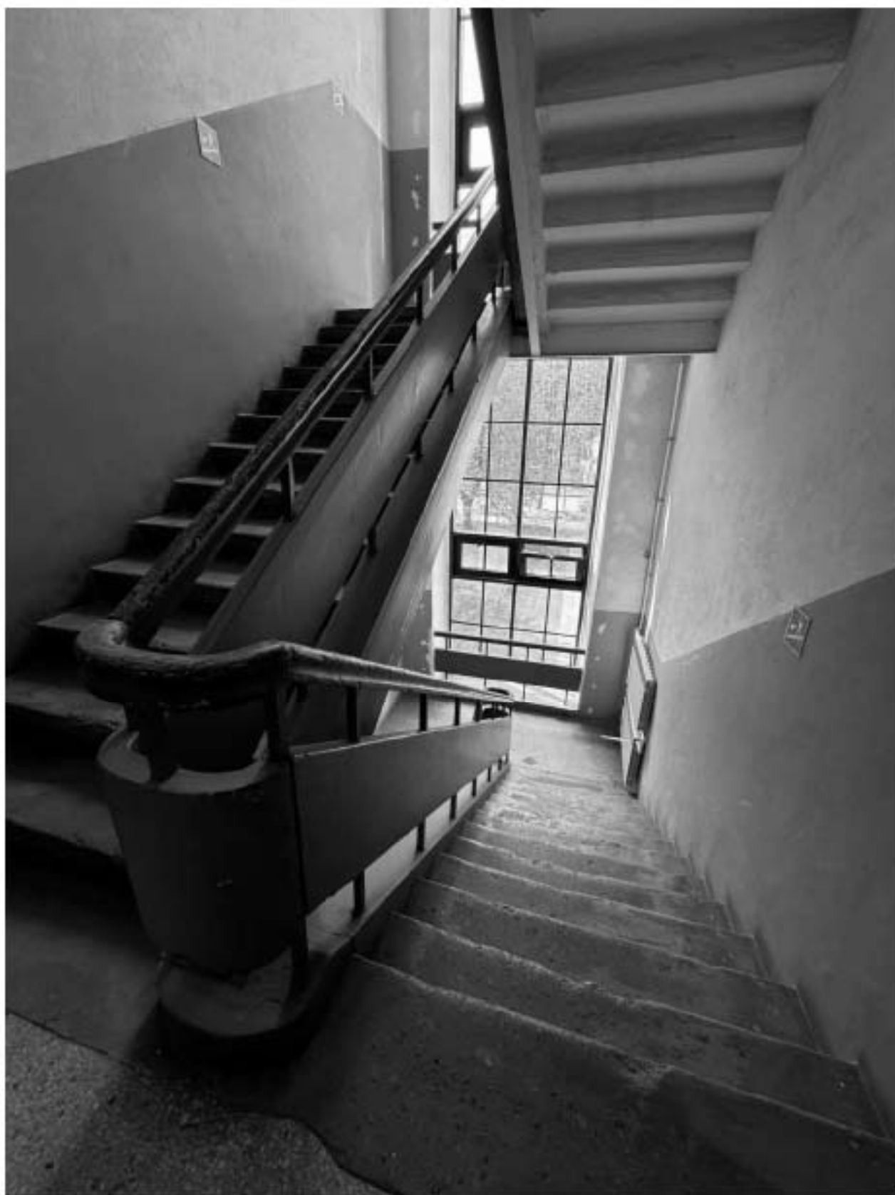
Фото 92. Вид на интерьер лестницы 1-ЛК объекта культурного наследия.
