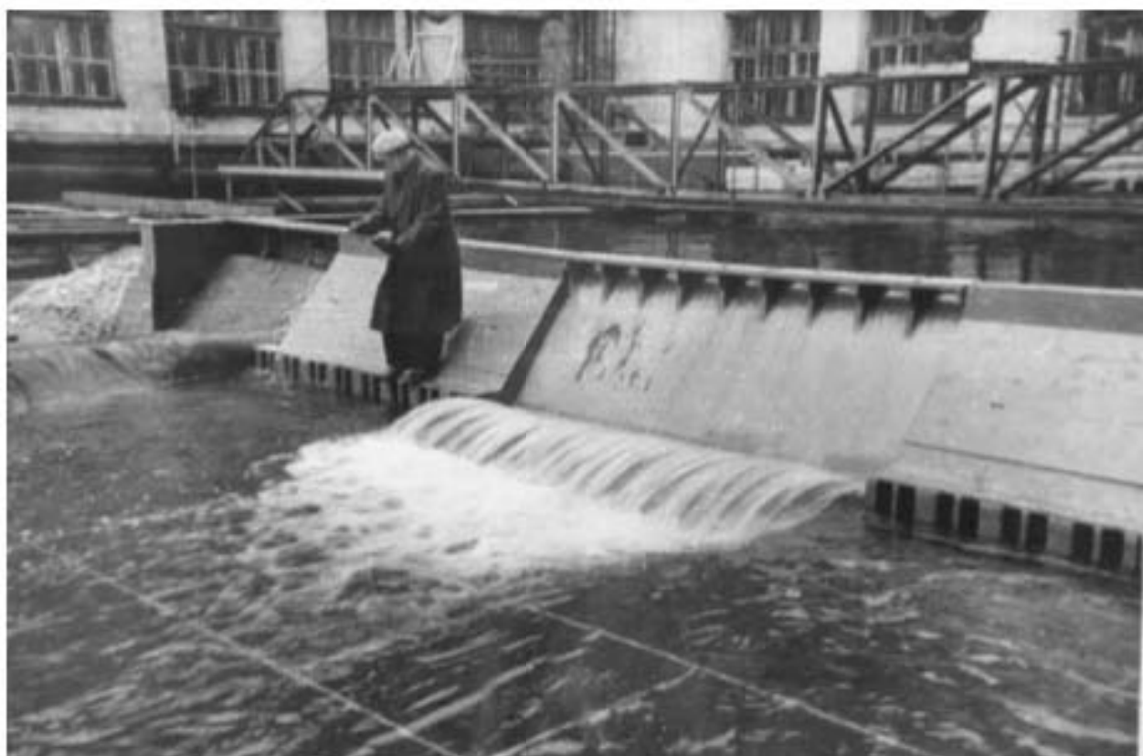
60. Проверка работы Братской ГЭС по модели. Фото 1960-х гг. По материалам музея ОАО ВНИИГ им. Б.Е. Веденеева
