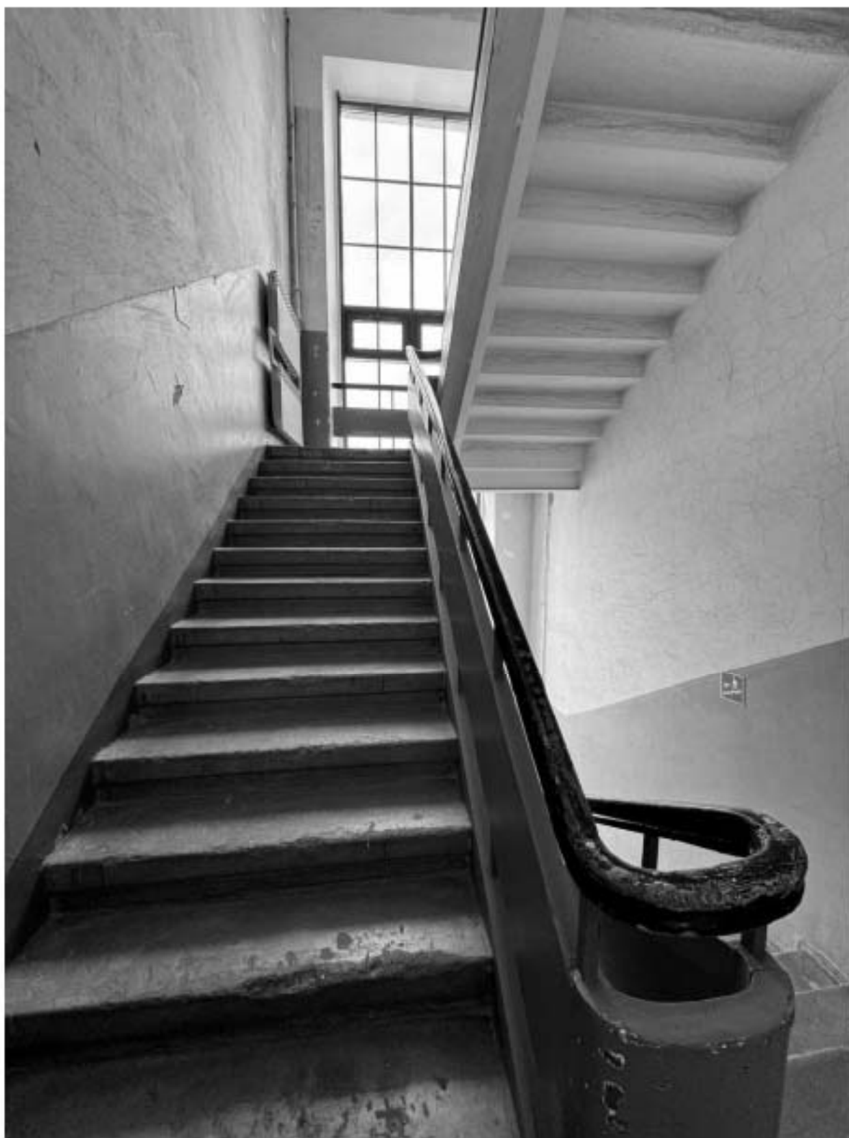
Фото 35. Вид на интерьер лестницы 3-ЛК объекта культурного наследия.
