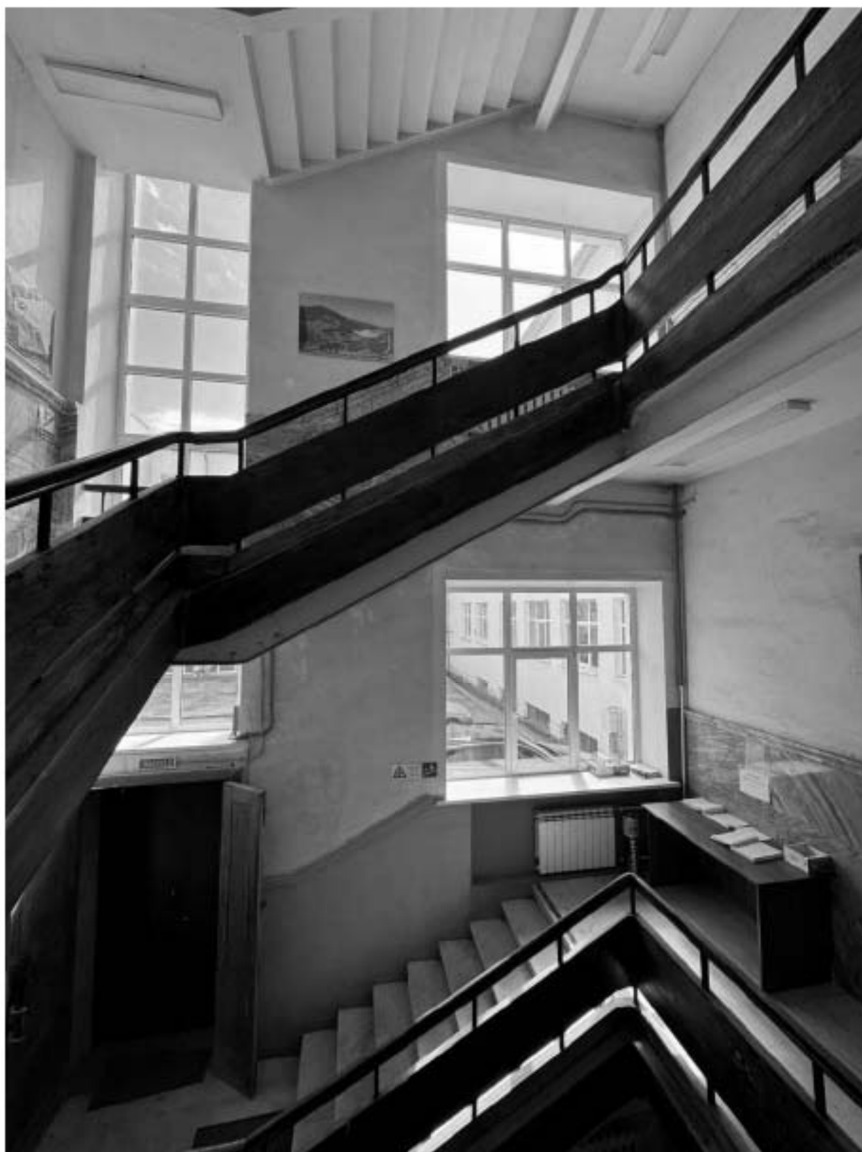
Фото 73. Вид на интерьер лестницы 2-ЛК объекта культурного наследия.
