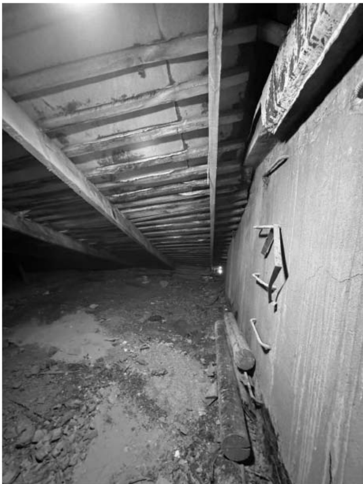
Фото 120. Вид на чердачное помещение объекта культурного наследия.
