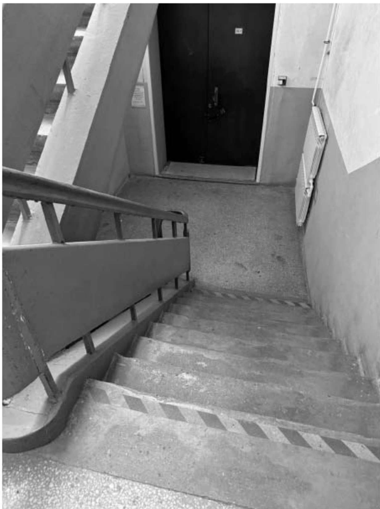
Фото 95. Вид на интерьер лестницы 1-ЛК объекта культурного наследия.
