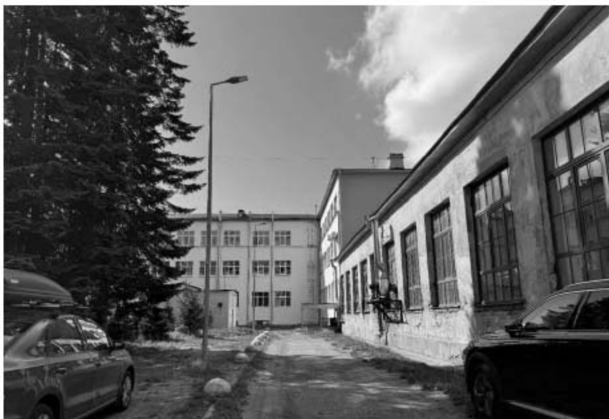
Фото 13. Вид на фасады северного двора объекта культурного наследия.
