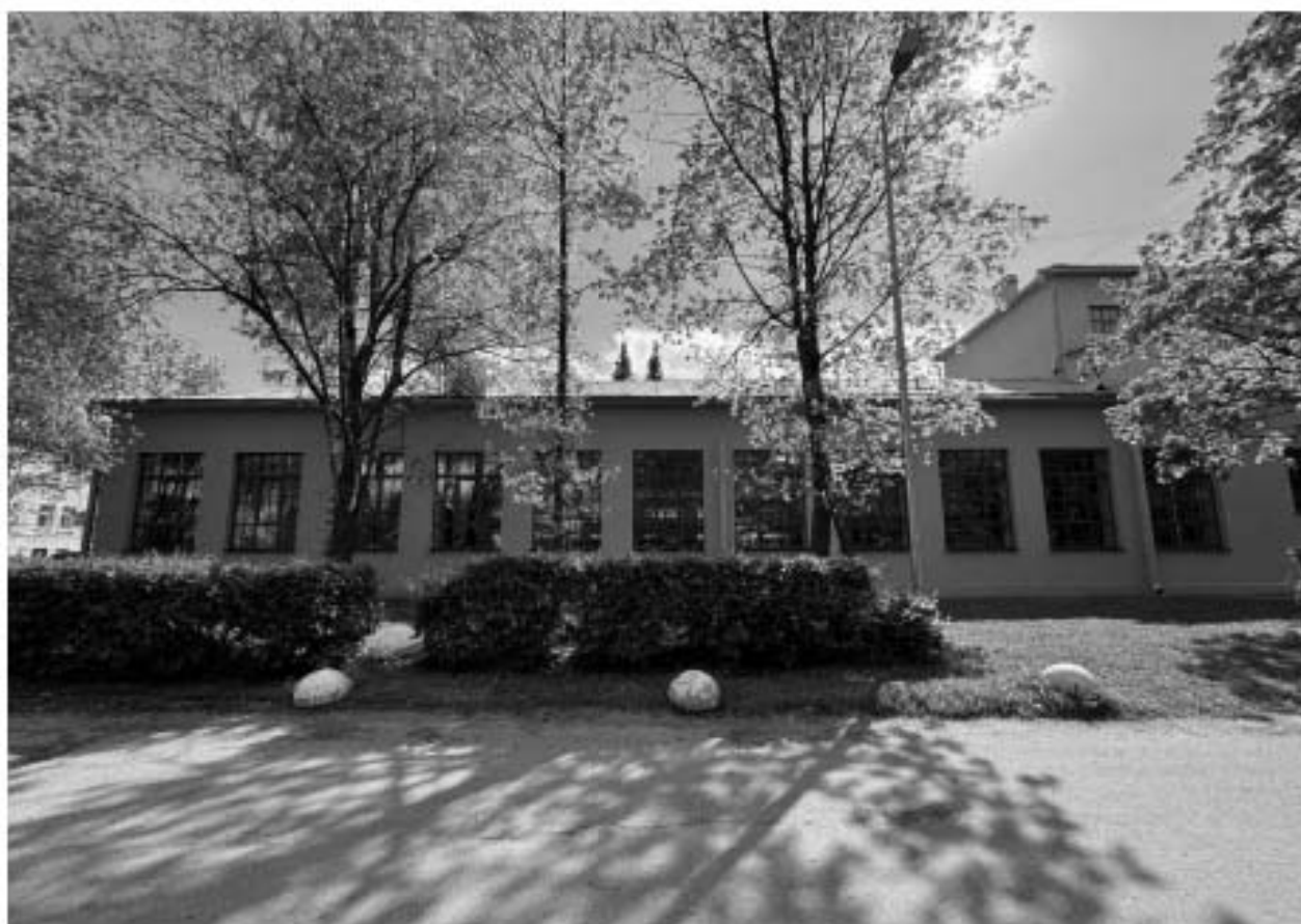
Фото 11. Фрагмент северного дворового фасада объекта культурного наследия.
