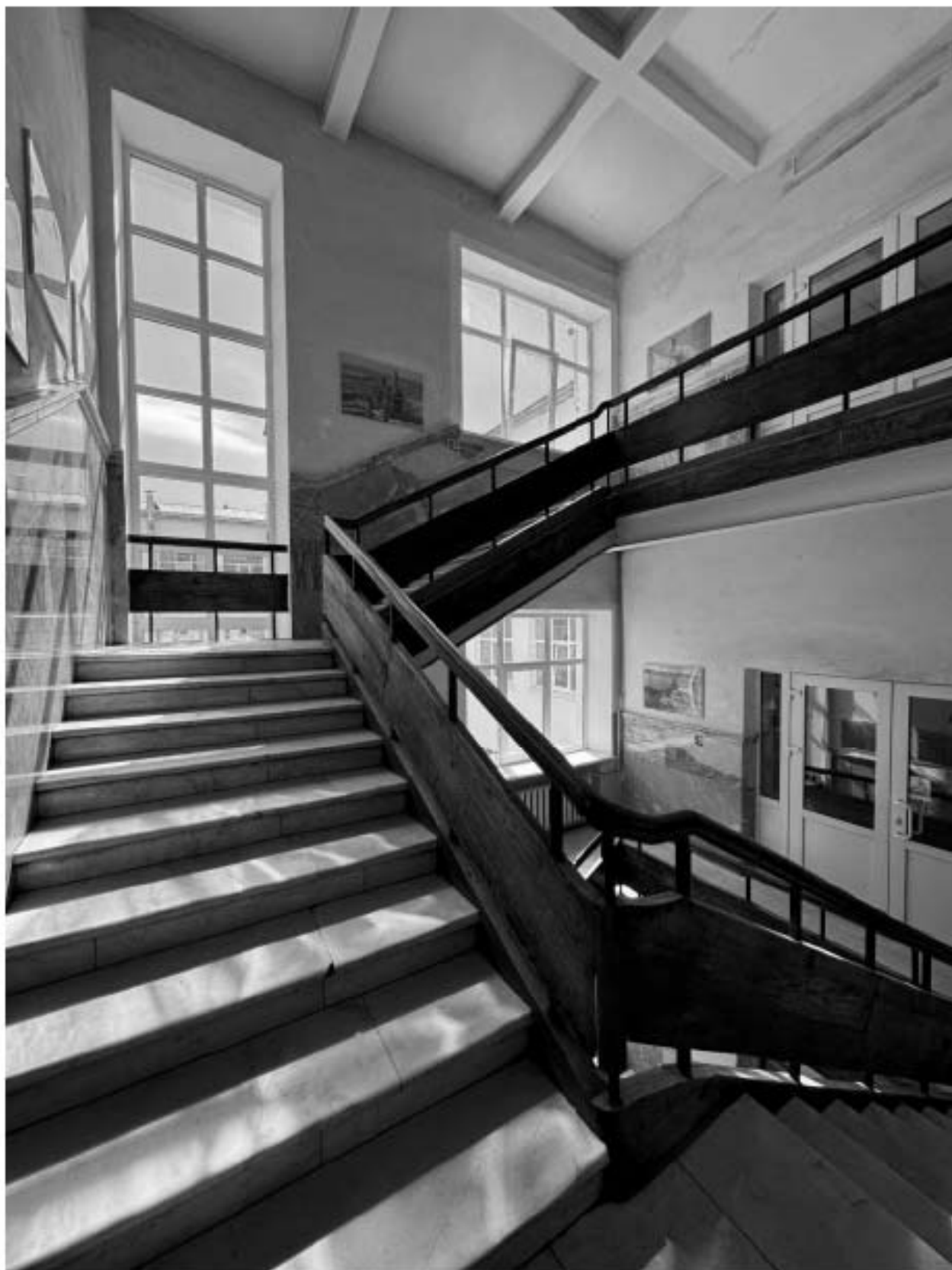
Фото 75. Вид на интерьер лестницы 2-ЛК объекта культурного наследия.
