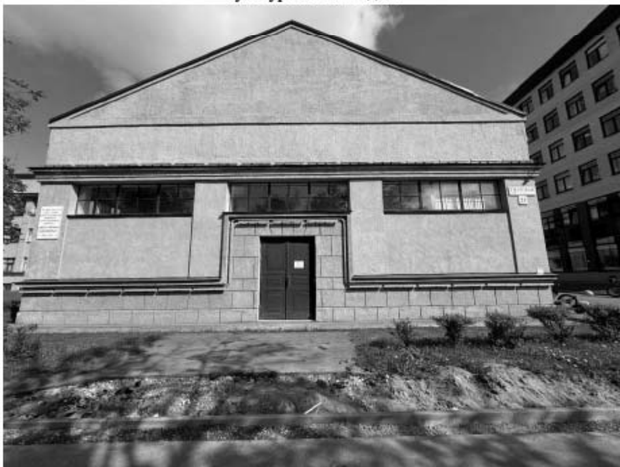
Фото 24. Вид на фрагмент лицевого фасада по Гжатской улице объекта культурного наследия.
