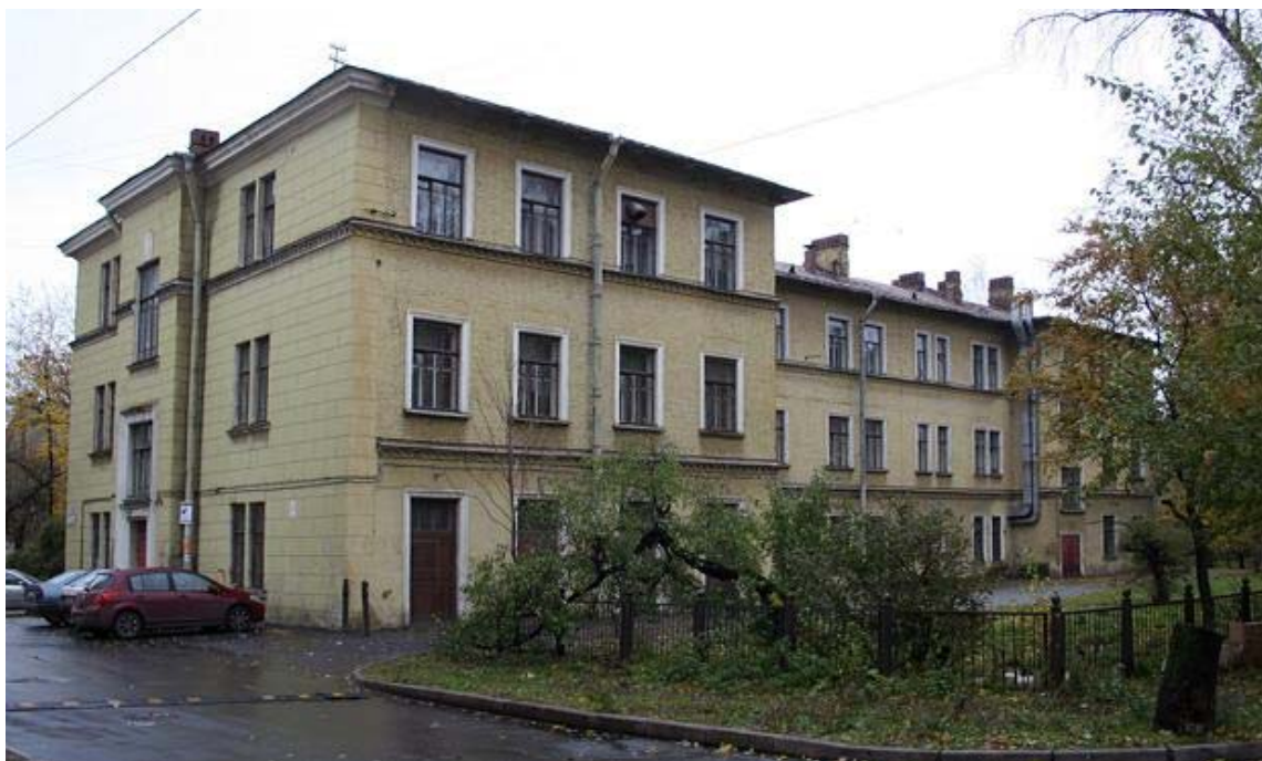
Илл. 13. Пр. Стачек, д. 34 к. 1. 2009 г. Citywalls – Архитектурный сайт Санкт-Петербурга [Электронный ресурс] URL: https://www.citywalls.ru/photo33615.html .
