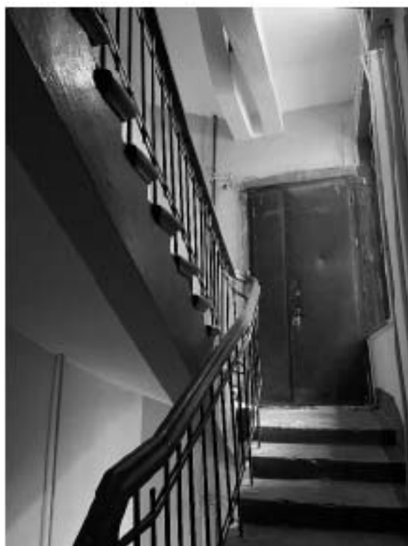
Фото 15. Вид на лестницу 2 ЛК.
