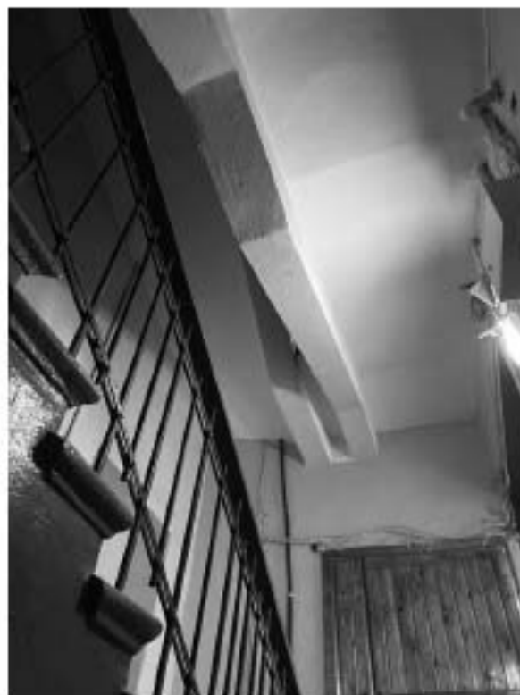
Фото 14. Вид на лестницу 2 ЛК.
