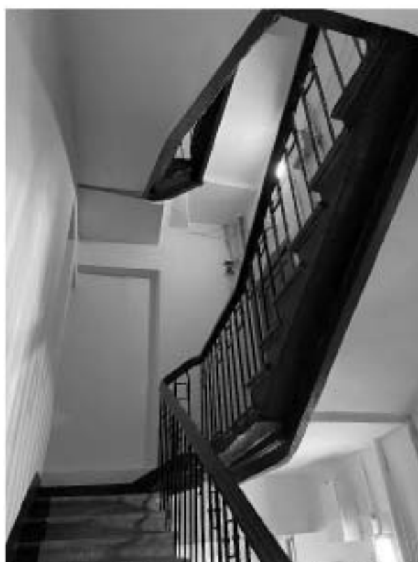
Фото 23. Вид на лестницу 3 ЛК.
