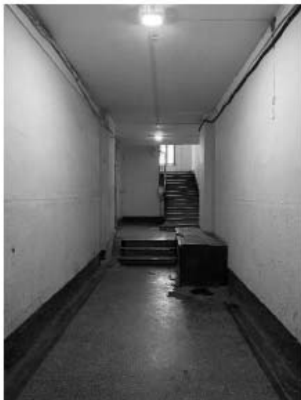
Фото 1. Вестибюль лестницы 1 ЛК.
