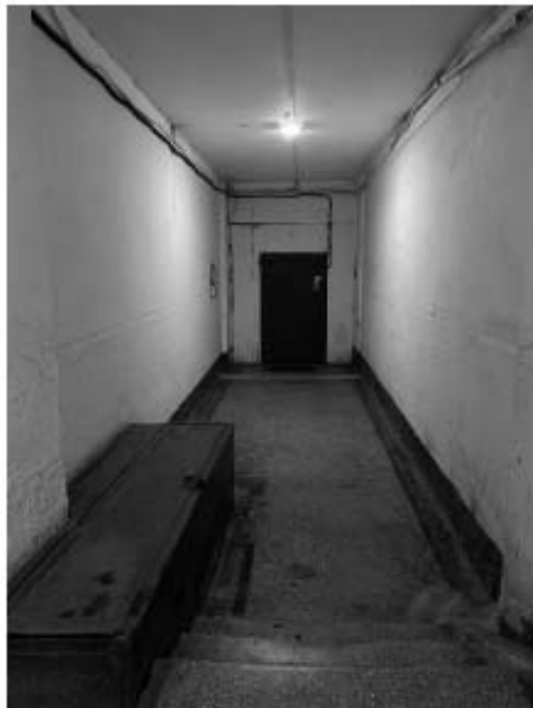
Фото 2. Вестибюль лестницы 1 ЛК.
