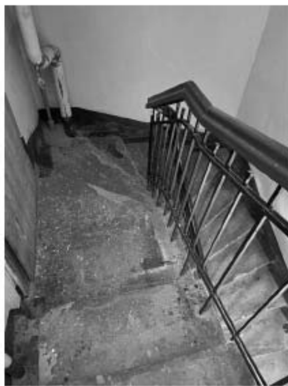
Фото 18. Вид на лестницу 2 ЛК.
