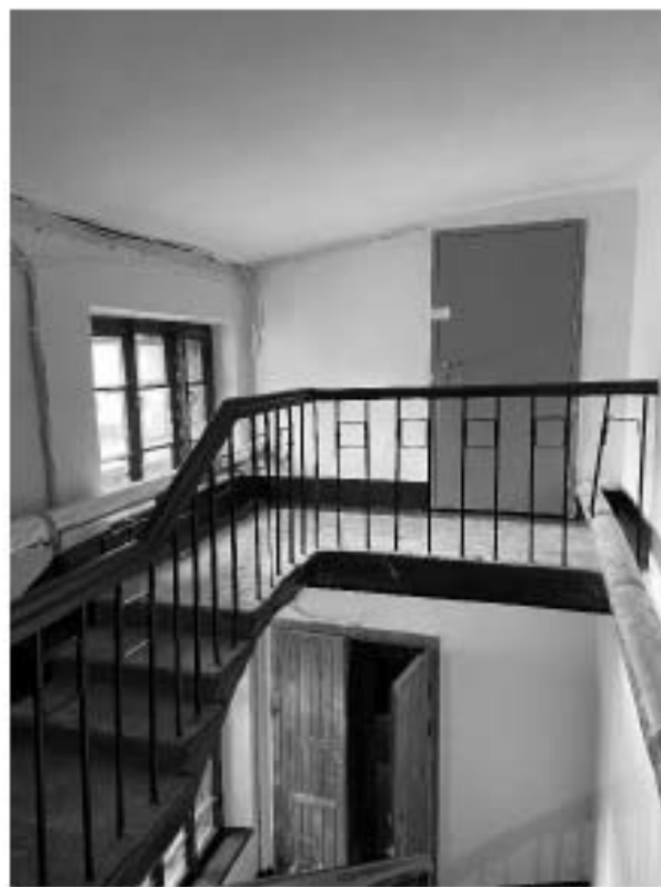
Фото 26. Вид на лестницу 3 ЛК.
