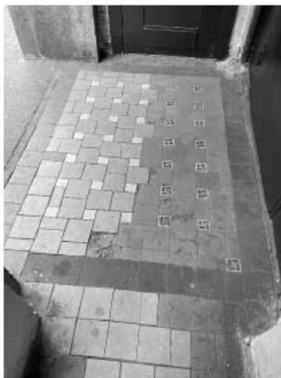
Фото 5. Покрытие пола лоджии метлахской плиткой.
