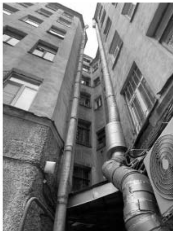
Фото 11. Фрагмент дворовых фасадов.
