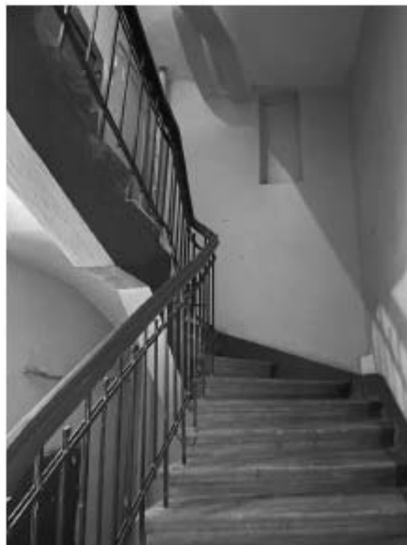
Фото 16. Вид на лестницу 2 ЛК.
