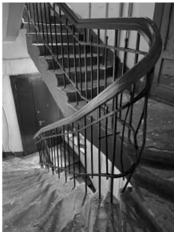
Фото 13. Вид на лестницу 2 ЛК.
