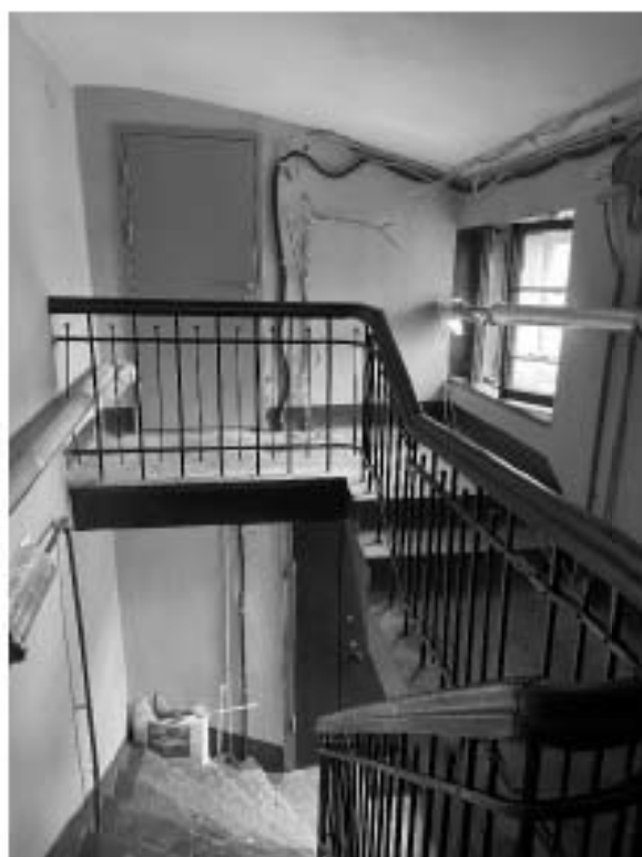
Фото 17. Вид на лестницу 2 ЛК.
