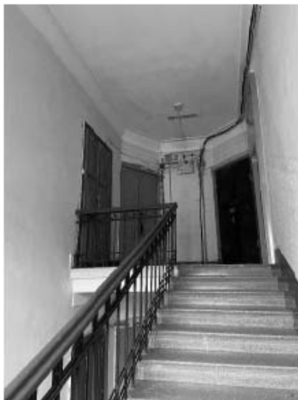
Фото 9. Вид на лестницу 1 ЛК.
