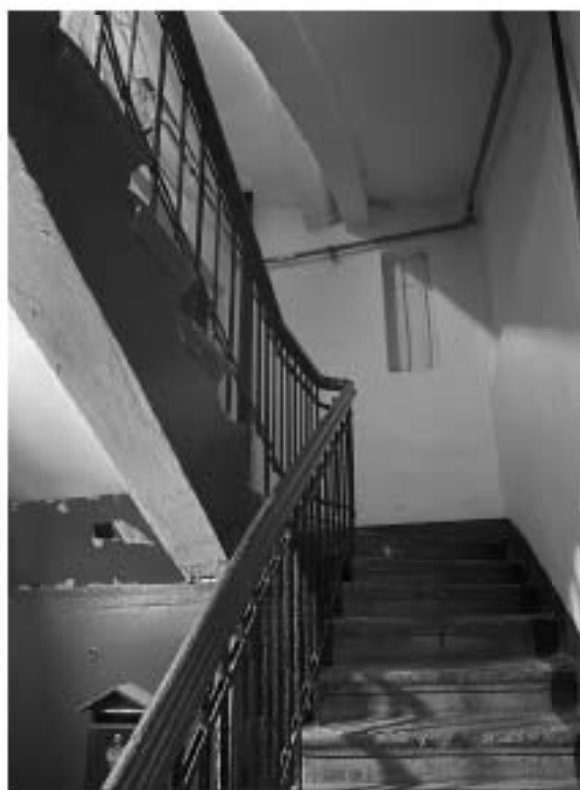
Фото 11. Вид на лестницу 2 ЛК.
