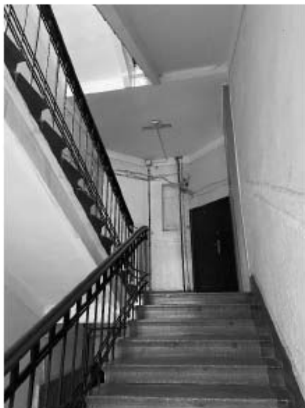
Фото 5. Вид на лестницу 1 ЛК.
