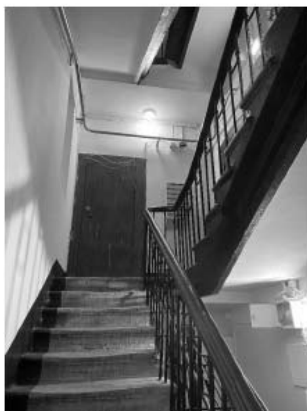
Фото 20. Вид на лестницу 3 ЛК.
