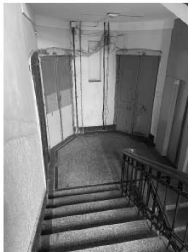
Фото 8. Вид на лестницу 1 ЛК.
