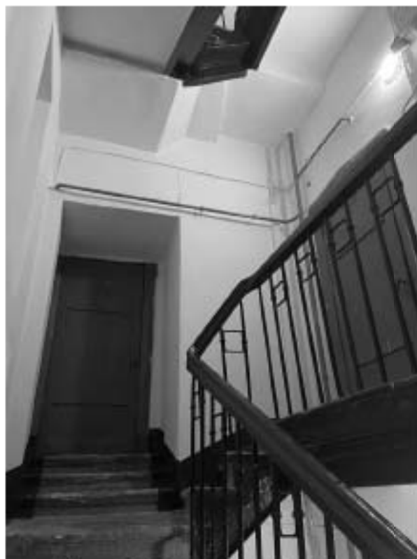
Фото 25. Вид на лестницу 3 ЛК.
