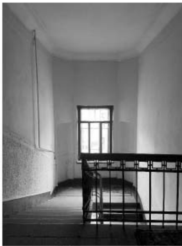
Фото 10. Вид на лестницу 1 ЛК.
