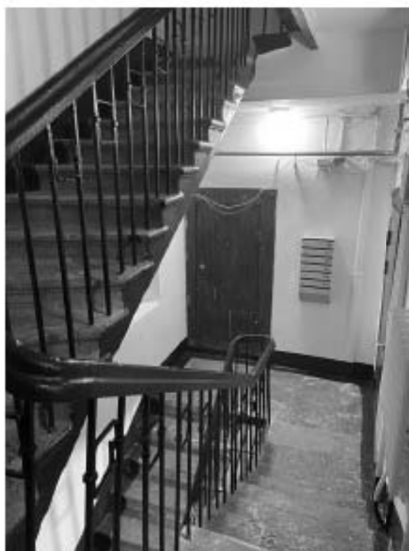
Фото 21. Вид на лестницу 3 ЛК.
