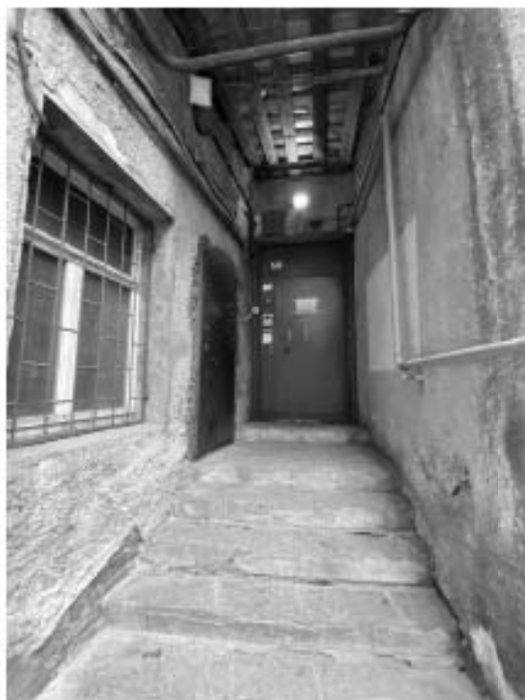
Фото 10. Крыльцо, ведущее к черной лестнице.
