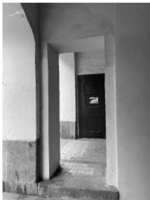
Фото 4. Вид на лоджию парадного входа.
