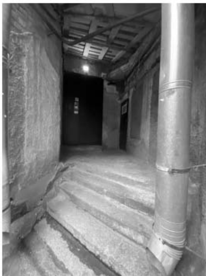
Фото 12. Крыльцо, ведущее к черной лестнице.
