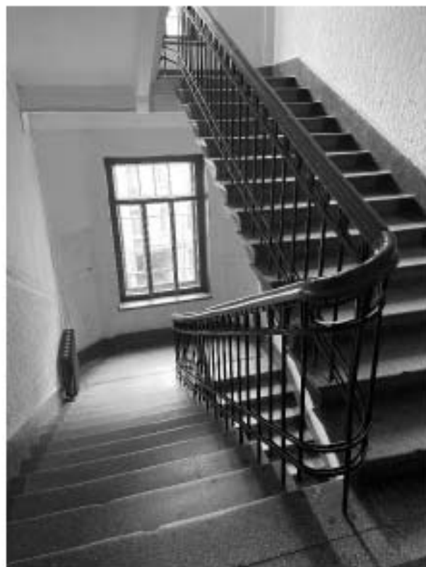
Фото 6. Вид на лестницу 1 ЛК.
