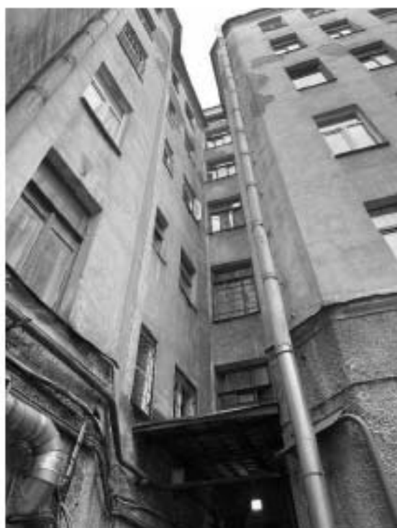
Фото 9. Фрагмент дворовых фасадов.
