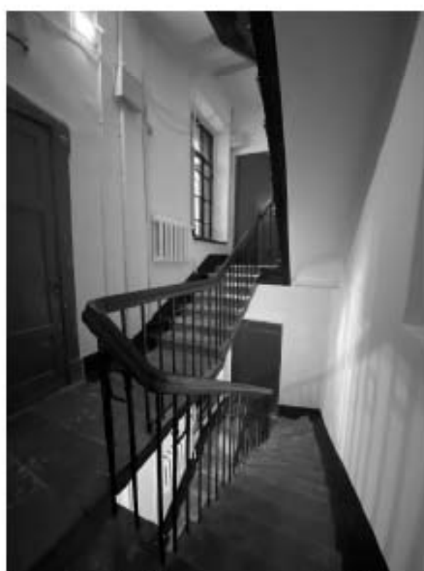
Фото 24. Вид на лестницу 3 ЛК.
