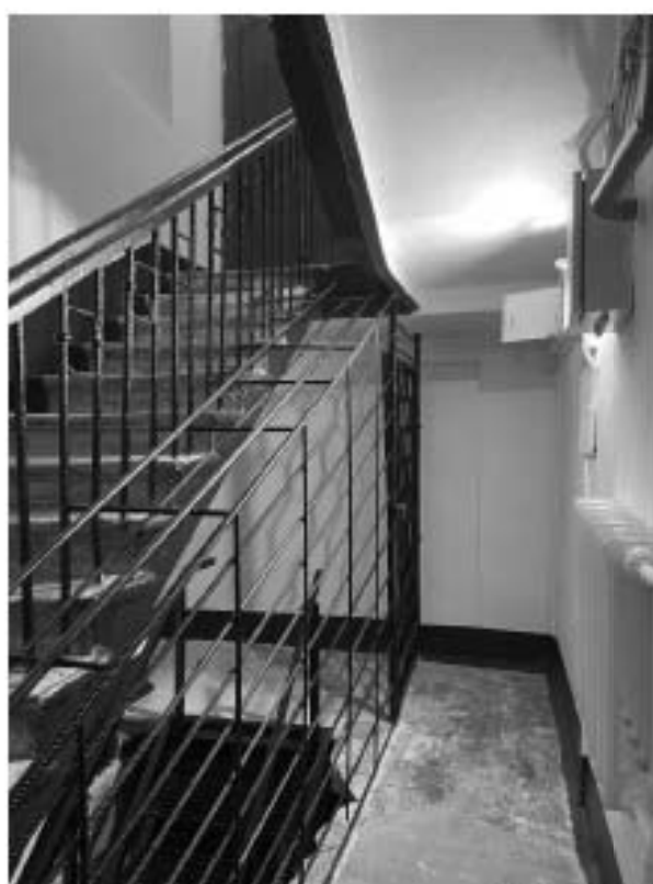
Фото 19. Вид на лестницу 3 ЛК.
