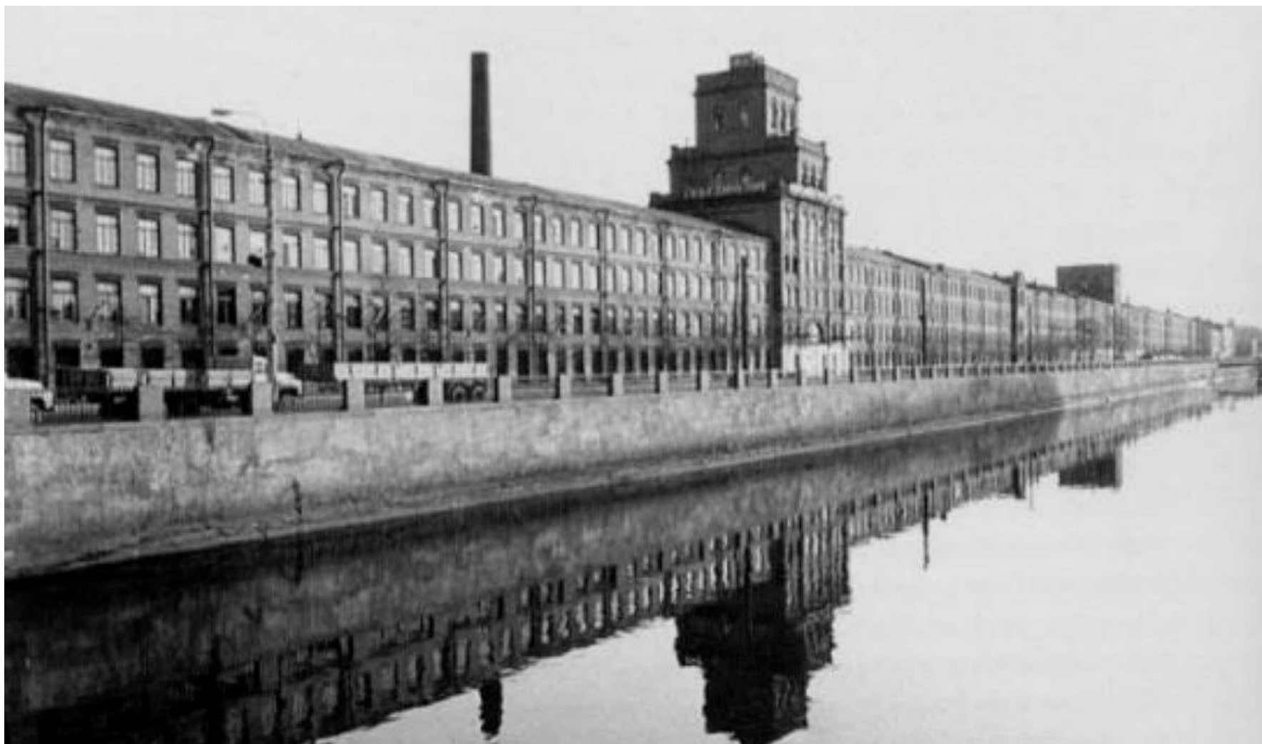
35. 1980-1990 гг. Вид завода Красный треугольник. Современные корпуса №№ 53, 54, 63, 67 слева – направо) https://pastvu.com/p/115036
