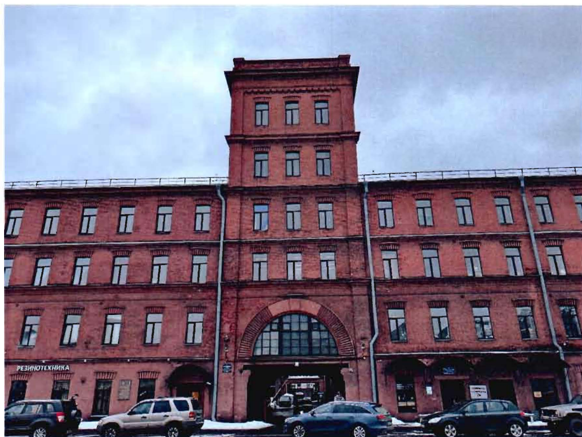
2. Северный лицевой фасад объекта культурного наследия.
