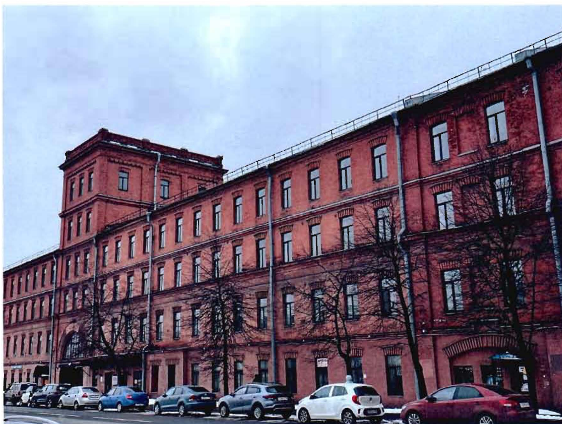
1. Северный лицевой фасад объекта культурного наследия.
