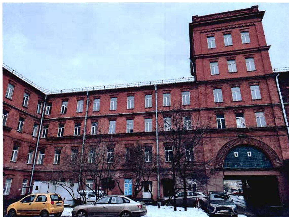
3. Южный дворовой фасад объекта культурного наследия.
