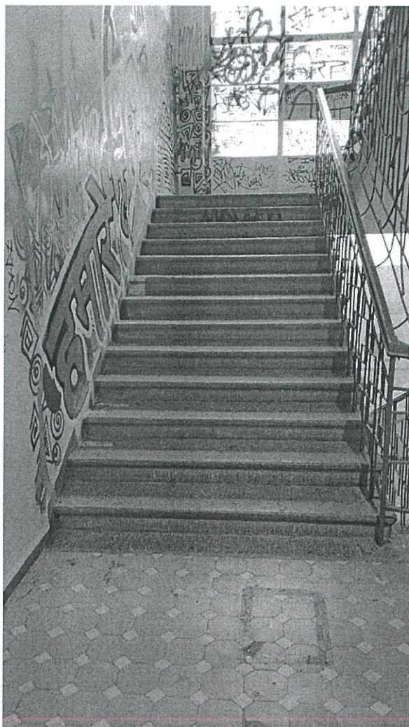
22. Общий вид лестничной клетки юго-восточной части здания.
