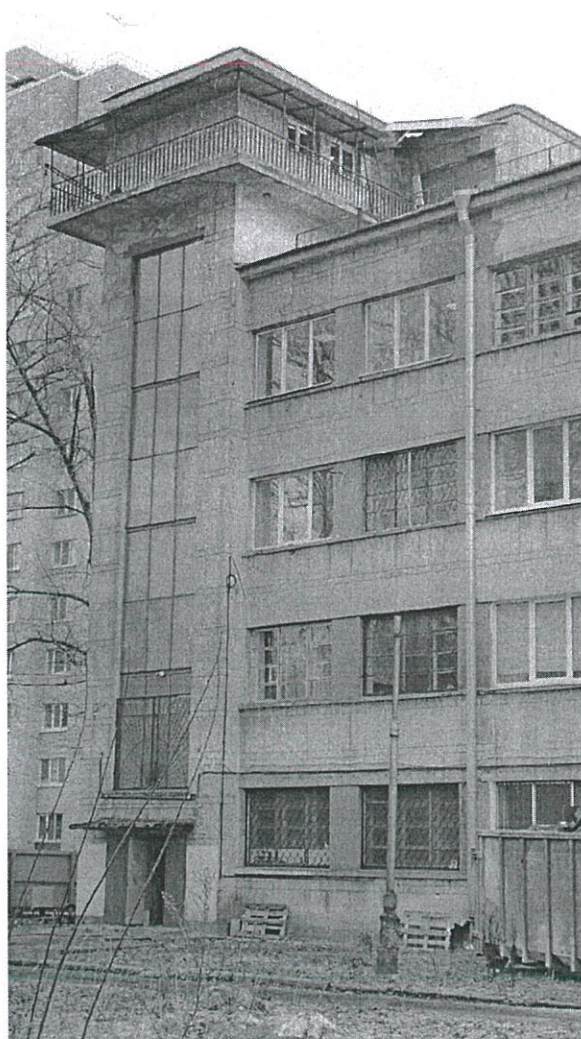
9. Фрагмент юго-восточной части здания.
