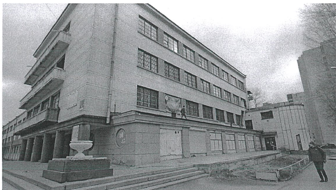
3. Вид южного фасада Объекта (юго-западная часть здания).
