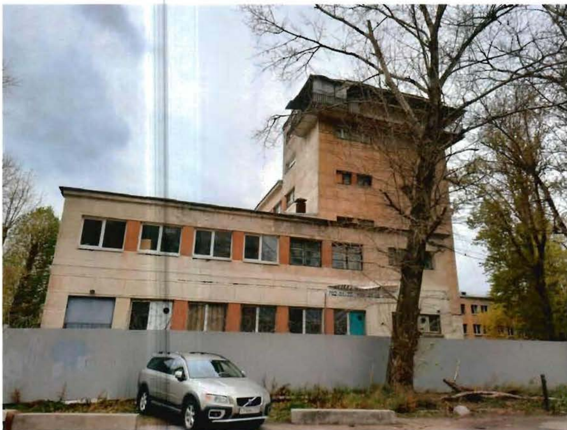
5. Вид на восточный фасад объекта культурного наследия
