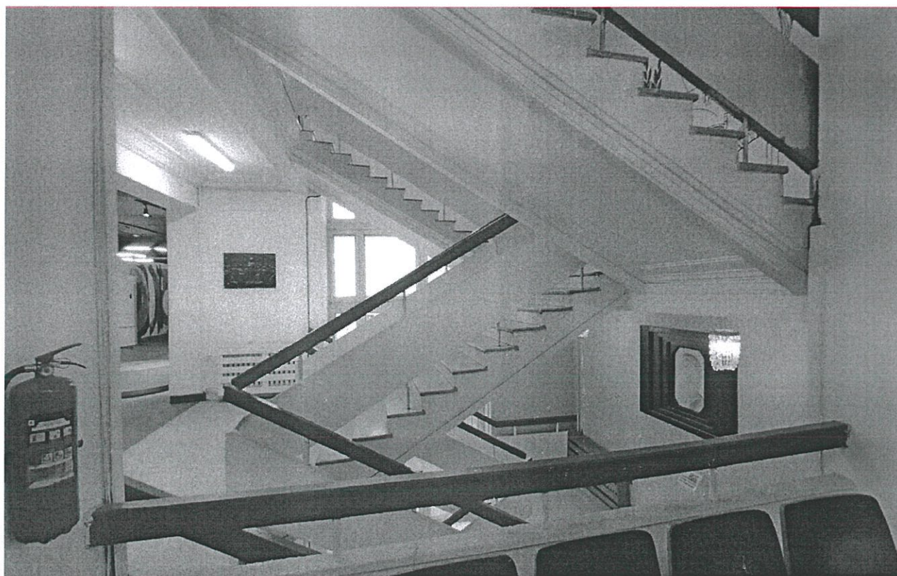
15. Общий вид центральной лестницы в уровне третьего этажа
