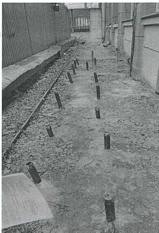
10. Фрагмент отмостки здания в процессе проведения работ по усилению основания
