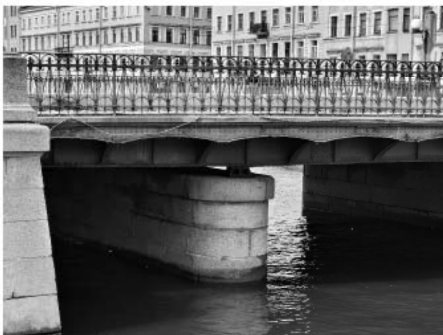
4. «Мост Аларчин» входящий в состав комплекса «Набережные и мосты Екатерининского канала (ныне канала Грибоедова)», через канал Грибоедова по Английскому проспекту. Восточный фасад. Фрагмент. Фото 09.07.2025г.
