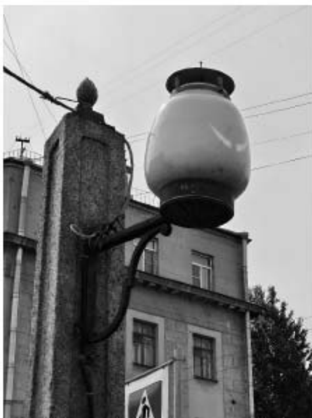
28. «Мост Аларчин» входящий в состав комплекса «Набережные и мосты Екатерининского канала (ныне канала Грибоедова)», через канал Грибоедова по Английскому проспекту. Фрагмент. Фото 09.07.2025г.
