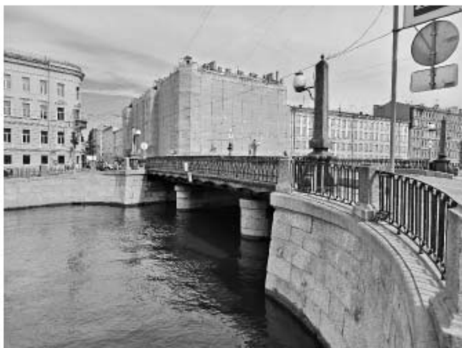
9. «Мост Аларчин» входящий в состав комплекса «Набережные и мосты Екатерининского канала (ныне канала Грибоедова)», через канал Грибоедова по Английскому проспекту. Западный фасад. Общий вид. Фото 09.07.2025г.
