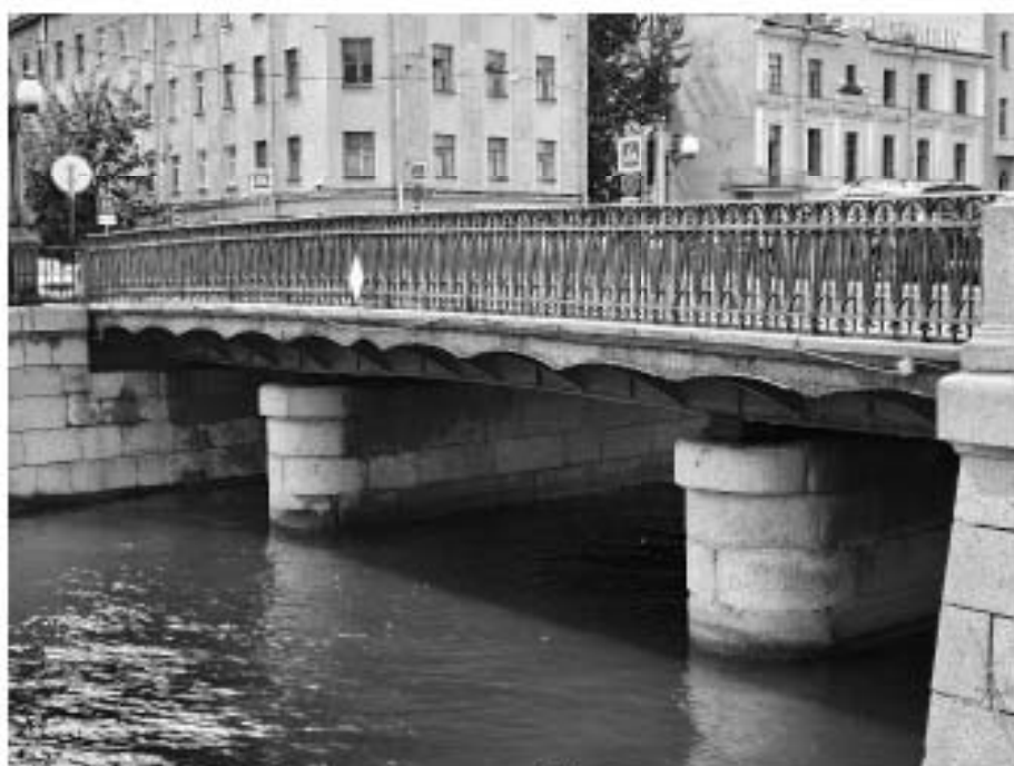
8. «Мост Аларчин» входящий в состав комплекса «Набережные и мосты Екатерининского канала (ныне канала Грибоедова)», через канал Грибоедова по Английскому проспекту. Восточный фасад. Фрагмент. Фото 09.07.2025г.
