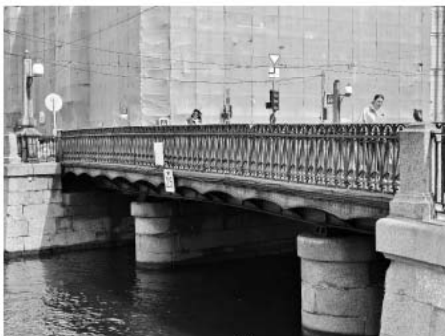
10. «Мост Аларчин» входящий в состав комплекса «Набережные и мосты Екатерининского канала (ныне канала Грибоедова)», через канал Грибоедова по Английскому проспекту. Западный фасад. Фрагмент. Фото 09.07.2025г.
