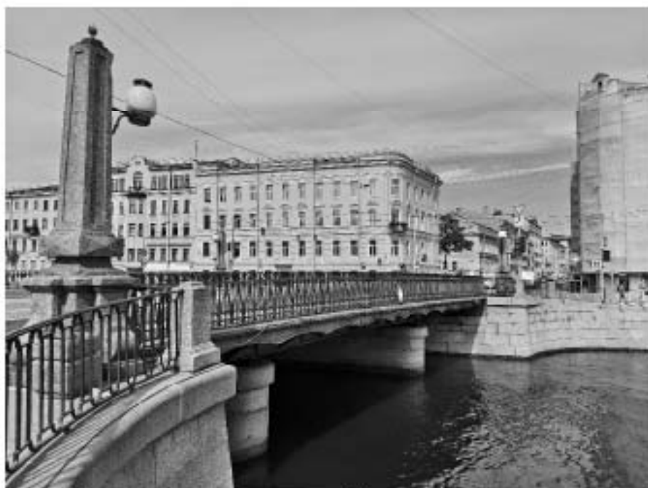
12. «Мост Аларчин» входящий в состав комплекса «Набережные и мосты Екатерининского канала (ныне канала Грибоедова)», через канал Грибоедова по Английскому проспекту. Фрагмент. Фото 09.07.2025г.
