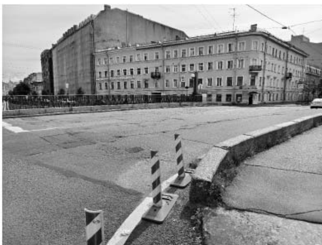
2. «Мост Аларчин» входящий в состав комплекса «Набережные и мосты Екатерининского канала (ныне канала Грибоедова)», через канал Грибоедова по Английскому проспекту. Общий вид с северо-запада. Фото 09.07.2025г.
