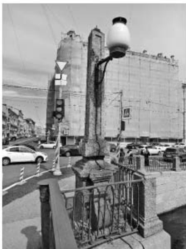
19. «Мост Аларчин» входящий в состав комплекса «Набережные и мосты Екатерининского канала (ныне канала Грибоедова)», через канал Грибоедова по Английскому проспекту. Фрагмент. Фото 09.07.2025г.
