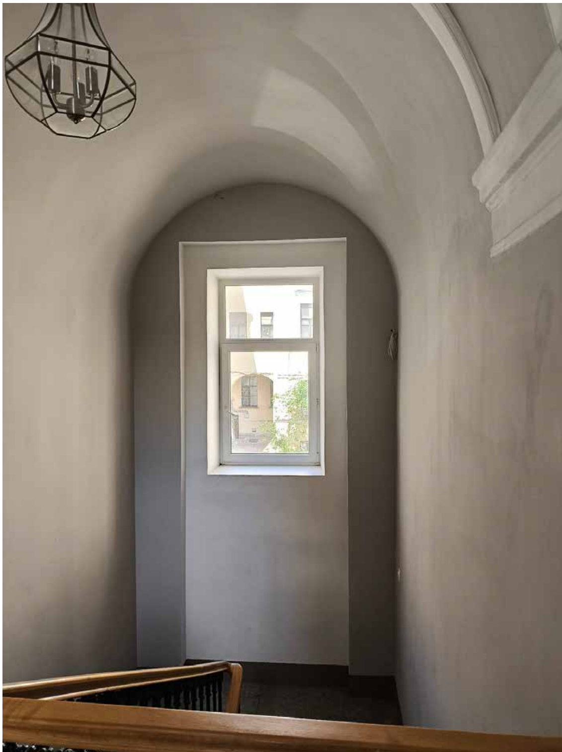
44. Выявленный объект культурного наследия «Дом С. Крамера (Г.А. Лепена)», по адресу: г. Санкт-Петербург, Морская Большая ул., 50; Мойки р. наб., 95. Фрагмент пом. 2ЛК (3) в уровне 2-го этажа юго-восточного лицевого корпуса по набережной реки Мойки. Цилиндрический свод перекрытия над междуэтажной площадкой между 1-м и 2-м этажами. Дата съёмки: 03.07.2025.
