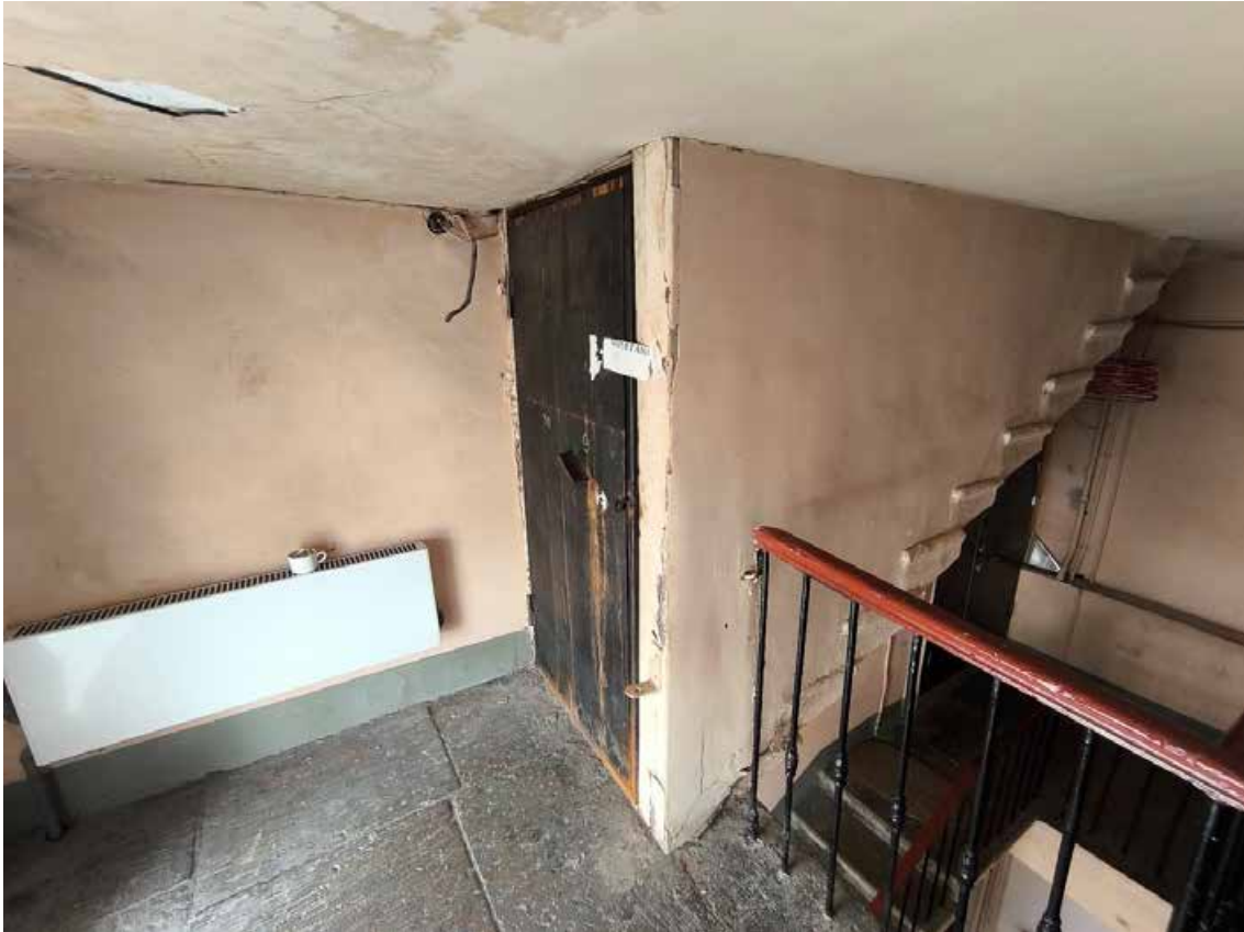
57.Выявленный объект культурного наследия «Дом С. Крамера (Г.А. Лепена)», по адресу: г. Санкт-Петербург, Морская Большая ул., 50; Мойки р. наб., 95. Фрагмент междуэтажной площадки ЗЛК в уровне 4-го этажа северо-восточного дворового флигеля. Дата съёмки: 03.07.2025.
