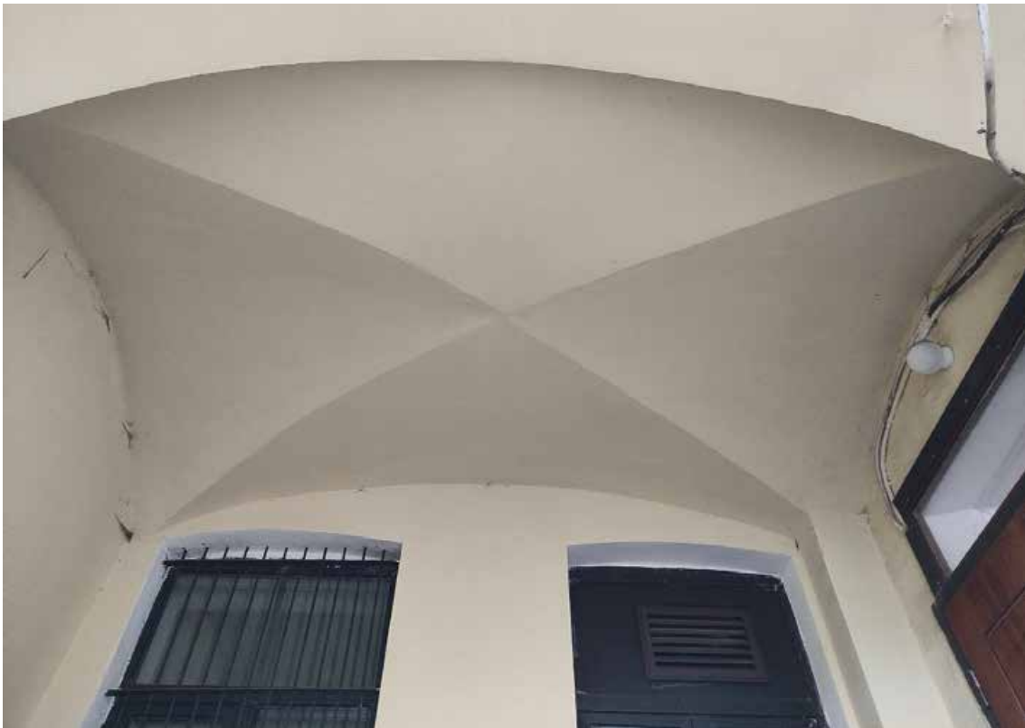
20. Выявленный объект культурного наследия «Дом С. Крамера (Г.А. Лепена)», по адресу: г. Санкт-Петербург, Морская Большая ул., 50; Мойки р. наб., 95. Фрагмент юго-восточного дворового фасада лицевого корпуса по Большой Морской улице. Крестовый свод в нише, расположенной по 6-7 осям фасада. Дата съёмки: 19.06.2025.
