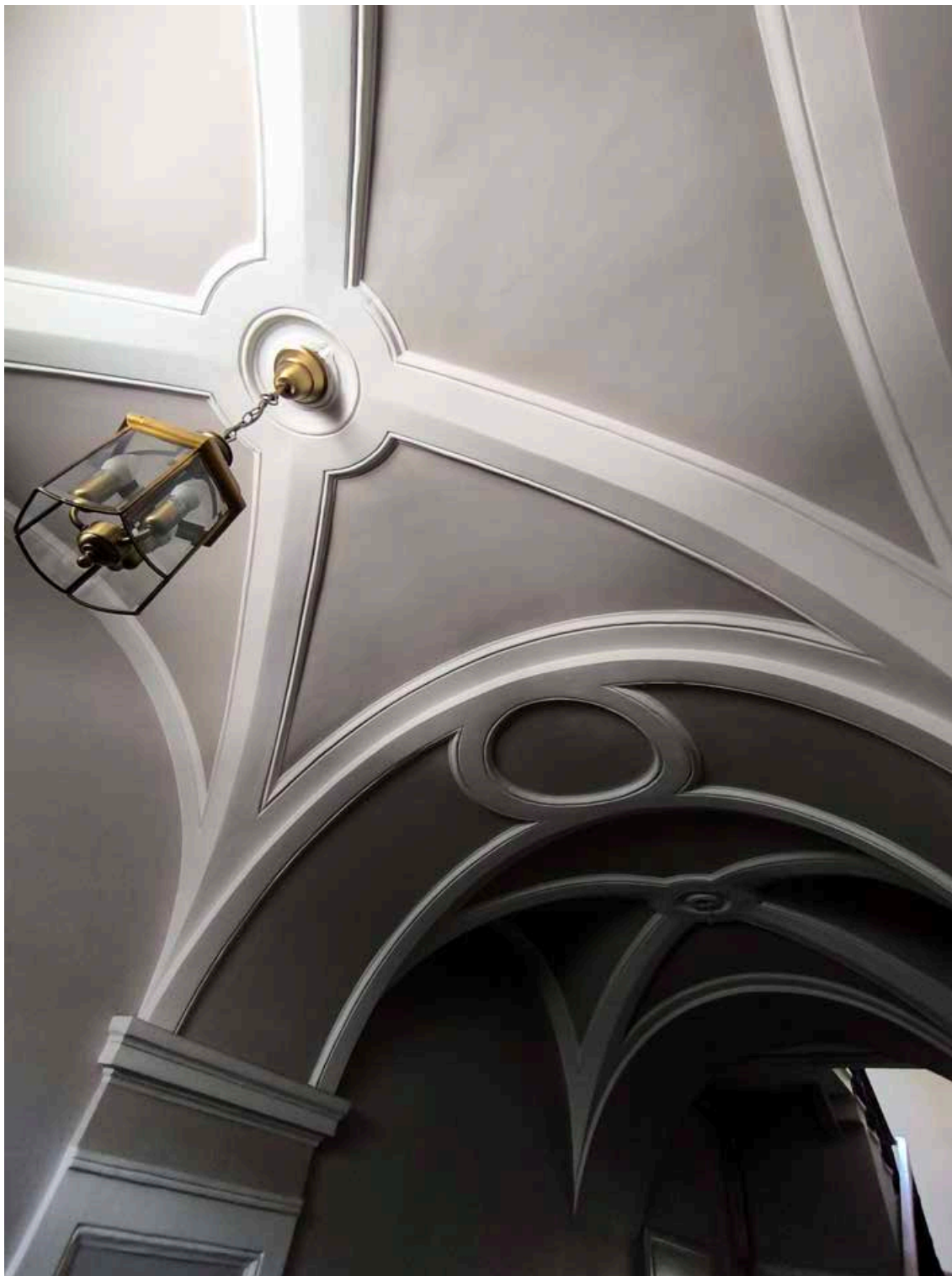
40. Выявленный объект культурного наследия «Дом С. Крамера (Г.А. Лепена)», по адресу: г. Санкт-Петербург, Морская Большая ул., 50; Мойки р. наб., 95. Крестовые своды перекрытия пом. 2ЛК (1) в уровне 1-го этажа юго-восточного лицевого корпуса по набережной реки Мойки. Дата съёмки: 03.07.2025.
