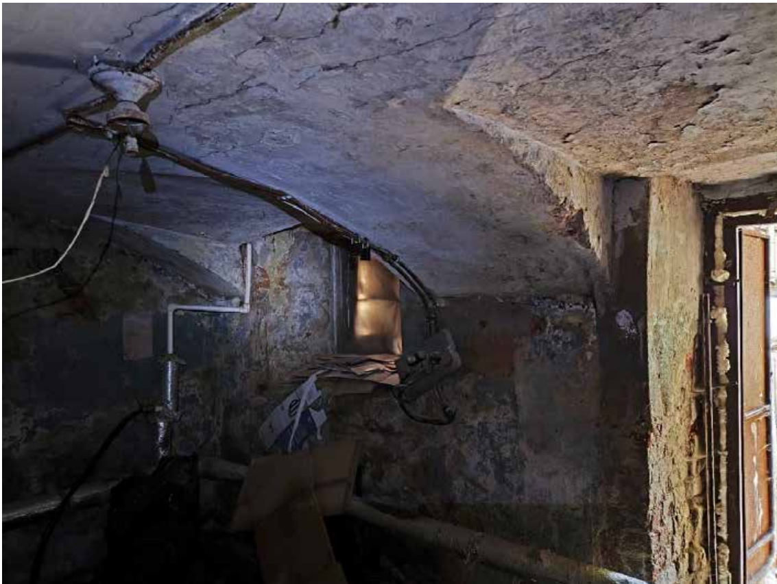
27. Выявленный объект культурного наследия «Дом С. Крамера (Г.А. Лепена)», по адресу: г. Санкт-Петербург, Морская Большая ул., 50; Мойки р. наб., 95. Фрагмент пом. 12-Н (1) в уровне подвала. Коробовый свод с распалубками. Дата съёмки: 03.07.2025.
