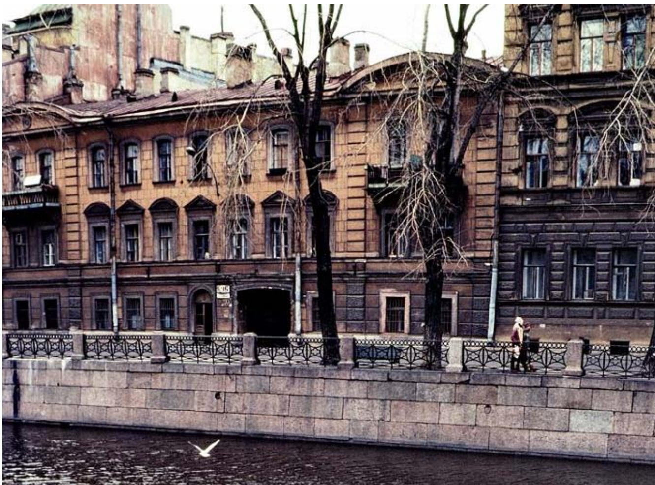
Илл. 125. Фото 1982 г. Интернет-ресурс https://pastvu.com/p/1372338 . Лицевой фасад по наб. р. Мойки.
