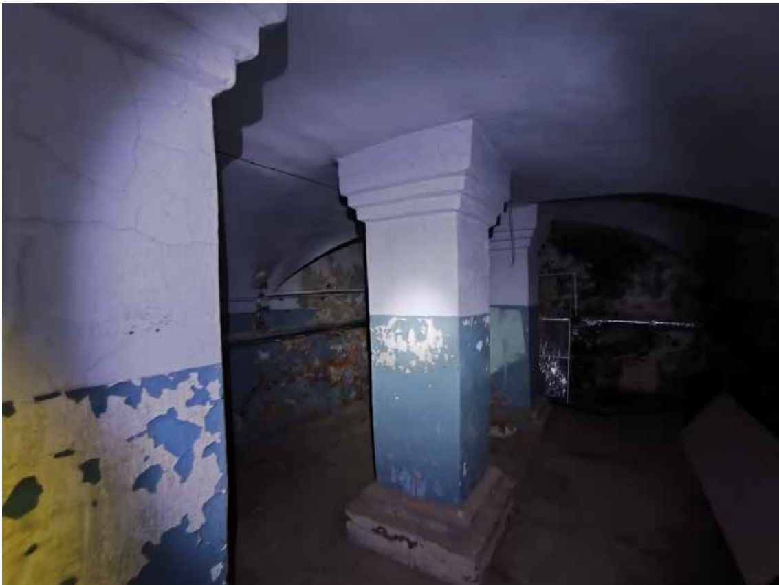
33.Выявленный объект культурного наследия «Дом С. Крамера (Г.А. Лепена)», по адресу: г. Санкт-Петербург, Морская Большая ул., 50; Мойки р. наб., 95. Фрагмент пом. 13-Н (3) в уровне подвала. Дата съёмки: 03.07.2025.
