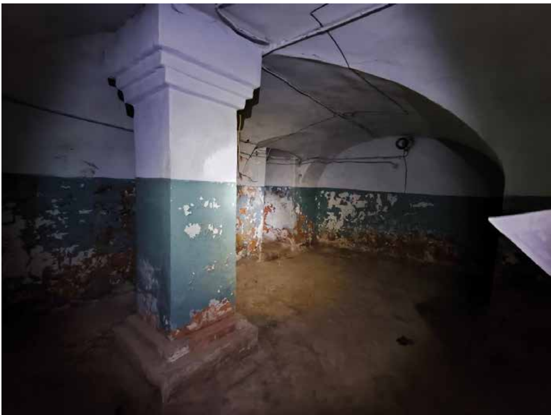
31.Выявленный объект культурного наследия «Дом С. Крамера (Г.А. Лепена)», по адресу: г. Санкт-Петербург, Морская Большая ул., 50; Мойки р. наб., 95. Общий вид пом. 13-Н (7) в уровне подвала. Дата съёмки: 03.07.2025.
