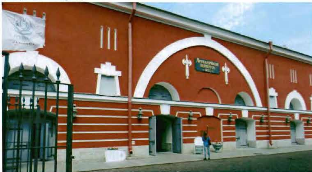
1. Вид на южный фасад.
