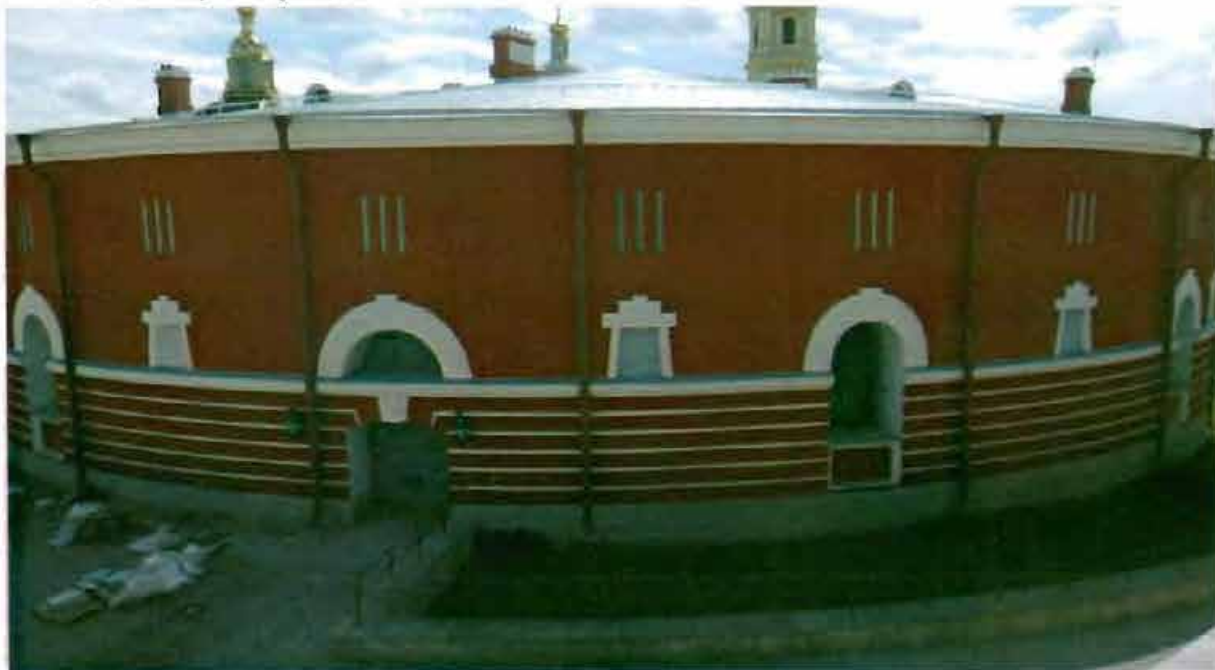
2. Вид на северный фасад.
