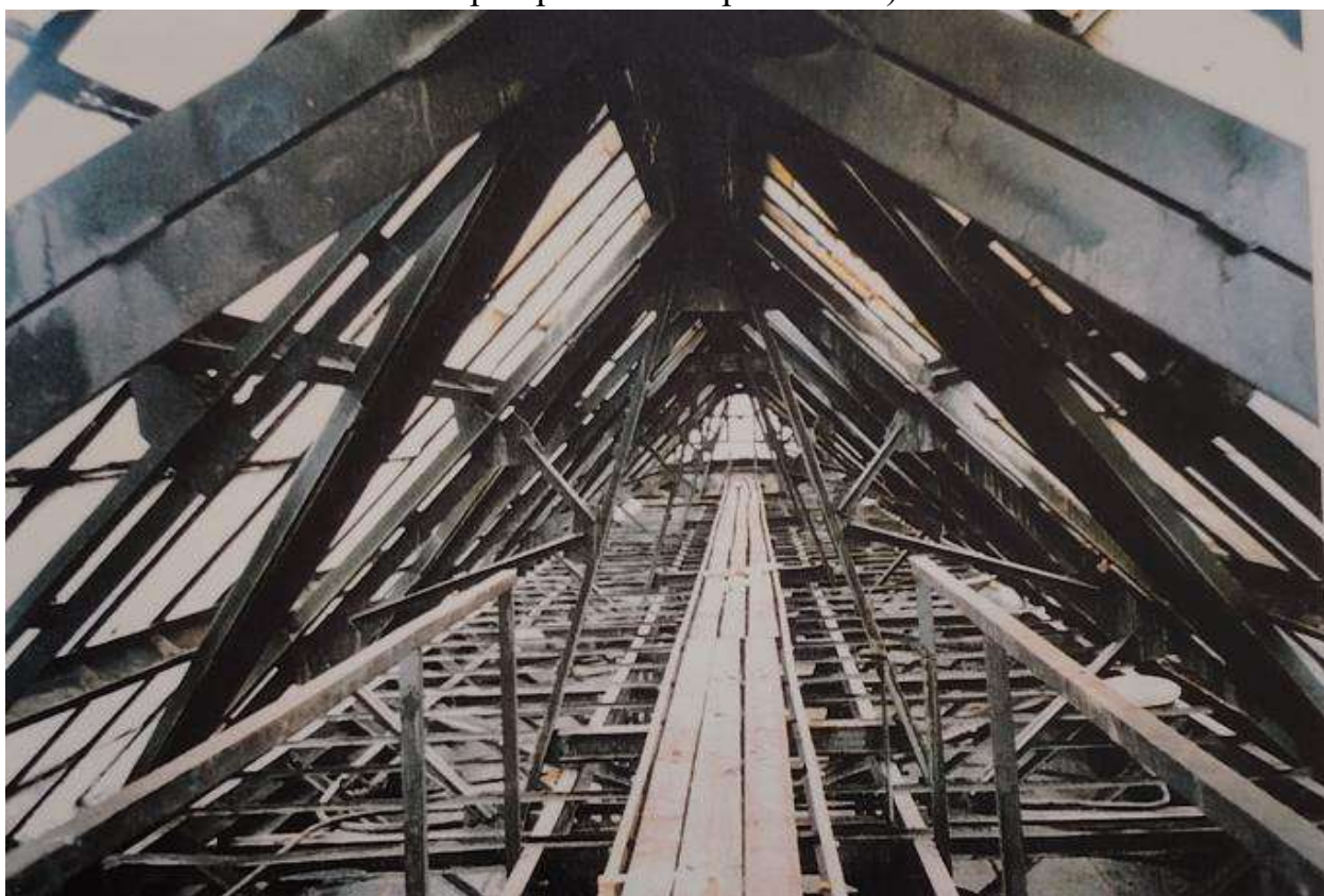
Илл. 107. Несущие конструкции фонаря юго-западного павильона. 1999 г. (источник: архив КГИОП. П. 1500-М. Инв. № 355).
