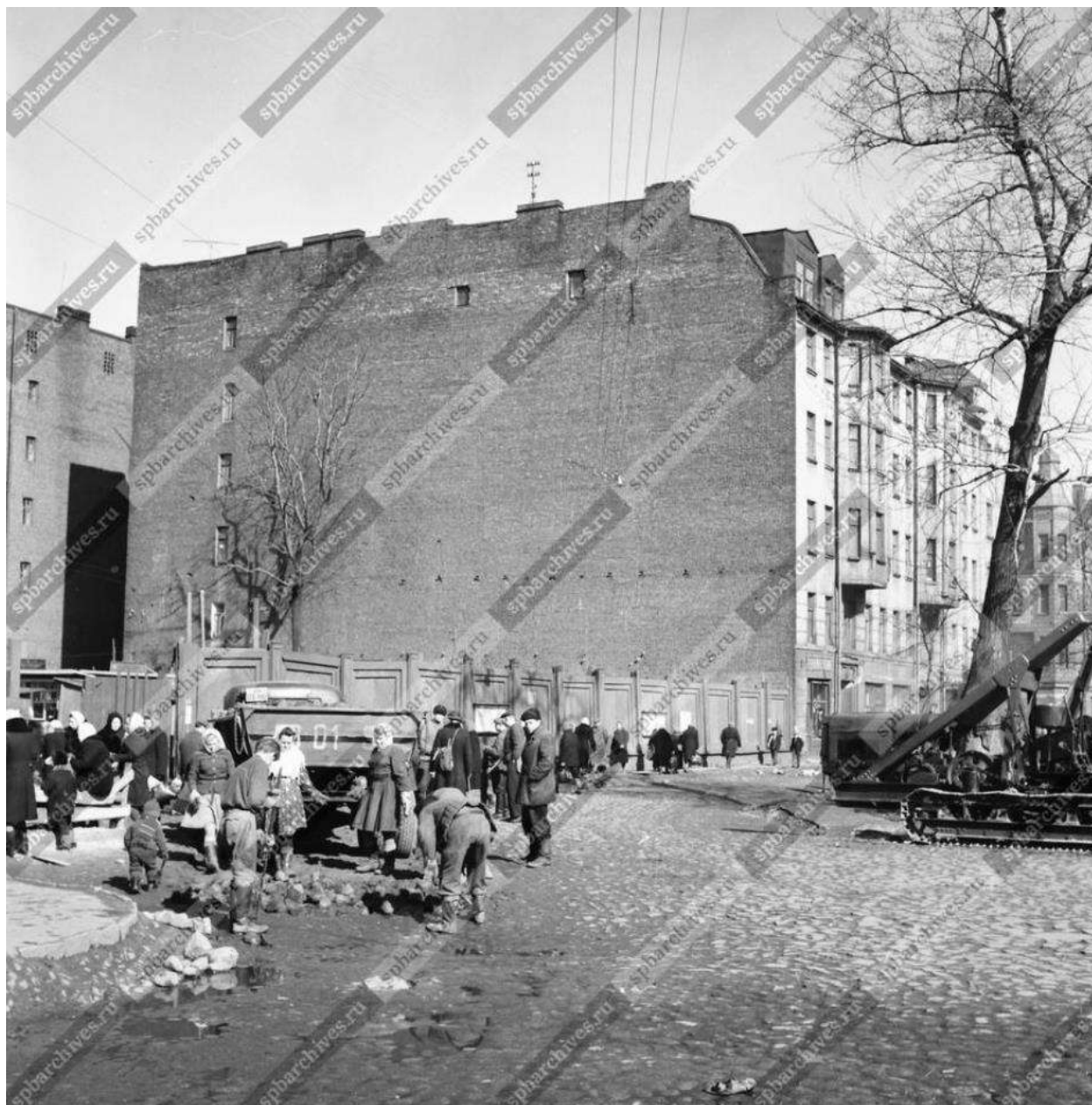
Илл. 77. Ремонт булыжной мостовой на проспекте Щорса у будущего Приморского рынка, в перспективе жилой дом № 58. 1952 г. (источник: ЦГАКФФД СПб. Фотодокументы. Опись 1БР-65. Ед.хр.79716).
