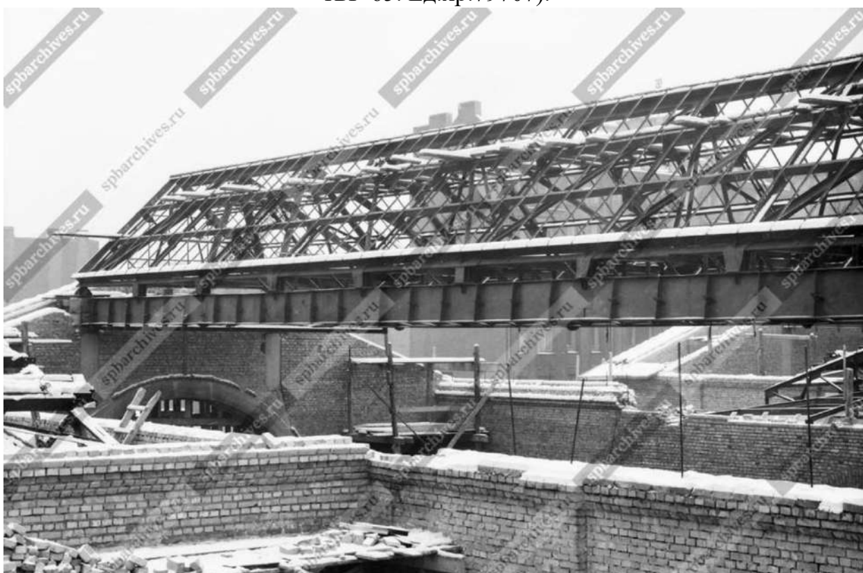
Илл. 83. Вид металлических конструкций кровли строящегося Приморского колхозного рынка. 1953 г. (источник: ЦГАКФФД СПб. Фотодокументы. Описание 1БР-65. Ед.хр.79708).
