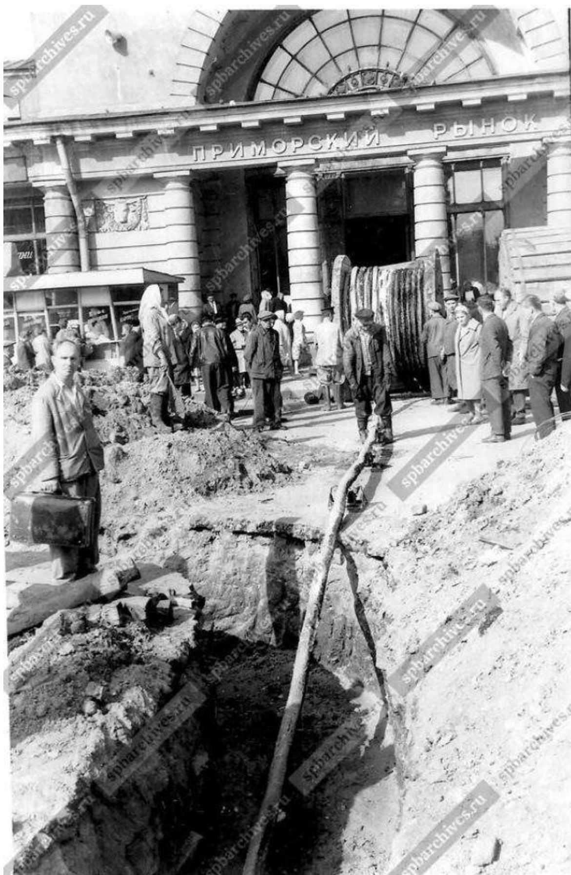
Илл. 103. Монтажники за прокладкой 35-киловольтного кабеля перед зданием Приморского рынка на проспекте Щорса, 54/56. 1966 г. (источник: ЦГАКФД СПб. Фотодокументы. Описание 1БР-59. Ед.хр.76941).
