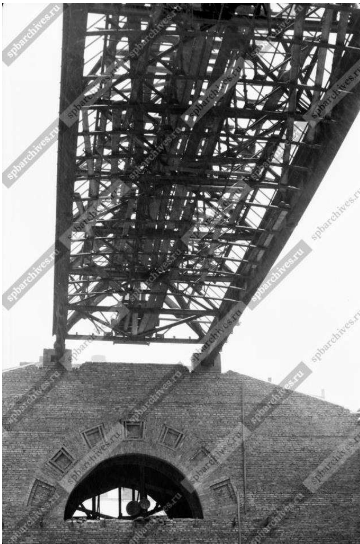
Илл. 85. Вид металлических перекрытий кровли строящегося Приморского колхозного рынка. 1953 г. (источник: ЦГАКФД СПб. Фотодокументы. Описание 1БР-65. Ед.хр.79713).
