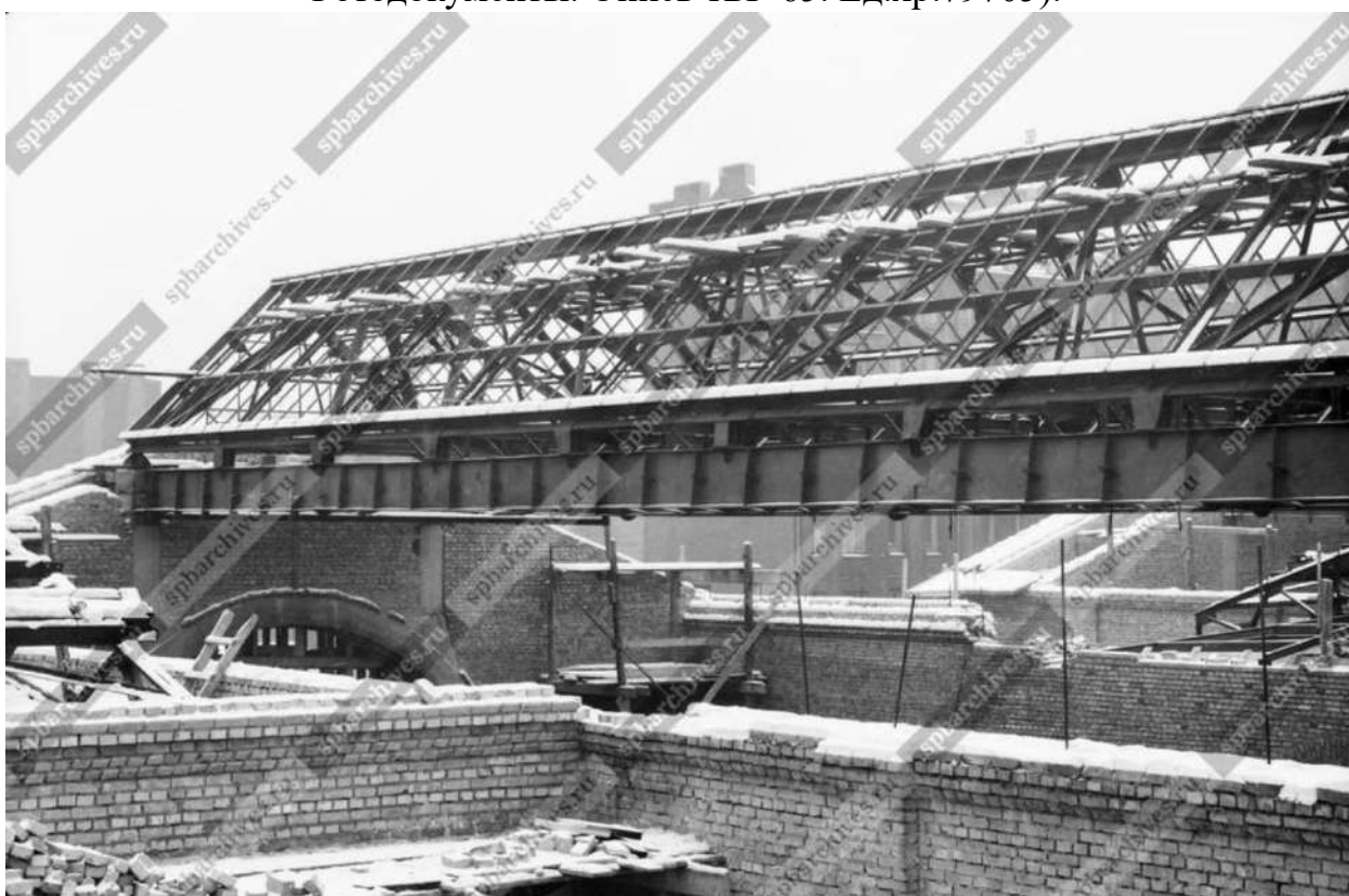
Илл. 88. Вид металлических конструкций кровли строящегося Приморского колхозного рынка. 1953 г. (источник: ЦГАКФФД СПб. Фотодокументы. Опись 1БР-65. Ед.хр.79708).
