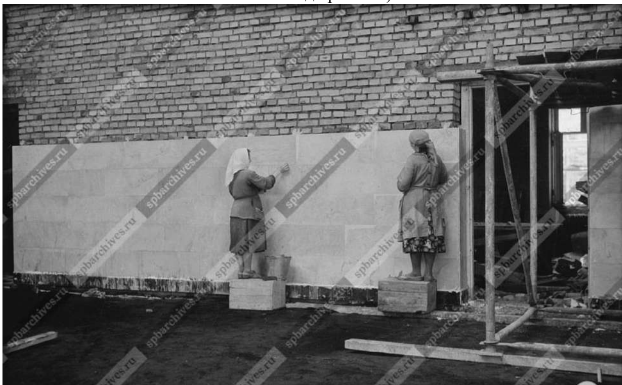
Илл. 90. Маляры-штукатуры за отделкой наружных стен нового Приморского колхозного рынка на проспекте Щорса, 54-56. 1955 г. (источник: ЦГАКФФД СПб. Фотодокументы. Опись 1БР-74. Ед.хр.81151).
