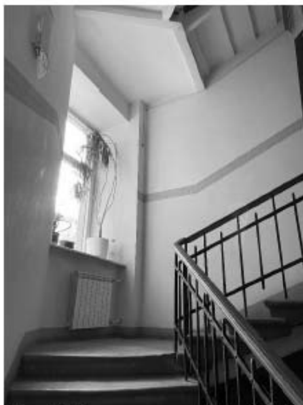
Фото 57. Пространство лестницы 14 ЛК.
