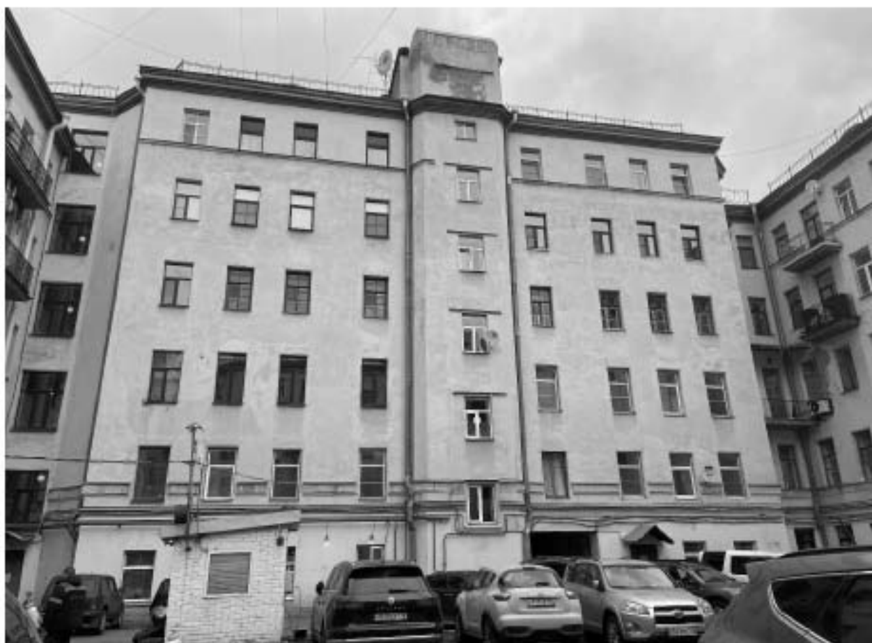
Фото 13. Вид на дворовый фасад.
