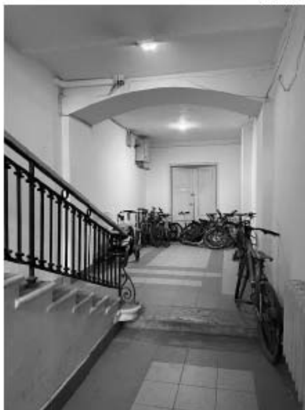
Фото 11. Пространство лестницы 3 ЛК.
