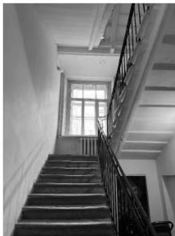
Фото 8. Пространство лестницы 2 ЛК.
