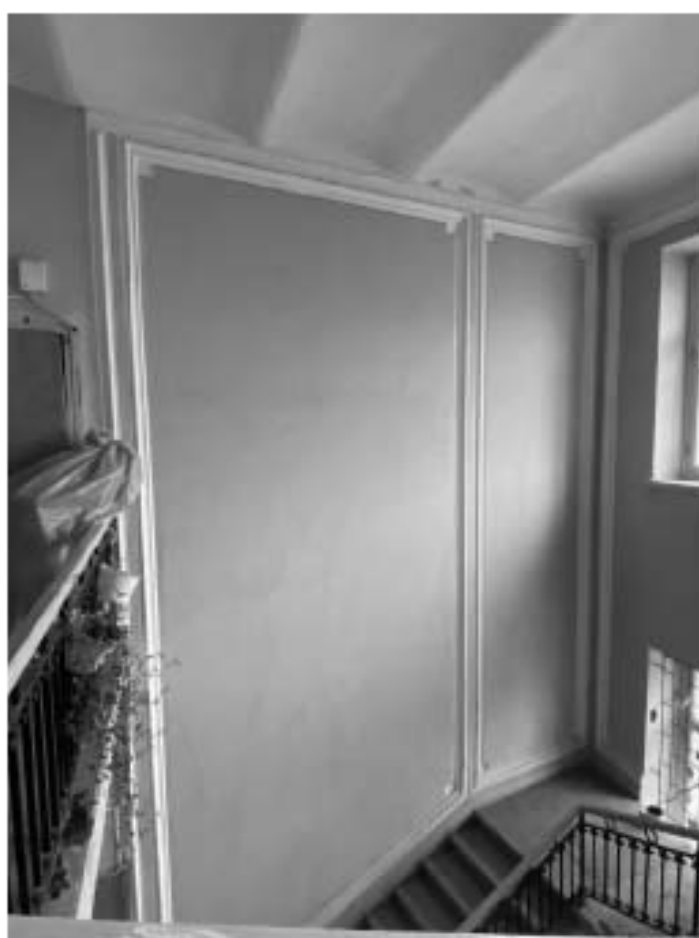
Фото 65. Пространство лестницы 16 ЛК.
