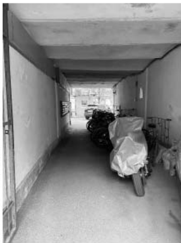
Фото 18. Вид на проезд между дворами.
