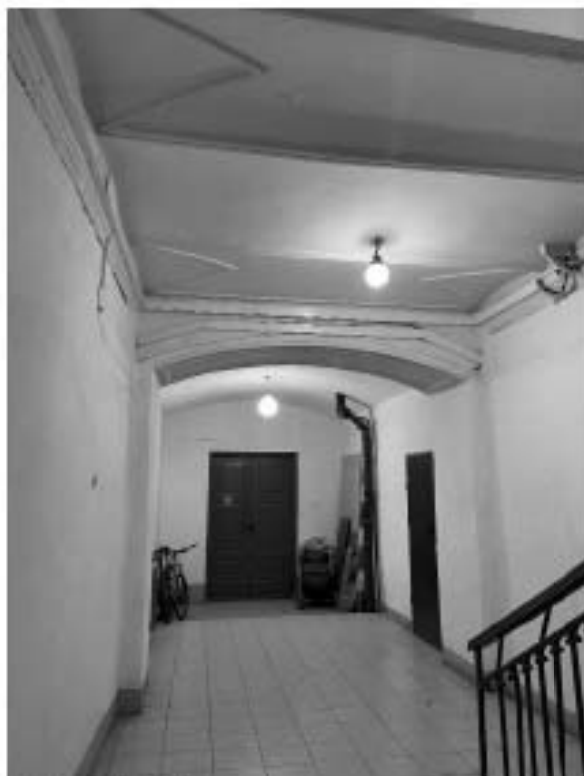
Фото 20. Пространство лестницы 5 ЛК.
