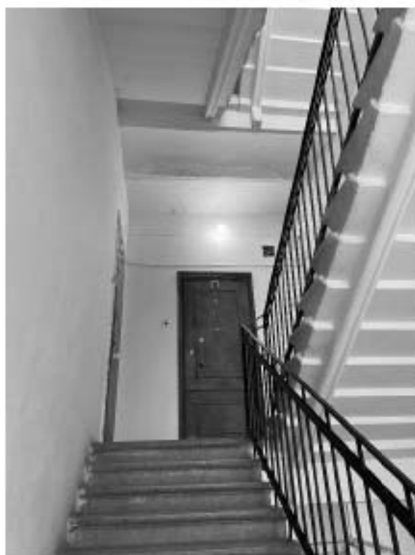
Фото 9. Пространство лестницы 2 ЛК.
