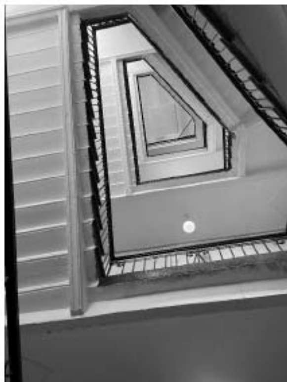
Фото 44. Пространство лестницы 11 ЛК.
