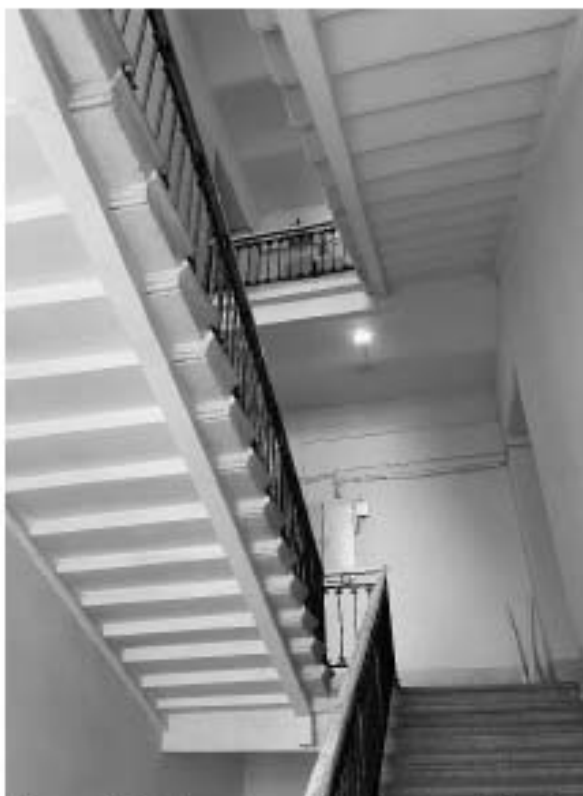
Фото 14. Пространство лестницы 3 ЛК.
