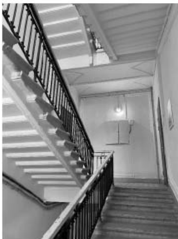
Фото 5. Пространство лестницы 1 ЛК.
