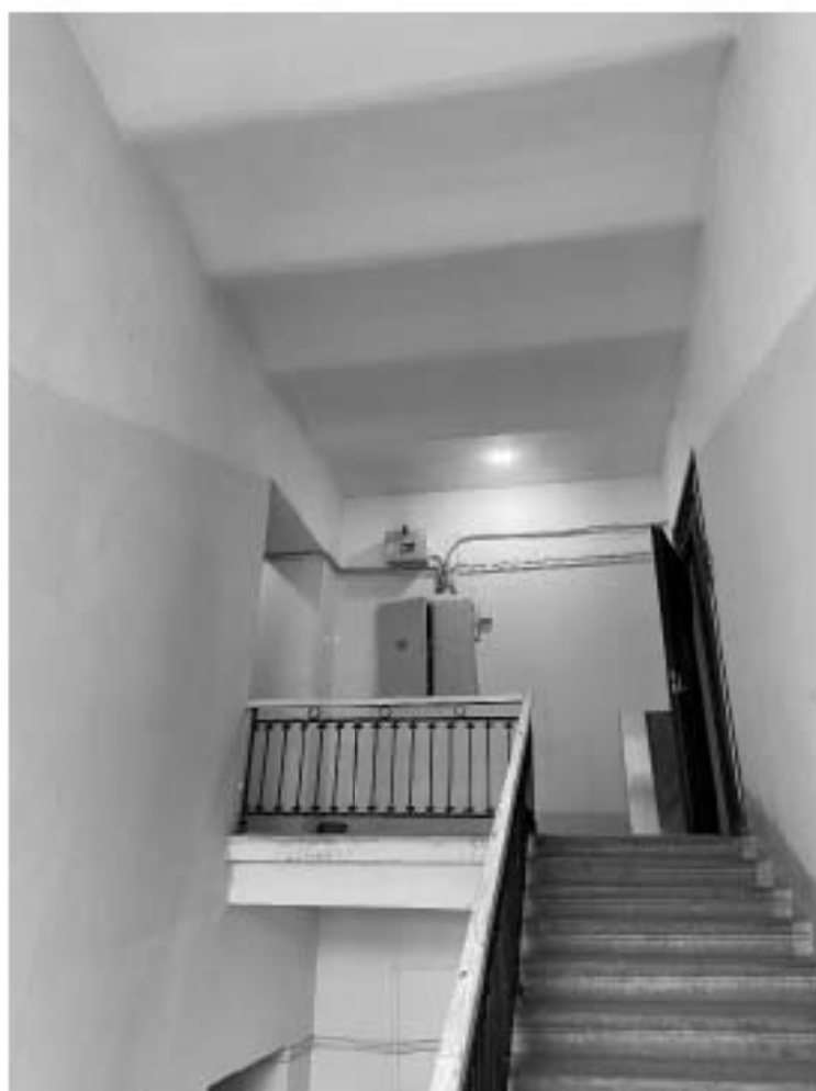
Фото 15. Пространство лестницы 3 ЛК.
