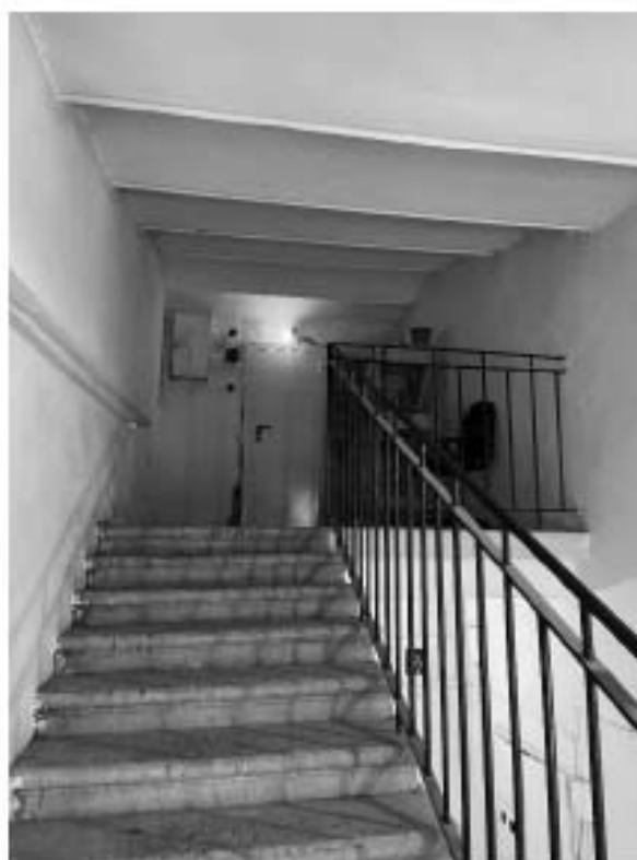
Фото 10. Пространство лестницы 2 ЛК.
