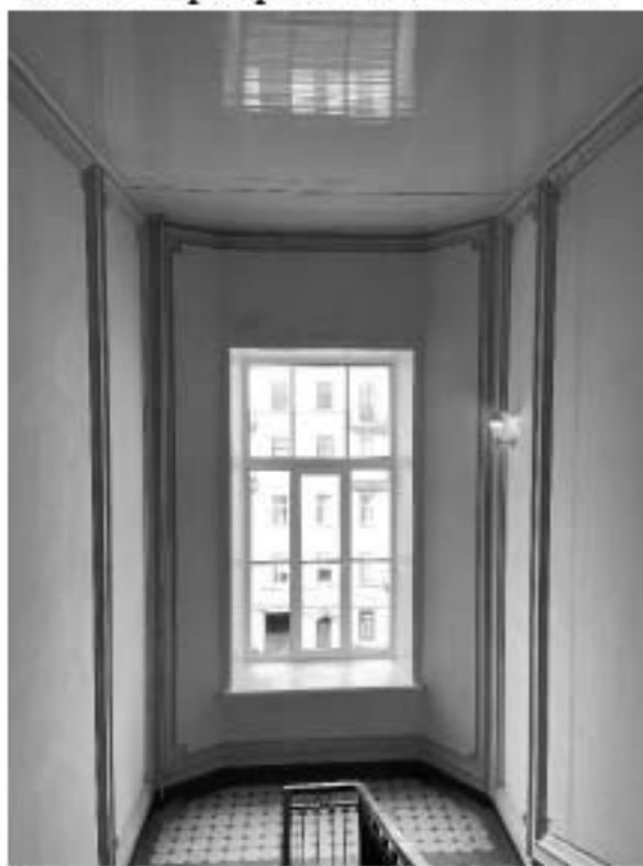
Фото 30. Пространство лестницы 7 ЛК.
