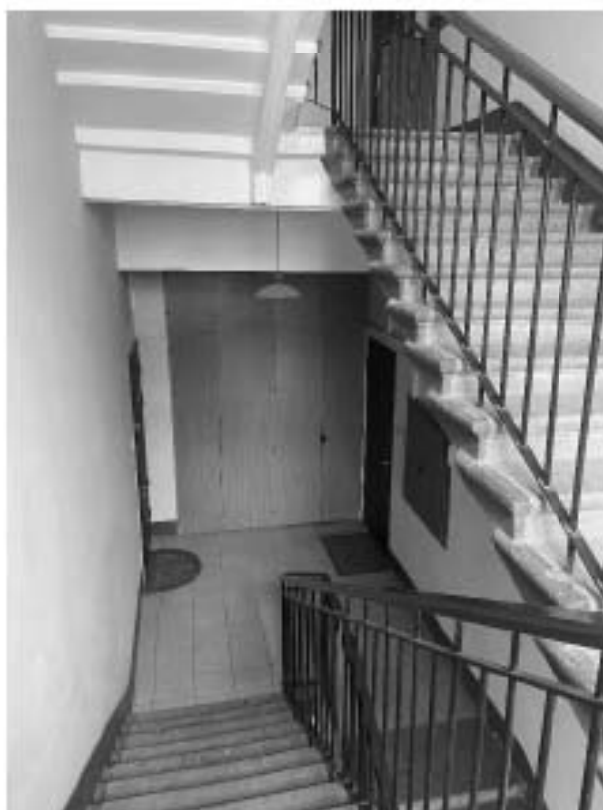
Фото 18. Пространство лестницы 4 ЛК.
