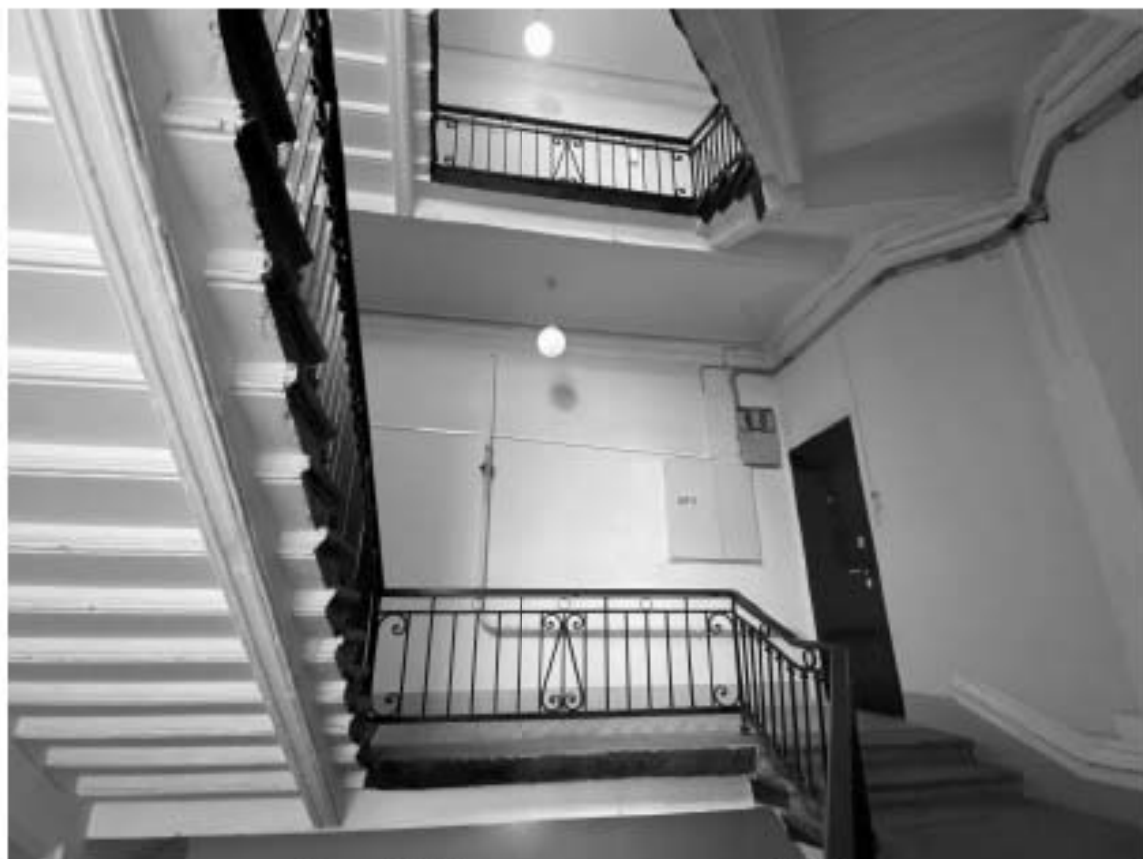
Фото 47. Пространство лестницы 11 ЛК.
