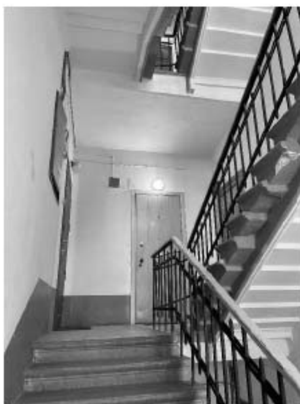
Фото 55. Пространство лестницы 13 ЛК.
