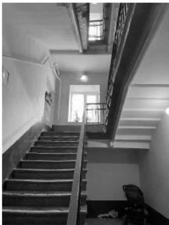
Фото 54. Пространство лестницы 13 ЛК.
