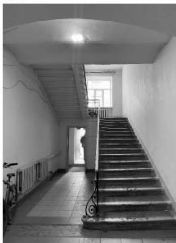
Фото 12. Пространство лестницы 3 ЛК.
