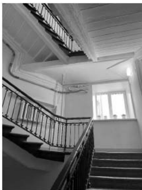
Фото 46. Пространство лестницы 11 ЛК.
