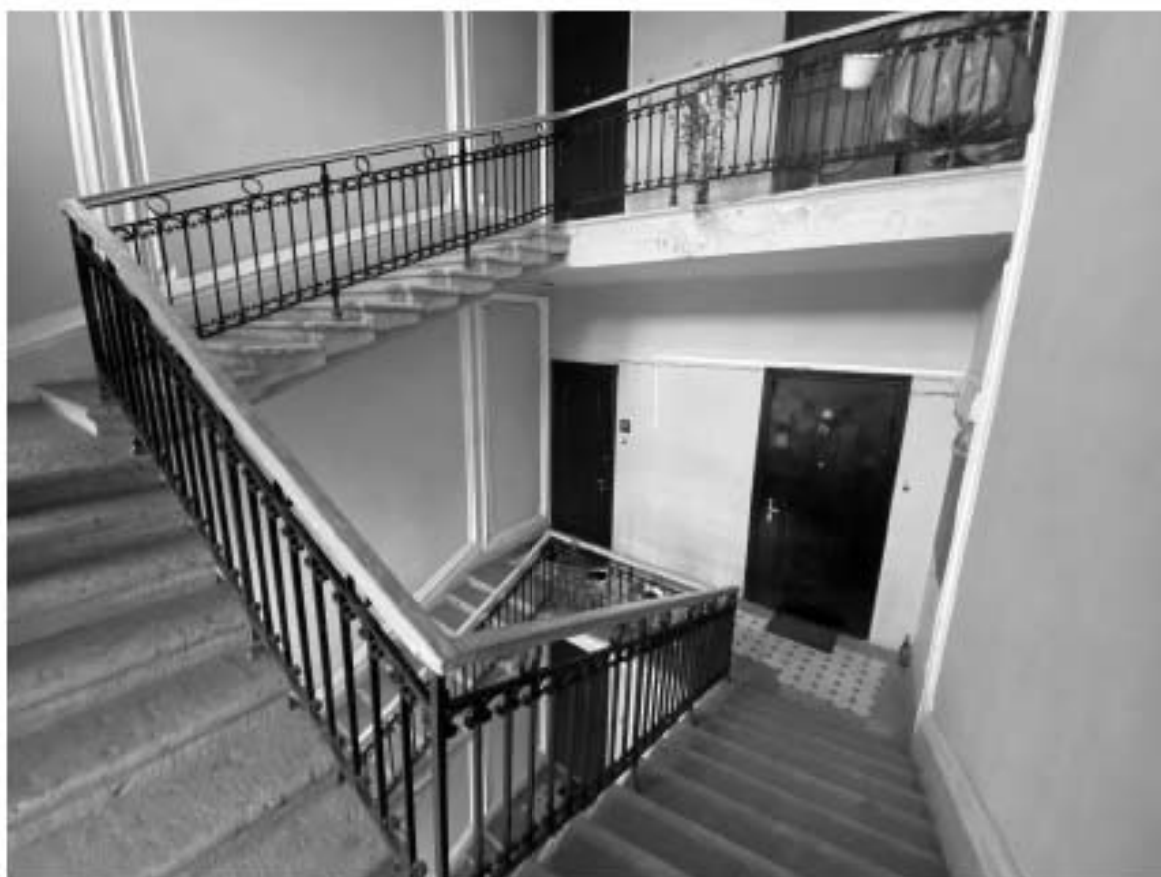
Фото 64. Пространство лестницы 16 ЛК.
