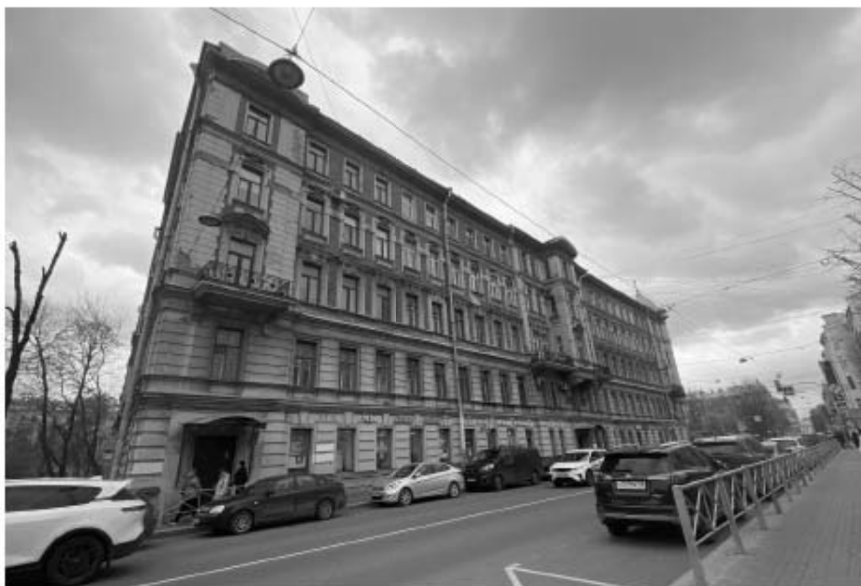
Фото 4. Лицевой фасад по Чкаловскому проспекту.
