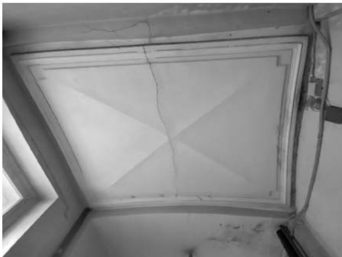
Фото 61. Пространство лестницы 16 ЛК.
