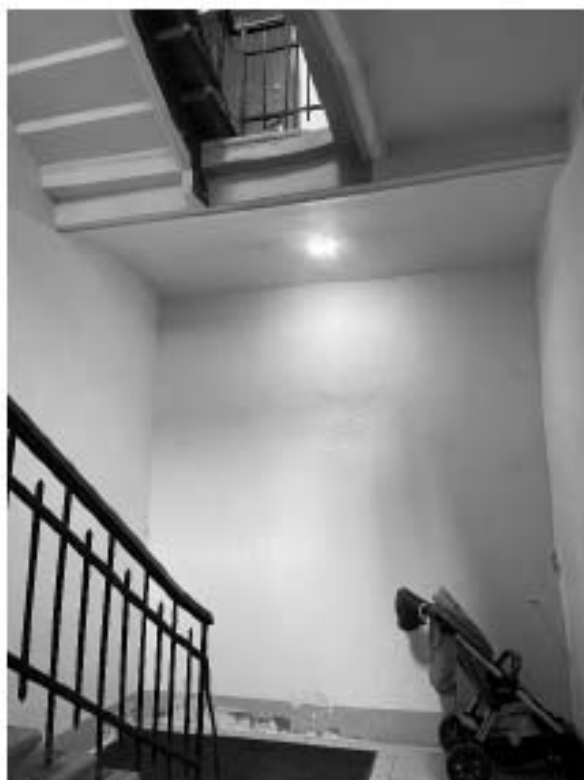
Фото 49. Пространство лестницы 12 ЛК.
