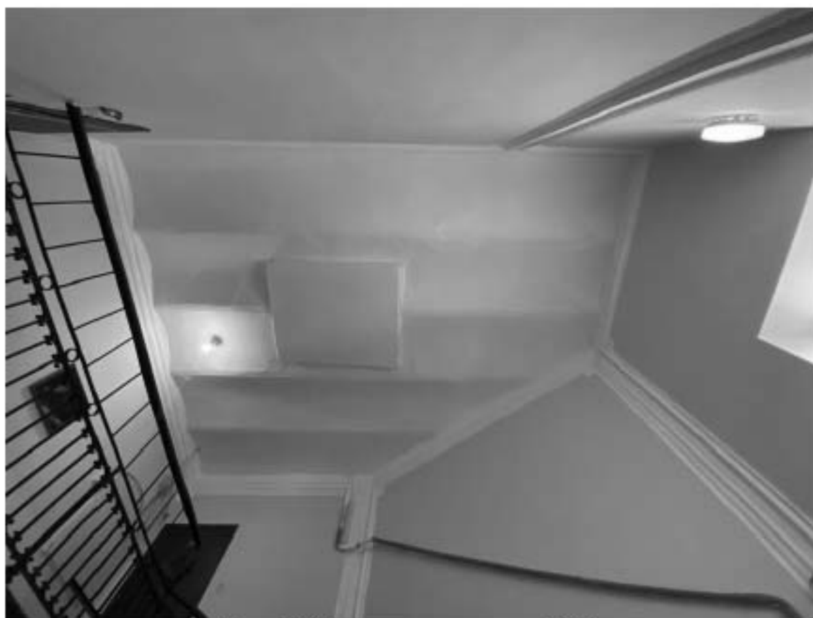
Фото 48. Пространство лестницы 11 ЛК.
