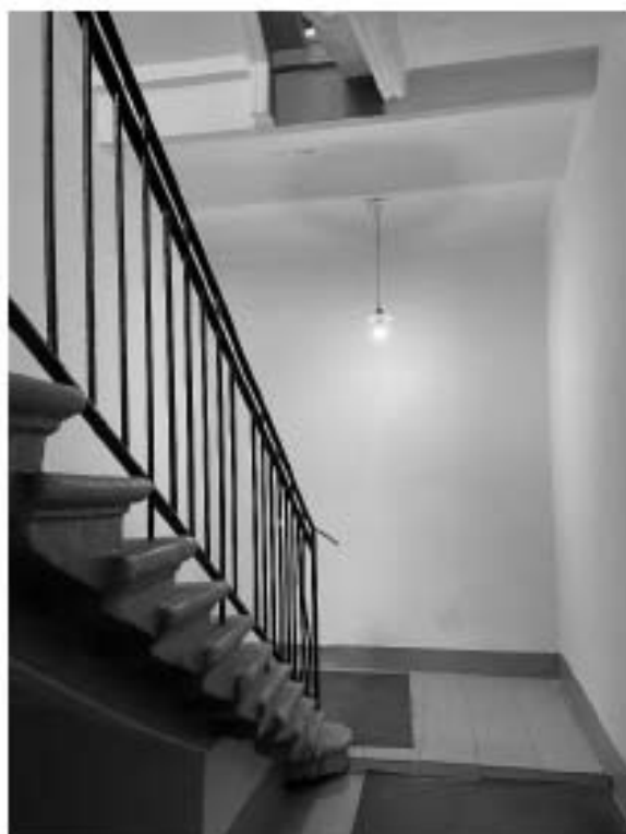
Фото 66. Пространство лестницы 17 ЛК.
