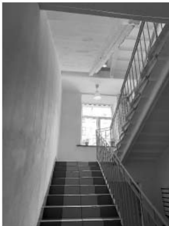
Фото 24. Пространство лестницы 6 ЛК.
