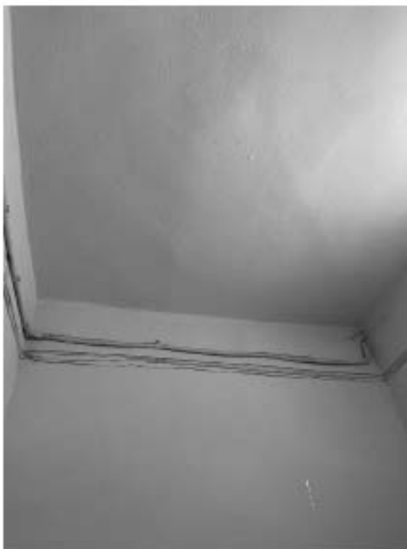
Фото 7. Пространство лестницы 2 ЛК.
