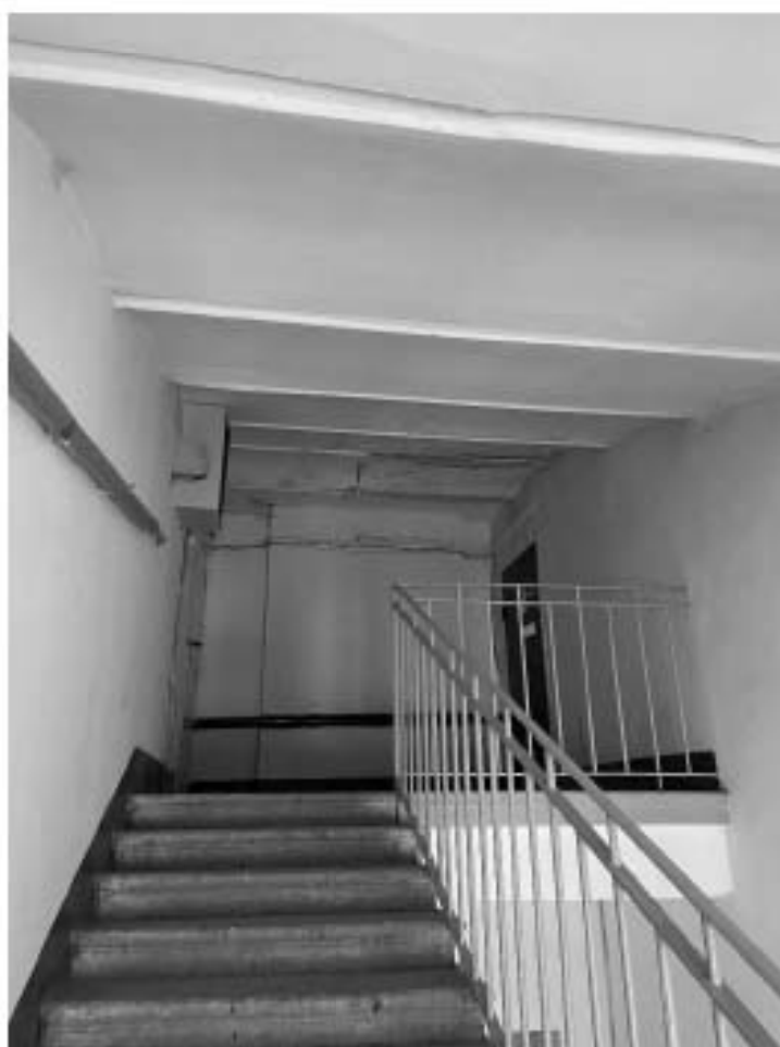
Фото 26. Пространство лестницы 6 ЛК.
