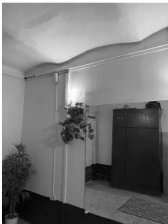
Фото 53. Пространство лестницы 13 ЛК.
