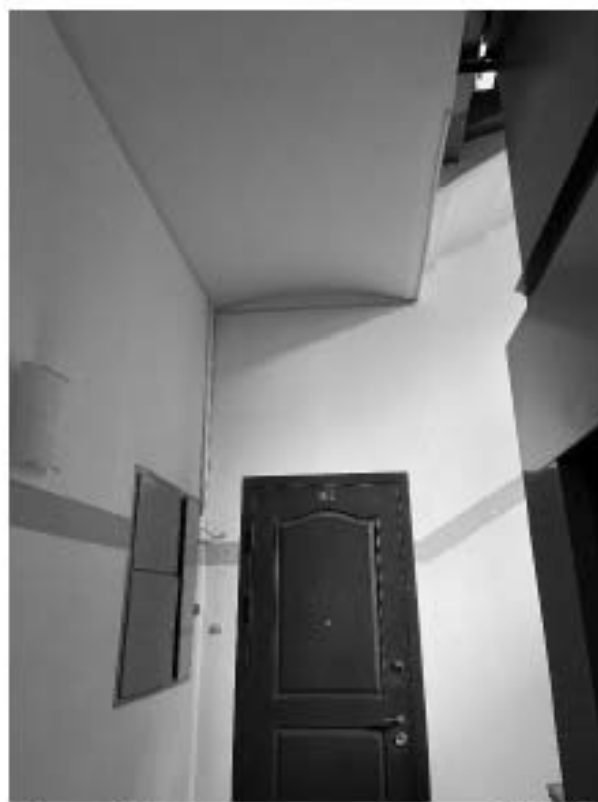
Фото 58. Пространство лестницы 14 ЛК.
