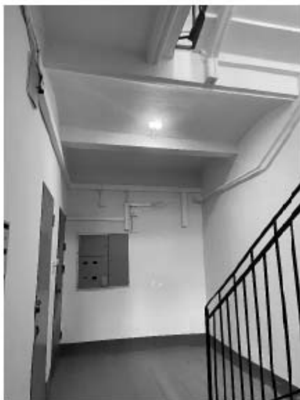
Фото 39. Пространство лестницы 10 ЛК.
