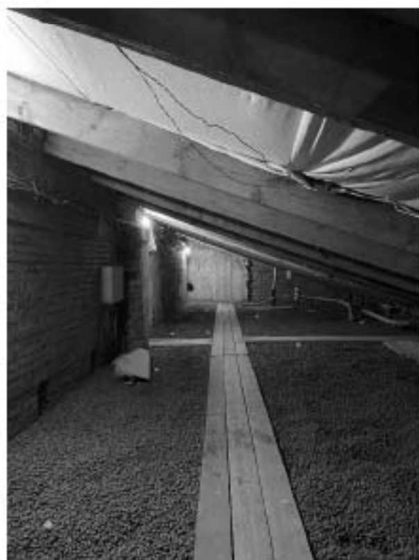
Фото 73. Вид на чердачное пространство.
