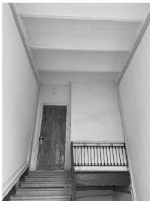
Фото 38. Пространство лестницы 9 ЛК.
