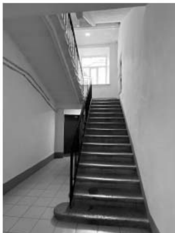
Фото 32. Пространство лестницы 8 ЛК.
