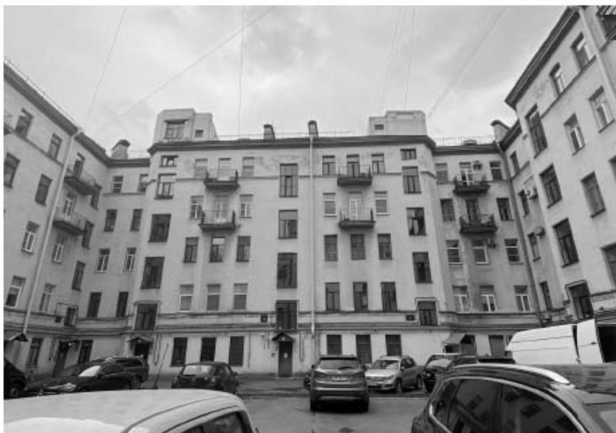
Фото 15. Вид на дворовый фасад.
