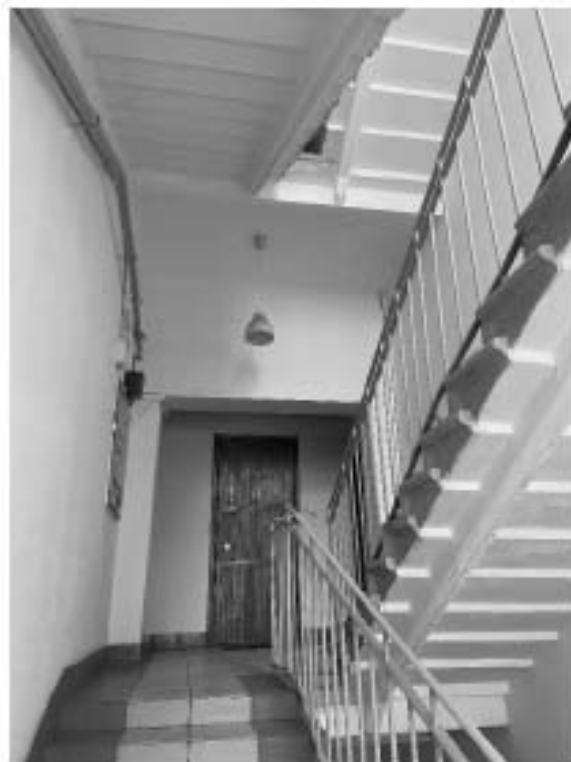
Фото 25. Пространство лестницы 6 ЛК.
