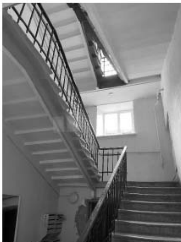
Фото 50. Пространство лестницы 12 ЛК.
