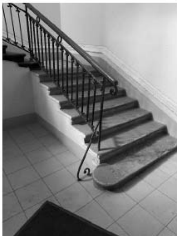
Фото 43. Пространство лестницы 11 ЛК.
