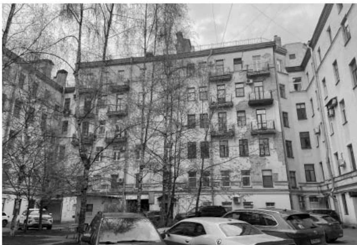
Фото 21. Вид на дворовый фасад.
