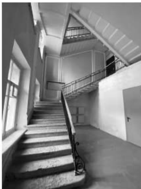
Фото 62. Пространство лестницы 16 ЛК.
