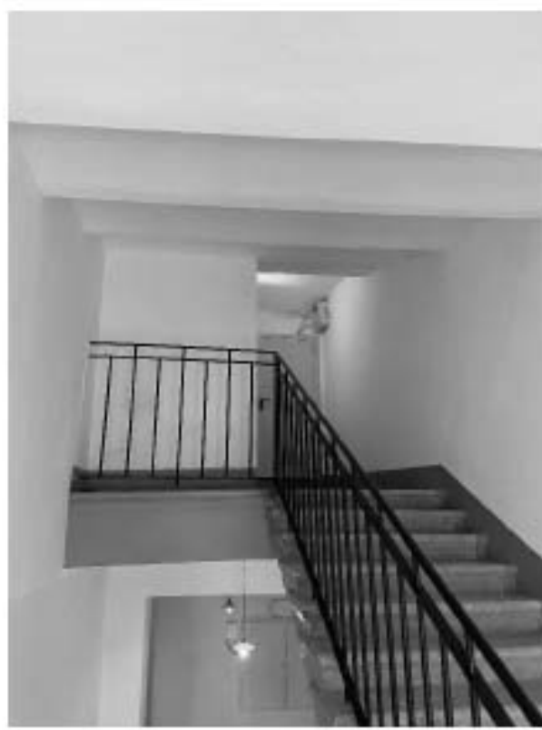
Фото 69. Пространство лестницы 17 ЛК.
