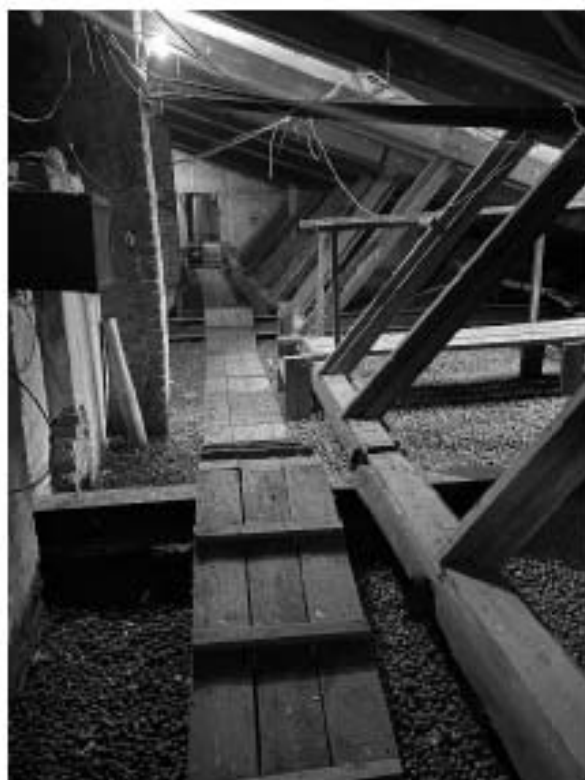
Фото 70. Вид на чердачное пространство.
