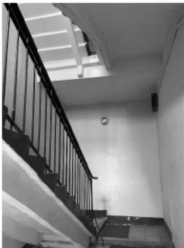
Фото 16. Пространство лестницы 4 ЛК.
