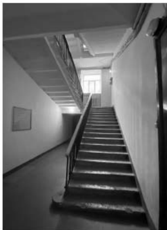
Фото 4. Пространство лестницы 1 ЛК.
