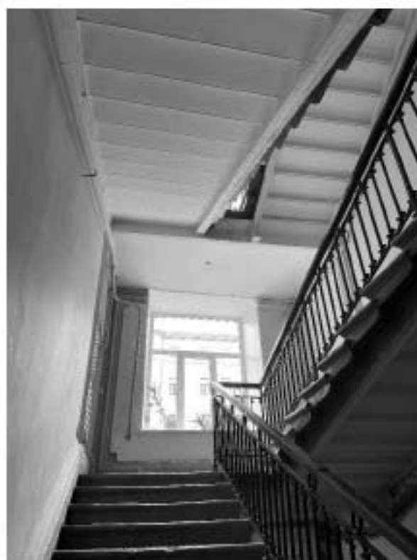
Фото 36. Пространство лестницы 9 ЛК.
