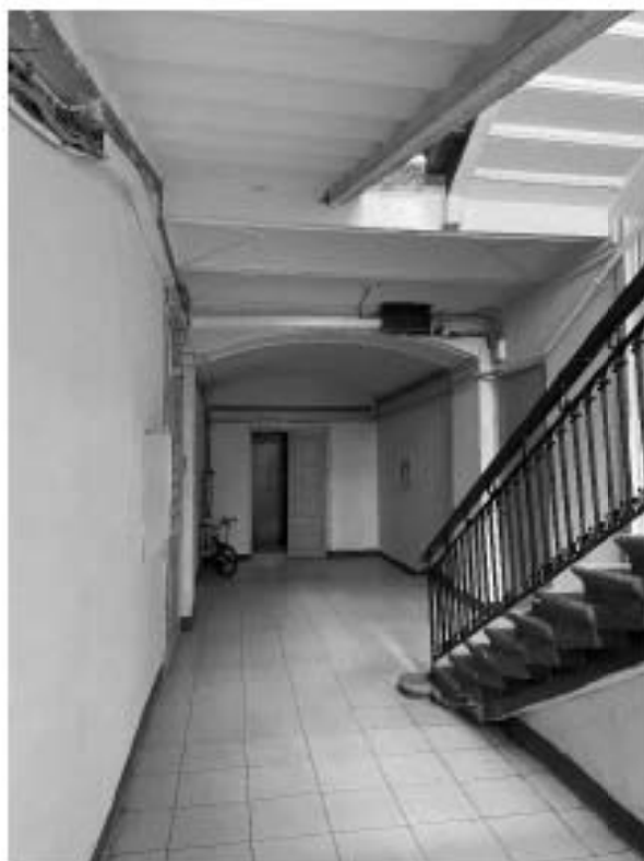
Фото 35. Пространство лестницы 9 ЛК.
