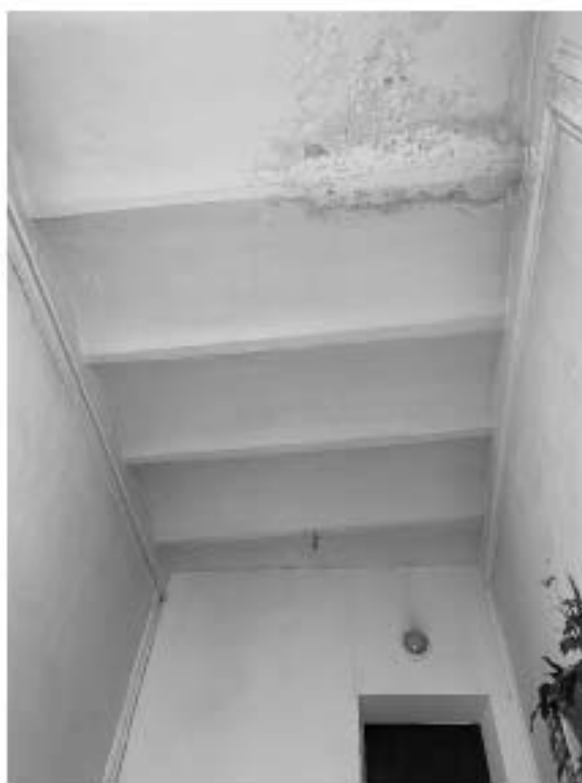
Фото 6. Пространство лестницы 1 ЛК.
