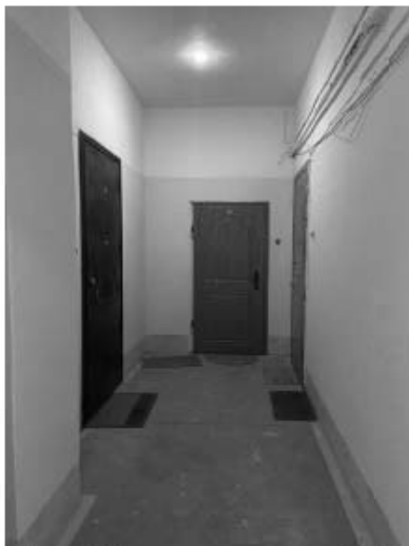
Фото 13. Пространство лестницы 3 ЛК.
