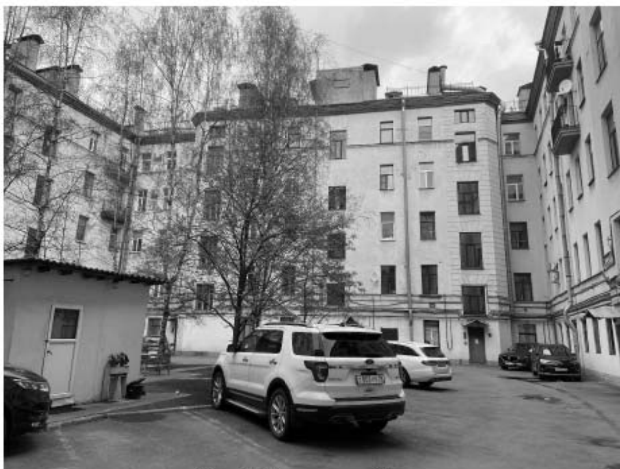
Фото 19. Вид на дворовый фасад.
