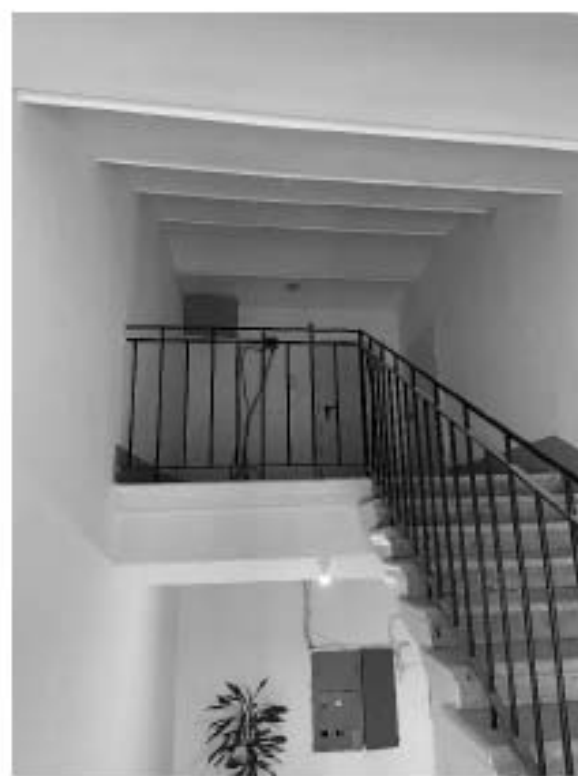
Фото 34. Пространство лестницы 8 ЛК.
