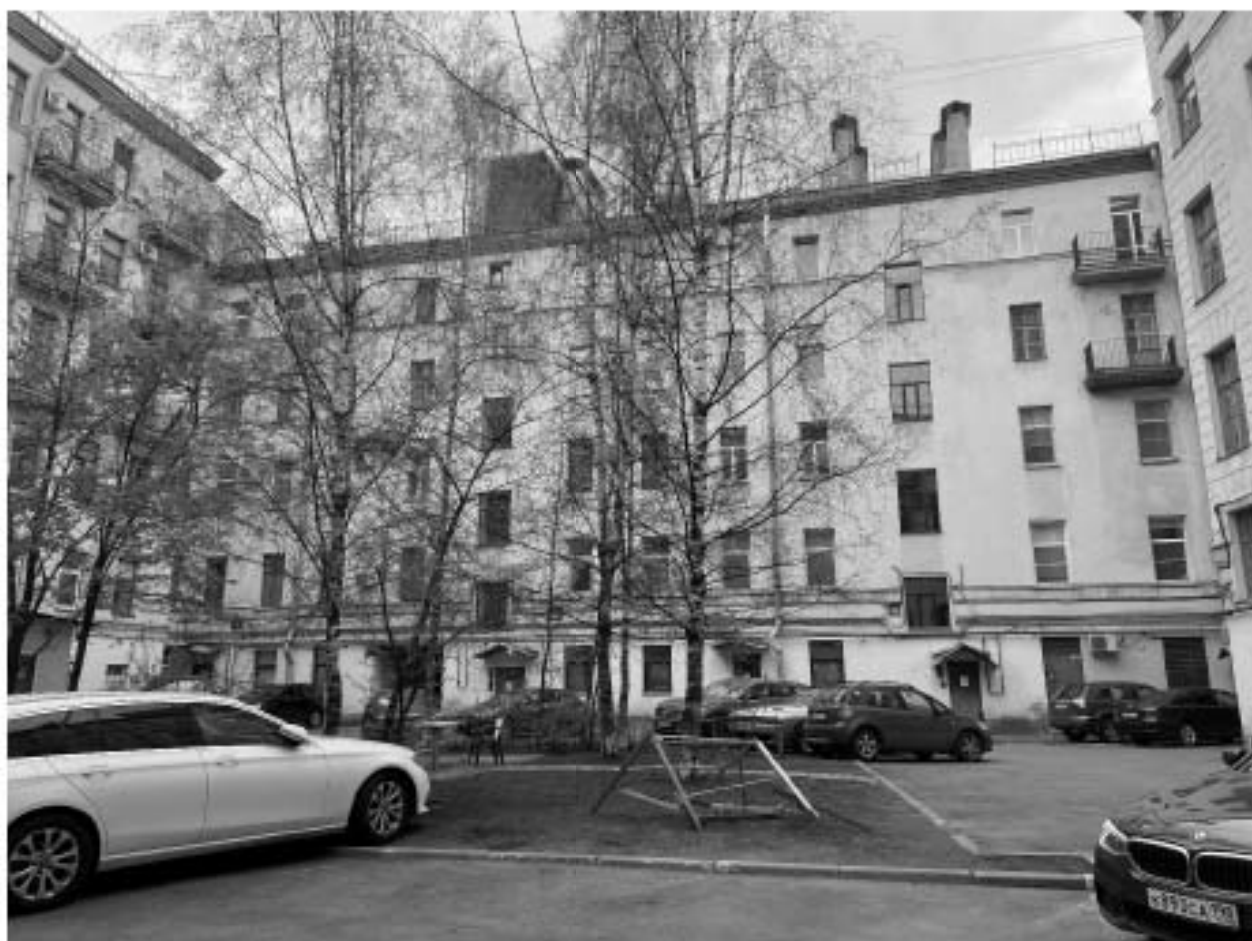
Фото 20. Вид на дворовый фасад.
