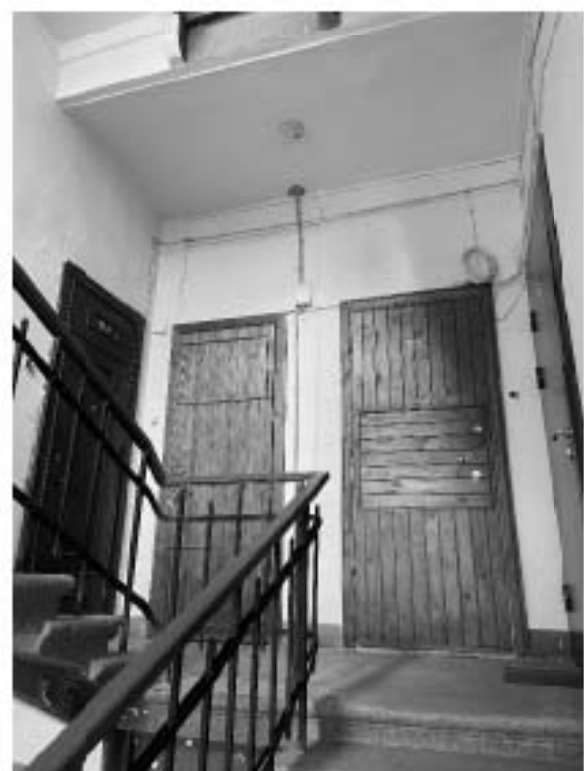
Фото 51. Пространство лестницы 12 ЛК.
