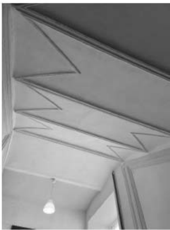
Фото 23. Пространство лестницы 5 ЛК.
