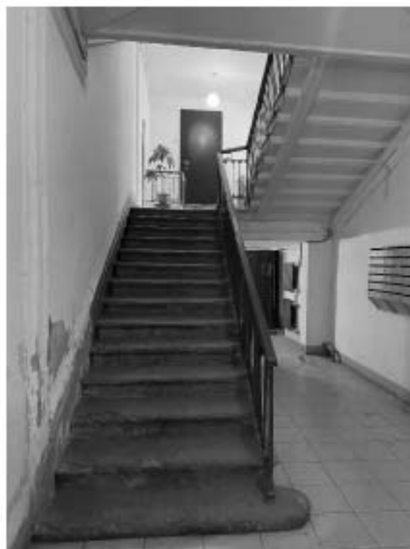
Фото 21. Пространство лестницы 5 ЛК.
