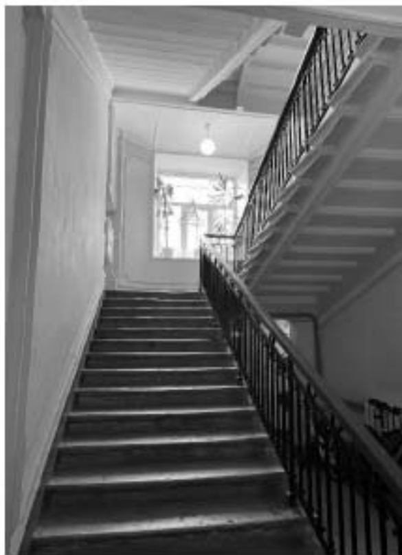
Фото 28. Пространство лестницы 7 ЛК.
