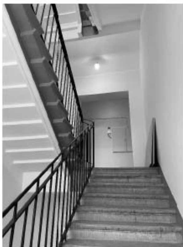
Фото 68. Пространство лестницы 17 ЛК.
