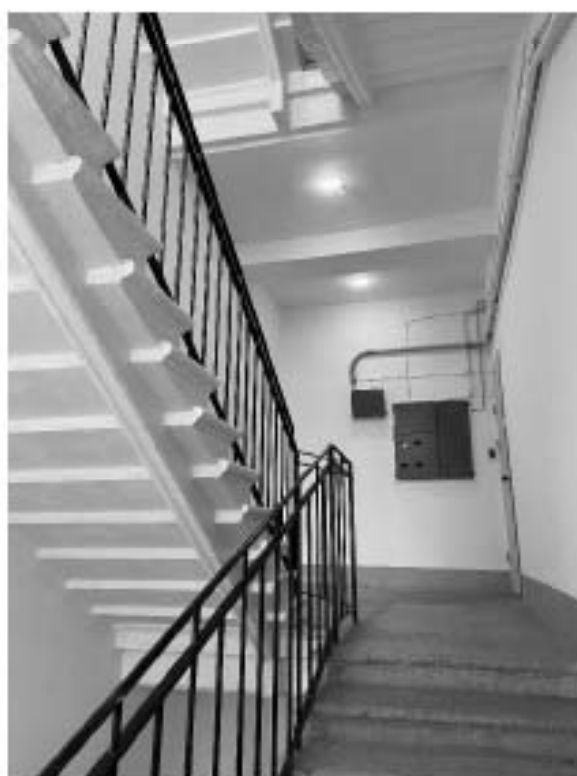
Фото 33. Пространство лестницы 8 ЛК.
