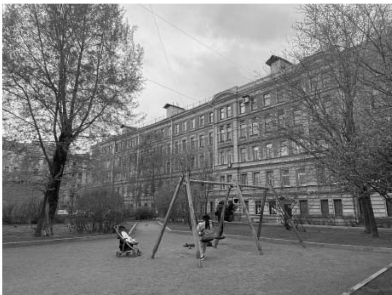
Фото 5. Вид на лицевой фасад с Ораниенбаумской улицы.
