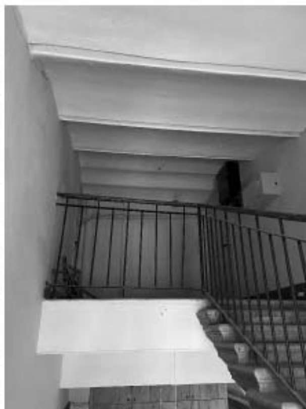
Фото 19. Пространство лестницы 4 ЛК.
