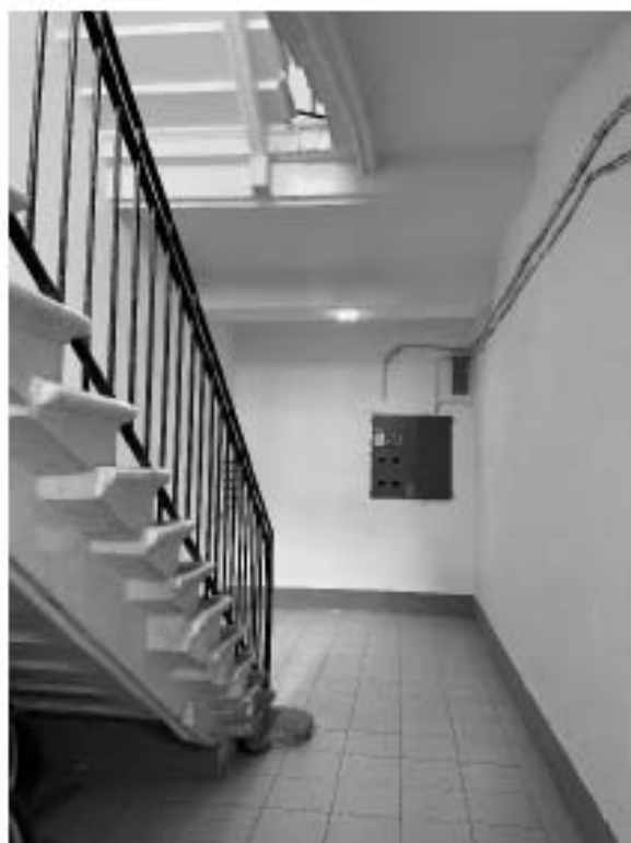
Фото 31. Пространство лестницы 8 ЛК.
