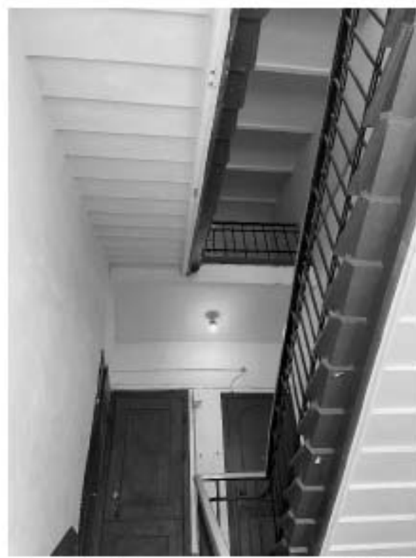
Фото 60. Пространство лестницы 15 ЛК.
