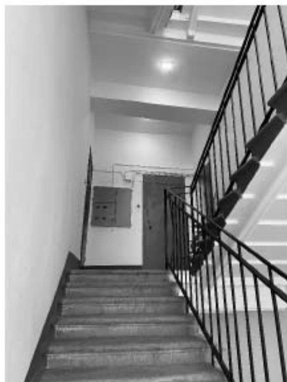
Фото 41. Пространство лестницы 10 ЛК.
