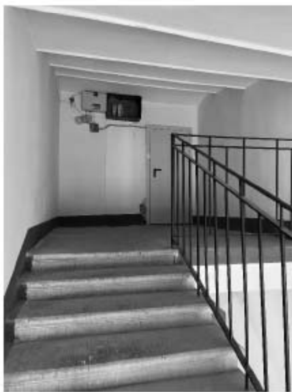
Фото 42. Пространство лестницы 10 ЛК.
