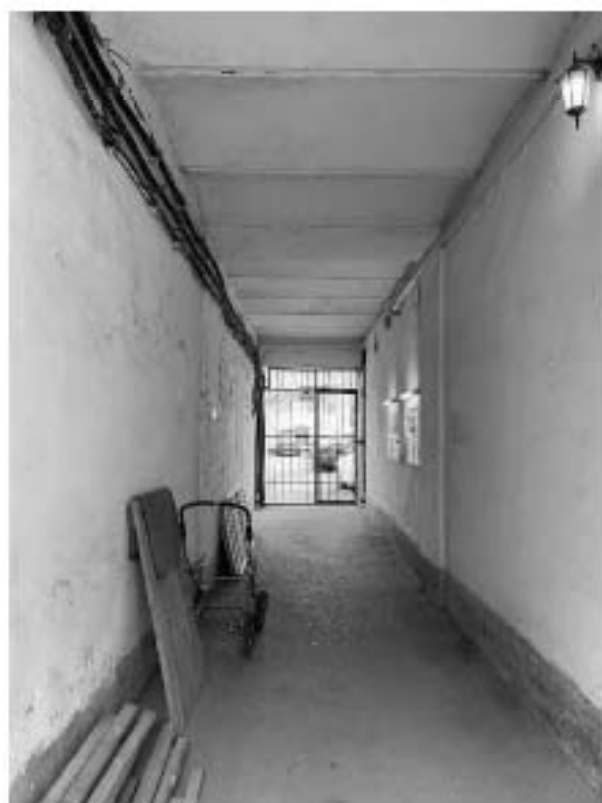
Фото 12. Вид на воротный проезд из двора.
