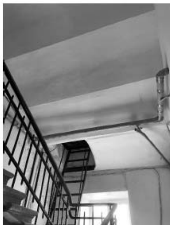
Фото 52. Пространство лестницы 12 ЛК.
