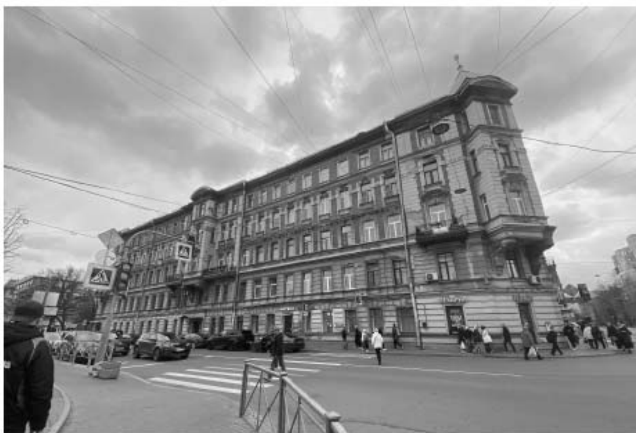
Фото 3. Лицевой фасад по Чкаловскому проспекту.
