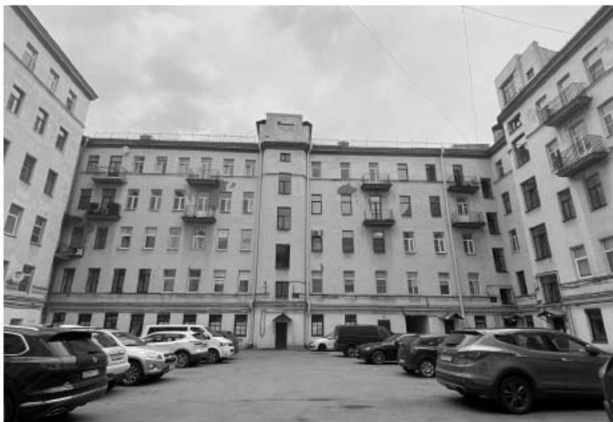
Фото 14. Вид на дворовый фасад.
