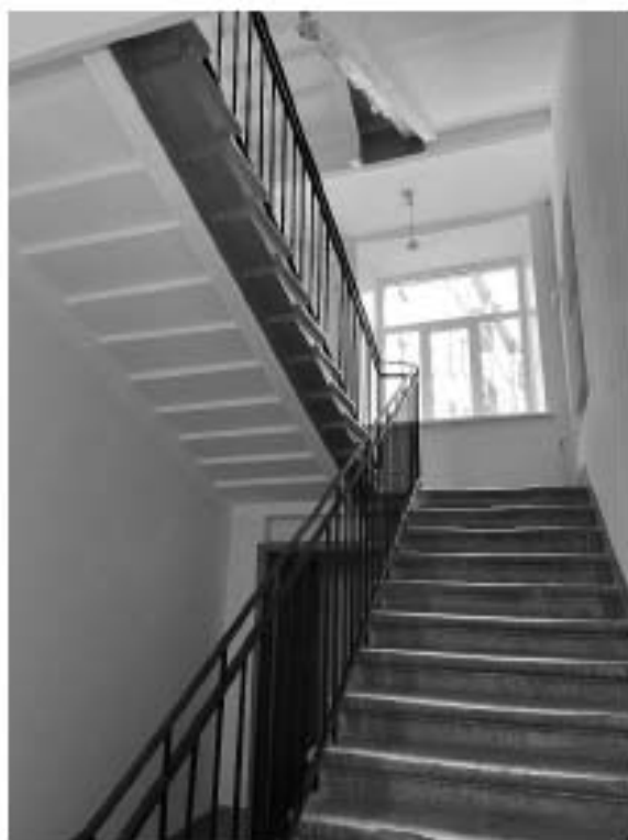
Фото 67. Пространство лестницы 17 ЛК.
