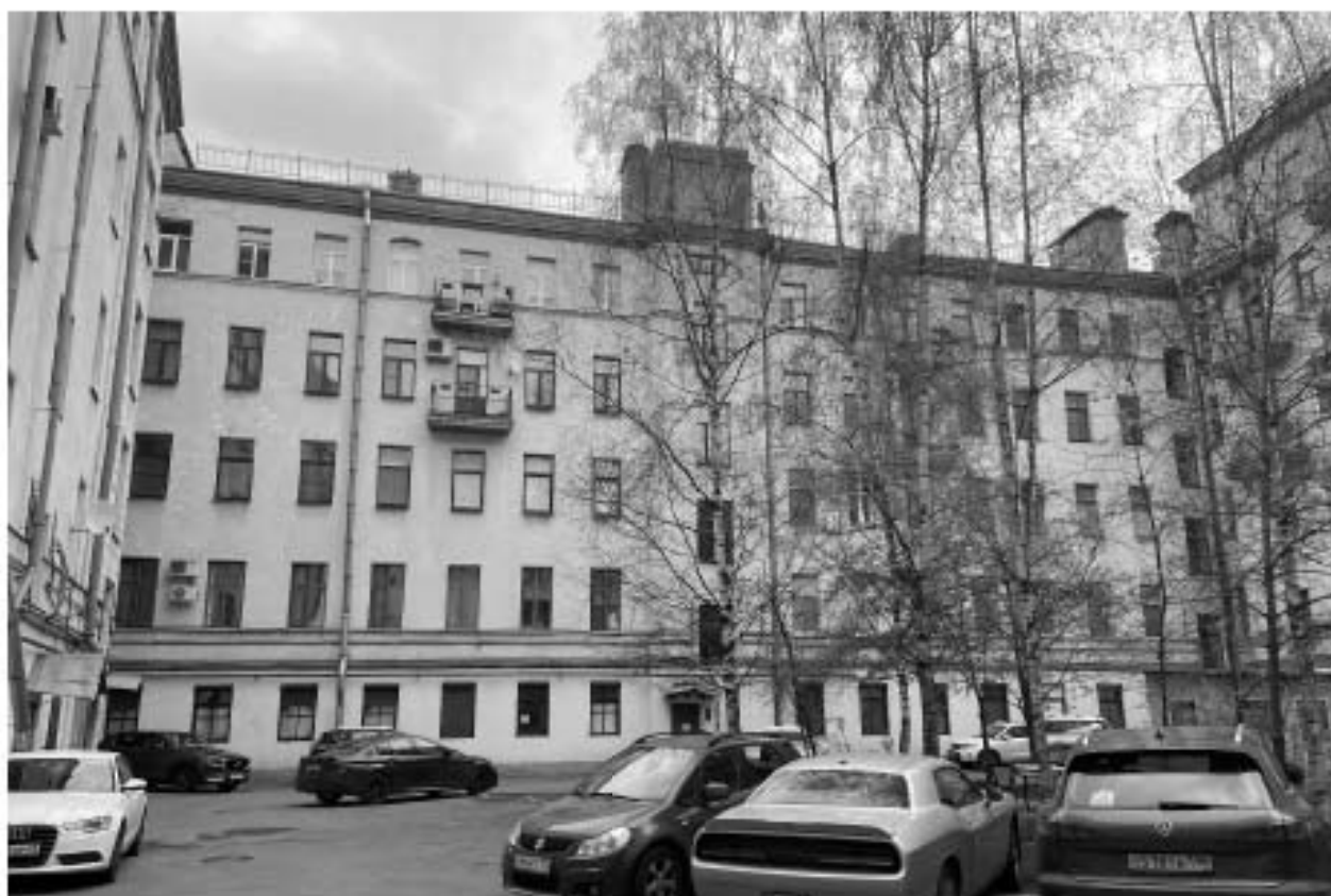
Фото 22. Вид на дворовый фасад.
