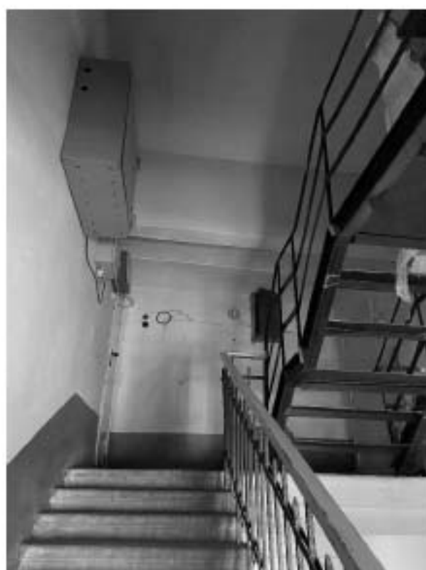
Фото 56. Пространство лестницы 13 ЛК.
