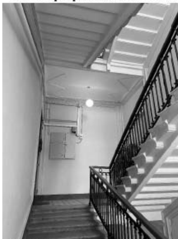
Фото 29. Пространство лестницы 7 ЛК.
