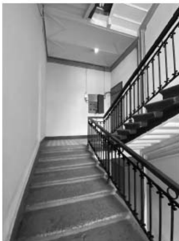
Фото 37. Пространство лестницы 9 ЛК.
