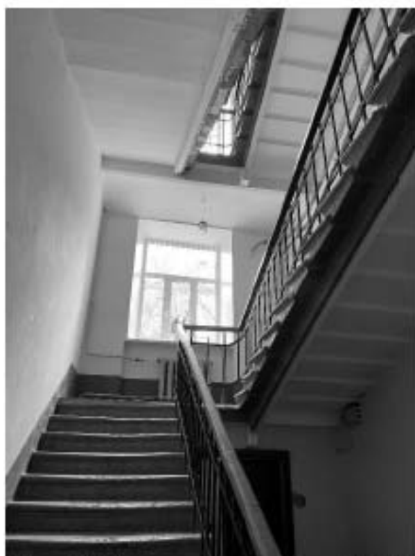
Фото 59. Пространство лестницы 15 ЛК.
