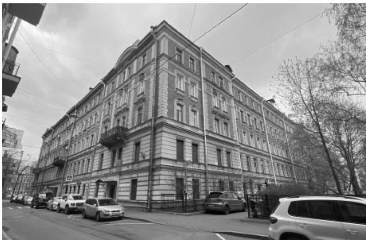
Фото 6. Угол пересечения Ораниенбаумской улицы и Колпинского переулка.
