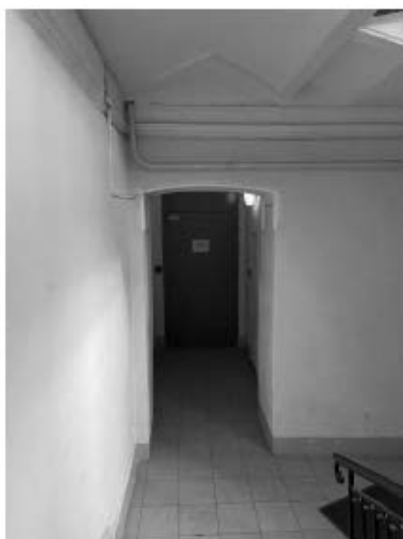
Фото 45. Пространство лестницы 11 ЛК.
