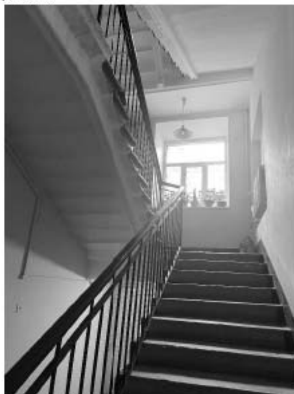
Фото 17. Пространство лестницы 4 ЛК.
