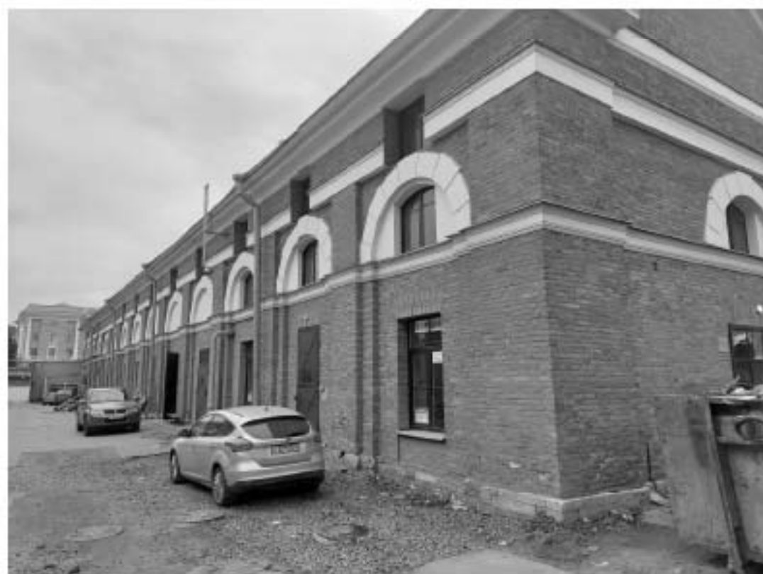
Две фото фасада Амбара В, обращенного во двор на восточной стороне здания.
