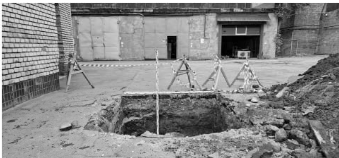
Рис. 63. Санкт-Петербург, Петроградский район. Чкаловский проспект, д. 15. Шурф № 3. Общий вид шурфа на этапе финальной фиксации. Вид с юго-запада.
