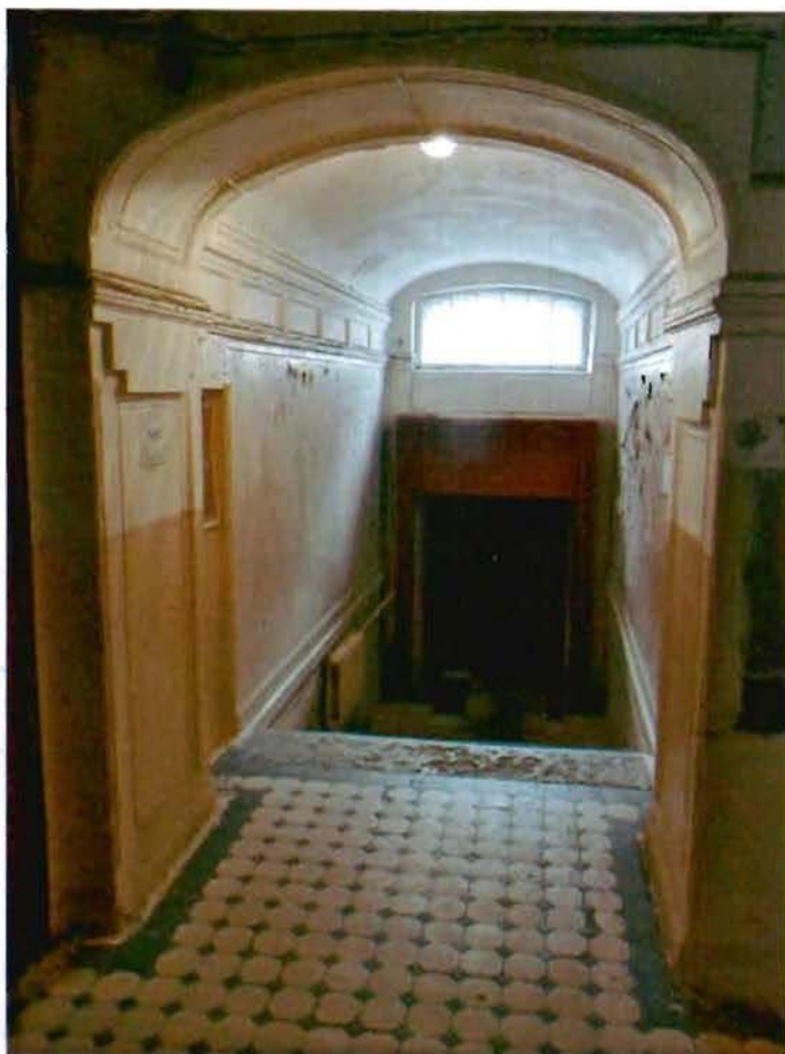
4. Вестибюль лестницы Л-3.
