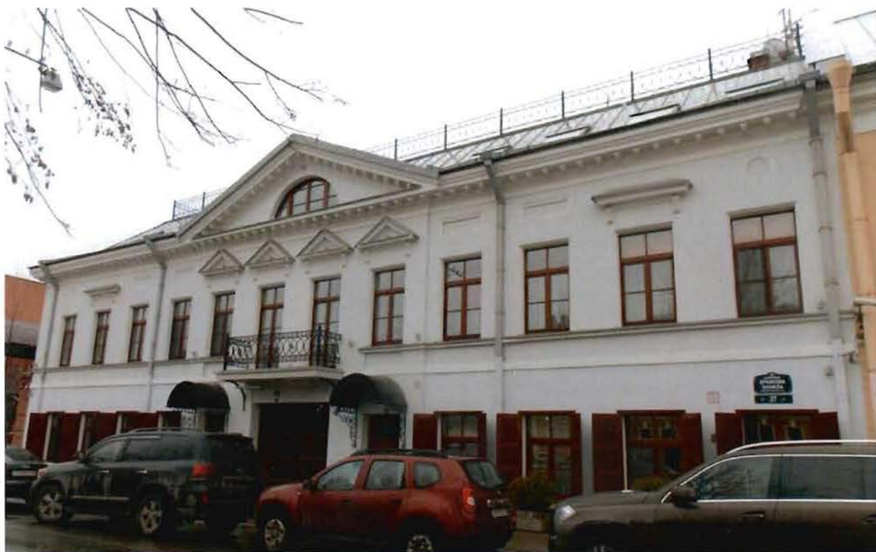
10. Фасад со стороны Крюкова канала 27.
