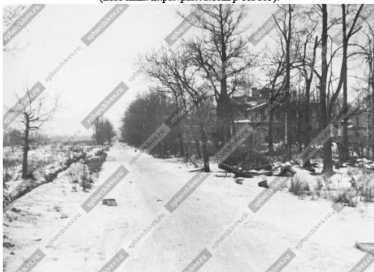
Илл. 69. Вид разрушенных немцами жилых домов справа от Слуцкого шоссе. 1941-1944 гг. (источник: ЦГАКФФД СПб. Фотоальбом Пр 1048. Позитив сн.9).
