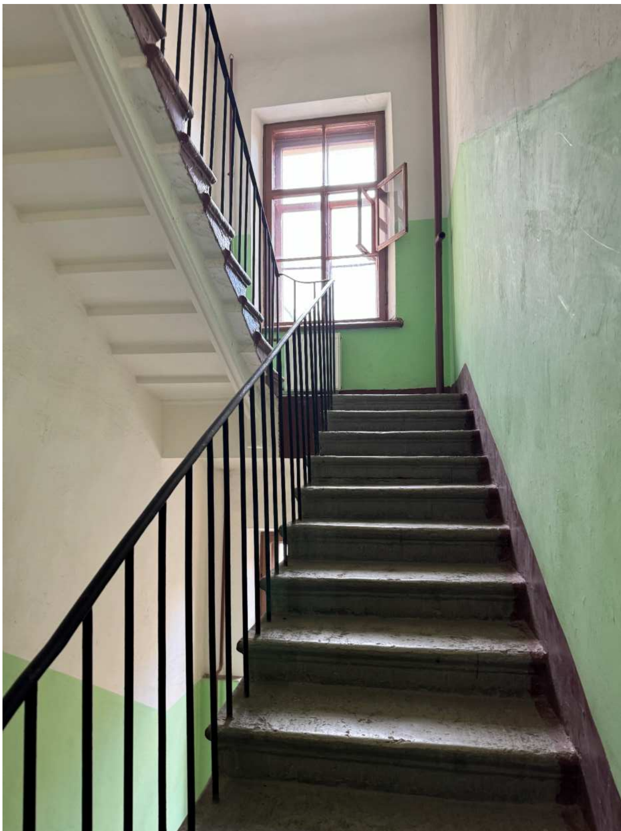
Фото 15. Помещение лестницы 3-ЛК объекта культурного наследия.
