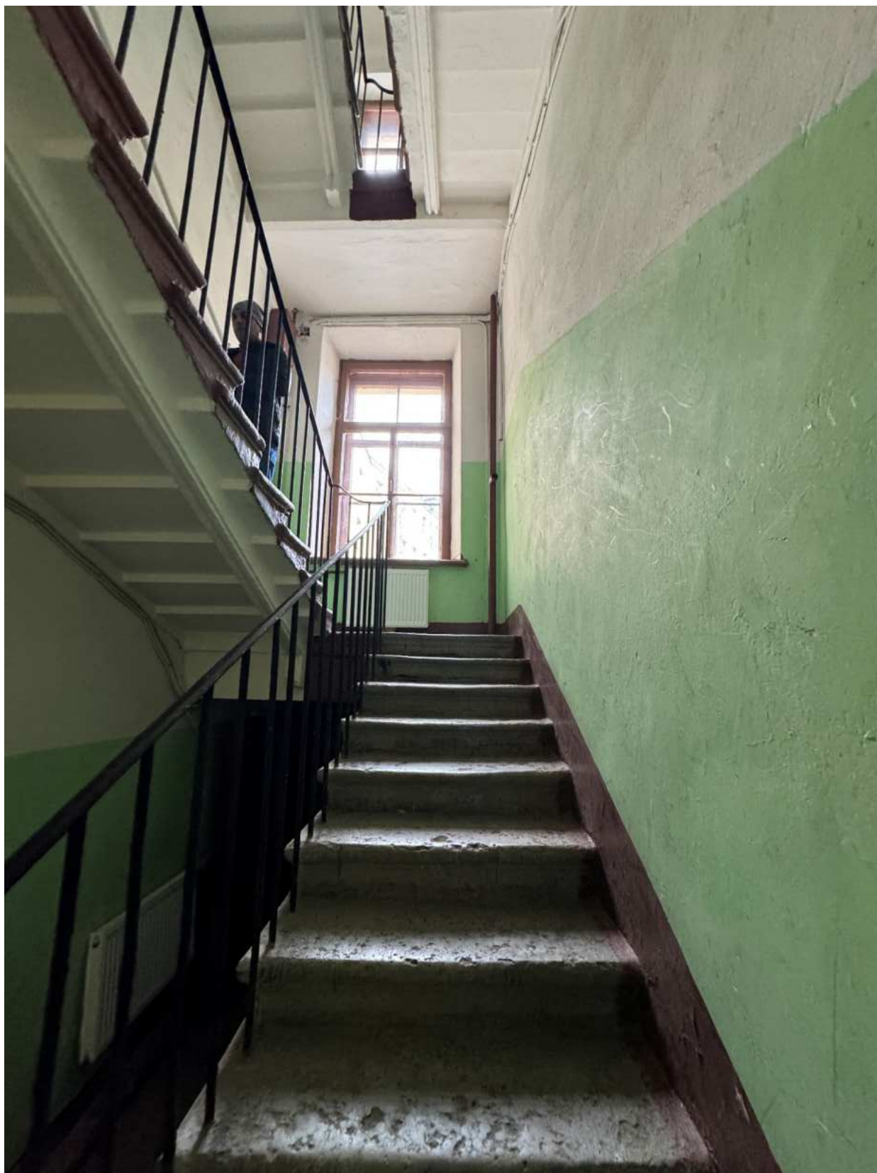
Фото 11. Помещение лестницы 3-ЛК объекта культурного наследия.
