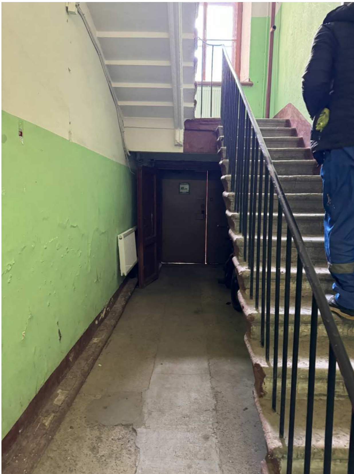
Фото 10. Помещение лестницы 3-ЛК объекта культурного наследия.
