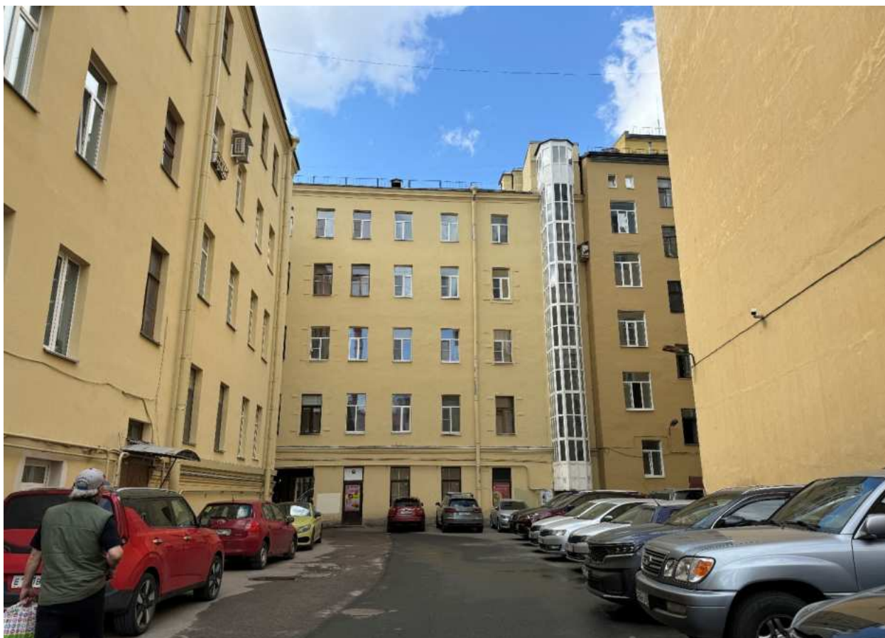
Фото 5. Фрагмент дворового фасада объекта культурного наследия.
