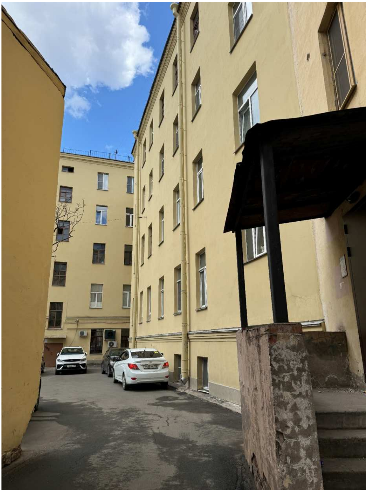
Фото 7. Фрагмент дворовых фасадов объекта культурного наследия.
