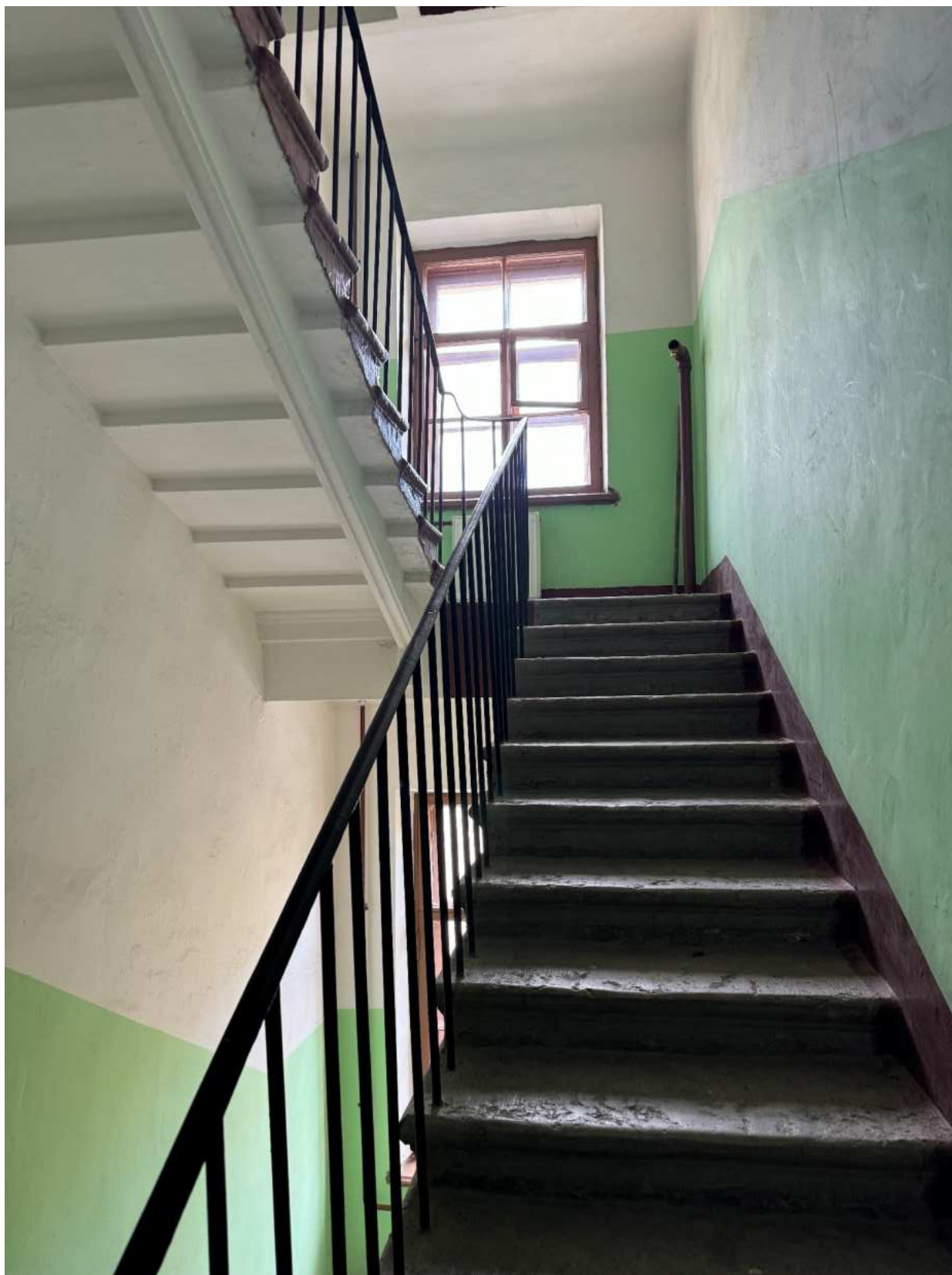
Фото 17. Помещение лестницы 3-ЛК объекта культурного наследия.
