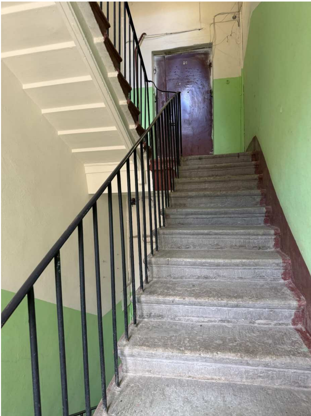
Фото 14. Помещение лестницы 3-ЛК объекта культурного наследия.
