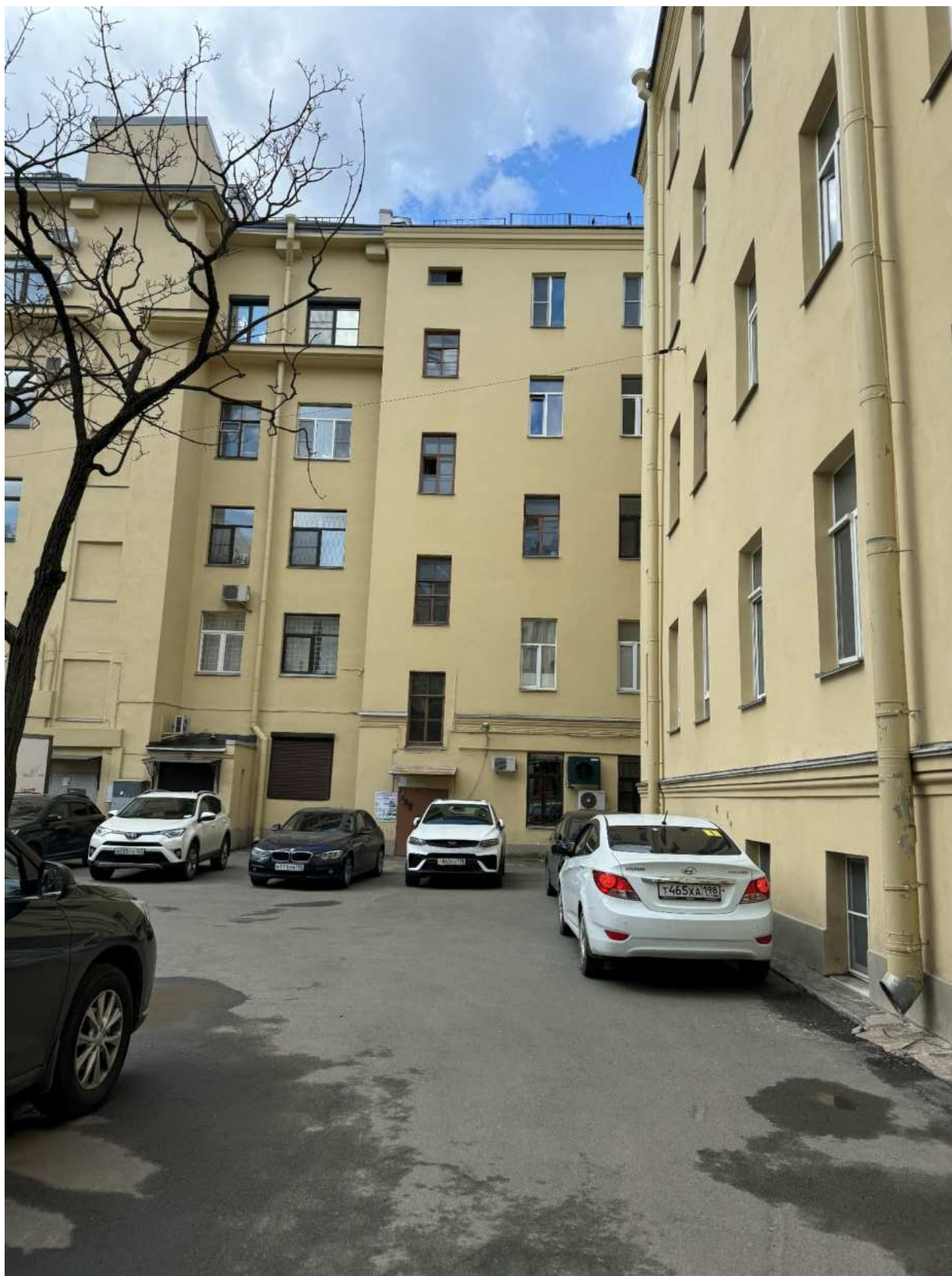
Фото 8. Фрагмент дворовых фасадов объекта культурного наследия.
