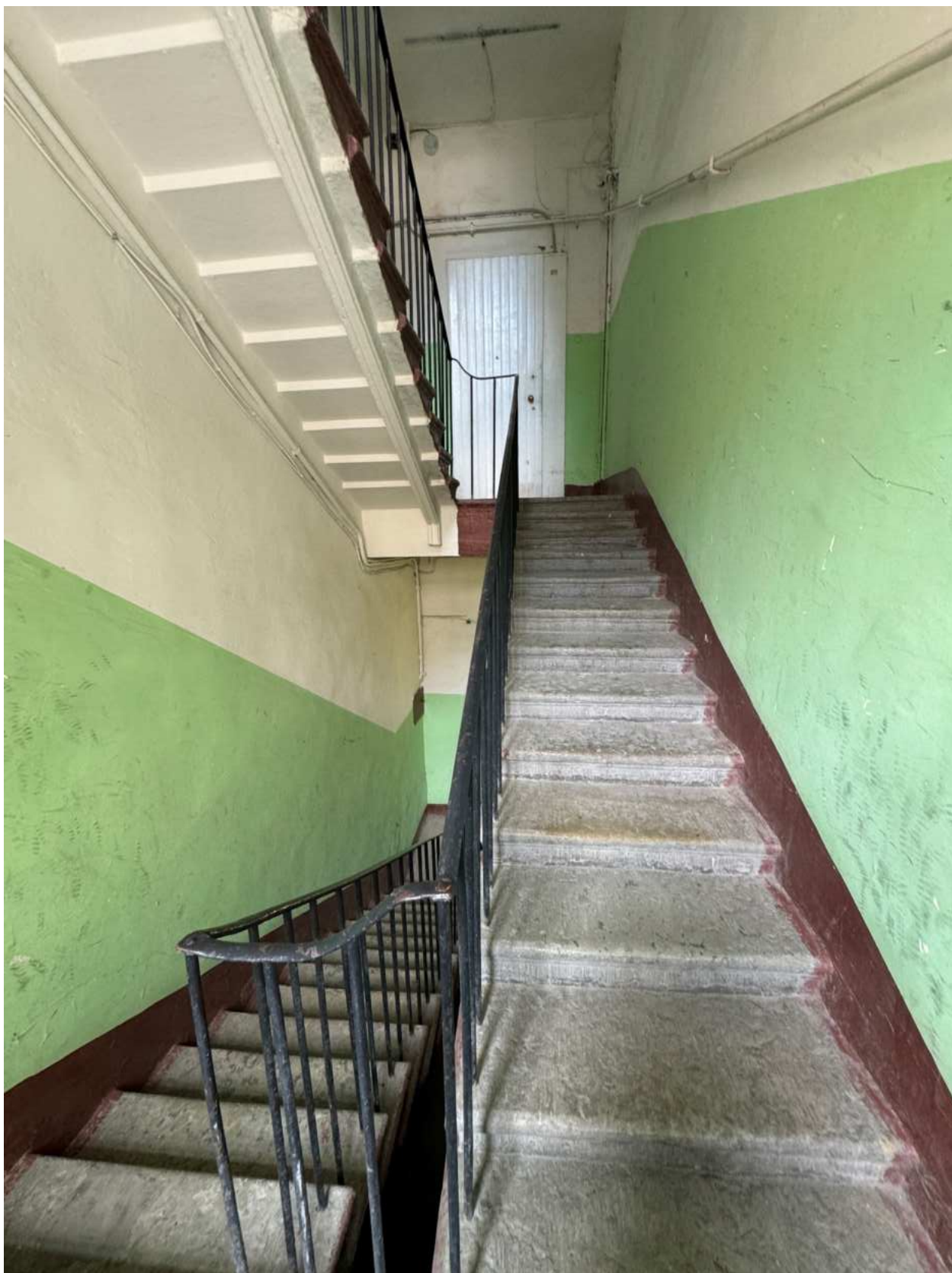
Фото 12. Помещение лестницы 3-ЛК объекта культурного наследия.
