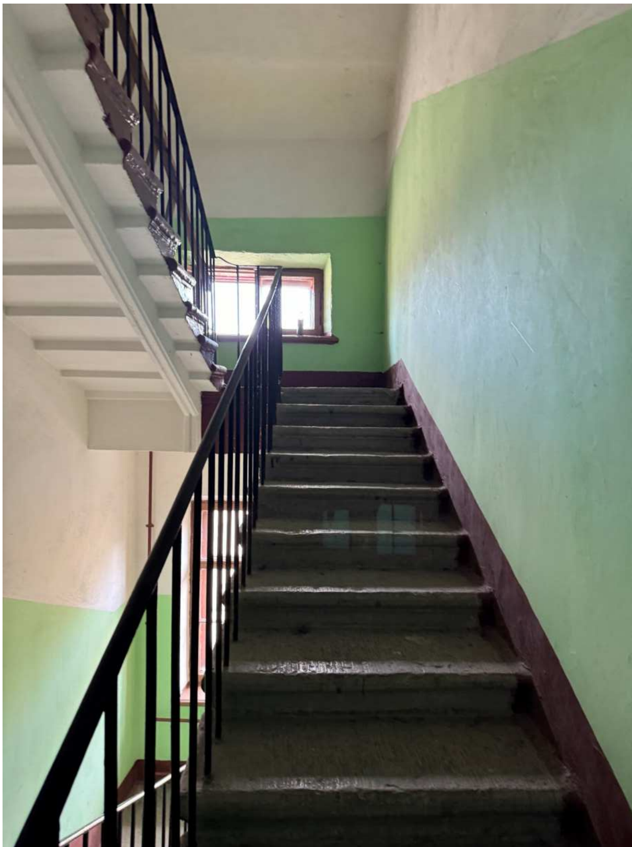
Фото 19. Помещение лестницы 3-ЛК объекта культурного наследия.
