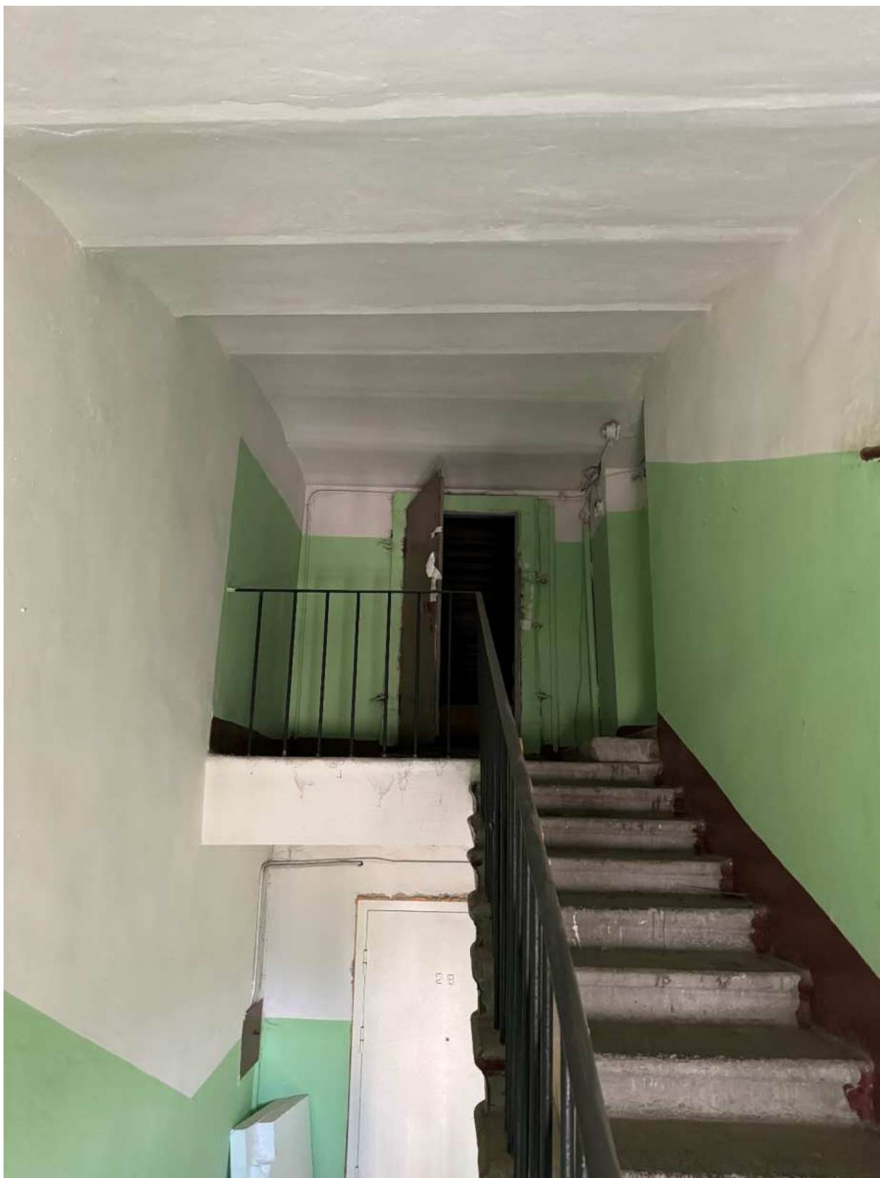
Фото 20. Помещение лестницы 3-ЛК объекта культурного наследия.
