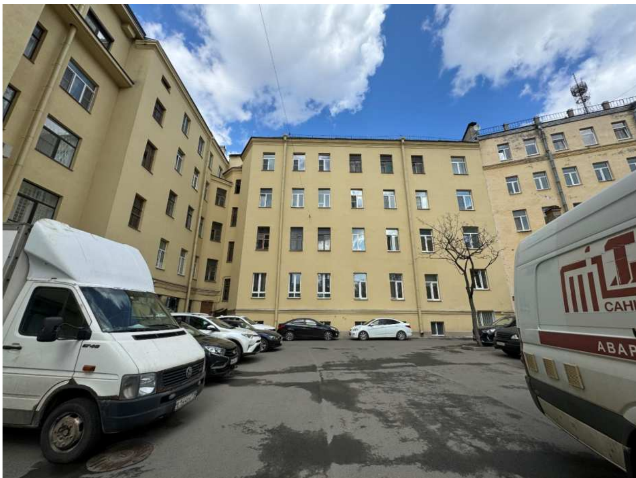
Фото 9. Общий вид дворовых фасадов объекта культурного наследия.
