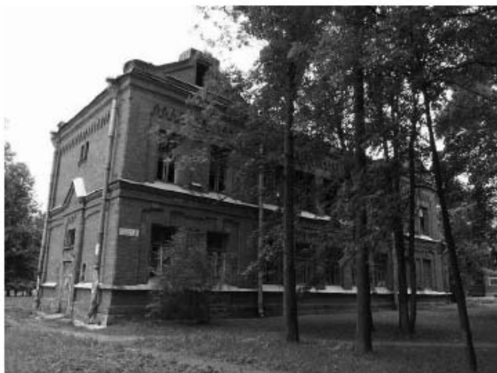
Илл. 72. Пушкин, Набережная улица, дом 3. Северо-западный фасад. 2012 г.
