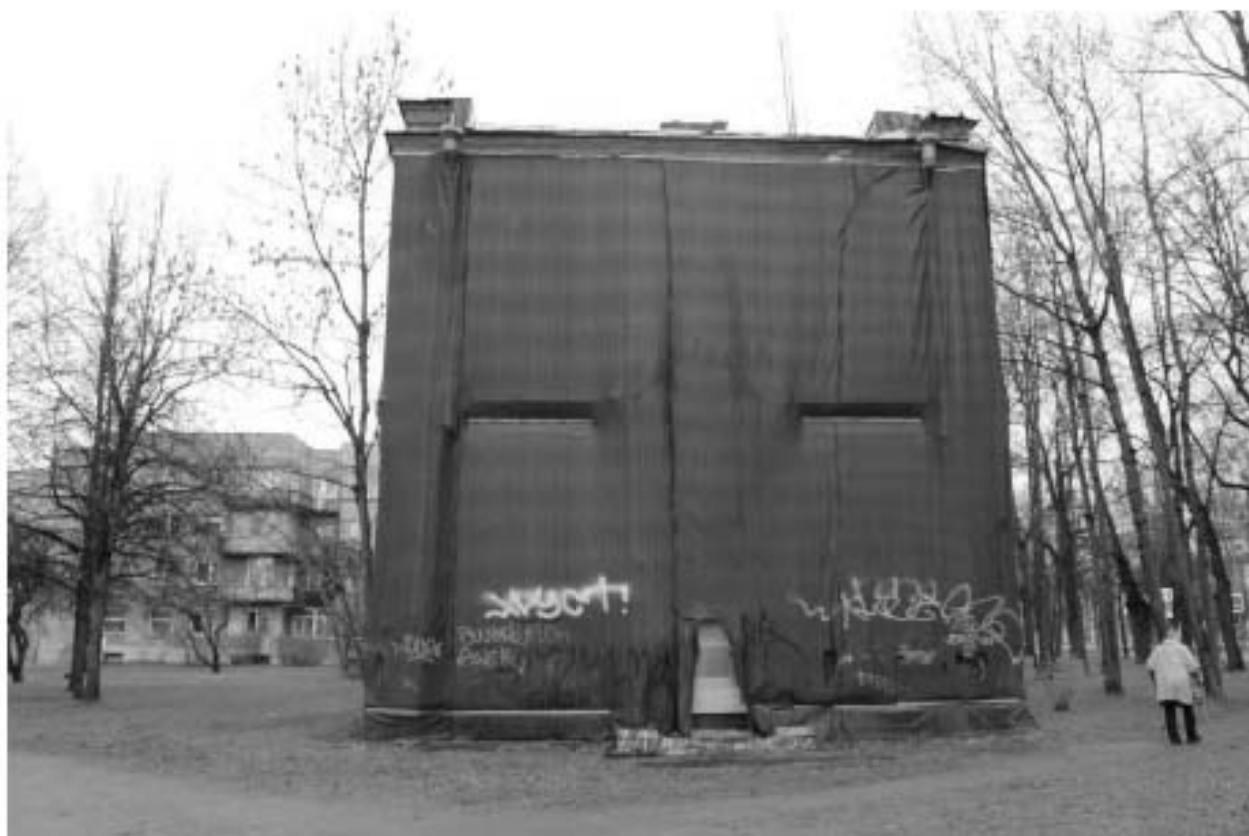
Фото 3. Вид на северо-восточный фасад выявленного объекта культурного наследия «Жилой дом Ремесленного женского приюта (?)».
