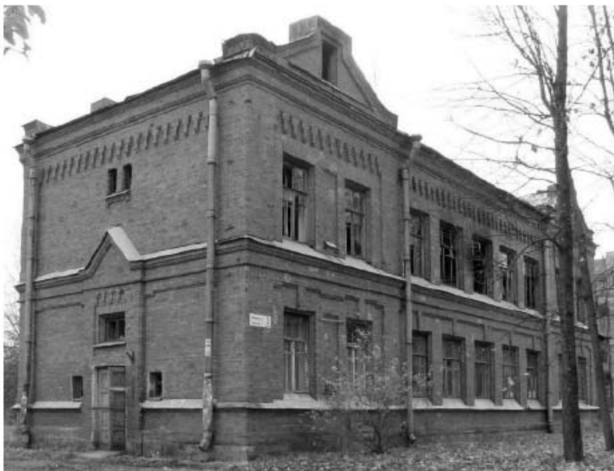
Илл. 70. Пушкин, Набережная улица, дом 3. Северо-западный фасад. 2011 г. (источник: https://www.citywalls.ru/photo194797.html ).
