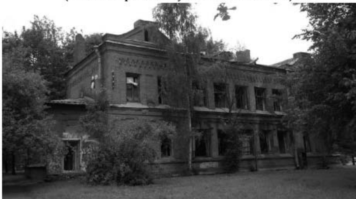
Илл. 77. Пушкин, Набережная улица, дом 3. Юго-восточный фасад. 2018 г. (источник: https://commons.m.wikimedia.org/wiki/File:Сгоревший_прачечный_флигель.jpg ).
