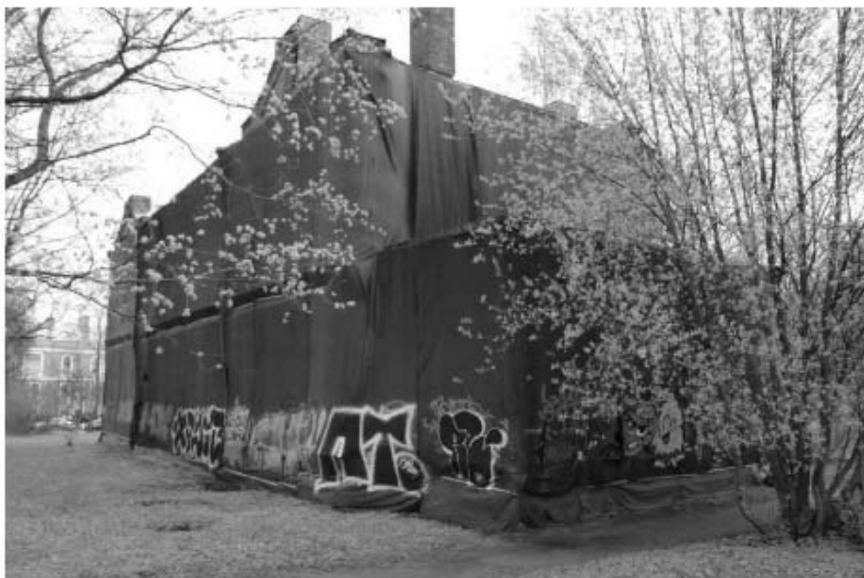
Фото 7. Вид на северо-западный фасад выявленного объекта культурного наследия «Жилой дом Ремесленного женского приюта (?)».
