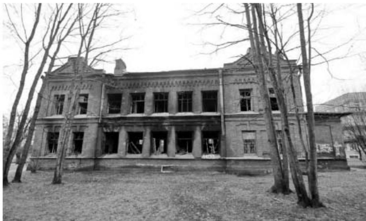
Илл. 74. Пушкин, Набережная улица, дом 3. Северо-западный фасад. 2017 г. (источник: https://kanoner.com/2017/11/21/157689/ ).
