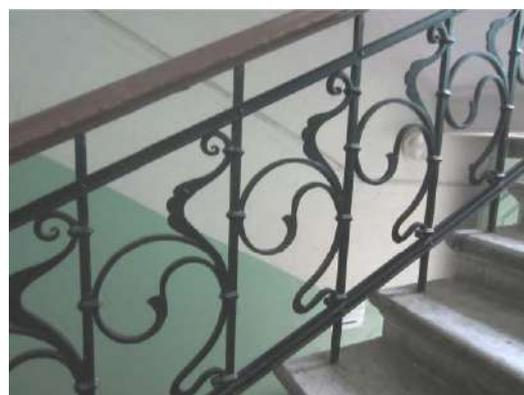
служебная лестница – местоположение, габариты, конструкция (по металлическим косоурам), тип (двухмаршевая); исторический материал ступеней (лещадная плита);
