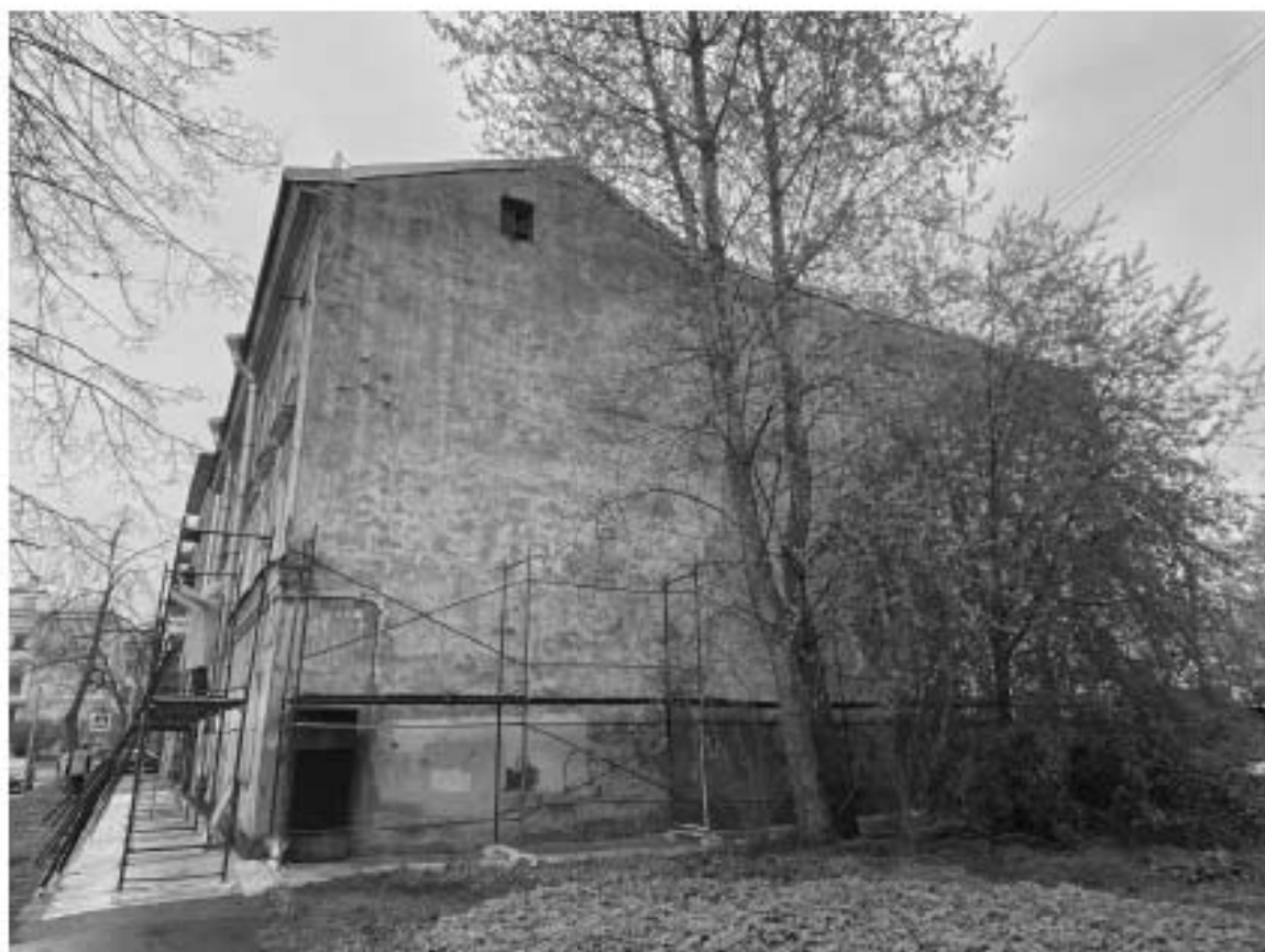
Фото 2. Торцевой фасад дома № 4 по улице Гусева.
