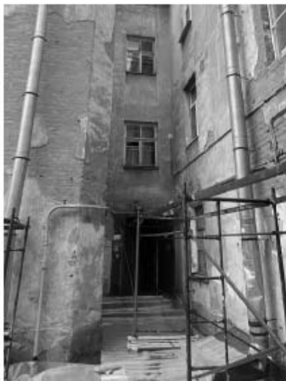
Фото 8. Вид на вход в помещение лестницы 2.
