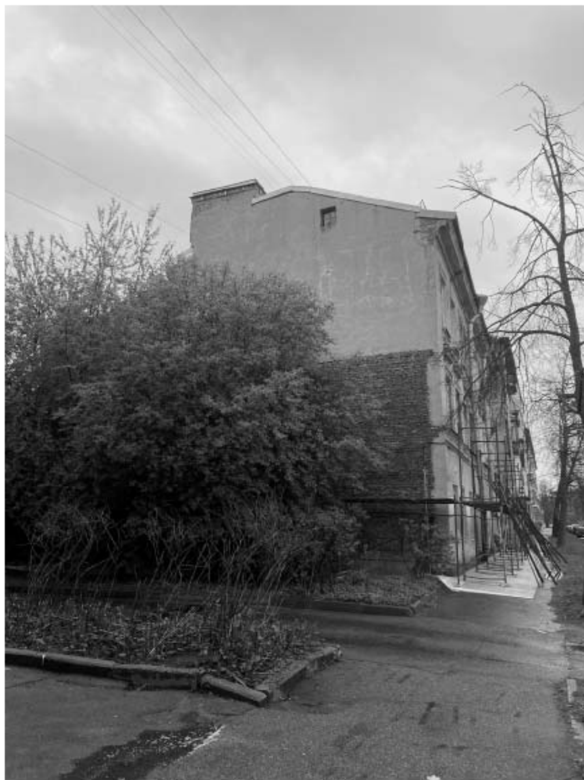
Фото 5. Торцевой фасад дома № 4 по улице Гусева.
