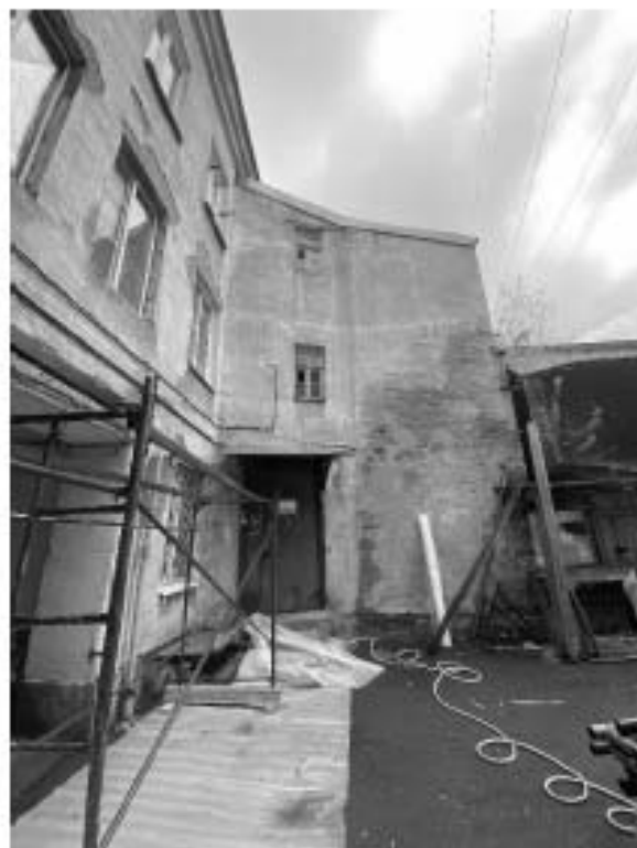
Фото 9. Вид на вход в помещение лестницы 1.
