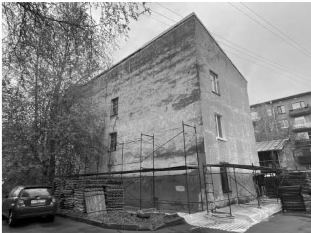
Фото 12. Торцевой и дворовый фасады дома № 4 по улице Гусева.
