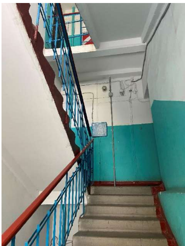
Фото 10. Вид на лестницу № 1.
