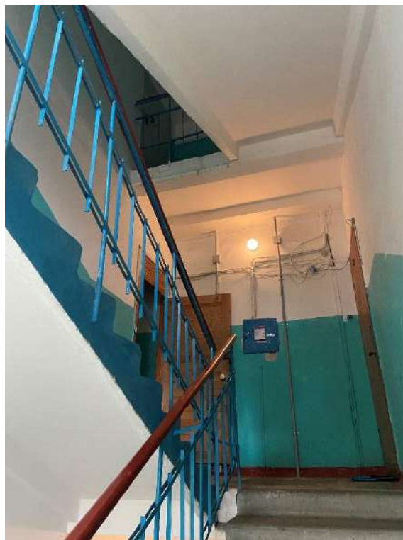
Фото 17. Вид на лестницу № 2.
