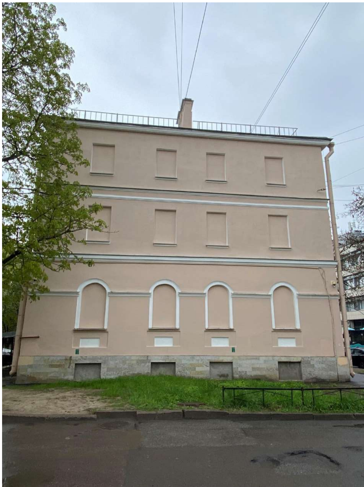
Фото 5. Вид на торцевой фасад дома № 11 по Гражданской улице.
