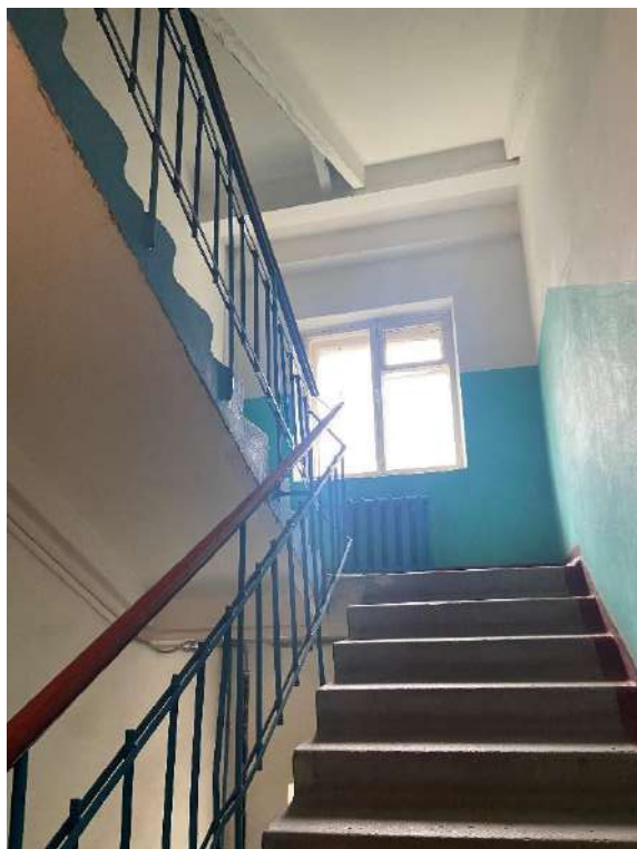
Фото 16. Вид на лестницу № 2.
