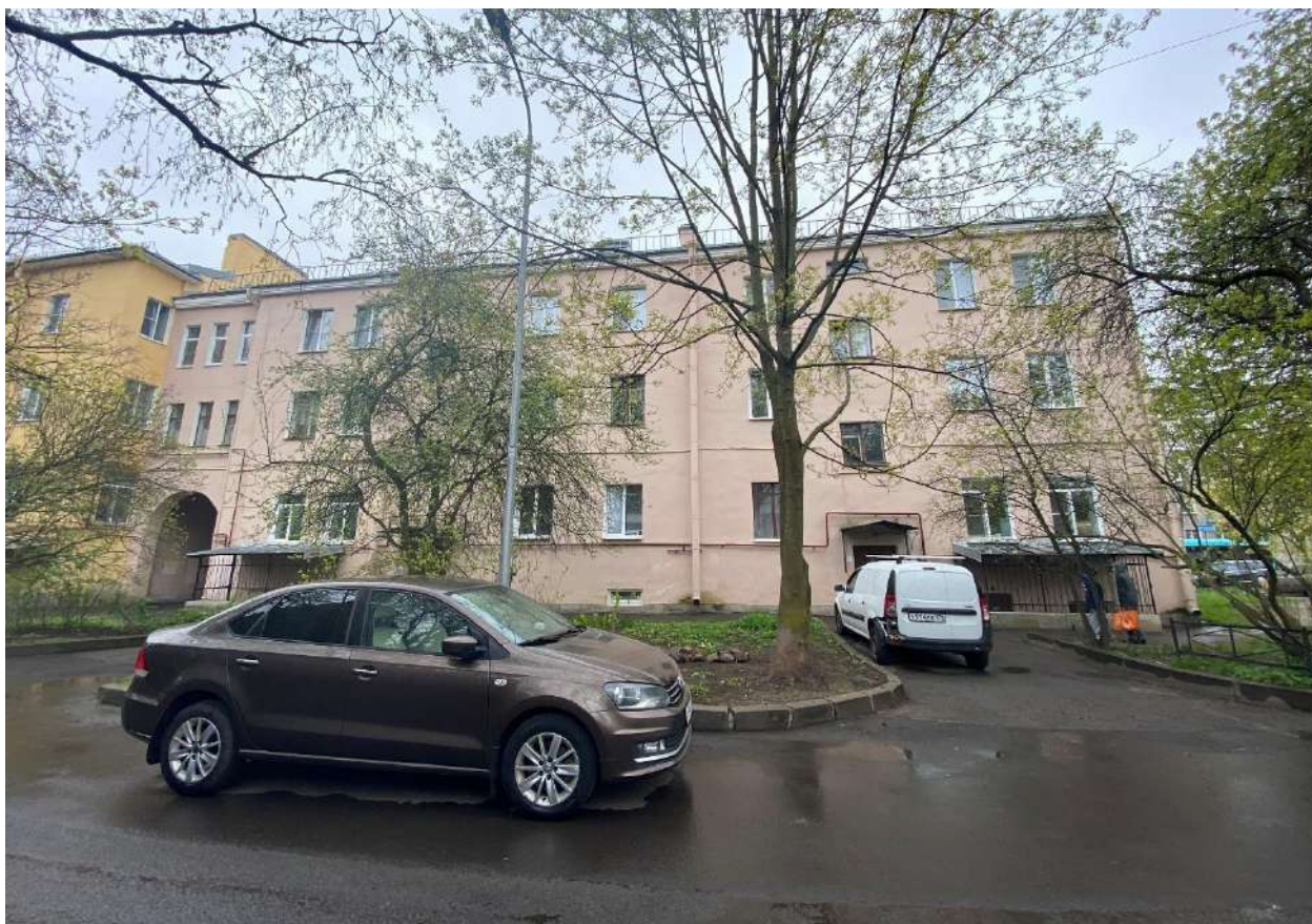
Фото 6. Вид на дворовой фасад дома № 11 по Гражданской улице.
