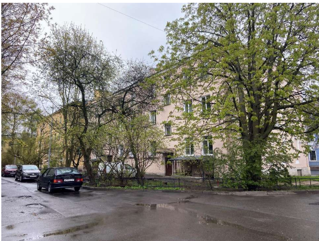
Фото 4. Вид на дворовой фасад дома № 11 по Гражданской улице.
