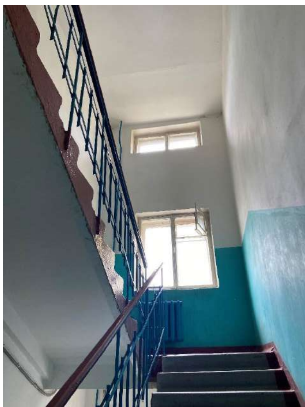
Фото 11. Вид на лестницу № 1.
