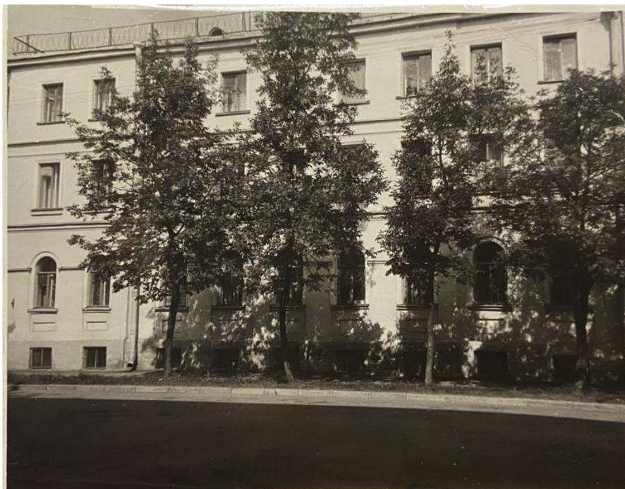
Илл. 14. Вид на дома № 11 по Гражданской ул. Дата: 1990 г. Источник: архив КГИОП.
