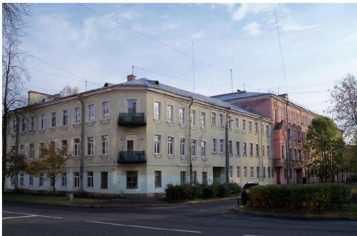
Илл. 10. Вид на дом № 8 по Ленинградской улице. Дата: 2018 г. Источник: citywalls.ru.
