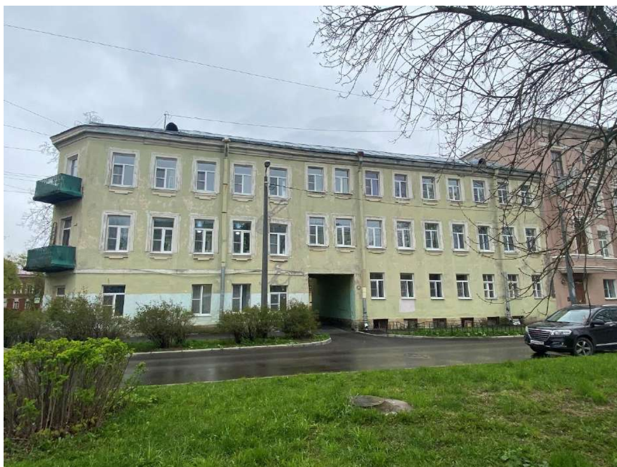
Фото 4. Вид на юго-восточный фасад дома № 8 по Ленинградской улице.
