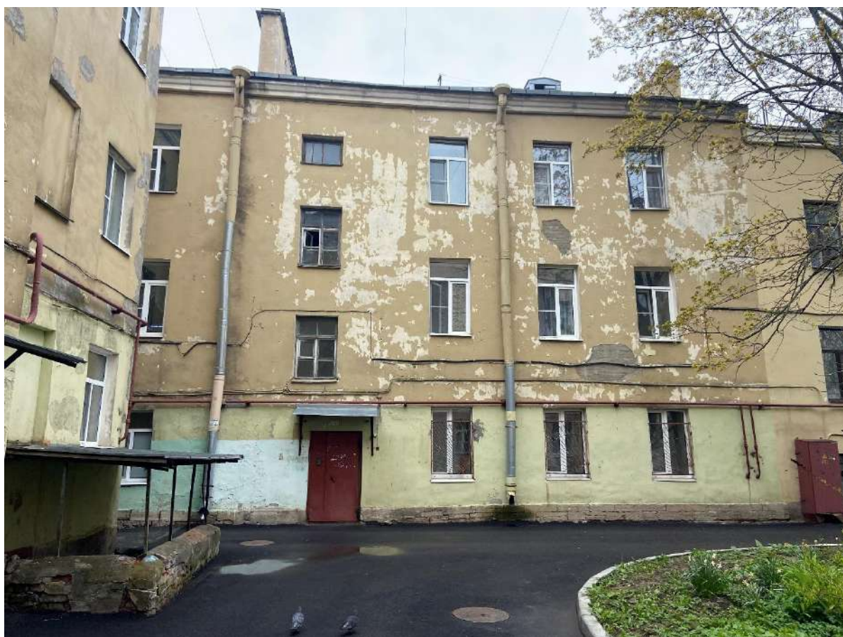
Фото 6. Вид на дворовый фасад.
