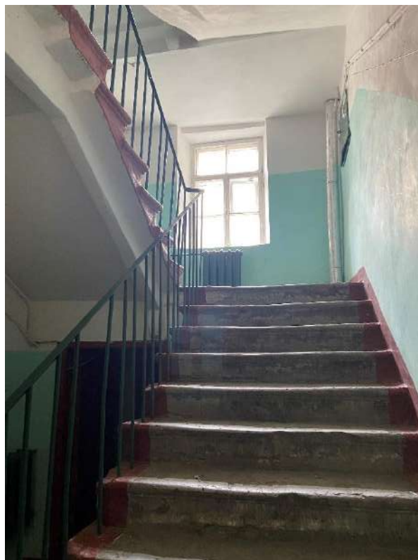
Фото 9. Вид на лестницу.
