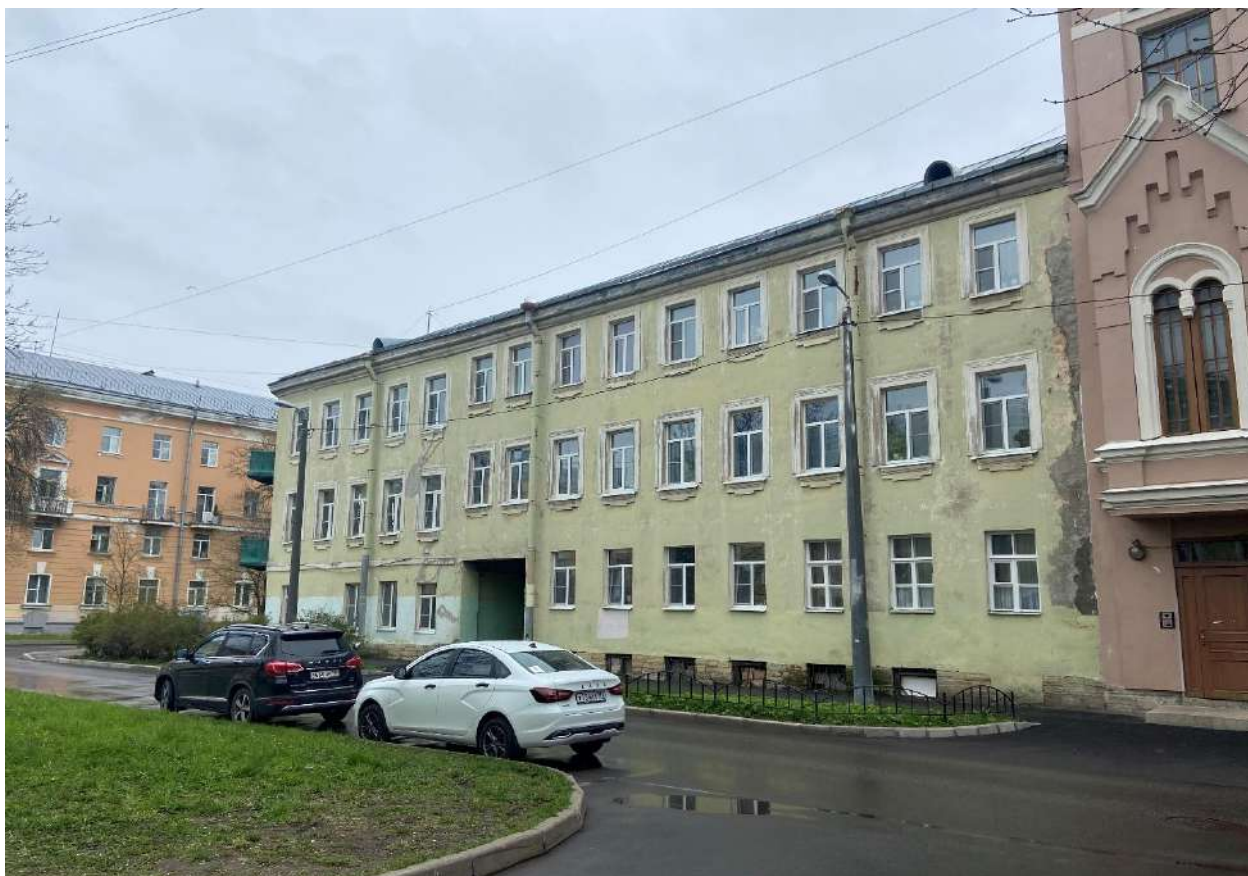
Фото 3. Вид на юго-восточный фасад дома № 8 по Ленинградской улице.
