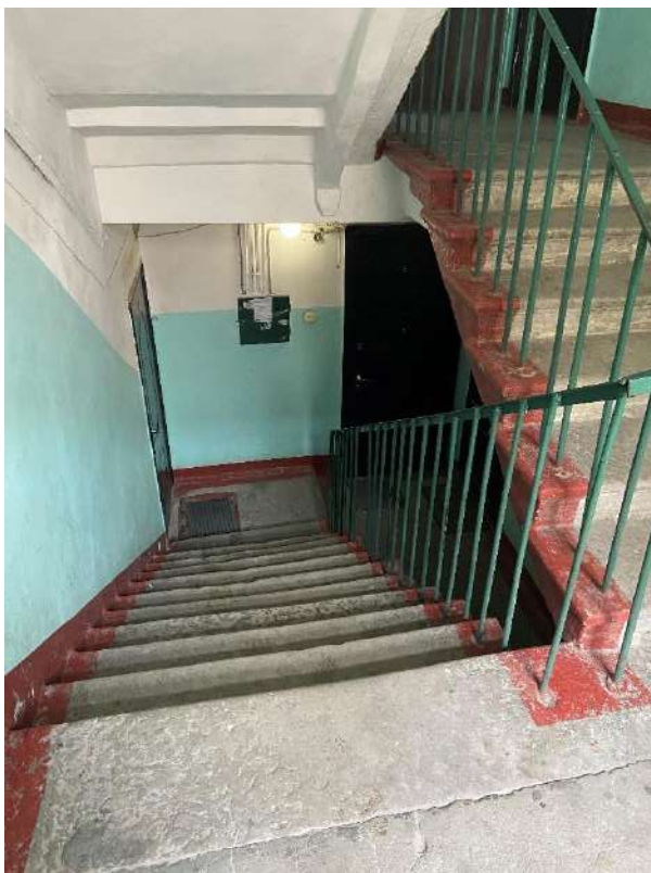
Фото 10. Вид на лестницу.
