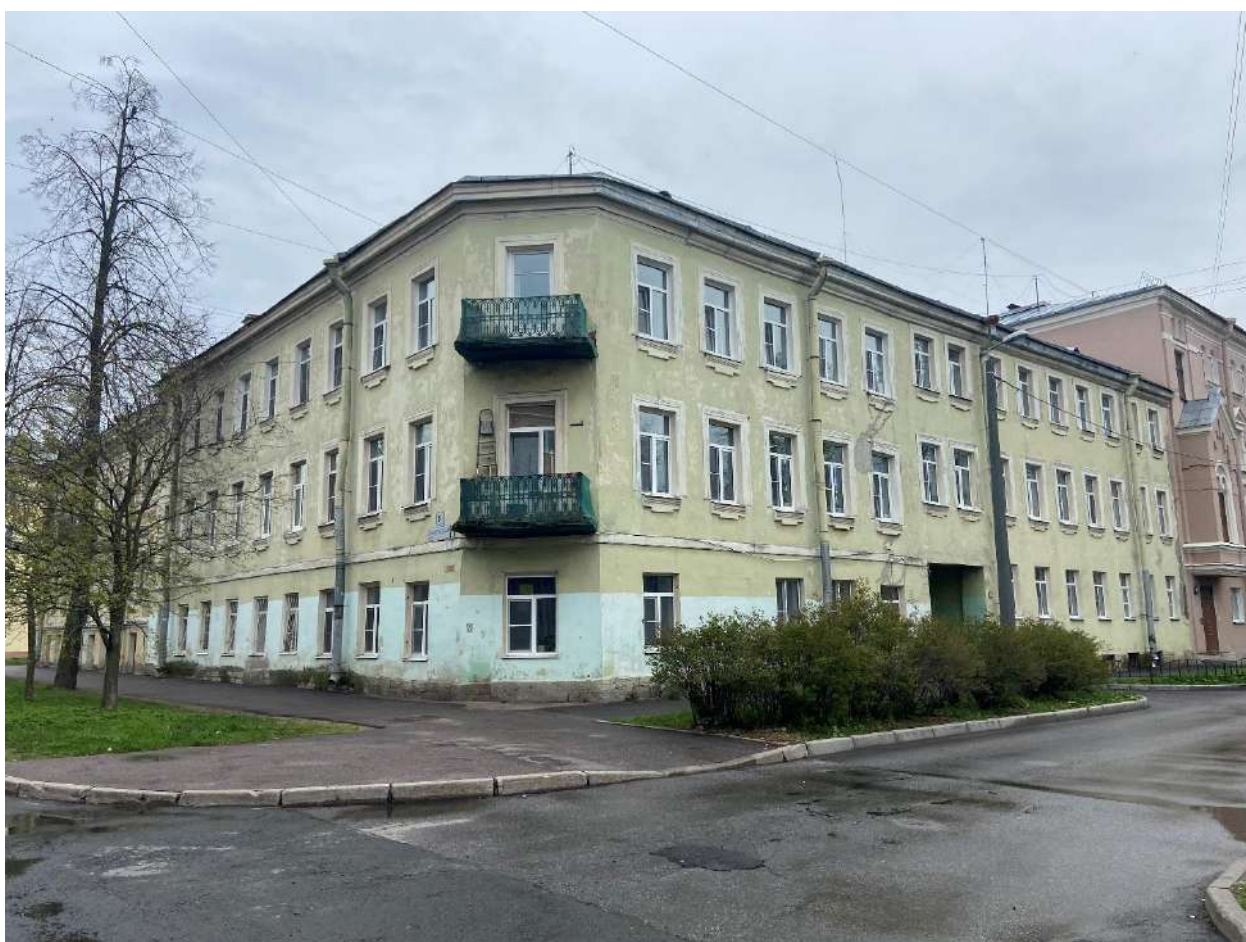
Фото 2. Вид на угол дома № 8 по Ленинградской улице.
