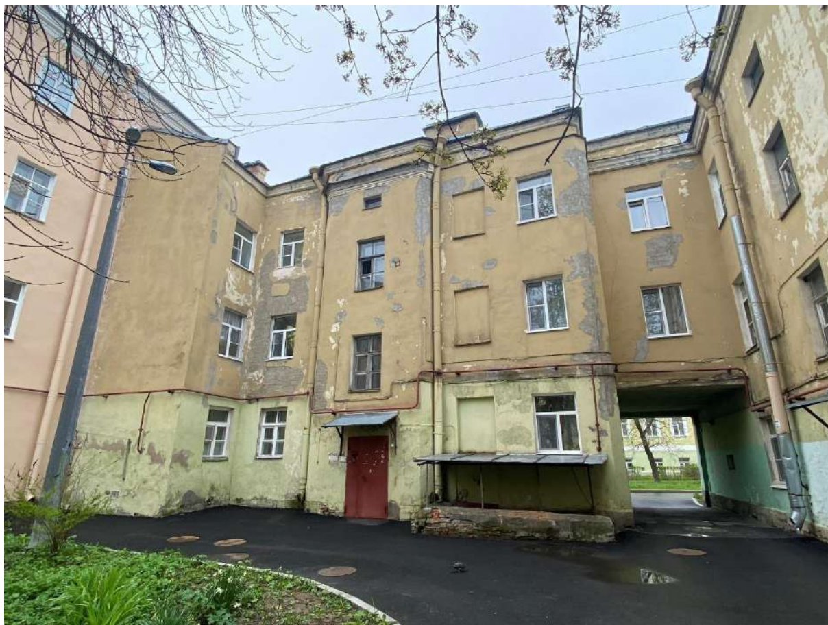
Фото 7. Вид на дворовый фасад.
