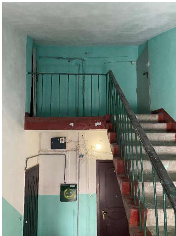
Фото 13. Вид на лестницу.
