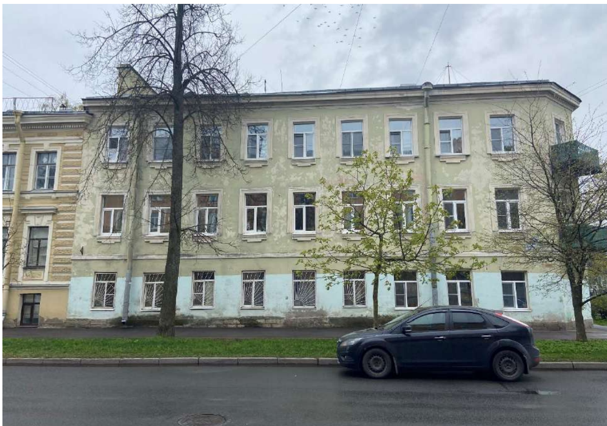
Фото 1. Вид на фасад здания № 8 по улице Ленинградской.
