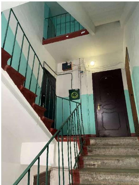
Фото 12. Вид на лестницу.
