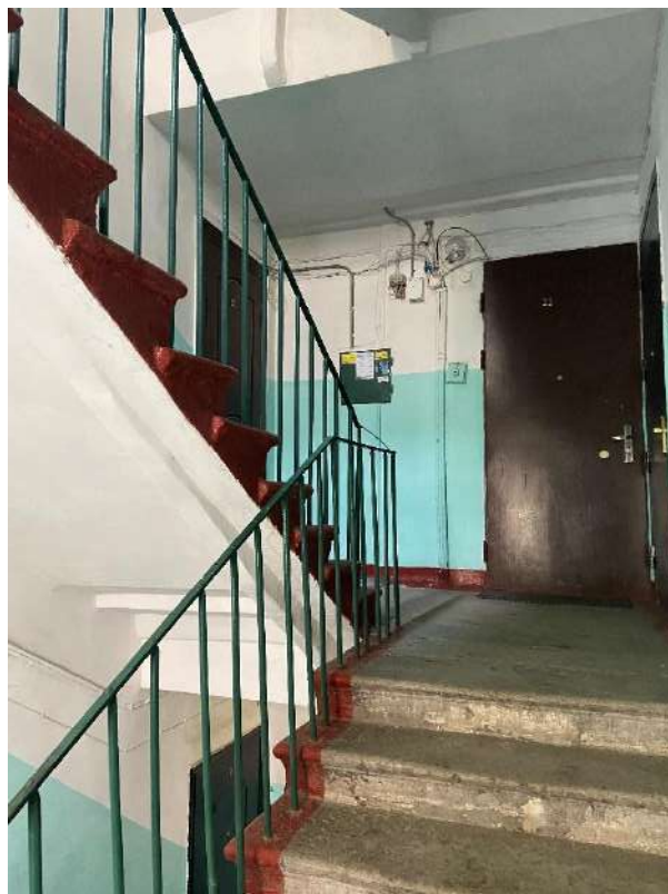
Фото 11. Вид на лестницу.
