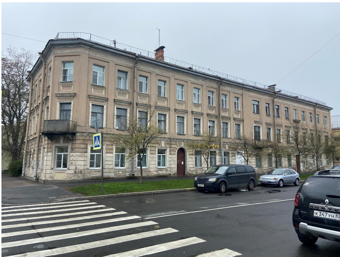
Фото 5. Вид на лицевой фасад дома № 14 по улице Ленинградской.
