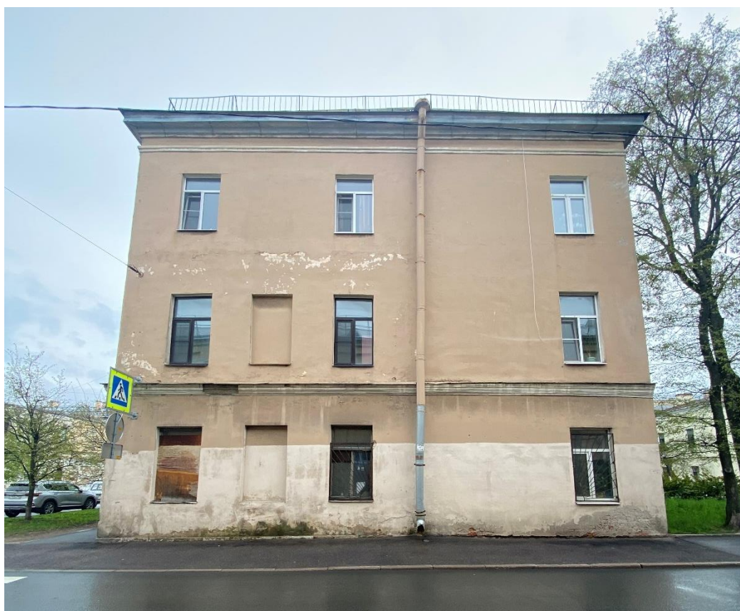
Фото 2. Вид на торцевой фасад здания по улице Комсомола.
