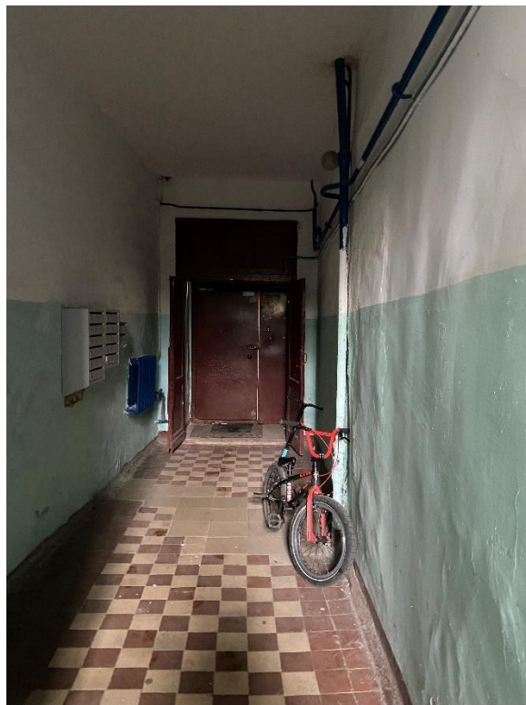
Фото 21. Вид на лестницу 2.
