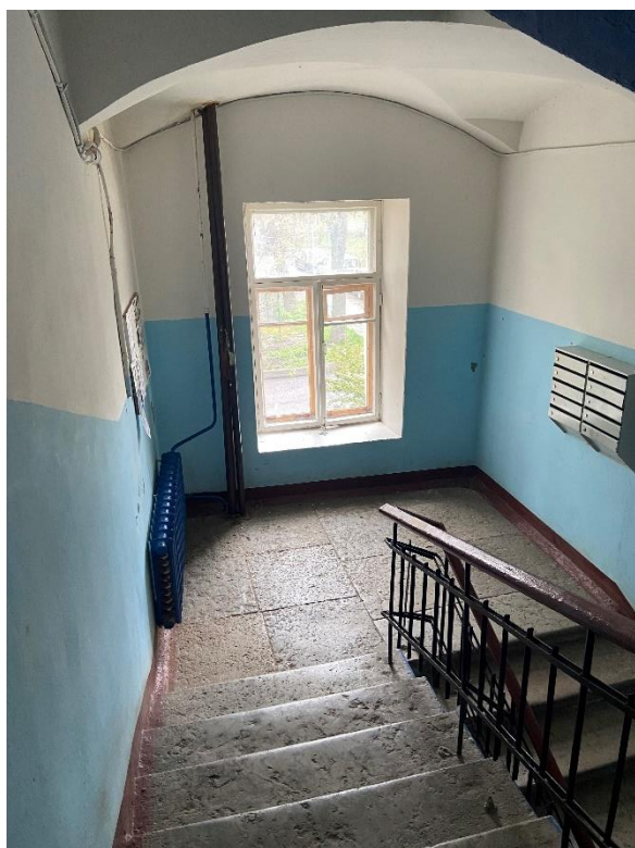
Фото 14. Вид на лестницу 1.
