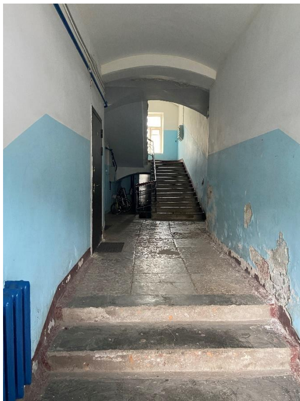
Фото 8. Вид на лестницу 1.
