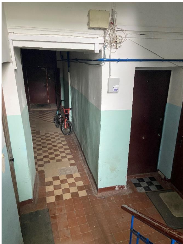
Фото 20. Вид на лестницу 2.
