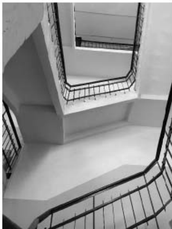
Фото 12. Вид лестницы 1 ЛК.
