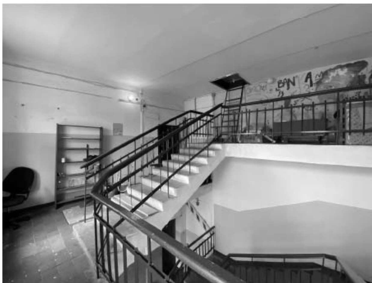
Фото 14. Вид лестницы 1 ЛК.
