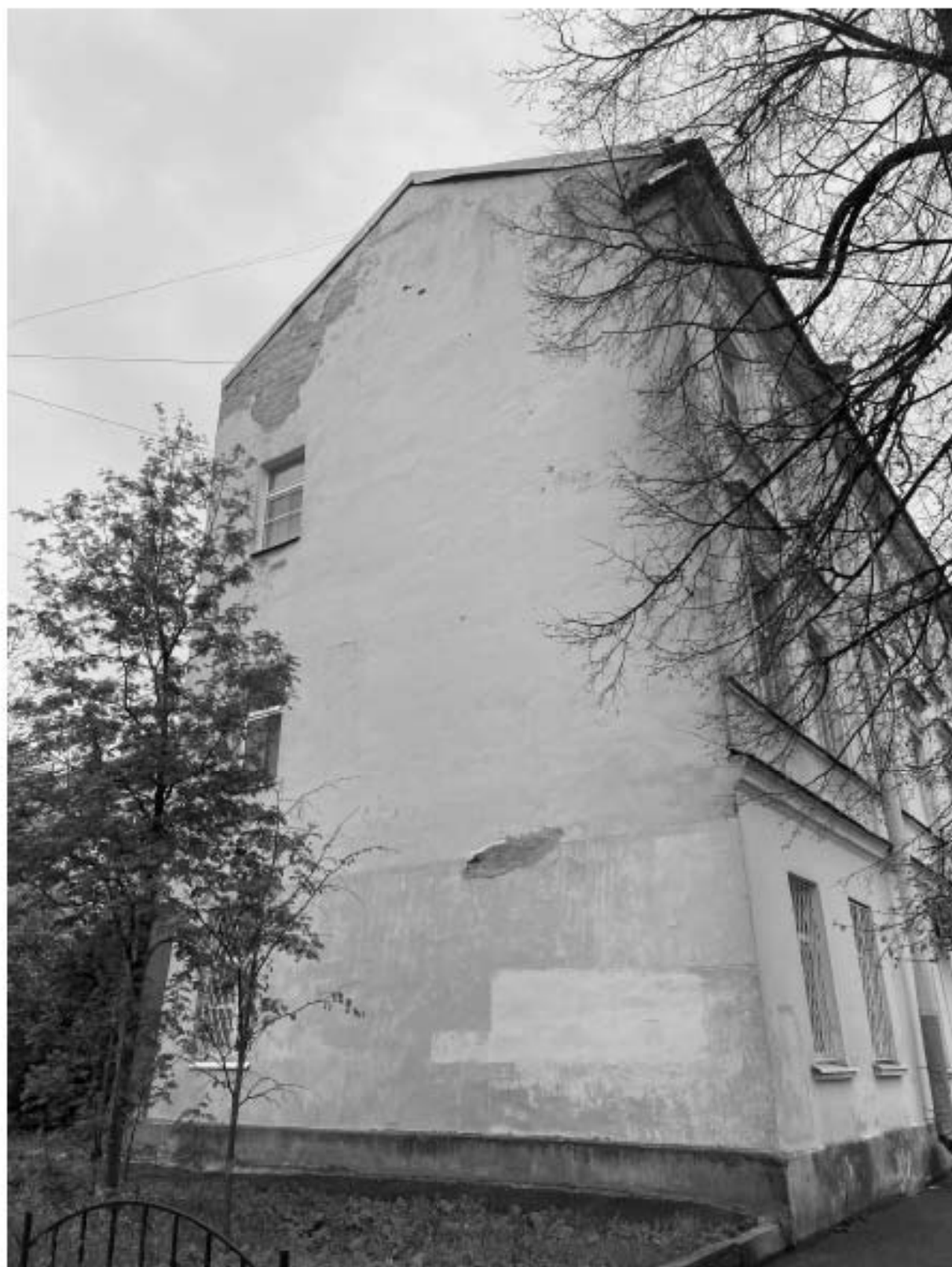
Фото 7. Вид на торцевой фасад дома № 12 по улице Ленинградской.
