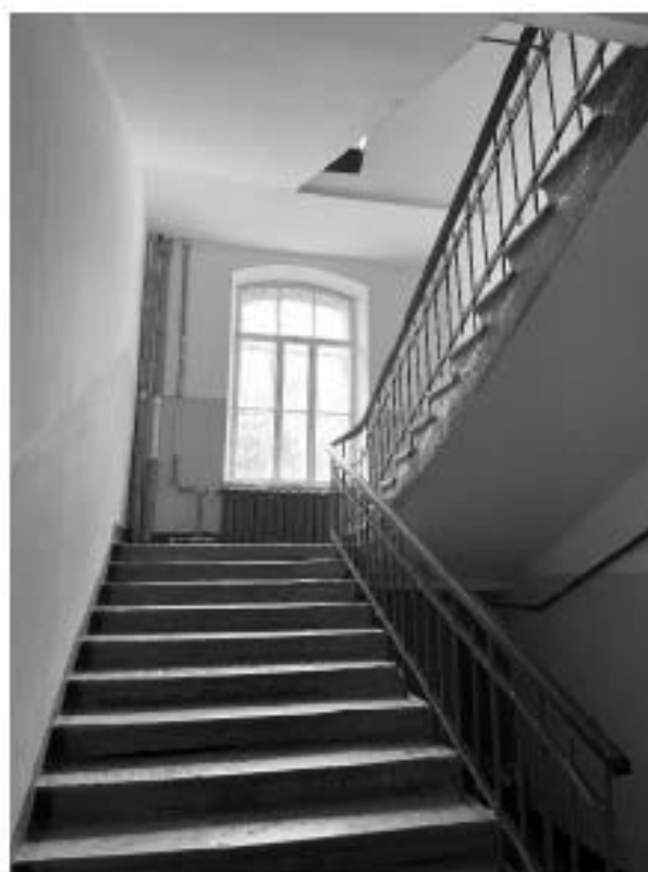
Фото 17. Вид лестницы 2 ЛК.
