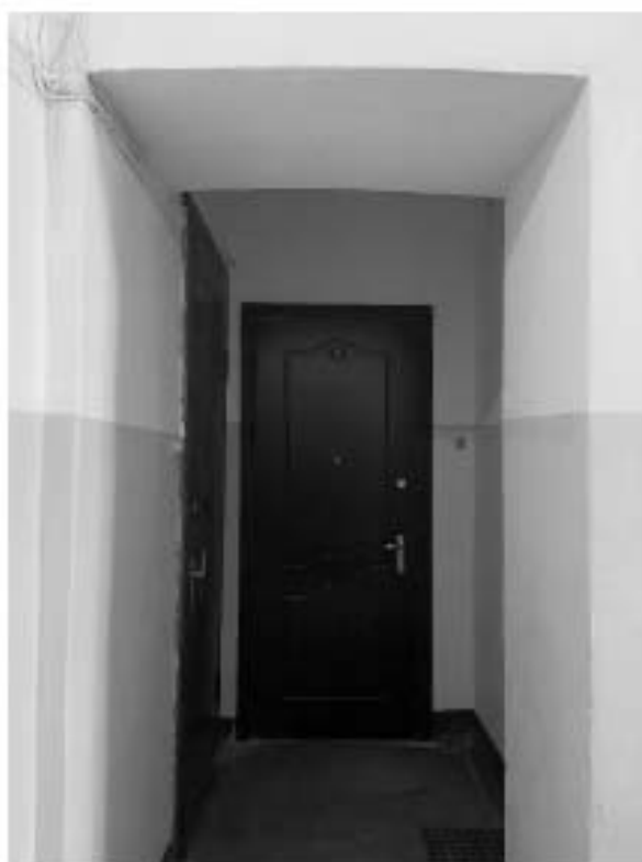
Фото 23. Вид лестницы 3 ЛК.
