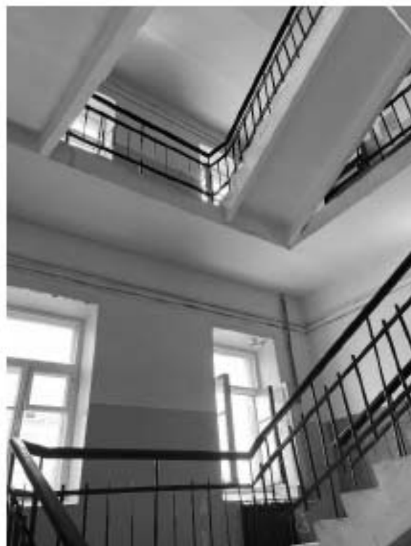
Фото 13. Вид лестницы 1 ЛК.
