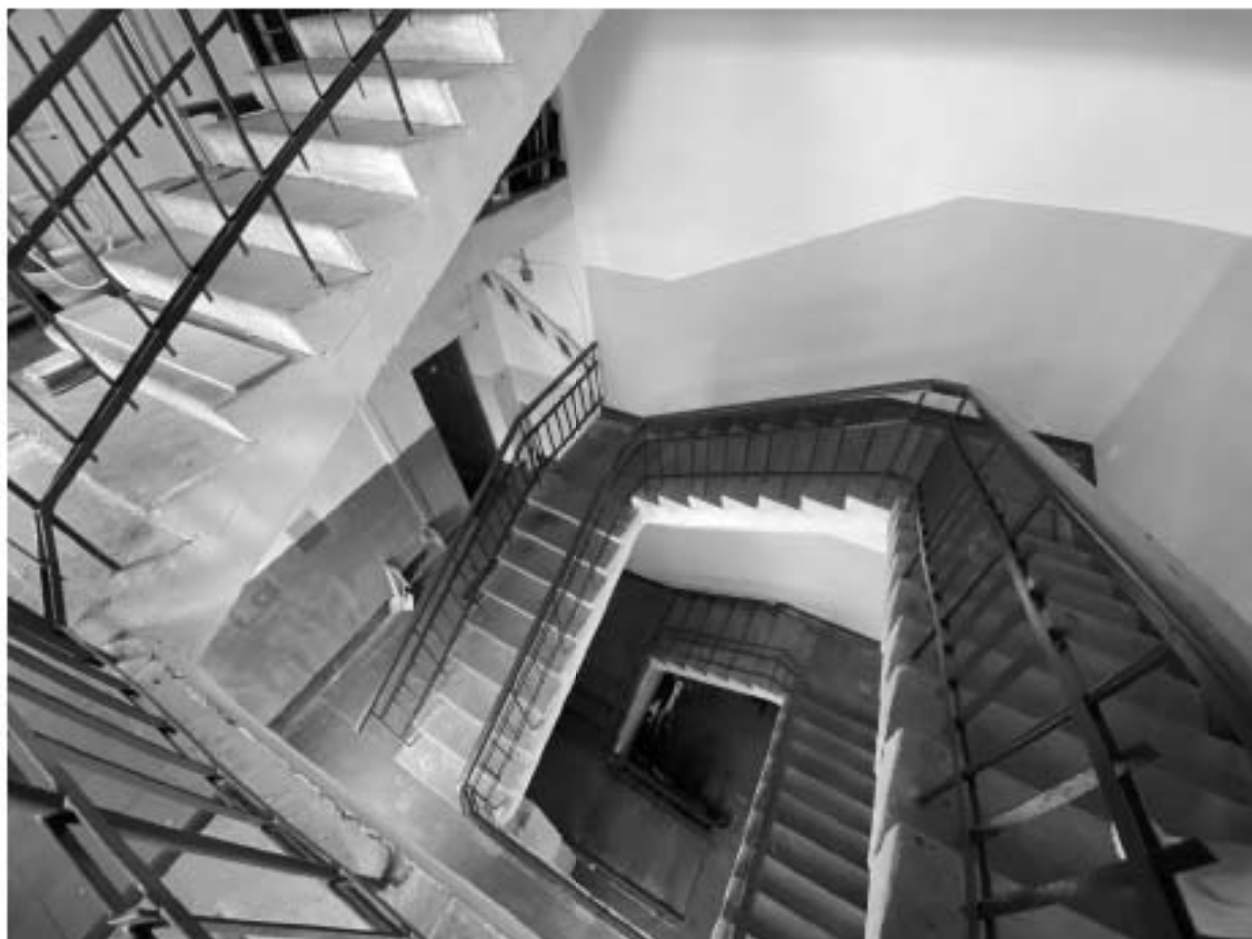
Фото 15. Вид лестницы 1 ЛК.
