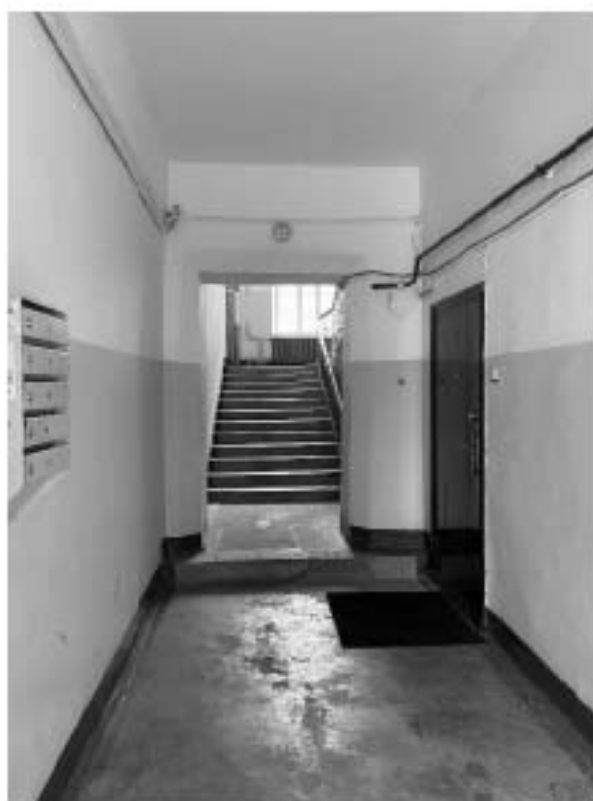
Фото 16. Вид лестницы 2 ЛК.
