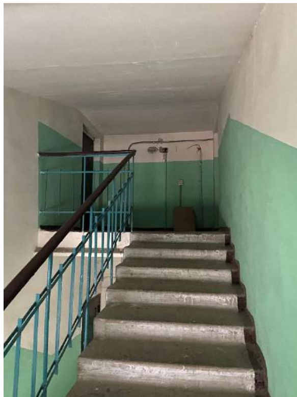
Фото 12. Вид на лестницу 1.
