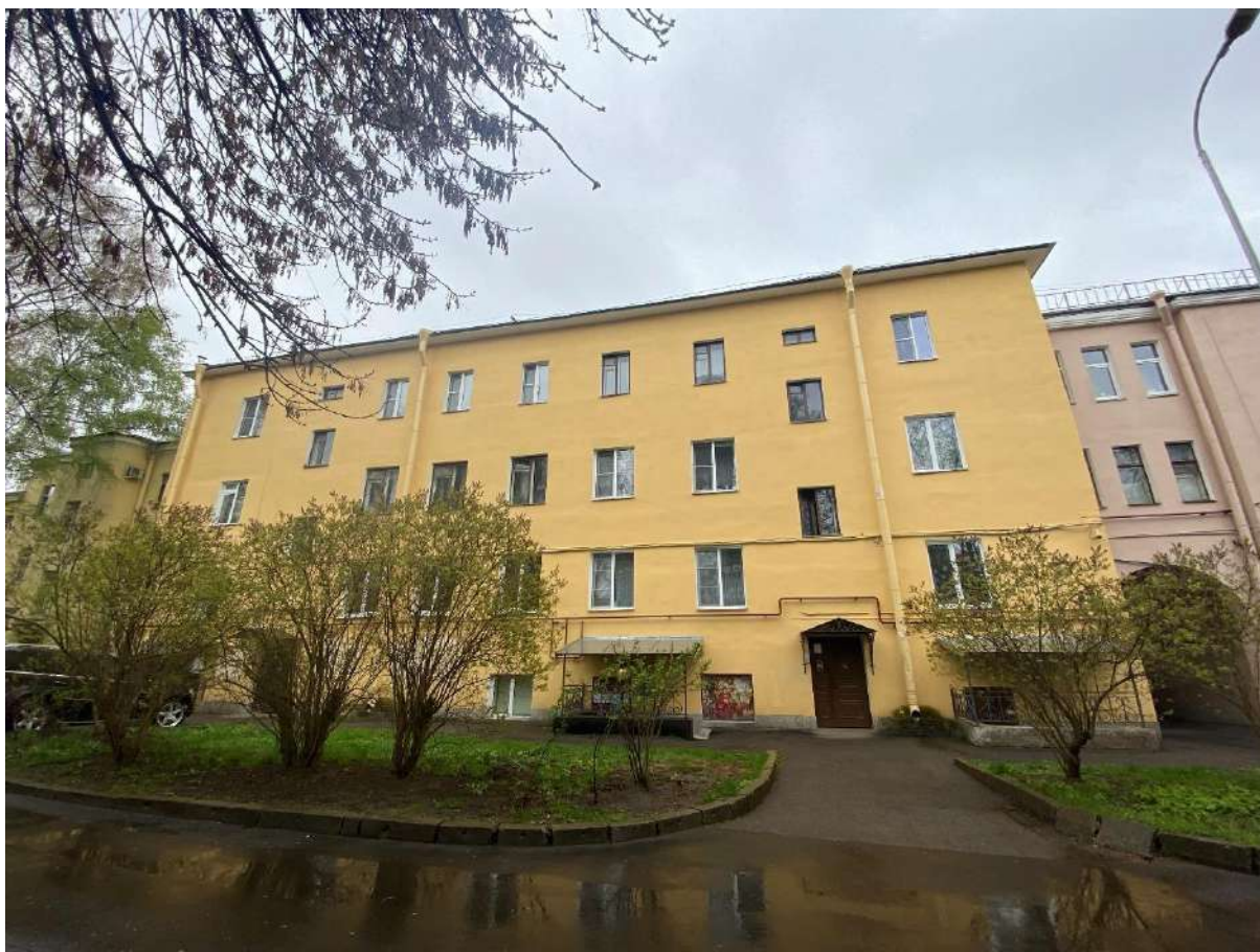
Фото 5. Вид на дворовой фасад.
