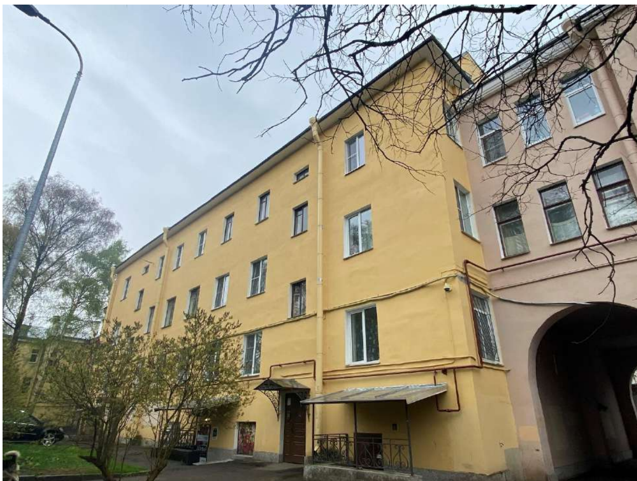
Фото 4. Вид на дворовой фасад.
