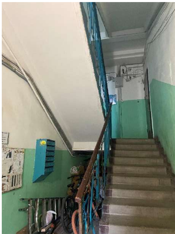
Фото 7. Вид на лестницу 1.
