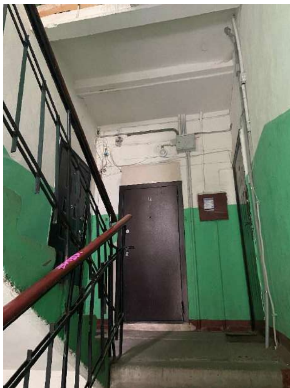
Фото 15. Вид на лестницу 2.
