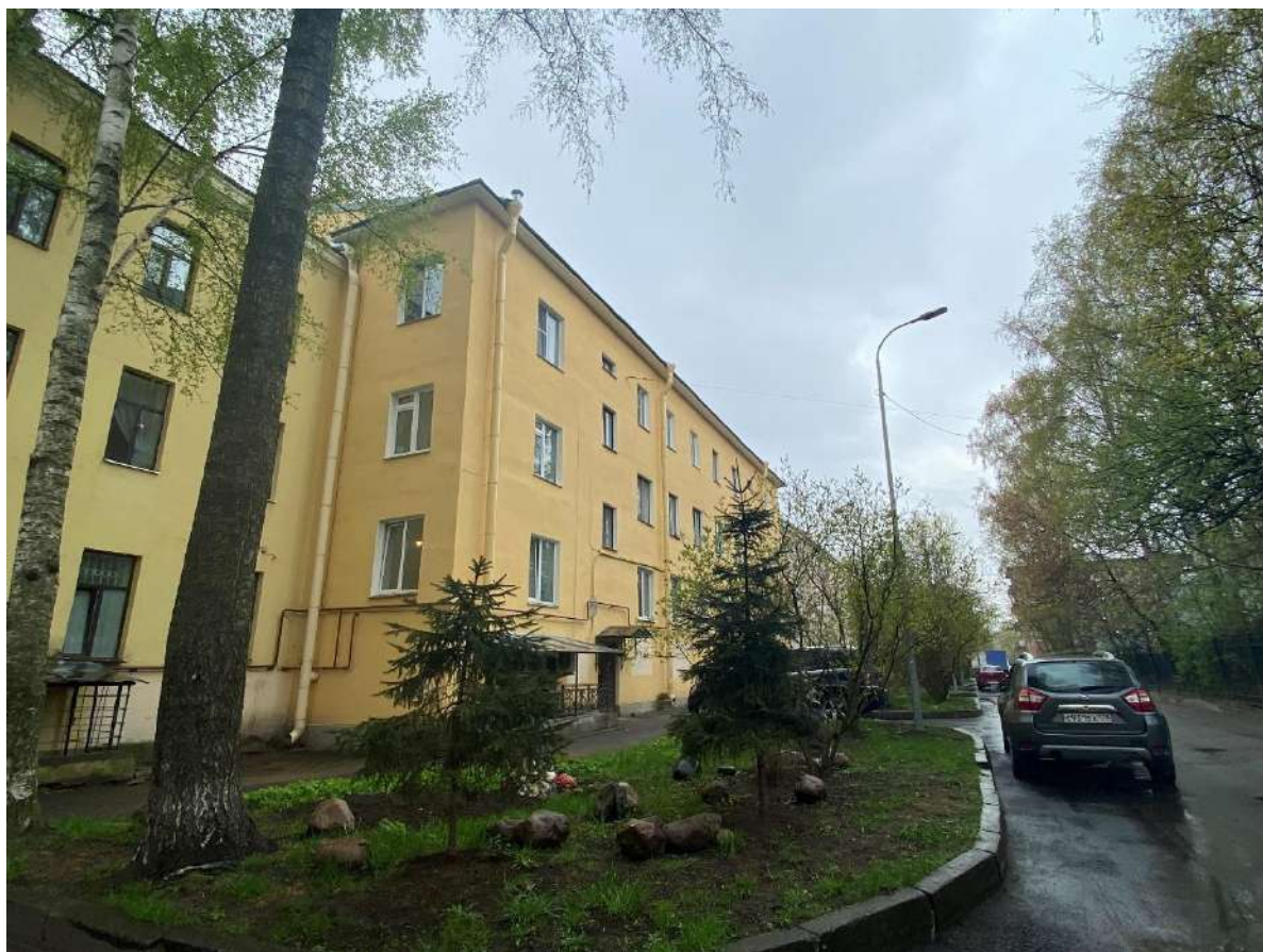
Фото 6. Вид на дворовой фасад.
