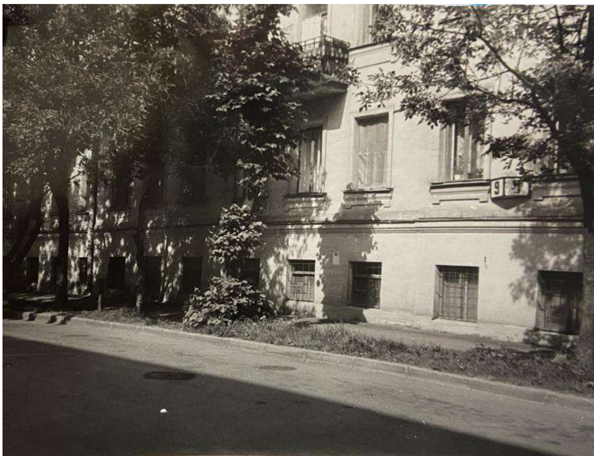
Илл. 13. Вид на дом № 9 по Гражданской ул. Дата: 1990 г. Источник: архив КГИОП.
