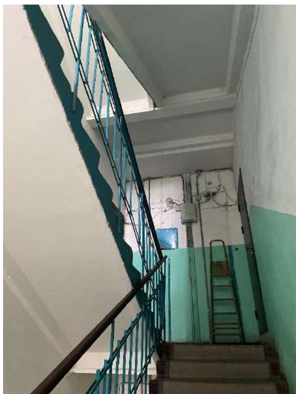
Фото 9. Вид на лестницу 1.
