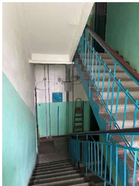
Фото 10. Вид на лестницу 1.
