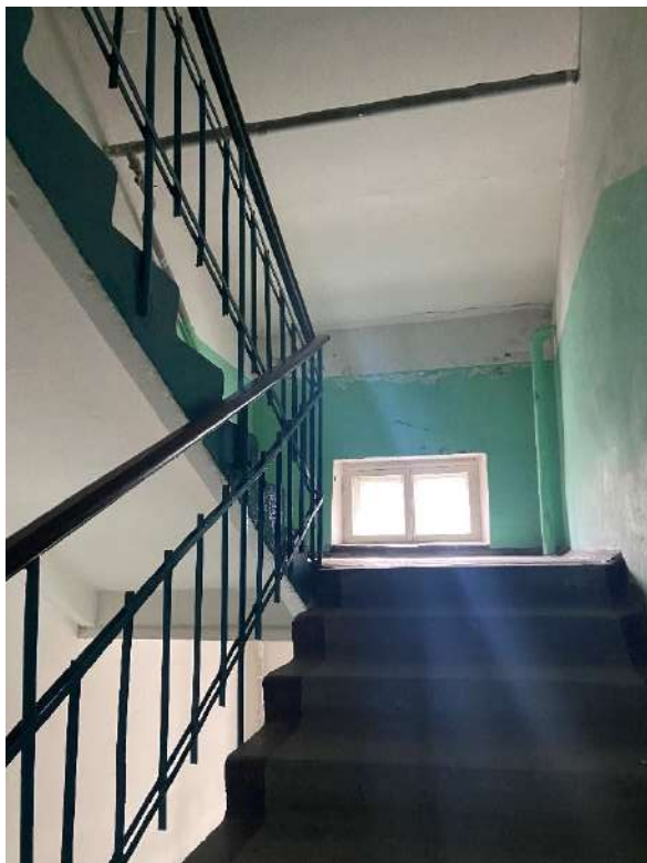
Фото 11. Вид на лестницу 1.
