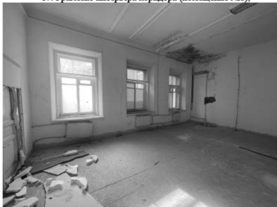
18. Фрагмент интерьера помещения №9;
