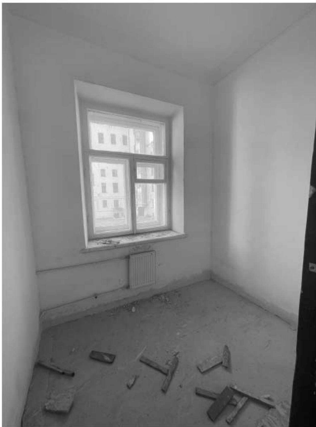
26. Фрагмент интерьера помещения №28 и №29;
