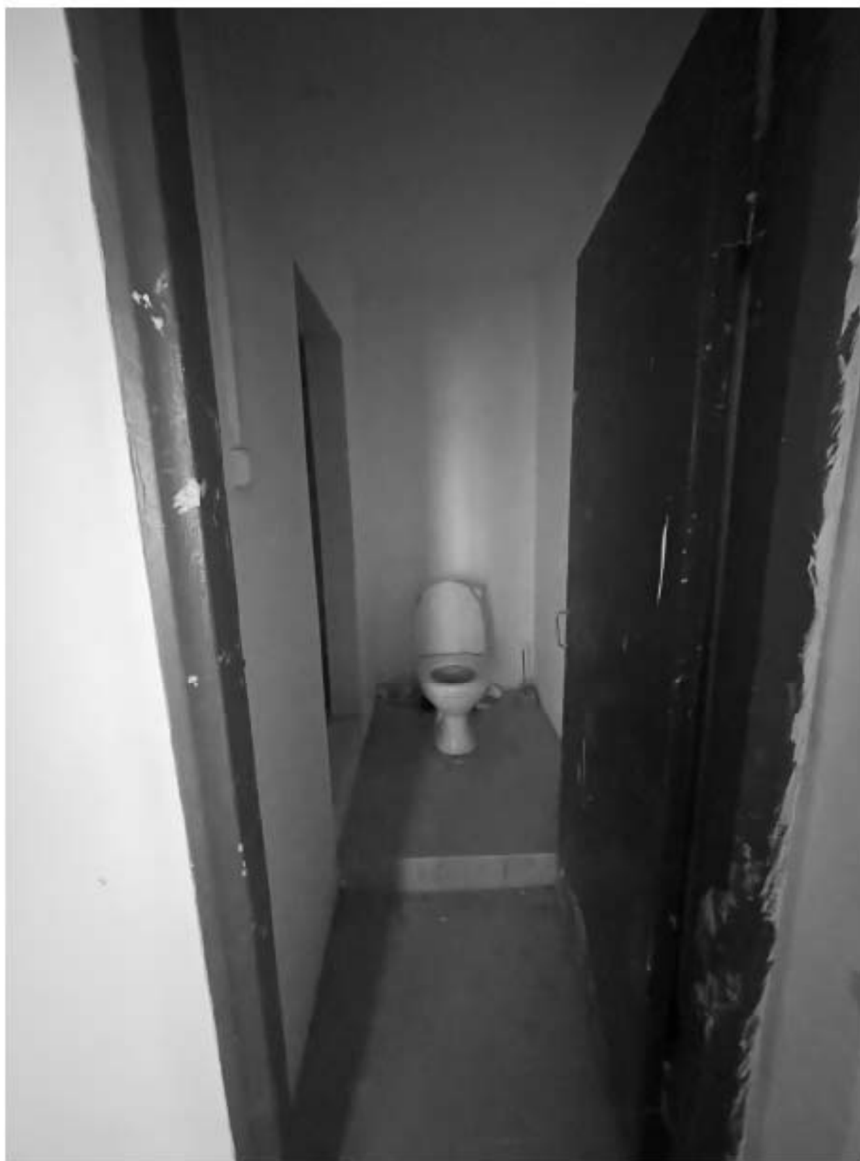
32. Фрагмент интерьера помещения №34;
