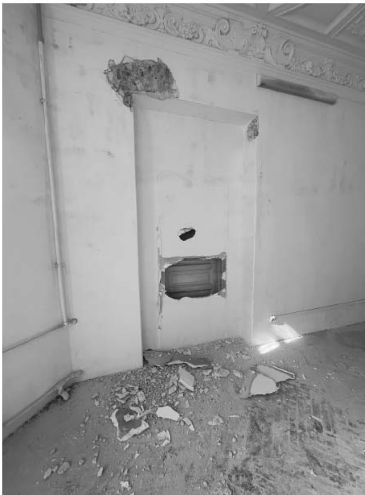
14. Фрагмент заложеного дверного проема в помещении №4;
