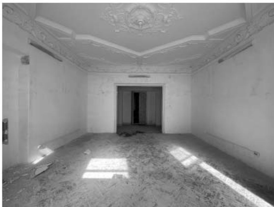
13. Фрагмент интерьера помещения №4;
