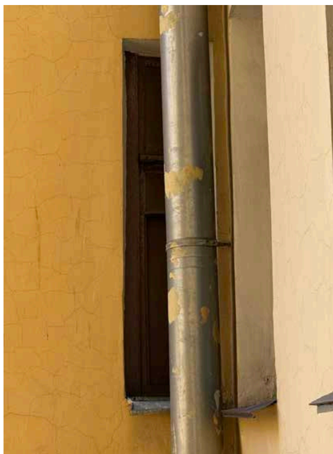
33. Работы, проведенные в период с 2011 по 2024 год. Оконные заполнения со стороны дворового фасада.
