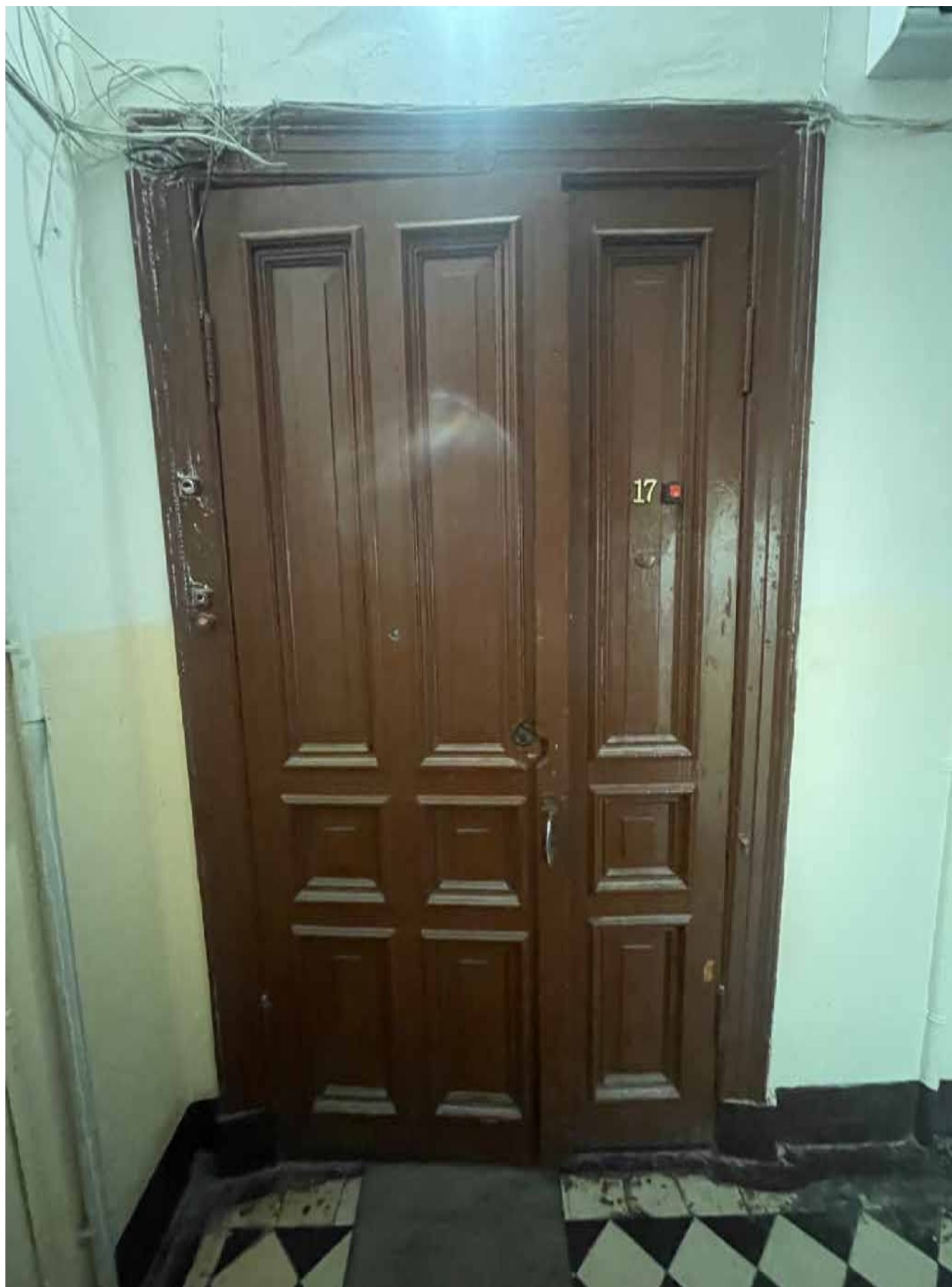
4. Входная дверь в квартиру № 17.
