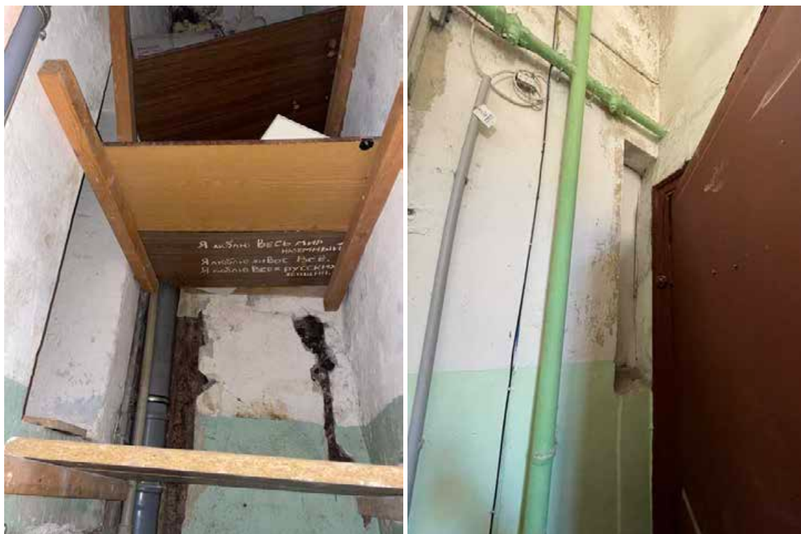
31. Работы, проведенные в период с 2011 по 2024 год. Зашивка оконного проема из туалета в лестничную клетку. Вид со стороны туалета (слева), вид со стороны лестничной клетки (справа).
