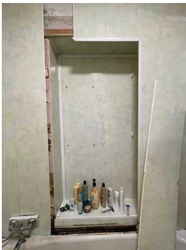
30. Работы, проведенные в период с 2011 по 2024 год. Закладка оконного проема из ванной в лестничную клетку. Вид со стороны ванной (слева), вид со стороны лестничной клетки (справа).
