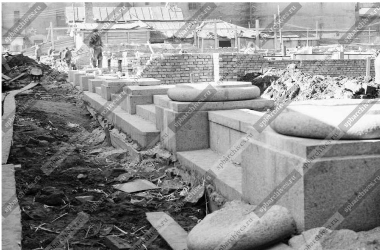
Илл. 78. Вид фундамента центрального фасада строящегося Приморского колхозного рынка. 1953 г. (источник: ЦГАКФФД СПб. Фотодокументы. Описание 1БР-65. Ед.хр.79714).
