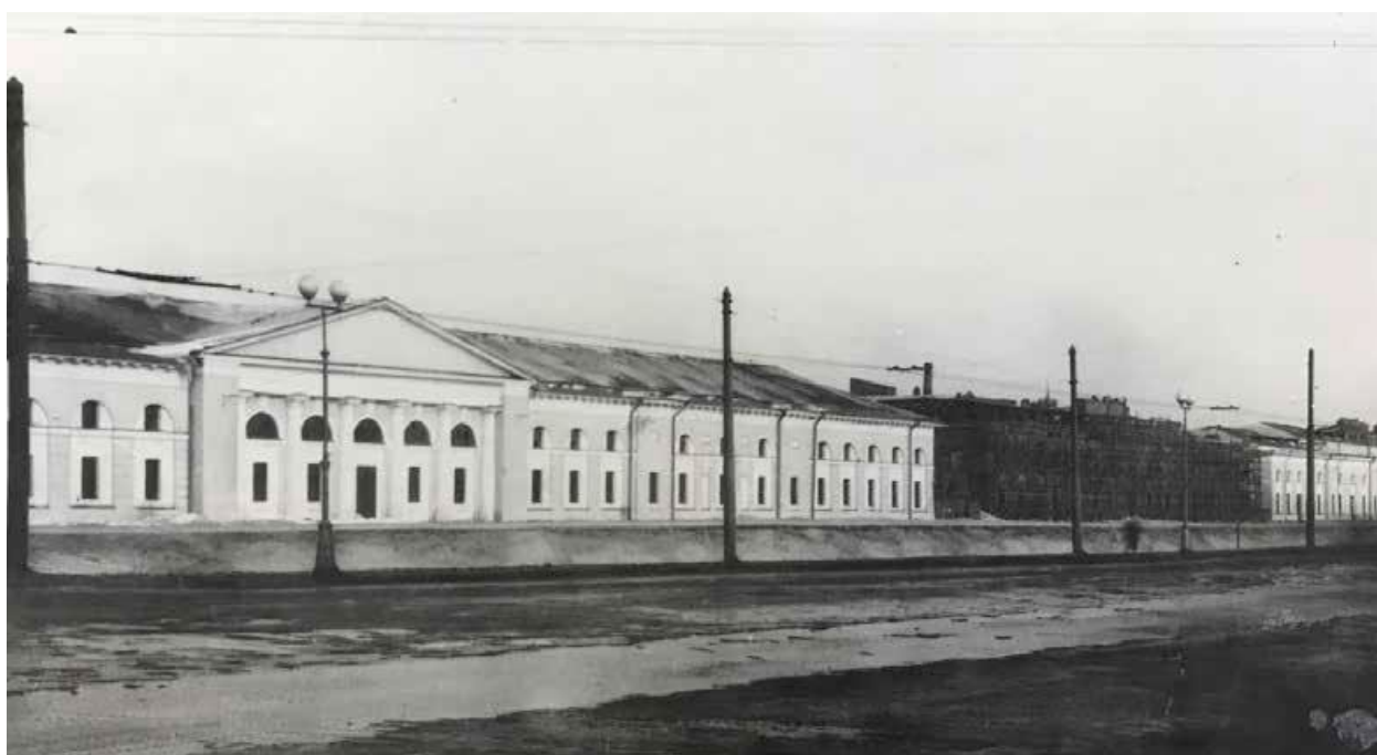
24. Измайловские провиантские магазины. Западный корпус. Фрагмент. 1950 г. // КГИОП. № 31399
