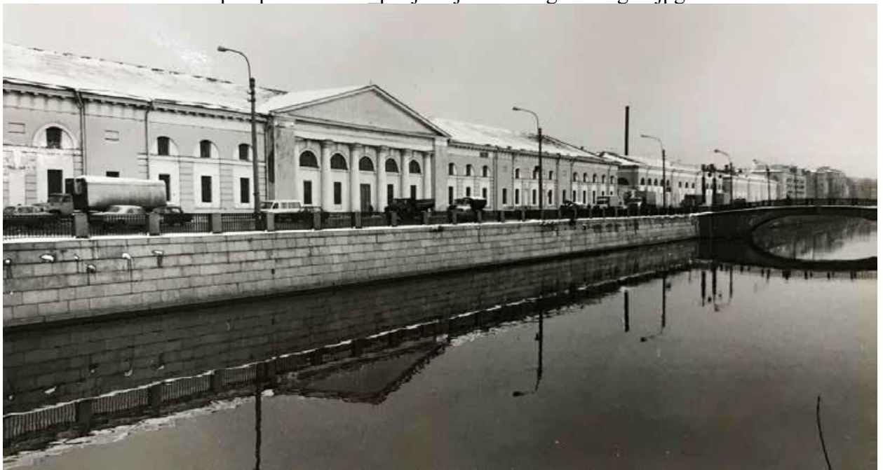
28. Измайловские провиантские магазины. Западный корпус. Общий вид с юго-запада. Автор: С. Шмидт. 1992 г. // КГИОП. № 452/17-Н
