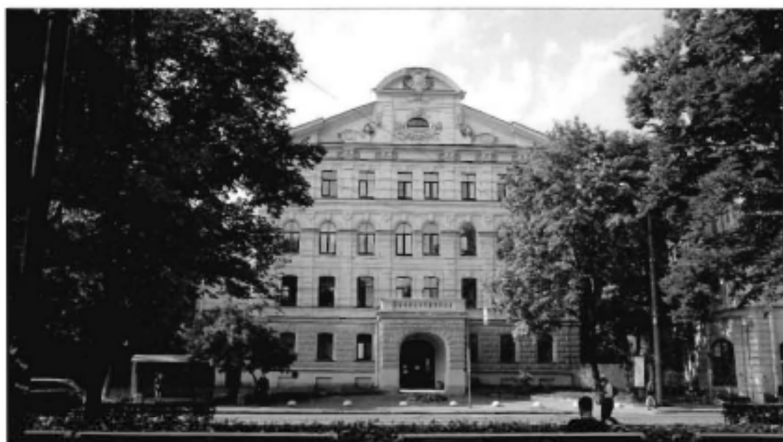
1. Лицевой фасад. Общий вид.
