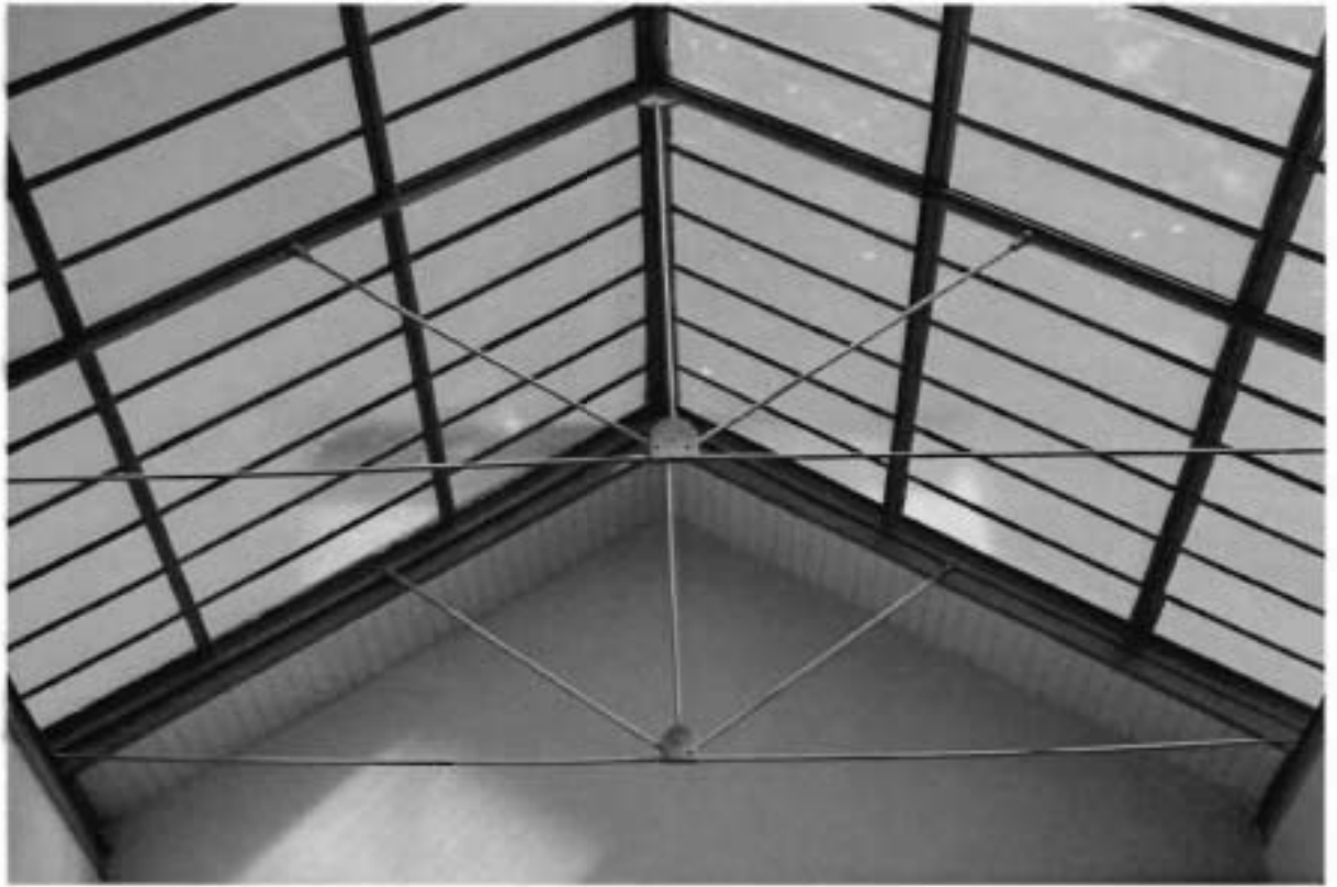
10. Конструкция пирамидального светового фонаря над парадной лестницей.
