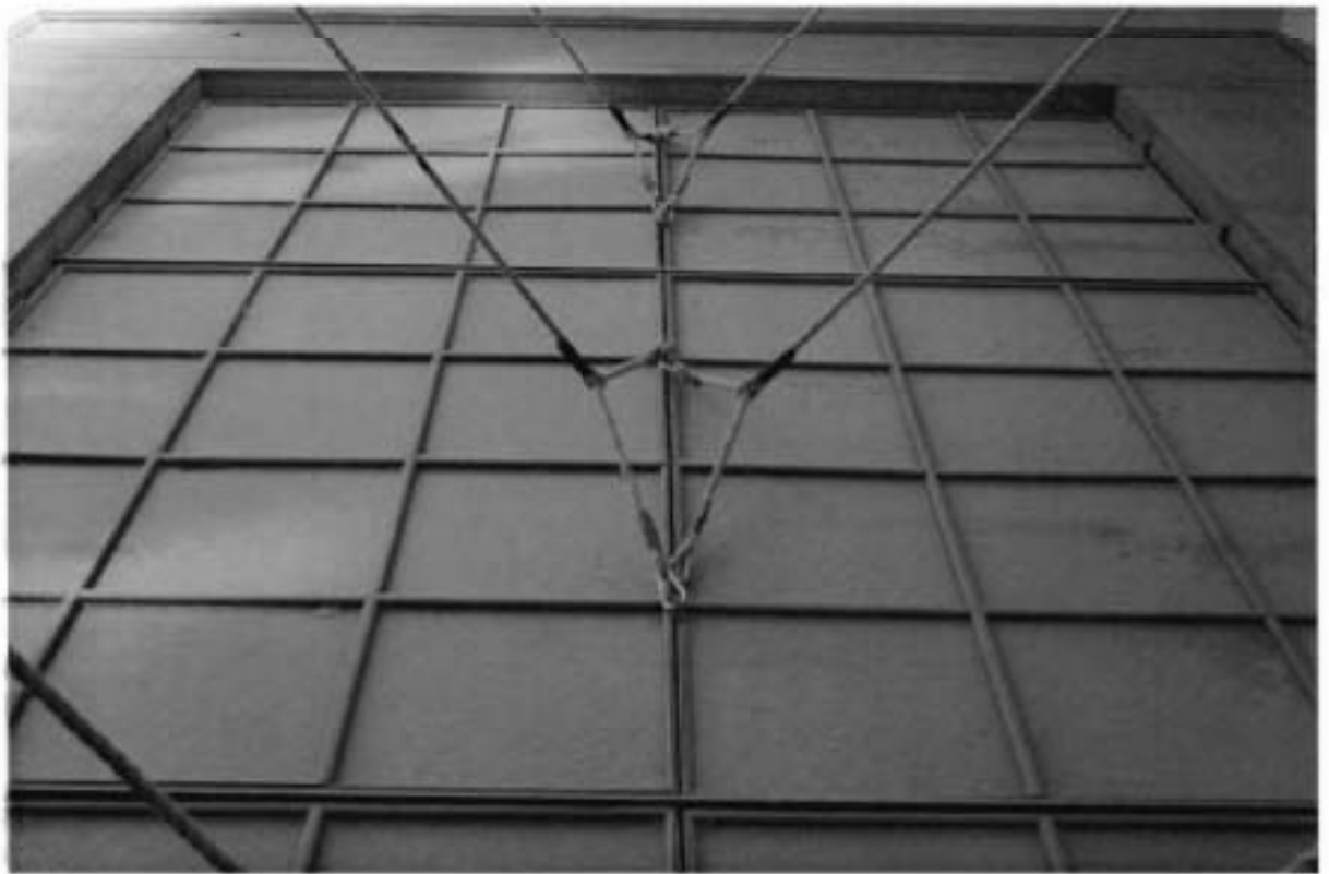
11. Расстекловка пирамидального светового фонаря над парадной лестницей.
