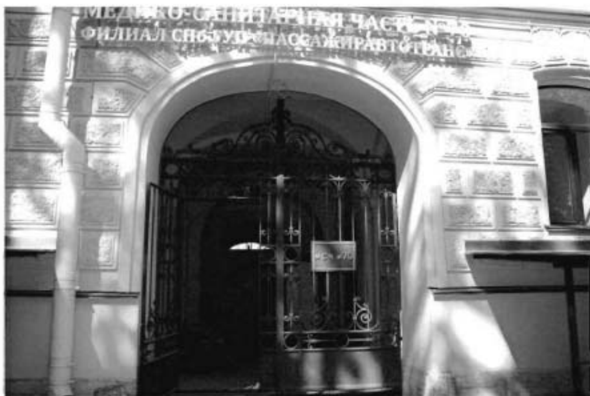
4. Воротный проезд со стороны восточного лицевого фасада.
