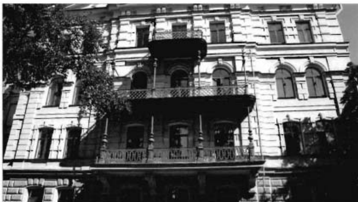
3. Южный фасад. Фрагмент. Трехъярусный балкон.
