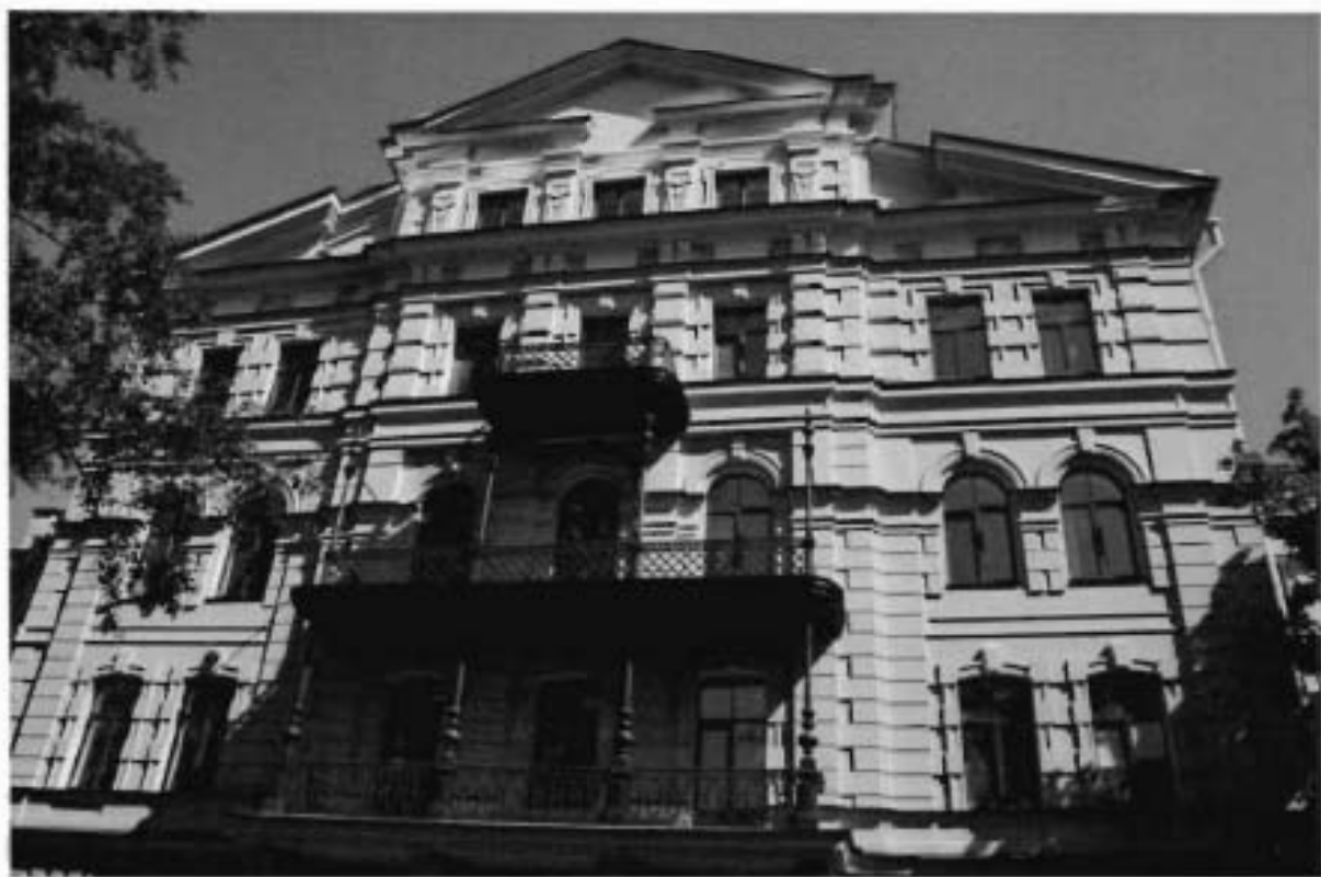
3. Южный лицевой фасад.
