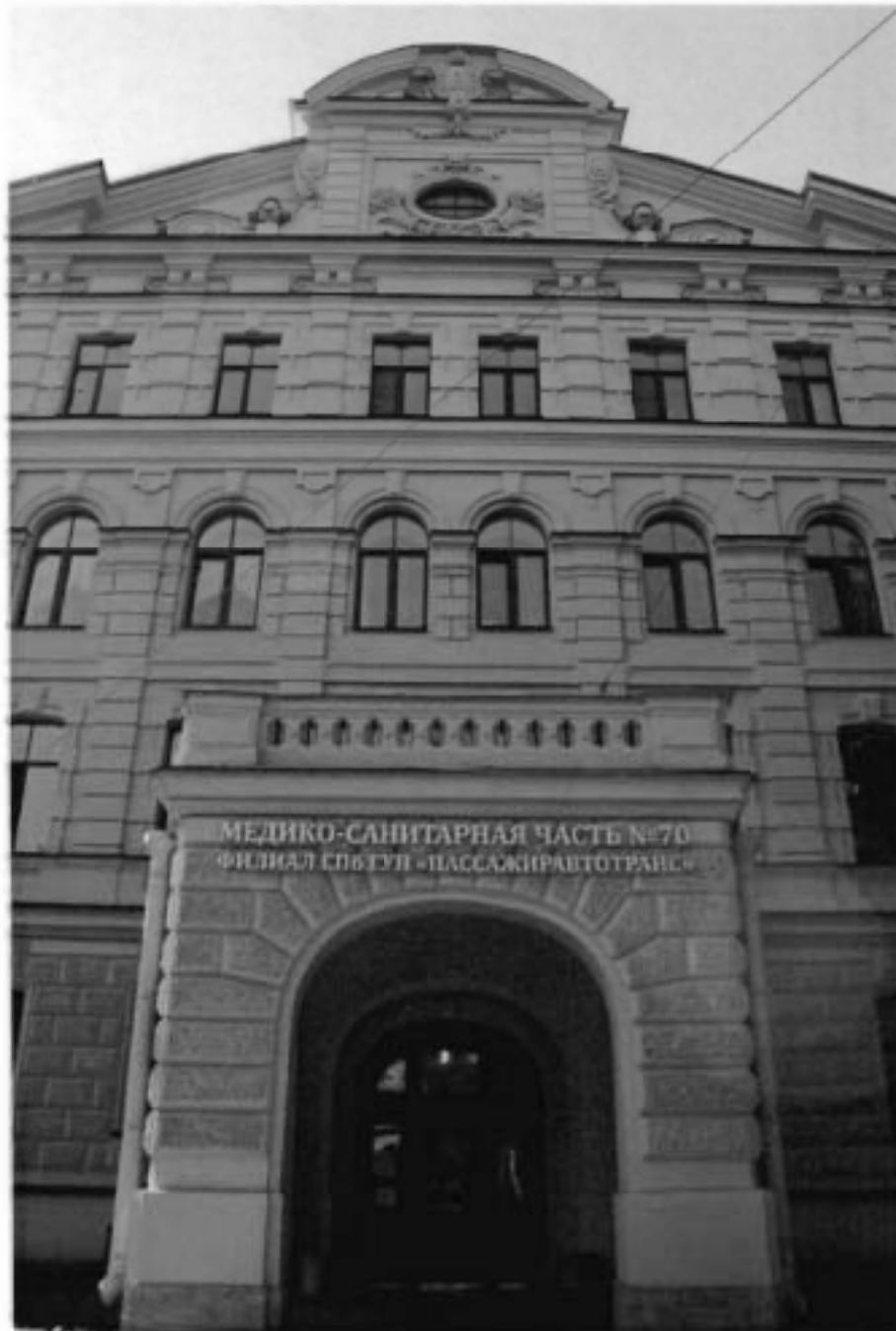
1. Крыльцо со стороны северного лицевого фасада.
