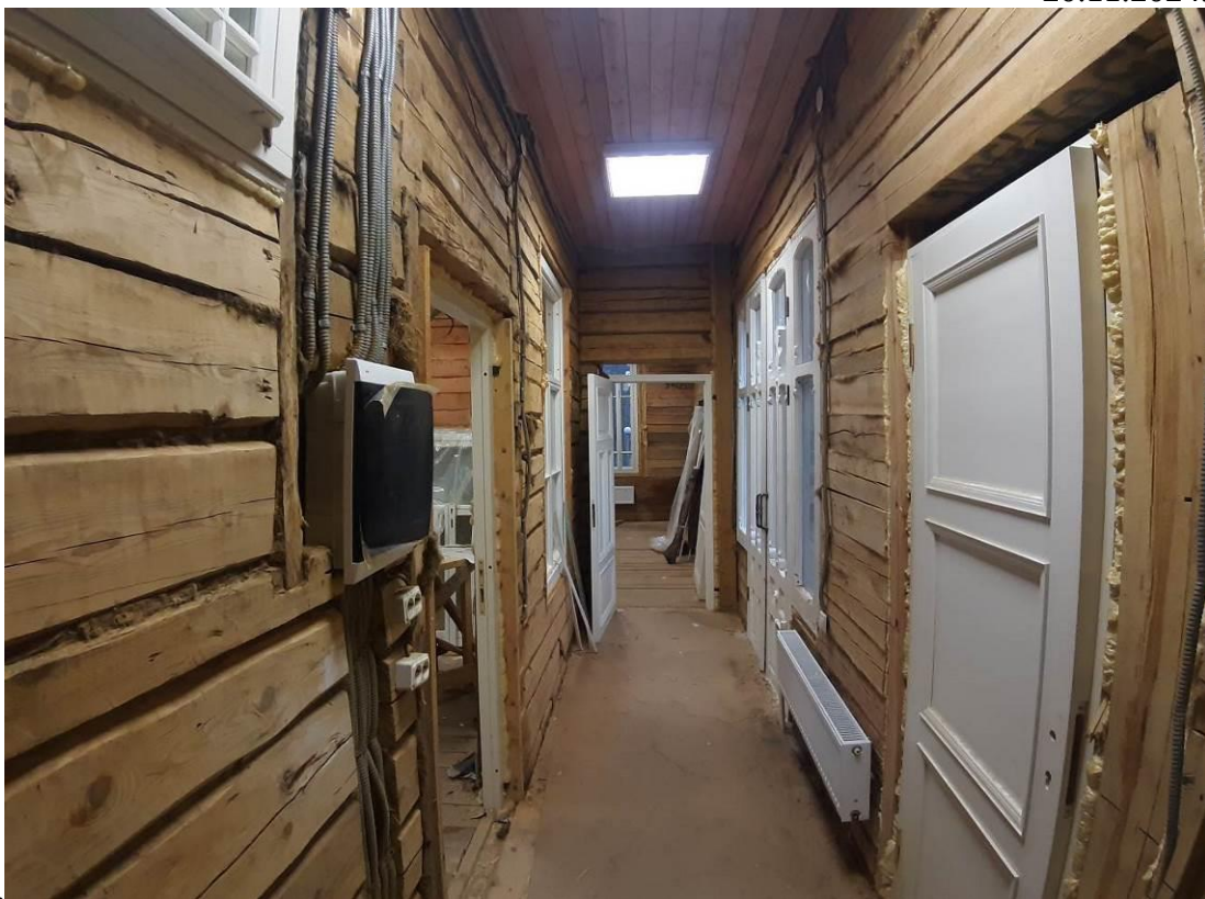
54. «Дача (деревянная)». 1 этаж. Помещение 1 (по плану ПИБ). Штиглиц М.С. 20.11.2024.
