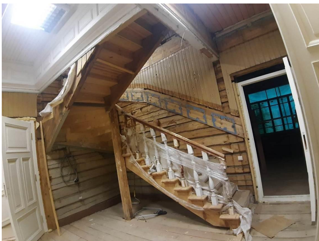
72. «Дача (деревянная)». 1 этаж. Помещение 12 (по плану ПИБ). Штиглиц М.С. 20.11.2024.
