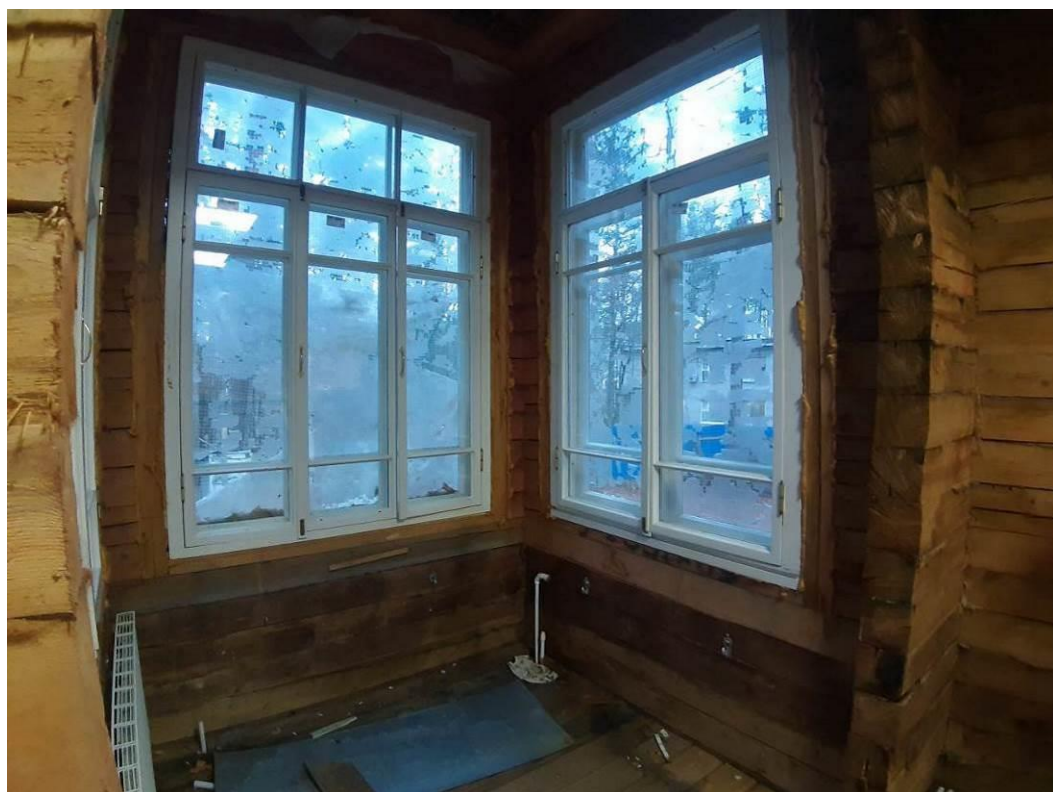
44. «Дача (деревянная)». 1 этаж. Помещение 7 (по плану ПИБ). Штиглиц М.С. 20.11.2024.
