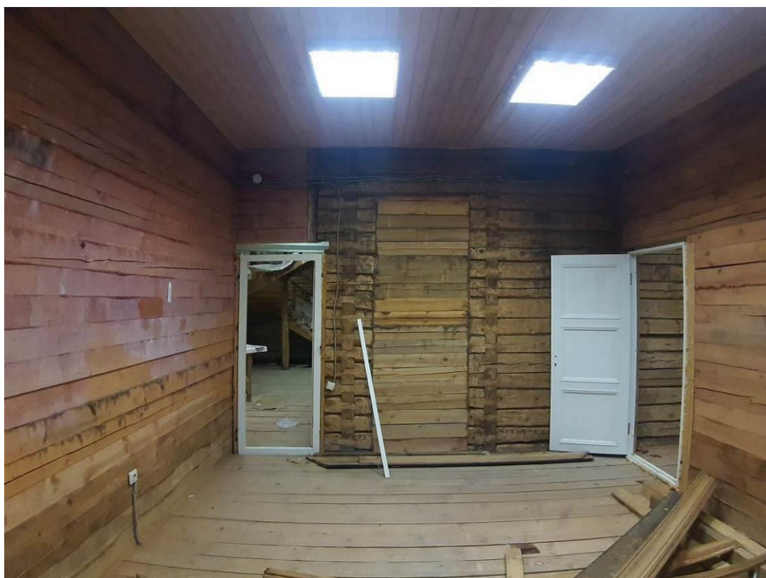
48. «Дача (деревянная)». 1 этаж. Помещения 8, 9, 10 (по плану ПИБ). Штиглиц М.С. 20.11.2024.
