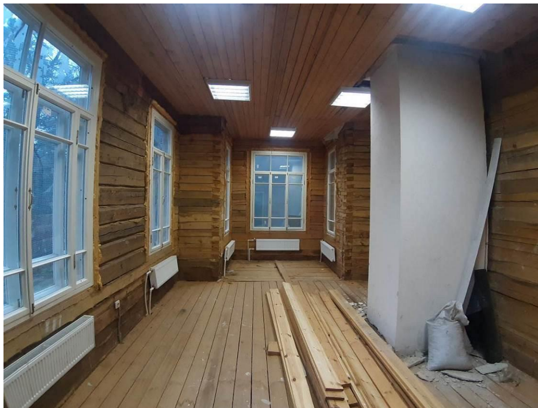
59. «Дача (деревянная)». 1 этаж. Помещение 6-7 (по плану ПИБ). Штиглиц М.С. 20.11.2024.
