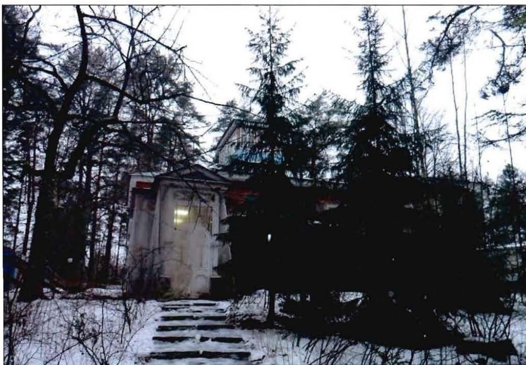
2. Объект культурного наследия. Вид с востока.
