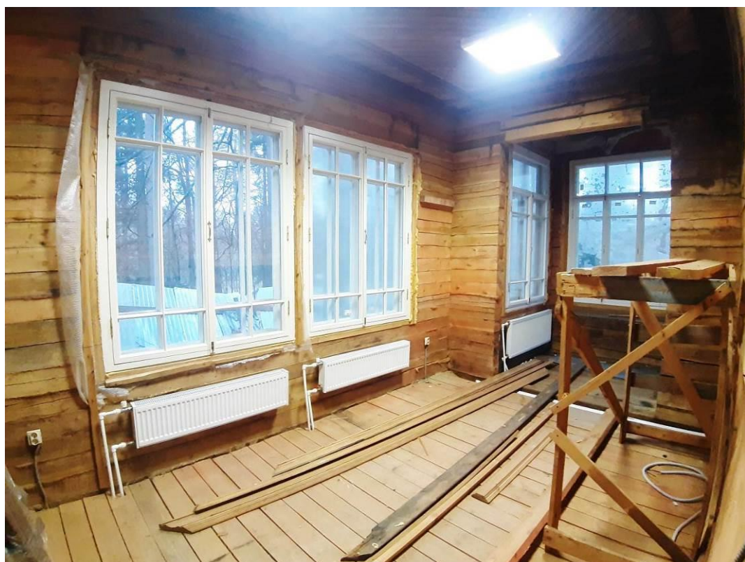
42. «Дача (деревянная)». 1 этаж. Помещение 7 (по плану ПИБ). Штиглиц М.С. 20.11.2024.
