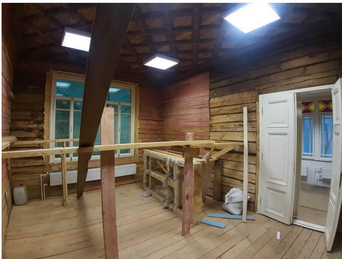
66. «Дача (деревянная)». 1 этаж. Помещение 4 (по плану ПИБ). Штиглиц М.С. 20.11.2024.
