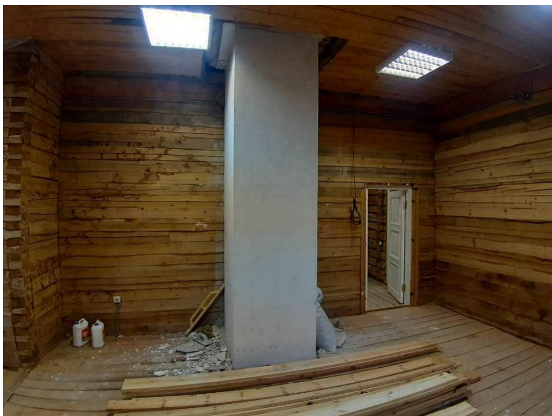
62. «Дача (деревянная)». 1 этаж. Помещение 6-7 (по плану ПИБ). Штиглиц М.С. 20.11.2024.
