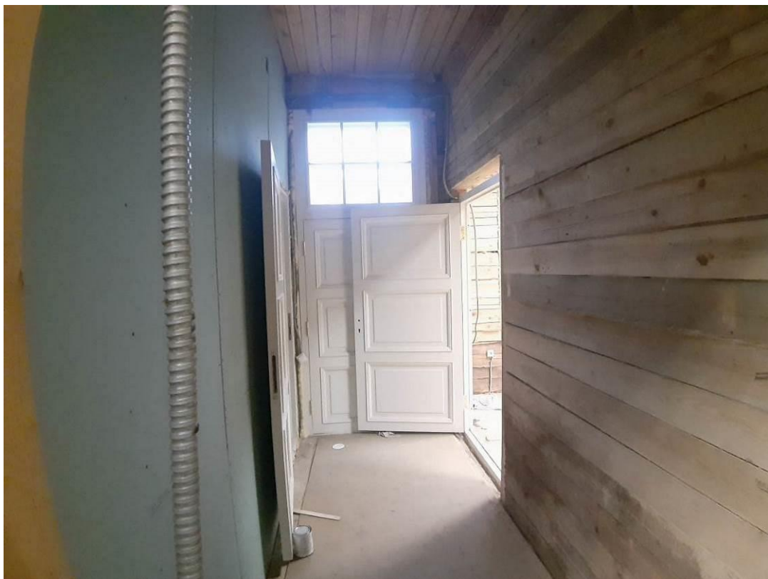
58. «Дача (деревянная)». 1 этаж. Помещение 1-5 (по плану ПИБ). Штиглиц М.С. 20.11.2024.
