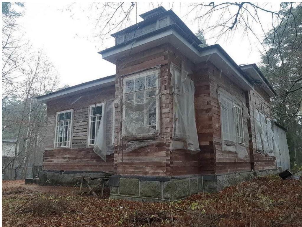
27. «Дача (деревянная)». Западный и южный фасады. Штиглиц М.С. 20.11.2024.
