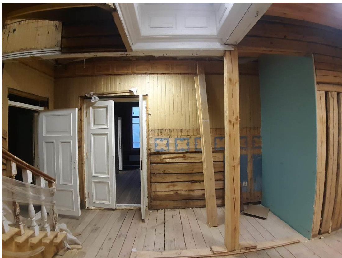
71. «Дача (деревянная)». 1 этаж. Помещение 12 (по плану ПИБ). Штиглиц М.С. 20.11.2024.
