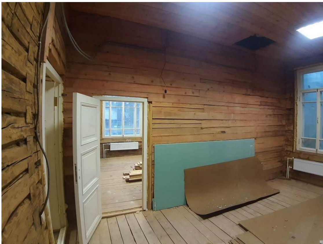
63. «Дача (деревянная)». 1 этаж. Помещение 6 (по плану ПИБ). Штиглиц М.С. 20.11.2024.
