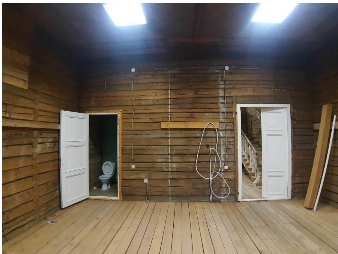
39. «Дача (деревянная)». 1 этаж. Помещение 6 (по плану ПИБ). Штиглиц М.С. 20.11.2024.
