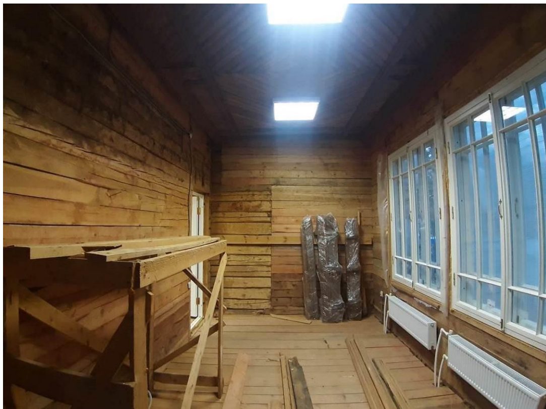
47. «Дача (деревянная)». 1 этаж. Помещение 7 (по плану ПИБ). Штиглиц М.С. 20.11.2024.
