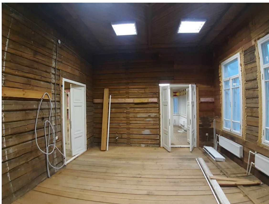
40. «Дача (деревянная)». 1 этаж. Помещение 6 (по плану ПИБ). Штиглиц М.С. 20.11.2024.
