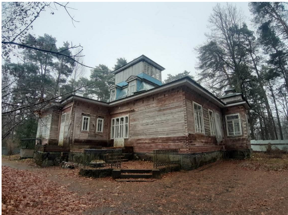
24. «Дача (деревянная)». Западный и северный фасады. Штиглиц М.С. 20.11.2024.
