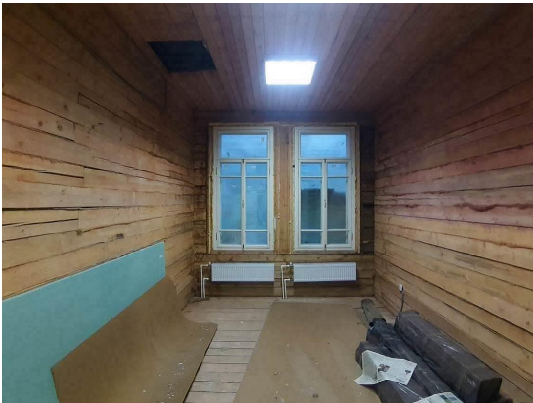
65. «Дача (деревянная)». 1 этаж. Помещение 3 (по плану ПИБ). Штиглиц М.С. 20.11.2024.
