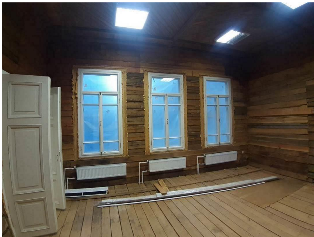
38. «Дача (деревянная)». 1 этаж. Помещение 6 (по плану ПИБ).. Штиглиц М.С. 20.11.2024.
