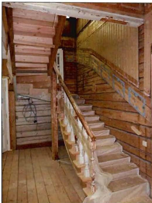
10. Пом. 1-Н (12). Лестница.
