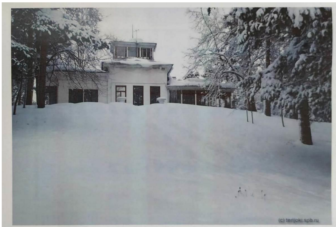
7. Фотография южного фасада до реставрации. https://terijoki.spb.ru .
