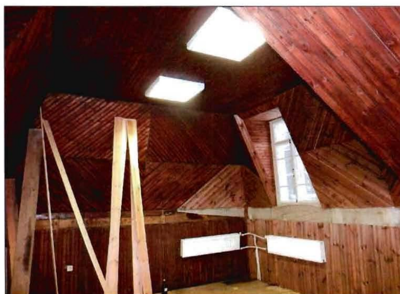
13. Деревянная обшивка стен (пом. 3-Н).
