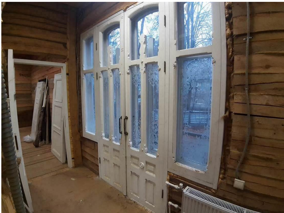
57. «Дача (деревянная)». 1 этаж. Помещение 1 (по плану ПИБ). Штиглиц М.С. 20.11.2024.
