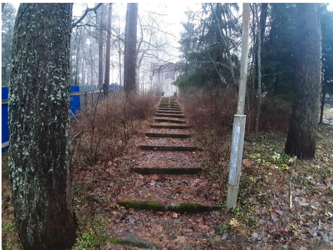
13. «Дача (деревянная)». Территория объекта культурного наследия. Лестница по склону холма к боковому входу в здание. Штиглиц М.С. 20.11.2024.
