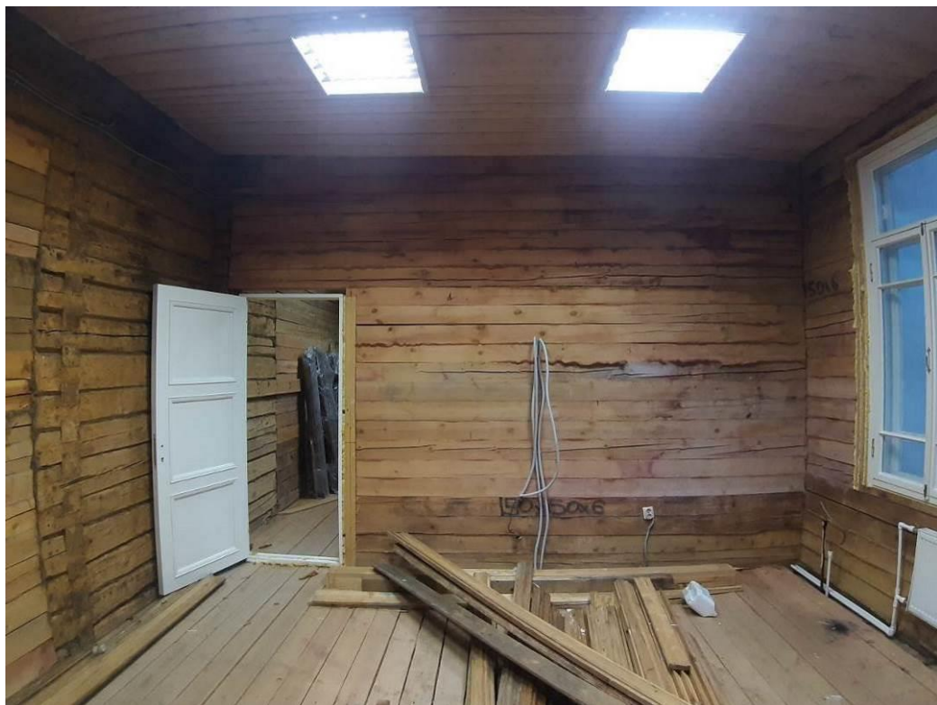
49. «Дача (деревянная)». 1 этаж. Помещения 8, 9, 10 (по плану ПИБ). Штиглиц М.С. 20.11.2024.
