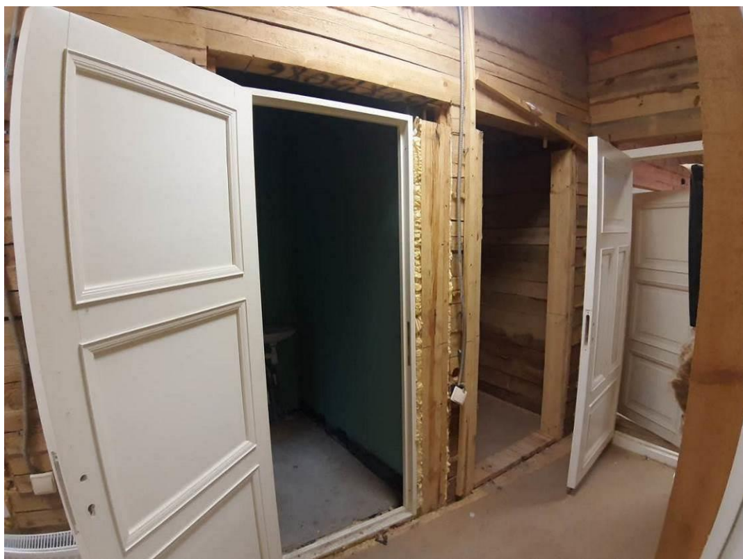
56. «Дача (деревянная)». 1 этаж. Помещение 1 (по плану ПИБ). Штиглиц М.С. 20.11.2024.
