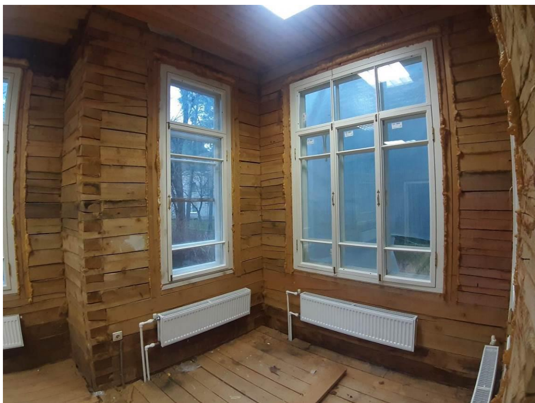
60. «Дача (деревянная)». 1 этаж. Помещение 6-7 (по плану ПИБ). Штиглиц М.С. 20.11.2024.
