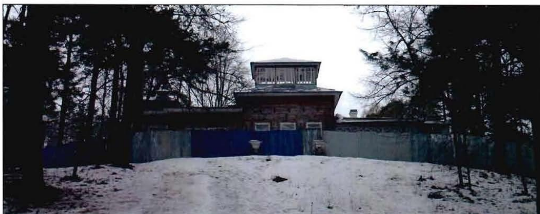
1. Объект культурного наследия. Общий вид с юга.
