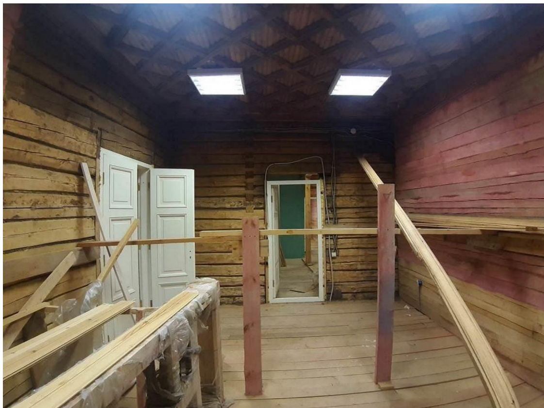
67. «Дача (деревянная)». 1 этаж. Помещение 4 (по плану ПИБ). Штиглиц М.С. 20.11.2024.
