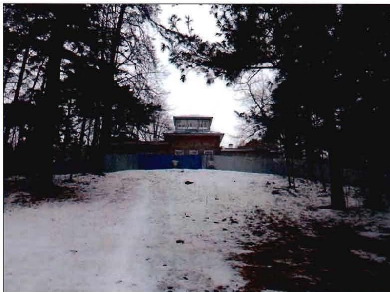
16. Фрагмент территории. Вид с юга.
