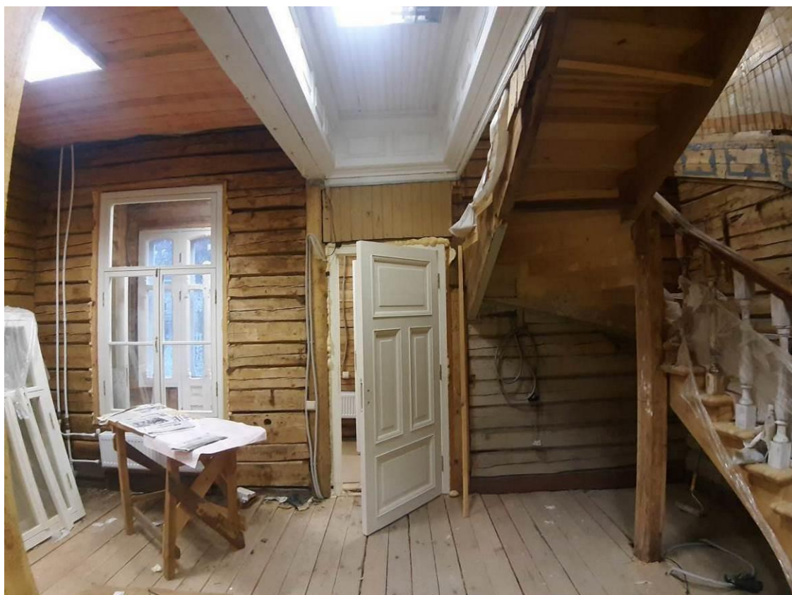
68. «Дача (деревянная)». 1 этаж. Помещение 12 (по плану ПИБ). Штиглиц М.С. 20.11.2024.
