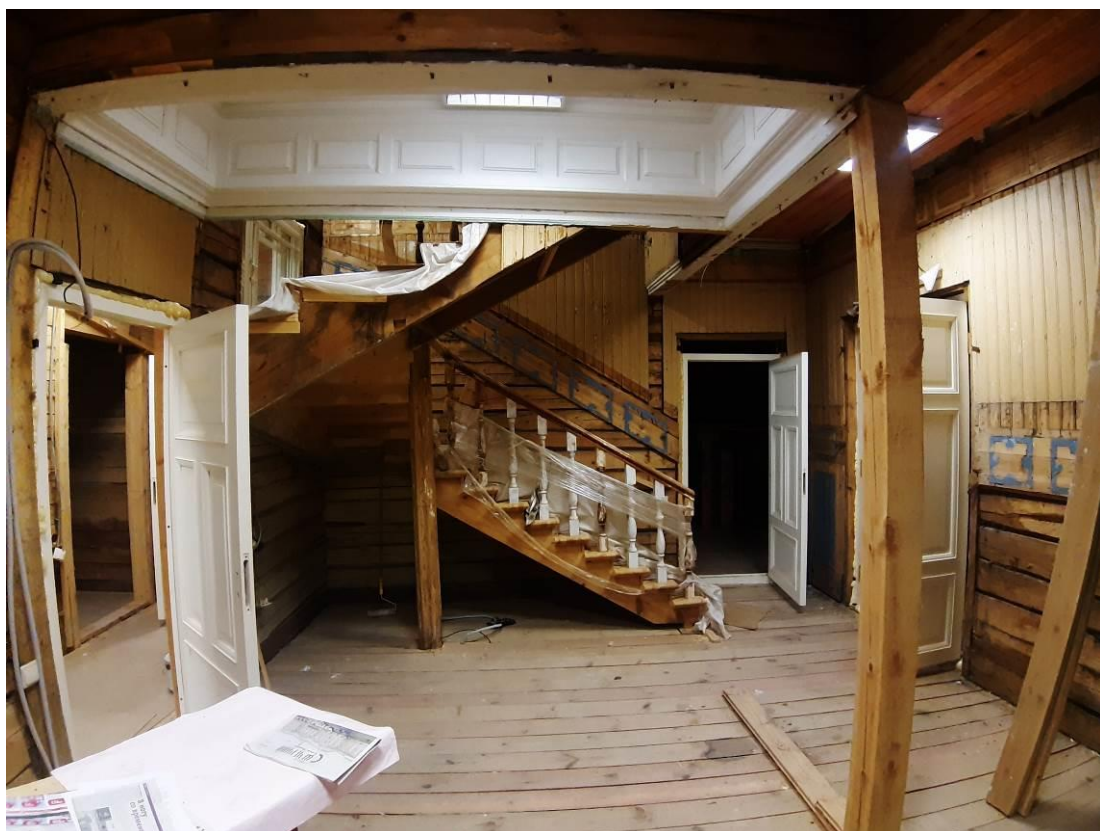
69. «Дача (деревянная)». 1 этаж. Помещение 12 (по плану ПИБ). Штиглиц М.С. 20.11.2024.
