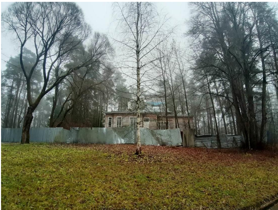
7. «Дача (деревянная)». Территория объекта культурного наследия рядом с северным фасадом здания. Штиглиц М.С. 20.11.2024.
