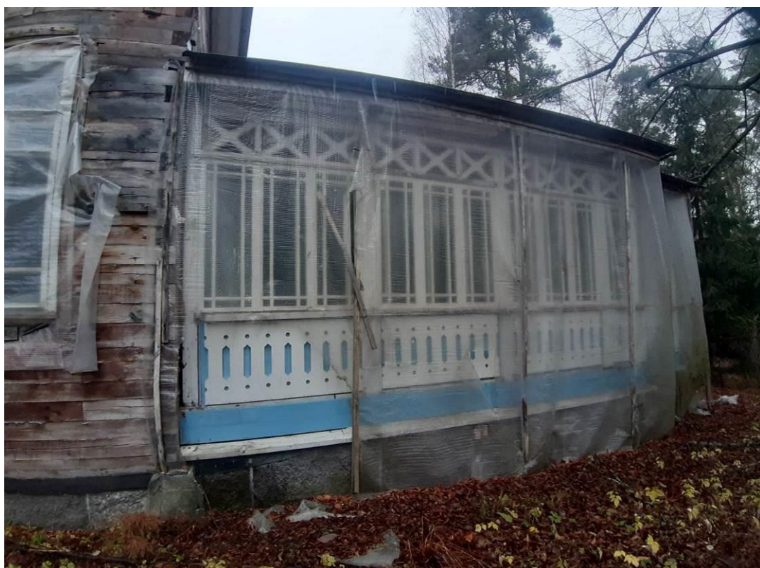
30. «Дача (деревянная)». Фрагмент южного фасада. Штиглиц М.С. 20.11.2024.
