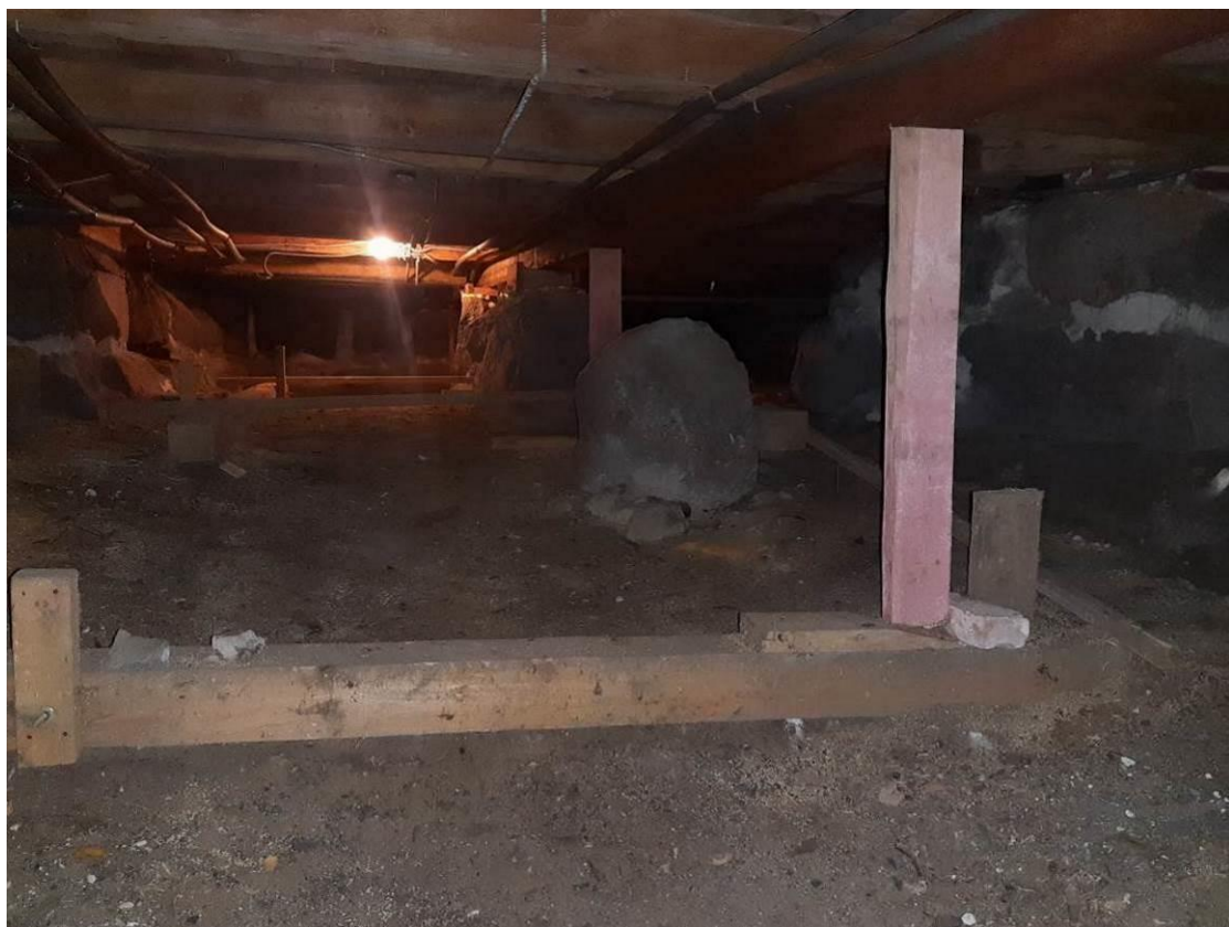
34. «Дача (деревянная)». Подвал. Штиглиц М.С. 20.11.2024.
