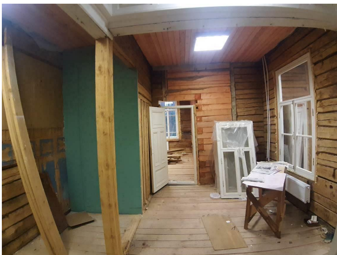
70. «Дача (деревянная)». 1 этаж. Помещение 12 (по плану ПИБ). Штиглиц М.С. 20.11.2024.
