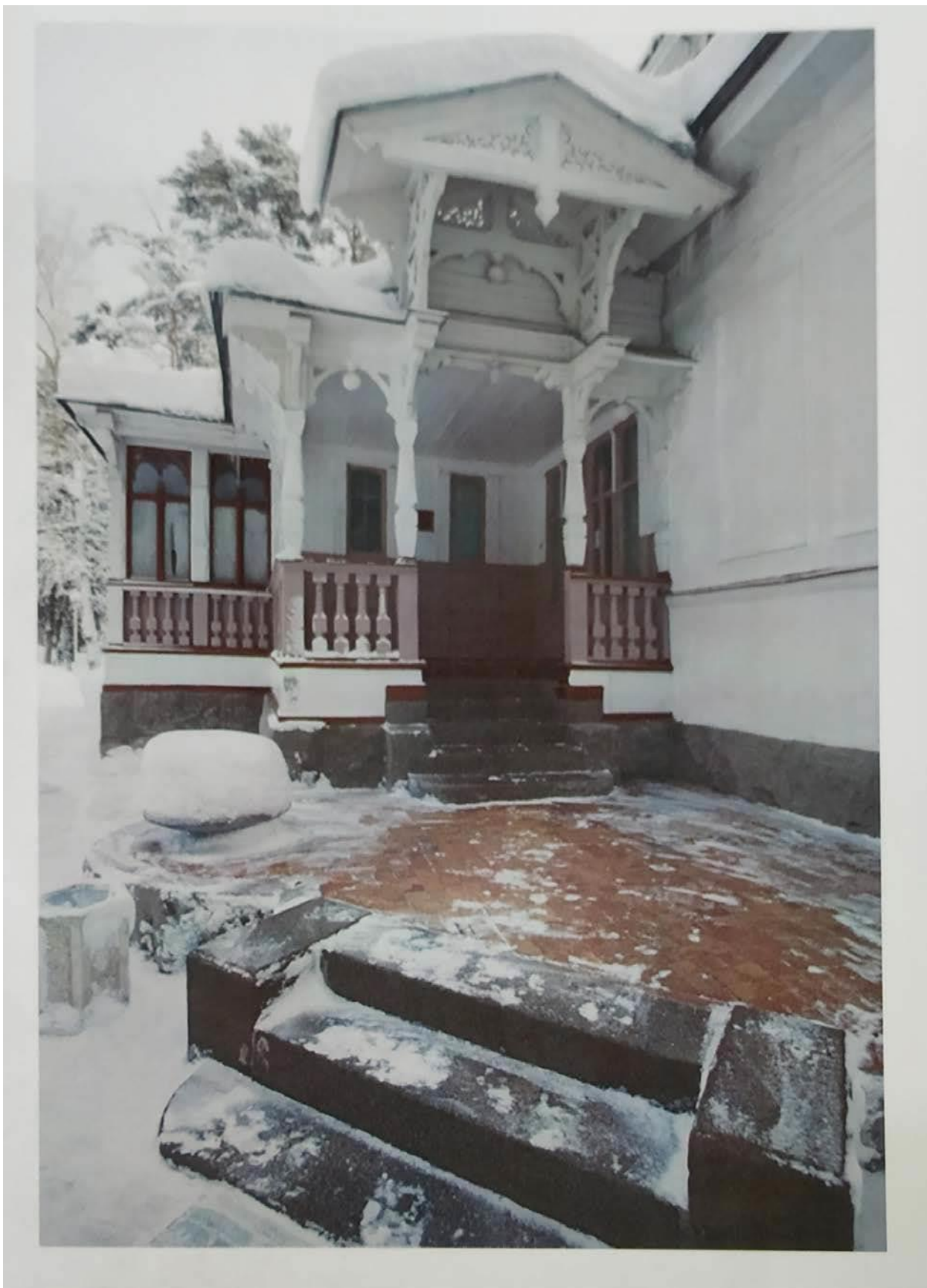
9. Фотография крыльца и террасы северного фасада до реставрации. https://terijoki.spb.ru .
