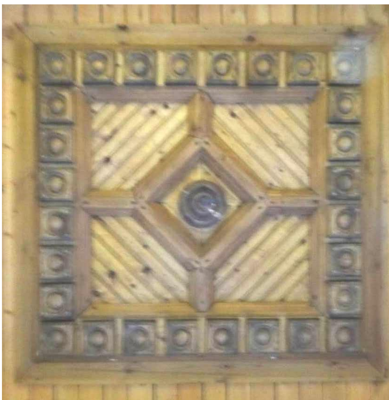
46. «Дача (деревянная)». 1 этаж. Помещение 7 (по плану ПИБ). Потолок эркера. Штиглиц М.С. 20.11.2024.
