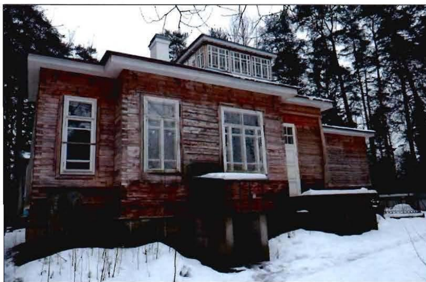
4. Объект культурного наследия. Северный фасад.
