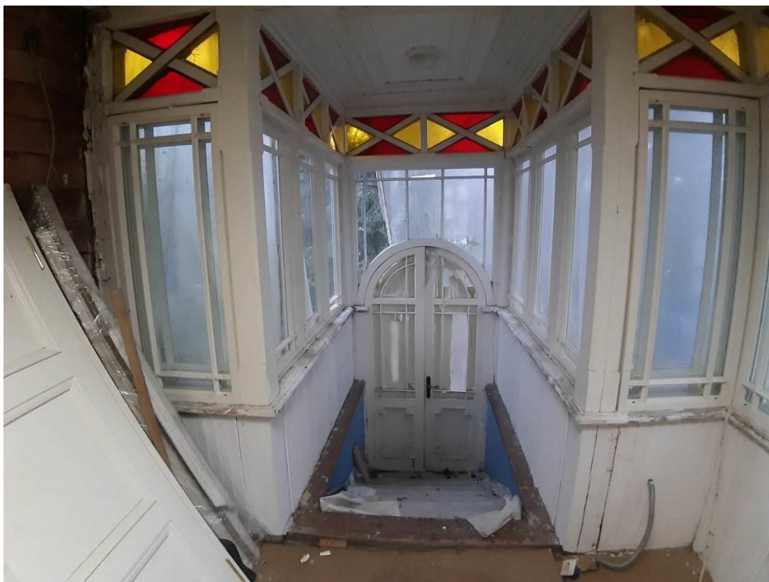
36. «Дача (деревянная)». Входная зона. 1 этаж. Помещение 5 (по плану ПИБ).. Штиглиц М.С. 20.11.2024.
