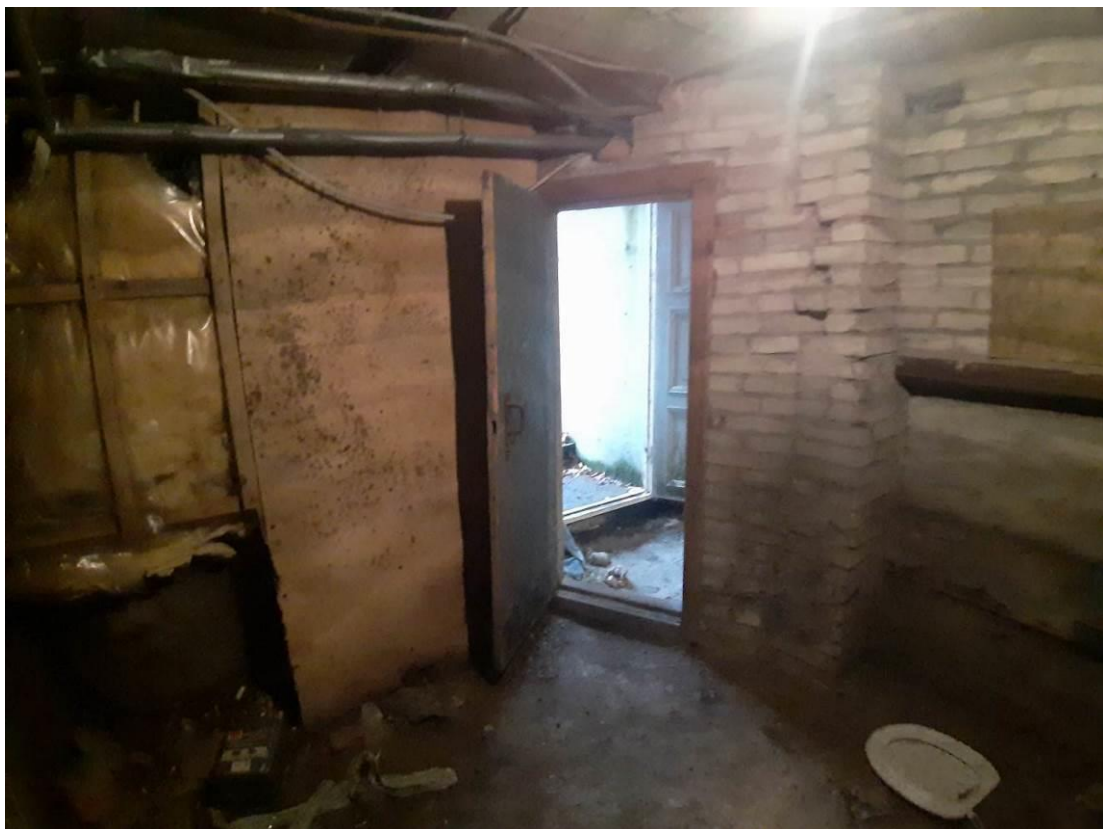
35. «Дача (деревянная)». Подвал. Штиглиц М.С. 20.11.2024.
