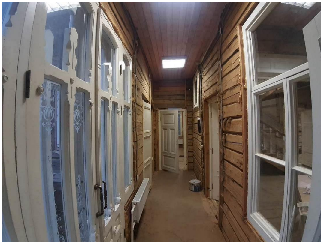
55. «Дача (деревянная)». 1 этаж. Помещение 1 (по плану ПИБ). Штиглиц М.С. 20.11.2024.
