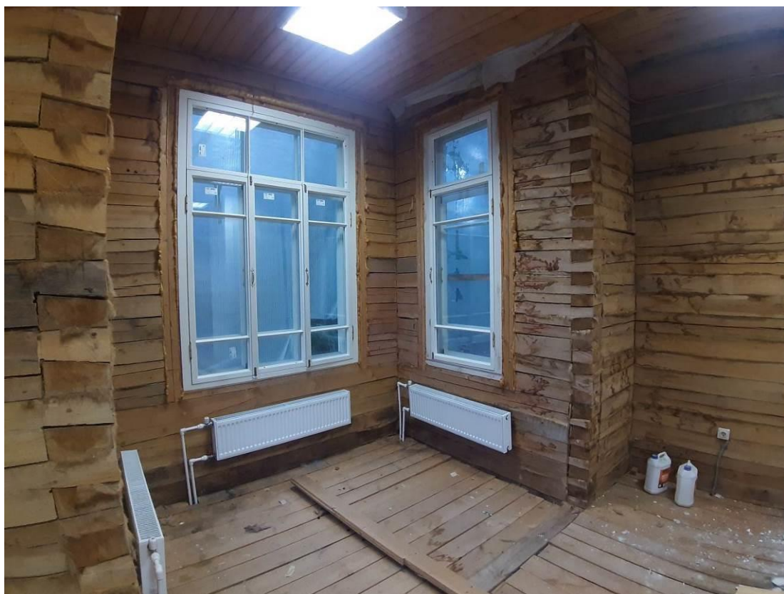
61. «Дача (деревянная)». 1 этаж. Помещение 6-7 (по плану ПИБ). Штиглиц М.С. 20.11.2024.
