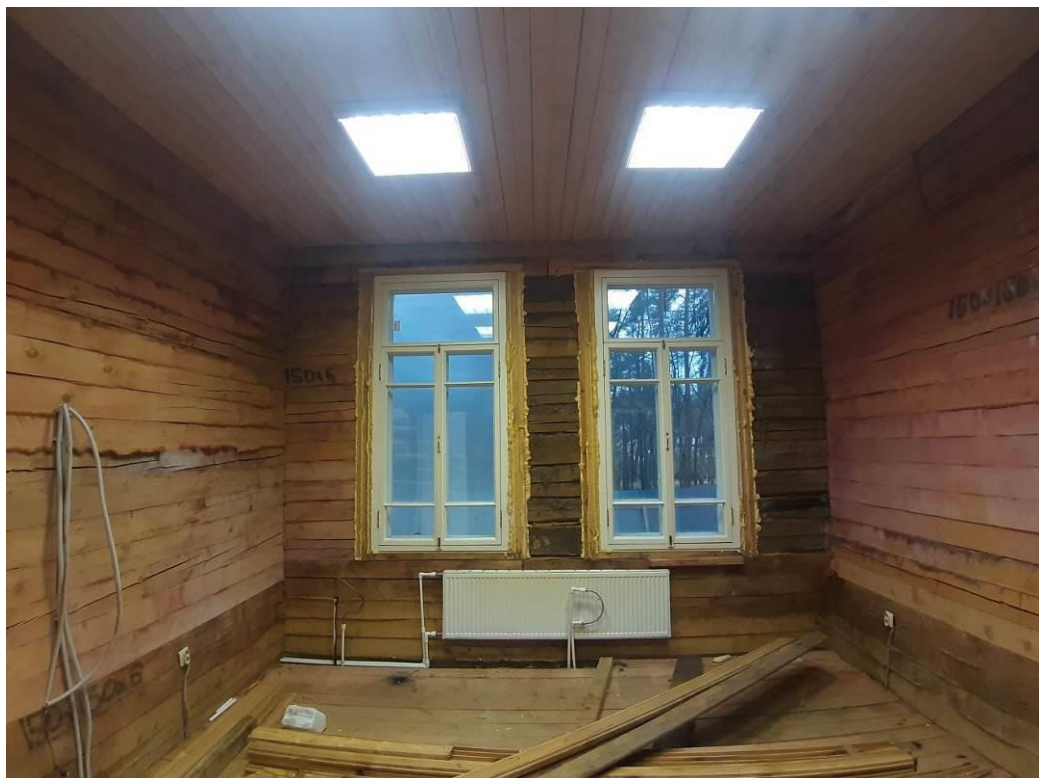
50. «Дача (деревянная)». 1 этаж. Помещения 8, 9, 10 (по плану ПИБ). Штиглиц М.С. 20.11.2024.
