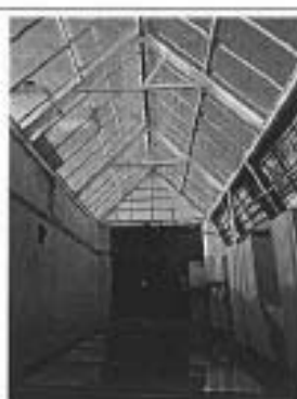
Фото 10. Фрагмент светового фонаря
