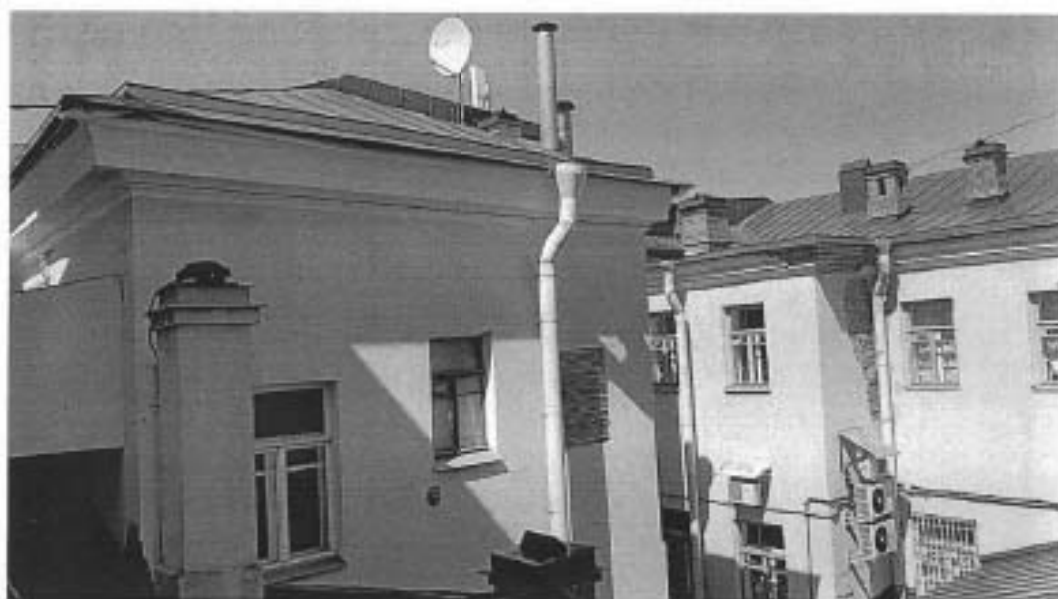
Фрагмент дворового фасада
