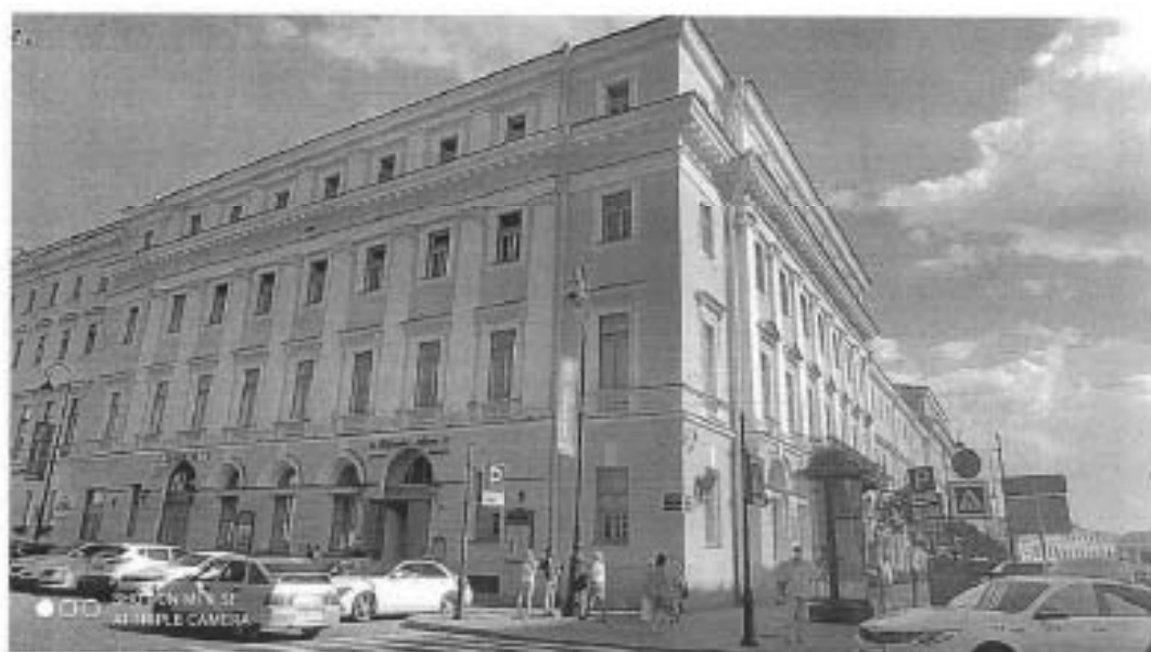
Лицевой фасад со стороны Итальянской улицы
