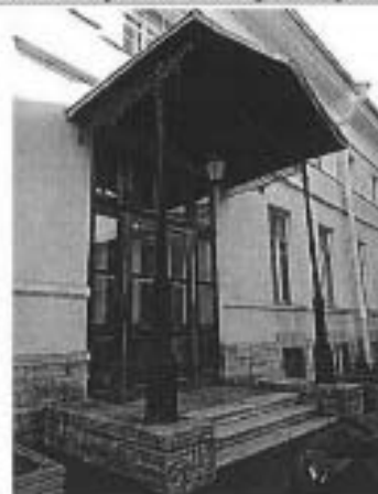
Фото 8. Фрагмент дворового фасада. Входная группа
