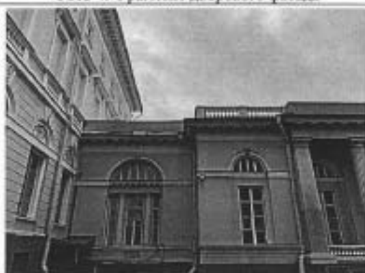
Фото 6. Фрагмент северного фасада
