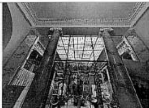
Фото 20. Фрагмент интерьера. Колонный зал
