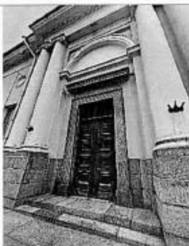
Фото 4. Фрагмент портала (по Инженерной ул.)
