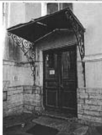
Фото 7. Фрагмент дворового фасада. Входная группа
