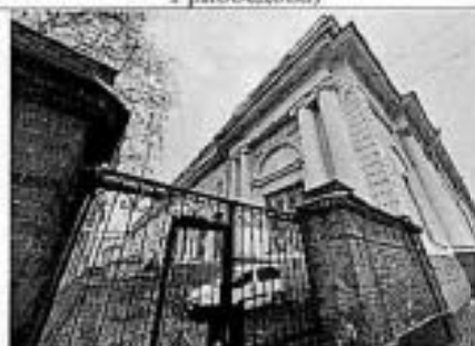
Фото 8. Фрагмент фасада во внутреннем дворе
