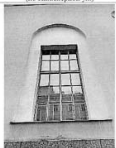
Фото 7. Оформление оконного проема лицевого фасада
