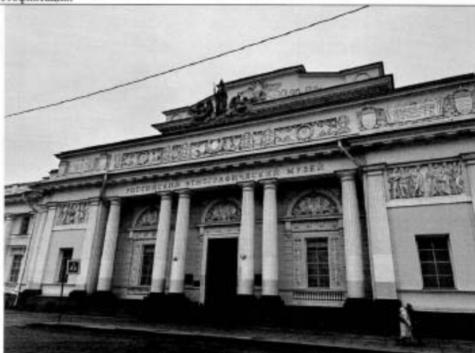
Фото 1. Лицевой фасад. Центральный ризалит
