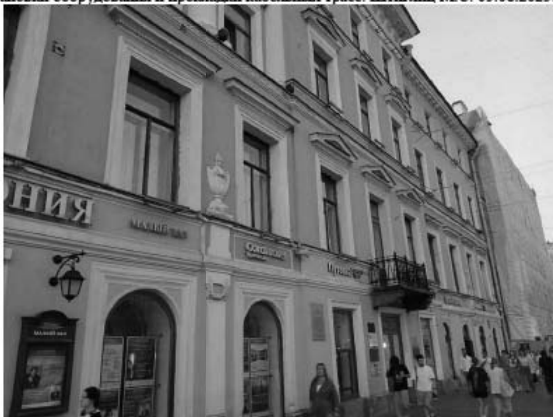
22. «Дом Энгельгардта В.В. (Санкт-Петербургский учетный и ссудный банк)». Невский пр., д. 30, лит. А. Лицевой фасад по Невскому пр. (фрагмент). Фото мест установки оборудования и прокладки кабельных трасс. Штиглиц М.С. 05.08.2025.
