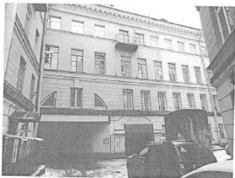
Фото 3. Дворовый фасад здания.
