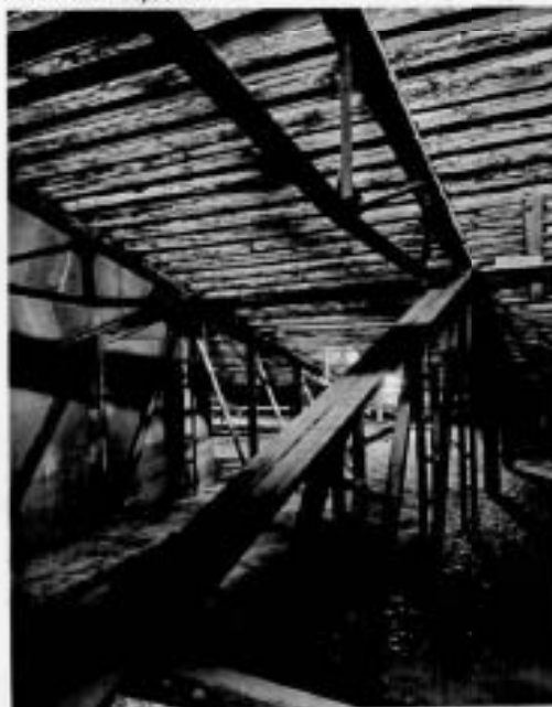
32. Металлические балки стропильной системы чердака.
