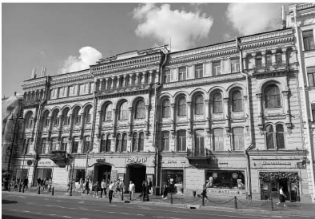
29. «Дом М.И. Лопатина (в составе «Дома товарищества «Григорий Бенингсон» (Доходный дом М.И. Лопатина. Здание панорамы «Голгофа» - бывший кинотеатр «Коллизей»)). Невский пр., д. 100, лит. А. Лицевой фасад по Невскому пр. Штиглиц М.С. 05.08.2025.
