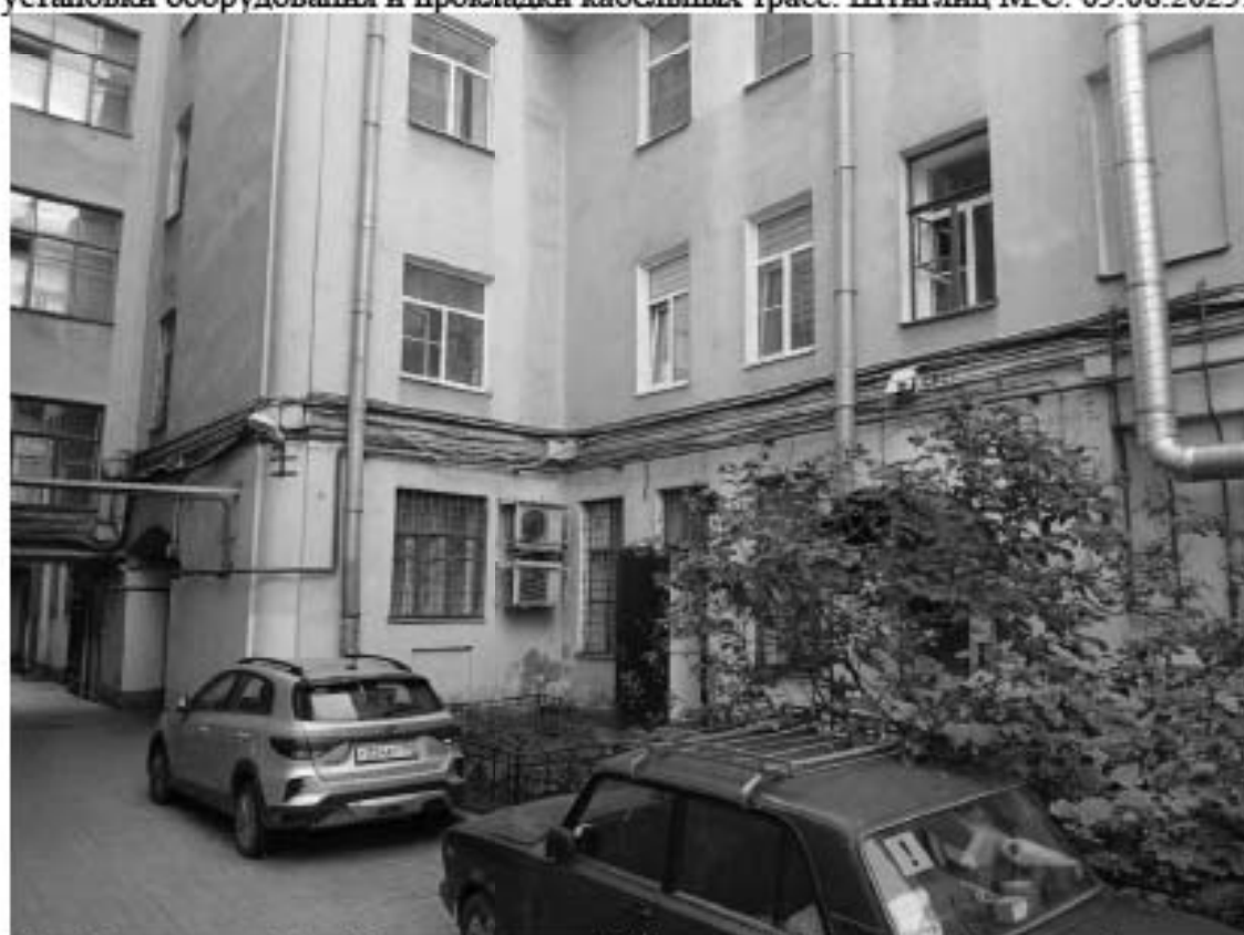
48. «Дом Яковлевых» (ул. Маяковского, д. 1/96, лит. А). Дворовые фасады. Фото мест установки оборудования и прокладки кабельных трасс. Штиглиц М.С. 05.08.2025.
