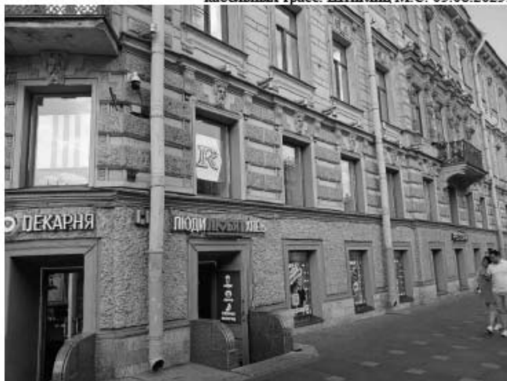
44. «Дом Яковлевых» (ул. Маяковского, д. 1/96, лит. А). Лицевой фасад по Невскому пр. (фрагмент). Фото мест установки оборудования и прокладки кабельных трасс. Штиглиц М.С. 05.08.2025.
