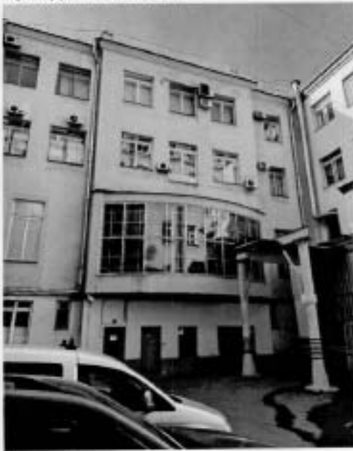
9. Северный дворовой фасад объекта культурного наследия.
