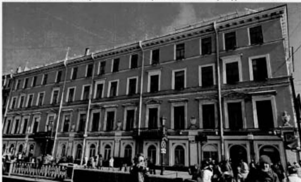
3. Вид на южный лицевой фасад по наб. кан. Грибоедова объекта культурного наследия.
