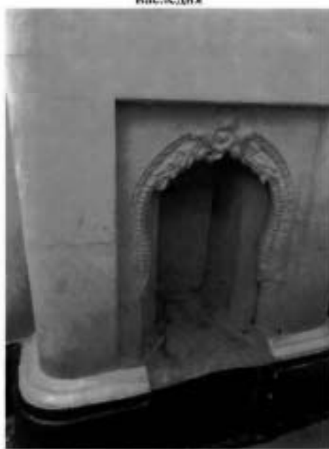
21. Помещение Л-5 объекта культурного наследия. Фото выполнено 22.03.2024.
