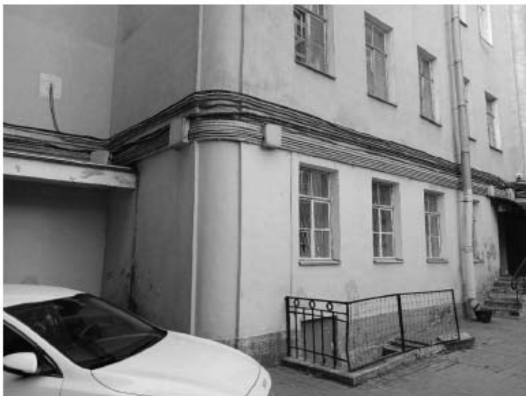
49. «Дом Яковлевых» (ул. Маяковского, д. 1/96, лит. А). Дворовые фасады. Фото мест установки оборудования и прокладки кабельных трасс. Штиглиц М.С. 05.08.2025.
