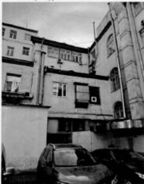
7. Западный и северный дворовые фасады объекта культурного наследия.
