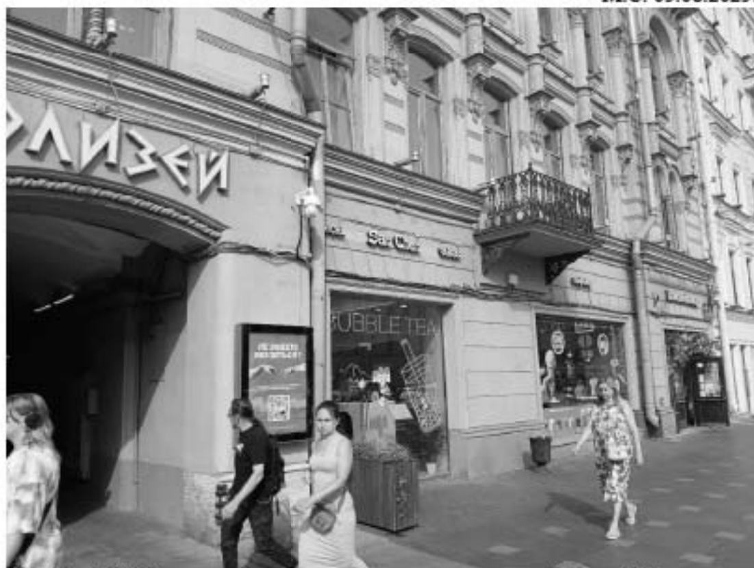
30. «Дом М.И. Лопатина (в составе «Дома товарищества «Григорий Бенингсон» (Доходный дом М.И. Лопатина. Здание панорамы «Голгофа» - бывший кинотеатр «Коллизей»)). Невский пр., д. 100, лит. А. Лицевой фасад по Невскому пр. (фрагмент). Фото мест установки оборудования и прокладки кабельных трасс. Штиглиц М.С. 05.08.2025.
