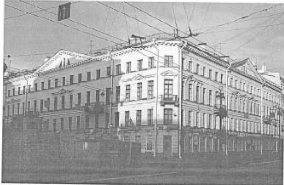
Фото 1. Лицевой фасад здания.
