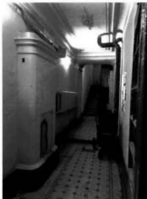
19. Помещение Л-5 объекта культурного наследия. наследия
