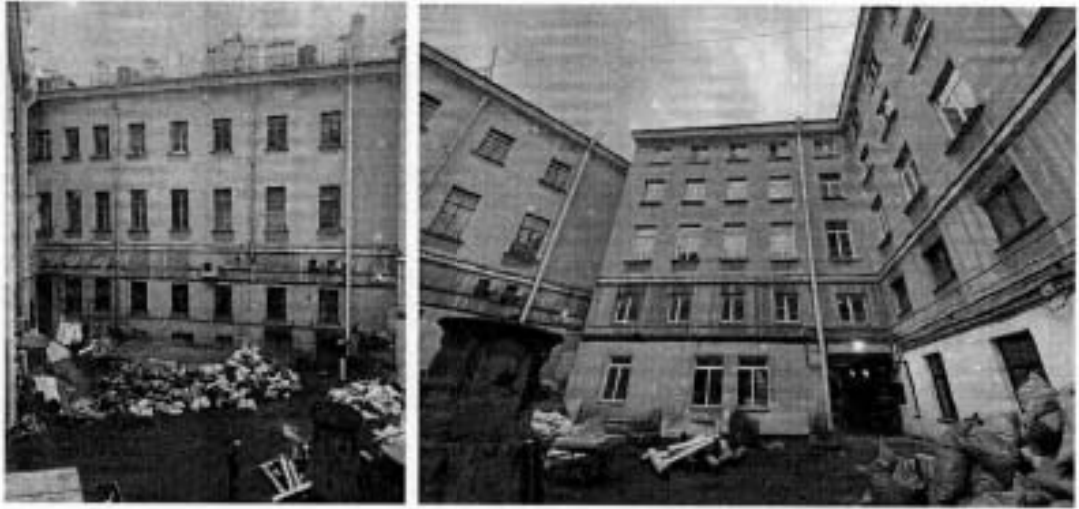
32-34. Фрагменты фасадов восточного двора (17.11.2021).
