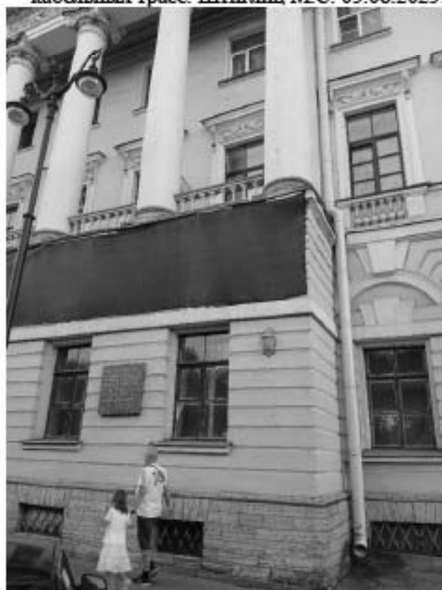
34. «Дом Антонова («Дом Адамини»)» (наб. реки Мойки, д. 1/8, лит. А). Лицевой фасад Марсово поле. (фрагмент). Фото мест установки оборудования и прокладки кабельных трасс. Штиглиц М.С. 05.08.2025.
