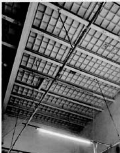
30. Перекрытия по металлическим балкам с остеклением (пом. 8-Н, ч.п. 7.8, 1 этаж).
