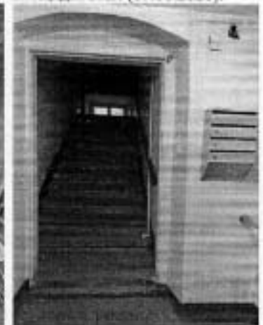
72. Промежуточная площадка 3ЛК (17.11.2021).
