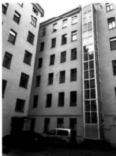
5. Фрагмент северо-восточного фасада южного двора объекта культурного наследия. Фото выполнено 22.03.2024.
