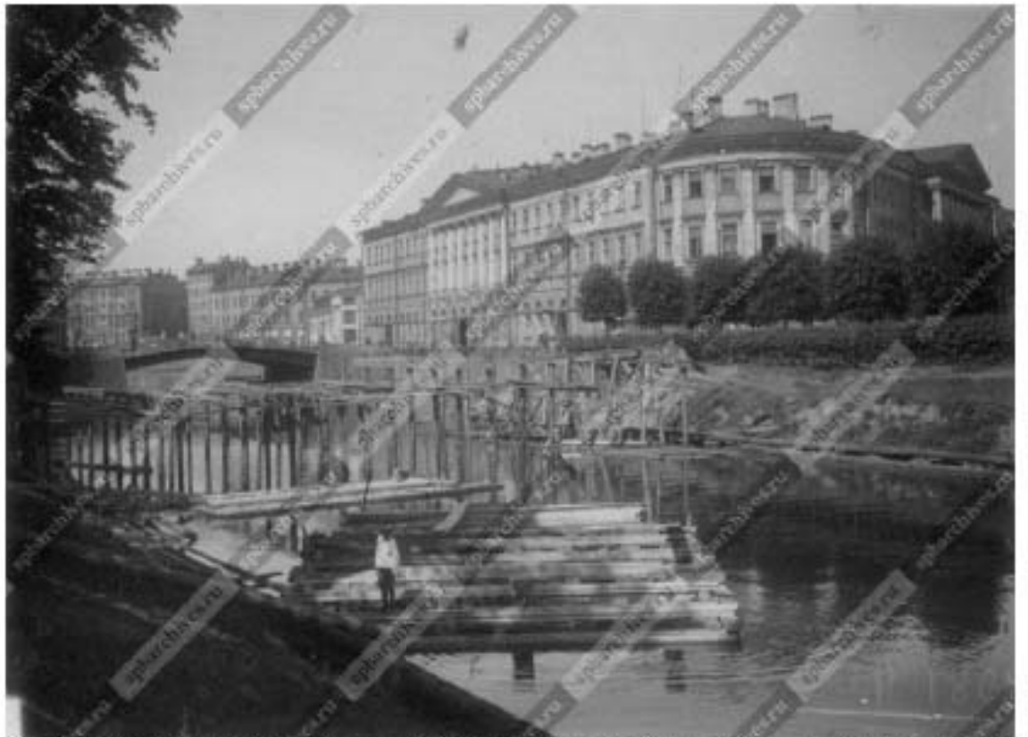
19. «Дом Антонова («дом Адамини»)» (наб. реки Мойки, д. 1/8, лит. А). 1933 г. Вид ремонтных работ на наб. реки Мойки. ЦГАКФФД СПб Гр 25087.
