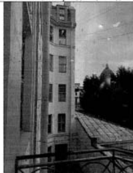
3. Фрагмент дворового фасада
