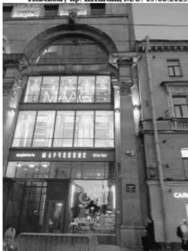
8. «Бывший дом Мертенса (фасады)» (Невский пр., д. 21, лит. А). Лицевой фасад по Невскому пр. (фрагмент). Фото мест установки оборудования и прокладки кабельных трасс. Штиглиц М.С. 05.08.2025.
