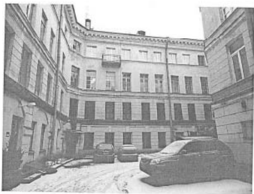
Фото 4. Дворовый фасад здания.
