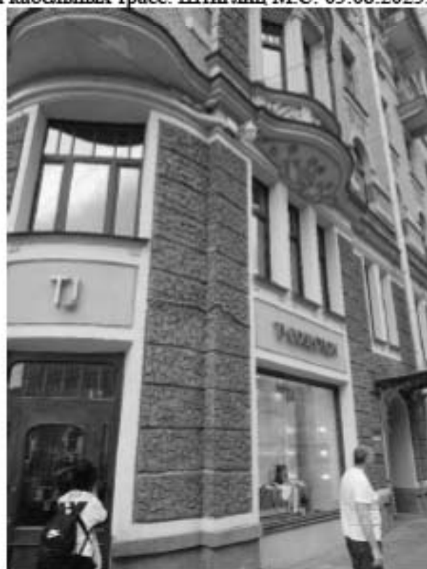
28. «Дом И.И. Круглова». Невский пр., д. 147, лит. А. Лицевой фасад по Невскому пр. (фрагмент). Фото мест установки оборудования и прокладки кабельных трасс. Штиглиц М.С. 05.08.2025.
