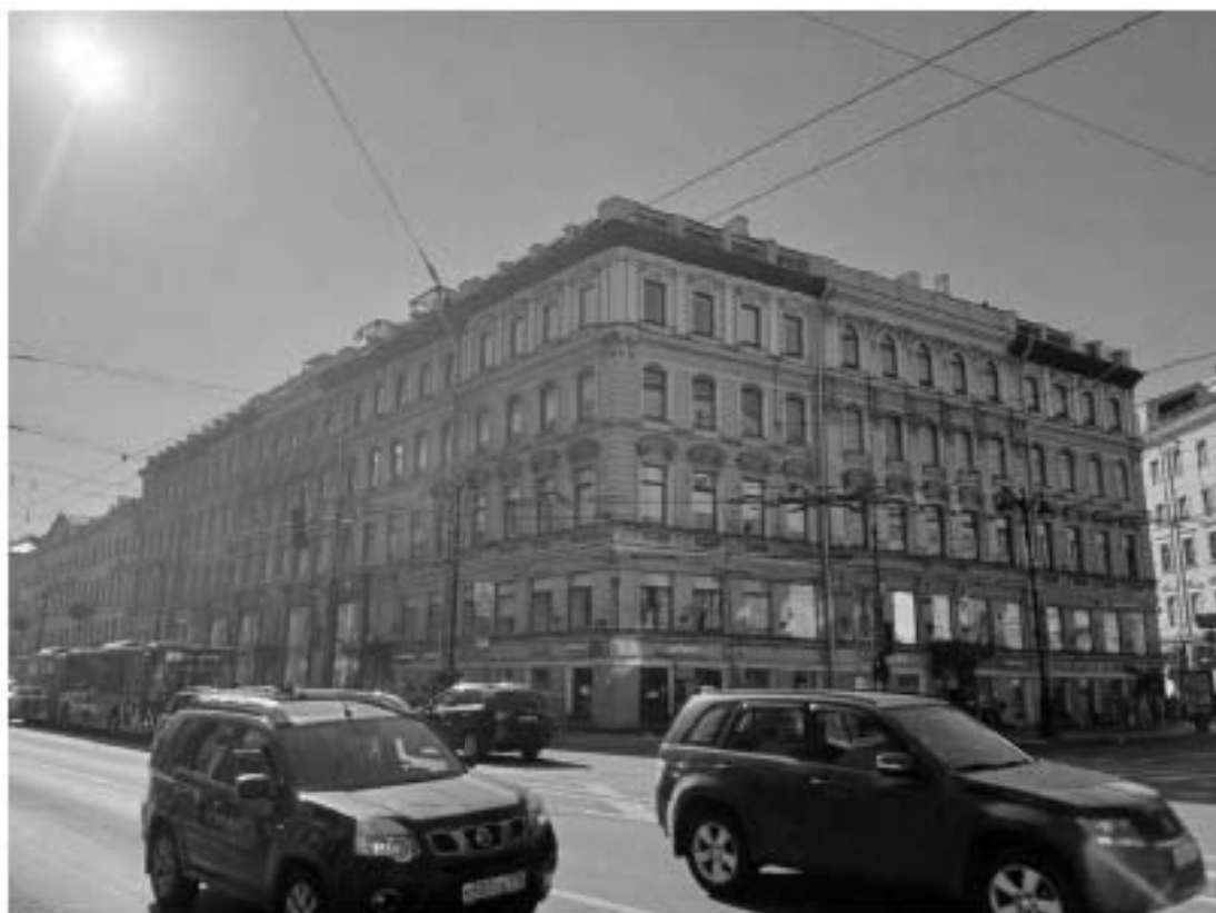
1. «Дом А.И. Трейберга» (Невский пр., д. 11/2, лит. А). Лицевой фасад по ул. Малая Морская. Штиглиц М.С. 05.08.2025.
