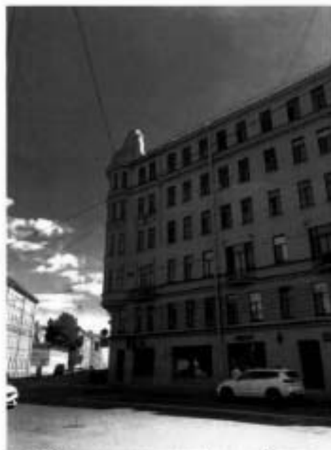
3. Фрагмент северного фасада объекта культурного наследия. Фото выполнено 16.07.2024
