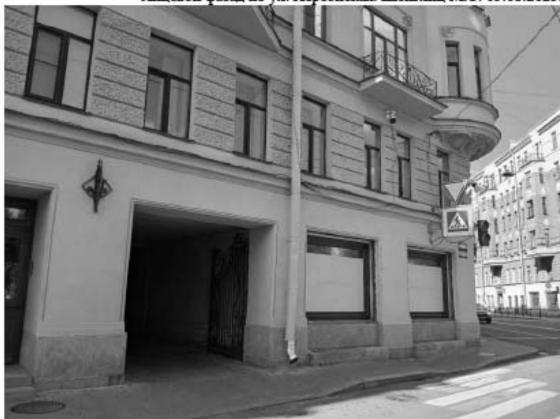
54. «Дом, где в 1907 г. жил Бонч-Бруевич В.Д.» (Херсонская ул., д. 1/7, лит. А). Лицевой фасад по ул. Херсонская. (фрагмент). Фото мест установки оборудования и прокладки кабельных трасс. Штиглиц М.С. 05.08.2025.
