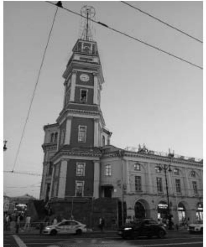
5. «Серебряные ряды» (Невский пр., д. 29-31, лит. А). Лицевой фасад по Невскому пр. Штиглиц М.С. 05.08.2025.
