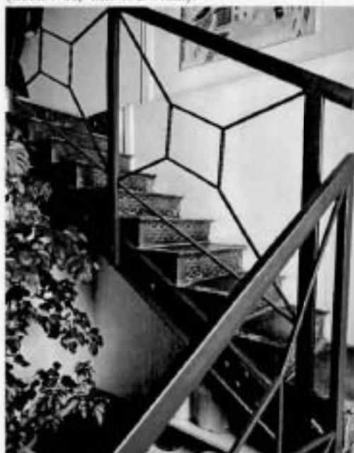
26. Чугунная лестница (пом. 9-Н, ч.п. 4, 2 этаж).
