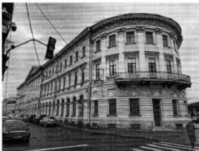
12. Общий вид на южный лицевой фасад и полукруглую часть (17.11.2021).
