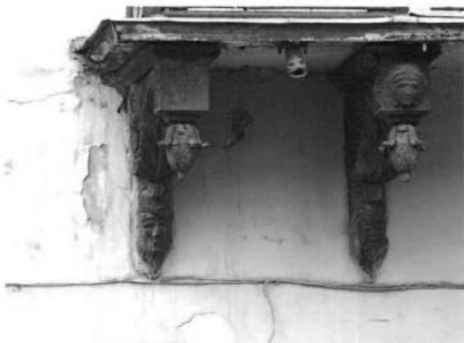
2. Фасад со стороны набережной реки Мойки. Декор балкона.
