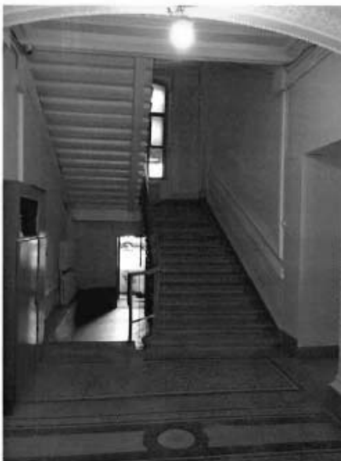
5. Помещение парадной лестницы.
