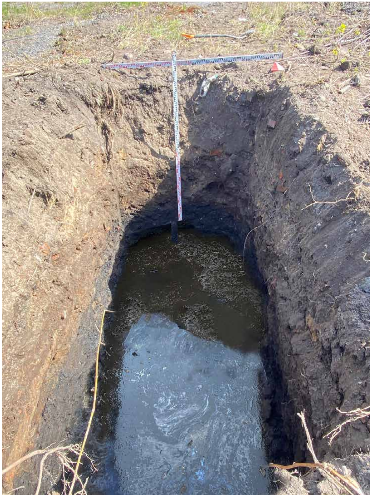
Рис. 72. Санкт-Петербург, Шкиперский проток (кадастровый номер: 78:06:0002205:3141); Санкт-Петербург, Шкиперский проток (кадастровый номер: 78:06:0002205:3142). Шурф 2-3. Зачистка по материке по уровню стояния грунтовых вод. Вид с юга.
