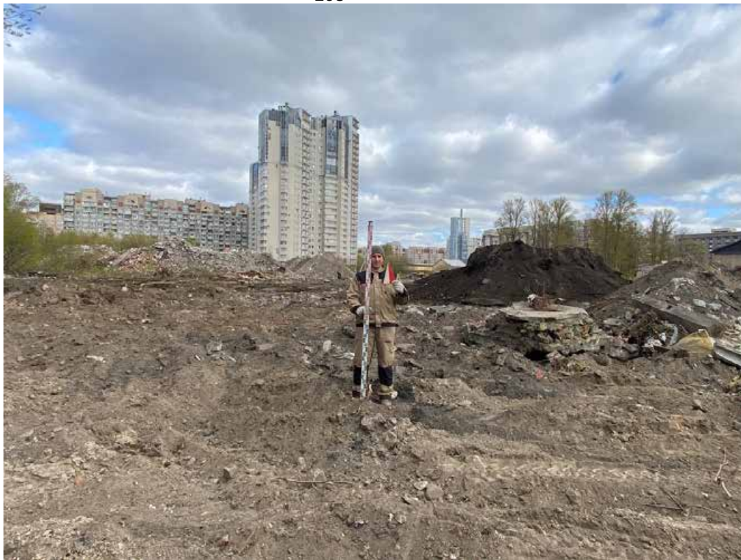
Рис. 42. Санкт-Петербург, Шкиперский проток (кадастровый номер: 78:06:0002205:3141); Санкт-Петербург, Шкиперский проток (кадастровый номер: 78:06:0002205:3142). Photo 8. Общий вид территории обследования. Вид с юга.
