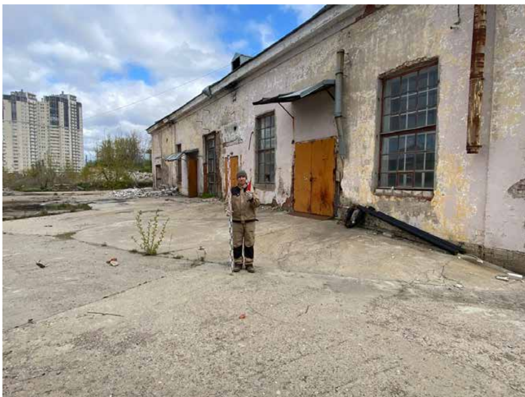
Рис. 61. Санкт-Петербург, Шкиперский проток (кадастровый номер: 78:06:0002205:3141); Санкт-Петербург, Шкиперский проток (кадастровый номер: 78:06:0002205:3142). Photo 13. Общий вид территории обследования. Вид с юга.
