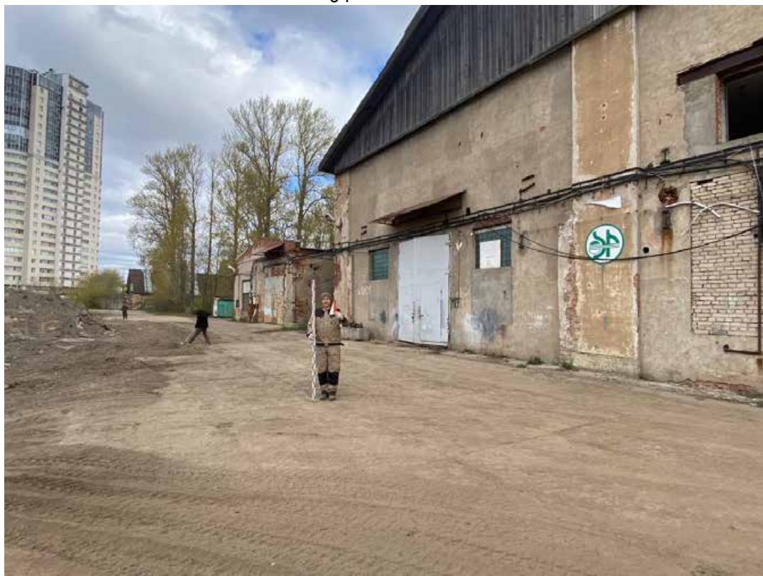
Рис. 20. Санкт-Петербург, Шкиперский проток (кадастровый номер: 78:06:0002205:3141); Санкт-Петербург, Шкиперский проток (кадастровый номер: 78:06:0002205:3142). Photo 2. Общий вид территории обследования. Вид с юга.
