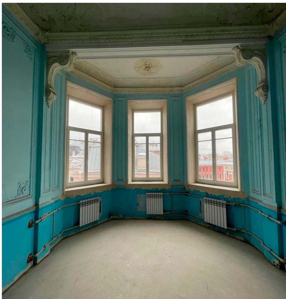
15. Помещение №22 кв. № 38 объекта культурного наследия регионального значения «Жилой дом страхового общества «Россия» с садом и оградами страхового общества «Россия» с садом и оградами», расположенного по адресу: г. Санкт-Петербург, ул. Моховая, дом 27-29, лит. А. 03.08.2025
