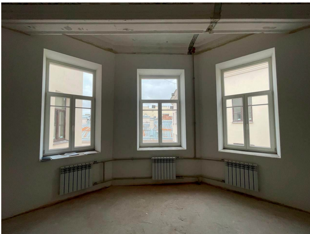
11. Помещение №12 кв. № 38 объекта культурного наследия регионального значения «Жилой дом страхового общества «Россия» с садом и оградами страхового общества «Россия» с садом и оградами», расположенного по адресу: г. Санкт-Петербург, ул. Моховая, дом 27-29, лит. А. 03.08.2025
