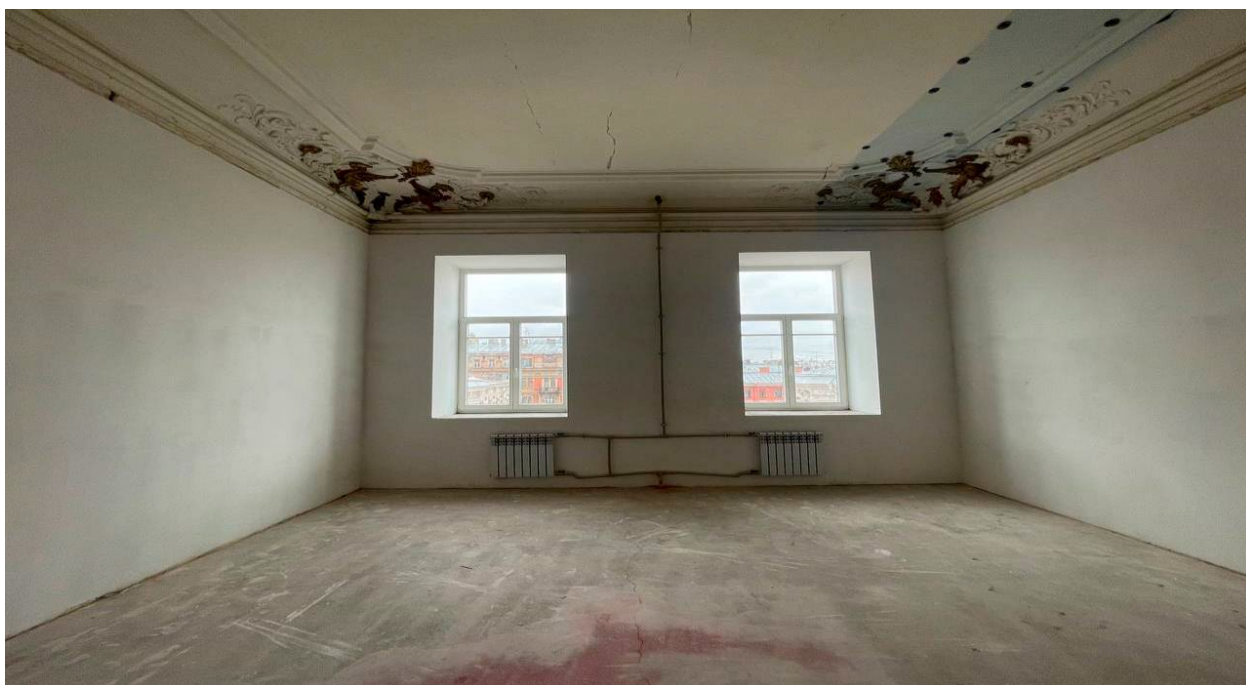
20. Помещение №31 кв. № 38 объекта культурного наследия регионального значения «Жилой дом страхового общества «Россия» с садом и оградами страхового общества «Россия» с садом и оградами», расположенного по адресу: г. Санкт-Петербург, ул. Моховая, дом 27-29, лит. А. 03.08.2025
