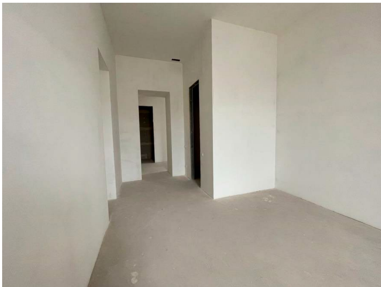
17. Помещение №23 кв. № 38 объекта культурного наследия регионального значения «Жилой дом страхового общества «Россия» с садом и оградами страхового общества «Россия» с садом и оградами», расположенного по адресу: г. Санкт-Петербург, ул. Моховая, дом 27-29, лит. А. 03.08.2025
