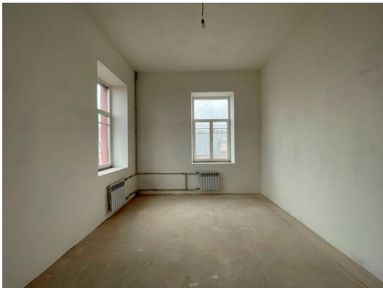
18. Помещение №26 кв. № 38 объекта культурного наследия регионального значения «Жилой дом страхового общества «Россия» с садом и оградами страхового общества «Россия» с садом и оградами», расположенного по адресу: г. Санкт-Петербург, ул. Моховая, дом 27-29, лит. А. 03.08.2025
