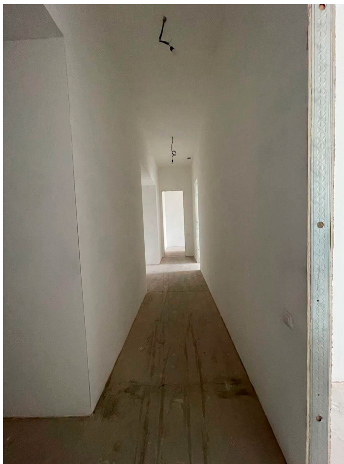
21. Помещение коридора №4 кв. № 38 объекта культурного наследия регионального значения «Жилой дом страхового общества «Россия» с садом и оградами страхового общества «Россия» с садом и оградами», расположенного по адресу: г. Санкт-Петербург, ул. Моховая, дом 27-29, лит. А. 03.08.2025
