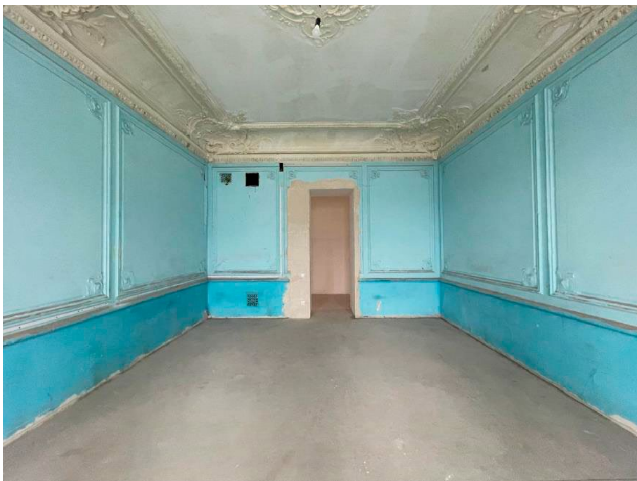
16. Помещение №22 кв. № 38 объекта культурного наследия регионального значения «Жилой дом страхового общества «Россия» с садом и оградами страхового общества «Россия» с садом и оградами», расположенного по адресу: г. Санкт-Петербург, ул. Моховая, дом 27-29, лит. А. 03.08.2025
