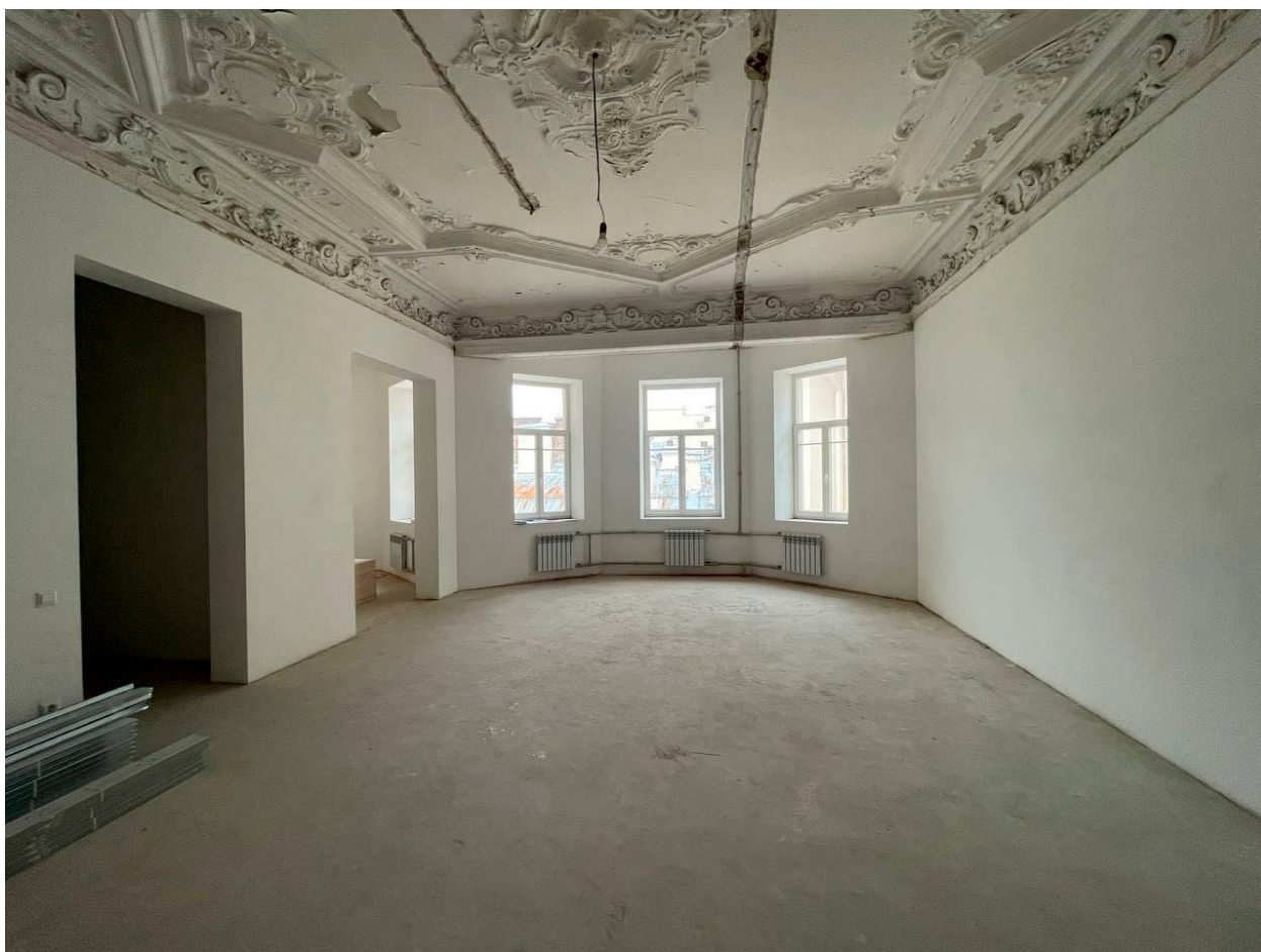
12. Помещение №12 кв. № 38 объекта культурного наследия регионального значения «Жилой дом страхового общества «Россия» с садом и оградами страхового общества «Россия» с садом и оградами», расположенного по адресу: г. Санкт-Петербург, ул. Моховая, дом 27-29, лит. А. 03.08.2025
