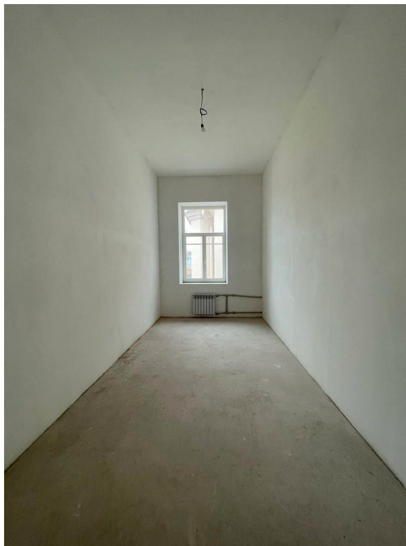
19. Помещение №16 кв. № 38 объекта культурного наследия регионального значения «Жилой дом страхового общества «Россия» с садом и оградами страхового общества «Россия» с садом и оградами», расположенного по адресу: г. Санкт-Петербург, ул. Моховая, дом 27-29, лит. А. 03.08.2025
