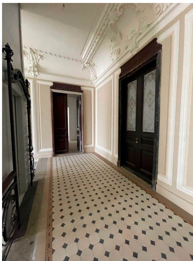
7. Вид на входные дверные проемы со стороны лестничной клетки объекта культурного наследия регионального значения «Жилой дом страхового общества «Россия» с садом и оградами страхового общества «Россия» с садом и оградами», расположенного по адресу: г. Санкт-Петербург, ул. Моховая, дом 27-29, лит. А. 03.08.2025
