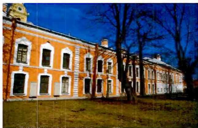
2. Фрагмент южного фасада
