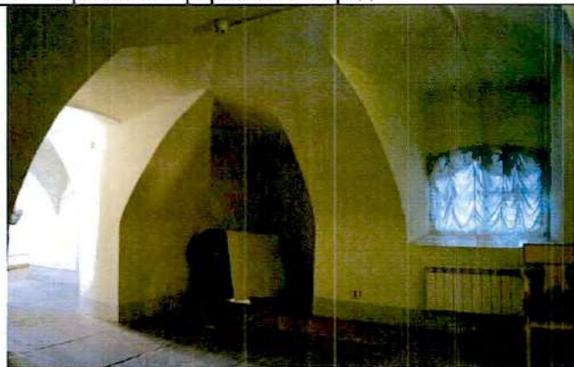
9. Фрагмент интерьера в уровне 1-го этажа
