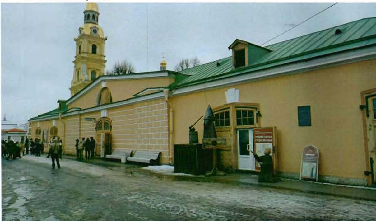
1. Вид на западный фасад.
