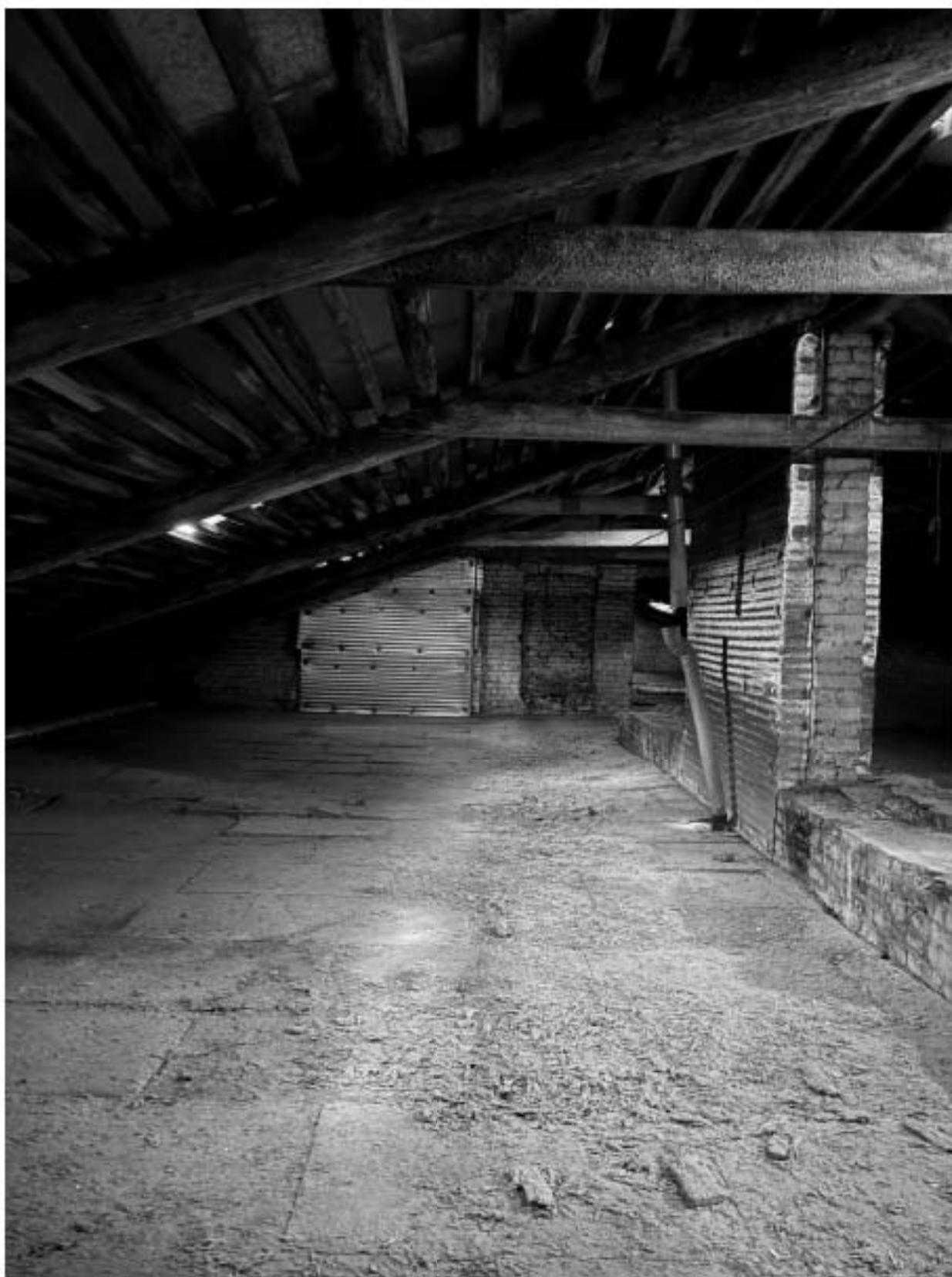
Фото 31. Вид на чердачное помещение объекта культурного наследия.
