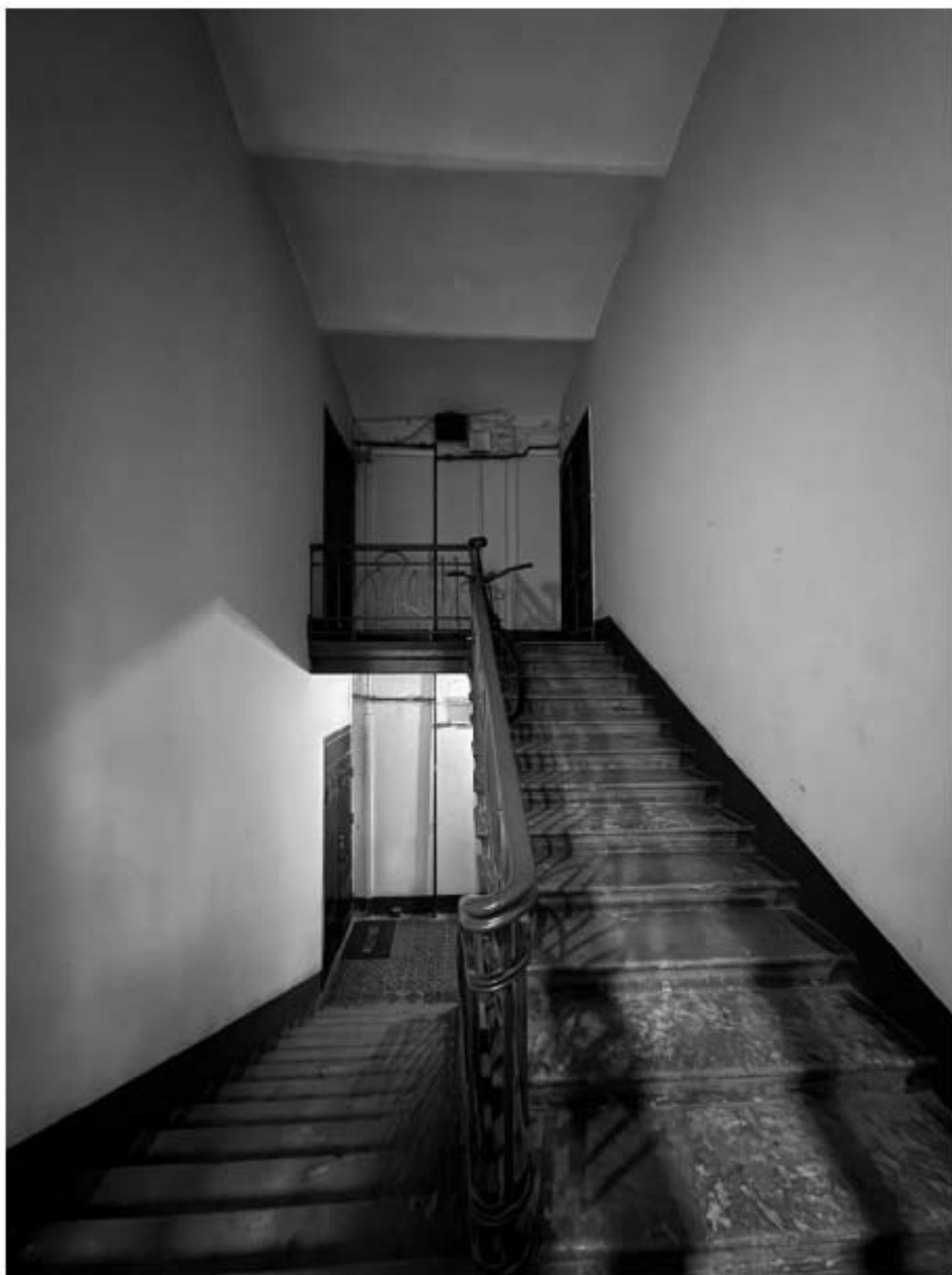
Фото 158. Вид на интерьер лестницы 2-ЛК объекта культурного наследия.
