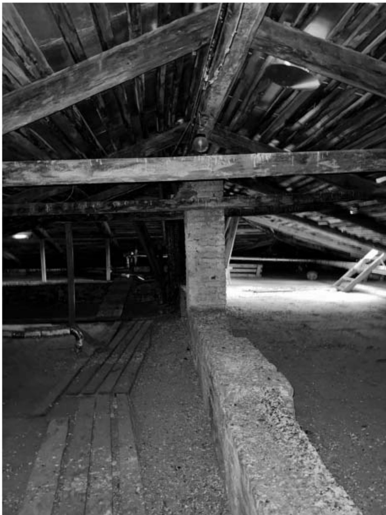
Фото 40. Вид на чердачное помещение объекта культурного наследия.
