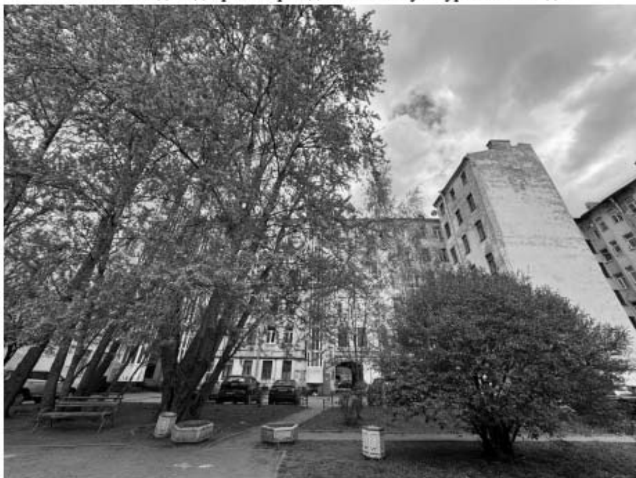
Фото 15. Вид на дворовые фасады объекта культурного наследия.
