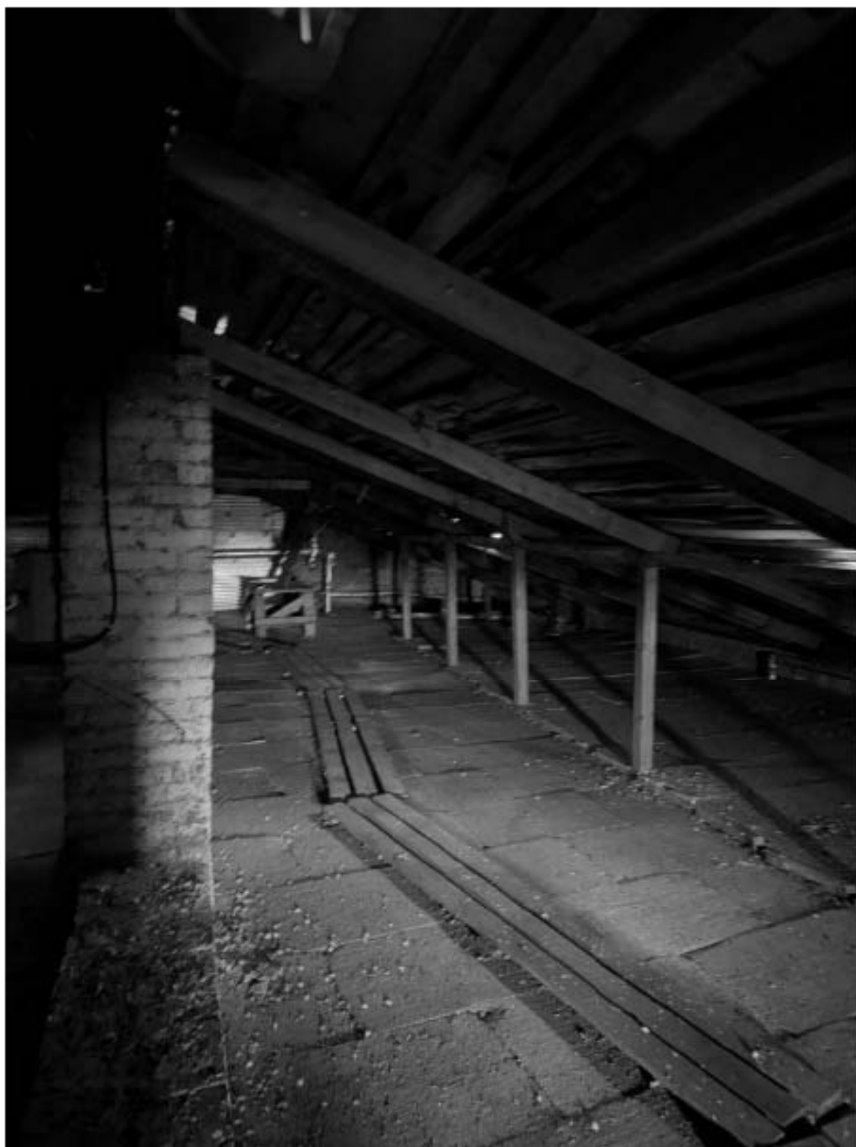
Фото 41. Вид на чердачное помещение объекта культурного наследия.
