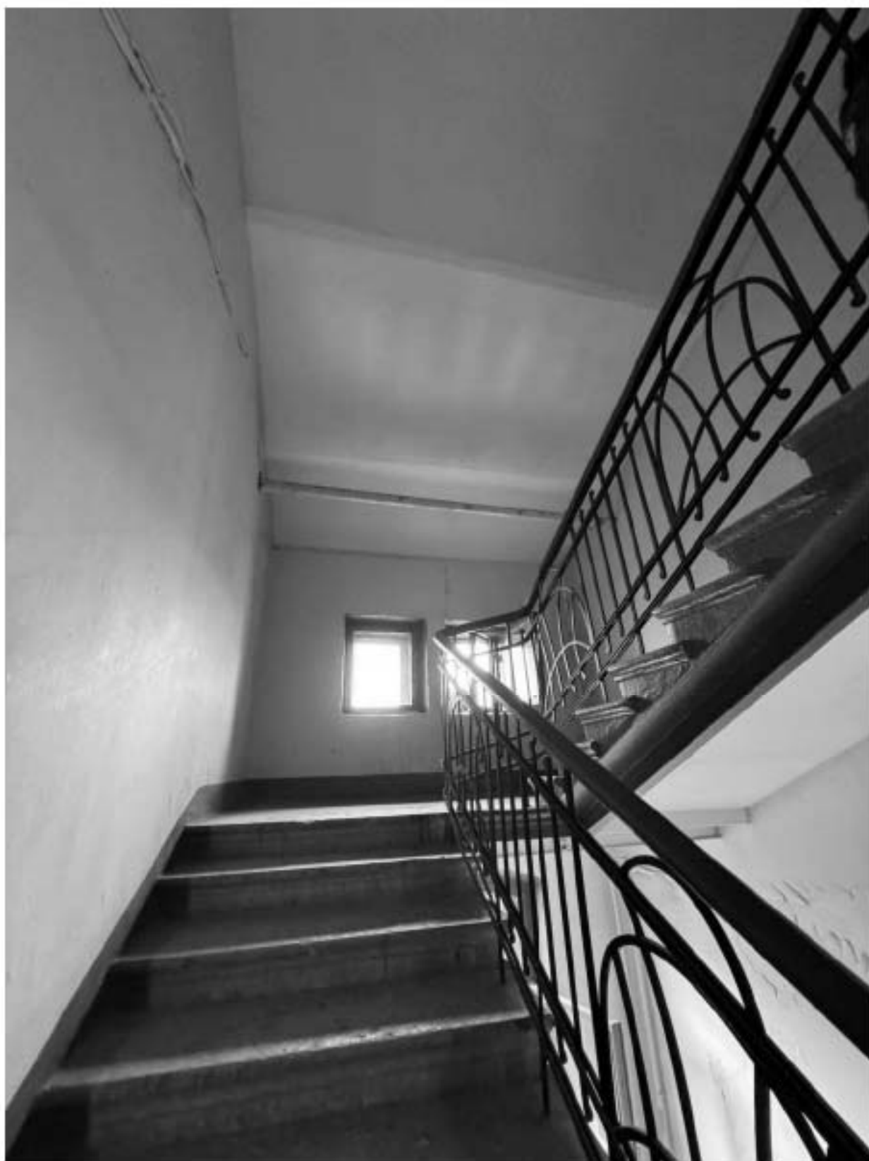
Фото 28. Вид на интерьер лестницы 7-ЛК объекта культурного наследия.
