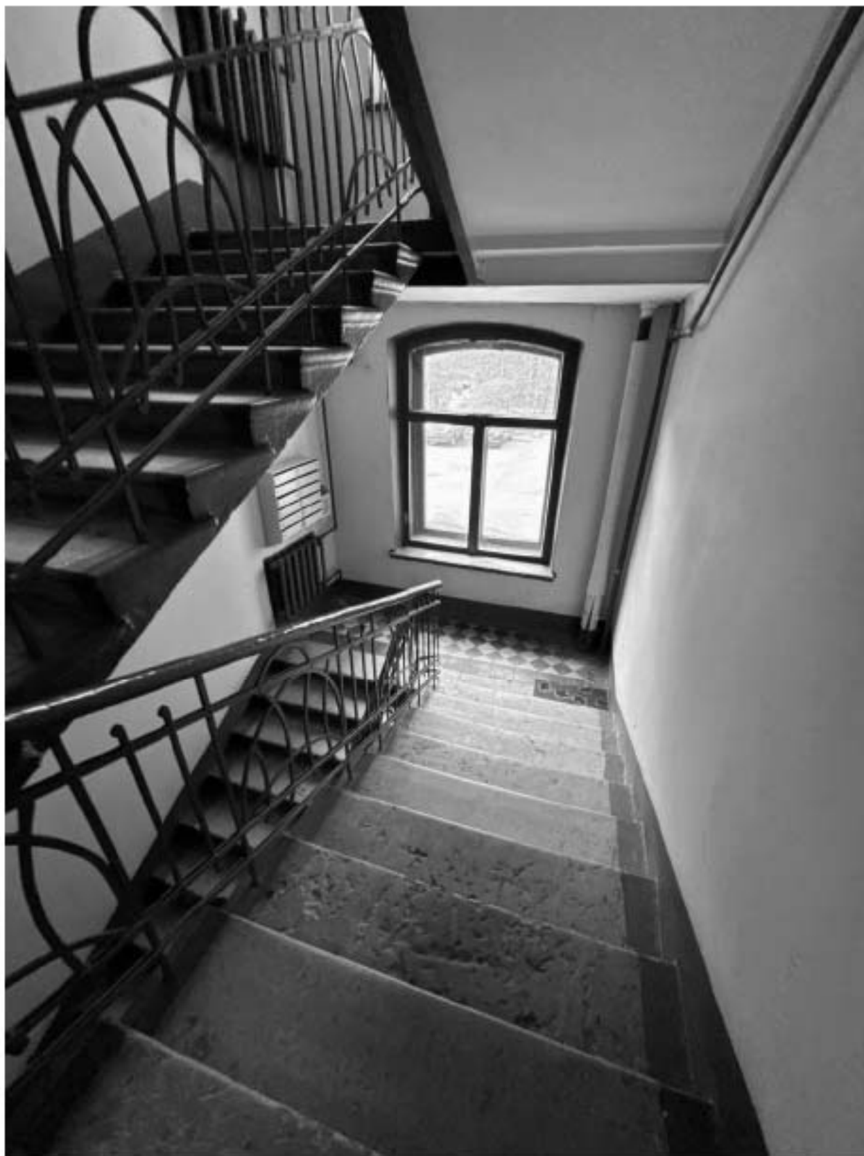
Фото 81. Вид на интерьер лестницы 6-ЛК объекта культурного наследия.
