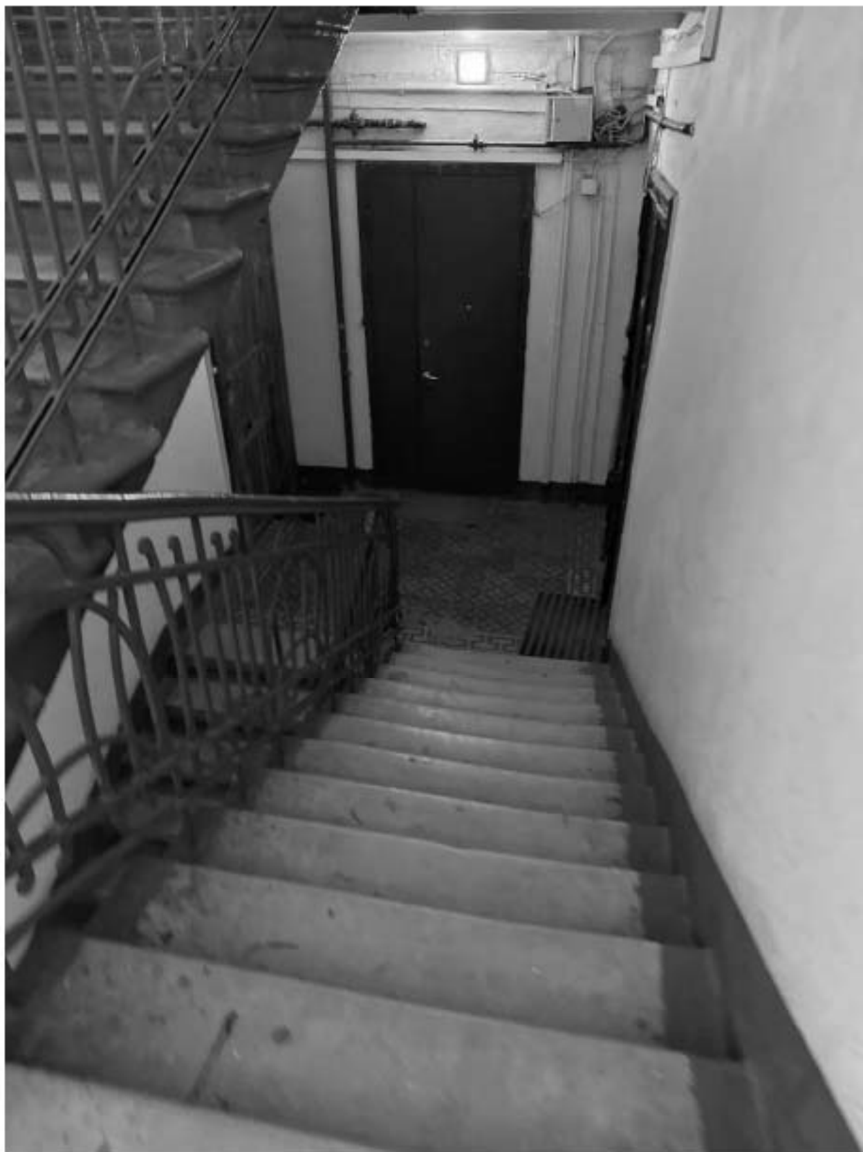
Фото 129. Вид на интерьер лестницы 4-ЛК объекта культурного наследия.
