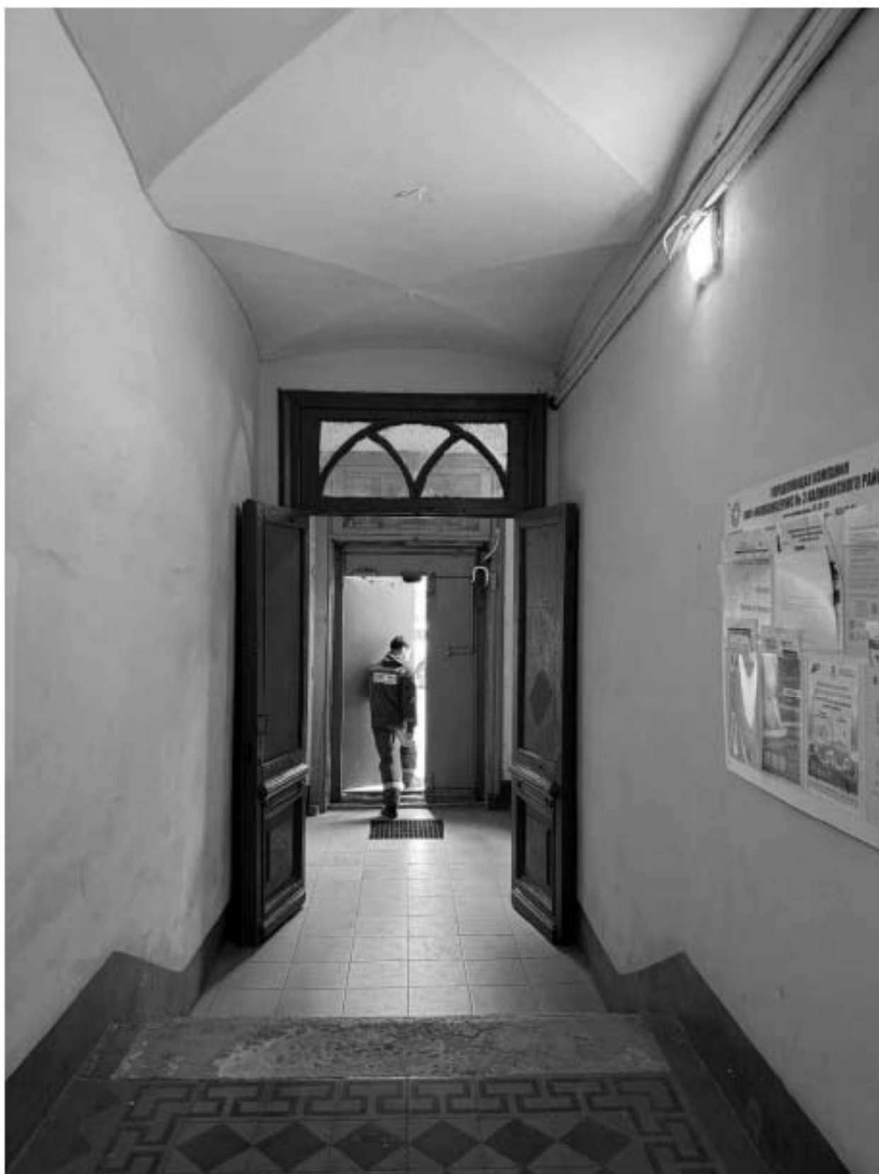
Фото 194. Вид на интерьер вестибюля лестницы 1-ЛК объекта культурного наследия.
