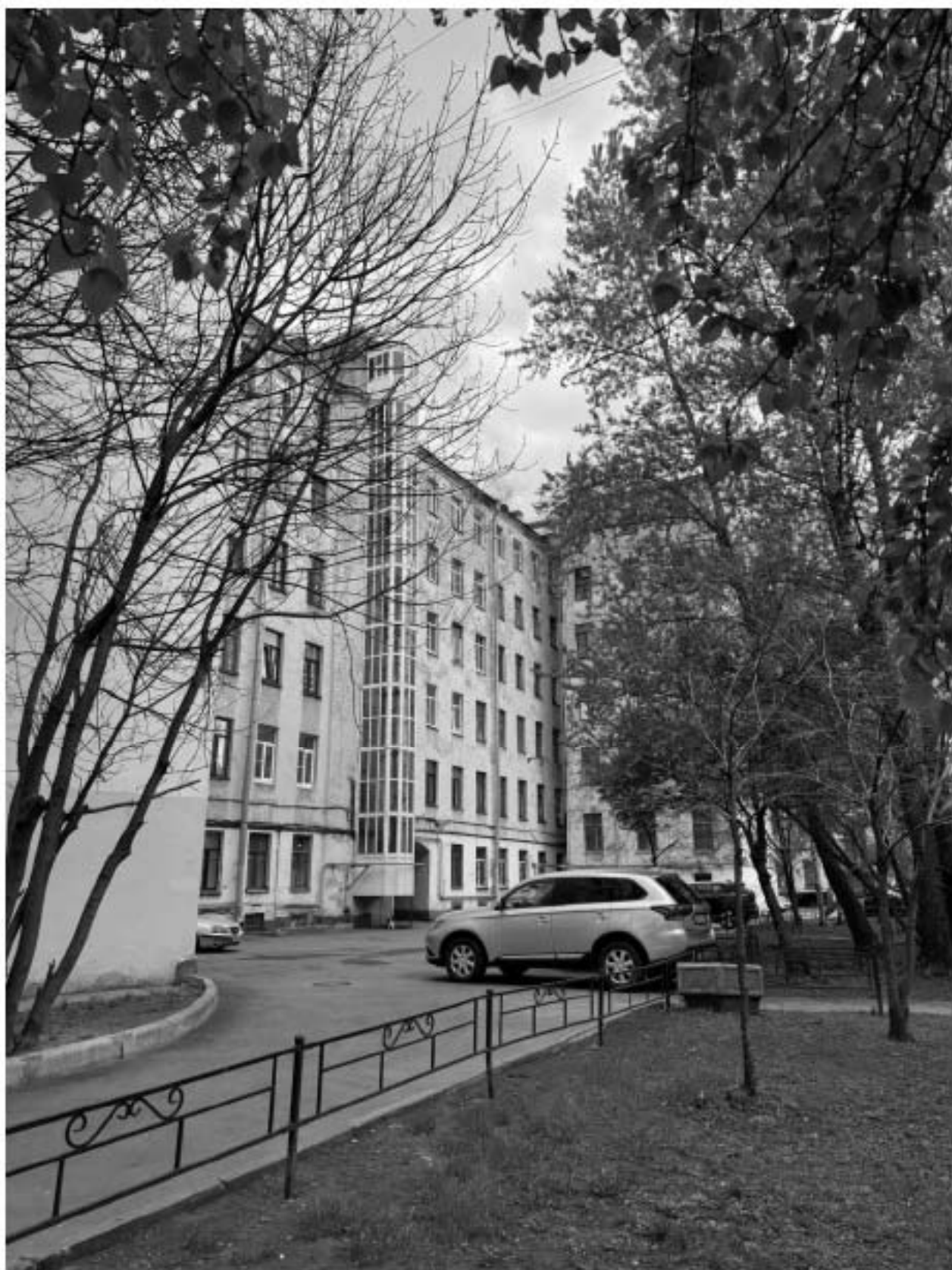
Фото 10. Вид на дворовые фасады объекта культурного наследия.
