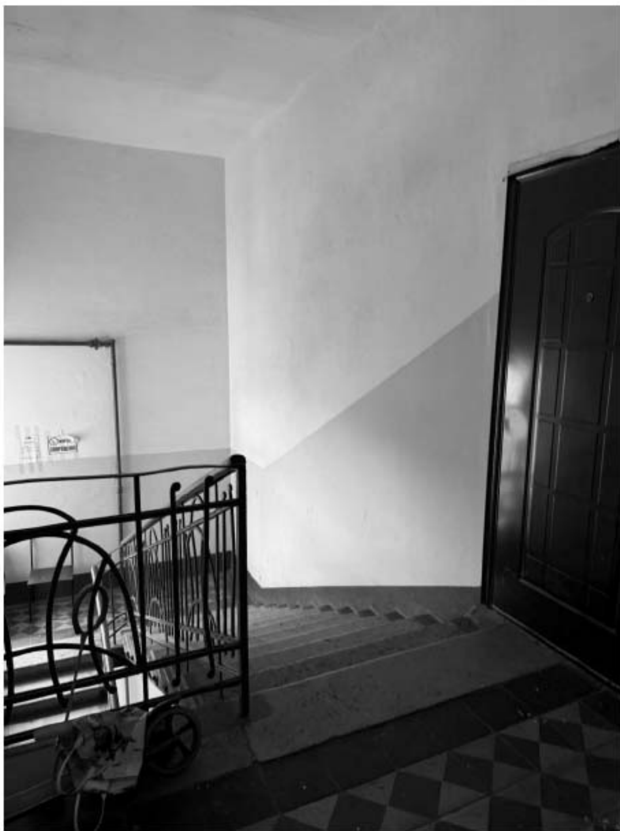
Фото 89. Вид на интерьер лестницы 5-ЛК объекта культурного наследия.
