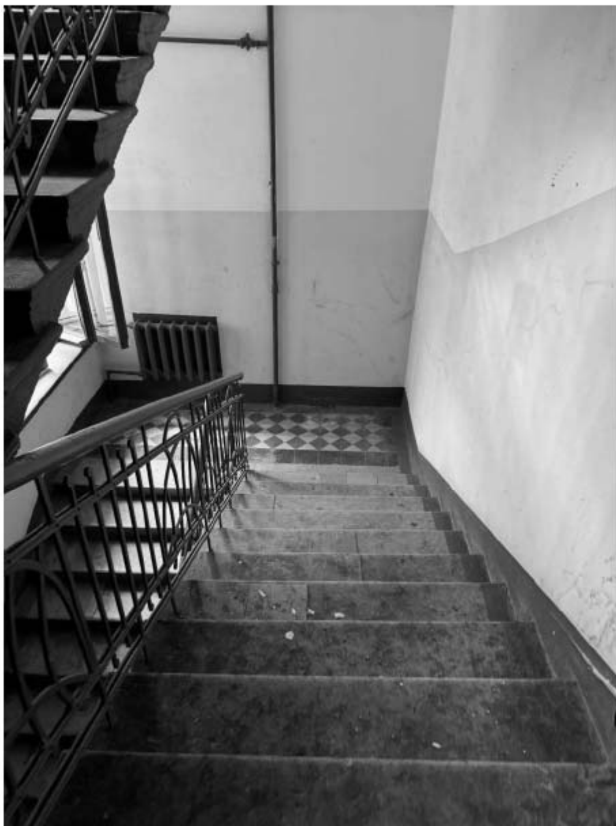
Фото 97. Вид на интерьер лестницы 5-ЛК объекта культурного наследия.
