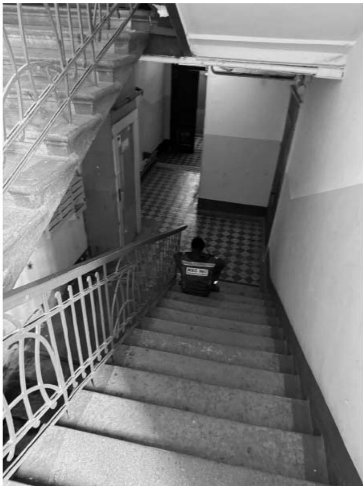
Фото 107. Вид на интерьер лестницы 5-ЛК объекта культурного наследия.
