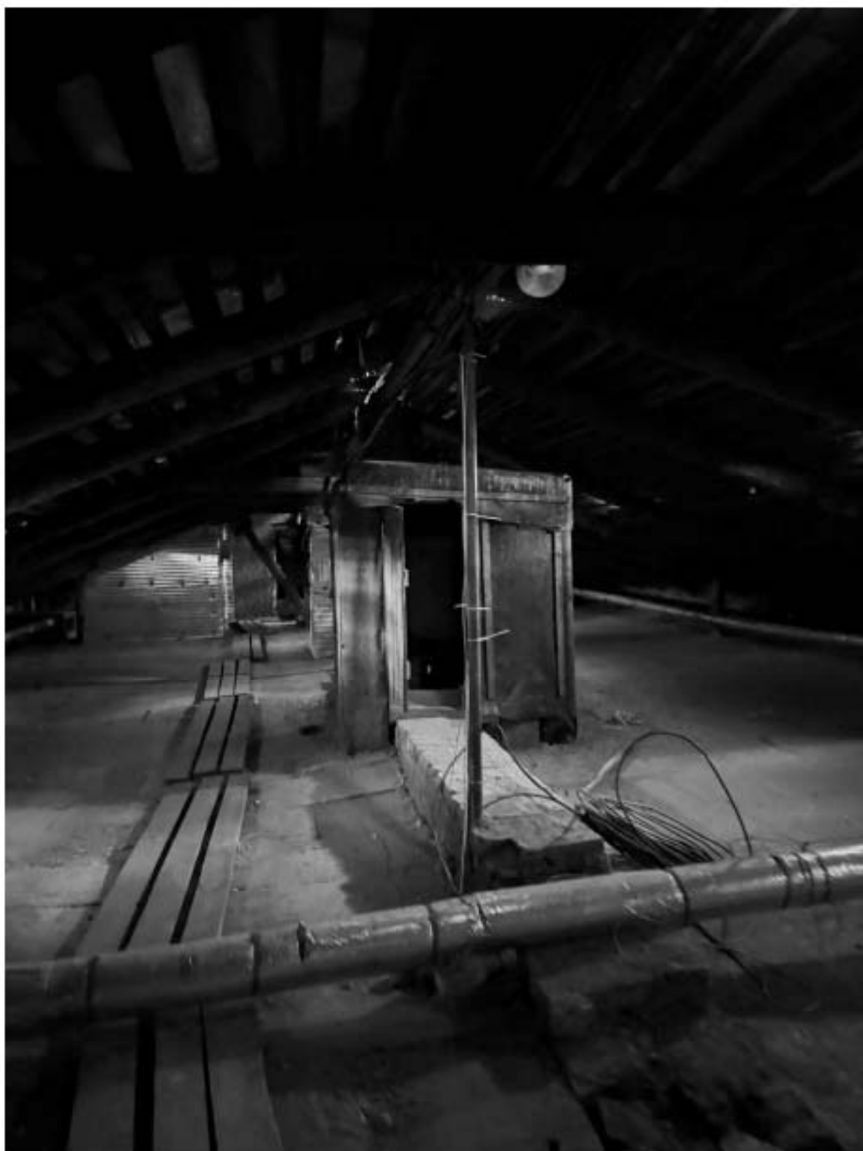
Фото 38. Вид на чердачное помещение объекта культурного наследия.
