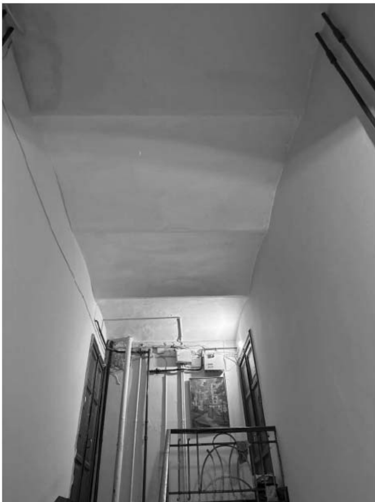
Фото 138. Вид на интерьер потолка лестницы 3-ЛК объекта культурного наследия.
