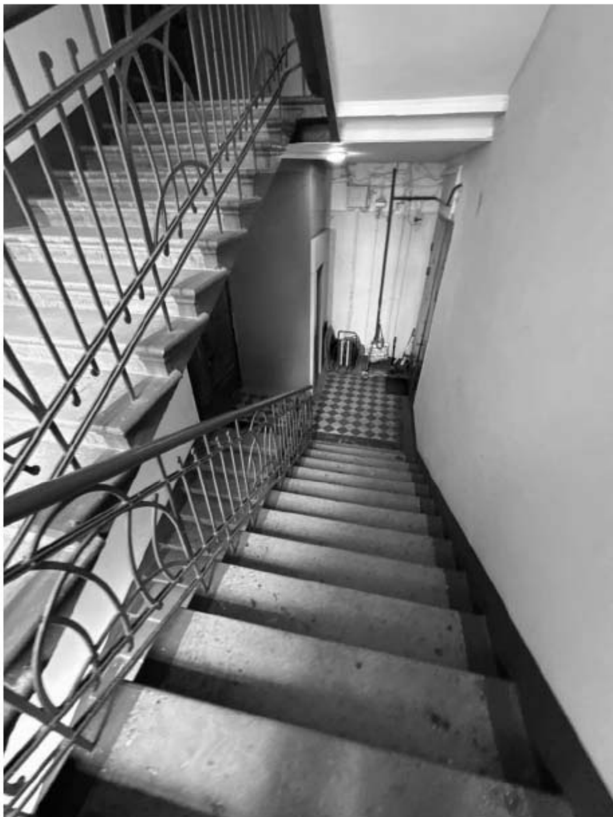
Фото 80. Вид на интерьер лестницы 6-ЛК объекта культурного наследия.
