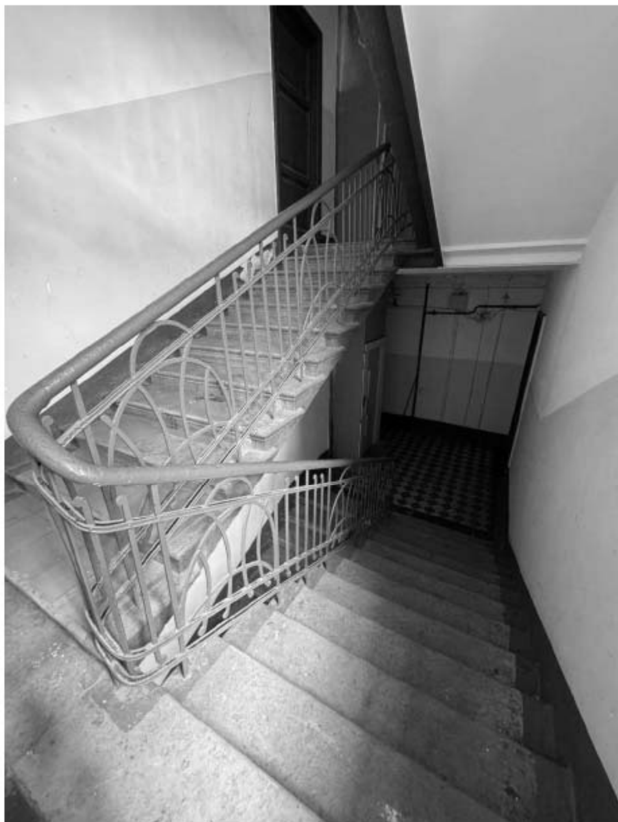
Фото 103. Вид на интерьер лестницы 5-ЛК объекта культурного наследия.
