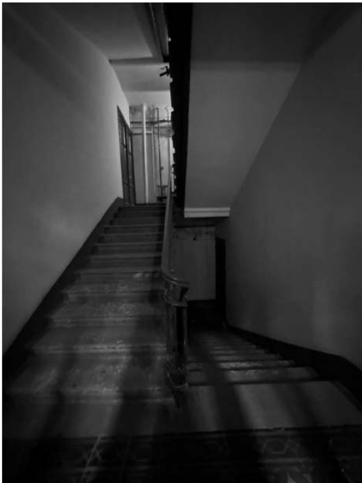
Фото 144. Вид на интерьер лестницы 3-ЛК объекта культурного наследия.
