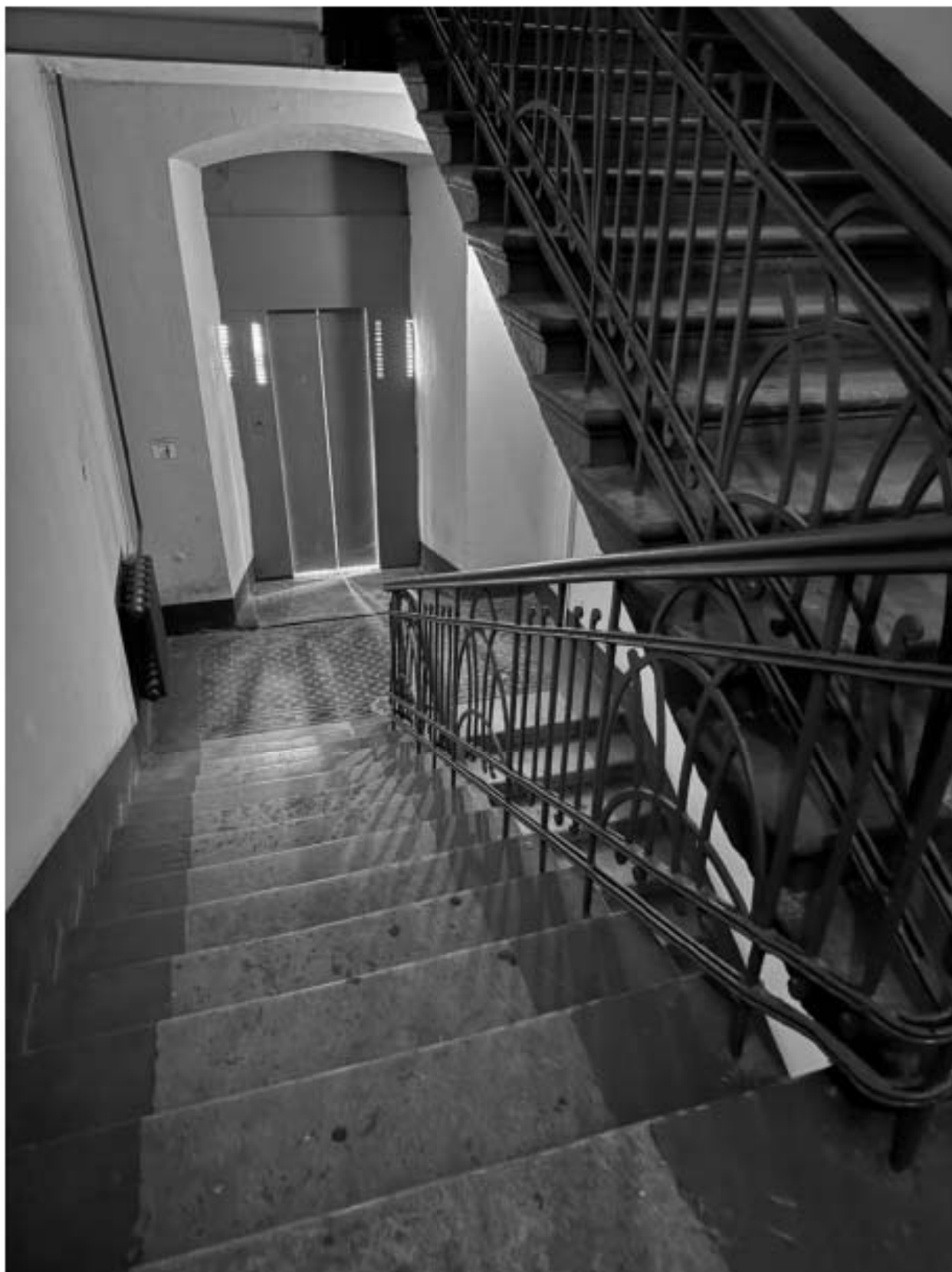
Фото 188. Вид на интерьер лестницы 1-ЛК объекта культурного наследия.
