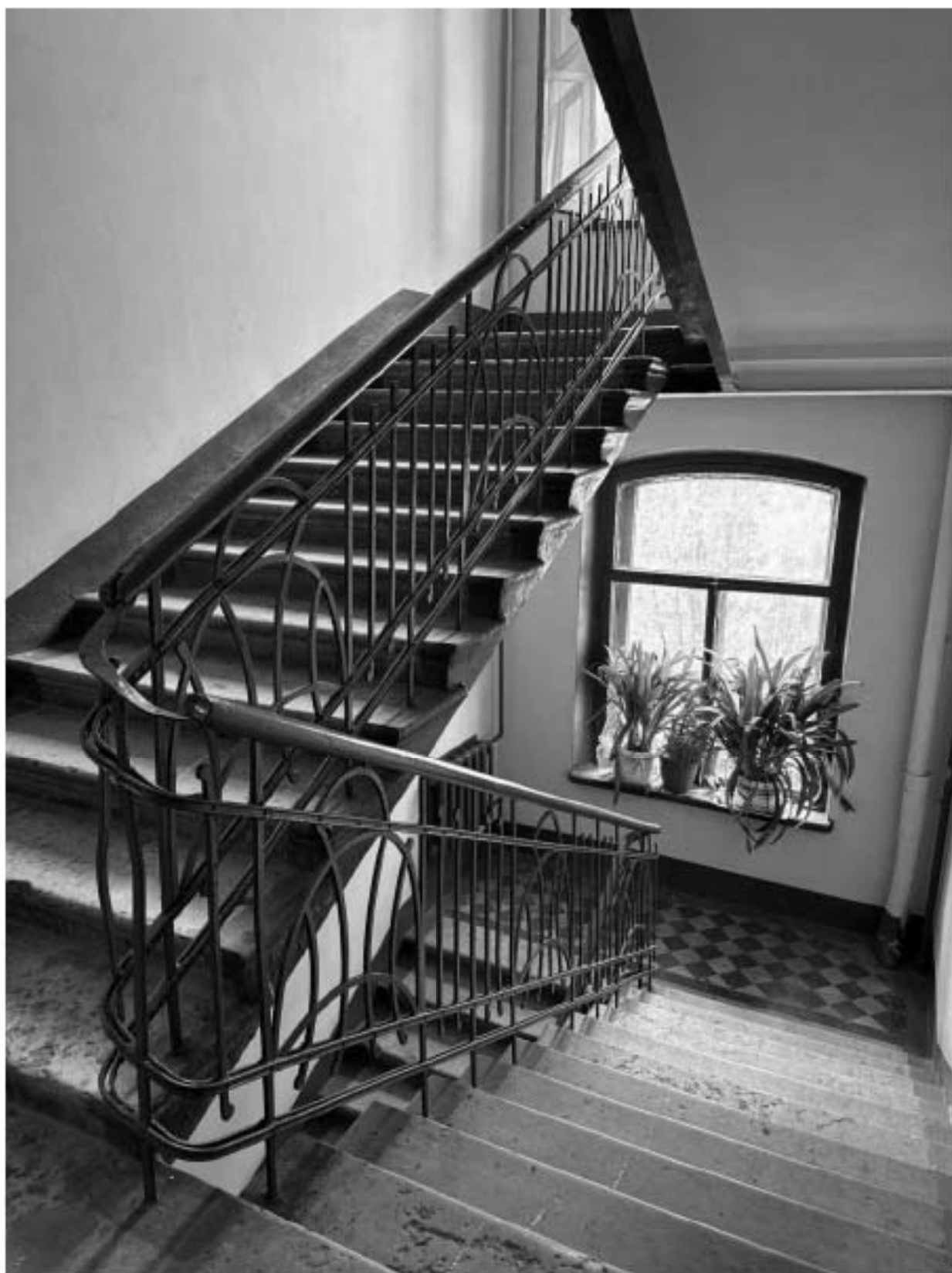
Фото 74. Вид на интерьер лестницы 6-ЛК объекта культурного наследия.
