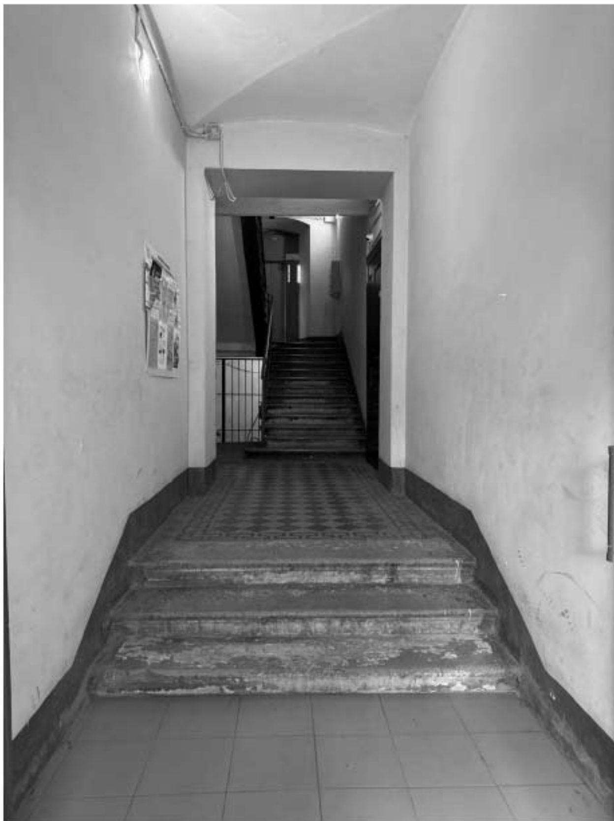
Фото 154. Вид на интерьер вестибюля лестницы 2-ЛК объекта культурного наследия.
