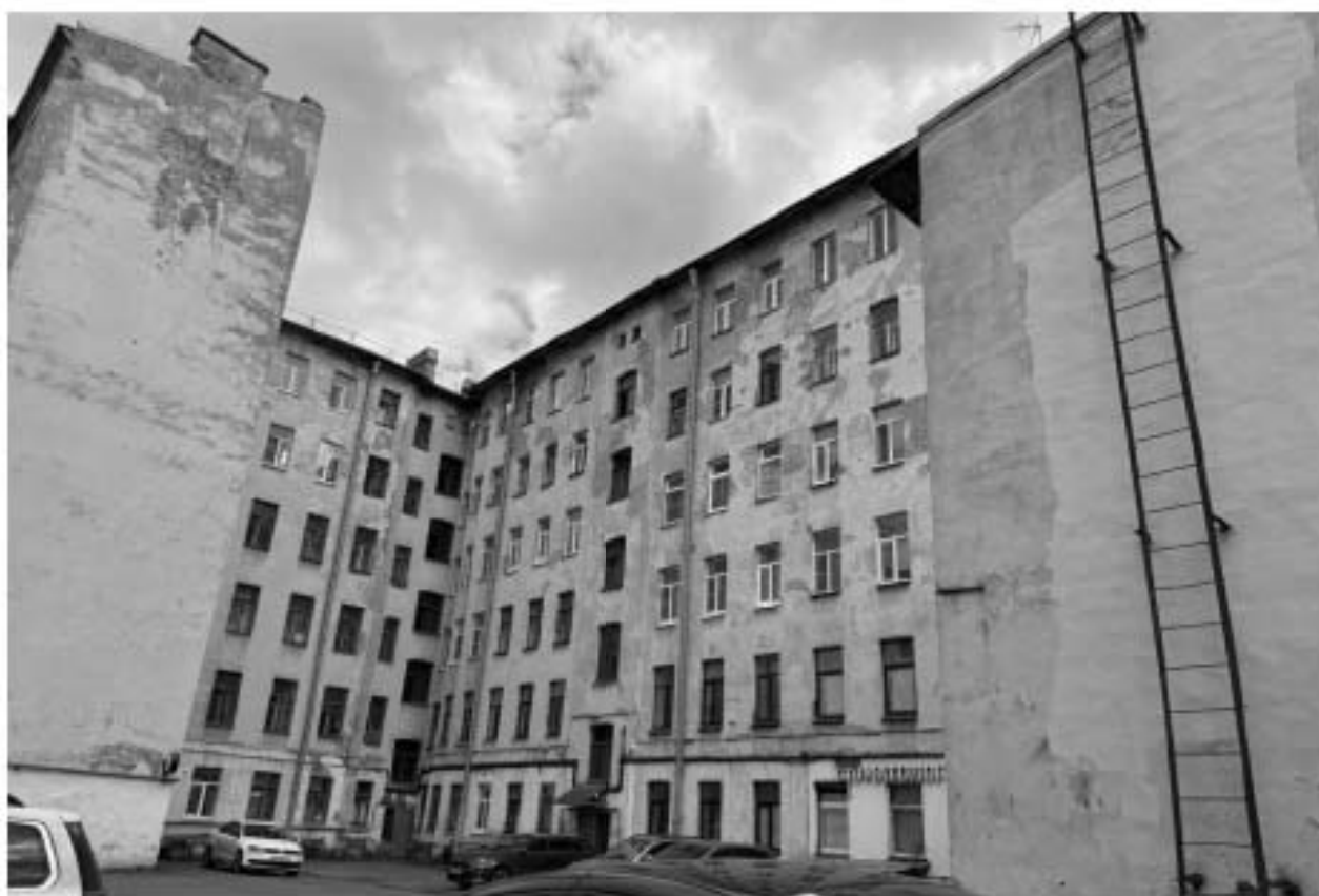
Фото 18. Вид на дворовые фасады объекта культурного наследия.
