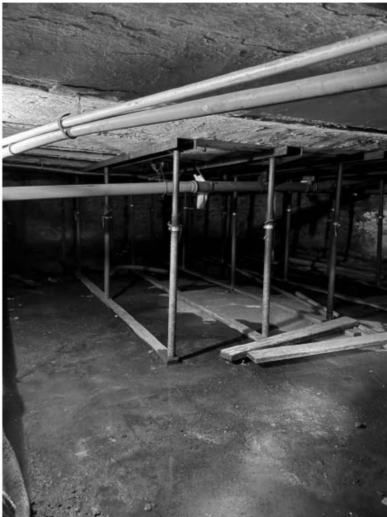
Фото 82. Вид на подвальное помещение объекта культурного наследия.
