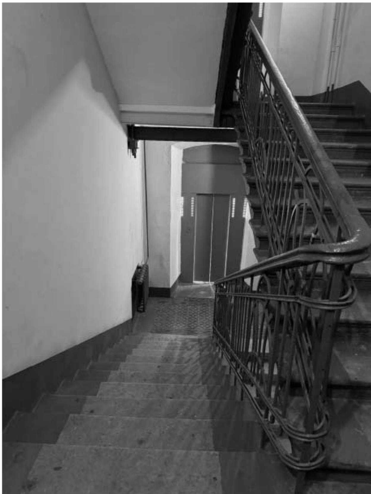
Фото 180. Вид на интерьер лестницы 1-ЛК объекта культурного наследия.
