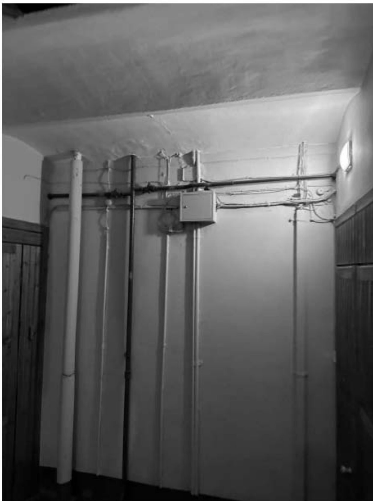
Фото 148. Вид на интерьер лестницы 3-ЛК объекта культурного наследия.
