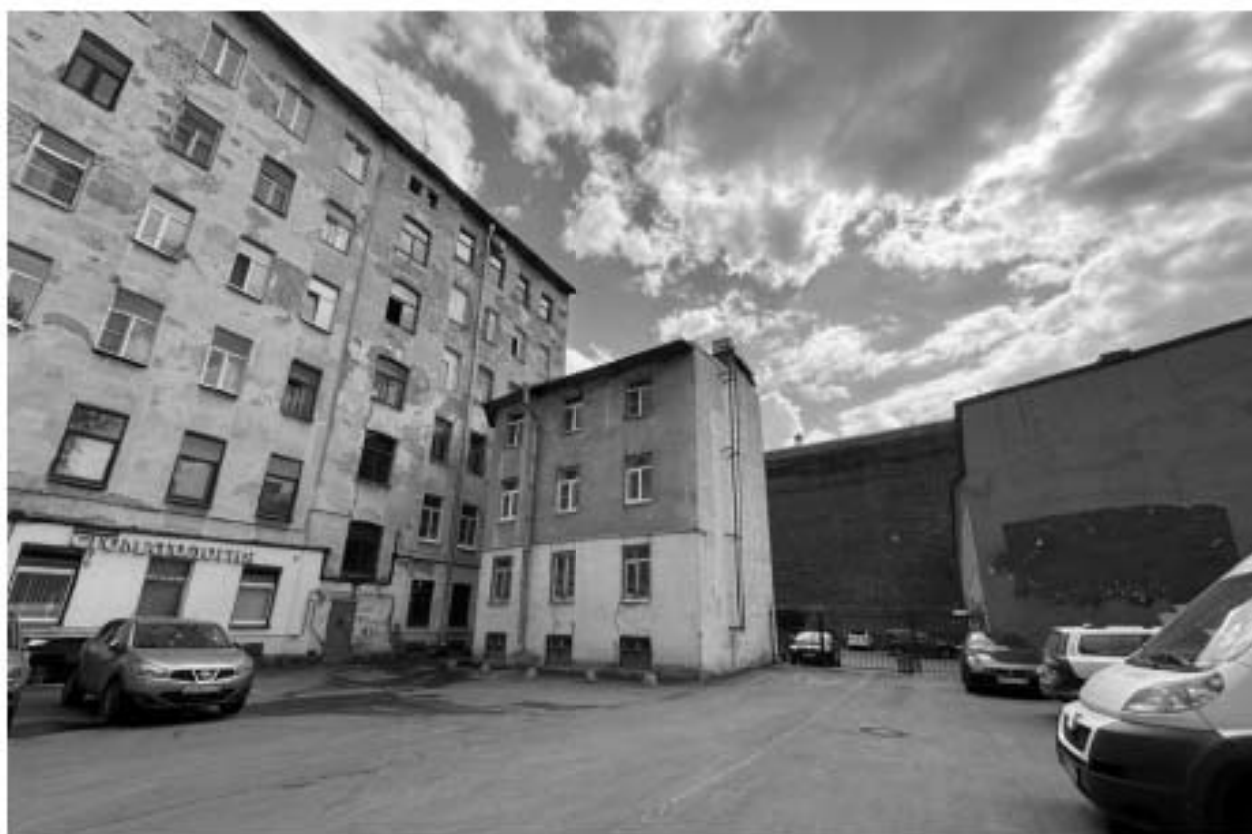
Фото 22. Вид на дворовые фасады объекта культурного наследия.
