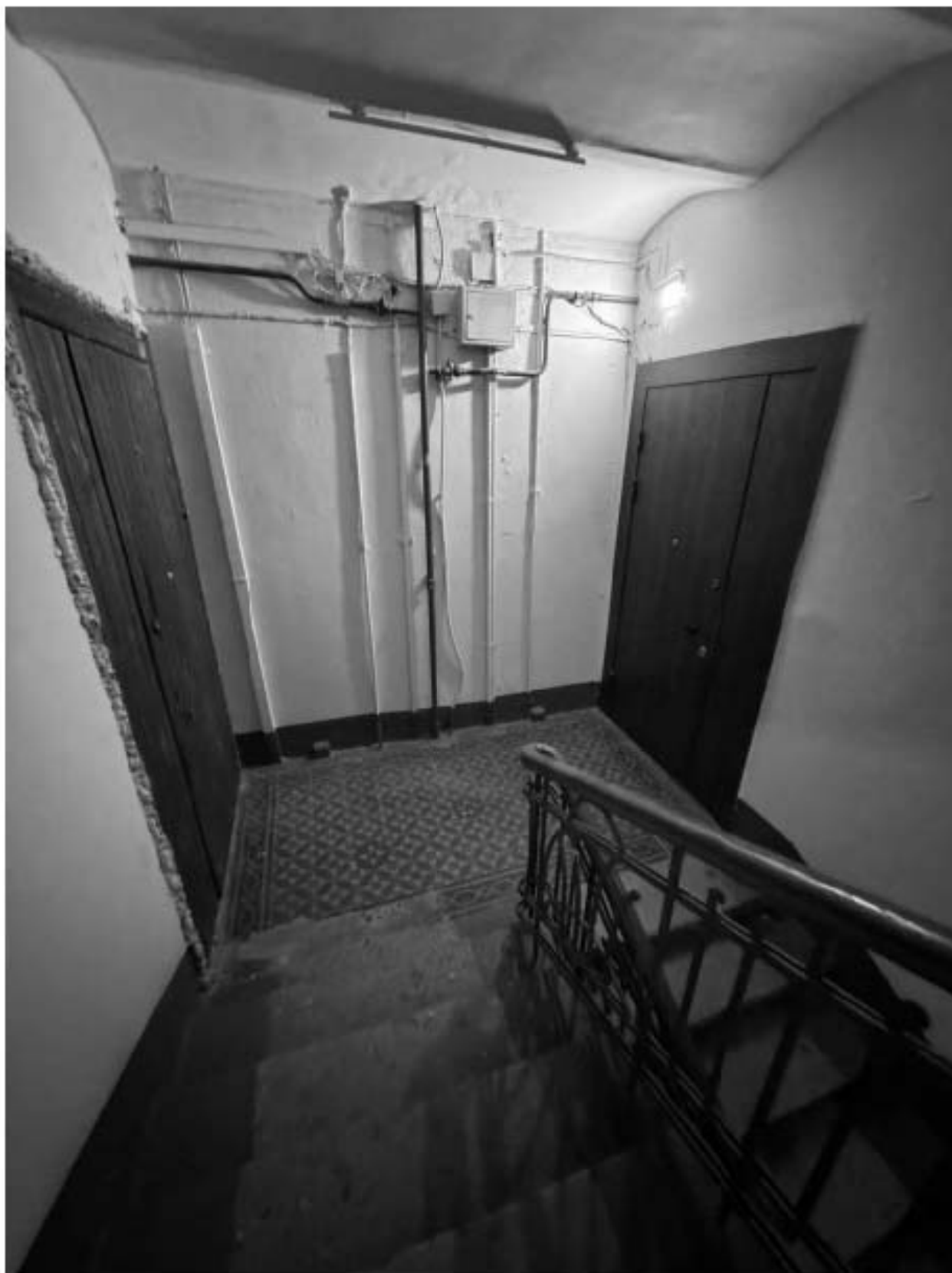
Фото 178. Вид на интерьер лестницы 1-ЛК объекта культурного наследия.
