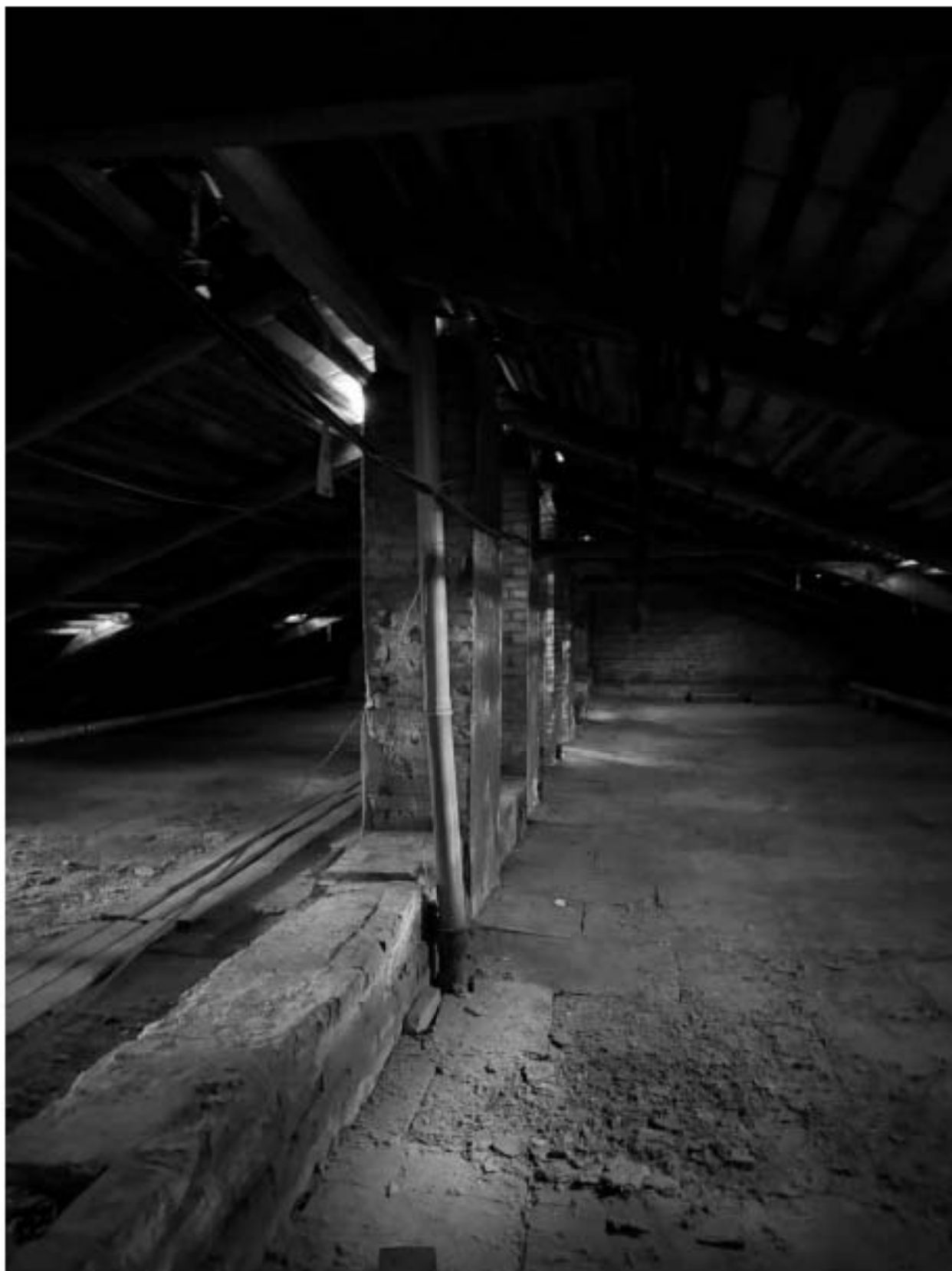
Фото 36. Вид на чердачное помещение объекта культурного наследия.
