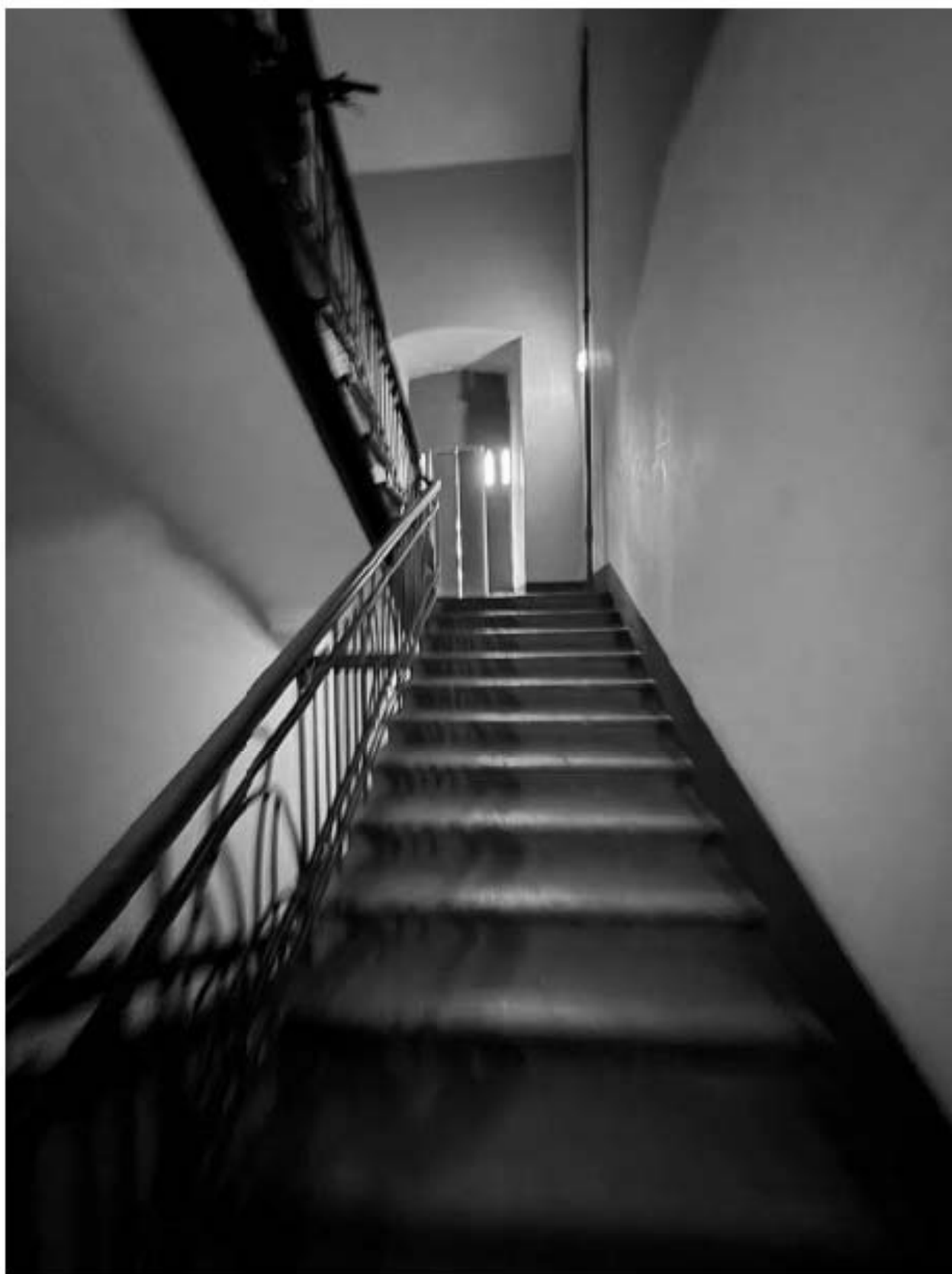
Фото 157. Вид на интерьер лестницы 2-ЛК объекта культурного наследия.
