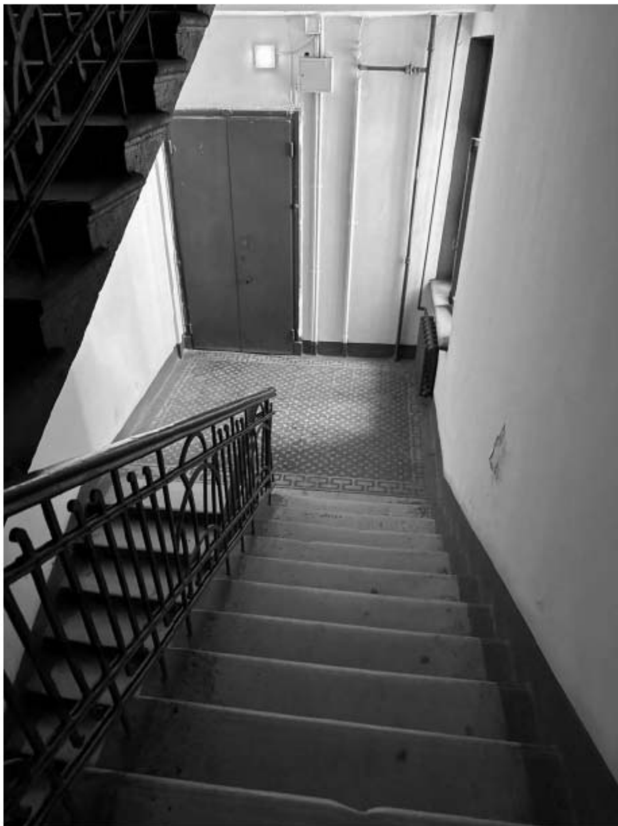
Фото 125. Вид на интерьер лестницы 4-ЛК объекта культурного наследия.
