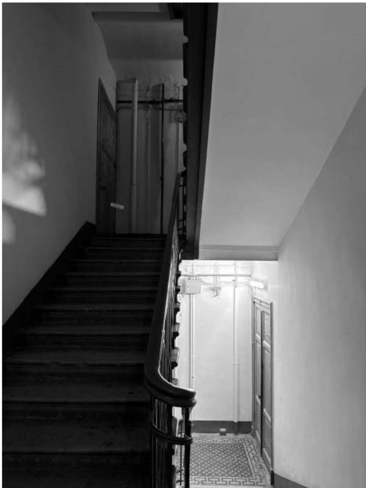
Фото 150. Вид на интерьер лестницы 3-ЛК объекта культурного наследия.
