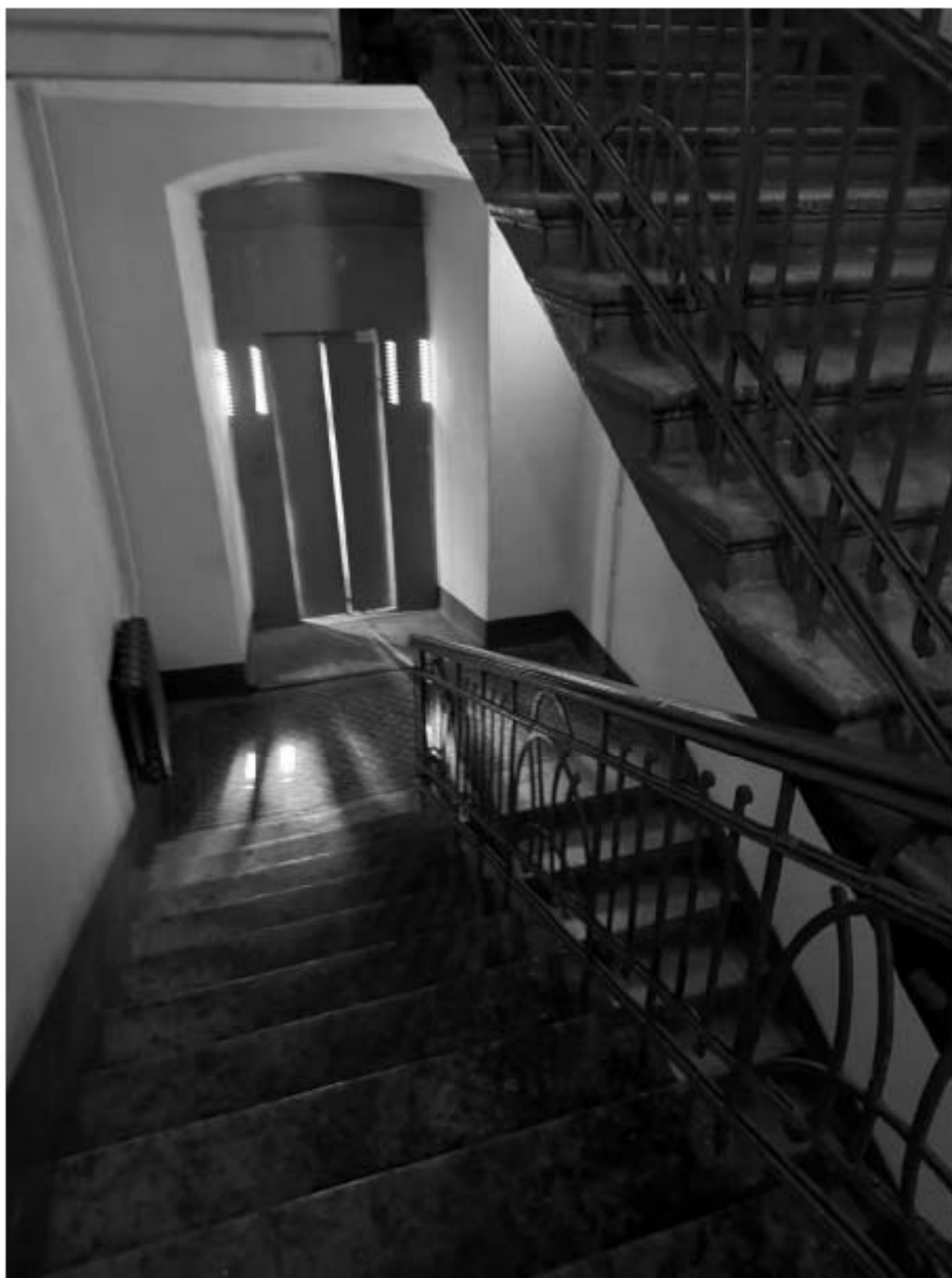
Фото 163. Вид на интерьер лестницы 2-ЛК объекта культурного наследия.
