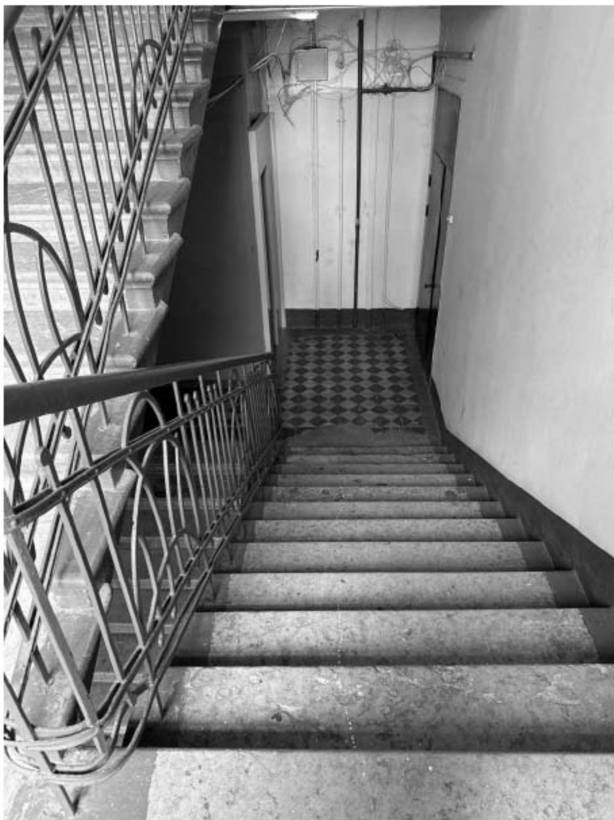
Фото 73. Вид на интерьер лестницы 6-ЛК объекта культурного наследия.
