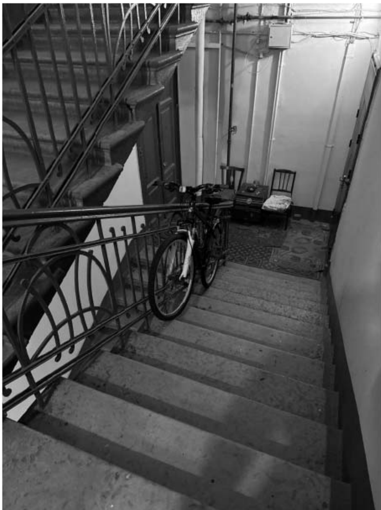
Фото 140. Вид на интерьер лестницы 3-ЛК объекта культурного наследия.
