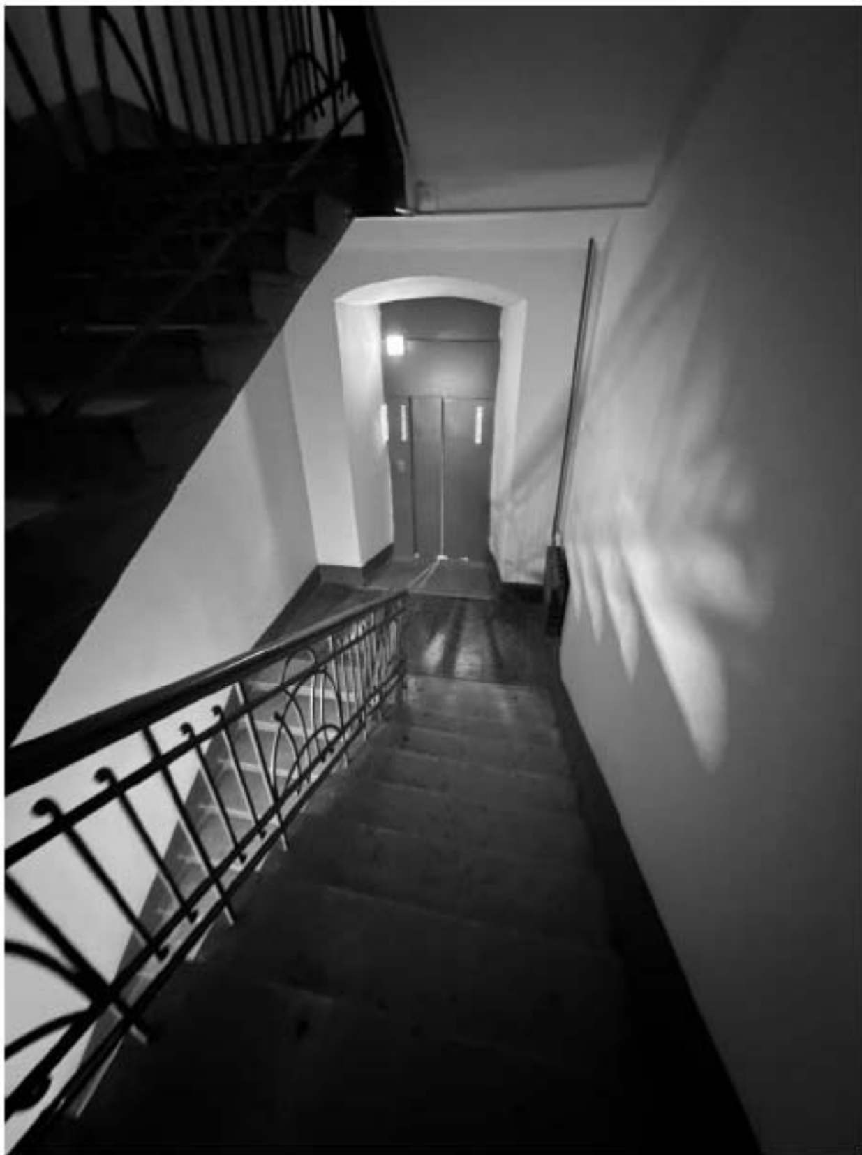
Фото 149. Вид на интерьер лестницы 3-ЛК объекта культурного наследия.
