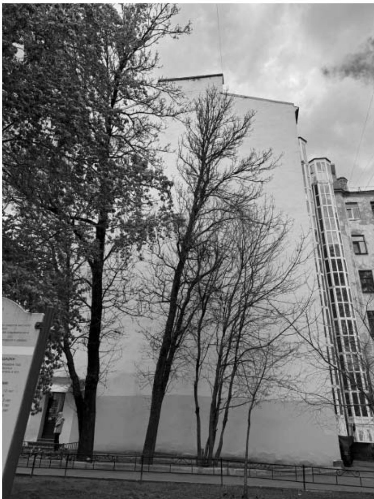
Фото 11. Фрагмент дворового фасада объекта культурного наследия.
