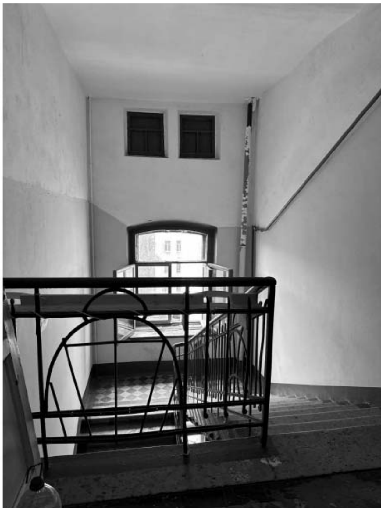
Фото 71. Вид на интерьер лестницы 6-ЛК объекта культурного наследия.
