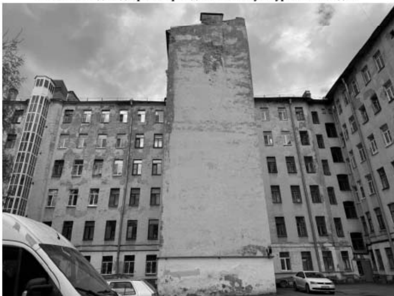
Фото 19. Вид на дворовые фасады объекта культурного наследия.
