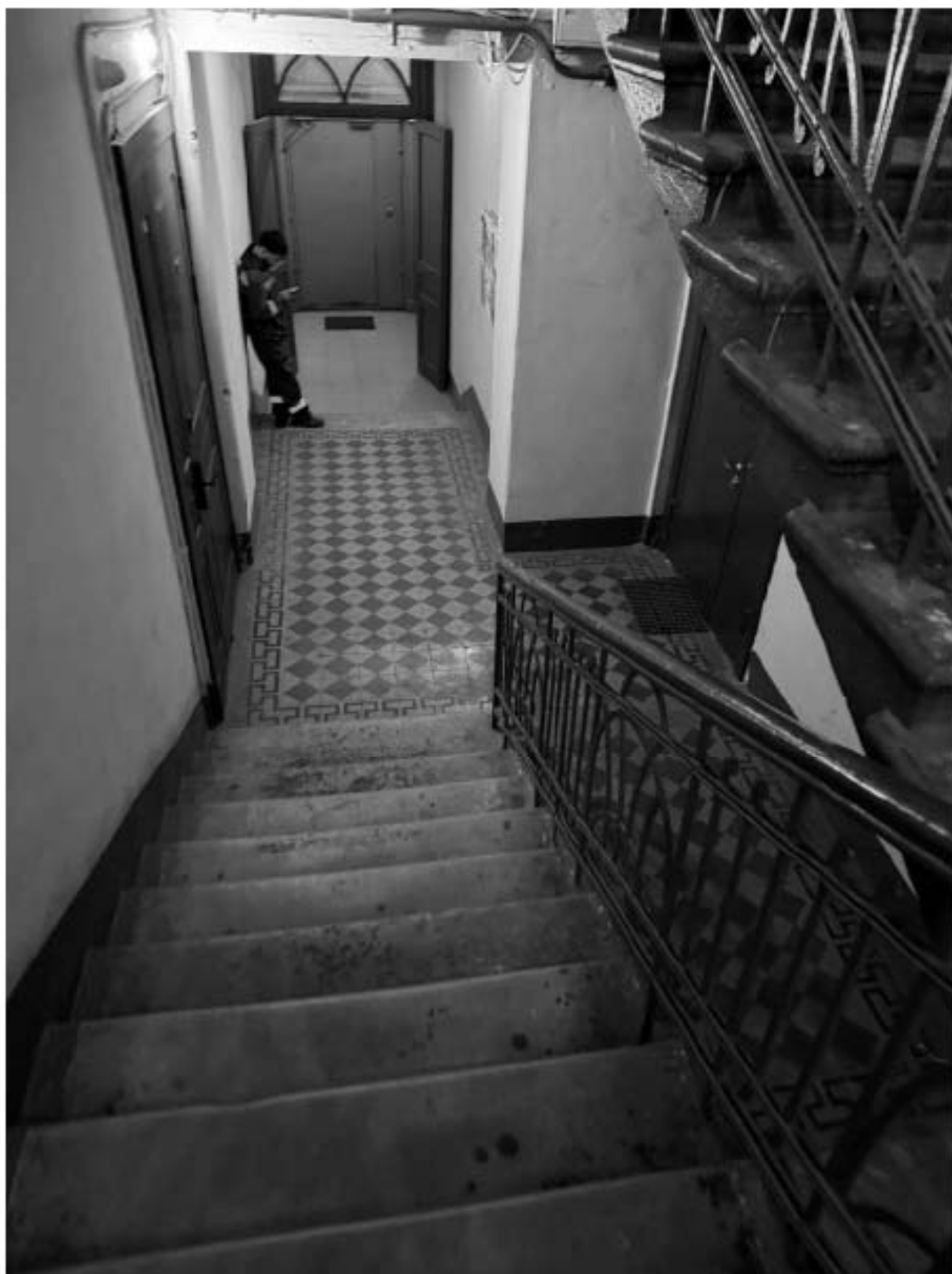
Фото 169. Вид на интерьер вестибюля лестницы 2-ЛК объекта культурного наследия.
