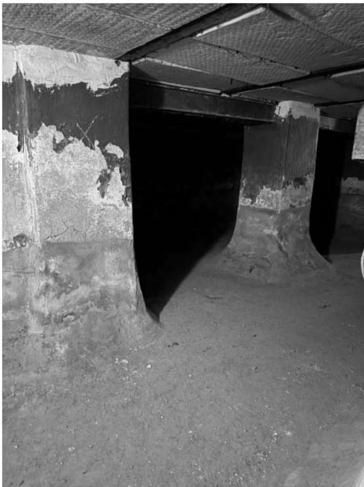
Фото 65. Вид на подвальное помещение объекта культурного наследия.
