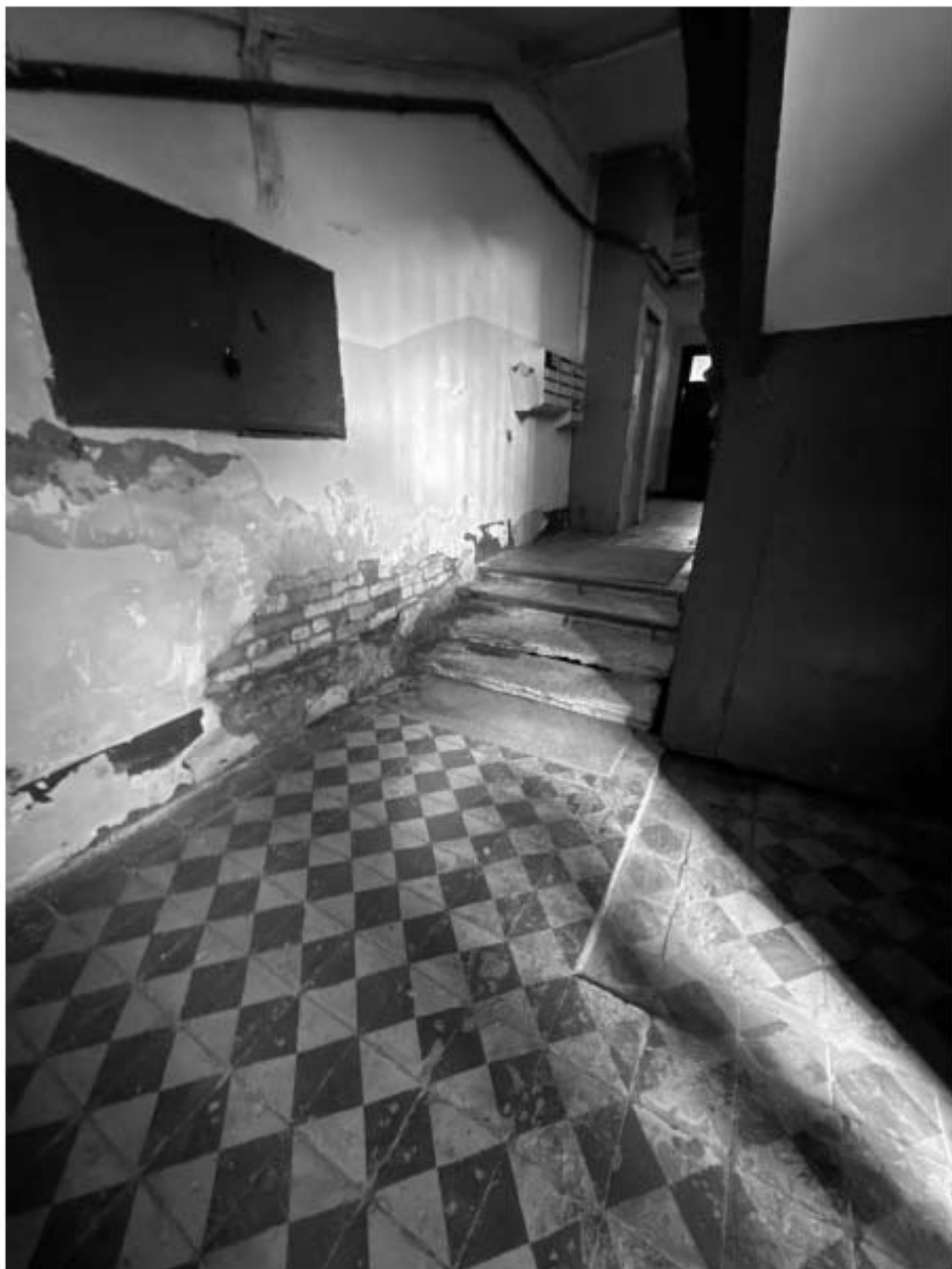
Фото 86. Вид на интерьер вестибюля лестницы 5-ЛК объекта культурного наследия.
