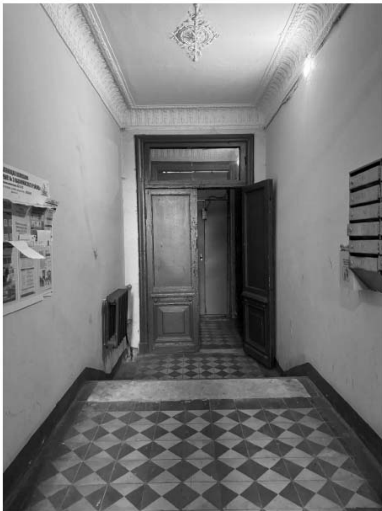
Фото 58. Вид на интерьер вестибюля лестницы 7-ЛК объекта культурного наследия.
