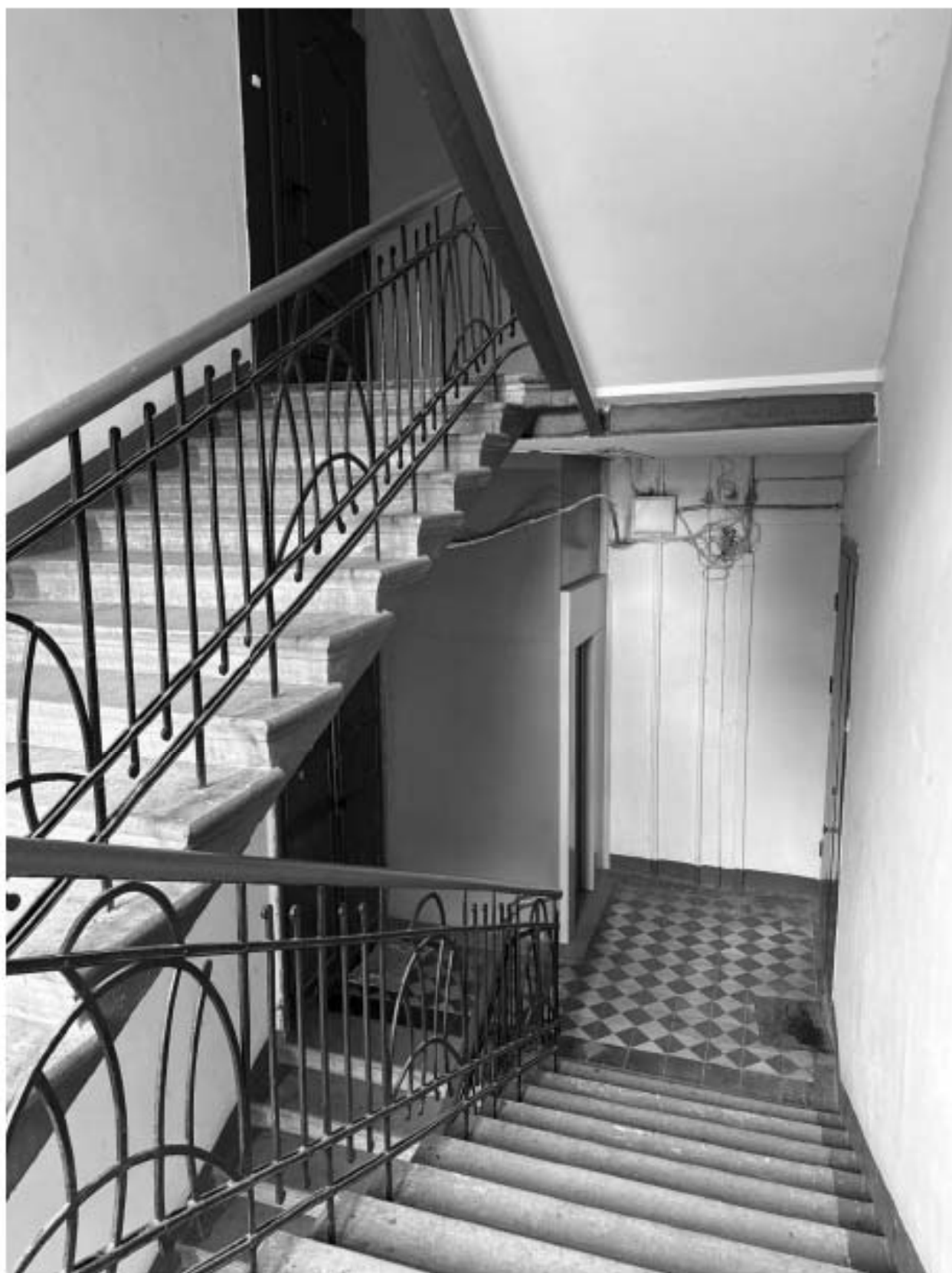
Фото 52. Вид на интерьер лестницы 7-ЛК объекта культурного наследия.
