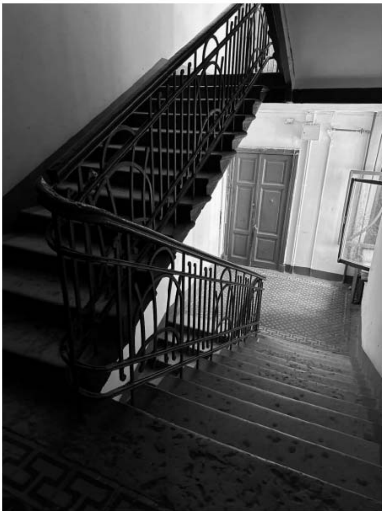
Фото 121. Вид на интерьер лестницы 4-ЛК объекта культурного наследия.
