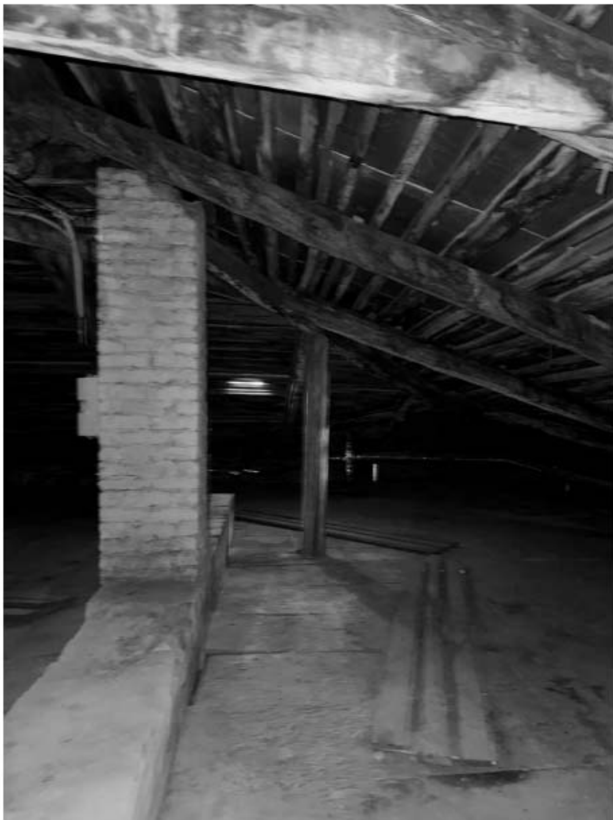
Фото 34. Вид на чердачное помещение объекта культурного наследия.
