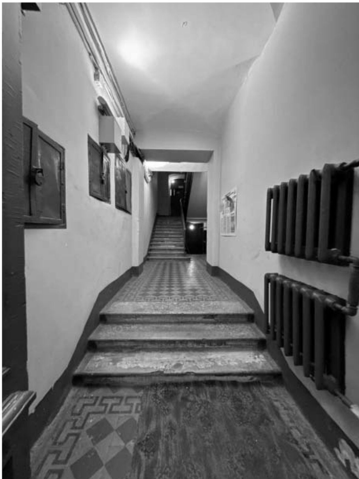
Фото 134. Вид на интерьер вестибюля лестницы 3-ЛК объекта культурного наследия.
