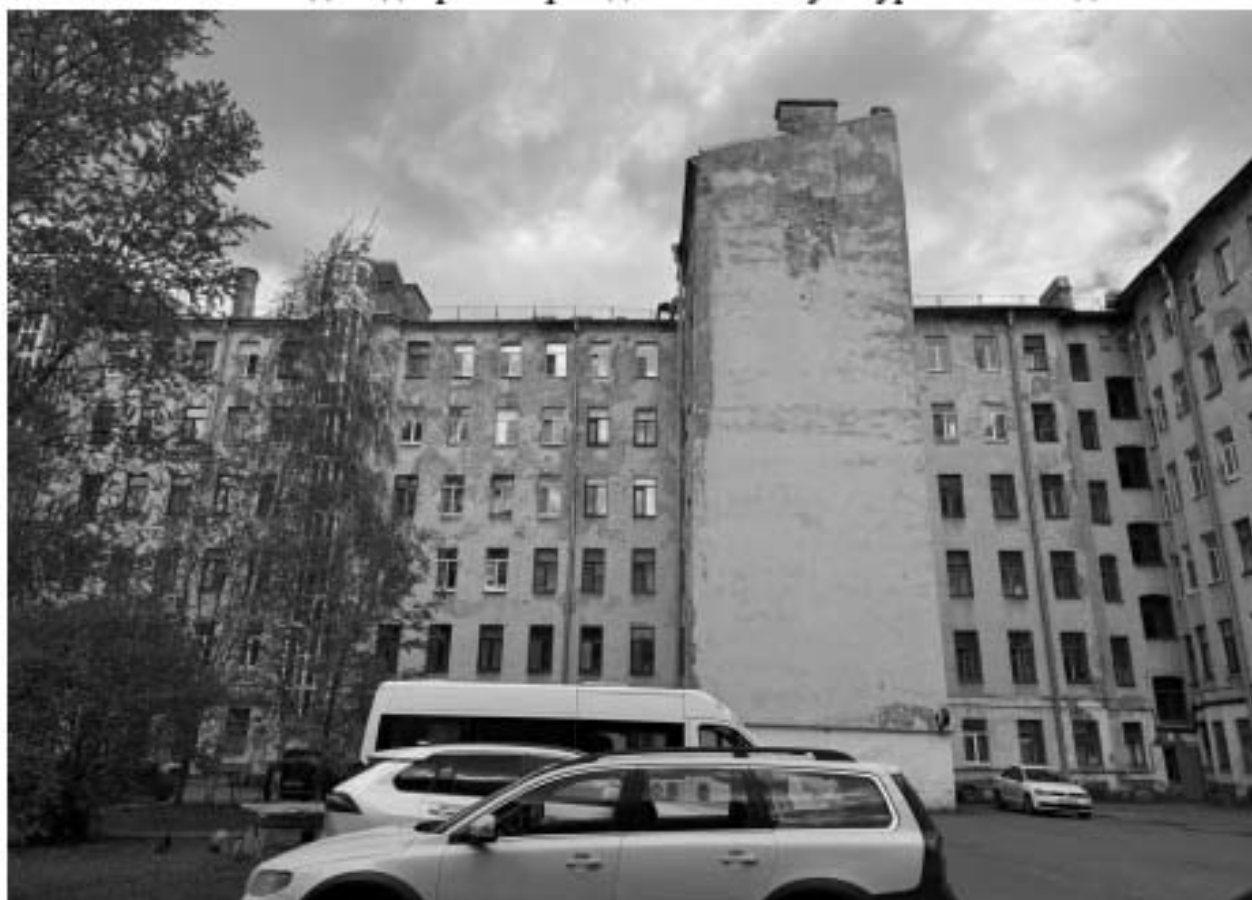
Фото 17. Вид на дворовые фасады объекта культурного наследия.
