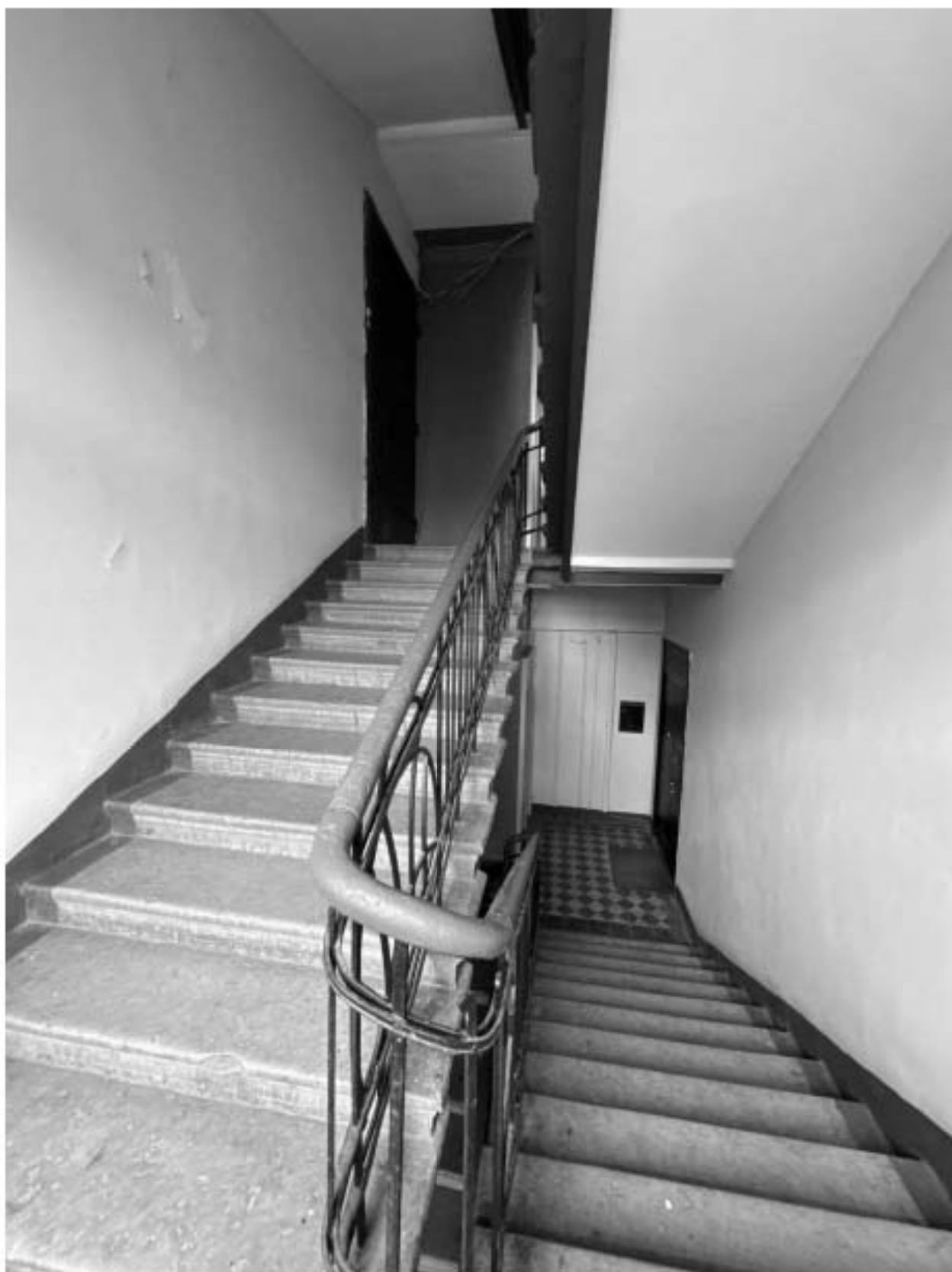
Фото 49. Вид на интерьер лестницы 7-ЛК объекта культурного наследия.
