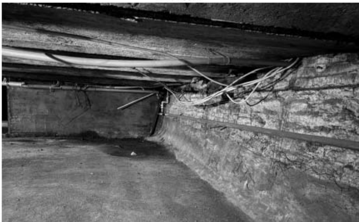
Фото 62. Вид на интерьер подвальных помещений объекта культурного наследия.
