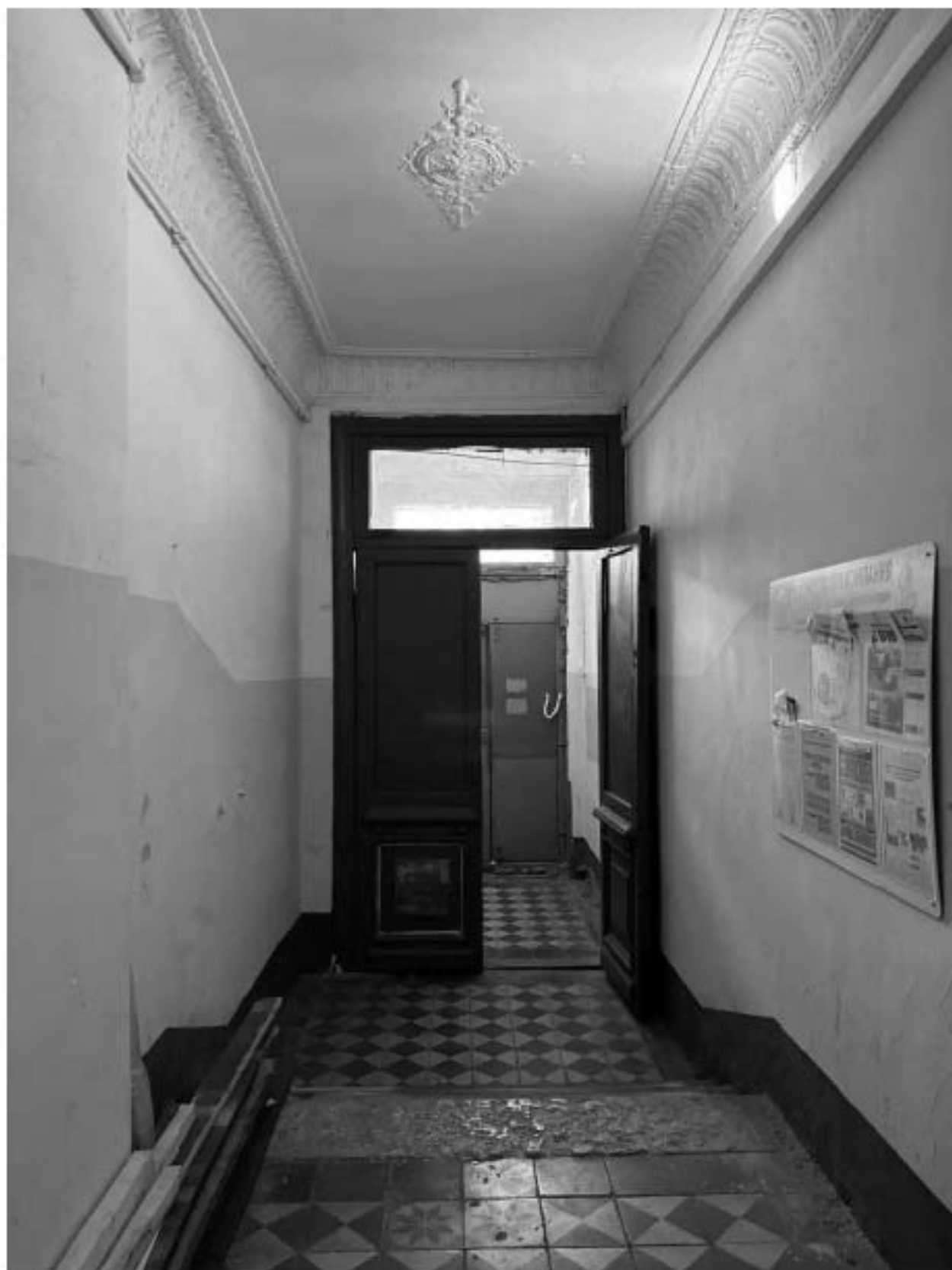
Фото 87. Вид на интерьер вестибюля лестницы 5-ЛК объекта культурного наследия.
