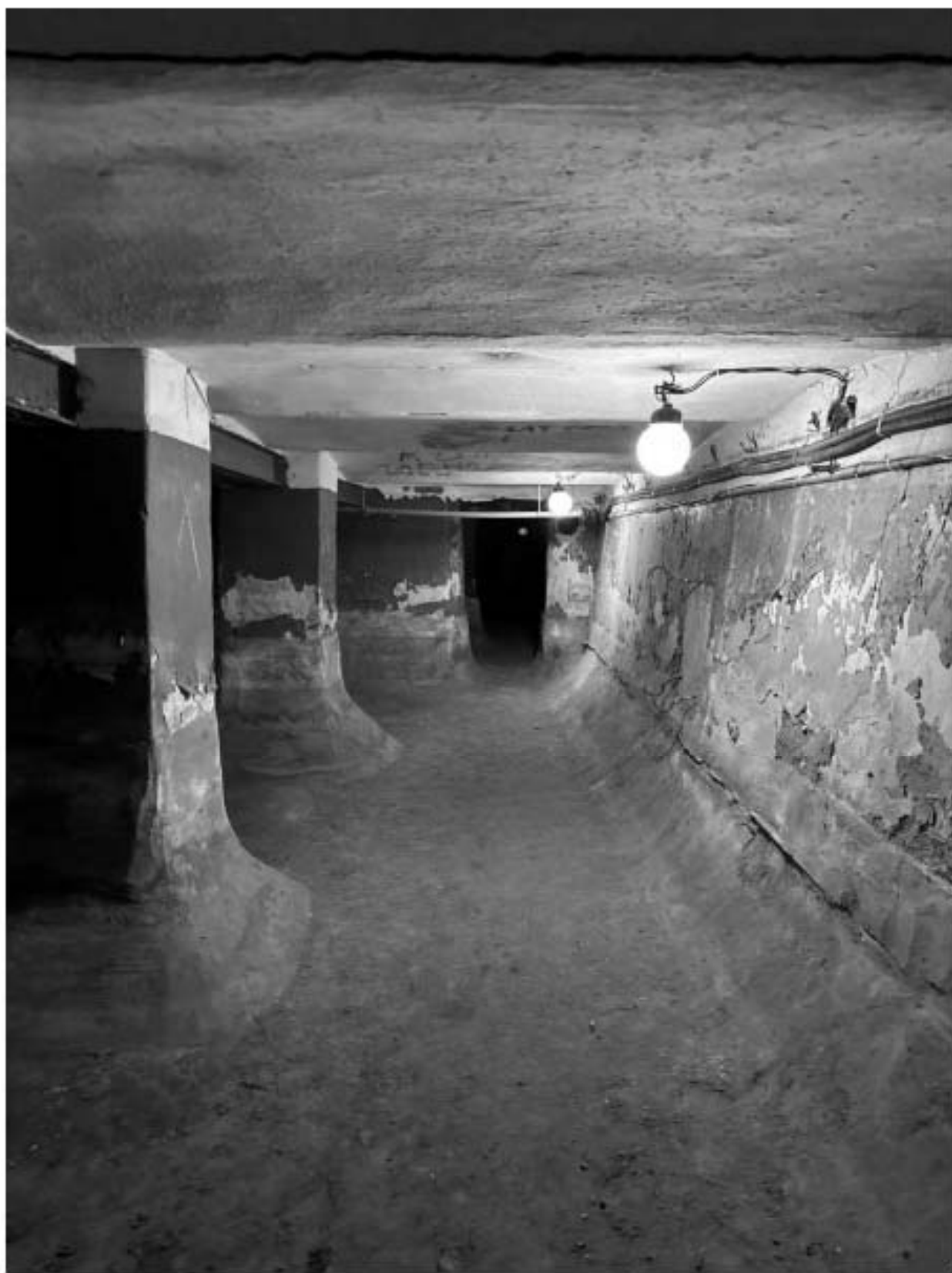
Фото 67. Вид на подвальное помещение объекта культурного наследия.
