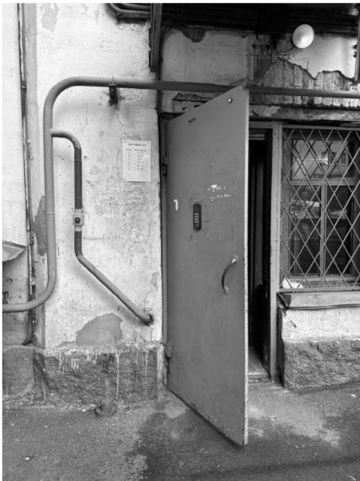
Фото 63. Вид на входное заполнение лестницы 6-ЛК объекта культурного наследия.
