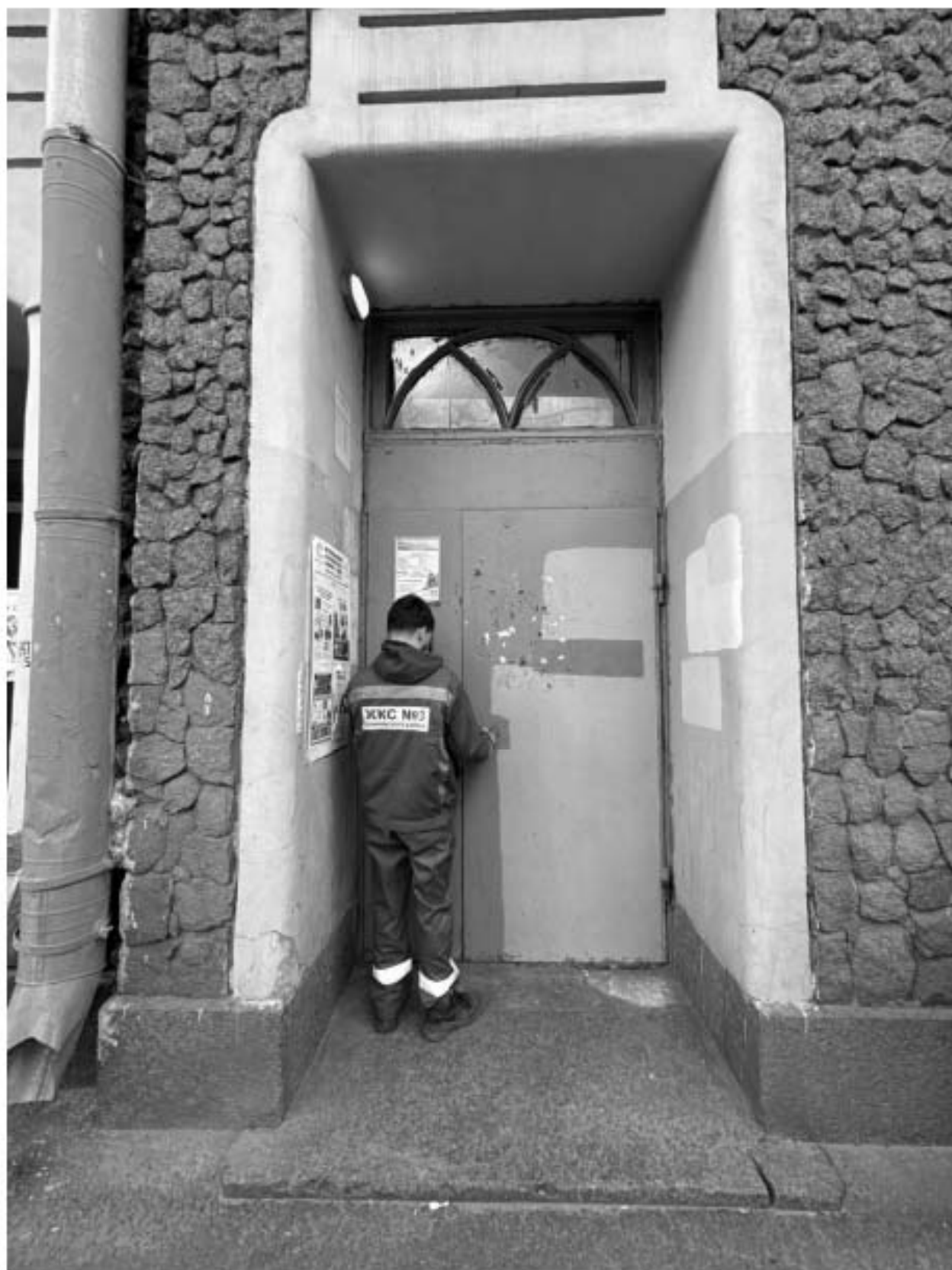
Фото 132. Вид на входное дверное заполнение лестницы 3-ЛК объекта культурного наследия.
