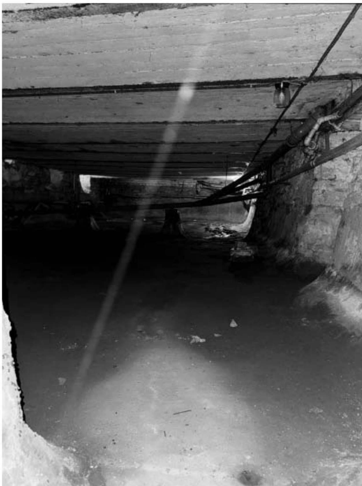
Фото 111. Вид на подвальное помещение объекта культурного наследия.
