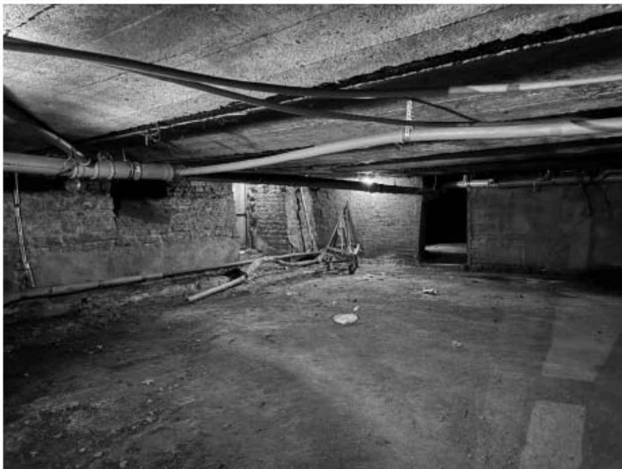
Фото 61. Вид на интерьер подвальных помещений объекта культурного наследия.
