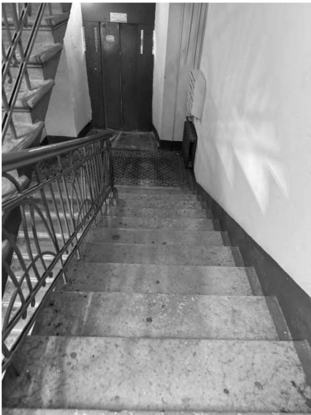
Фото 152. Вид на интерьер лестницы 3-ЛК объекта культурного наследия.
