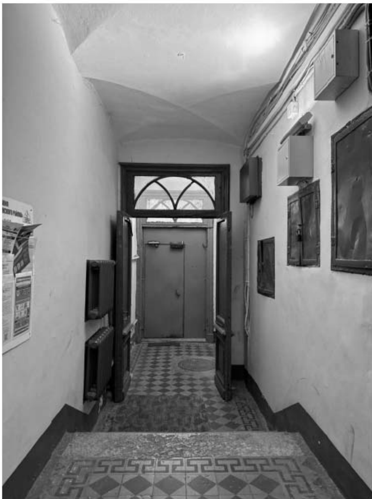
Фото 135. Вид на интерьер вестибюля лестницы 3-ЛК объекта культурного наследия.
