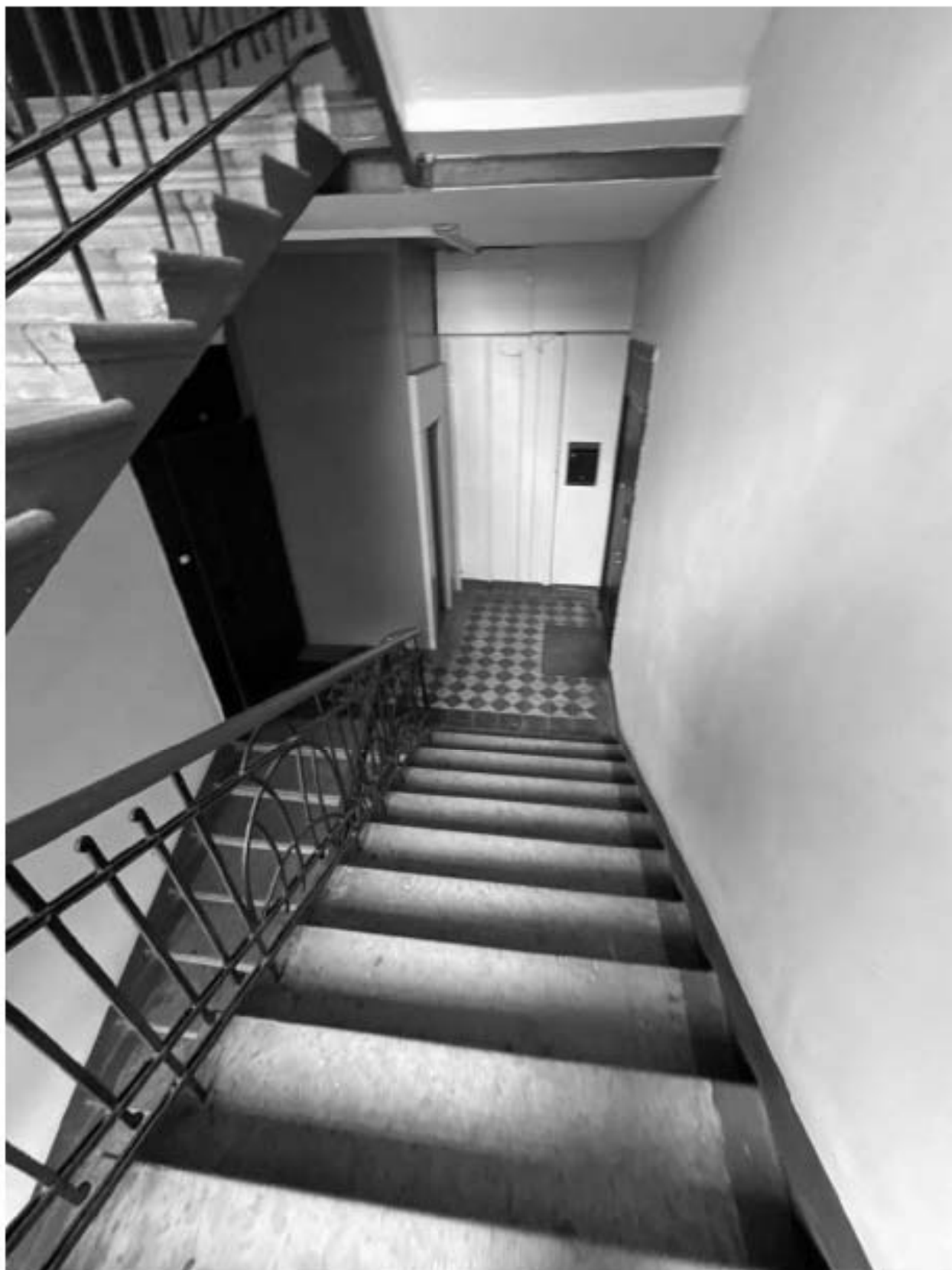
Фото 50. Вид на интерьер лестницы 7-ЛК объекта культурного наследия.
