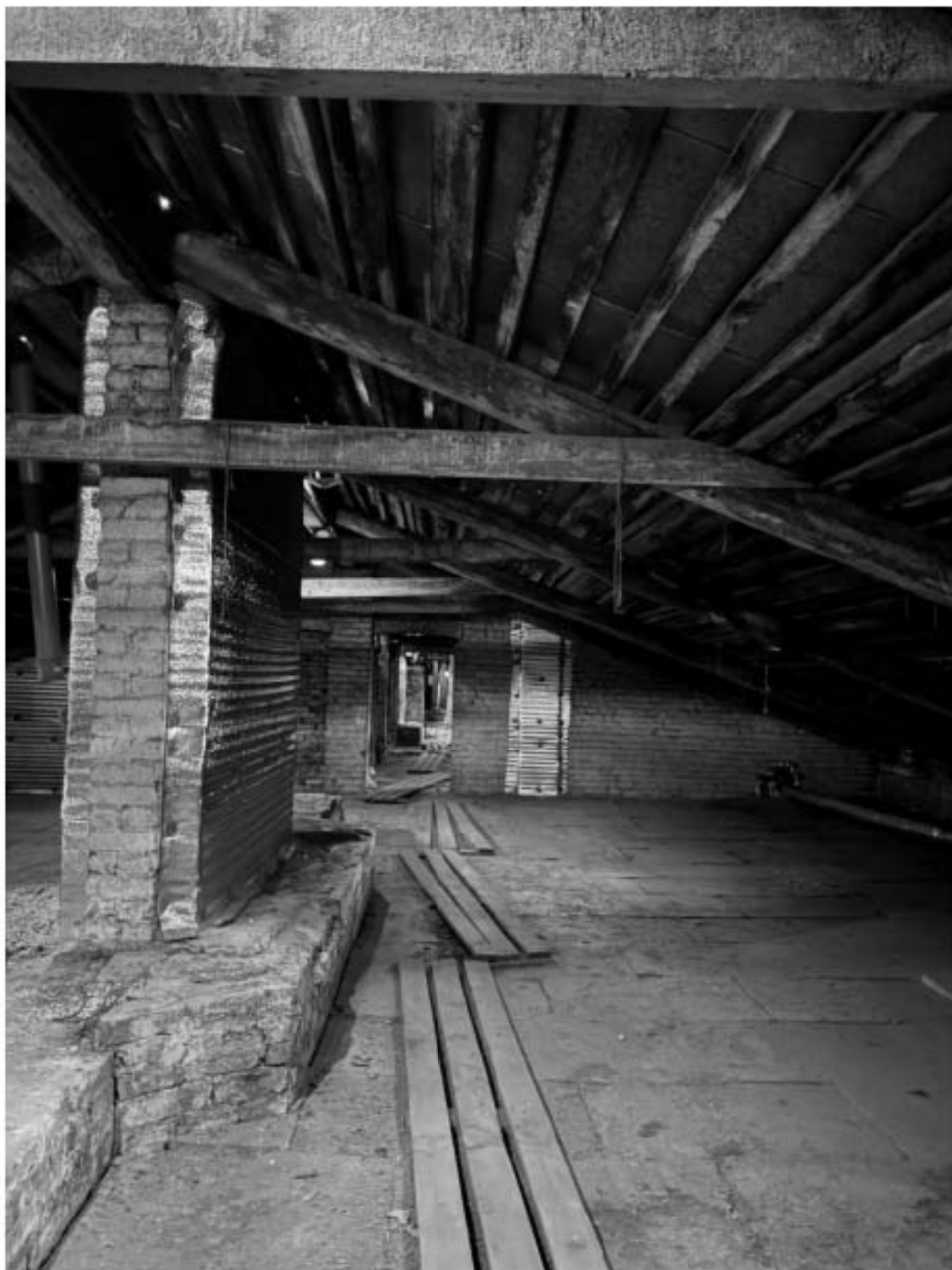
Фото 32. Вид на чердачное помещение объекта культурного наследия.
