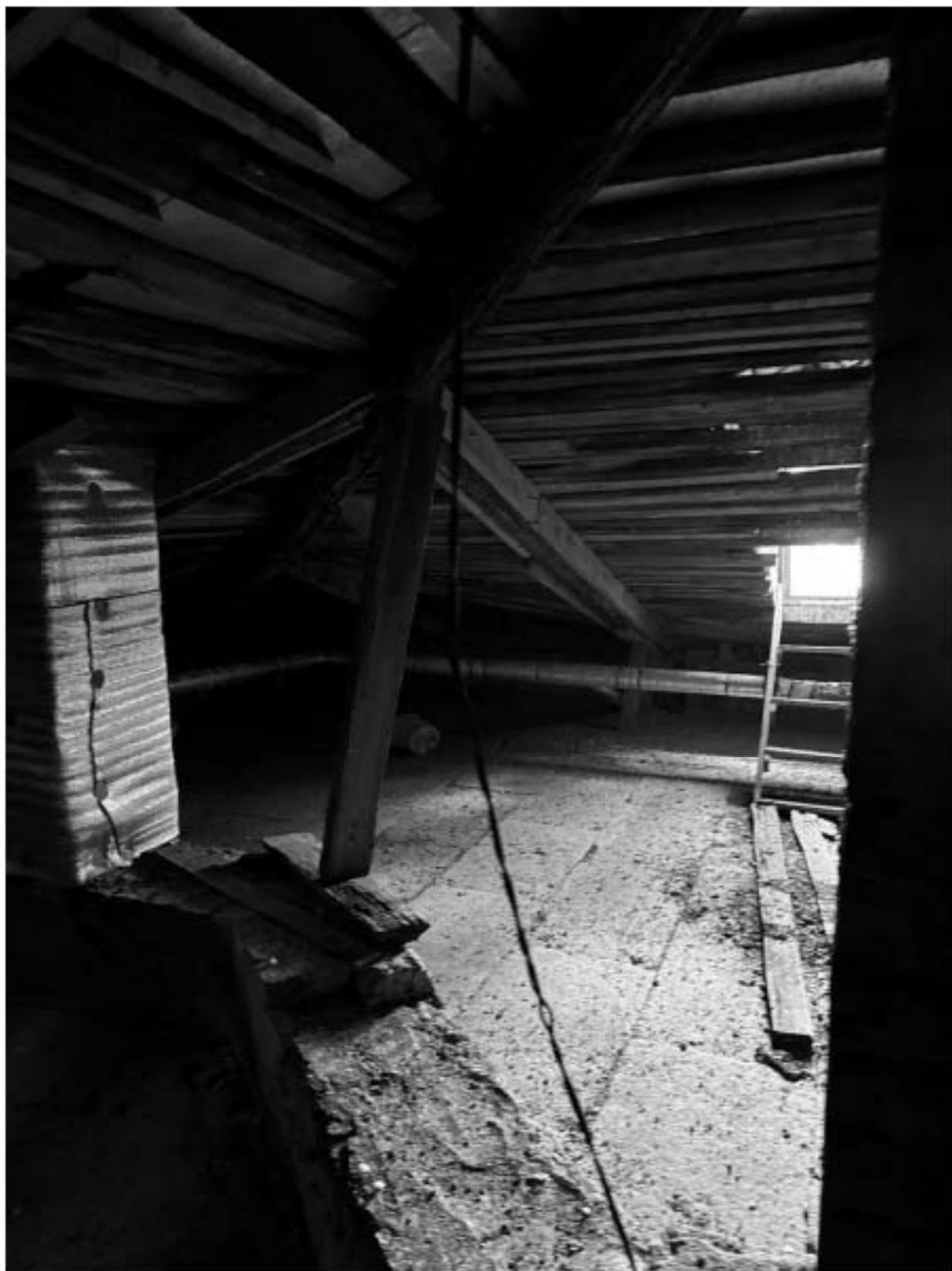
Фото 43. Вид на чердачное помещение объекта культурного наследия.
