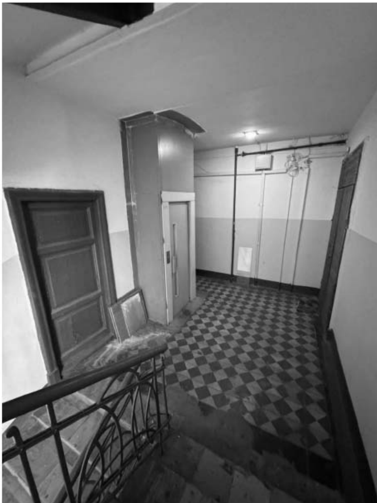
Фото 92. Вид на интерьер лестницы 5-ЛК объекта культурного наследия.
