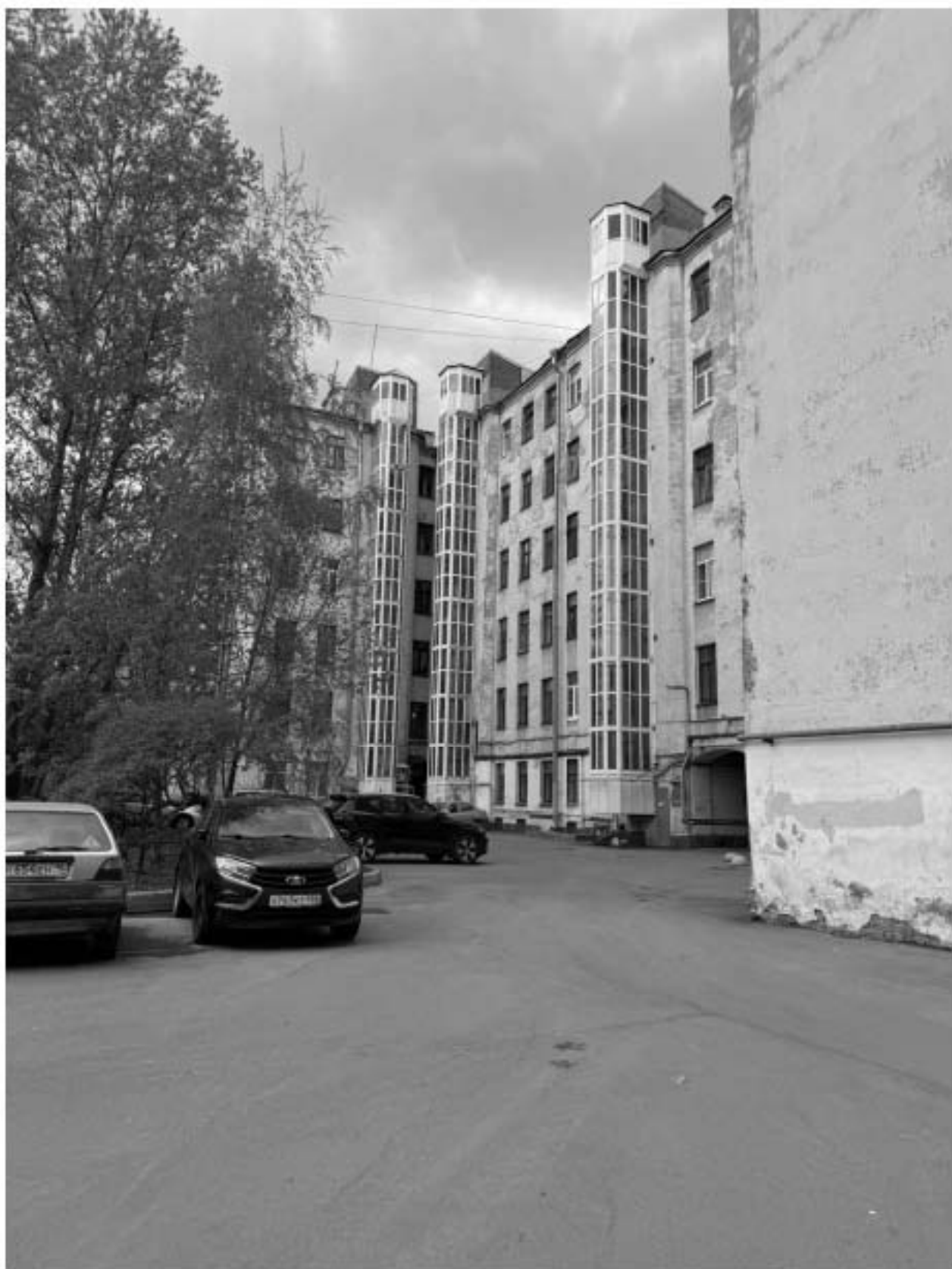
Фото 23. Вид на дворовые фасады объекта культурного наследия.
