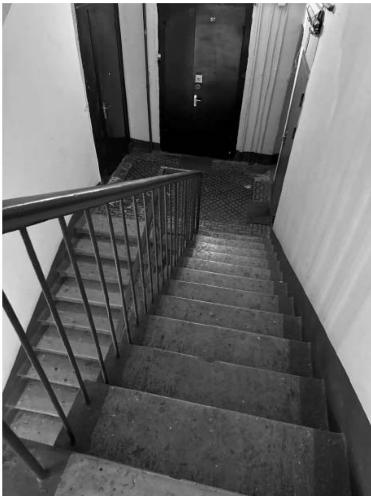
Фото 117. Вид на интерьер лестницы 4-ЛК объекта культурного наследия.
