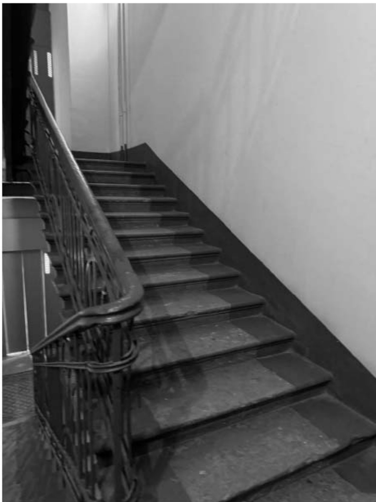
Фото 179. Вид на интерьер лестницы 1-ЛК объекта культурного наследия.
