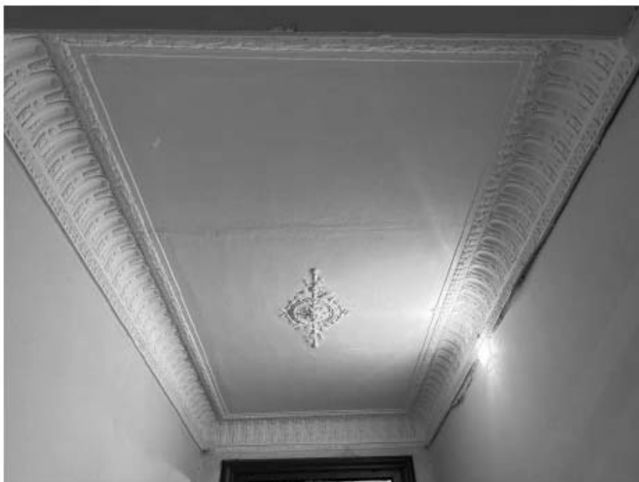
Фото 59. Вид на потолок вестибюля лестницы 7-ЛК объекта культурного наследия.
