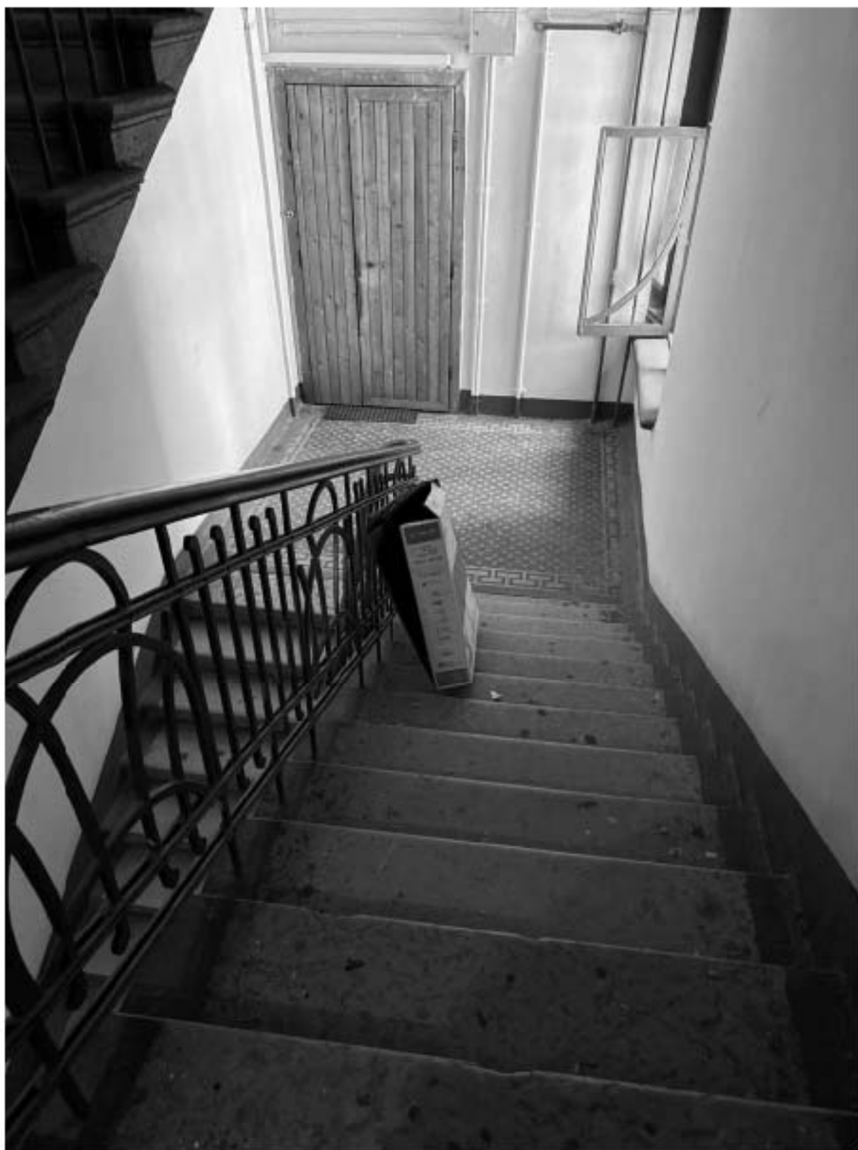
Фото 118. Вид на интерьер лестницы 4-ЛК объекта культурного наследия.
