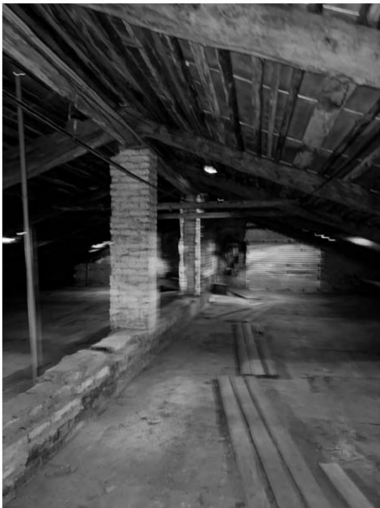
Фото 35. Вид на чердачное помещение объекта культурного наследия.
