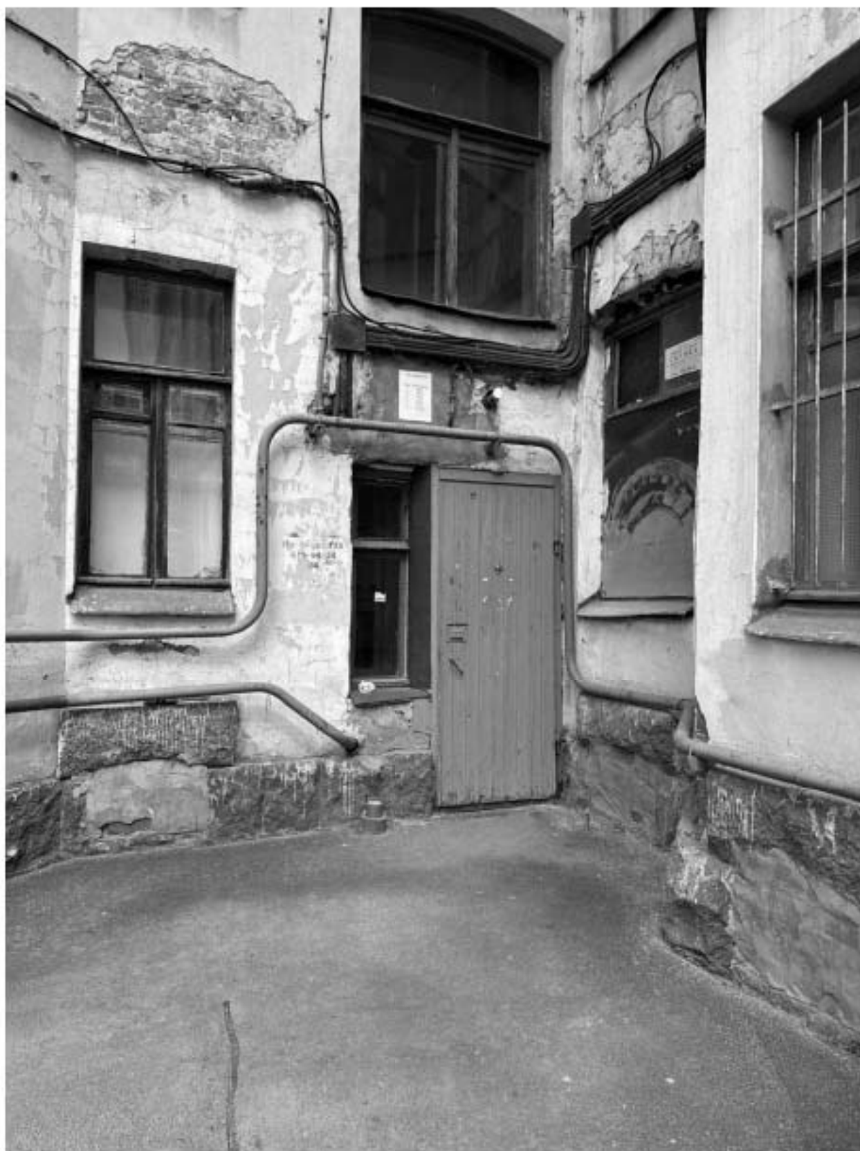
Фото 85. Вид на входное заполнение на лестницу 5-ЛК объекта культурного наследия.
