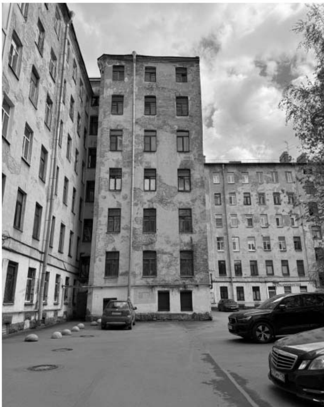
Фото 25. Вид на дворовые фасады объекта культурного наследия.
