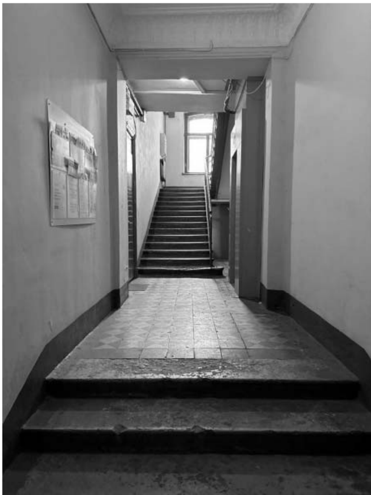
Фото 70. Вид на интерьер вестибюля лестницы 6-ЛК объекта культурного наследия.
