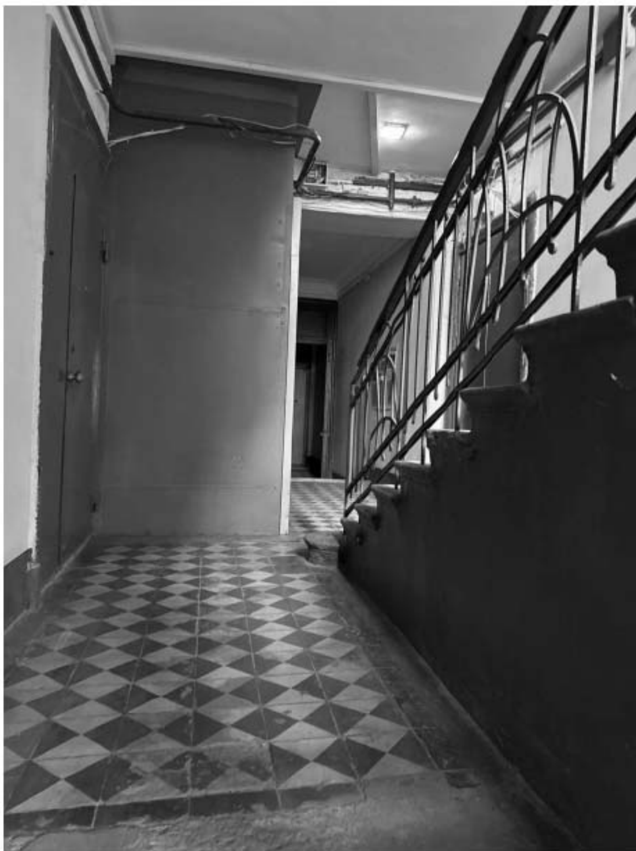
Фото 68. Вид на интерьер вестибюля лестницы 6-ЛК объекта культурного наследия.
