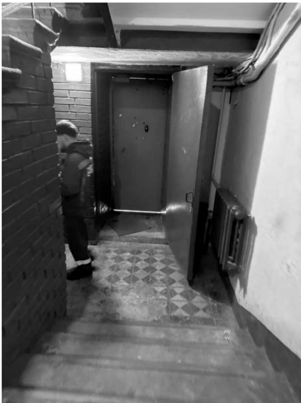
Фото 60. Вид на интерьер лестницы 7-ЛК объекта культурного наследия.
