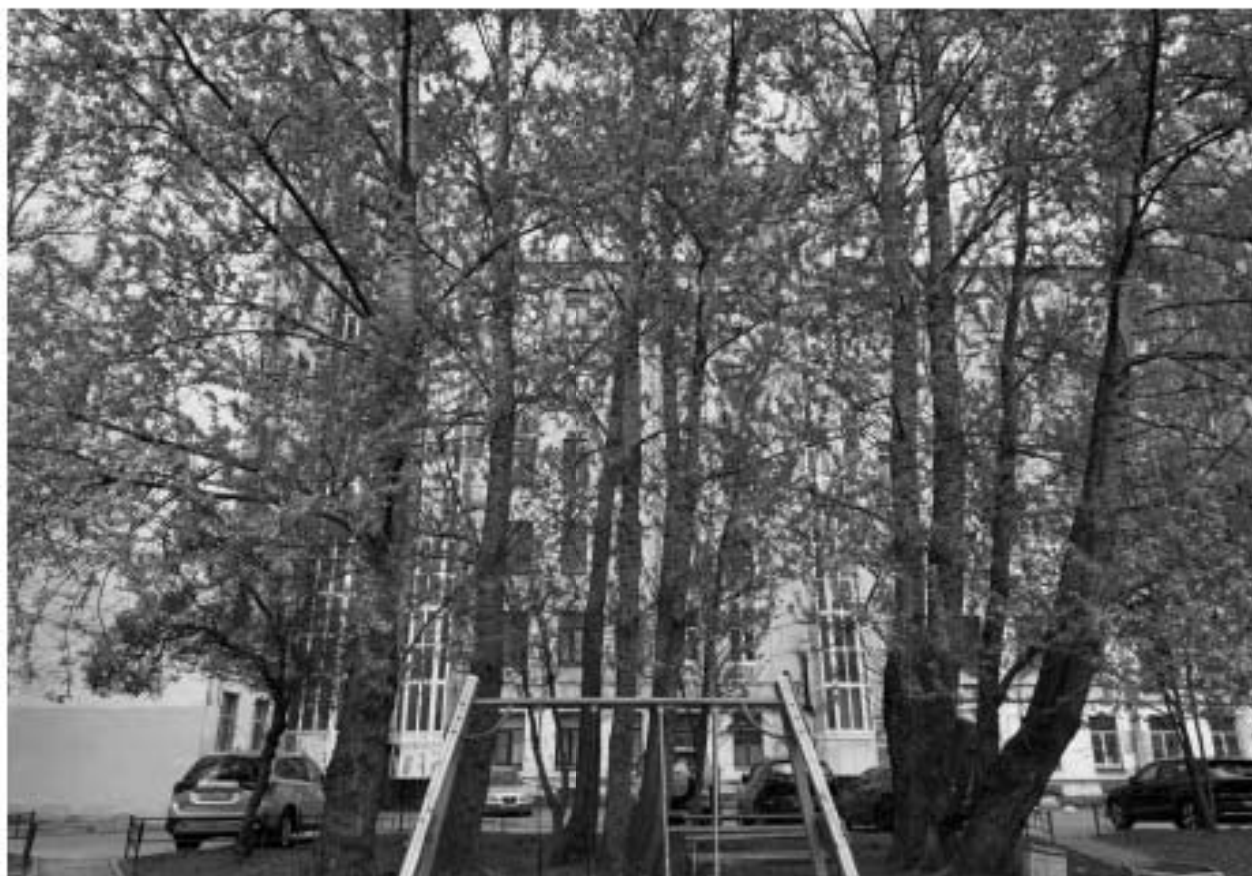
Фото 14. Вид на дворовые фасады объекта культурного наследия.
