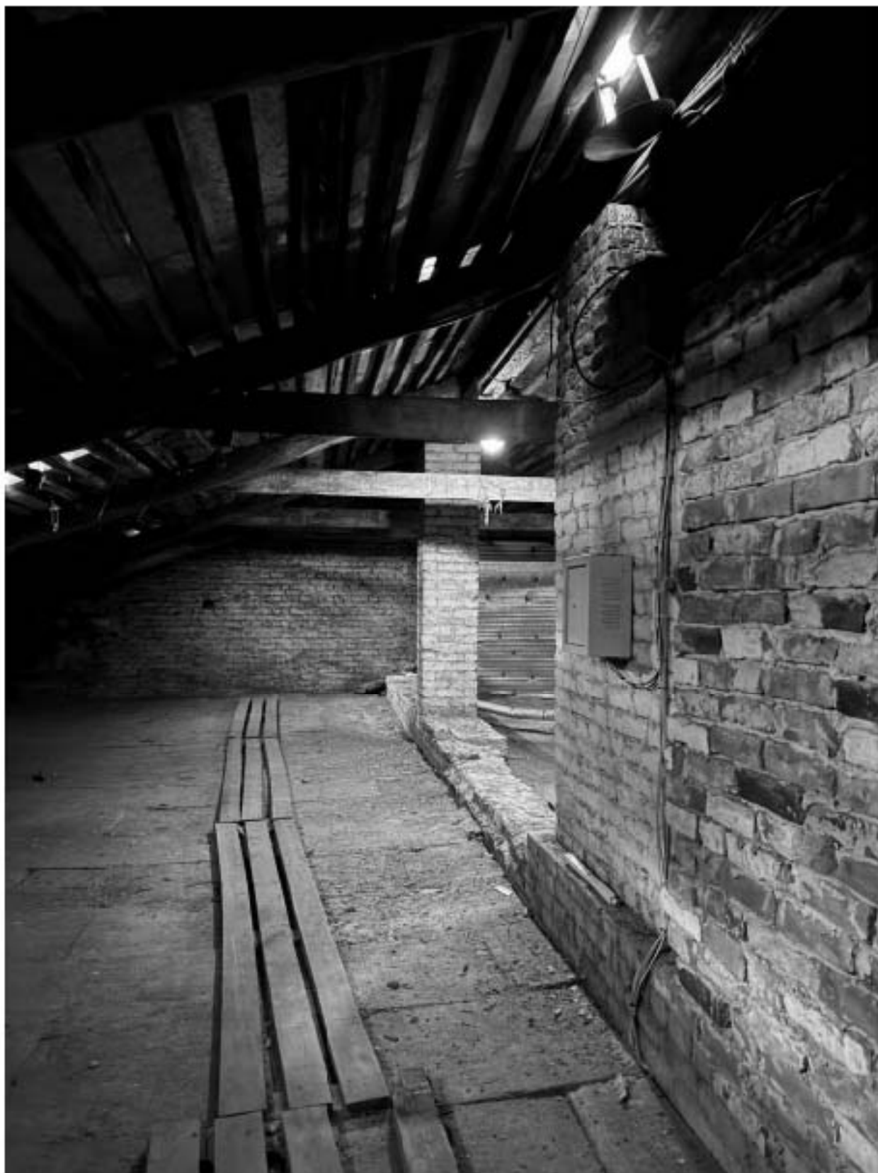
Фото 44. Вид на чердачное помещение объекта культурного наследия.
