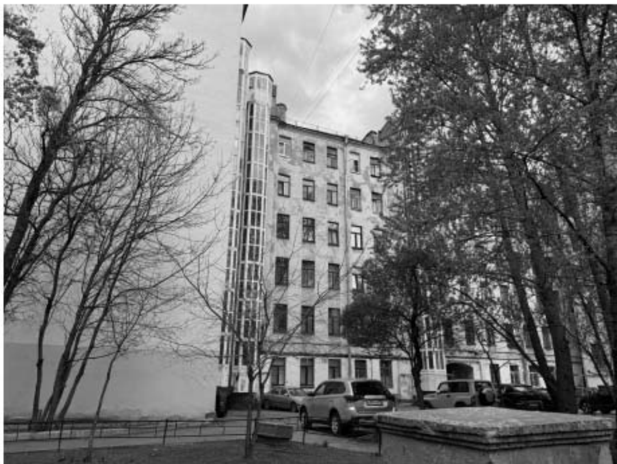
Фото 12. Вид на дворовые фасады объекта культурного наследия.
