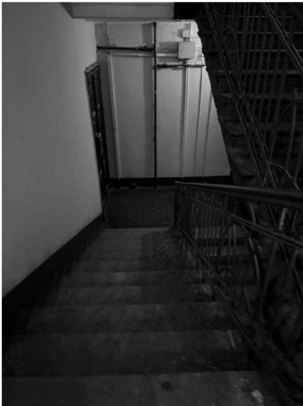
Фото 164. Вид на интерьер лестницы 2-ЛК объекта культурного наследия.
