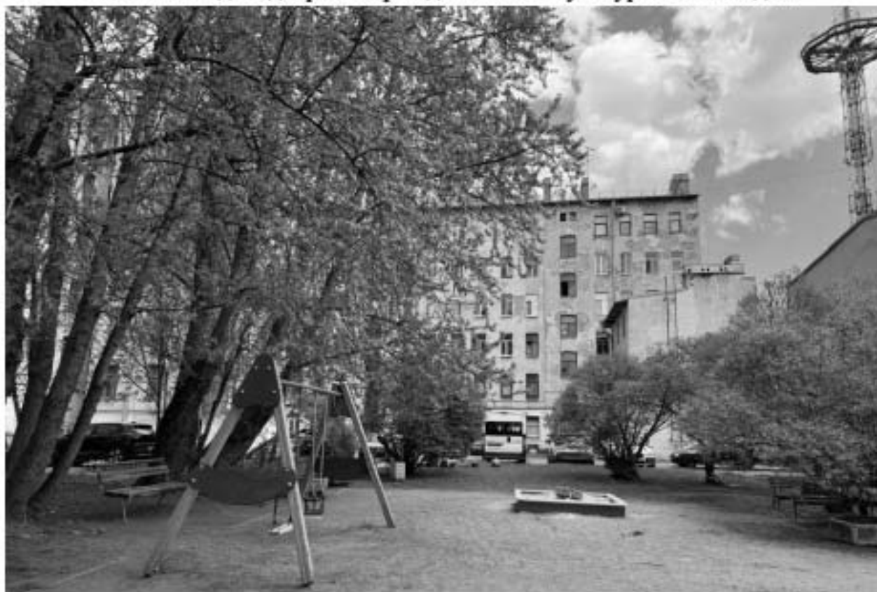
Фото 13. Вид на дворовые фасады объекта культурного наследия.
