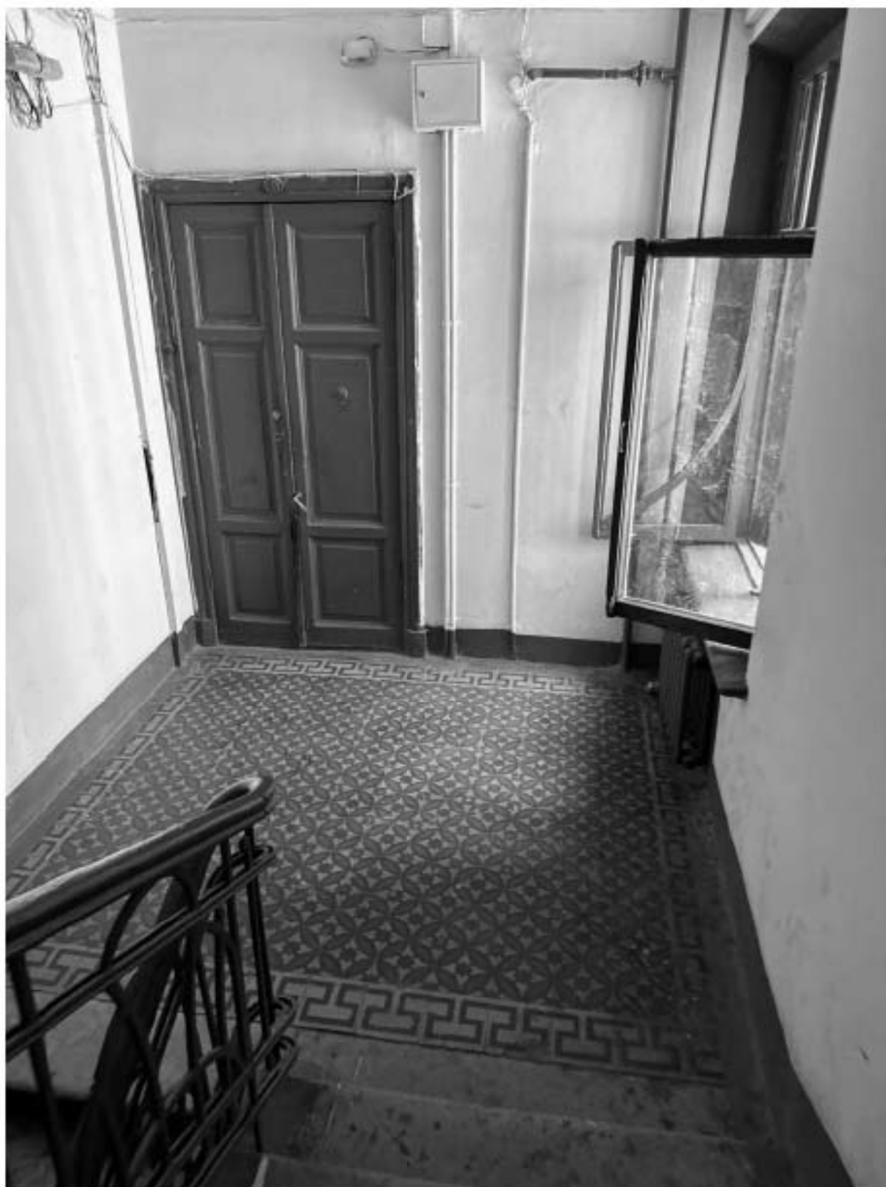
Фото 122. Вид на интерьер лестницы 4-ЛК объекта культурного наследия.
