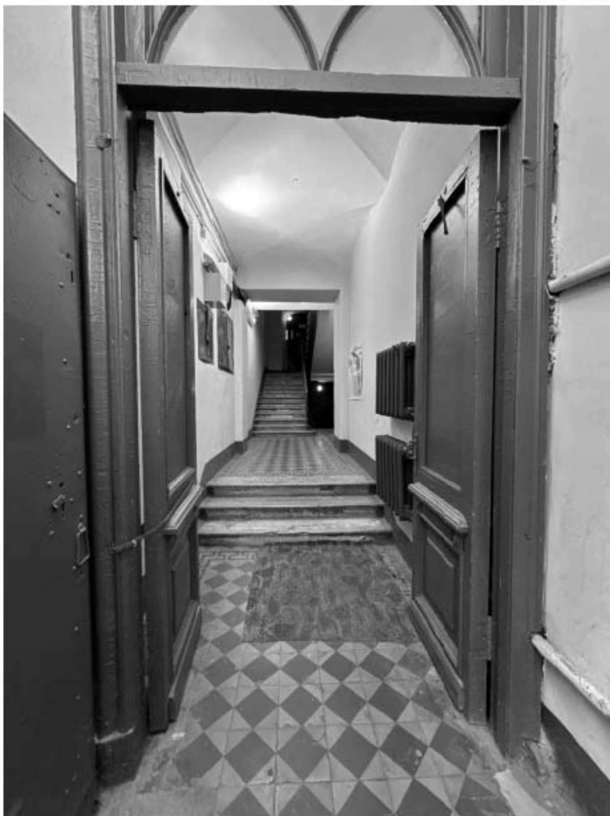
Фото 133. Вид на интерьер вестибюля лестницы 3-ЛК объекта культурного наследия.
