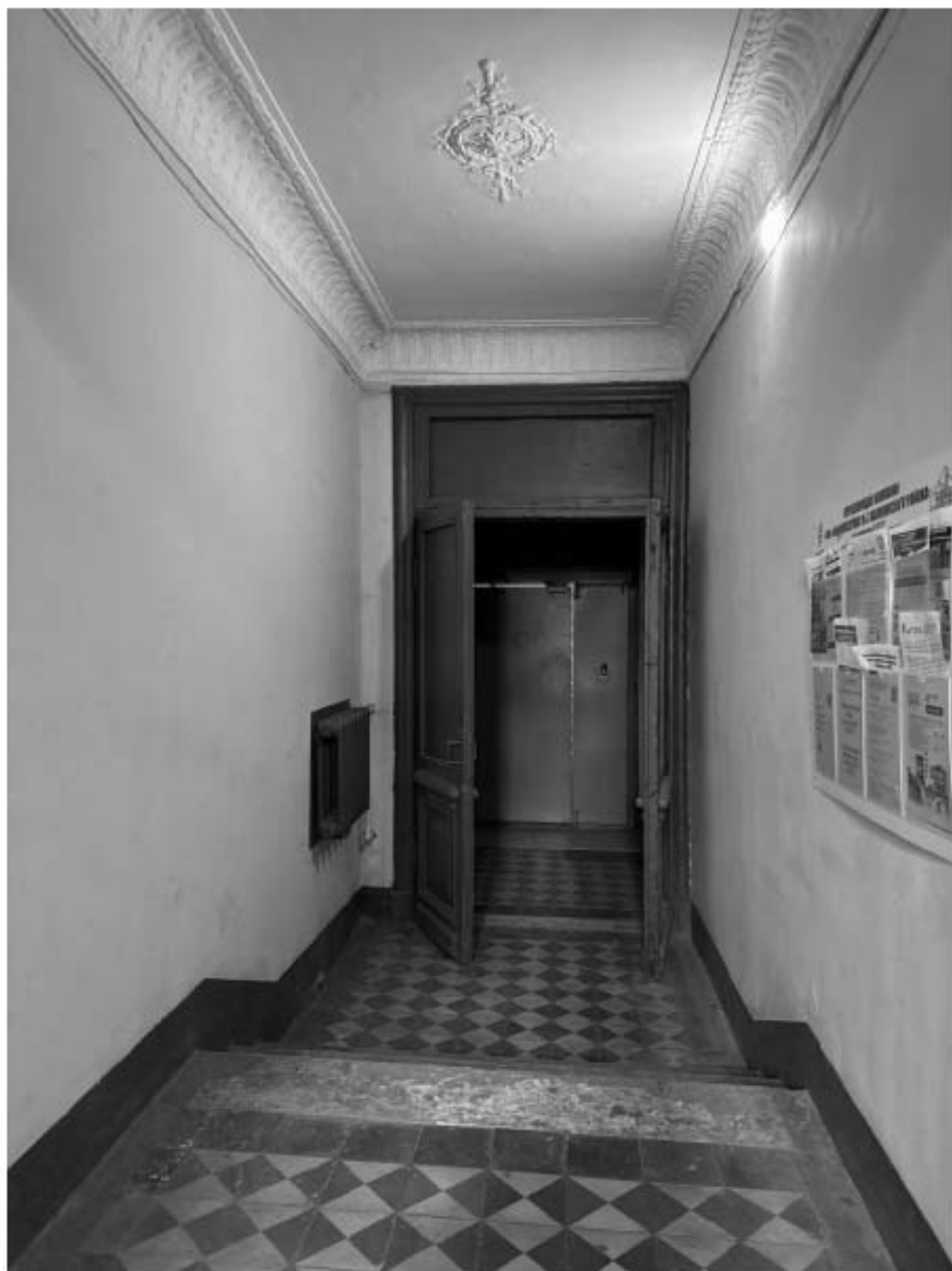
Фото 69. Вид на интерьер вестибюля лестницы 6-ЛК объекта культурного наследия.
