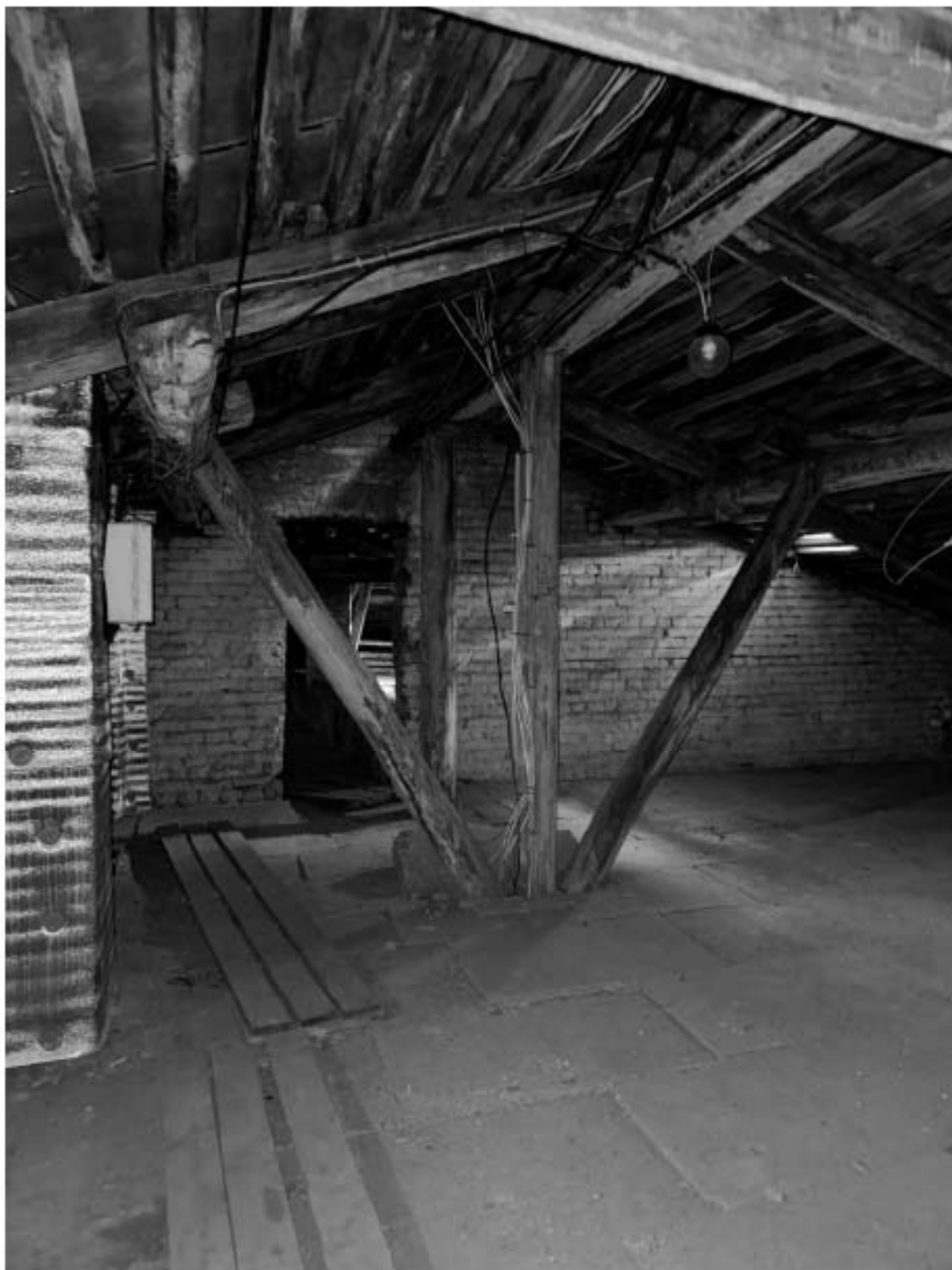
Фото 39. Вид на чердачное помещение объекта культурного наследия.
