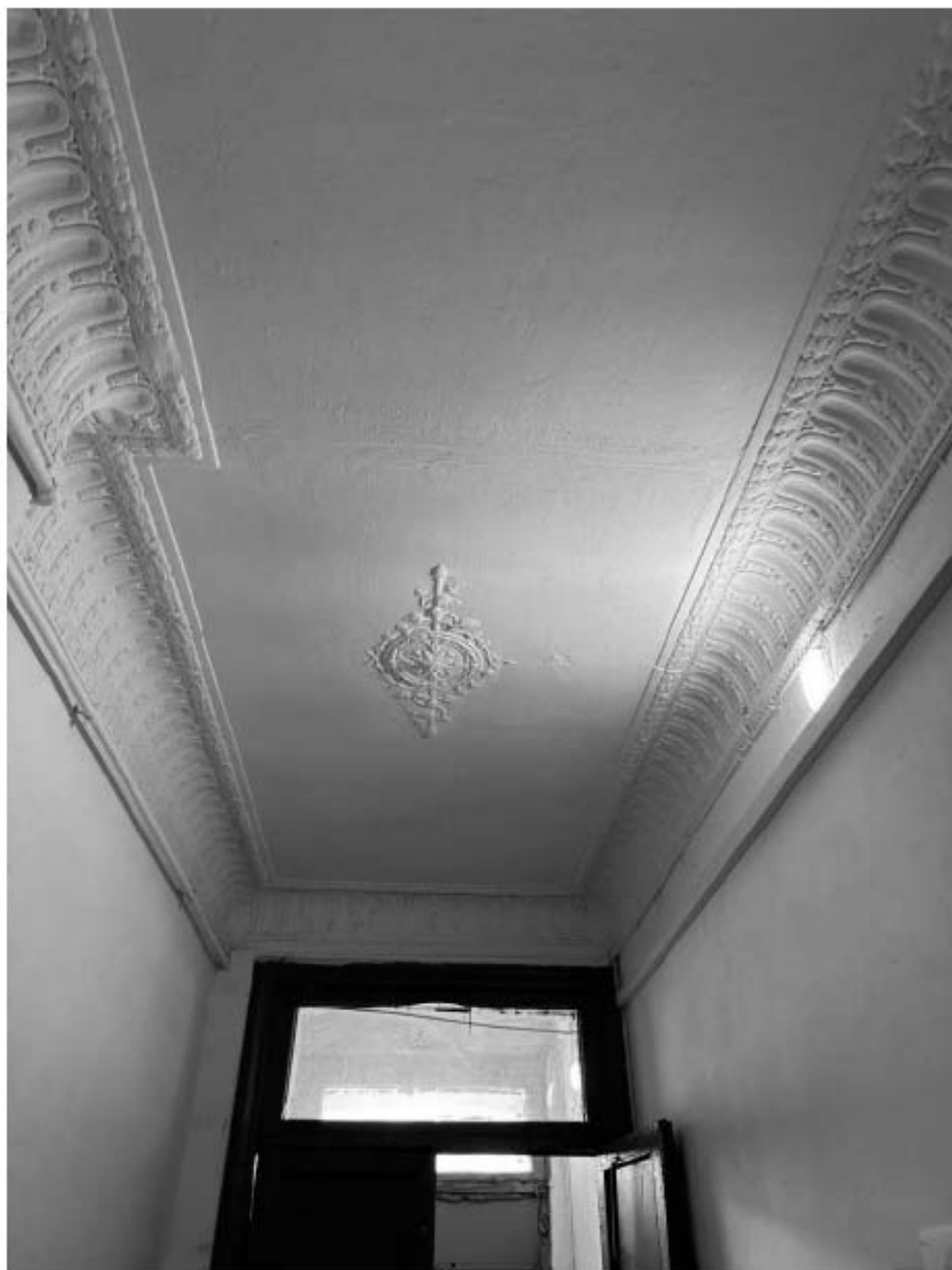
Фото 88. Вид на потолок вестибюля лестницы 5-ЛК объекта культурного наследия.
