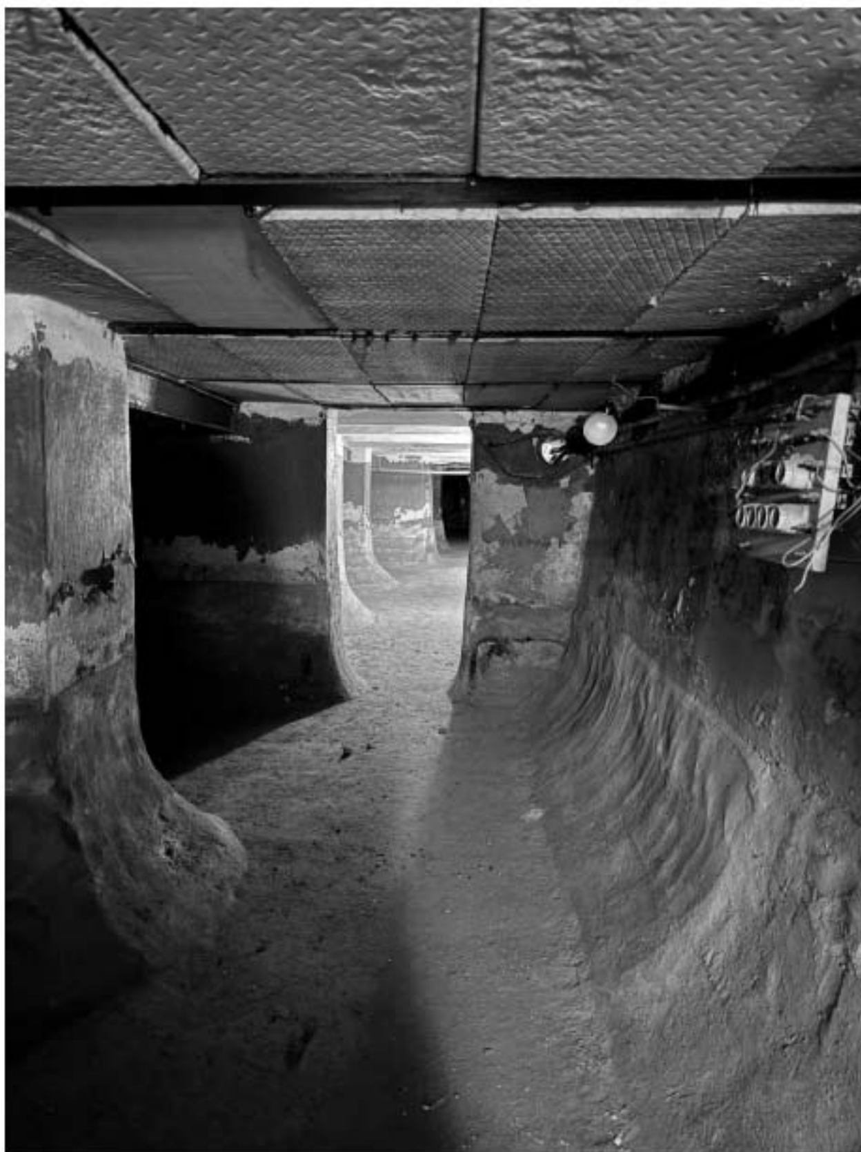
Фото 66. Вид на подвальное помещение объекта культурного наследия.
