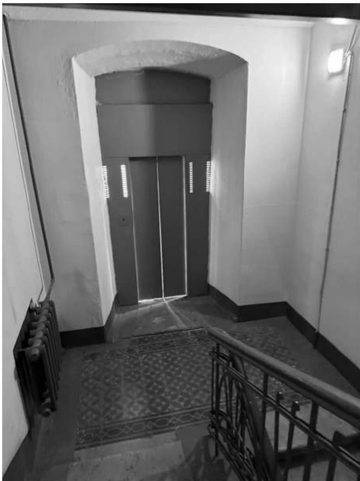
Фото 181. Вид на интерьер лестницы 1-ЛК объекта культурного наследия.
