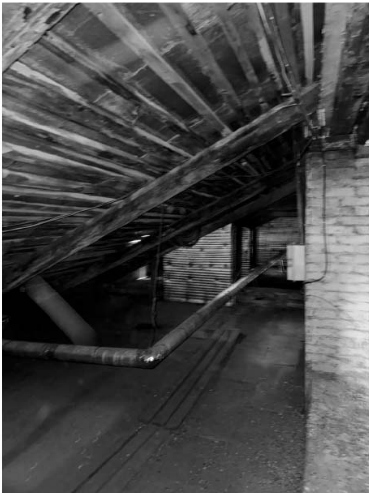
Фото 42. Вид на чердачное помещение объекта культурного наследия.
