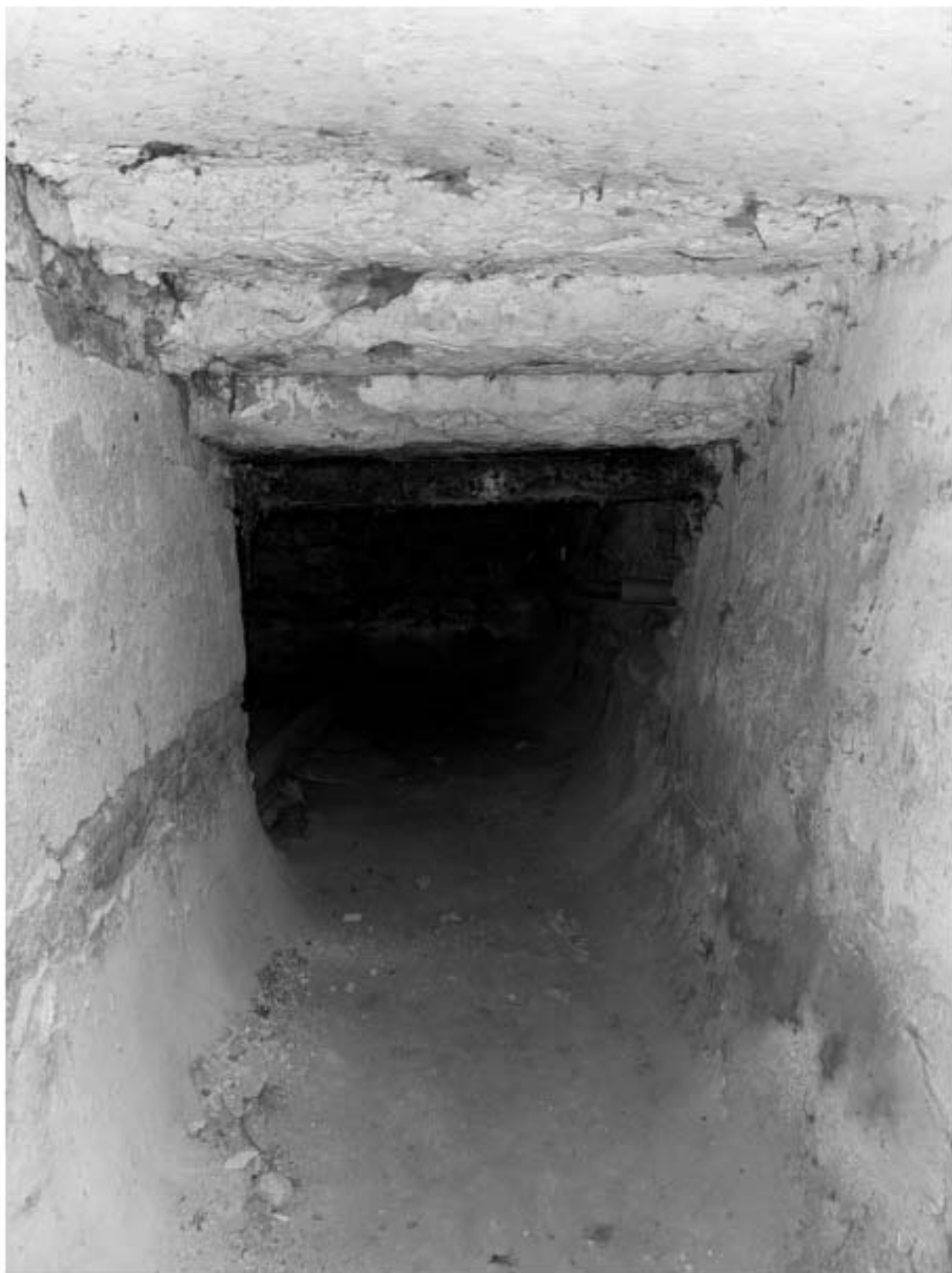
Фото 110. Вид на подвальное помещение объекта культурного наследия.
