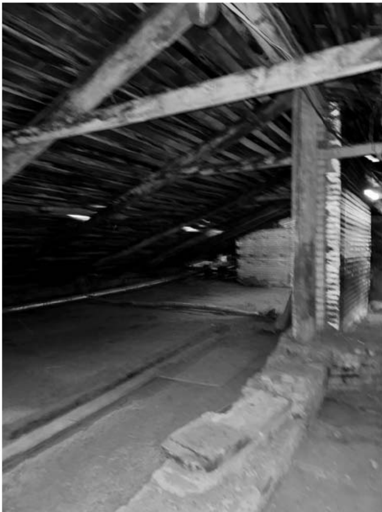
Фото 33. Вид на чердачное помещение объекта культурного наследия.
