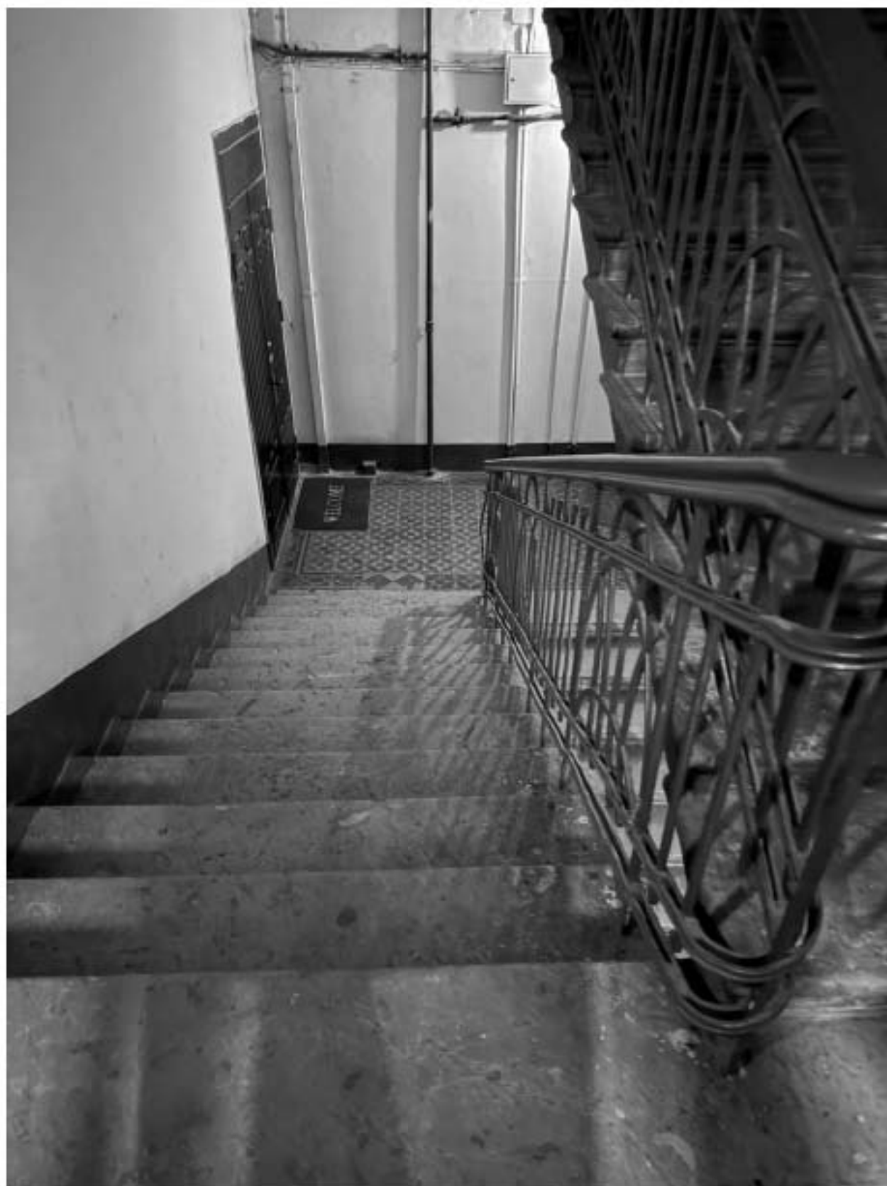
Фото 159. Вид на интерьер лестницы 2-ЛК объекта культурного наследия.
