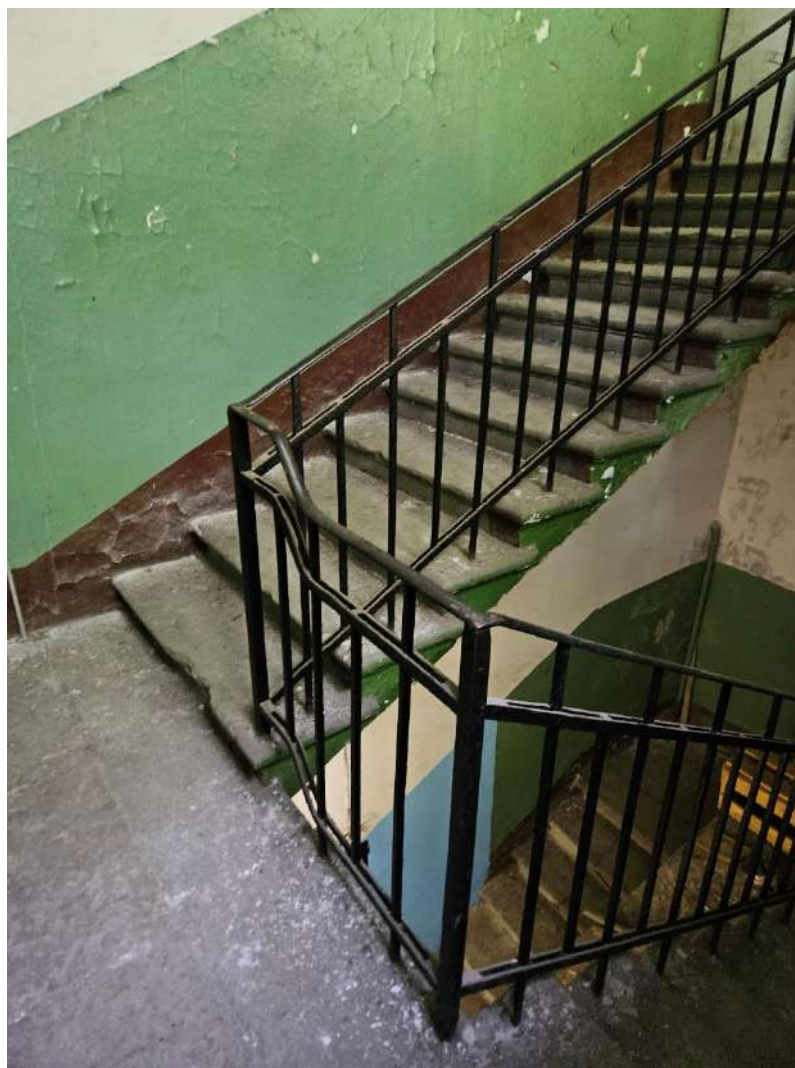
Фото 80. Выявленный объект культурного наследия «Два производственных корпуса». Главный производственный корпус. Трехмаршевая межэтажная лестница ЛК-1.
