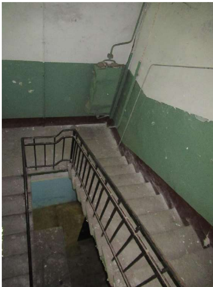
Фото 82. Выявленный объект культурного наследия «Два производственных корпуса». Главный производственный корпус. Трехмаршевая межэтажная лестница ЛК-1.
