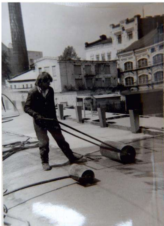
43. Архив СПб ГБУ «Мостотрест». Ф. Екатерингофский мост. Проект капитального ремонта Екатерингофского моста. Фото 1989 г.
