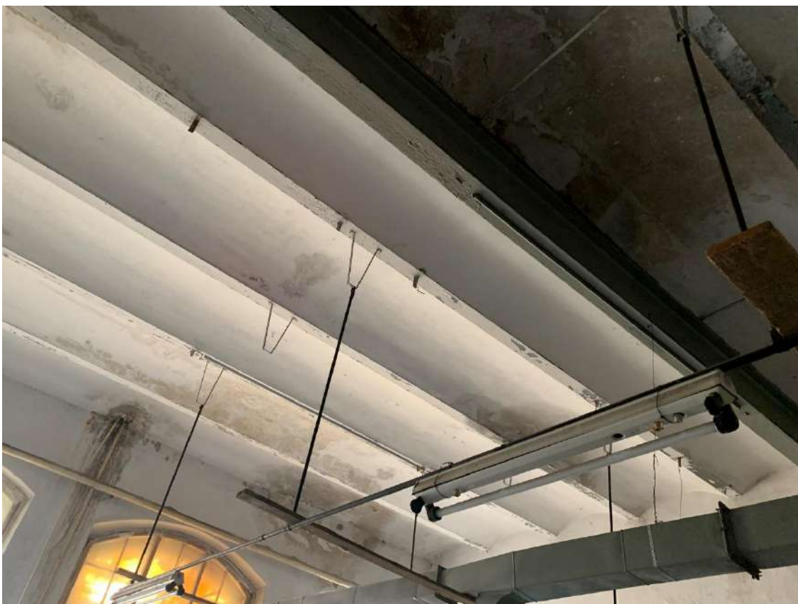
Фото 77. Выявленный объект культурного наследия «Два производственных корпуса». Главный производственный корпус. Своды по балкам («прусские») в помещении 4-Н (2) 1-го этажа.
