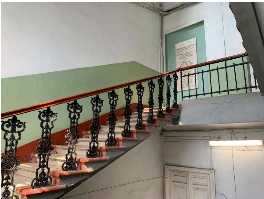
Фото 12. Выявленный объект культурного наследия «Два производственных корпуса». Западный производственный корпус. Трехмаршевая лестница ЛК-3 в южной части производственного корпуса
