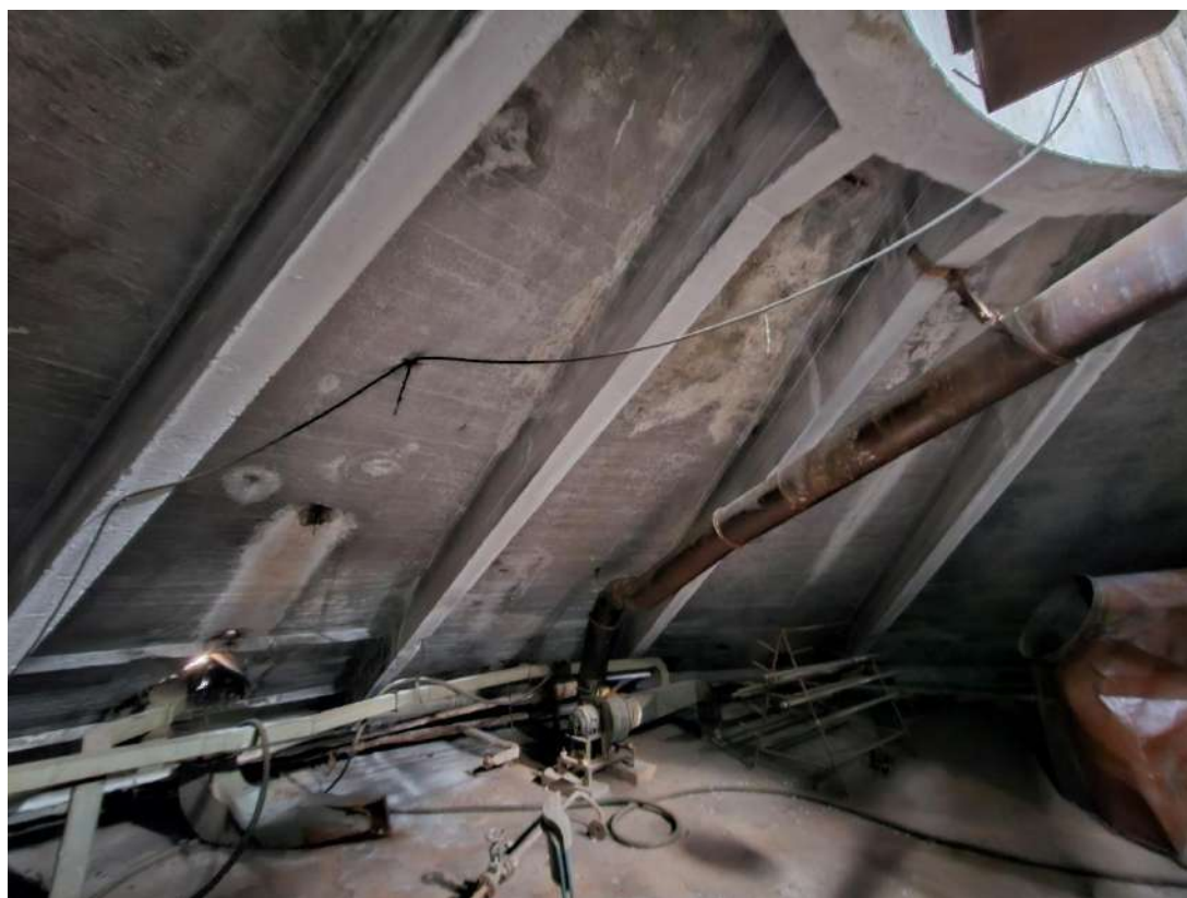
Фото 103. Выявленный объект культурного наследия «Два газгольдера». Южный газгольдер. Чердачное помещение. Вид на перекрытия.
