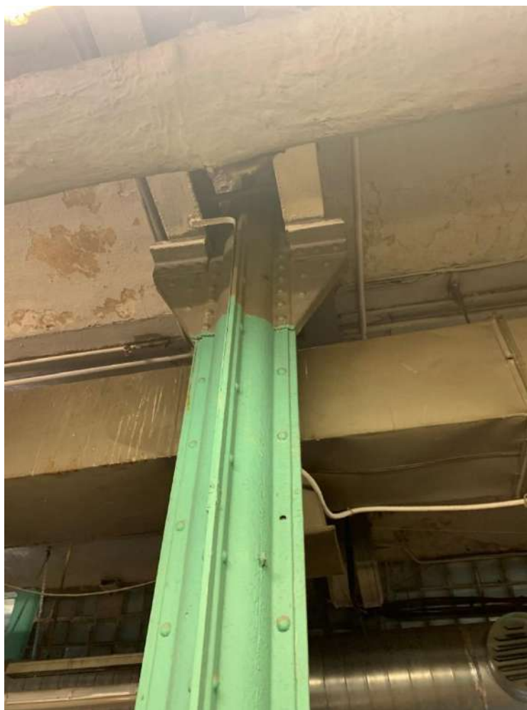
Фото 74. Выявленный объект культурного наследия «Два производственных корпуса». Главный производственный корпус. Металлический клепанный опорный столб в помещении 1-Н (72) 1-го этажа
