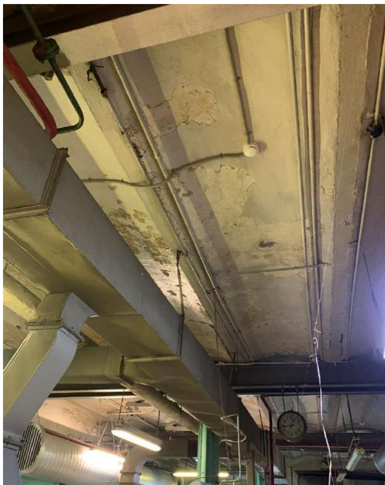
Фото 73. Выявленный объект культурного наследия «Два производственных корпуса». Главный производственный корпус. Своды по балкам («пруссские») в помещении 1-Н (72) 1-го этажа.
