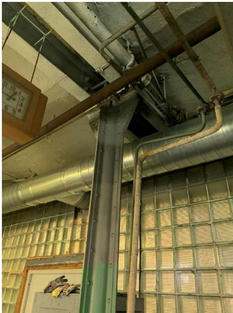
Фото 76. Выявленный объект культурного наследия «Два производственных корпуса». Главный производственный корпус. Металлический клепанный опорный столб в помещении 1-Н (76) 1-го этажа.
