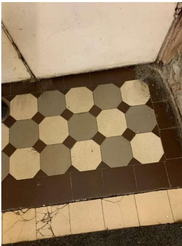
Фото 13. Выявленный объект культурного наследия «Два производственных корпуса». Западный производственный корпус. Покрытие пола тамбура метлахской плиткой между помещениями 11-Н (1) и 11-Н (9) 1-го этажа производственного корпуса
