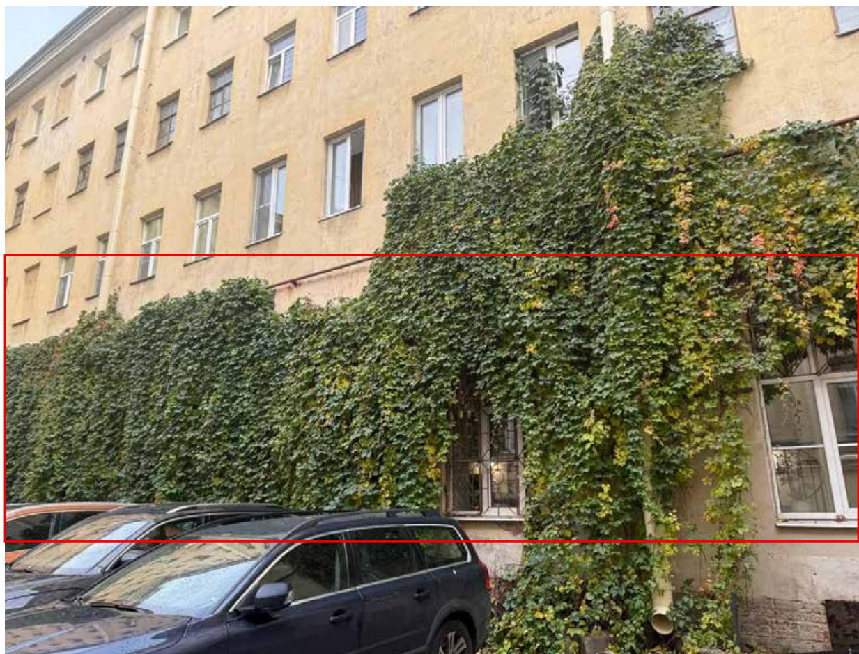
2. Фрагмент дворового фасада.
