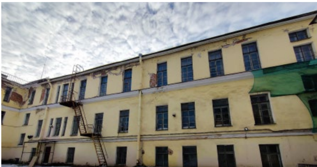
Фото №5. Дворовый фасад.
