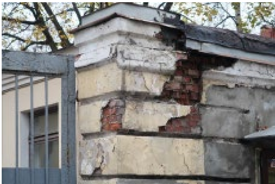
Фото №18. Фрагмент ограды.
