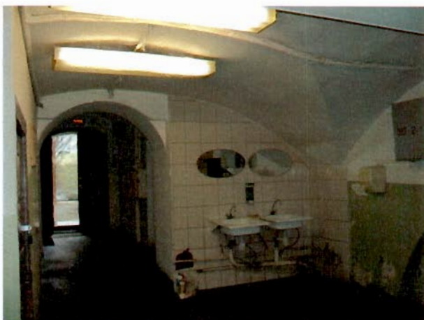
Фото 14. Интерьеры цокольного этажа.
