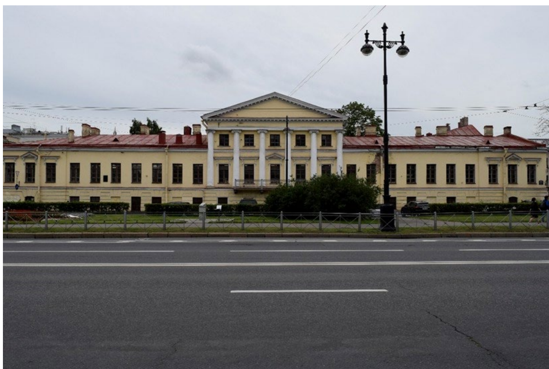
Фото №2. Центральная часть лицевого фасада.
