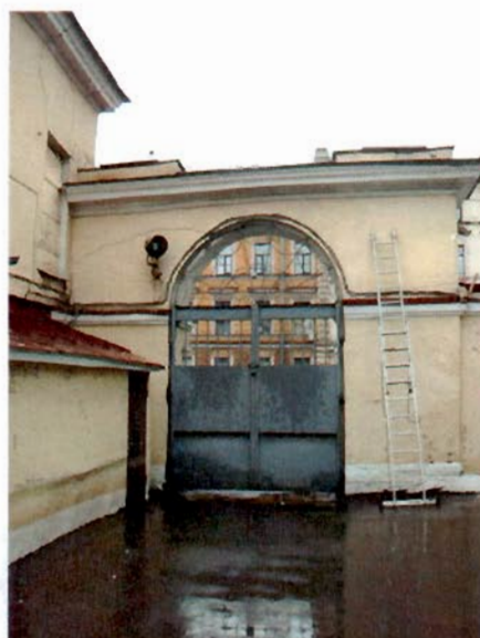
Фото 7. Ворота со стороны двора.
