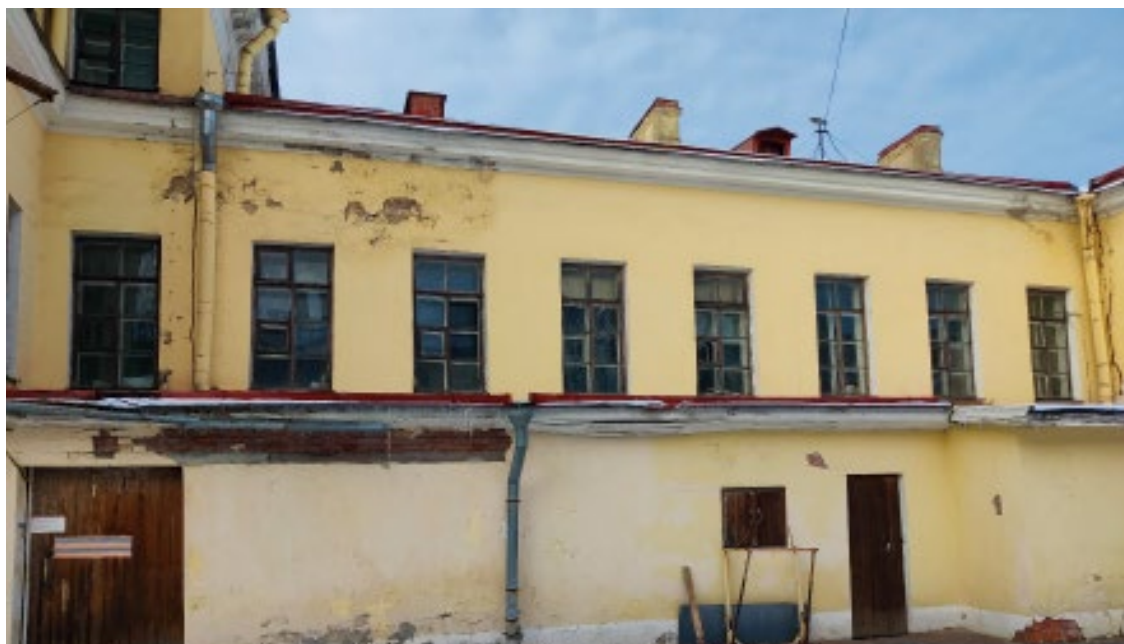
Фото №4. Дворовый фасад.
