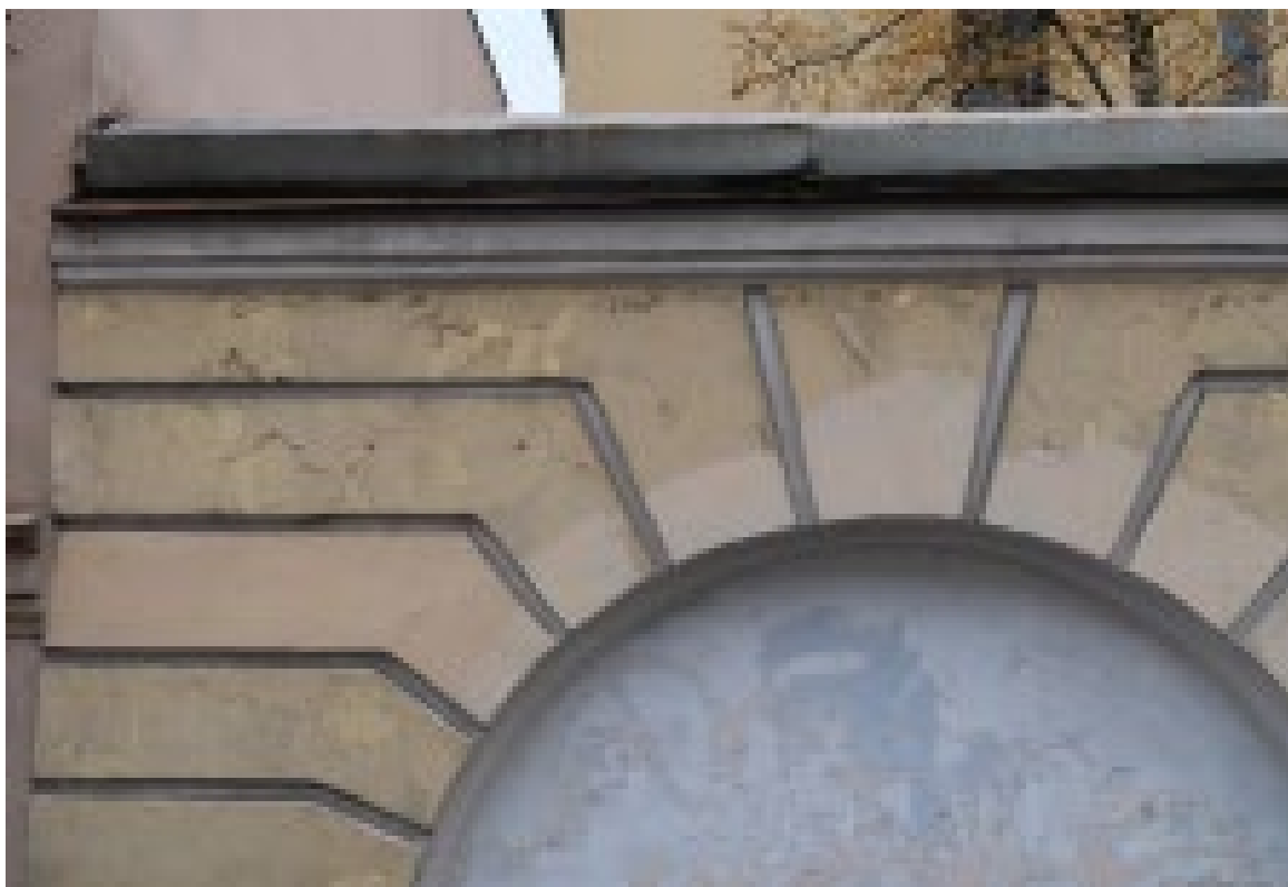
Фото №17. Фрагмент ограды.
