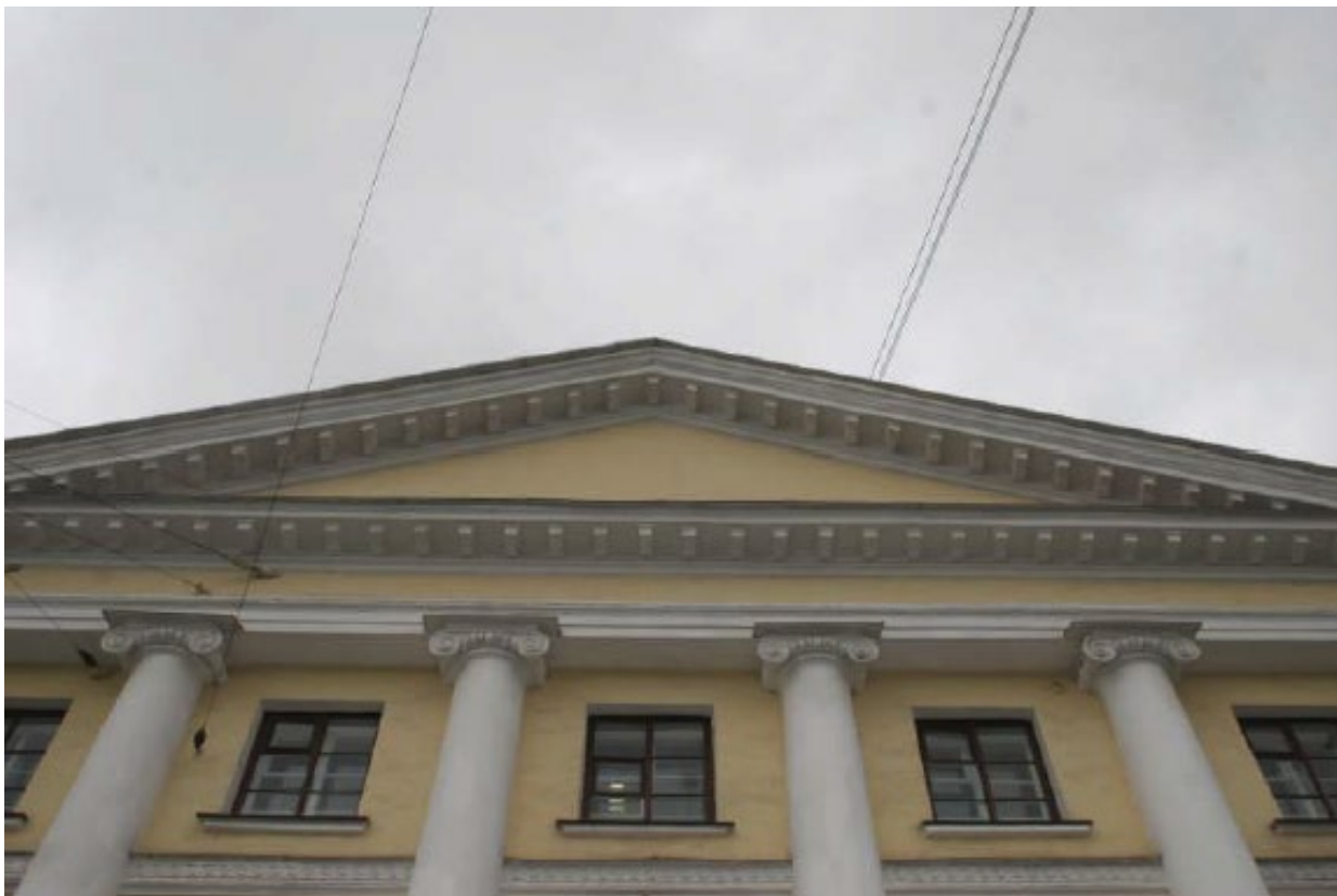
Фото №7. Фрагмент лицевого фасада по Большому проспекту. Фронтон центрального ризалита.
