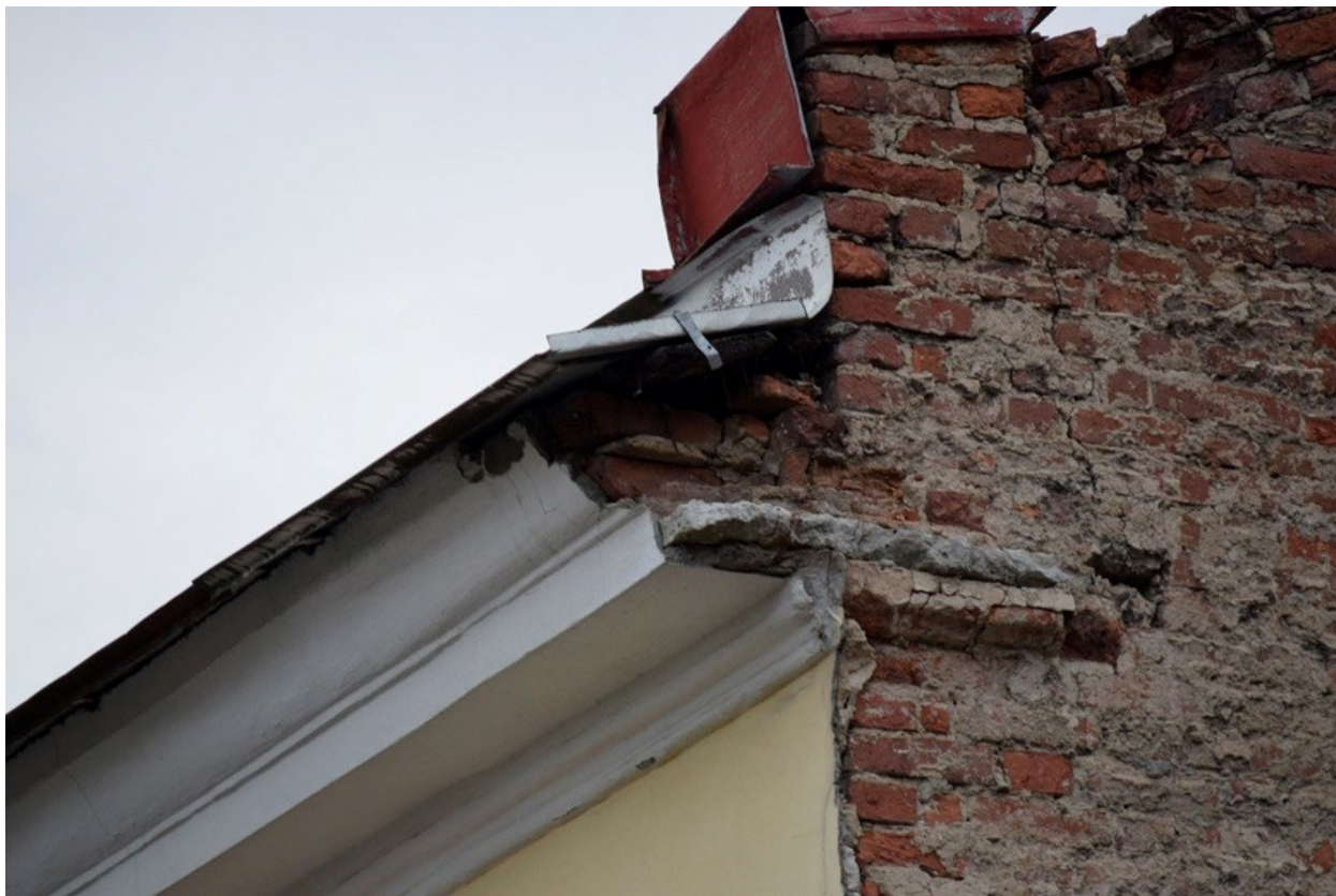
Фото №12. Фрагмент фасада, венчающий карниз.
