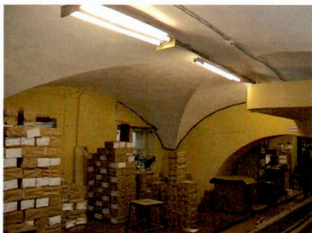
Фото 15. Интерьеры цокольного этажа.
