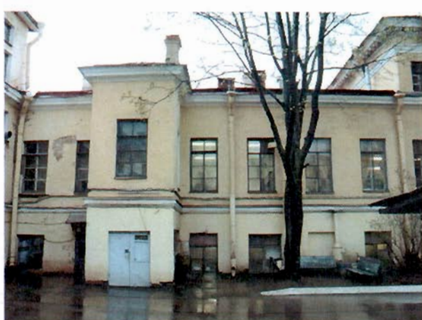
Фото 9. Дворовой фасад и территория.
