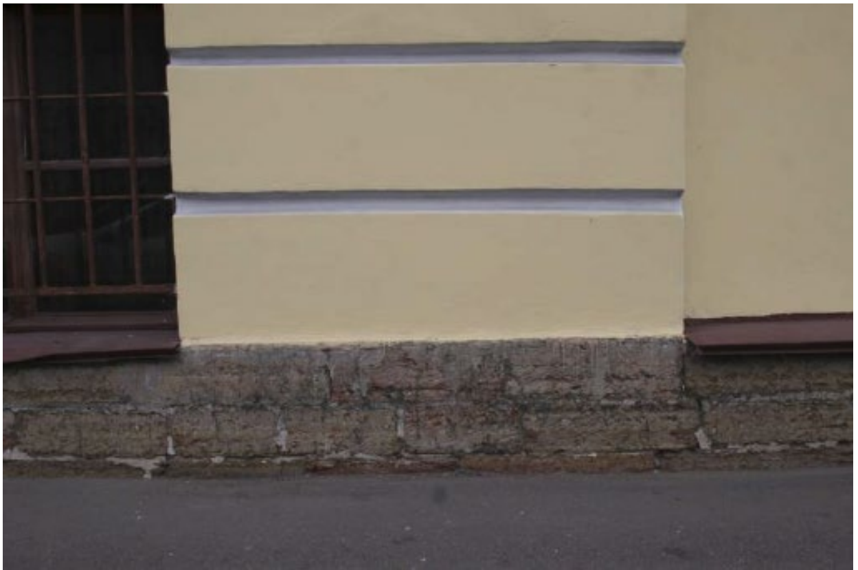
Фото №9. Лицевой фасад со стороны 9-й линии. Фрагмент цоколя.
