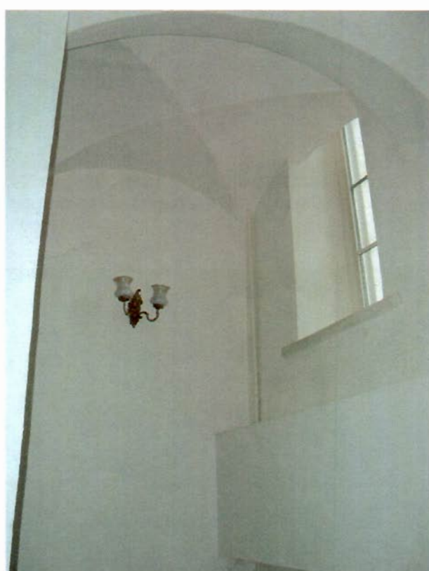
Фото 13. Своды центральной лестницы.
