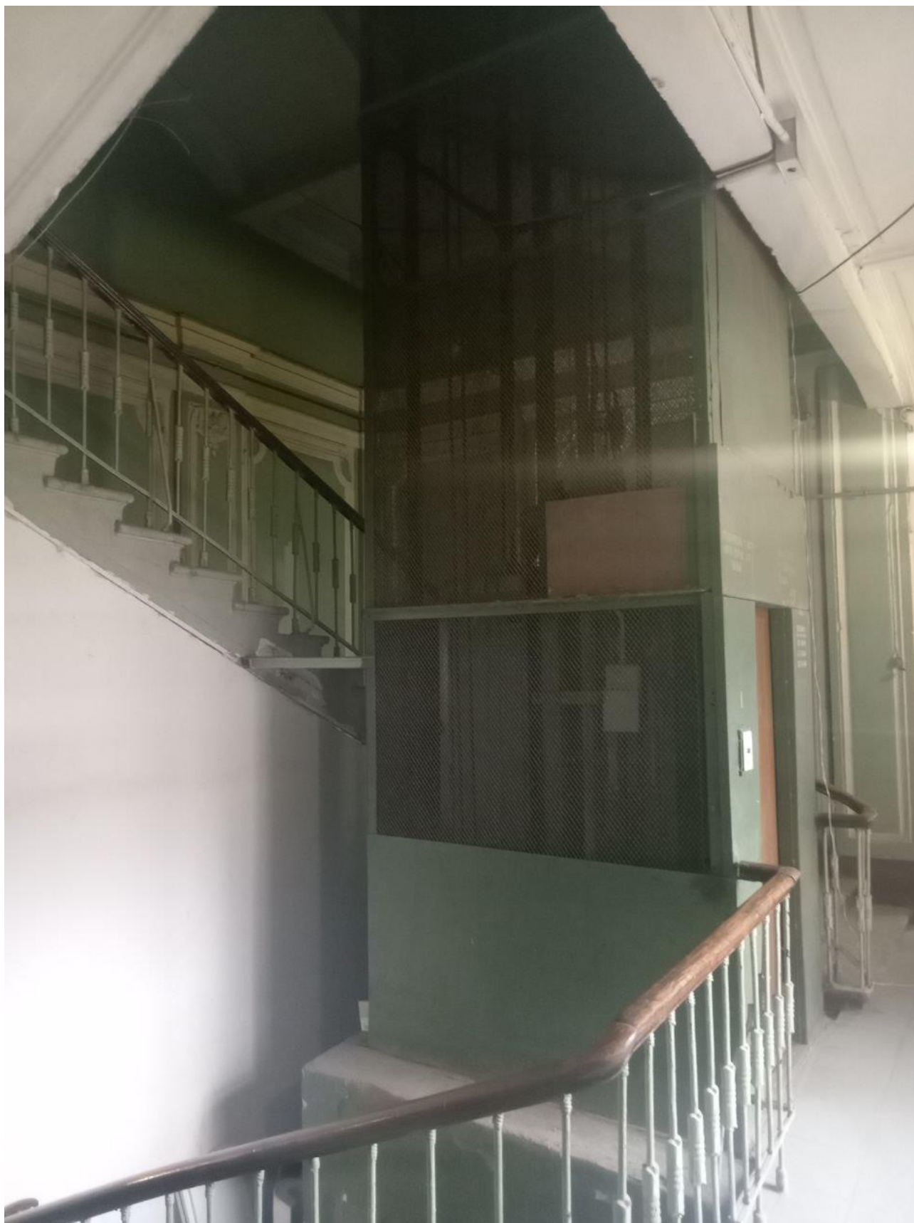
Фото 24. Пом. 1ЛК. Общий вид. Трехмаршевая, на косоурах, материал ступеней и площадок – путиловская плита, с литым металлическим ограждением в виде вертикальных стержней с утолщением в виде связки лепестков лотоса в центре, с профилированным дубовым поручнем, с латунными кольцами ковродержателей – в исторических габаритах (в уровне 1-2-го этажей).
