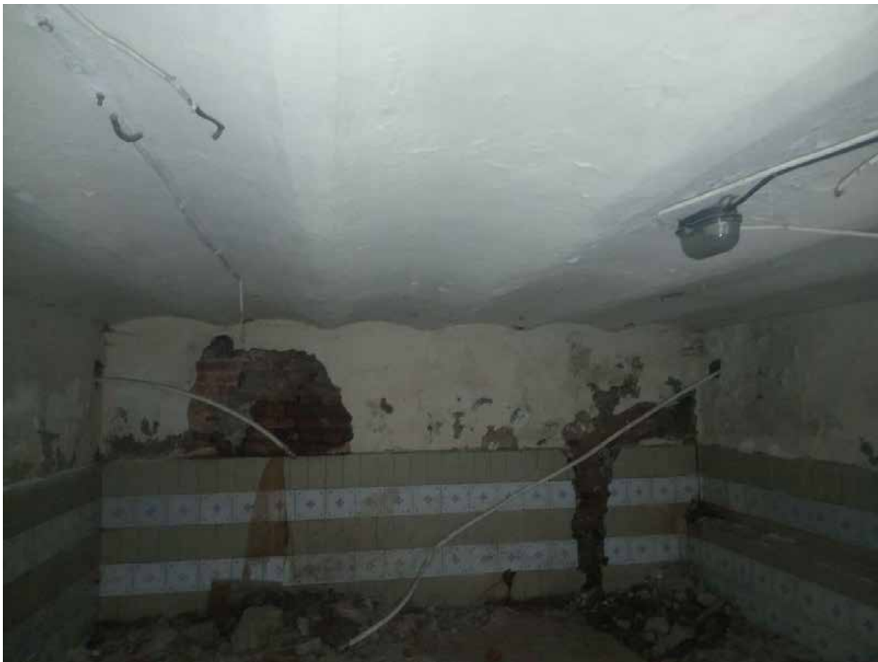
Фото 16. Общий вид пом. 1Н(18) надподвальные своды Манье по мет. балкам.
