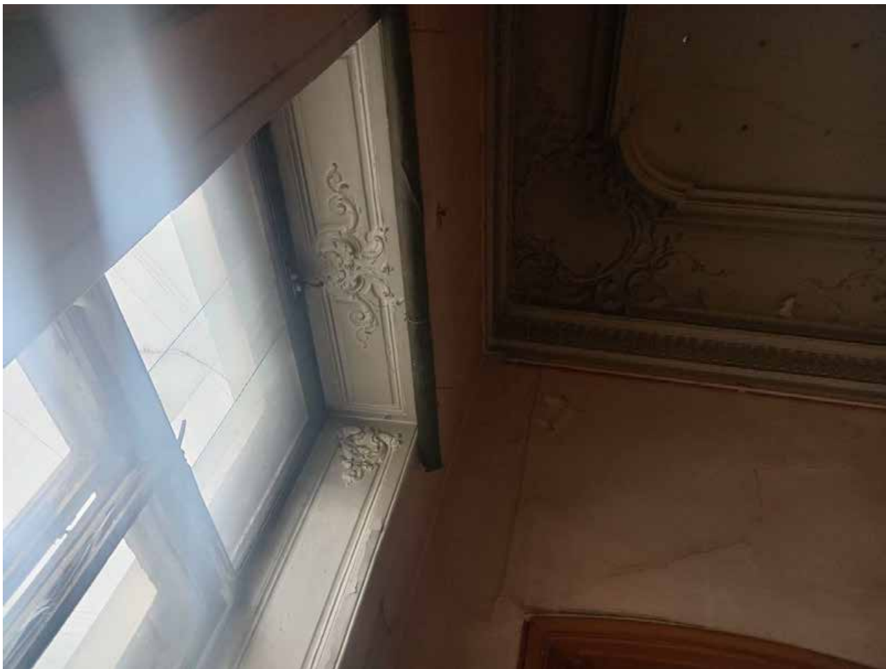
Фото 36. Помещение ЗН(8). Падуги в углах помещения оформлен картушами, декорированными рокайльными завитками.
