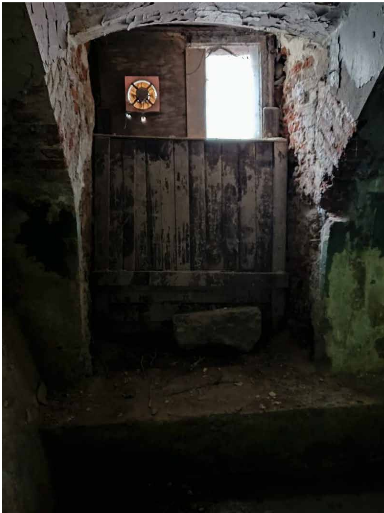
Фото 15. Фрагмент пом 1Н(3).
