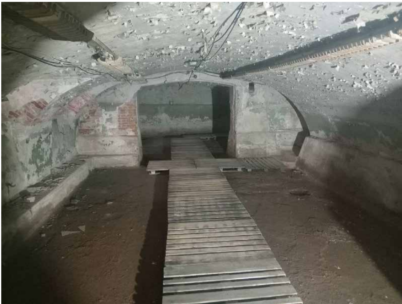
Фото 13. Общий вид пом 1Н(2) на пом 1Н(3).
