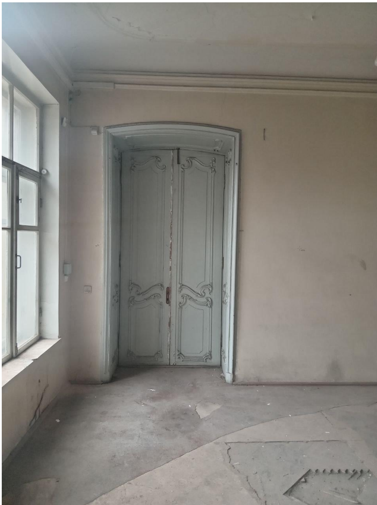
Фото 46. Помещение 3Н(12) (Передняя). Вид на 1ЛК (5). Исторический дверной проем с лучковой перемышкой. Профилированные наличники; откосы, облицованные филенчатыми фигурными деревянными панелями. заполнение дверных проемов – дуб, сосна, резьба, двери двустворчатые, профилированные филенки криволинейной формы, по две на каждом полотне, с резным обрамлением в виде стилизованных стеблей растений и завитков.
