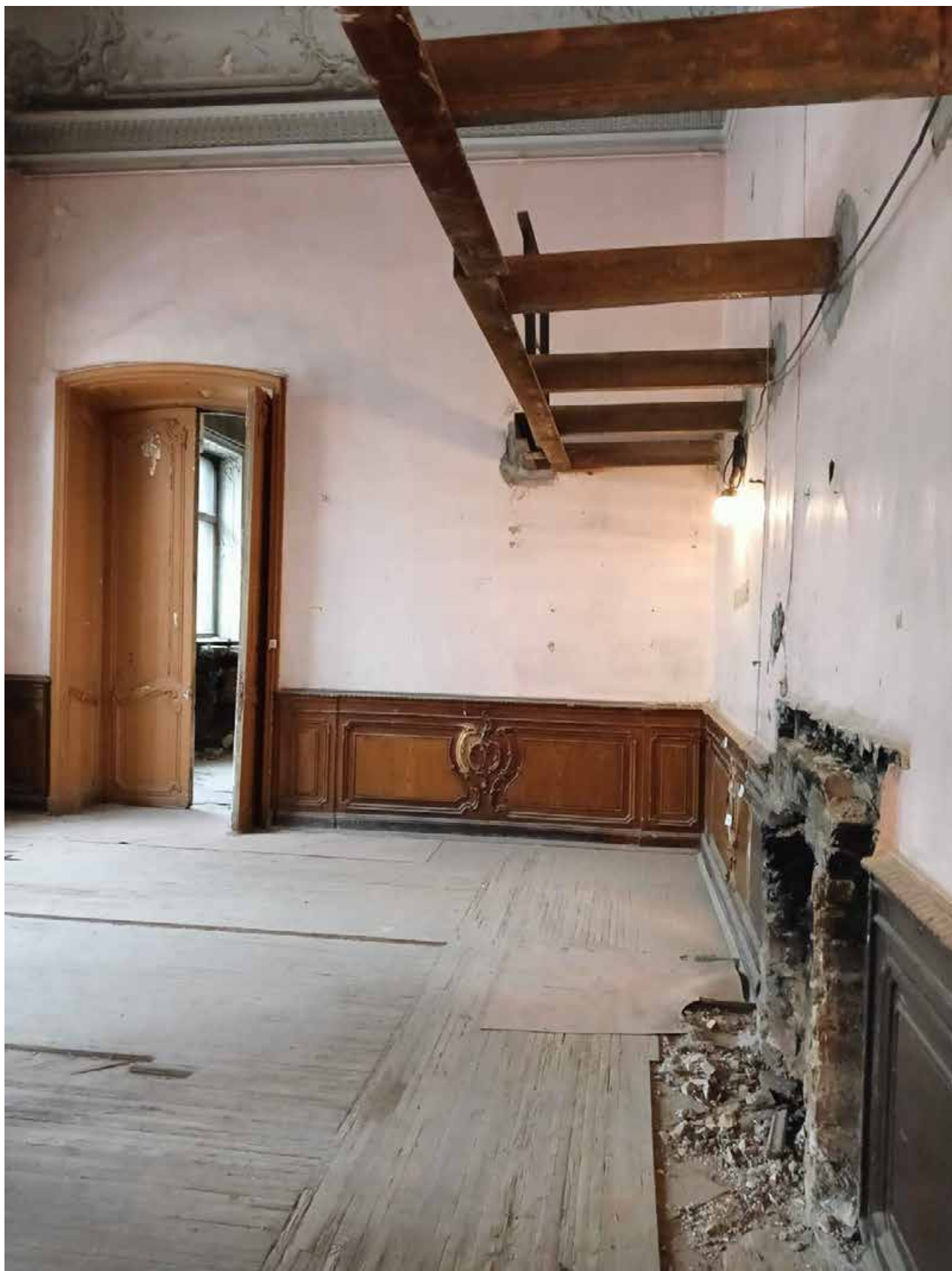
Фото 34. Помещение ЗН(8). Общий вид. Вход в помещение ЗН(9).
