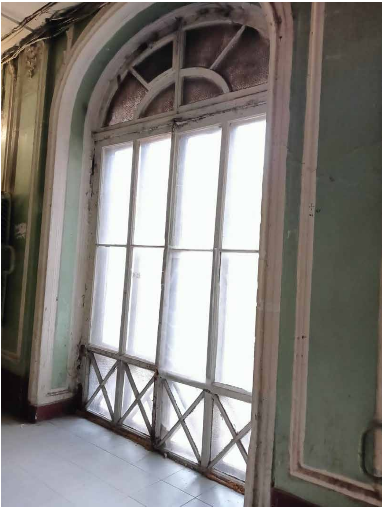
Фото 20. Фрагмент пом. 1ЛК(2). Оформление балконного проема площадки 1-го этажа: профилированный наличник с акантовыми замковым камнем и консолями; откосы оформлены профилированной филенкой.
