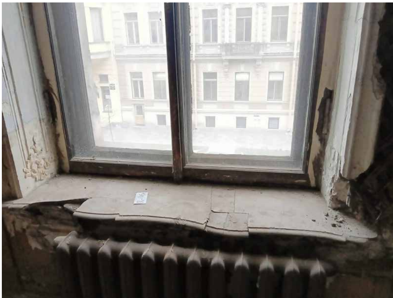
Фото 41. Помещение 3Н(9). доска подоконная (2) – белого с серыми прожилками мрамора, криволинейного очертания, с профилированным краем; мастерская Мадерни; время: 1846-1847 гг.; размер: длина – 176 см; ширина – 39 см.
