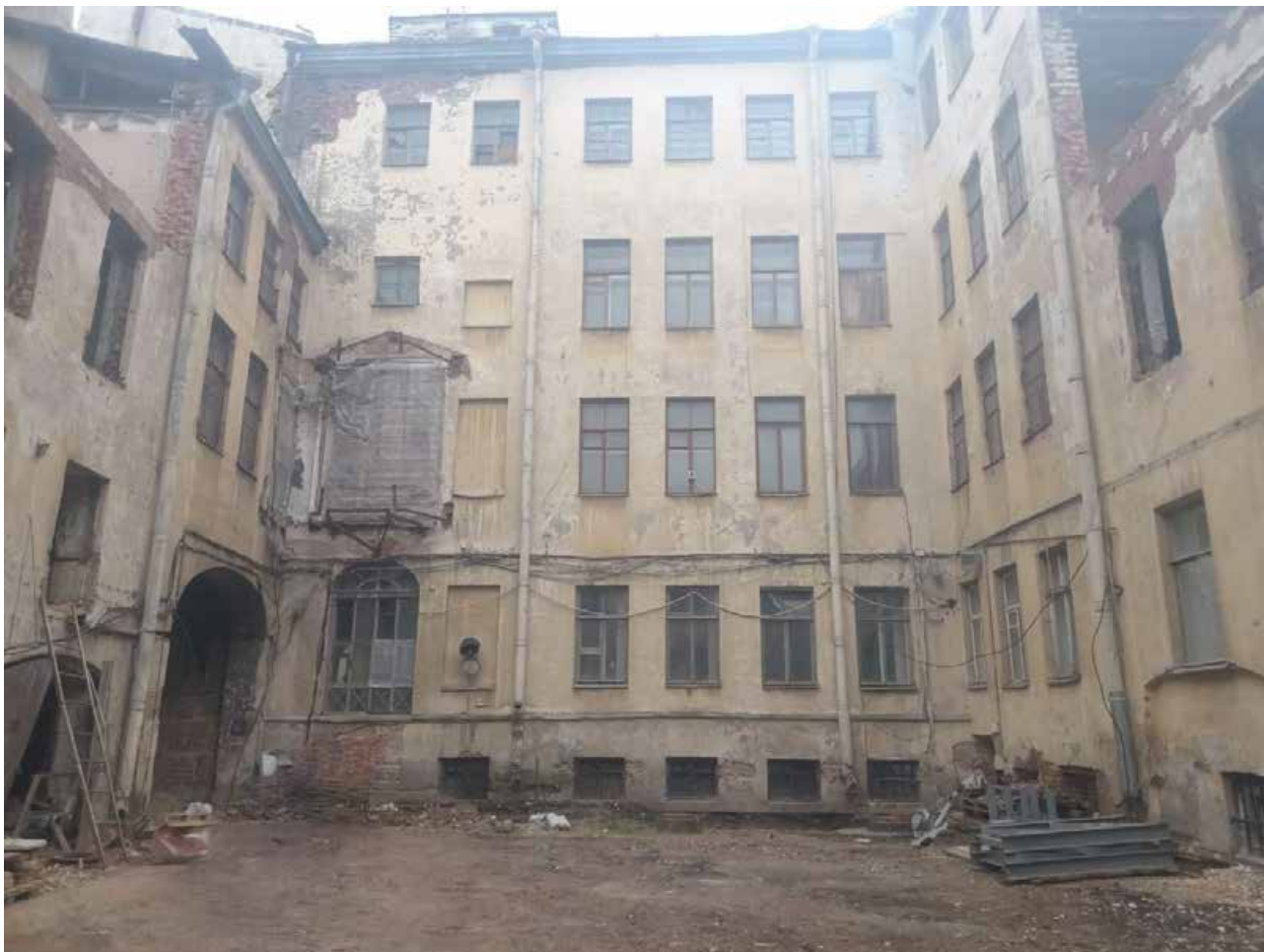
Фото 7. Фрагмент юго-западного, юго-восточный фрагмент северо-восточного фасадов. Материал отделки — окрашенная штукатурка, цоколь — известняк.
