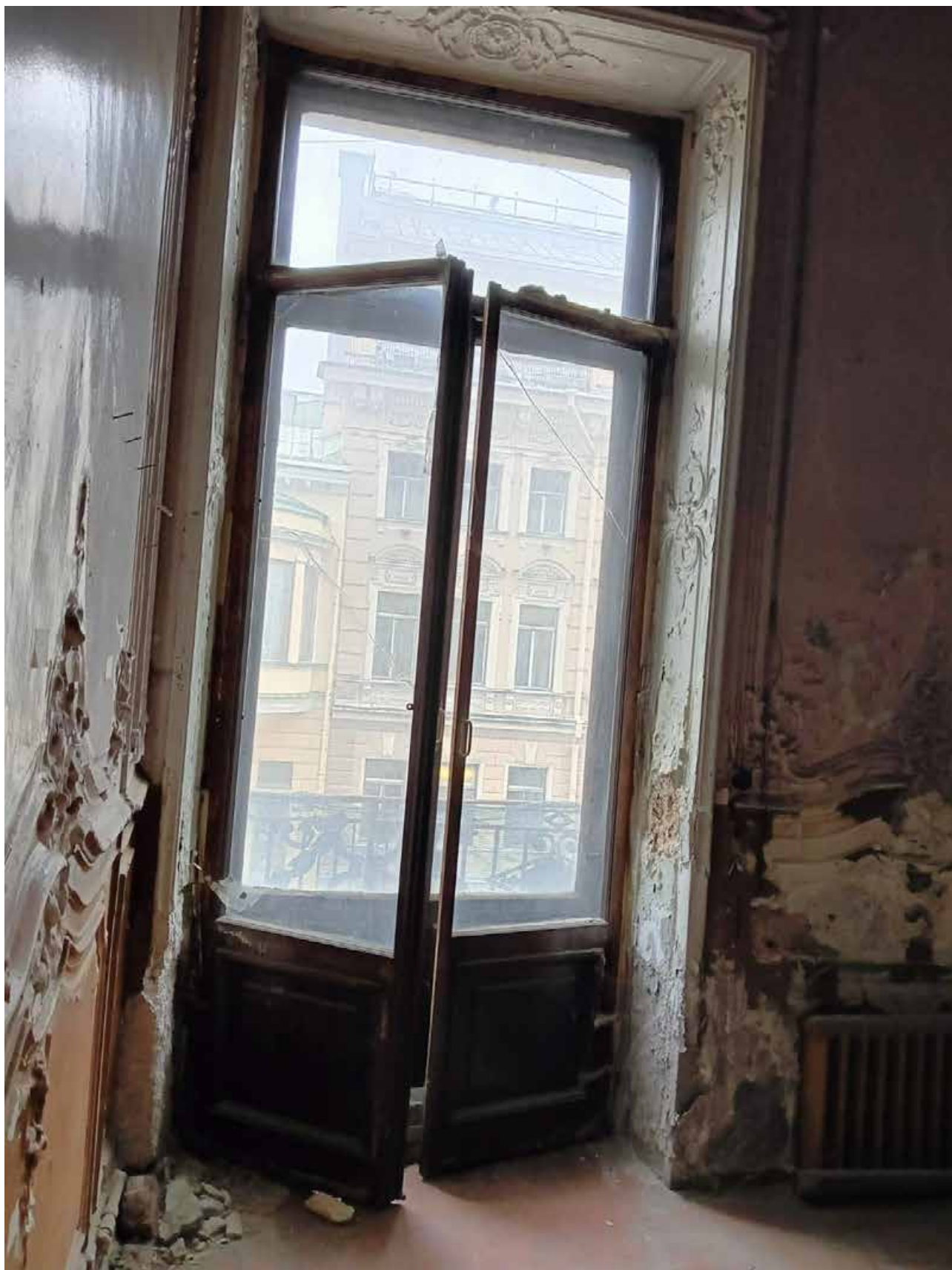
Фото 30. Фрагмент Помещения 3Н(1). Исторический балконный проем, прямоугольный, оформление (откосы с профилированными прямоугольными и криволинейными филенками, с лепными композициями из рокайлей, С-образных и акантовых завитков, композиции по серединам сторон с круглыми розетками в центре).
