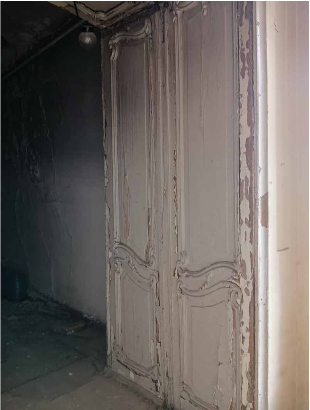
Фото 52. Помещение ЗН(11)(Вторая передняя). Вид на пом. ЗН(13). Тамбур двухфиленчатый (дуб, сосна, резьба, золочение); филенки декорированы накладной резьбой в виде рокайлей и волют; время: 1846-1847 гг.
