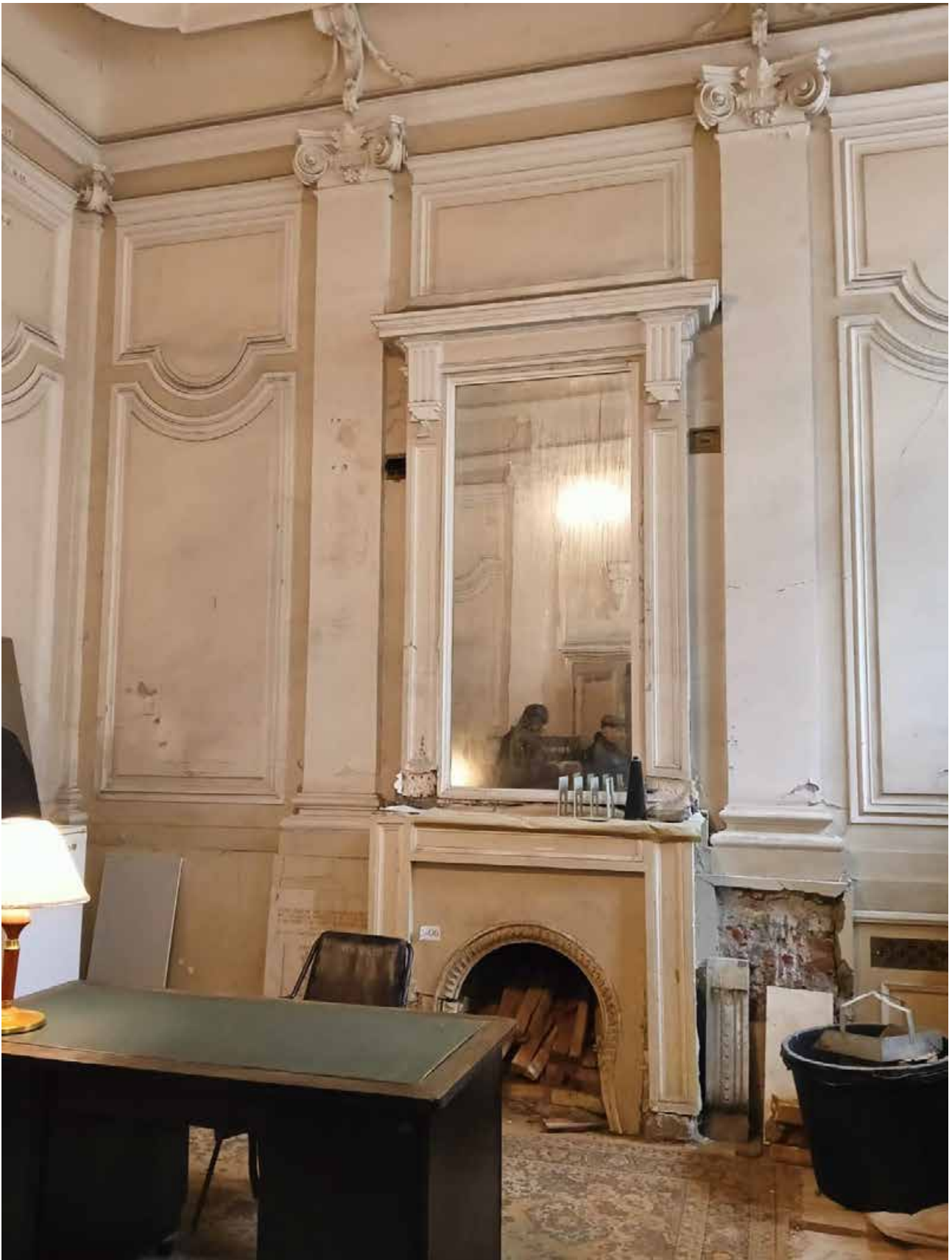
Фото 18. Фрагмент пом 1ЛК(1). Печь-камин средистенная, штукатурная, двухъярусная; нижний ярус: фронтальная часть с прямоугольной уплощенной нишей; по углам и под полочкой профилированные прямоугольные филенки; топочное отверстие фигурных очертаний, в орнаментированном лепном обрамлении с порезкой геометрического рисунка и растительными завитками.
