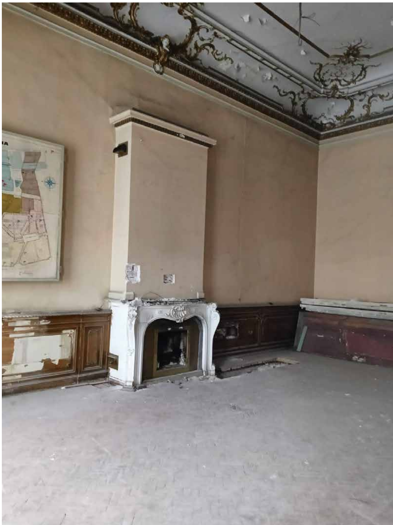
Фото 44. Помещение 3Н(10) (Большой кабинет). Общий вид. Печь-камин – средистенная, двухъярусная; нижний ярус: белого мрамора; нижний ярус с отделкой из гладкой оштукатуки, увенчан профилированным карнизом.
