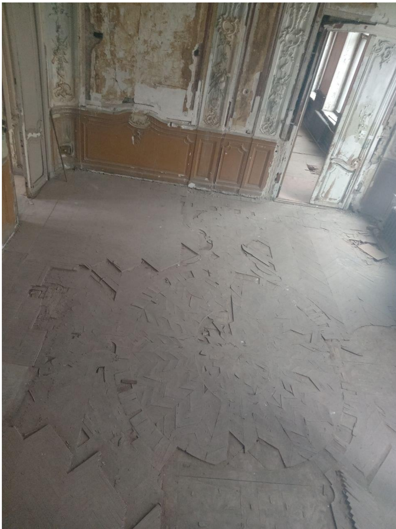
Фото 42. Помещение ЗН(9) покрытие пола – наборный паркет ценных пород дерева (красное, розовое, черное), по периметру с тягами и бордюрами, с центральной розеткой и сплошным орнаментом из завитков аканта, медальонов, рокайлей – рисунок, техника исполнения (столярная работа, набор, лакировка); первоначальный подбор пород дерева.
