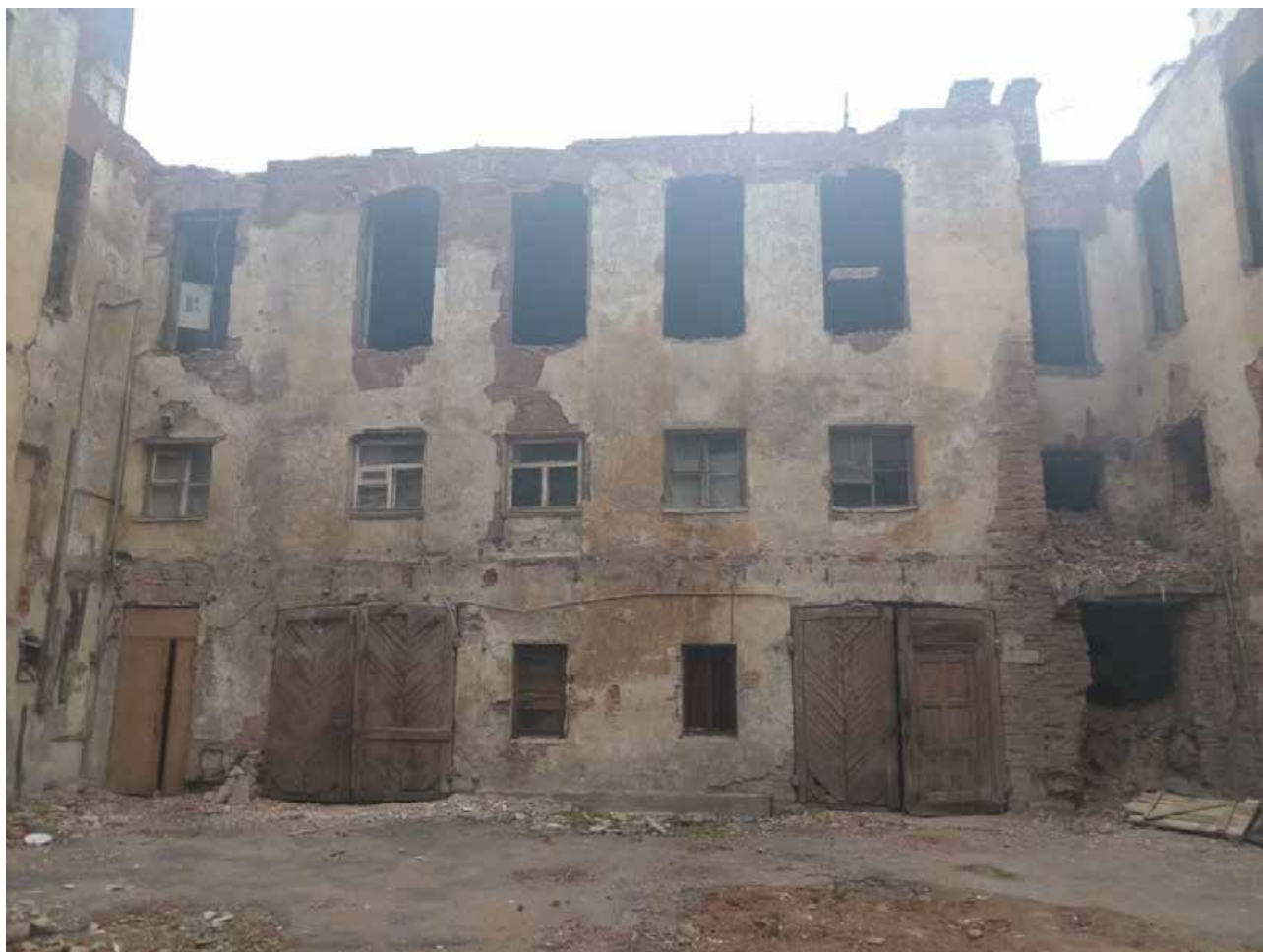
Фото 10. Юго-восточный дворовой фасад.
