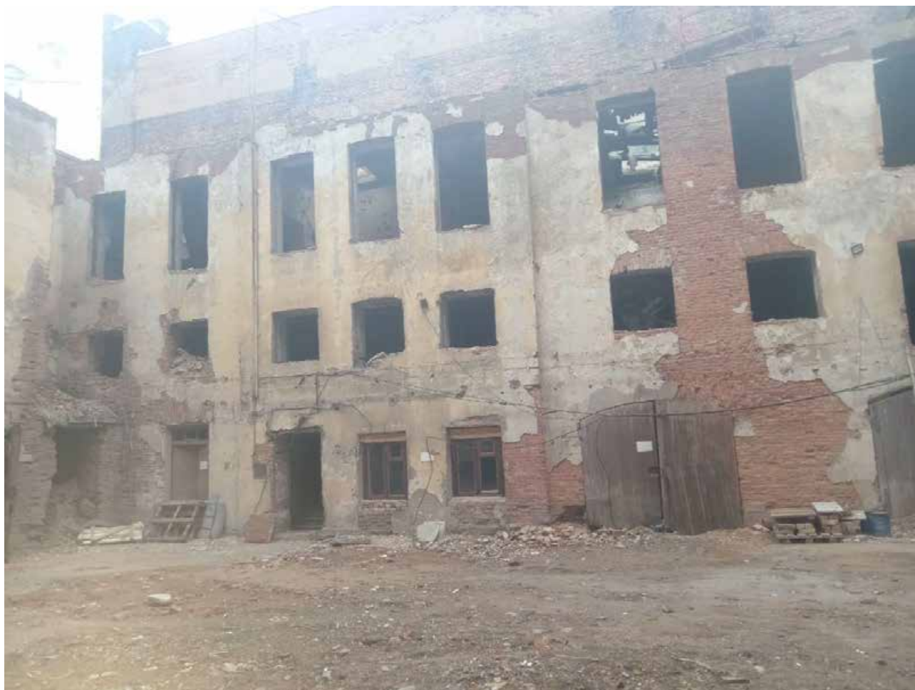
Фото 8. Фрагмент юго-западного дворового фасада.
