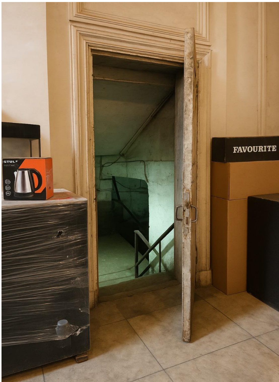
Фото 11. Фрагмент пом. ЛК1 (1), вид на 1Н(1)
