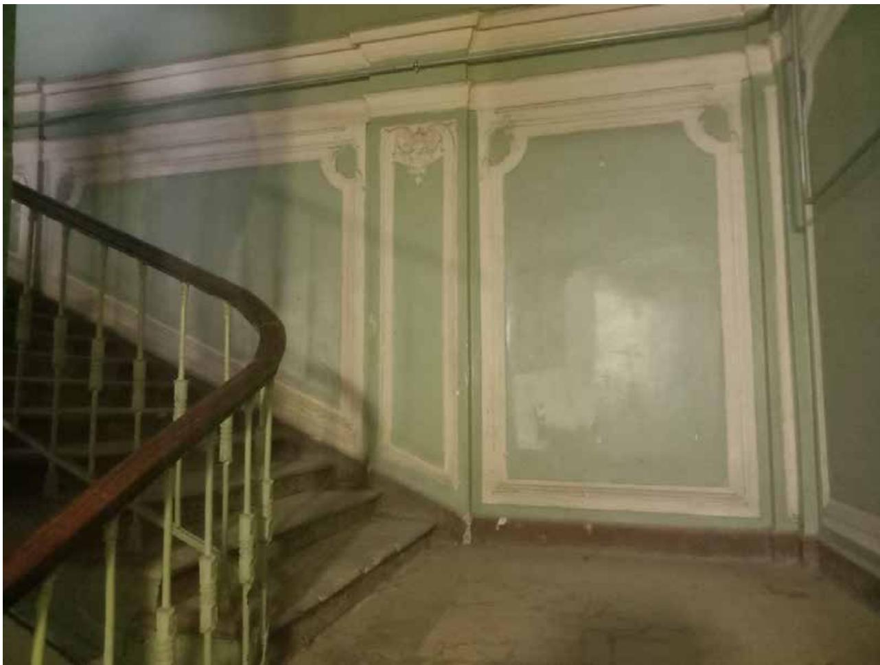
Фото 22. ЛК(1) Марш до площадки 2 этажа. Общий вид.
