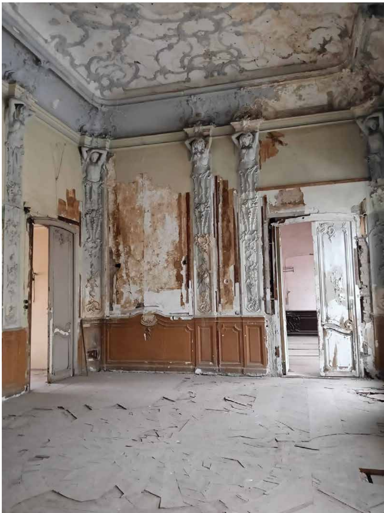
Фото 40. Помещение 3Н(9). Вид на помещение 3Н(8). оформление нижней части стен – профилированные штукатурные филенчатые панели; под пилястрами – в виде лопаток, с прямоугольными филенками; в простенках – с фигурными филенками, широкие простенки – с лепными акантовыми рокайлями; панели завершены профилированным карнизом, раскрепованным под пилястрами, с центральной повышенной фигурной частью (в виде волют) – над лепными композициями.
