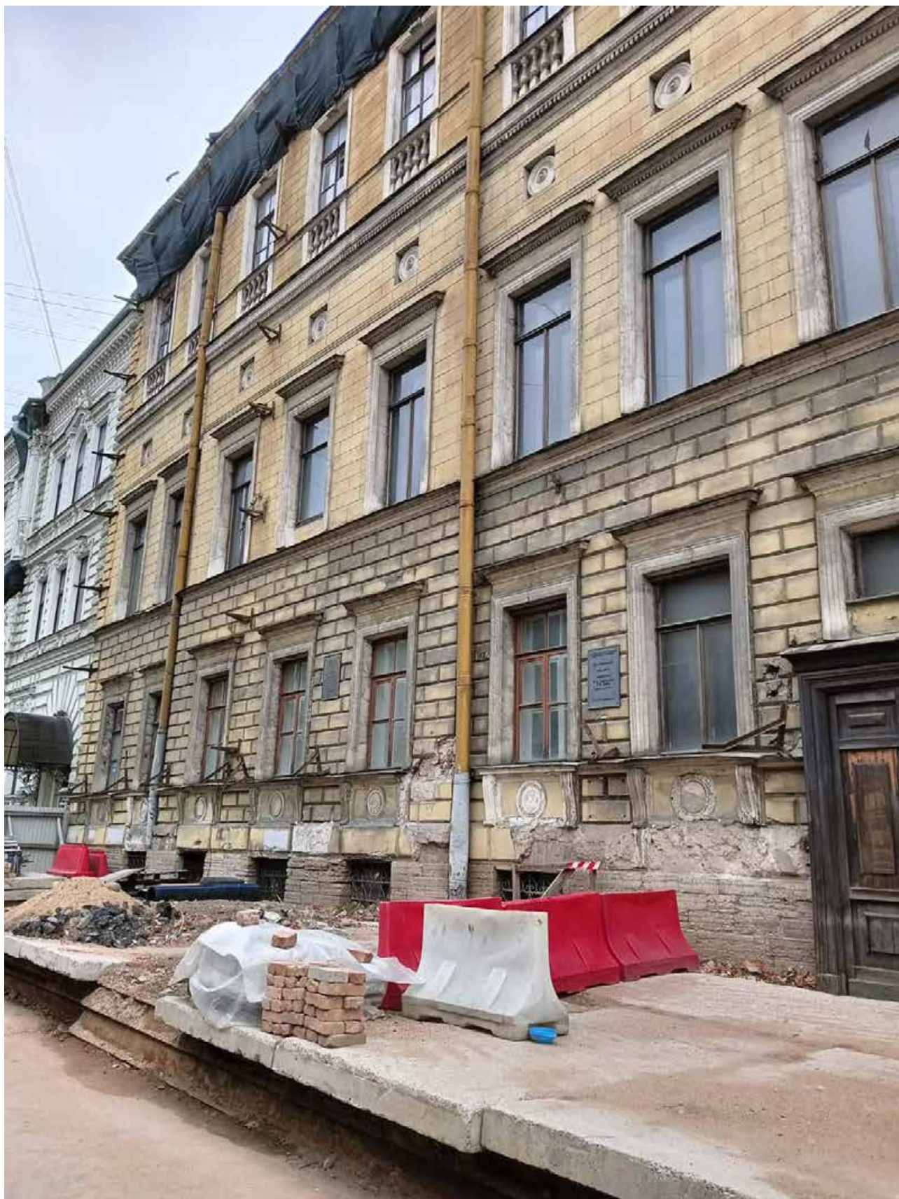
Фото 2. Фрагмент лицевого фасада. Первый этаж. 1-7 световых осей. Характер отделки цоколя — известняк.
