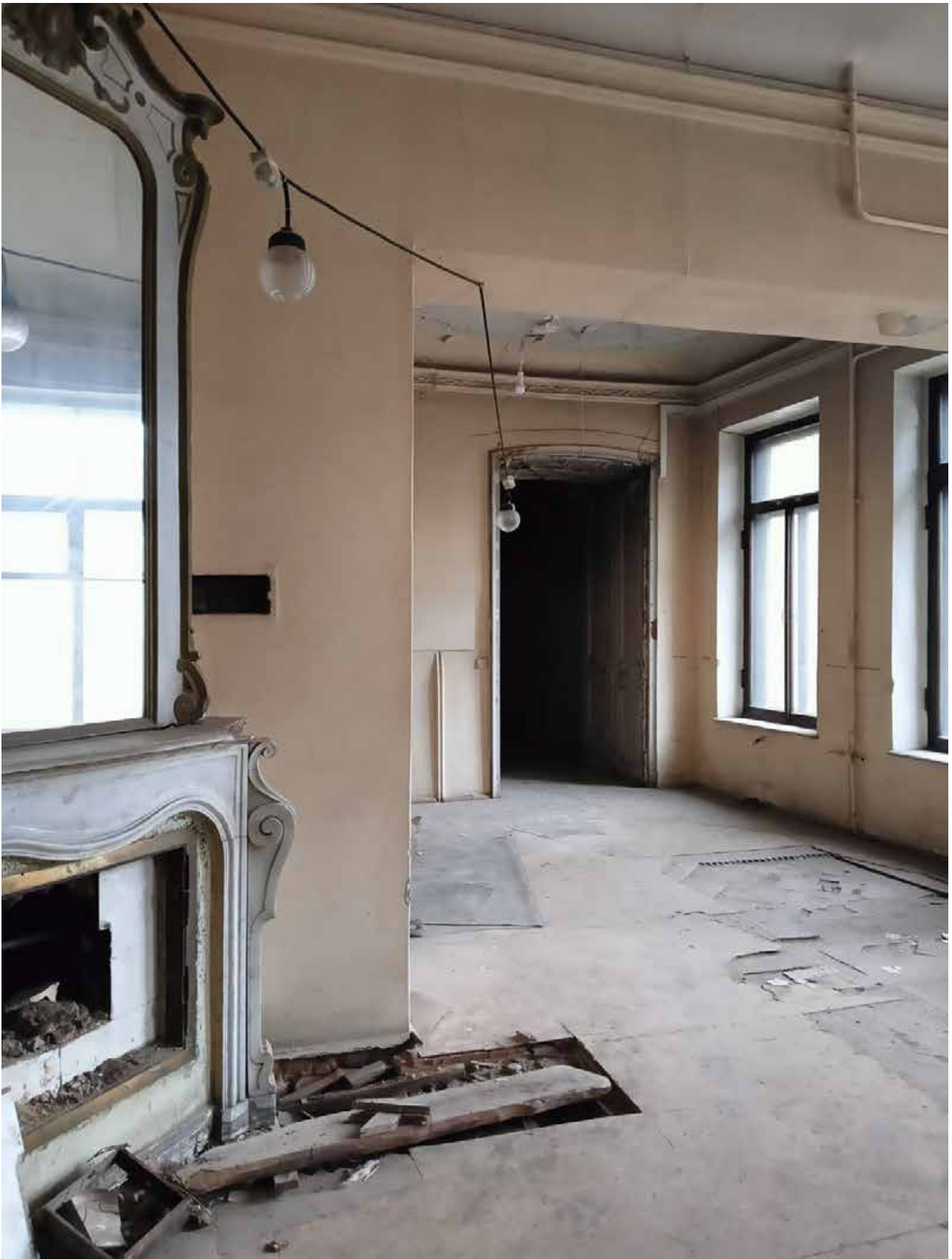
Фото 48. Помещение ЗН(12) (Передняя). Вид на пом. ЗН(11). Печь-камин угловая, двухъярусная; нижний ярус: белого с серыми прожилками мрамора; верхний ярус: надкаминное зеркало в лепной фигурной раме с бронзировкой.
