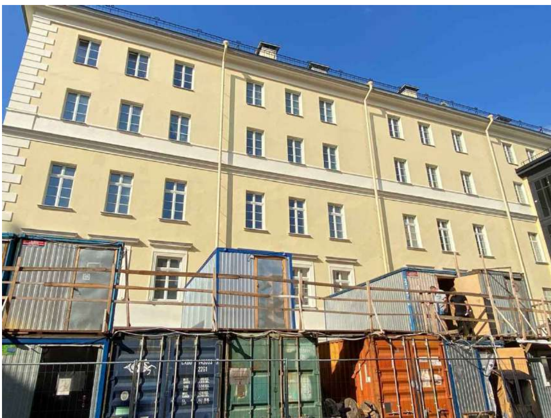
Фото 2. Общий вид объекта. Лицевой фасад со стороны двора
