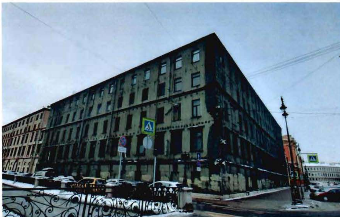
1. Общий вид на объект культурного наследия
