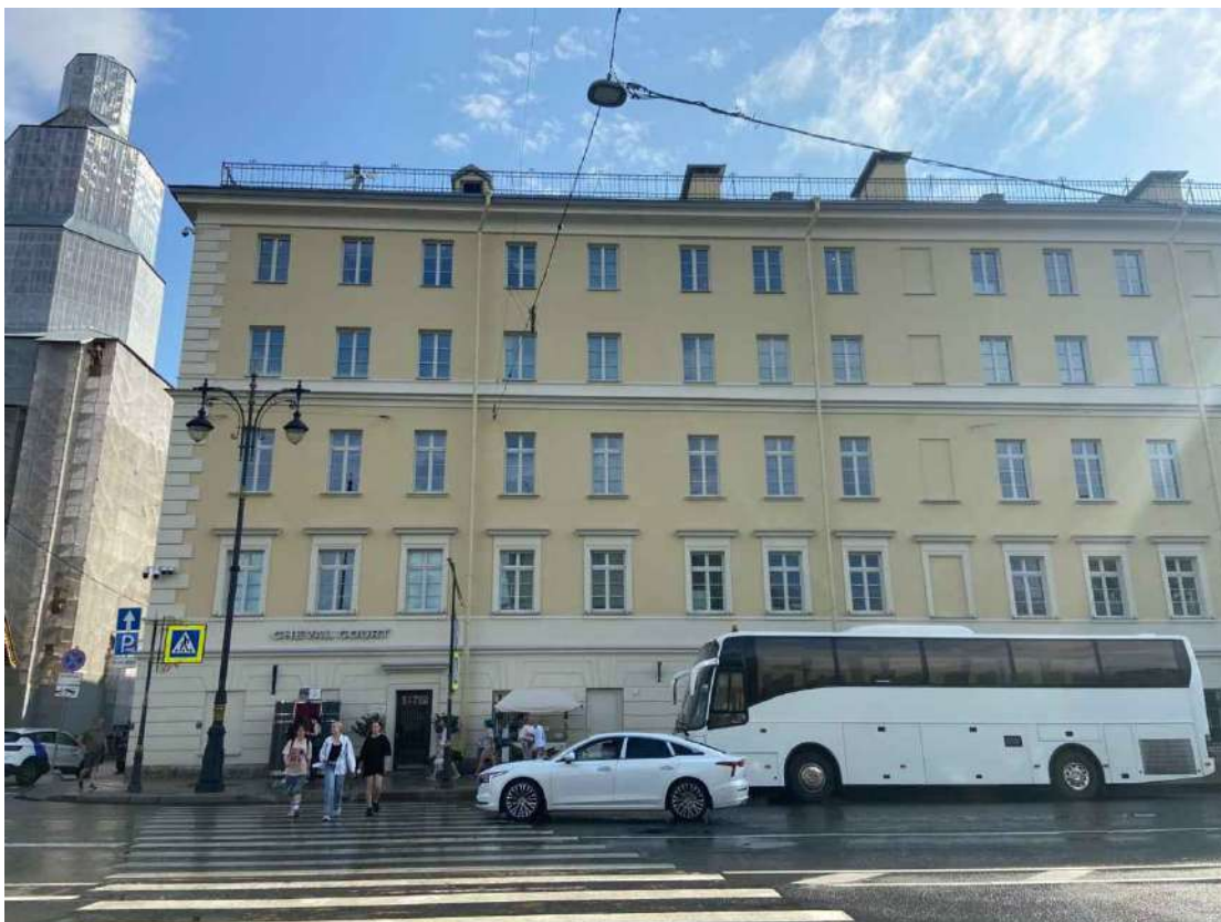
Фото 1. Общий вид объекта. Лицевой фасад со стороны Конюшенной площади и Главных императорских конюшен.
