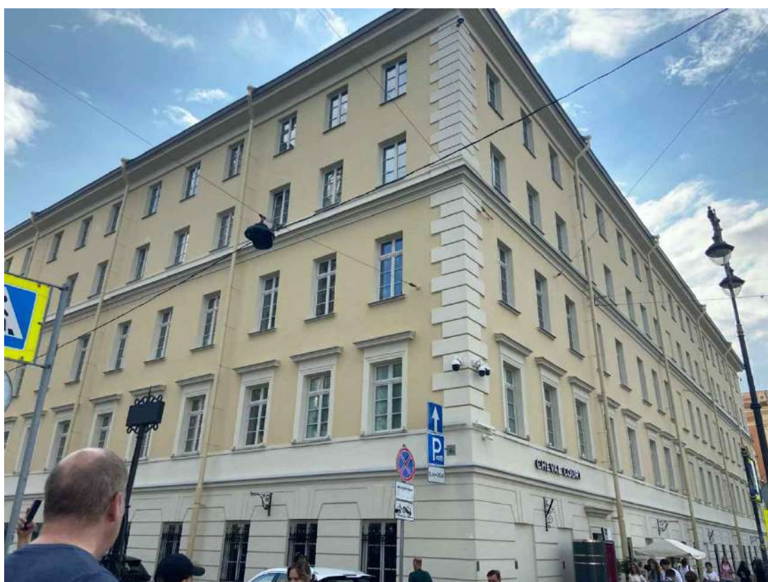
Фото 4. Общий вид объекта. Лицевой фасад со стороны Конюшенного моста и наб. кан. Грибоедова.
